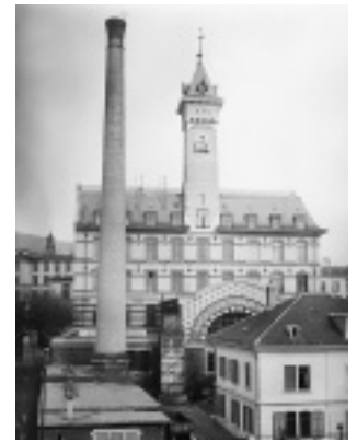
Maschinenlaboratorium (Benjamin Recordon, 1895–1900). Ansicht von Westen. Um 1905 (Archiv gta)
