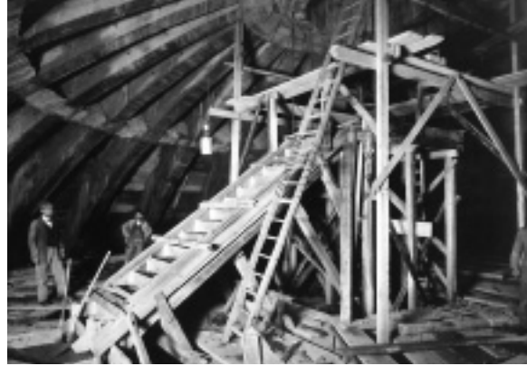
Bau der Kuppel des Hauptgebäudes. Blick in den Kuppelraum. 1919 (Archiv gta)
