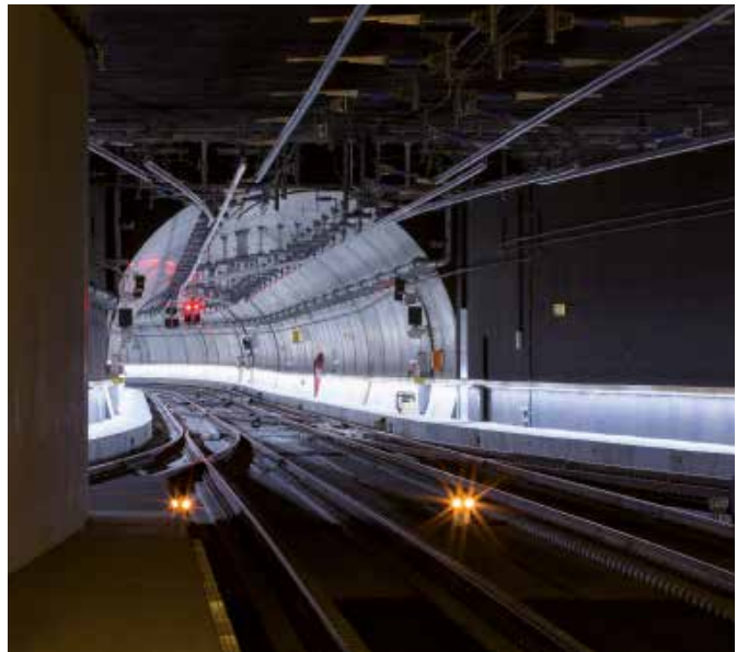
Einfahrt vom Weinbergtunnel in den Bahnhof Löwenstrasse
