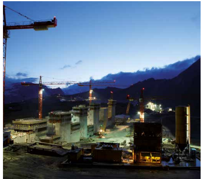
Pumpspeicherkraftwerk Linth-Limmern, Arbeiten an der Staumauer
