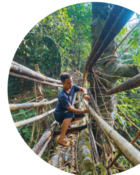
Ein Konstrukteur baut an einer Brücke aus Baumwurzeln. Die Bauweise im indischen Bundesstaat Meghalaya ist weltweit einzigartig.
