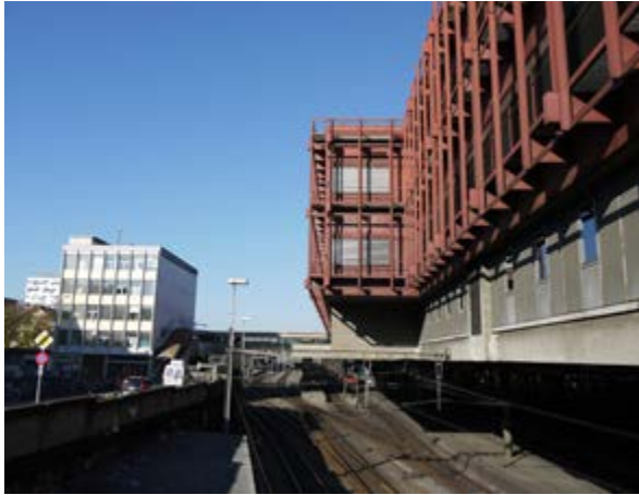
Gebäudeteil über den Gleisen
