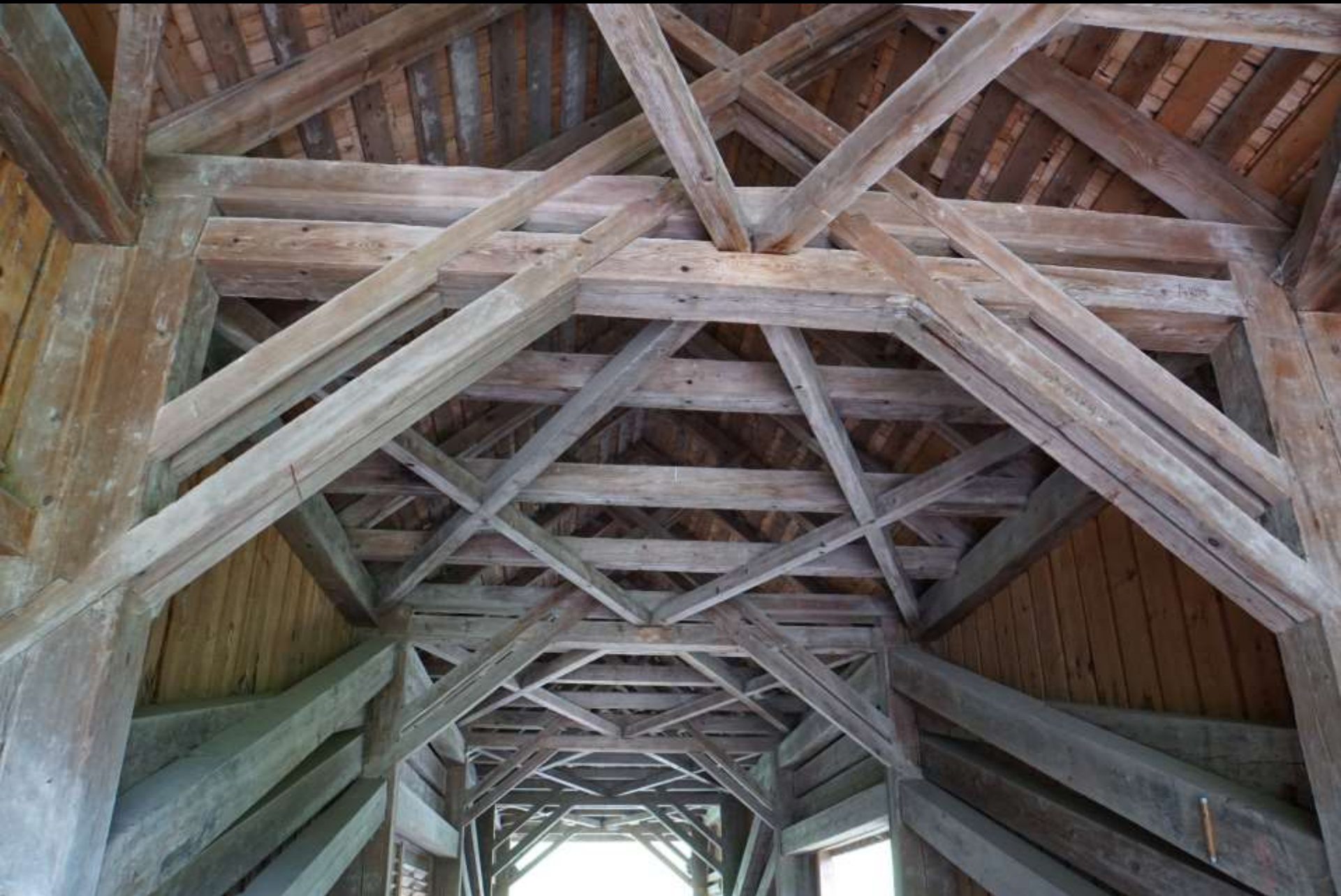
Stabile Portalrahmen (Thurbrücke Lank AI)
