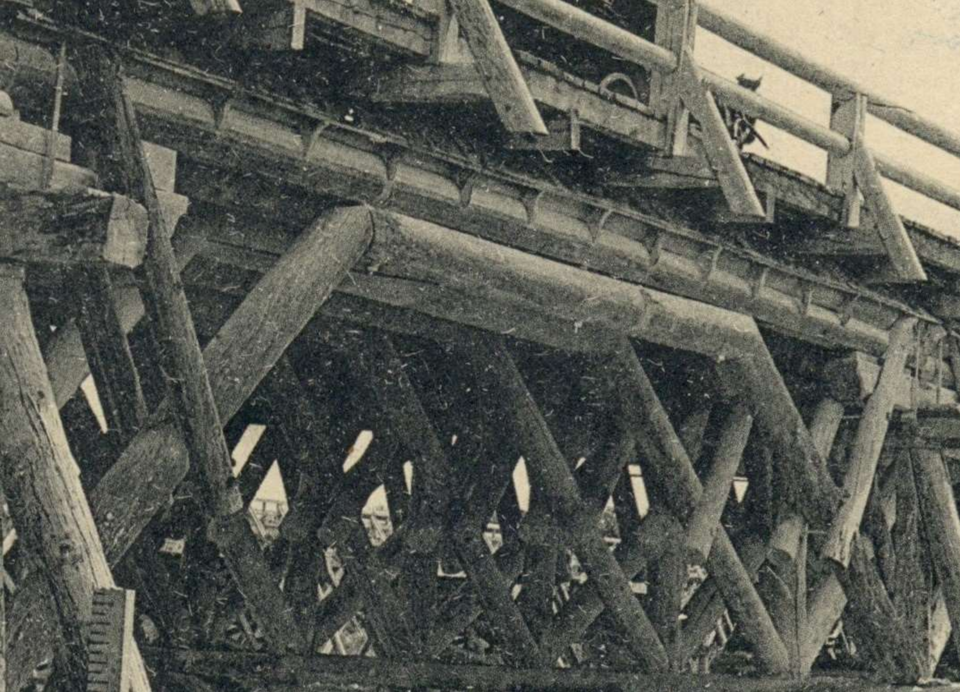
Unterstützung des Streckbalkens durch ein „doppeltes“ Sprengwerk
