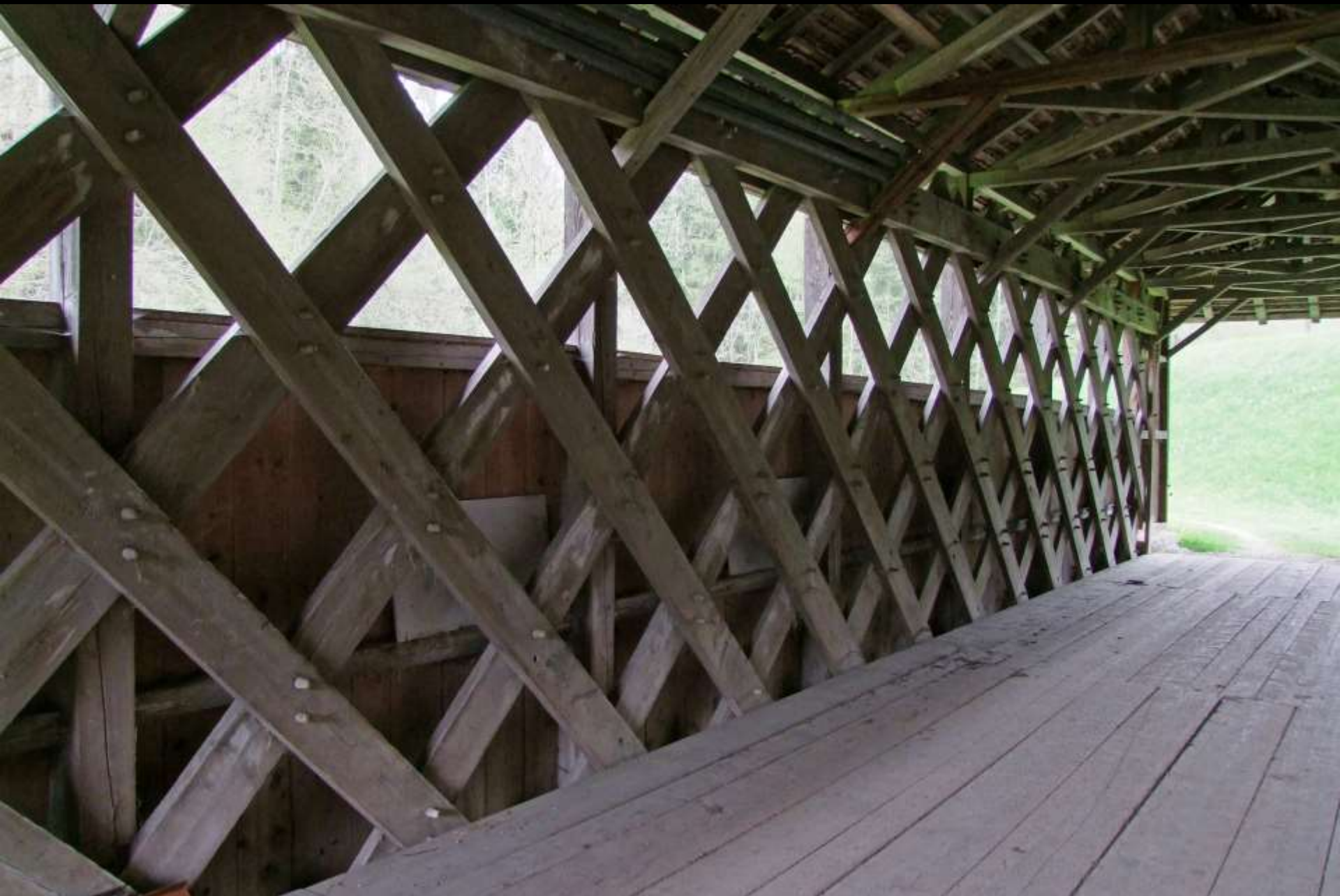
Rotenbrücke Lochmühle (Appenzell-Ausserrhoden) Town'scher Träger über der Fahrbahn
