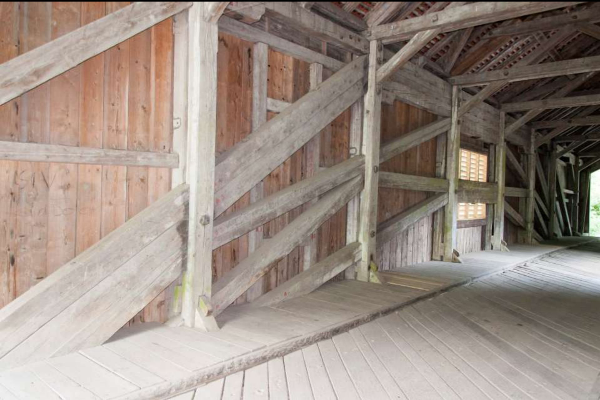
Übereck geschachtelte Polygonalbögen (Sihlbrücke Babenwag/Neuheim-Hirzel; Foto: C. Knobling)
