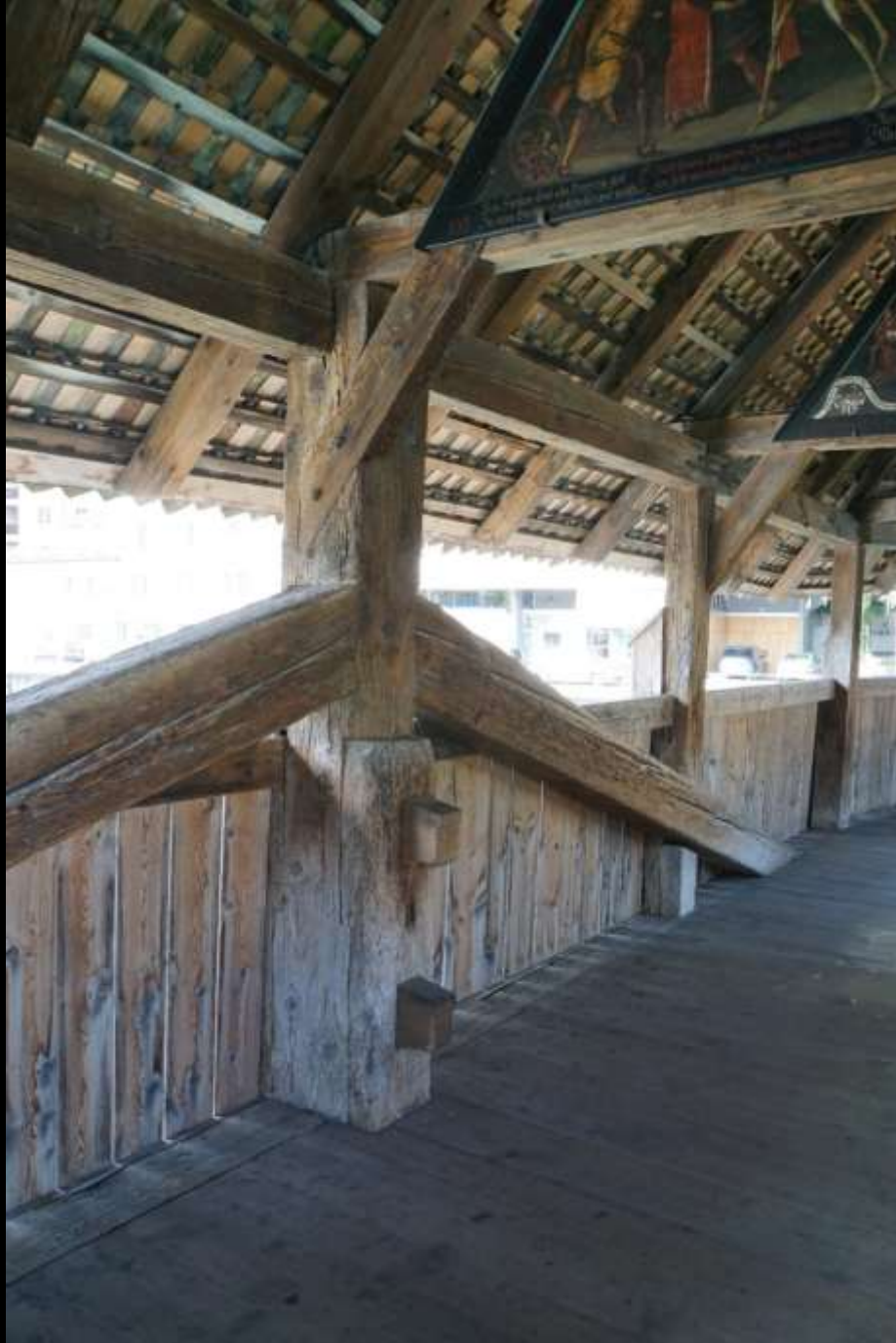
Einfaches Hängewerk (Luzern, Spreuerbrücke, 17. Jh.)
