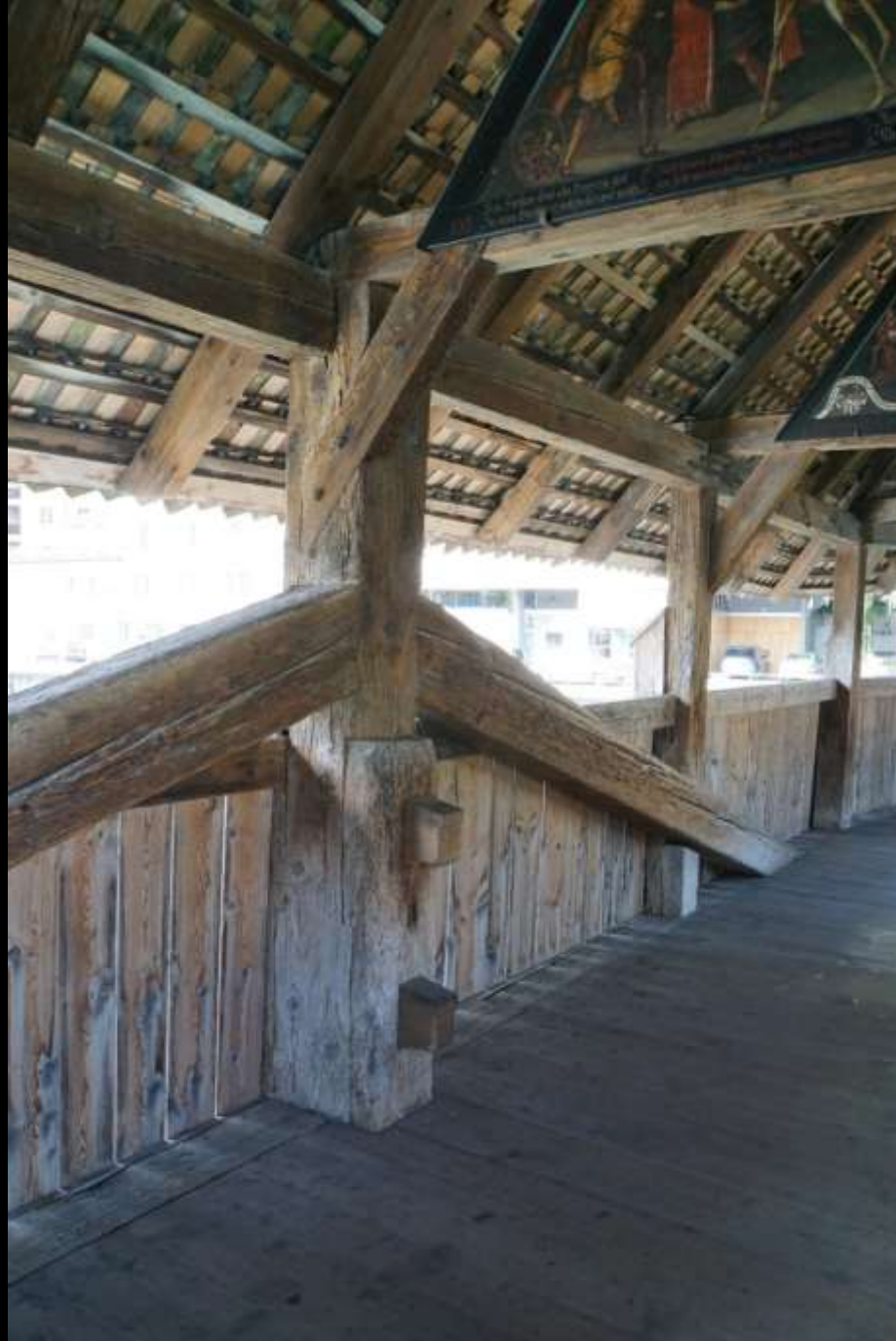
Im Brückenbau gibt es eine Vielzahl von Lösungen (Luzern, Spreuerbrücke, 17. Jh.)
