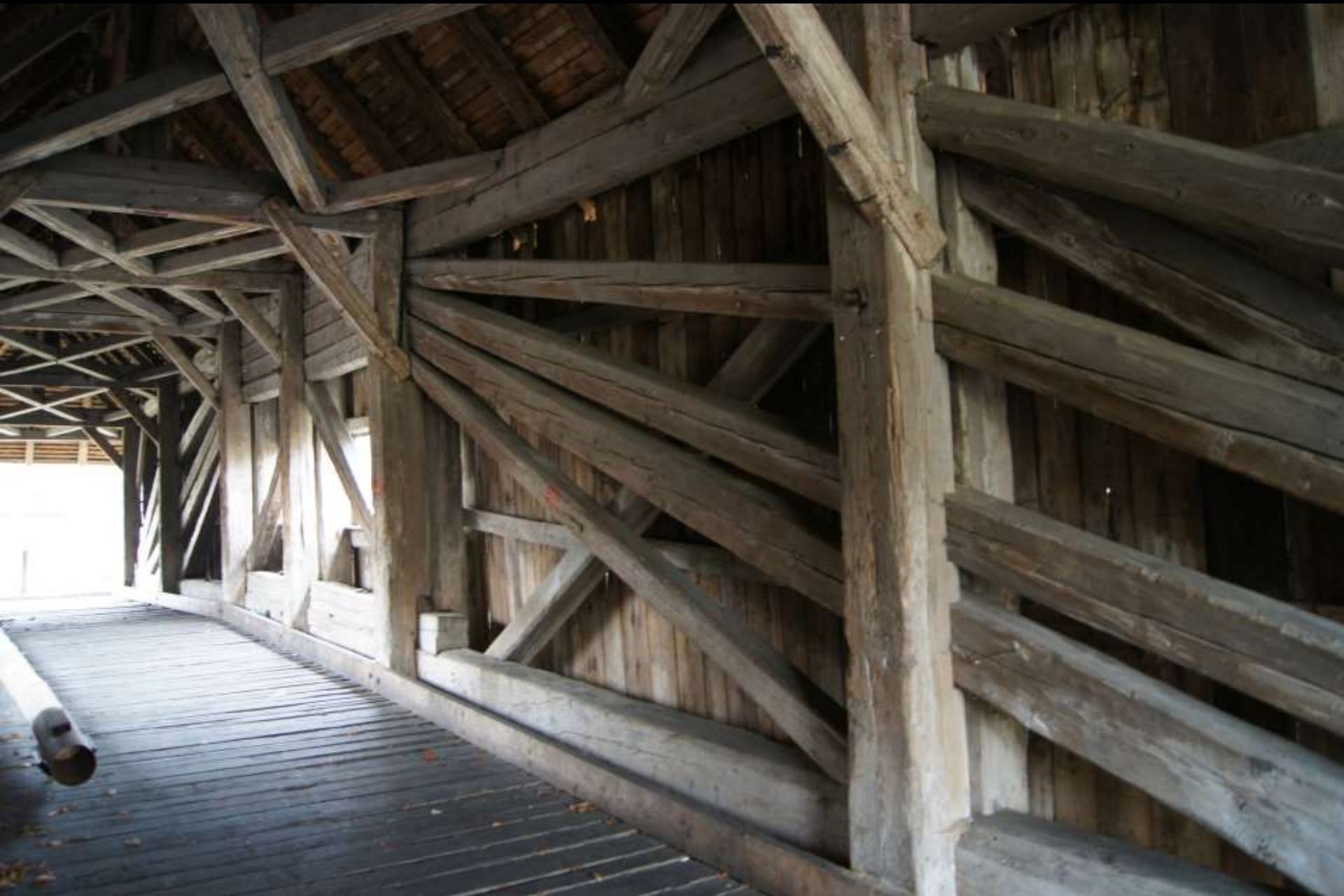
Geschachtelte Hängewerke und zweischichtige Wand (Föhlschmittenbrücke Neuravensburg)
