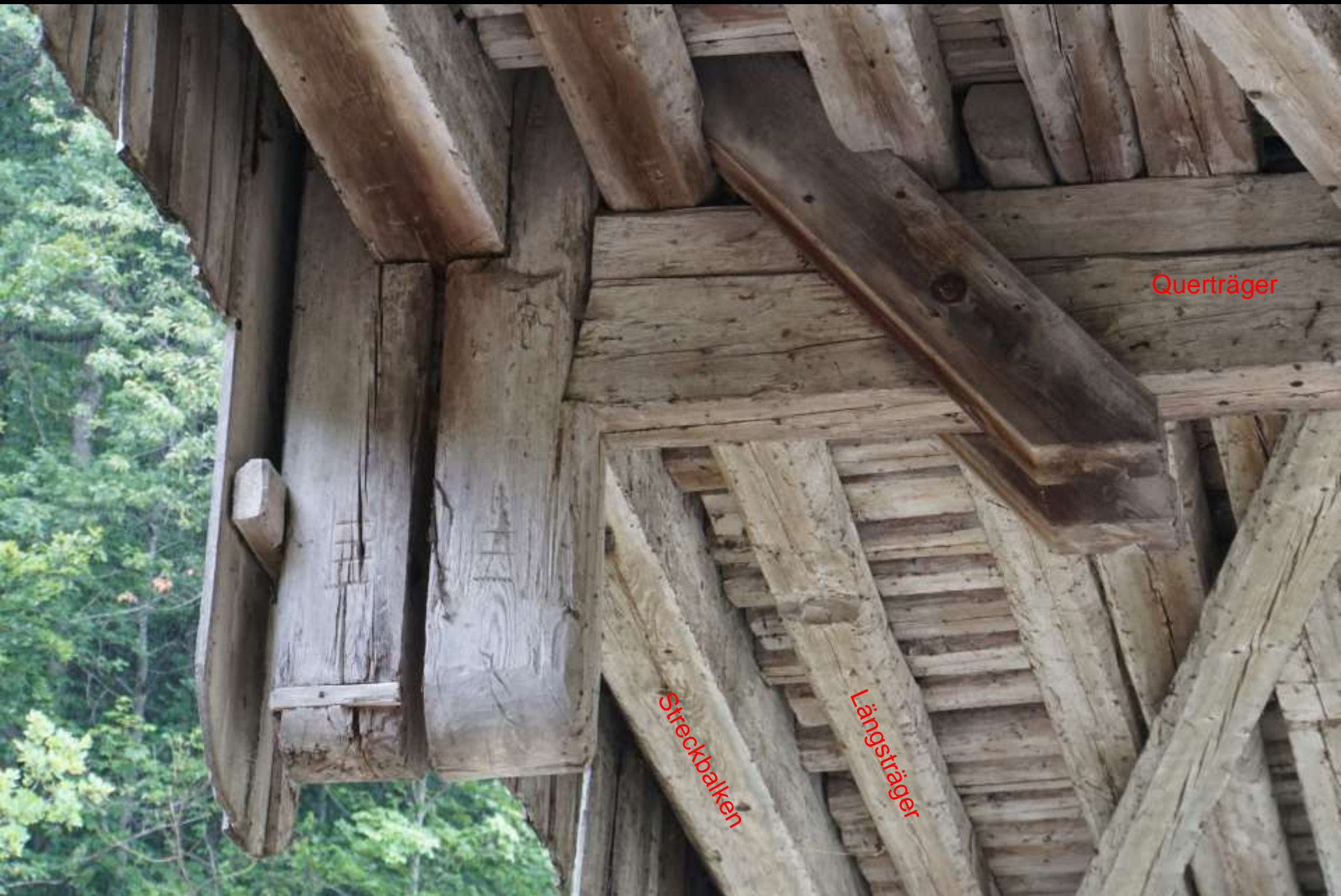
verdoppelte Hängesäule umgreift den Streckbalken zangenartig (Sitterbrücke Spisegg SG)
