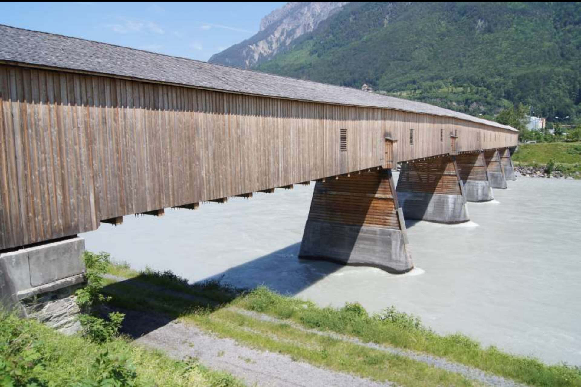
Rheinbrücke Sevelen (SG) – Vaduz (FL). Howe'scher Träger über der Fahrbahn
