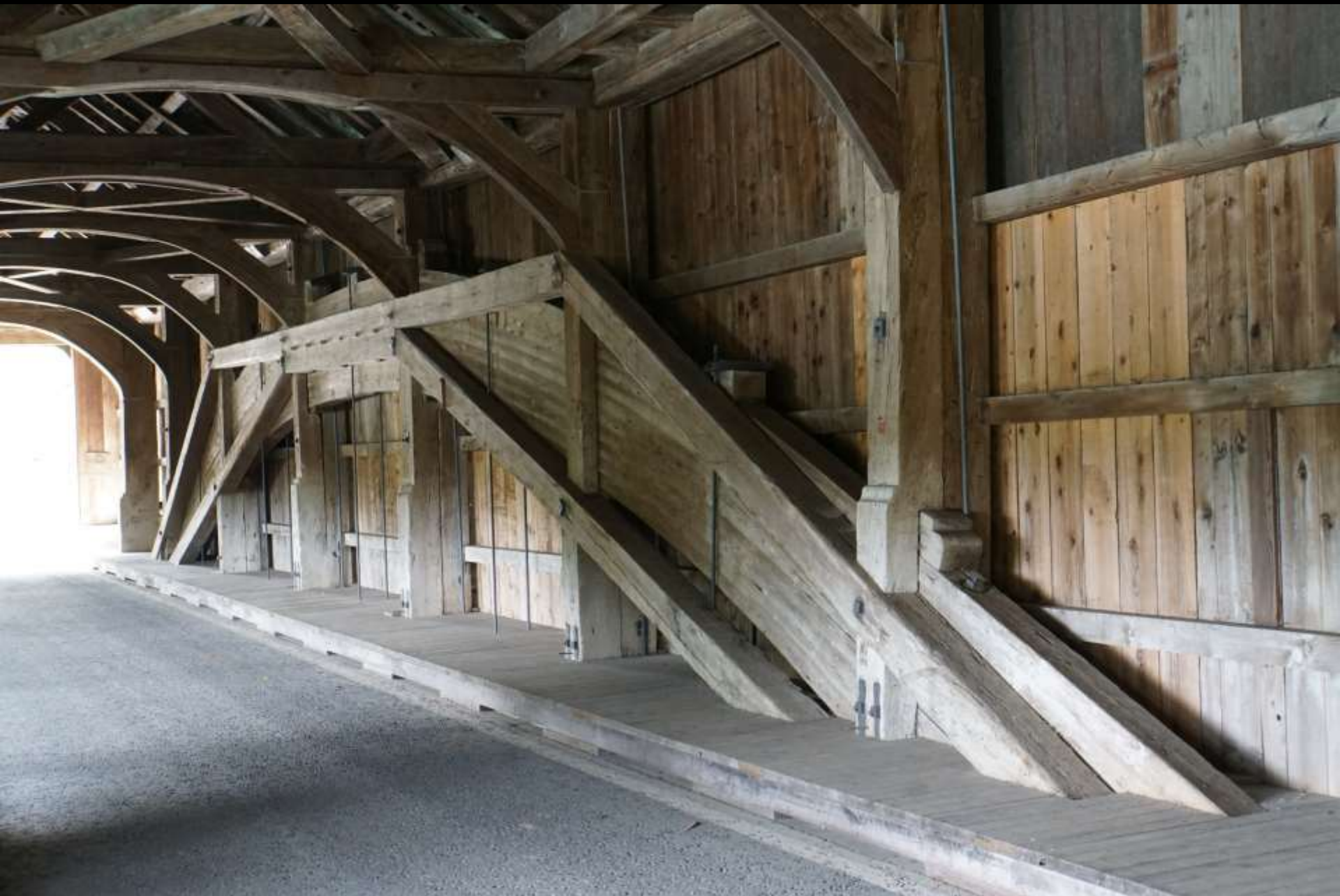
Zwei unabhängige Tragsysteme in zwei Schichten nebeneinander: Bogen und Hängewerk (Reussbrücke Sins)
