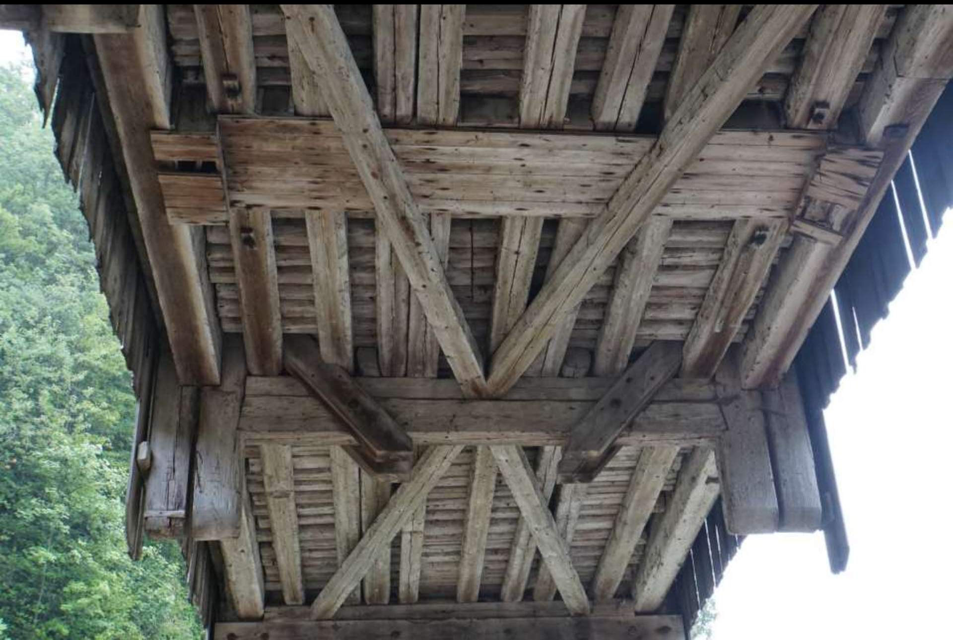
Andreaskreuz-Windverband unter der Fahrbahn (Sitterbrücke Spisegg SG)
