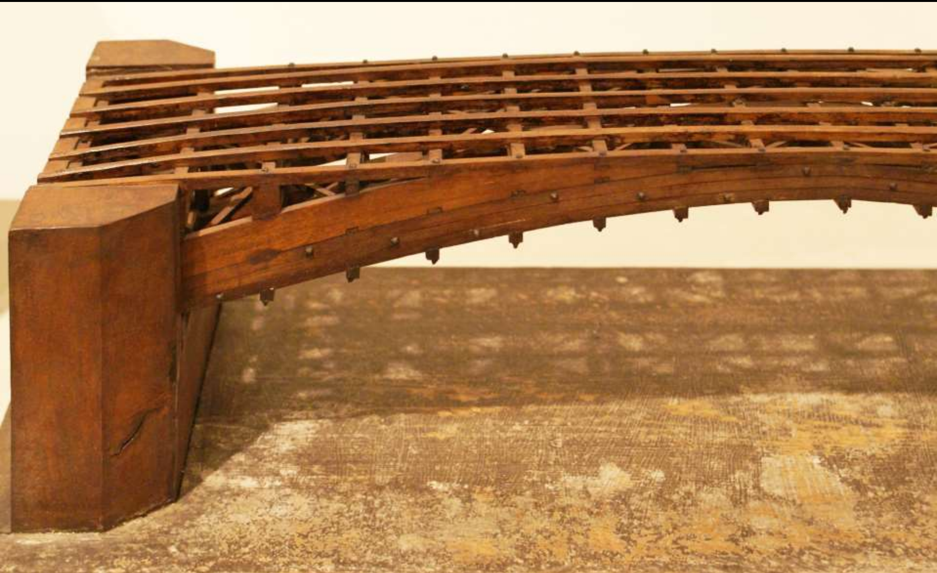
Verdübelter Bogen (Brückenmodell nach Carl Friedrich von Wiebeking 1812, Augsburg, Maximilianmuseum)
