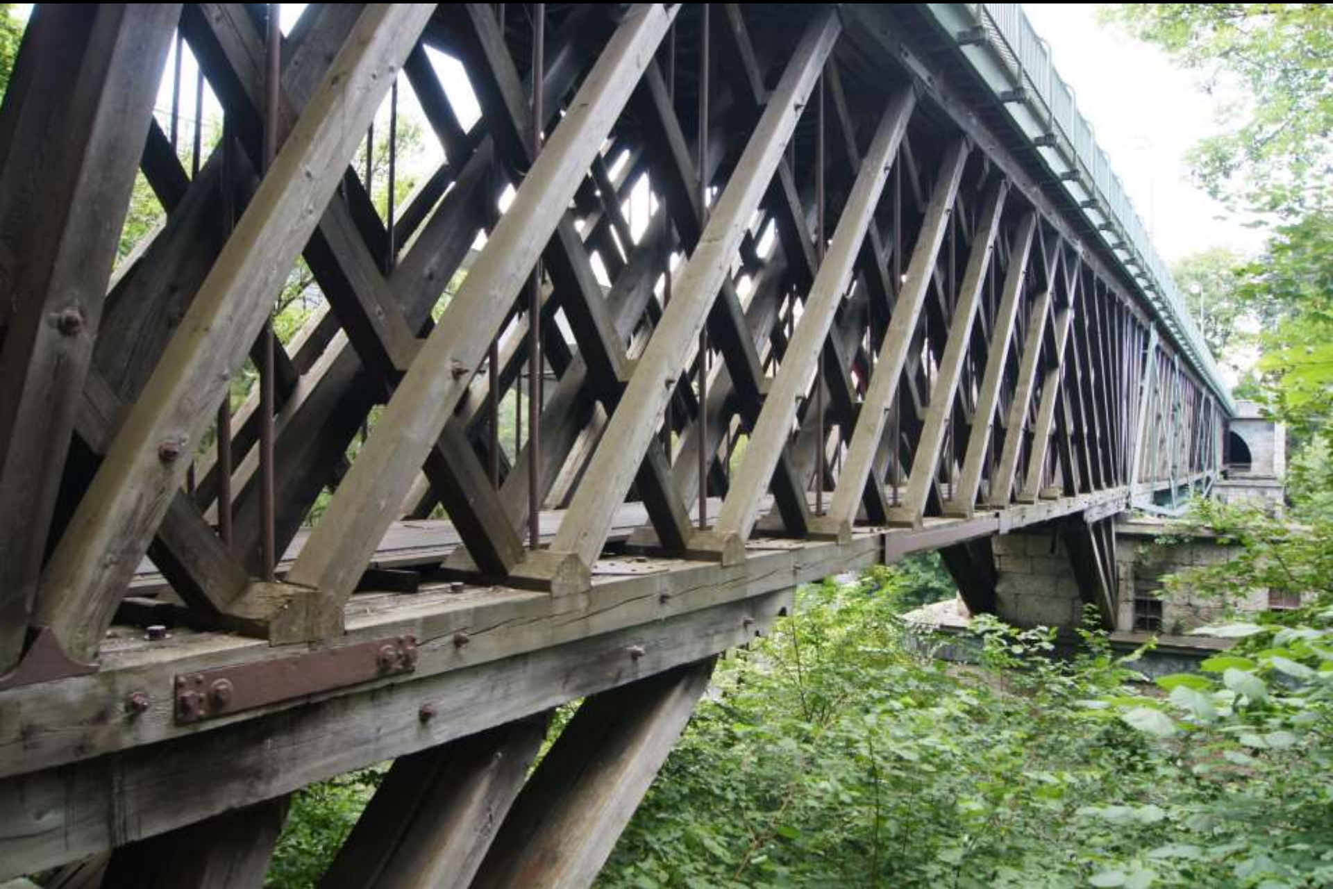
Illerbrücke Kempten (1848). Howe'scher Träger unter der Fahrbahn
