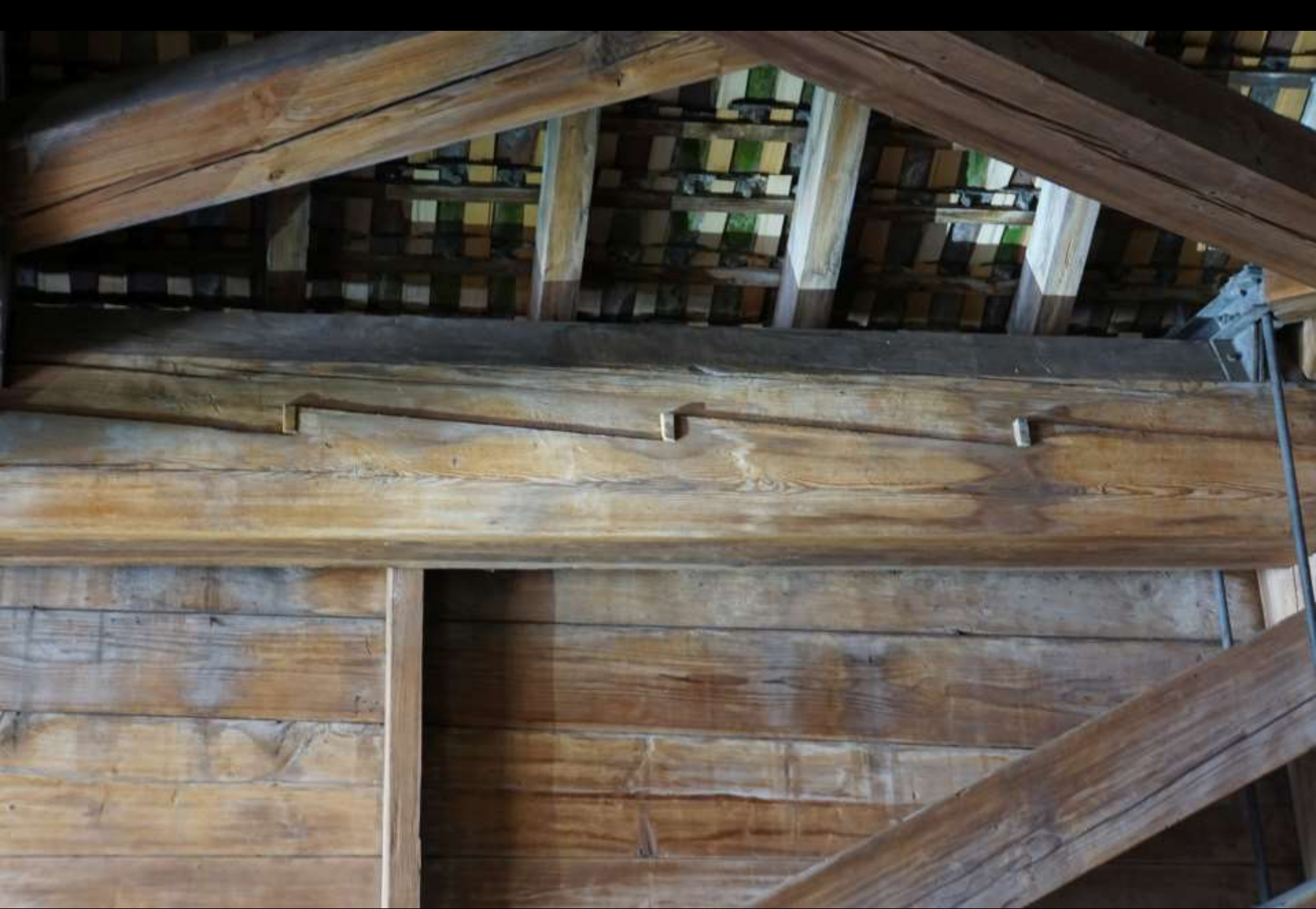
Verzahnnte Balken (Limmatbrücke Wettingen AG)
