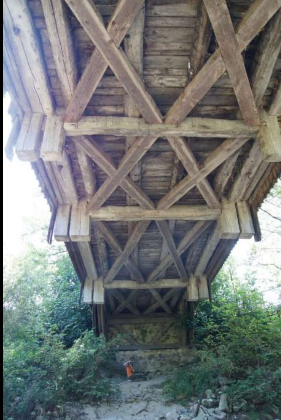
Rautenverband unter der Fahrbahn (Föhlschmittenbrücke Neuravensburg)
