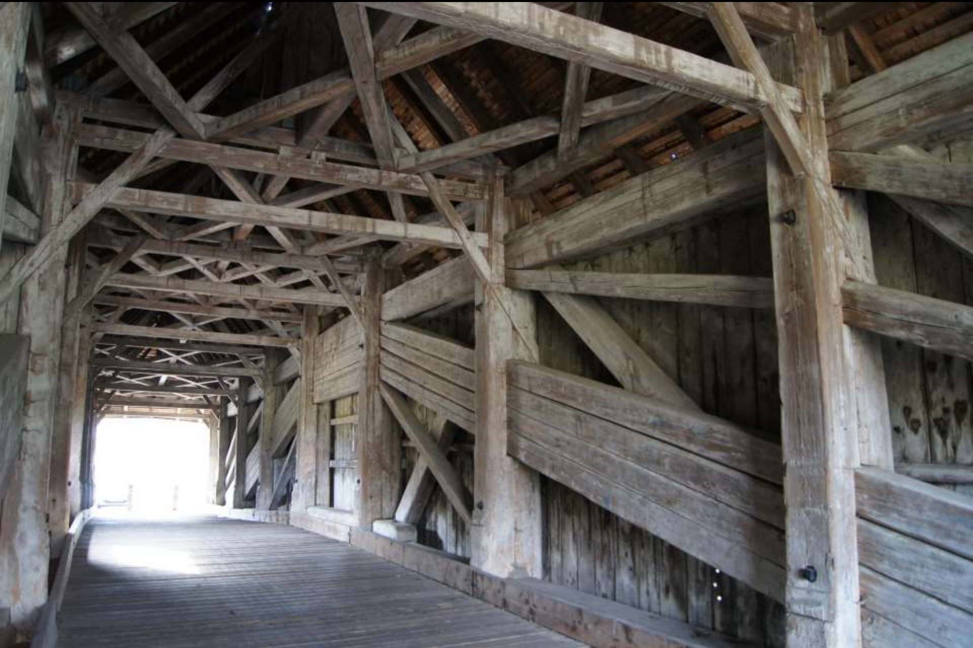
Windverband in der Dachtraufebene und steife Portalrahmen (Brücke Hiltensweiler)
