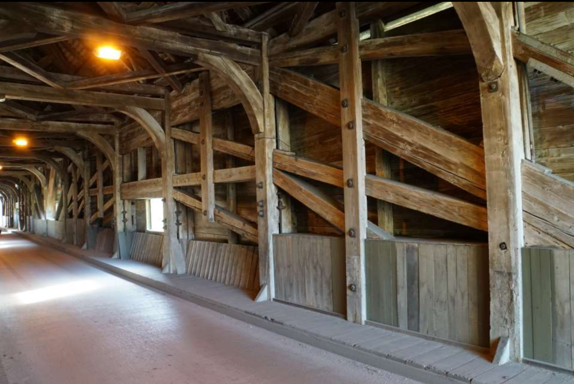
Übereck geschachtelte Polygonalbögen (Thurbrücke Andelfingen TG)
