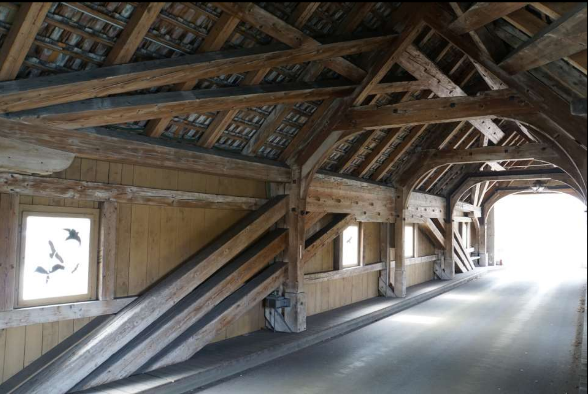
Ineinander gestellte doppelte Hängewerke (Rheinbrücke Rheinau ZH)
