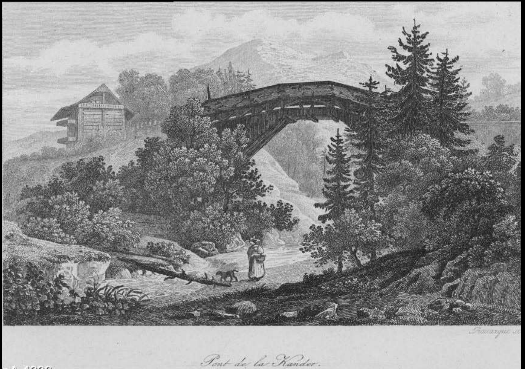
Sprengwerksbrücke über die Schlucht der Kander bei Wimmis (Ansicht von Rothmüller, 1. H. 19. Jh.)
