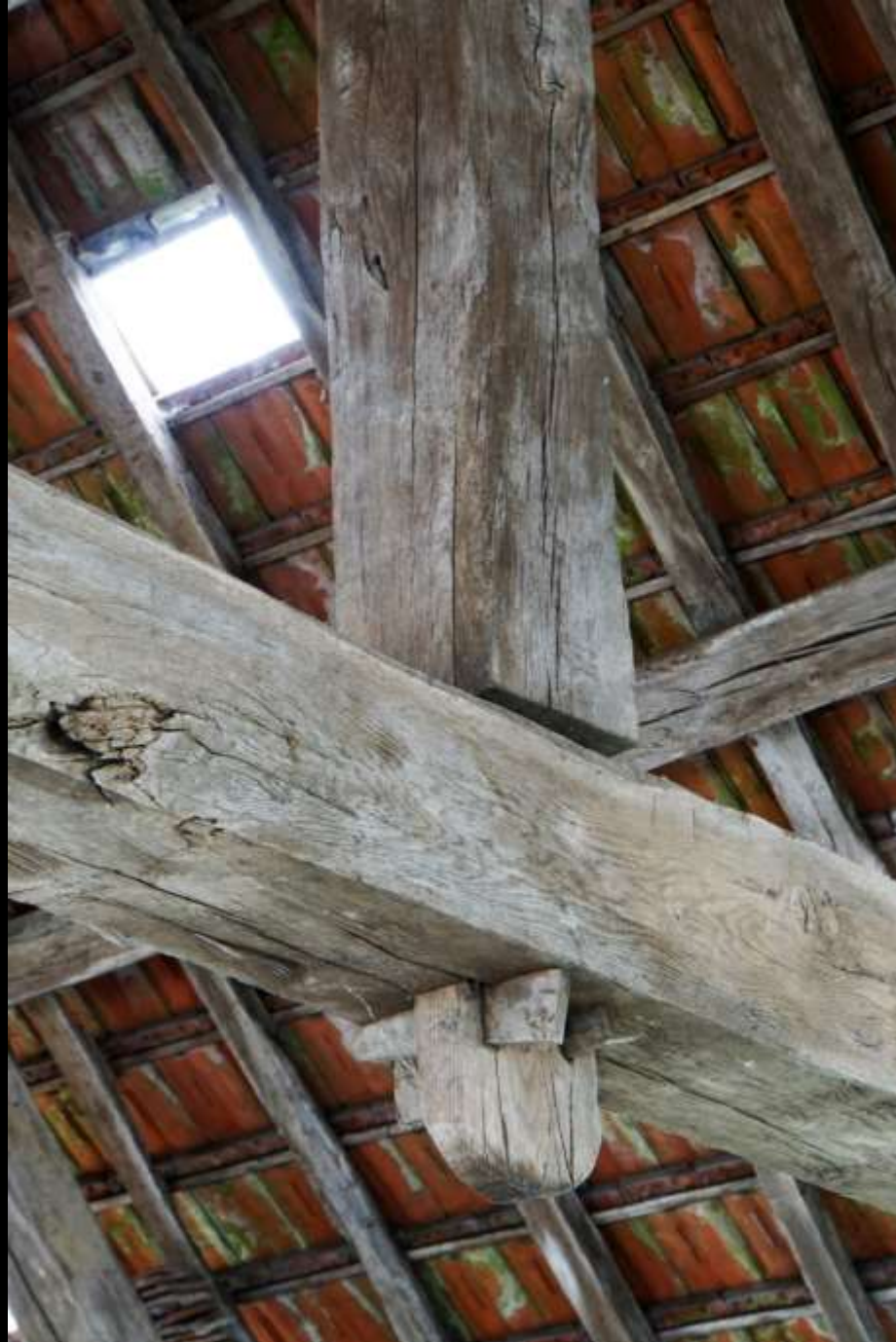
Zapfenschloss (=Durchsteckzapfen mit Splint): Vauvillers (70), Waschhaus (Anf. 19. Jh.)
