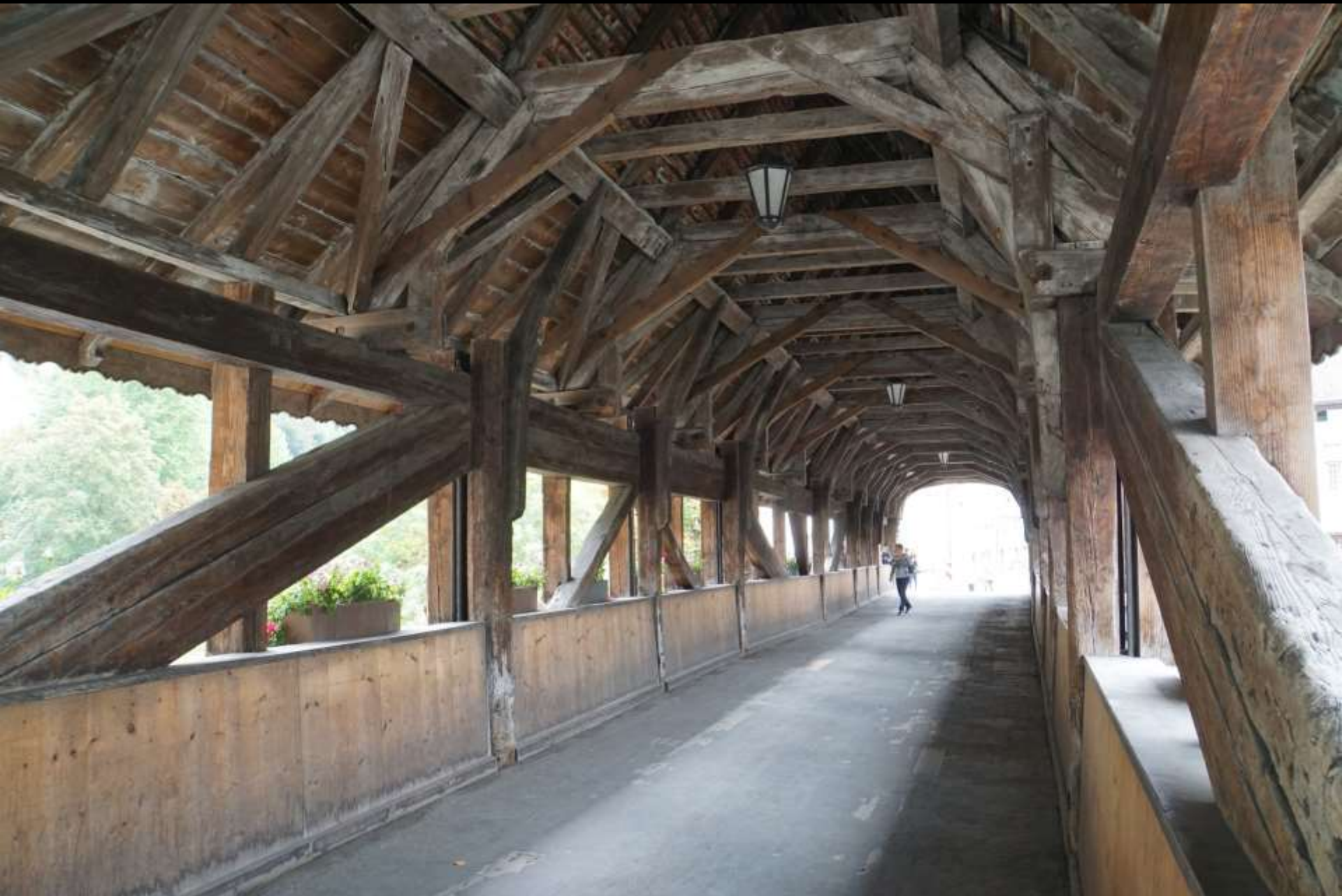
Doppeltes Hängewerk mit eingestelltem einfachem Hängewerk (Pont de Berne, Fribourg)
