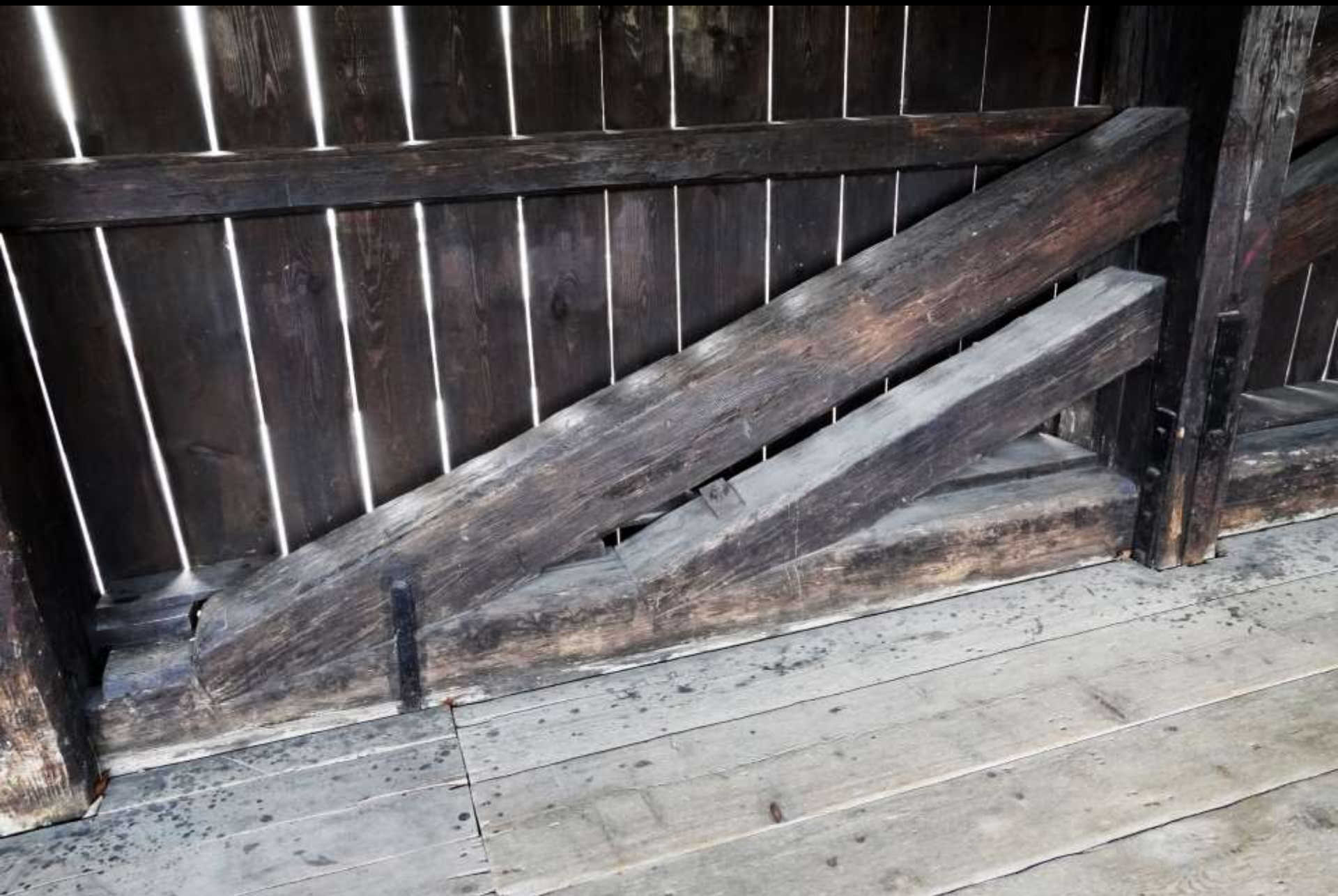
Brunnen SZ, Wylerbrugg (18. Jh.). Fusspunkt der Hängewerksstreben
