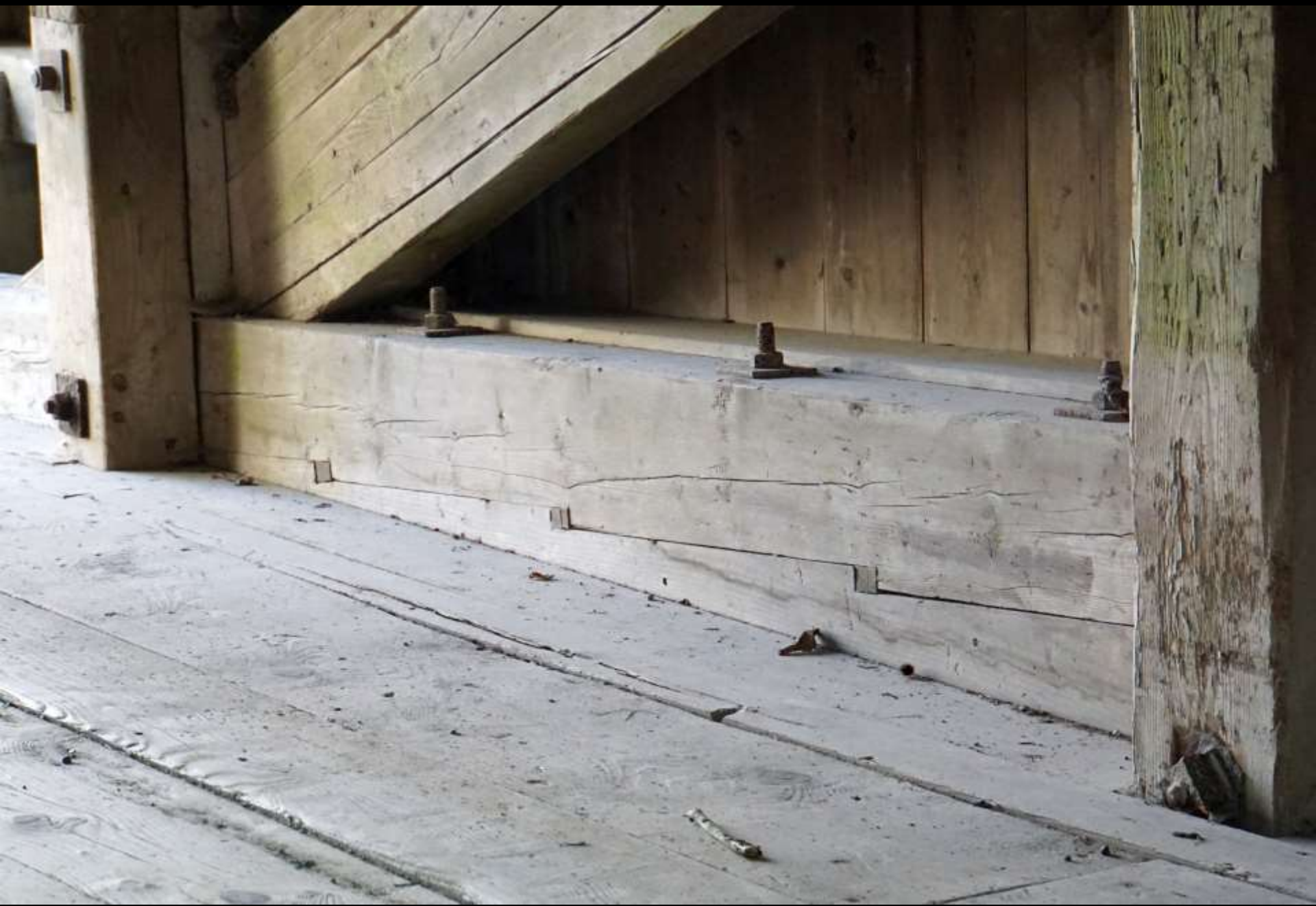
Verzahnte und verschraubte Balken (Sitterbrücke im Kubel SG)
