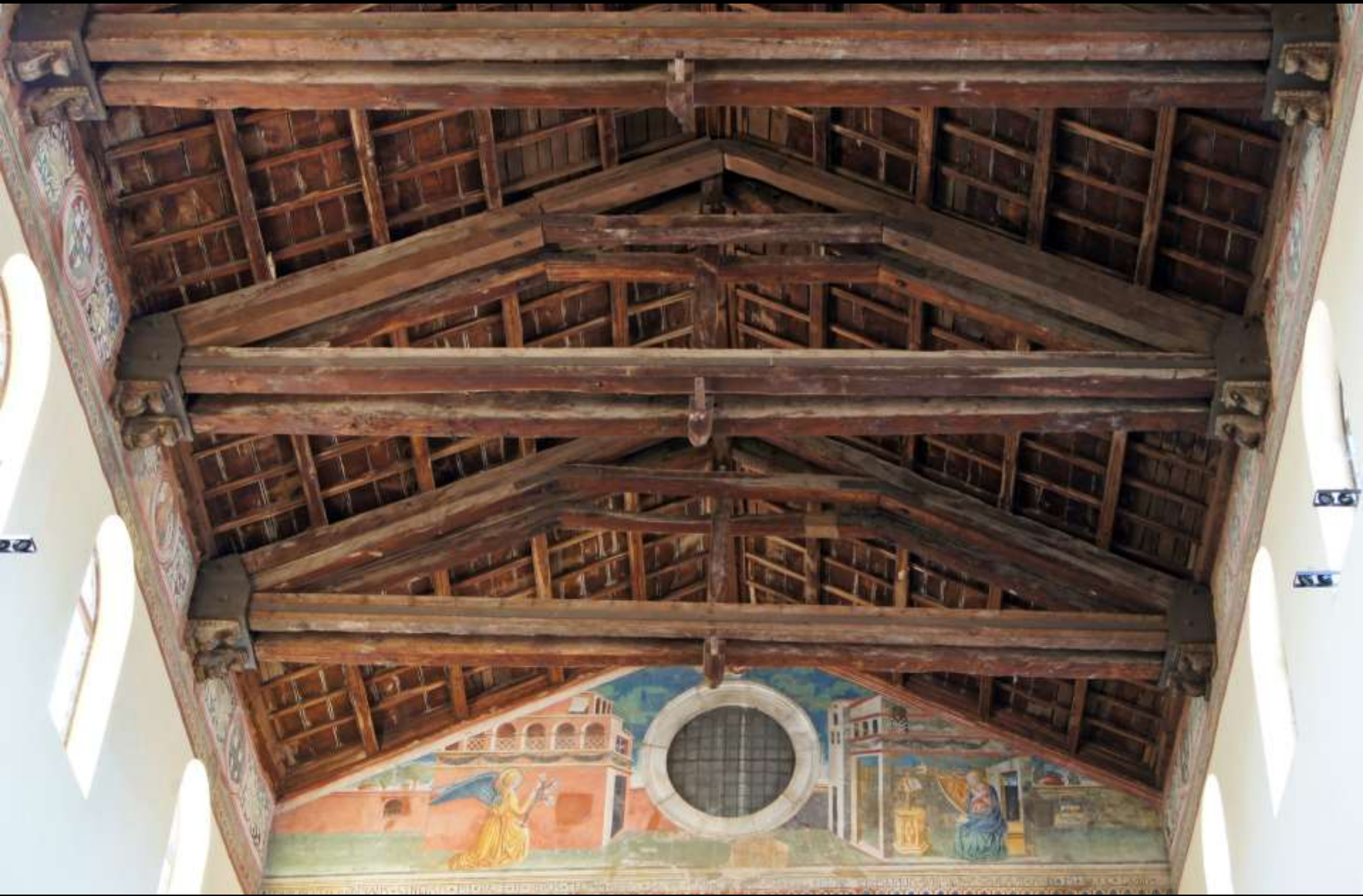
„Einfaches Hängewerk“ in italienischen Dachkonstruktionen (Rom, San Saba, Dach 1463)
