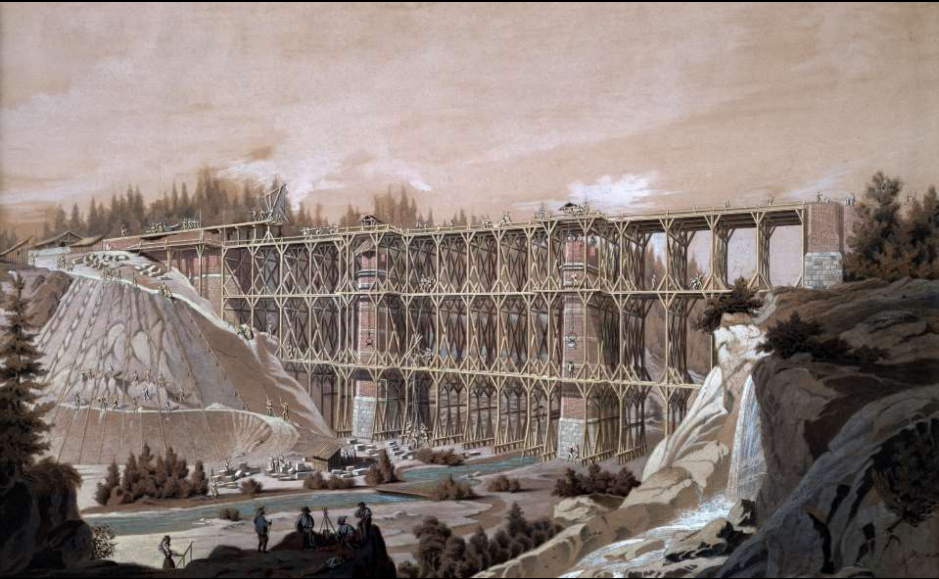
Aufstellgerüst einer Howeschen Brücke der Ludwig-Süd-Nord-Bahn 1853 (Aquarell von Karl Herrle)
