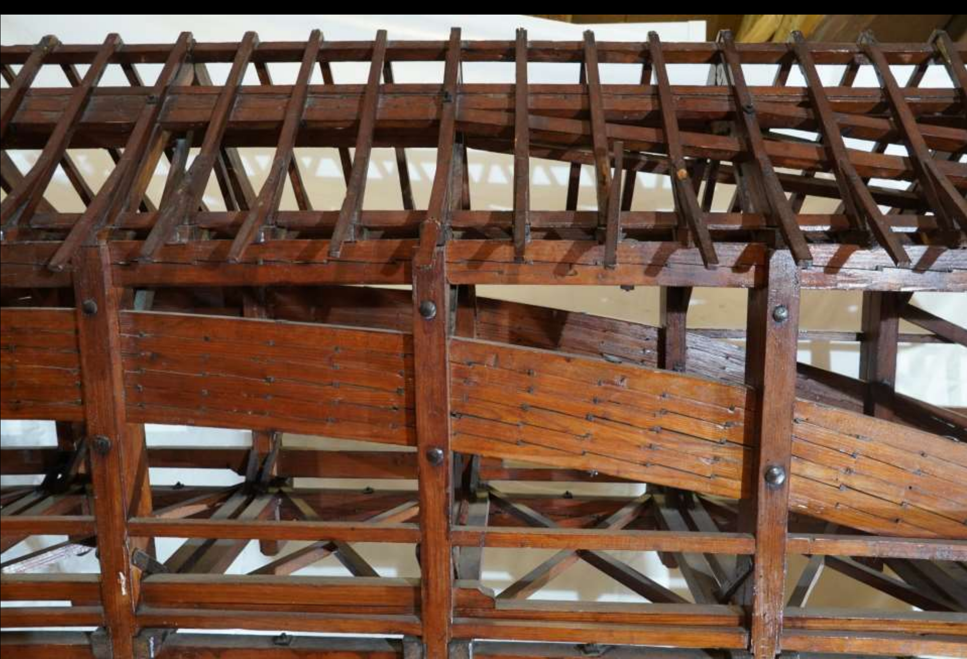
Verzahrter Bogen (heute zerstörte Brücke über die Thur in Bischofszell TG; Entwurfsmodell um 1810) Detail des Bogens (sechslagig, verzahnt und verkeilt)
