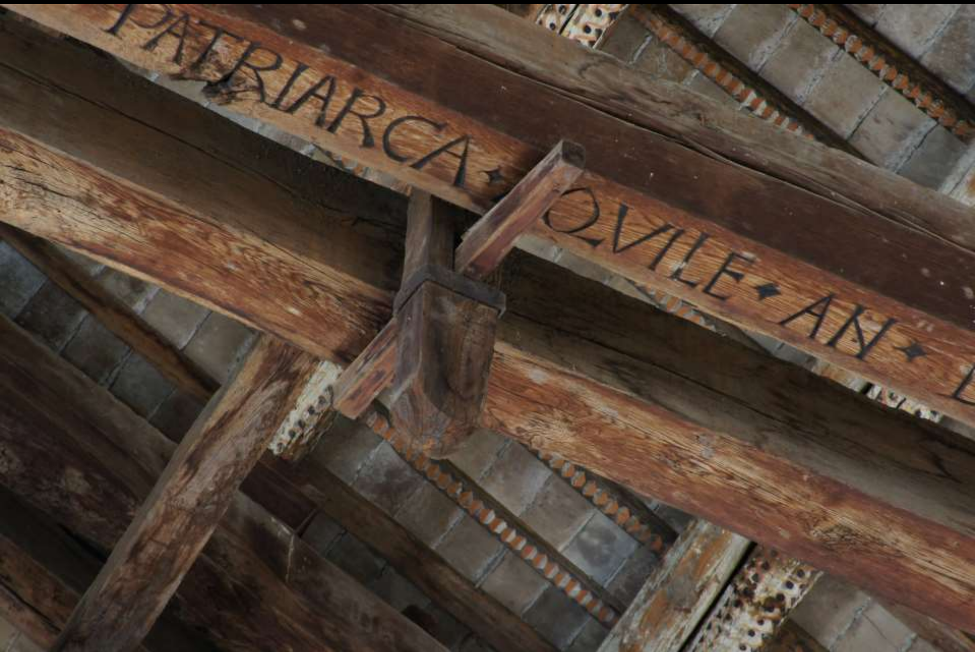
Doppelbinder, durchgesteckter hölzerner Splint (Rom, Santa Balbina, 1488)
