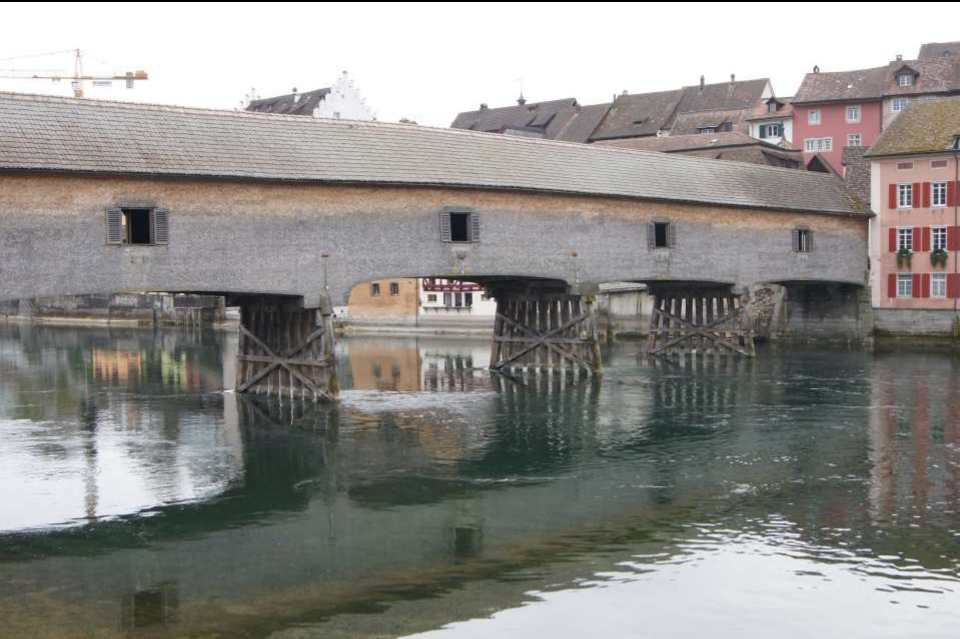
Rheinbrücke Diessenhofen (TG)
