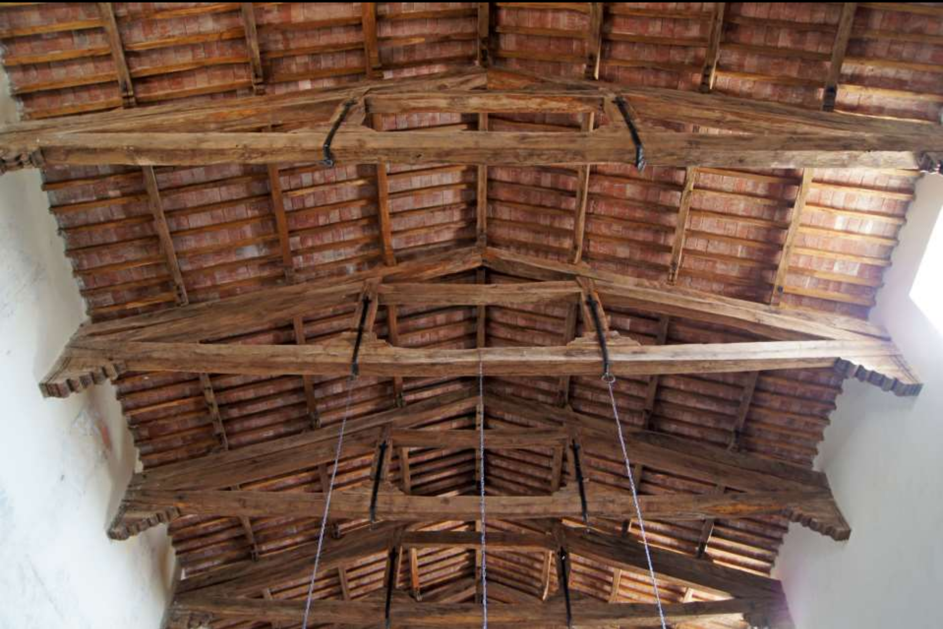
Doppertes Hängewerk im italienischen Dach (Canino VT, San Francesco)
