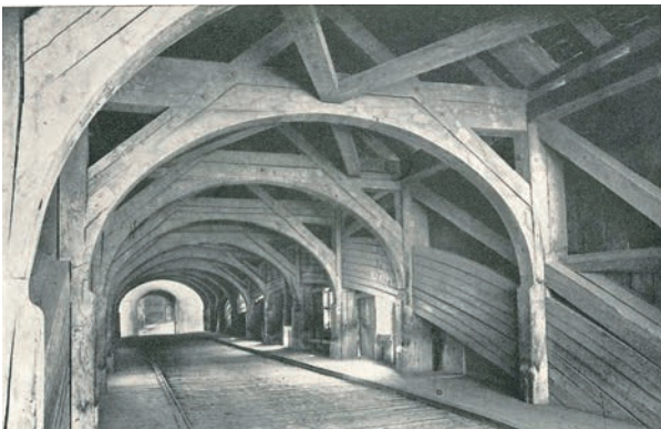
Abb. 42: Die Mellinger Reussbrücke kurz vor dem Abriss 1927 (BRUNNER 1925)
