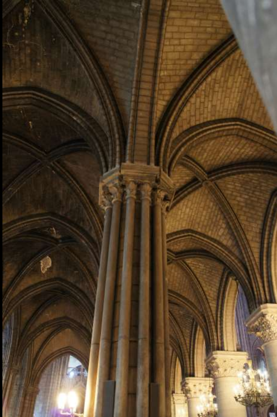
Paris, Kathedrale Notre-Dame, Gewölbe und Stützen im Seitenschiff
