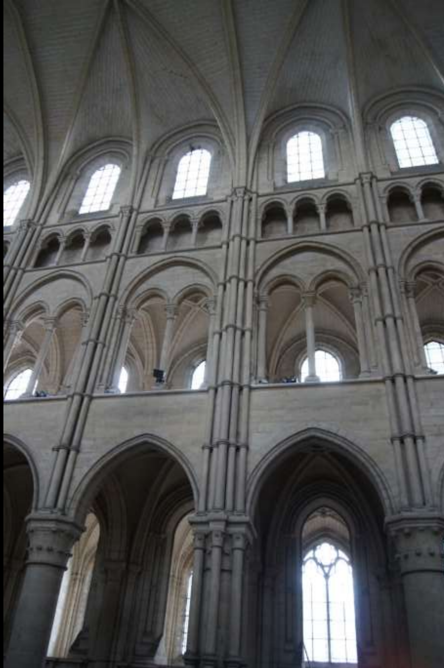
Laon, Kathedrale, differenziertes System der Stützen
