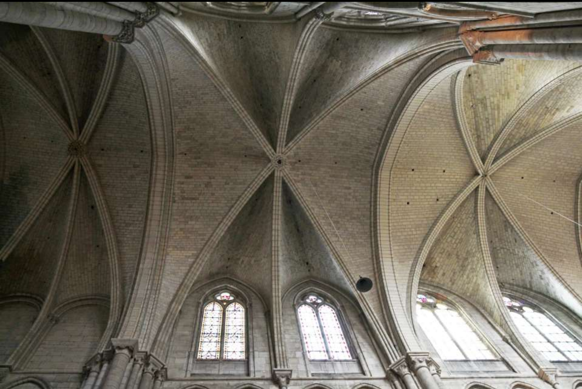
Sens, Kathedrale. Links ursprüngliches Joch des 12. Jh., Mitte und rechts im 13./14. Jh. vergrößerte Fenster
