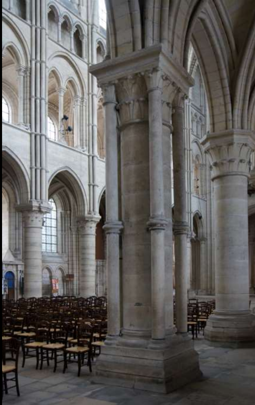
Laon, Kathedrale, Säule, umringt mit freistehenden Säulchen (en délit)
