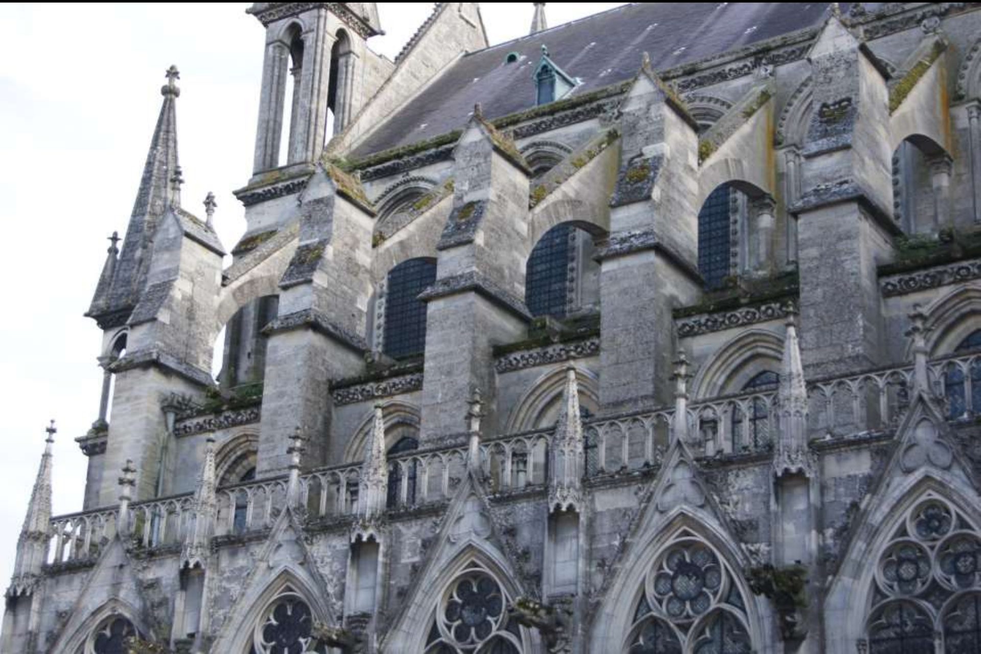
Laon, Kathedrale, Strebesystem am Chor (1. H. 13. Jh.). Alle Strebepfeiler und Strebebögen im 19. Jh. erneuert!
