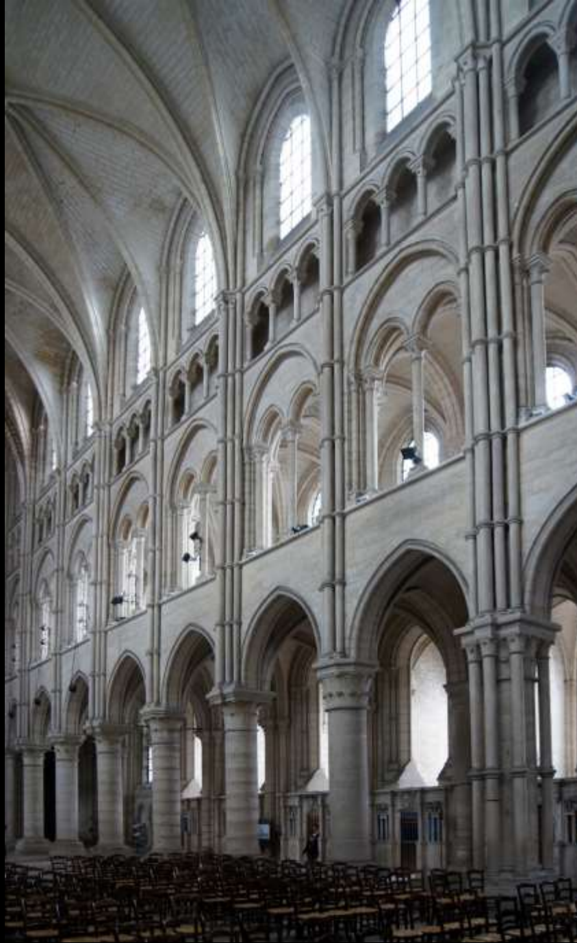
Laon, Kathedrale, vierzoniger Wandaufbau, Belichtung durch Emporen
