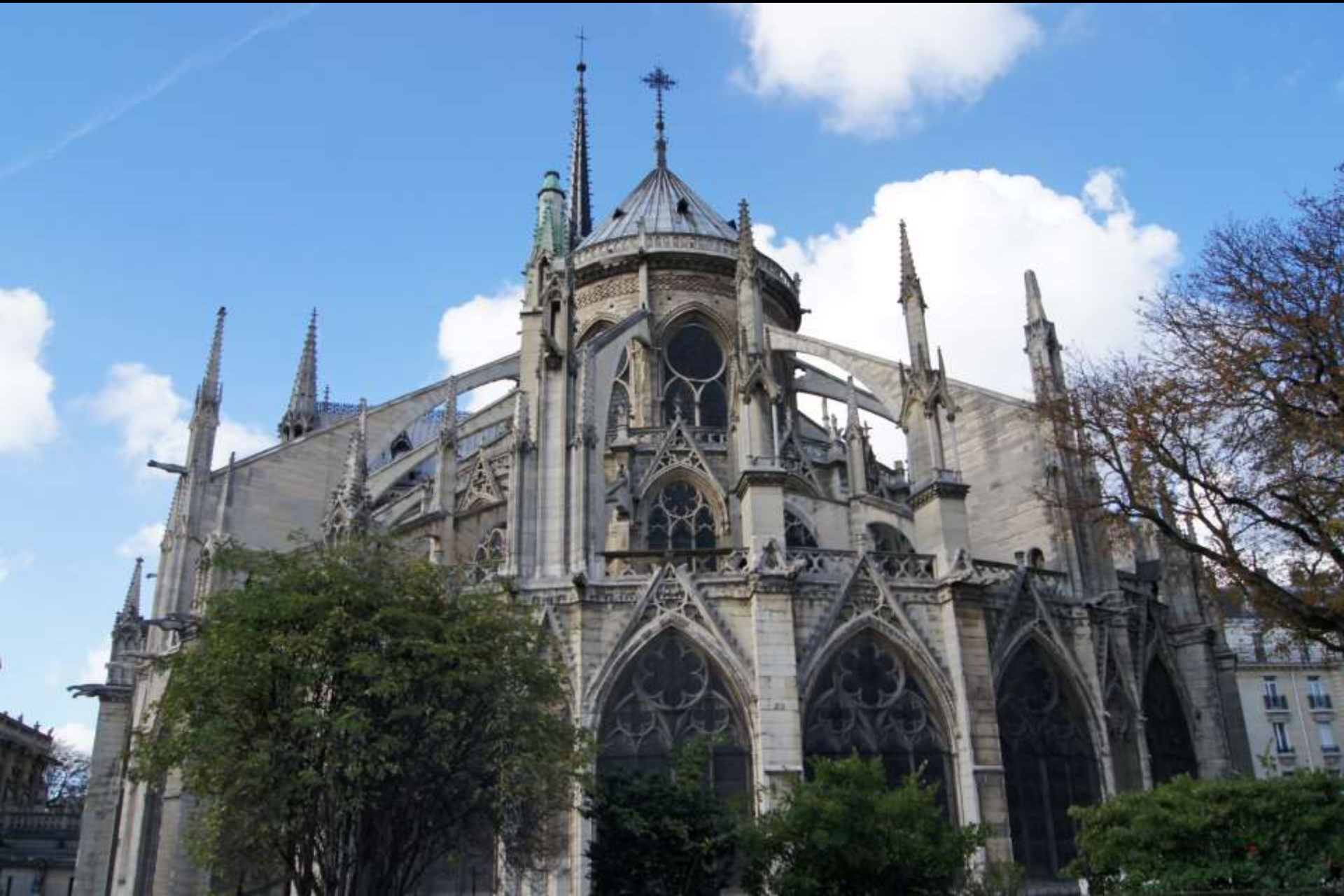
Paris, Kathedrale Notre-Dame, Ostansicht, Strebewerk im 14. und 19. Jh. erneuert
