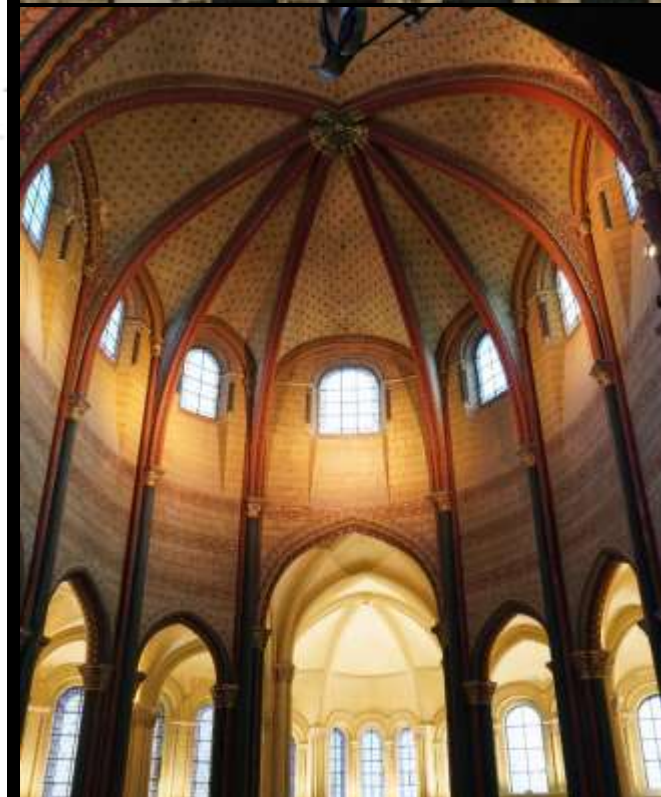
Paris, Saint-Martin-des-Champs. Stützung des Apsisgewölbes durch „radiale“ Strebemauern unter dem Dach
