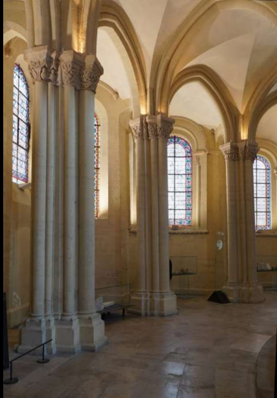
Paris, Saint-Martin-des-Champs, ab 1130. Gegliederte Stützen und Gratgewölbe im Umgang
