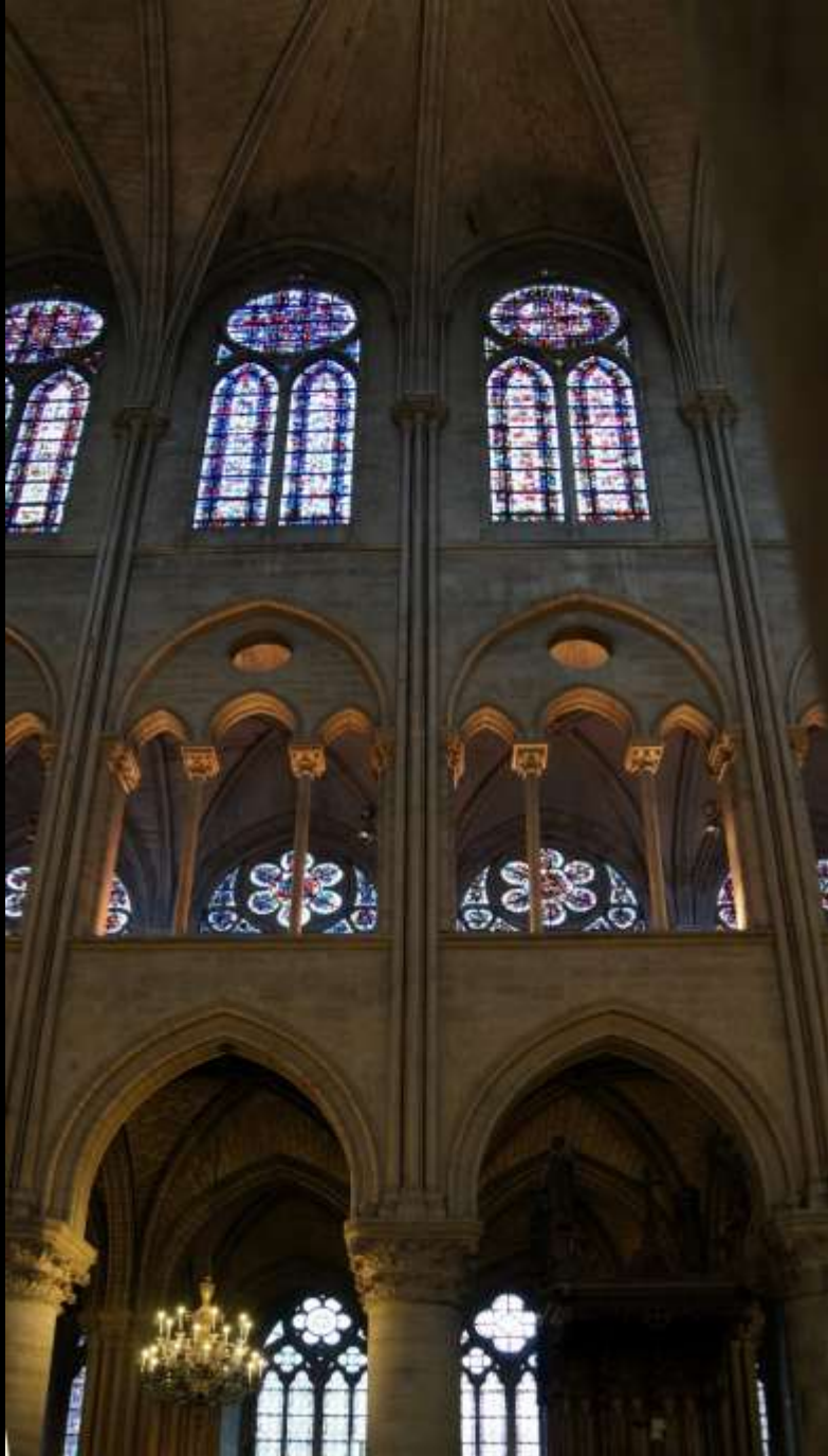
Paris, Kathedrale Notre-Dame, heutiger und von Viollet-le-Duc rekonstruierter ursprünglicher Wandaufbau
