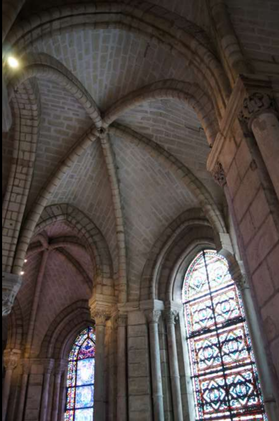
Saint-Denis, Chorumgang, Stützung der Gewölberippen durch monolithische Wandsäulchen („Dienste“)
