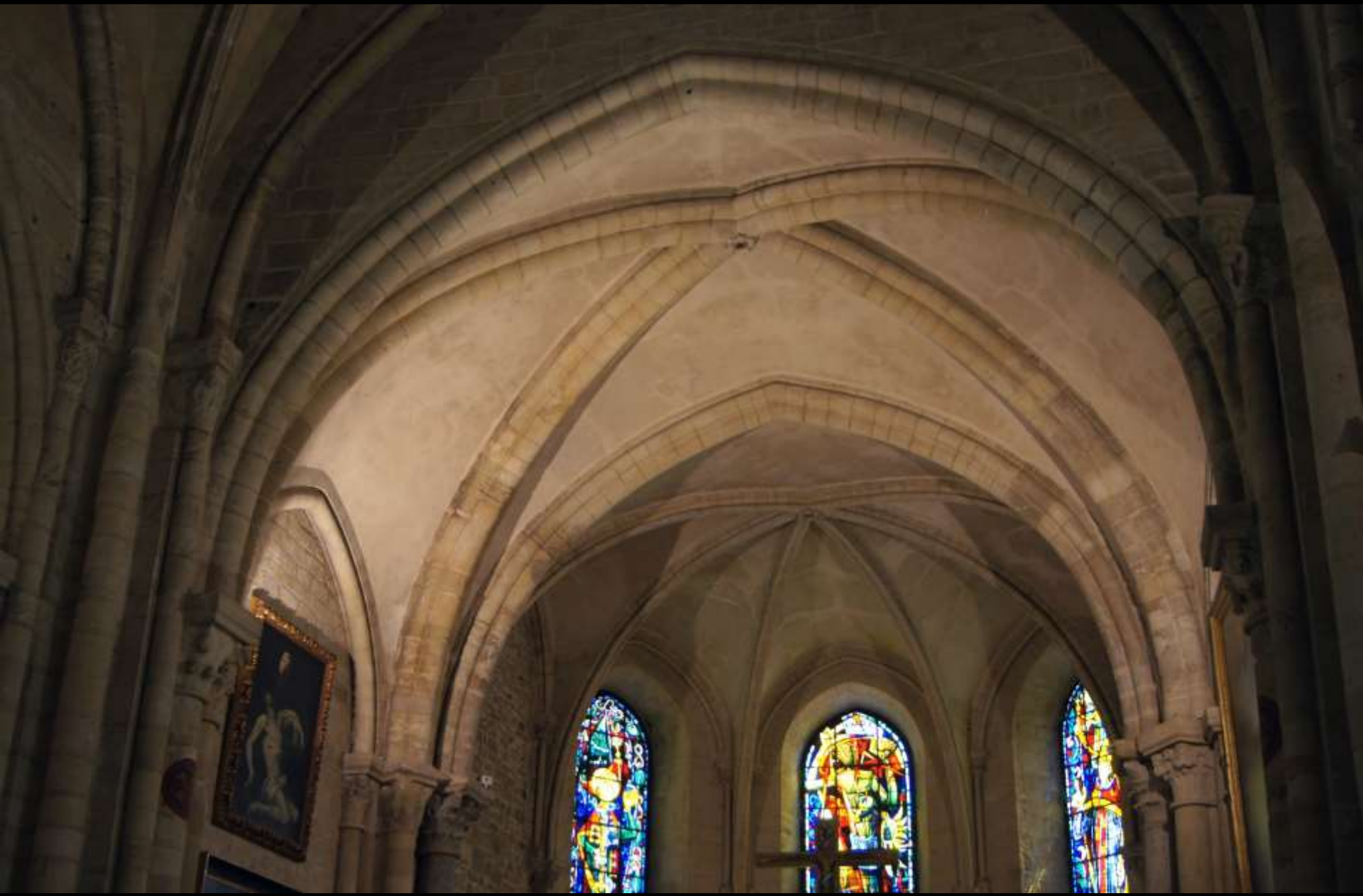
Paris, Abteikirche Saint-Pierre-de-Montmartre, Chor. Rippengewölbe mit Rippen aus kurzen Keilsteinen, ab 1135.
