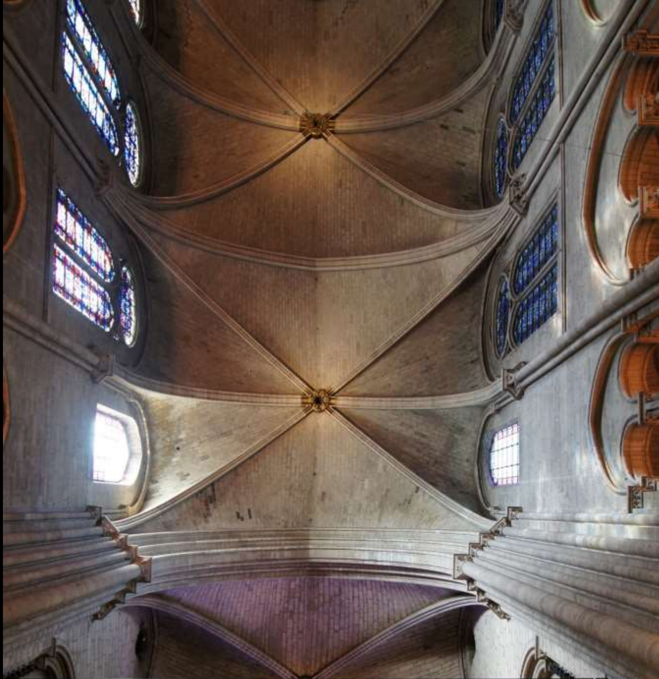
Paris, Kathedrale Notre-Dame, sechsteilige Gewölbe aus Werkstein im Mittelschiff
