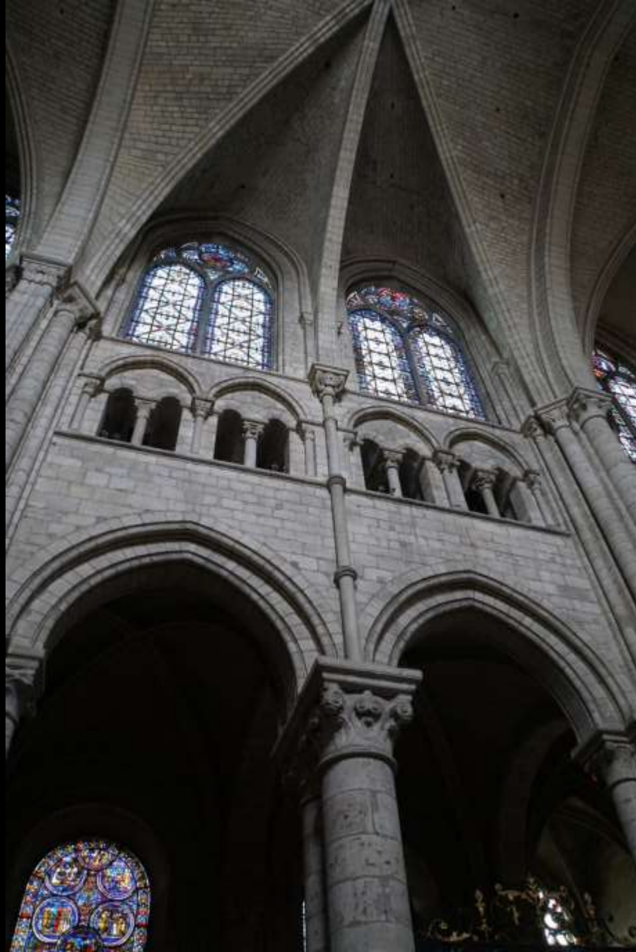
Sens, Kathedrale. Mittelschiffsgewölbe und Stützen.
