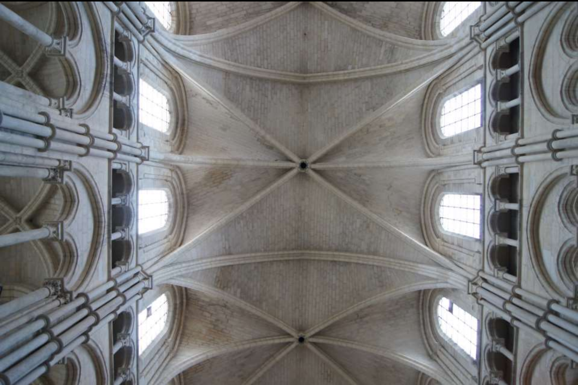
Laon, Kathedrale, sechsteiliges Gewölbe mit Werksteinkappen
