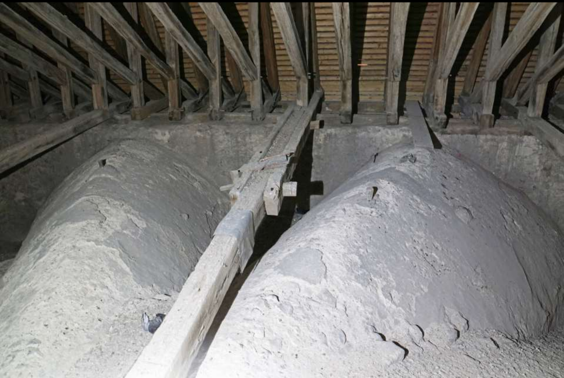
Sens, sechsteiliges Gewölbe von oben
