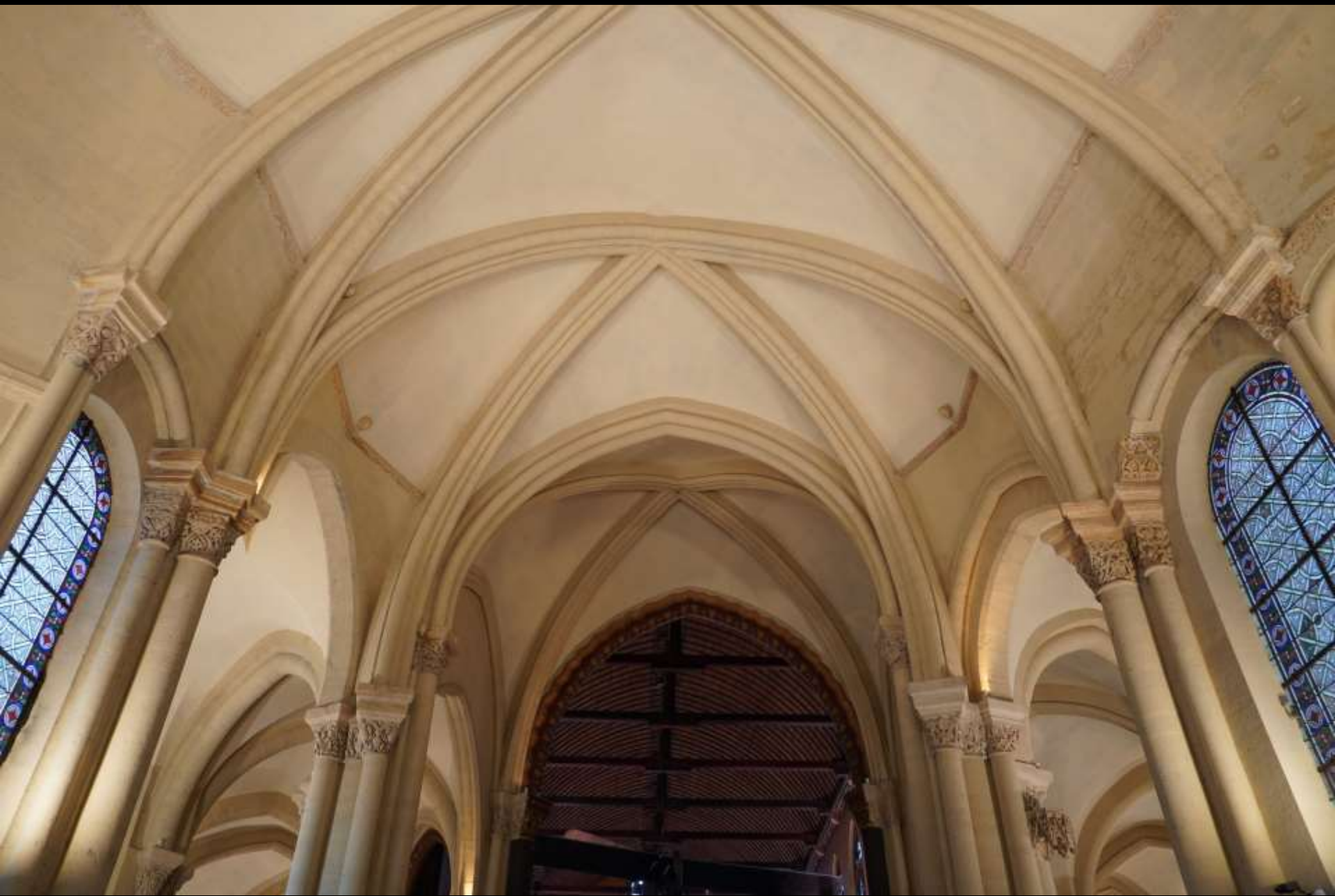
Paris, Saint-Martin-des-Champs, ab 1130. Rippengewölbe in der Hauptachse
