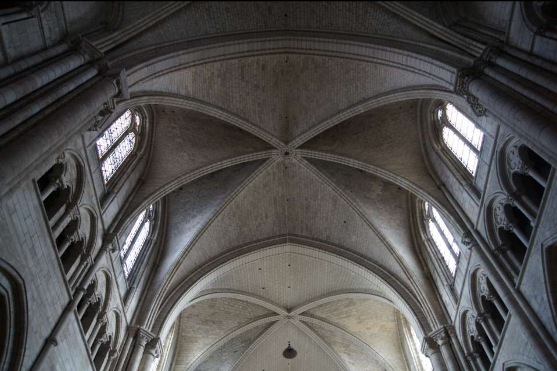
Sens, Kathedrale. Sechsteilige Gewölbe
