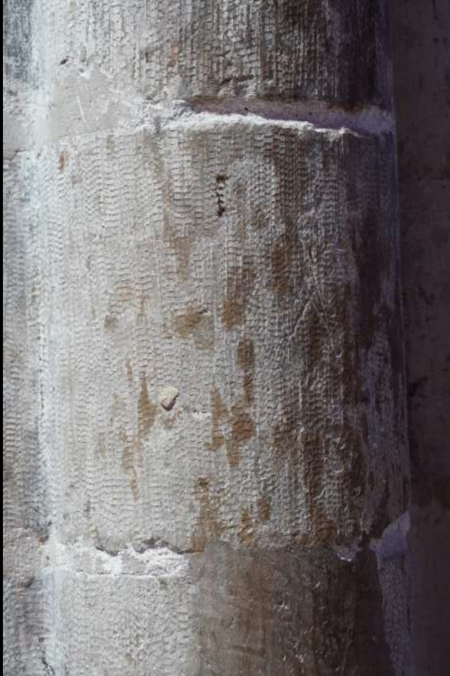
Bourges, Kathedrale, Steinbearbeitung mit Zahnfläche („bretture“)
