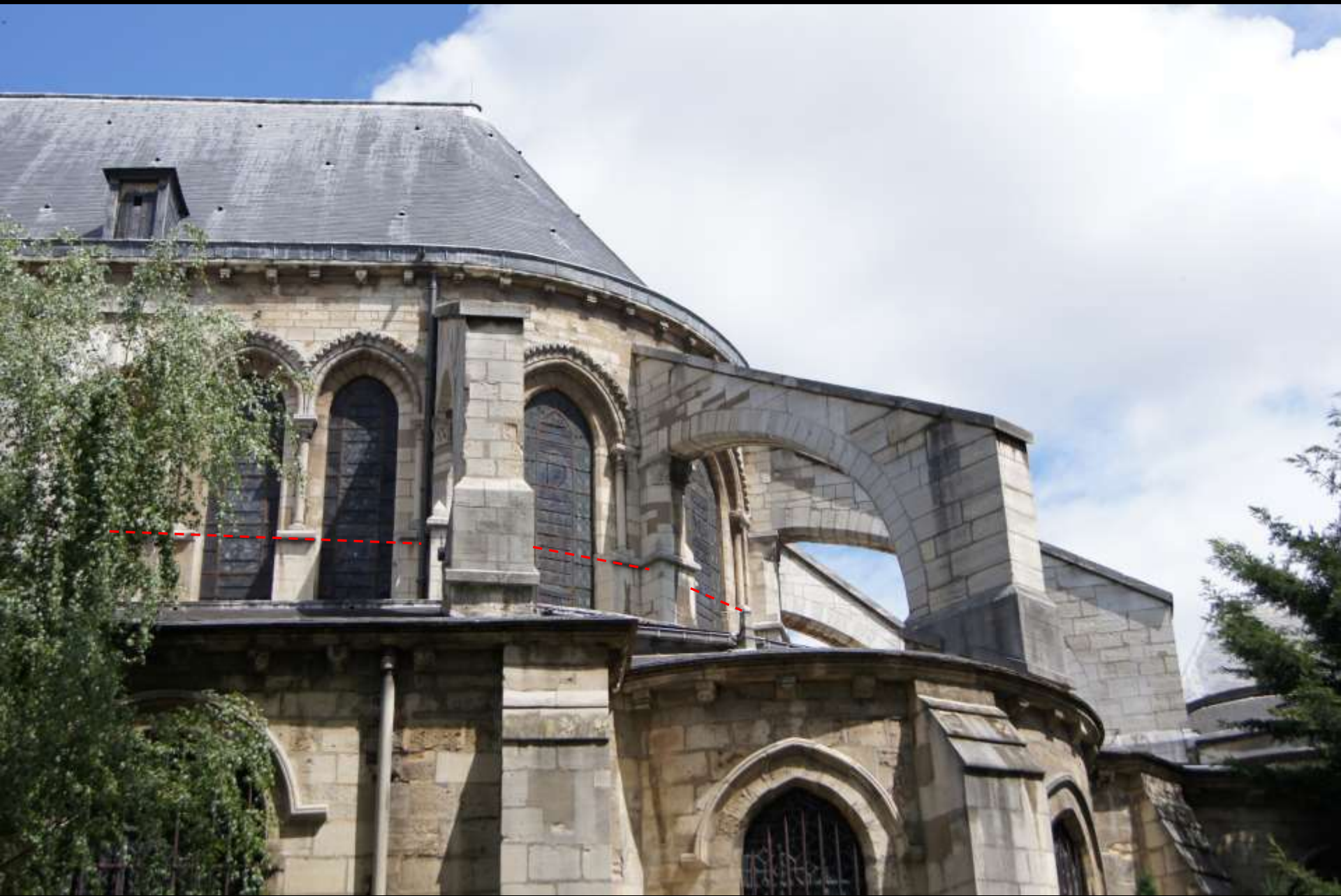
Paris, Saint-Germain-des-Prés, ab 1145. Aussenansicht und ursprünglicher Dachanschlag
