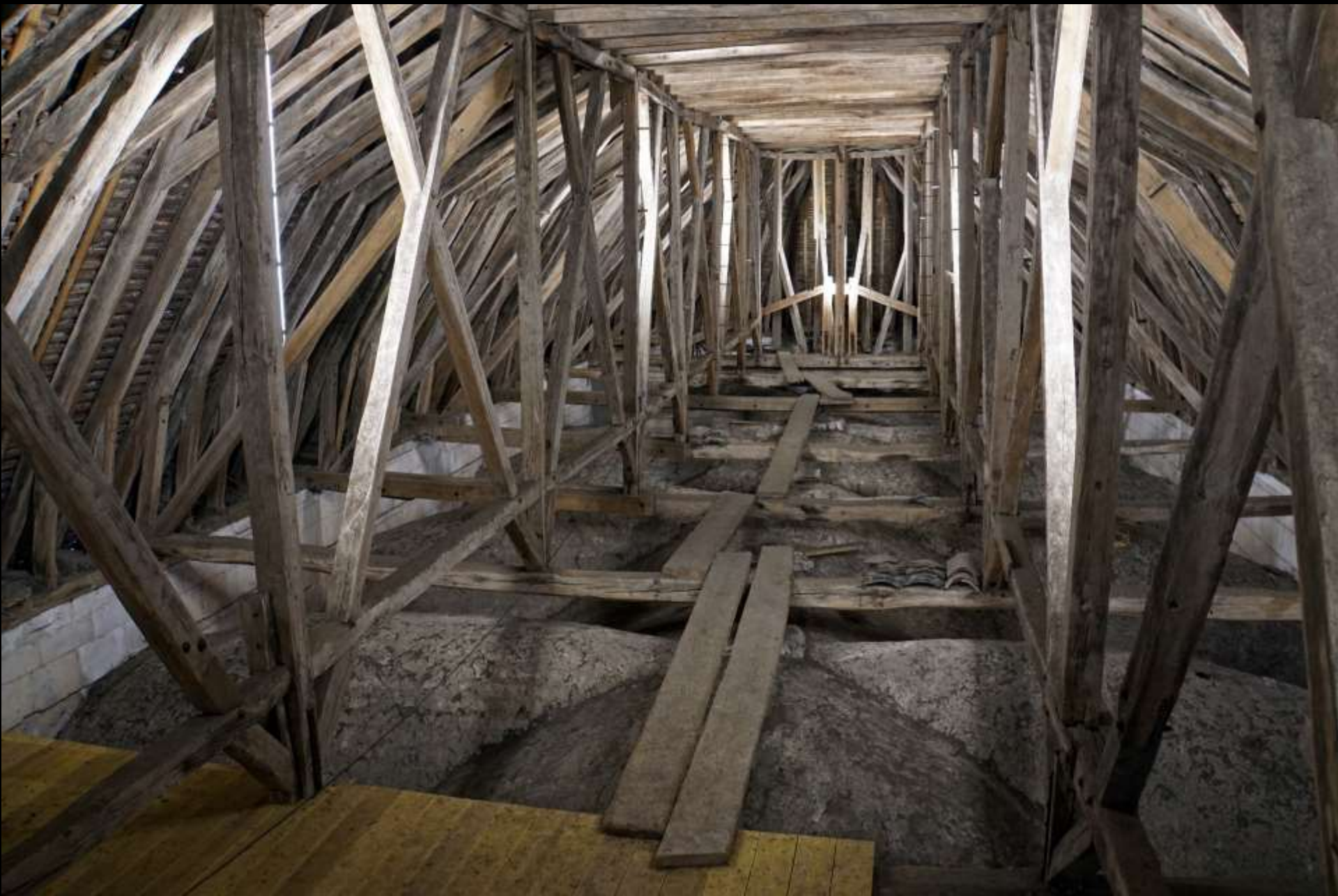
Auxerre, Kathedrale, Dachwerk über dem Chor (1236d)
