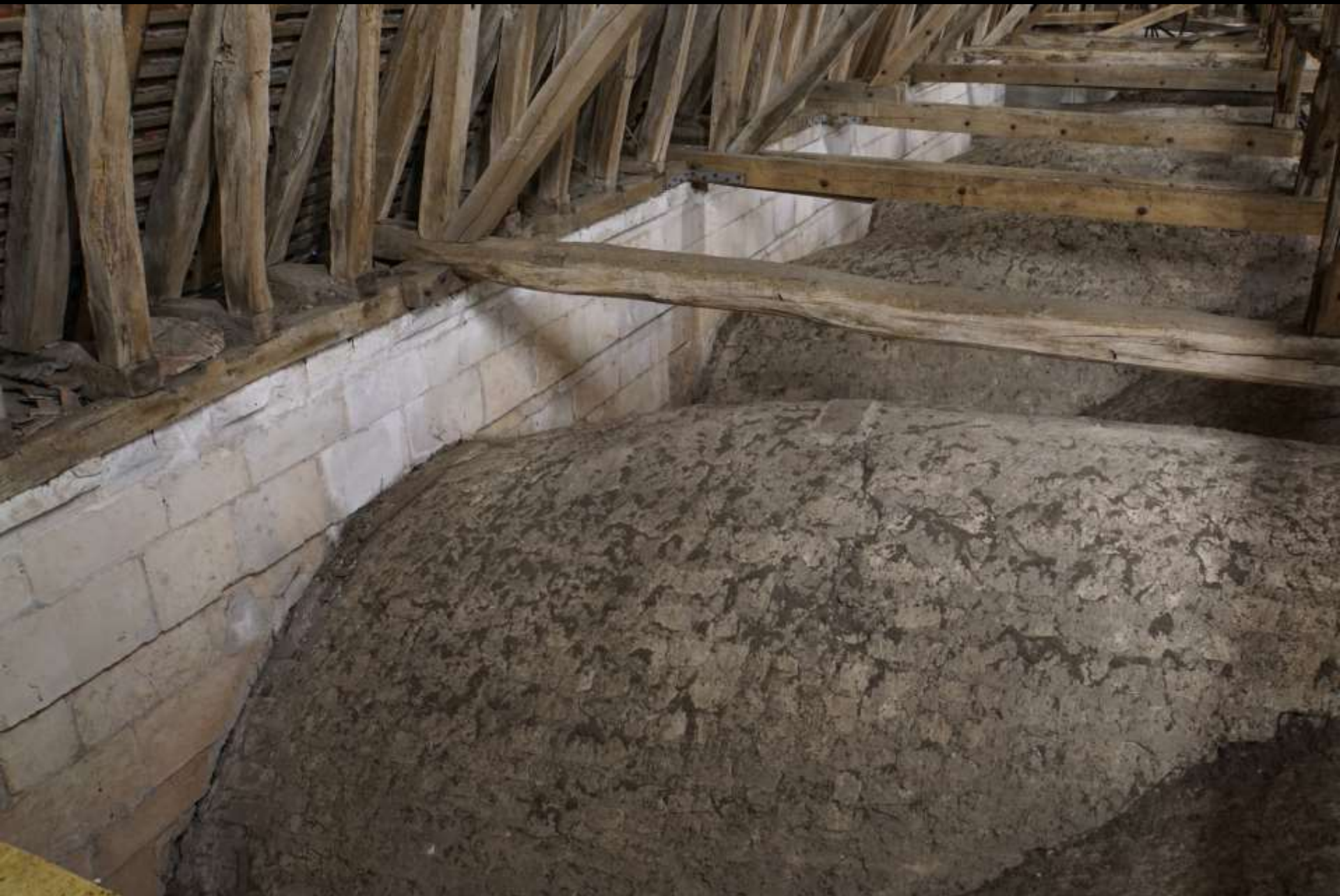
Auxerre, Kathedrale, Chorgewölbe von oben
