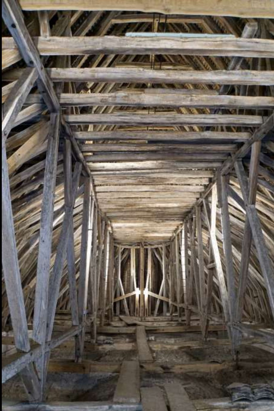
Auxerre, Kathedrale, Dachwerk über dem Chor (1236d)
