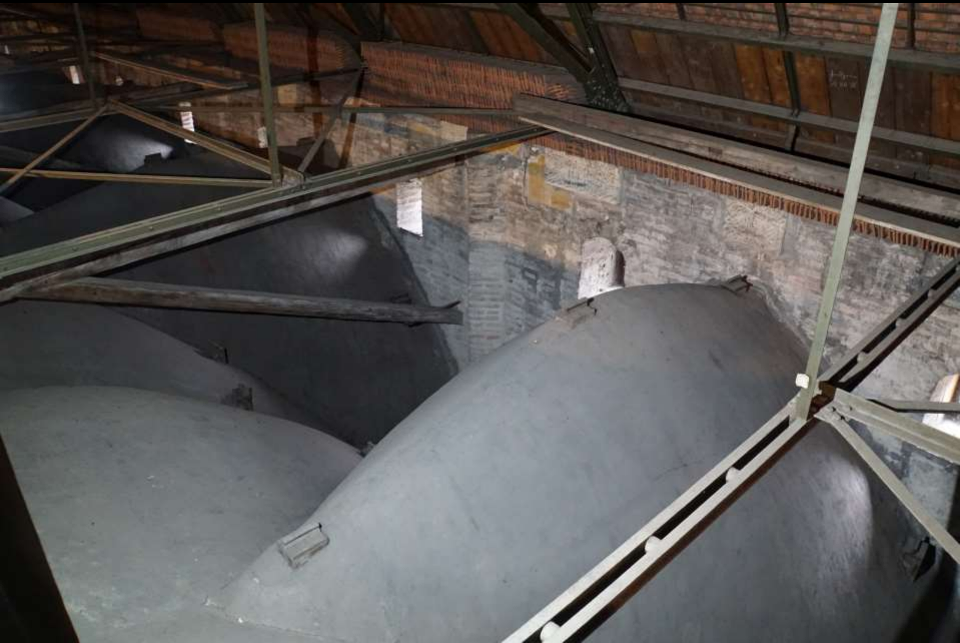
Ulm, Münster, gebuste (doppelt gekrümmte) Gewölbekappen des Langhaus-Mittelschiffs (um 1500)
