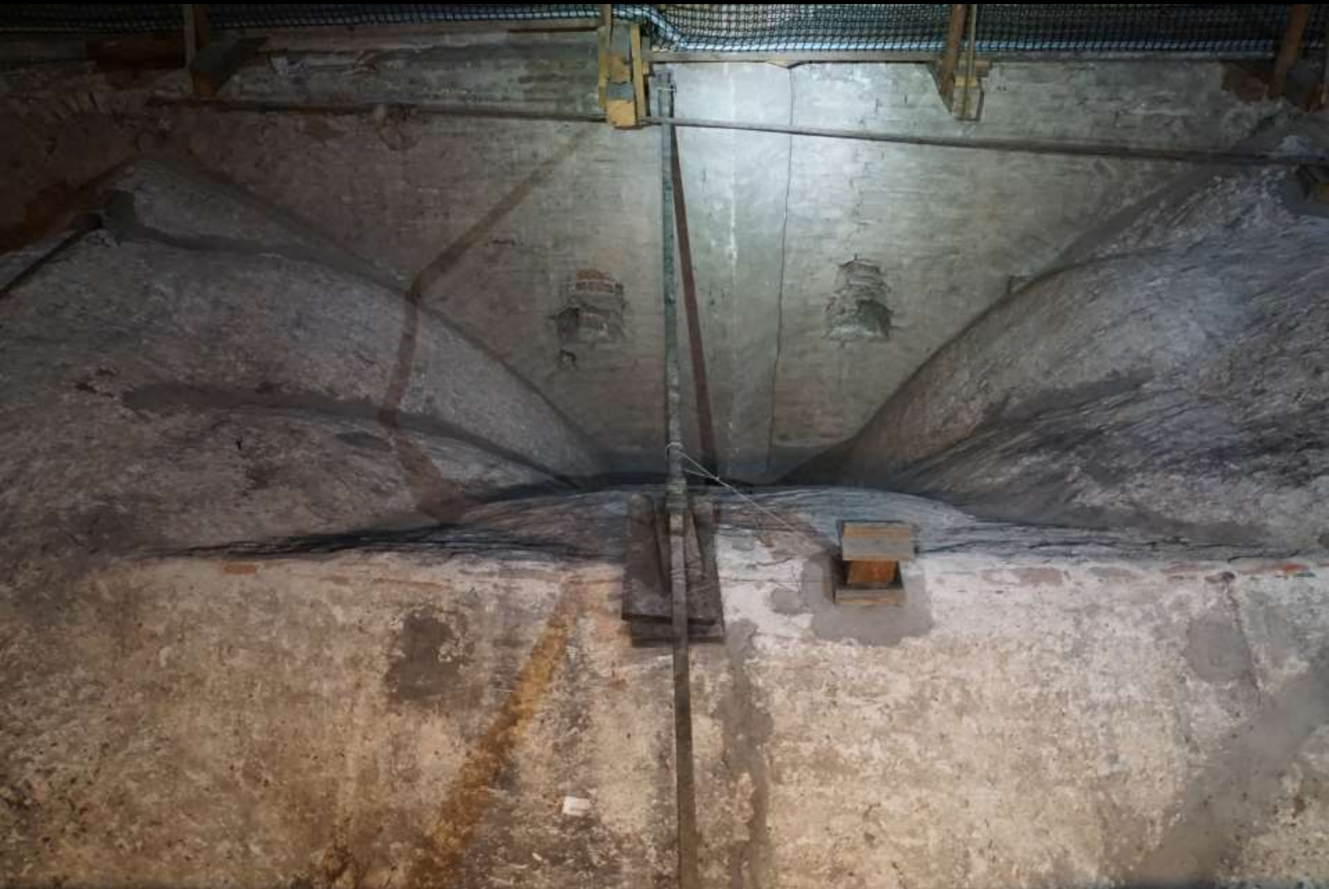
Ulm, Münster, Gewölbe der Seitenschiffe (Anf. 16. Jh.). Wohl freihändig gewölbte Kappen.
