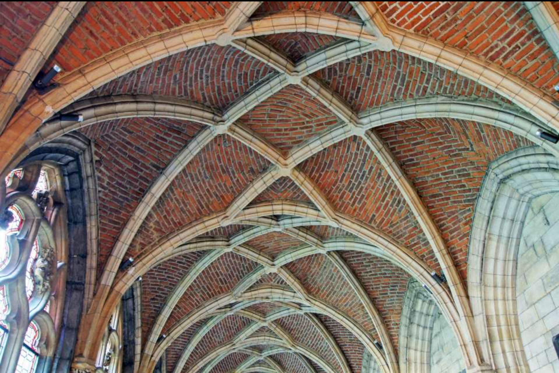
Lüttich, Saint-Paul, Kreuzgang (15. Jh.). Schwalbenschwanzverband des Kappenmauerwerks.
