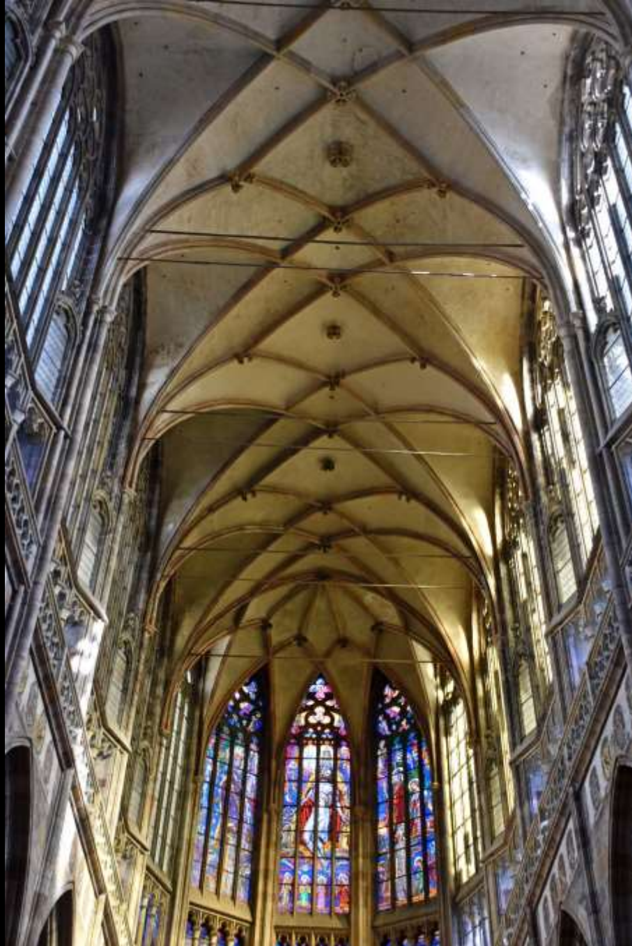
Prag, Veitsdom, Chor, Parallelrippengewölbe (2. H. 14. Jh.; Foto: Martina Diaz)
