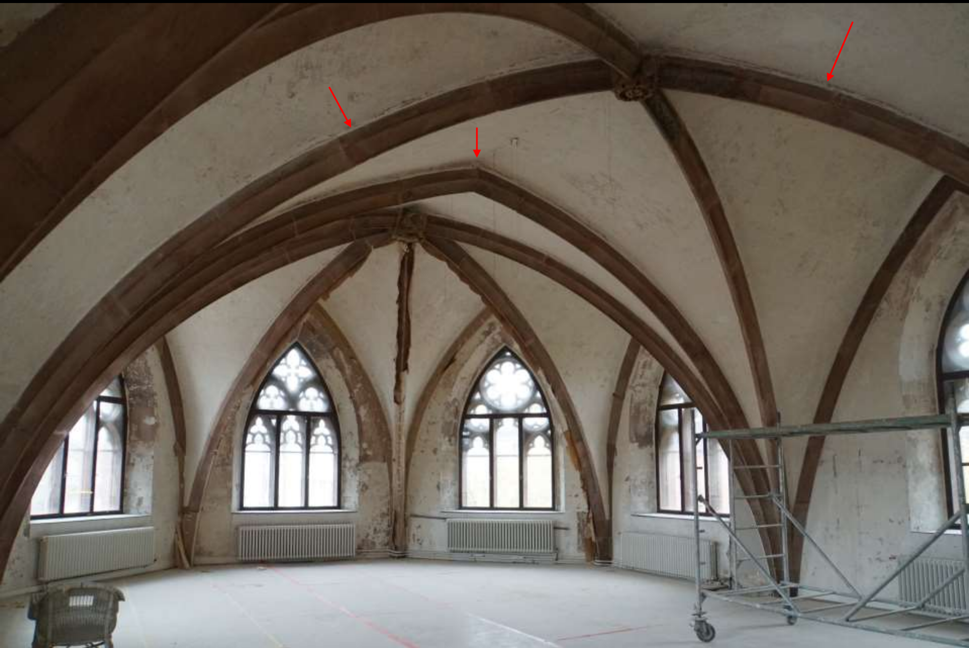
Rippen als Schalungsträger (Basel, ehem. Bettelordernskirche Grosses Klingental, um 1290)
