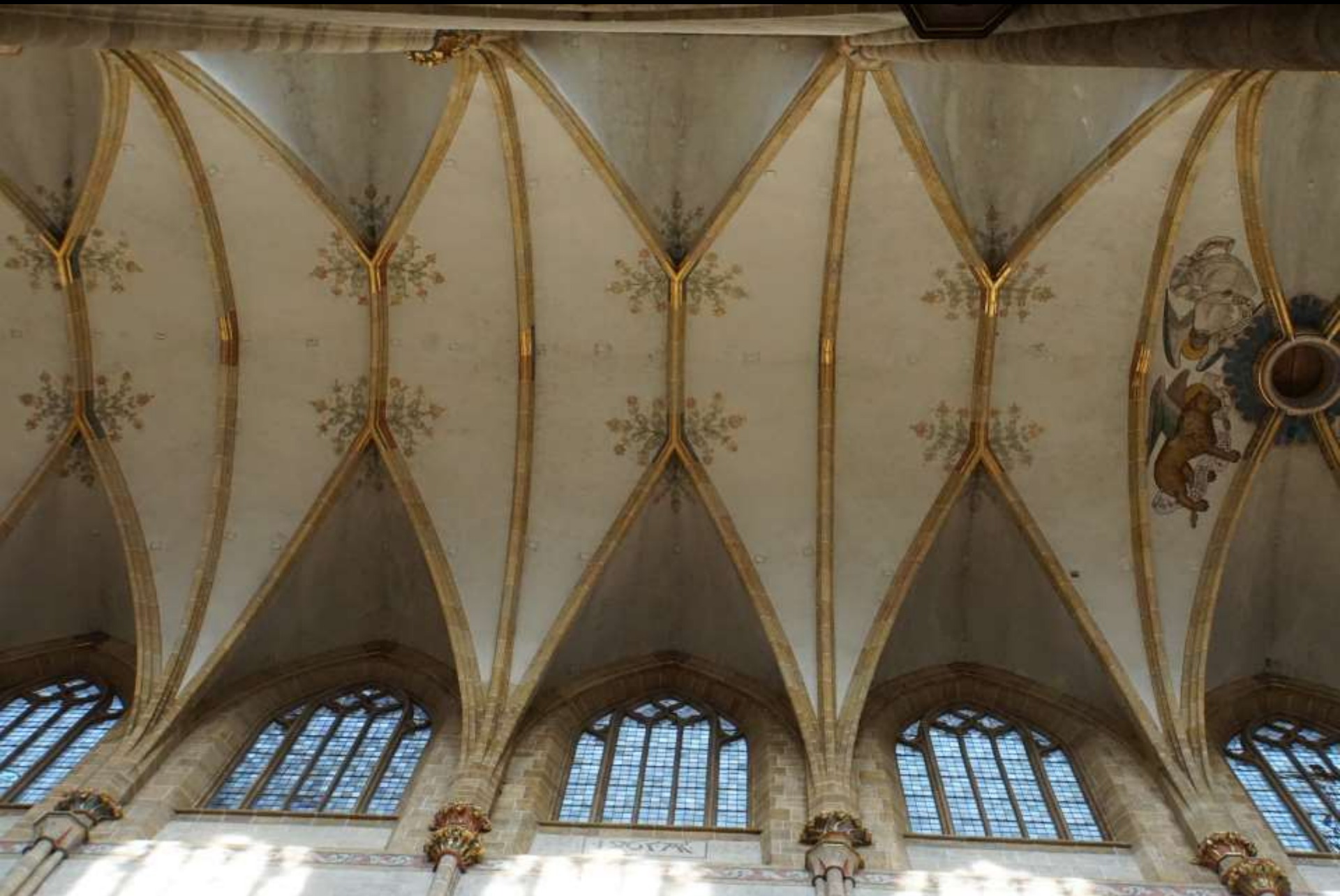
Ulm, Münster, Gewölbe des Langhaus-Mittelschiffs (um 1500)
