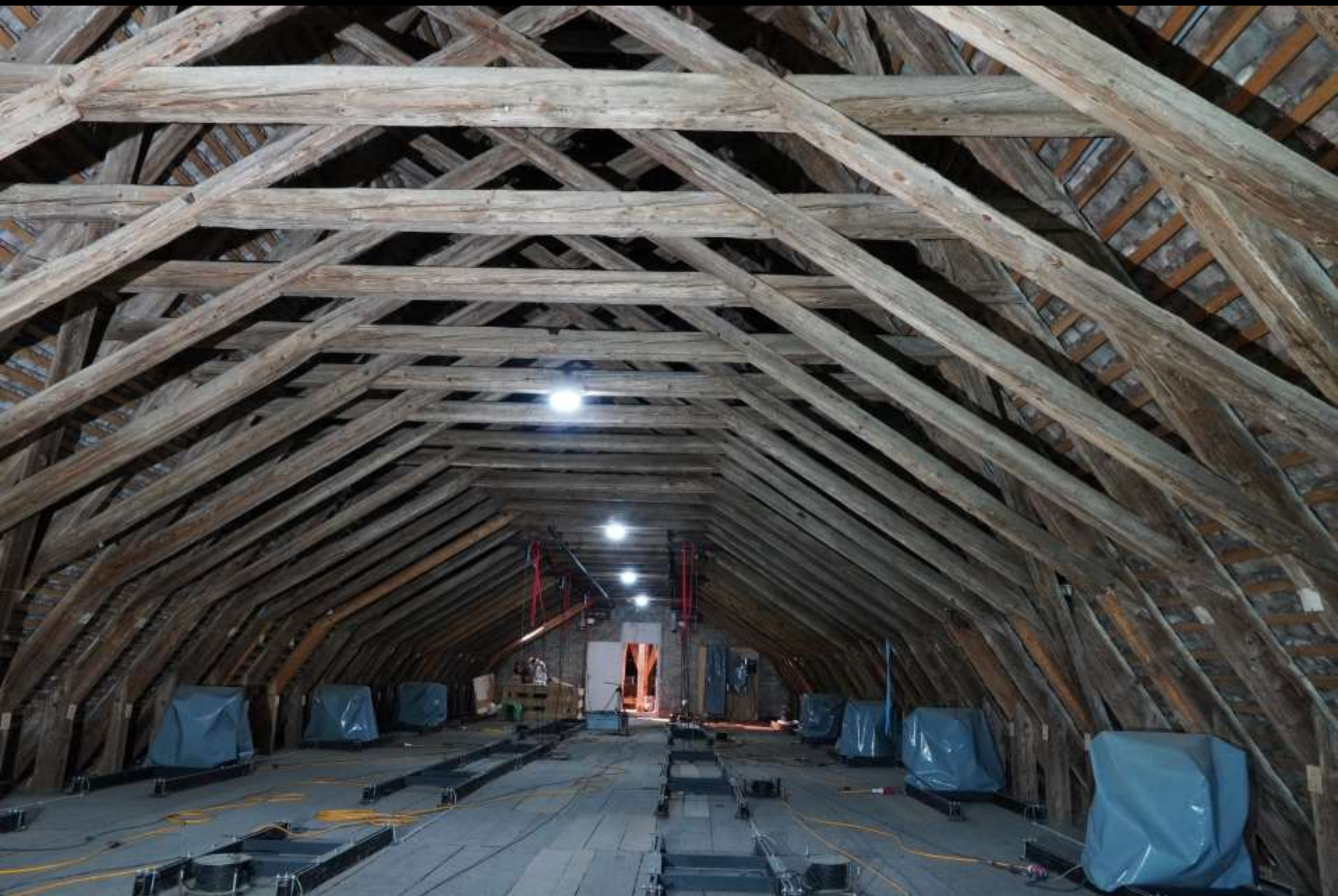
Königsfelden (AG), ehem. Franziskanerklosterkirche (1310–30), Dachwerk
