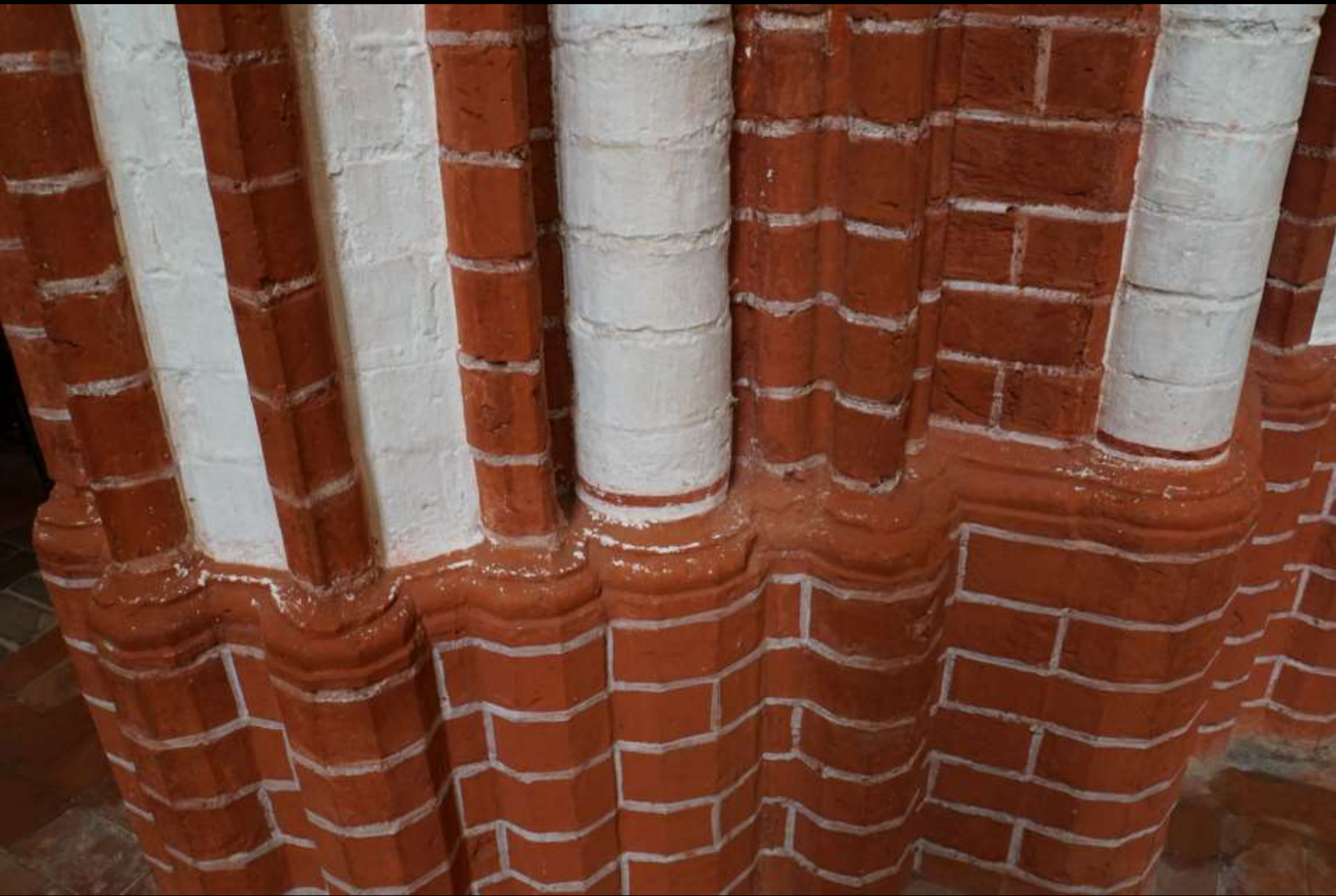
Doberan, Abteikirche (um 1300). Konstruktion der Bündelpfeiler
