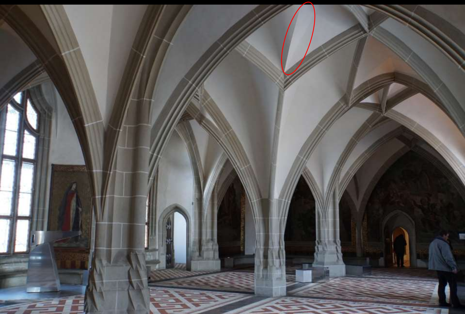
Meissen, Albrechtsburg. Gewölbegrat ohne Rippe (2. H. 15. Jh.)
