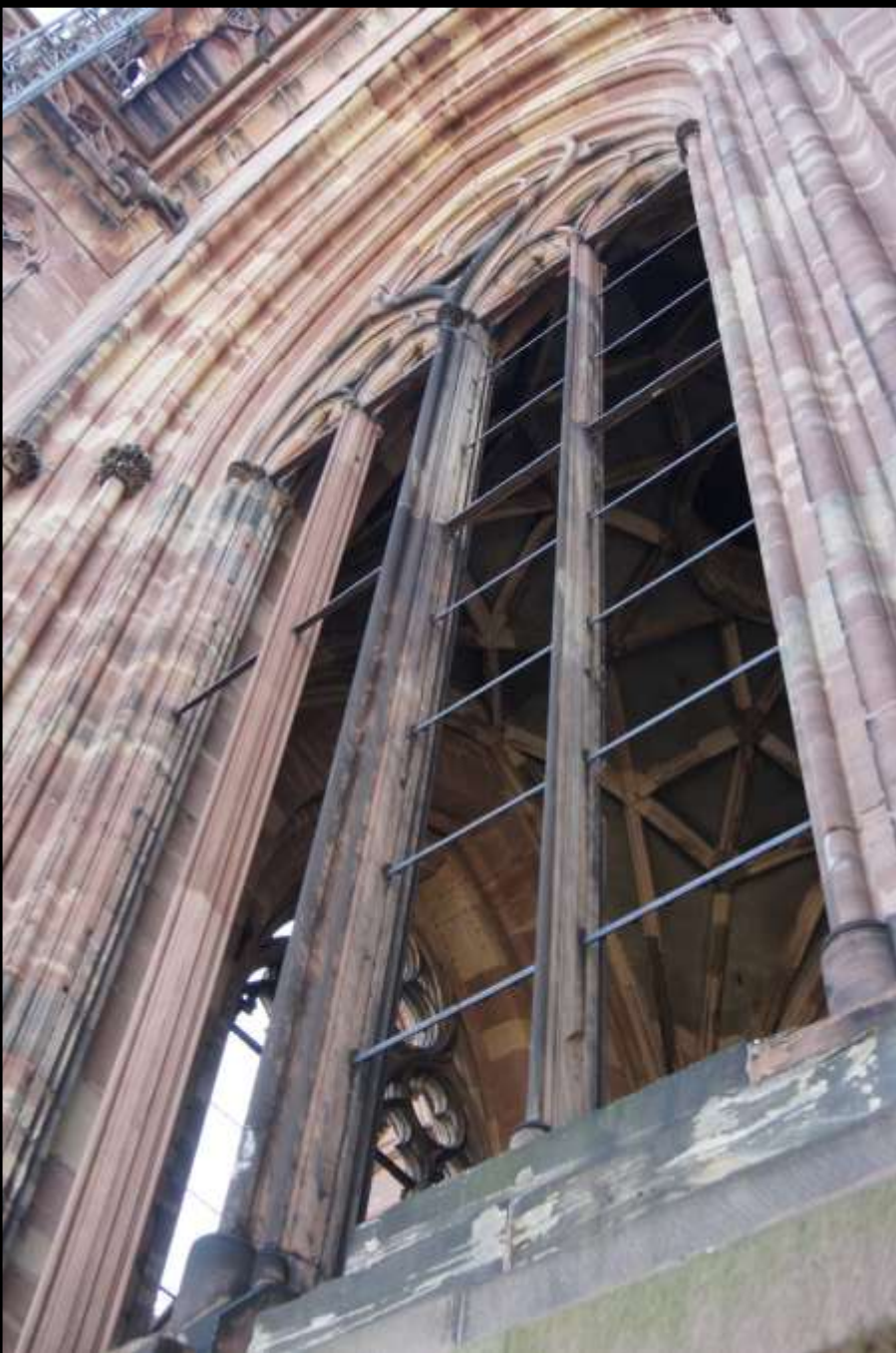
Strassburg, Münster, Westfassade (1275 – frühes 14. Jh.). Eiserne Konstruktionselemente
