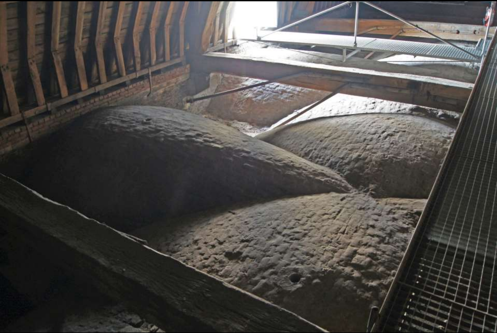
Brüssel, Notre Dame du Sablon (15. Jh.). Gebuste Kreuzrippengewölbe aus Backstein
