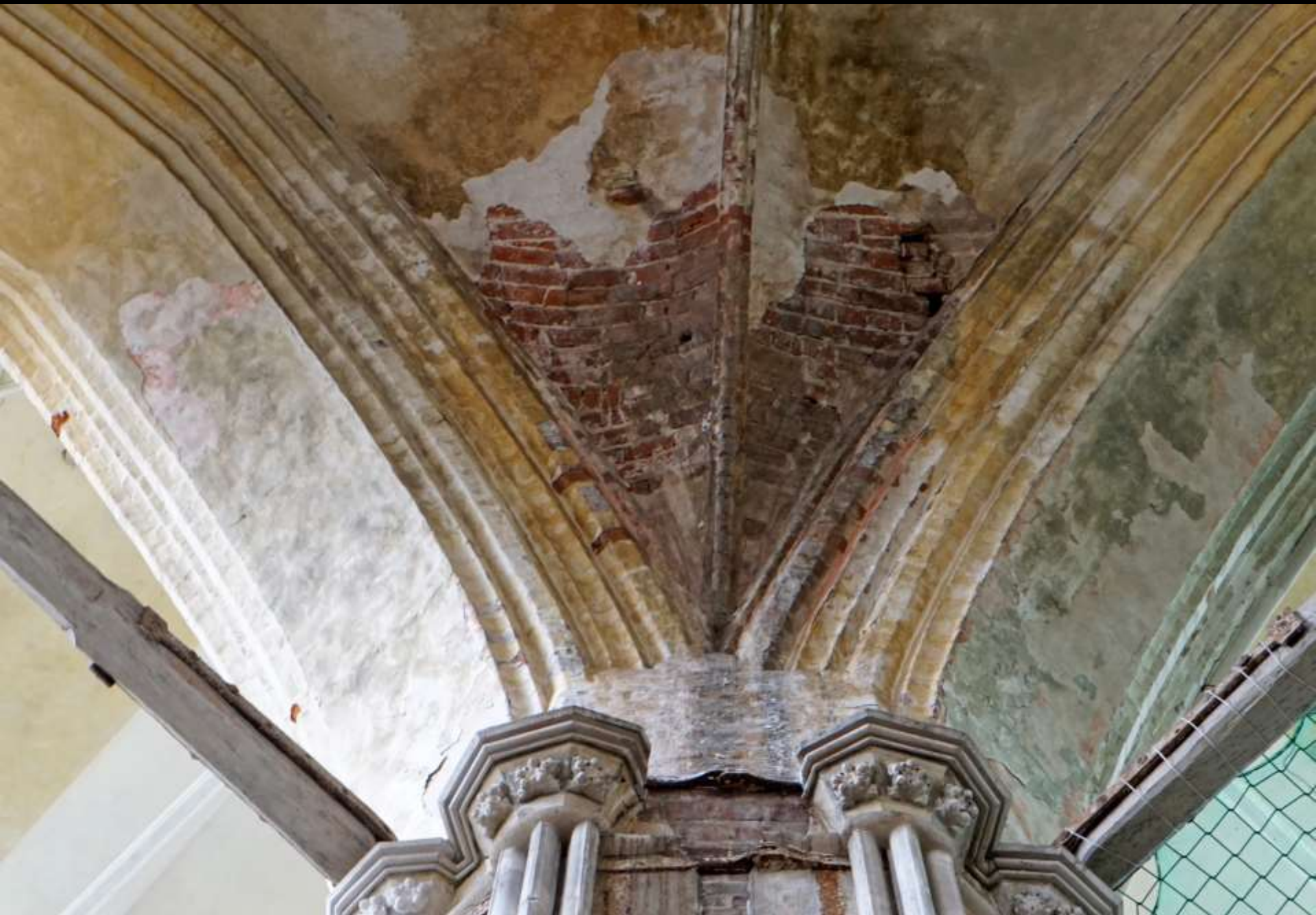
Stralsund, Marienkirche (1. H. 15. Jh.), Backsteingewölbe mit minimalen Rippen
