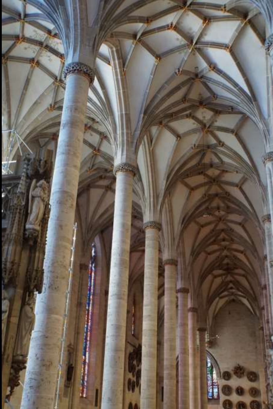
Ulm, Münster, Rautensterngewölbe der Seitenschiffe (Anf. 16. Jh.)
