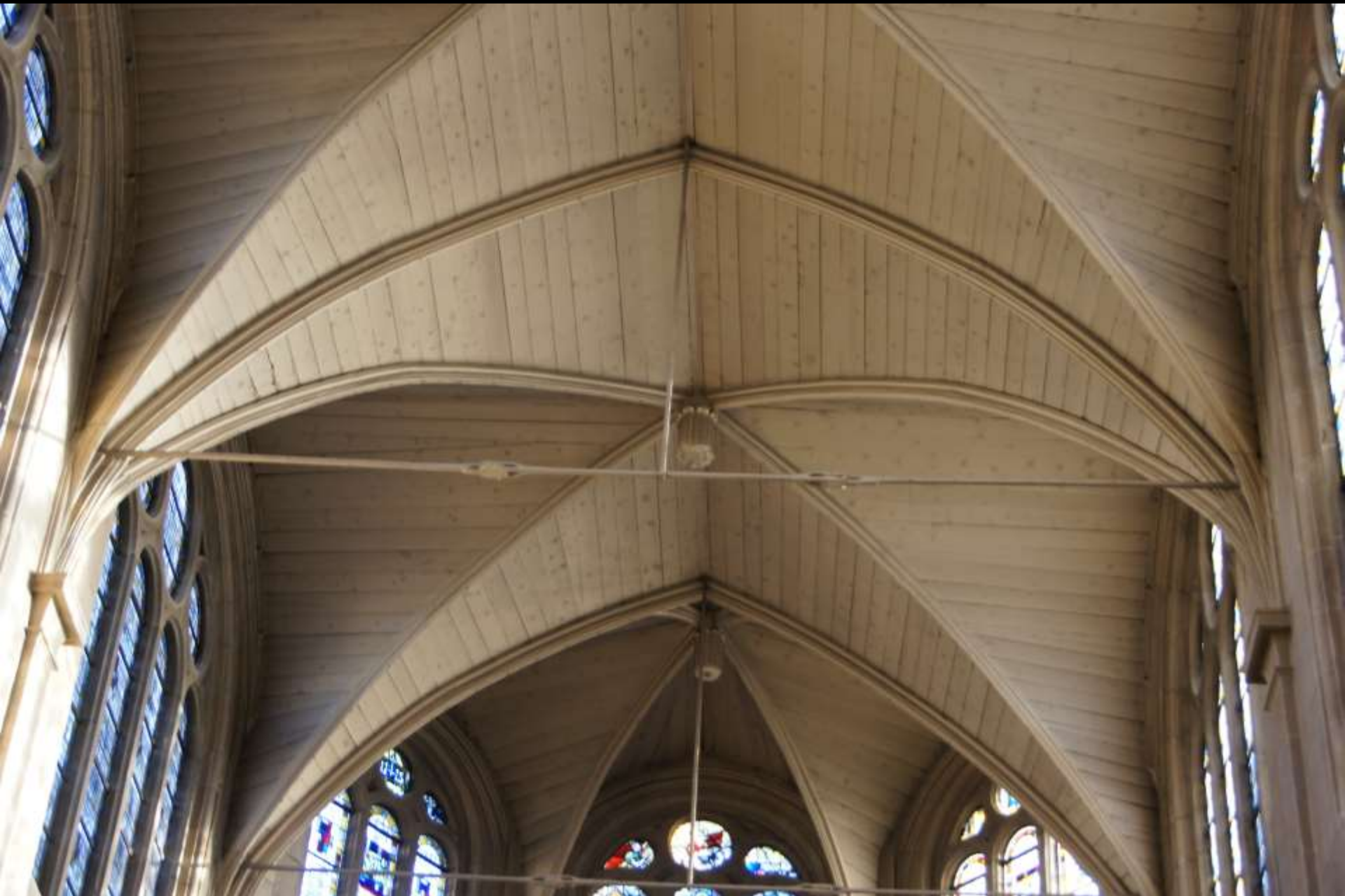
„Regelflächen“ eines Kreuzrippengewölbes, mit Holzbrettern verschalt (1622, Saint-Médard, Paris)
