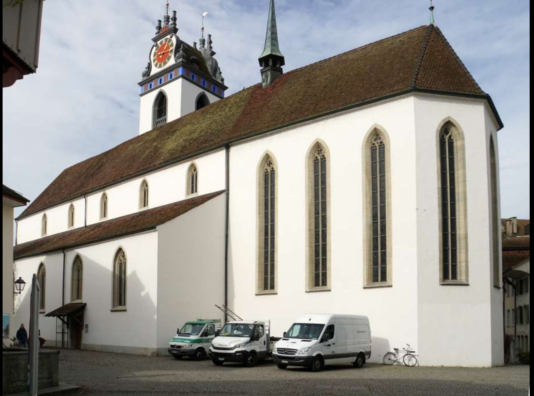
Stadtpfarrkirche Aarau, ein Echo der Bettelordensgotik
