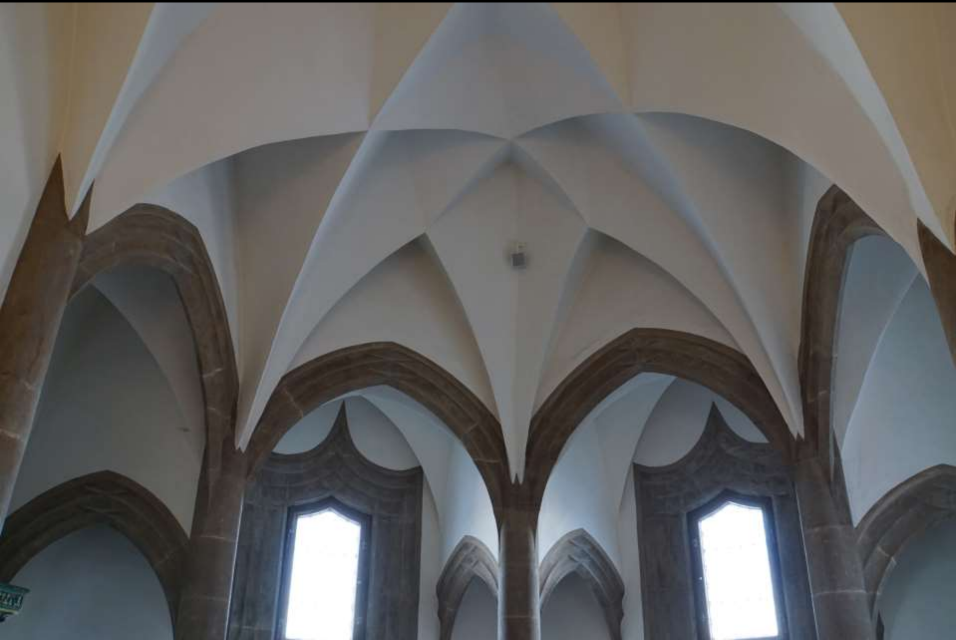
Meissen, Albrechtsburg. Zellengewölbe (2. H. 15. Jh.)
