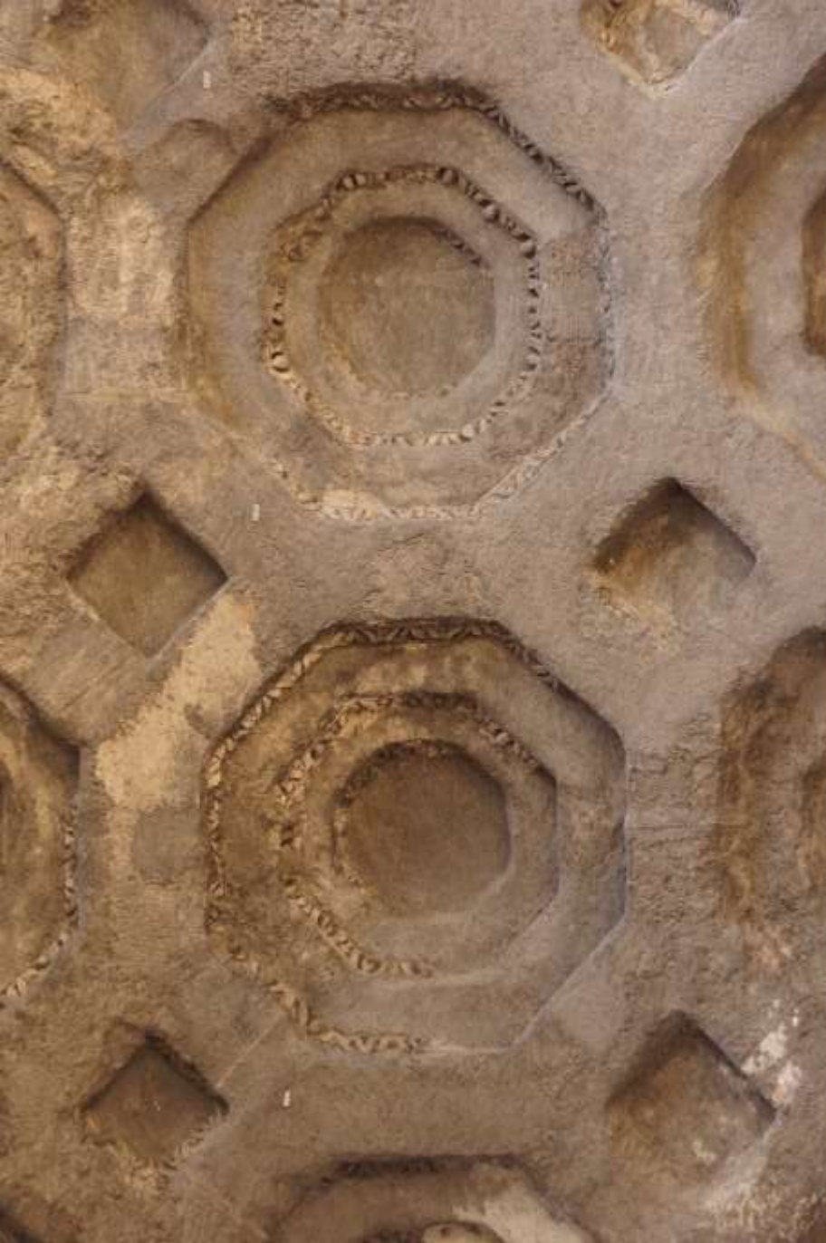
Kassetten an der Maxentiusbasilika und am Severusbogen: opus caementicium vs. Werkstein
