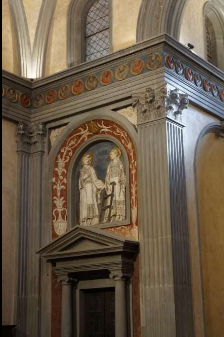
Florenz, San Lorenzo, Sagrestia Vecchia (Filippo Brunelleschi, ab 1421) Kontrast von Architekturgliederungen in pietra serena (Sandstein) und verputzten Wandflächen
