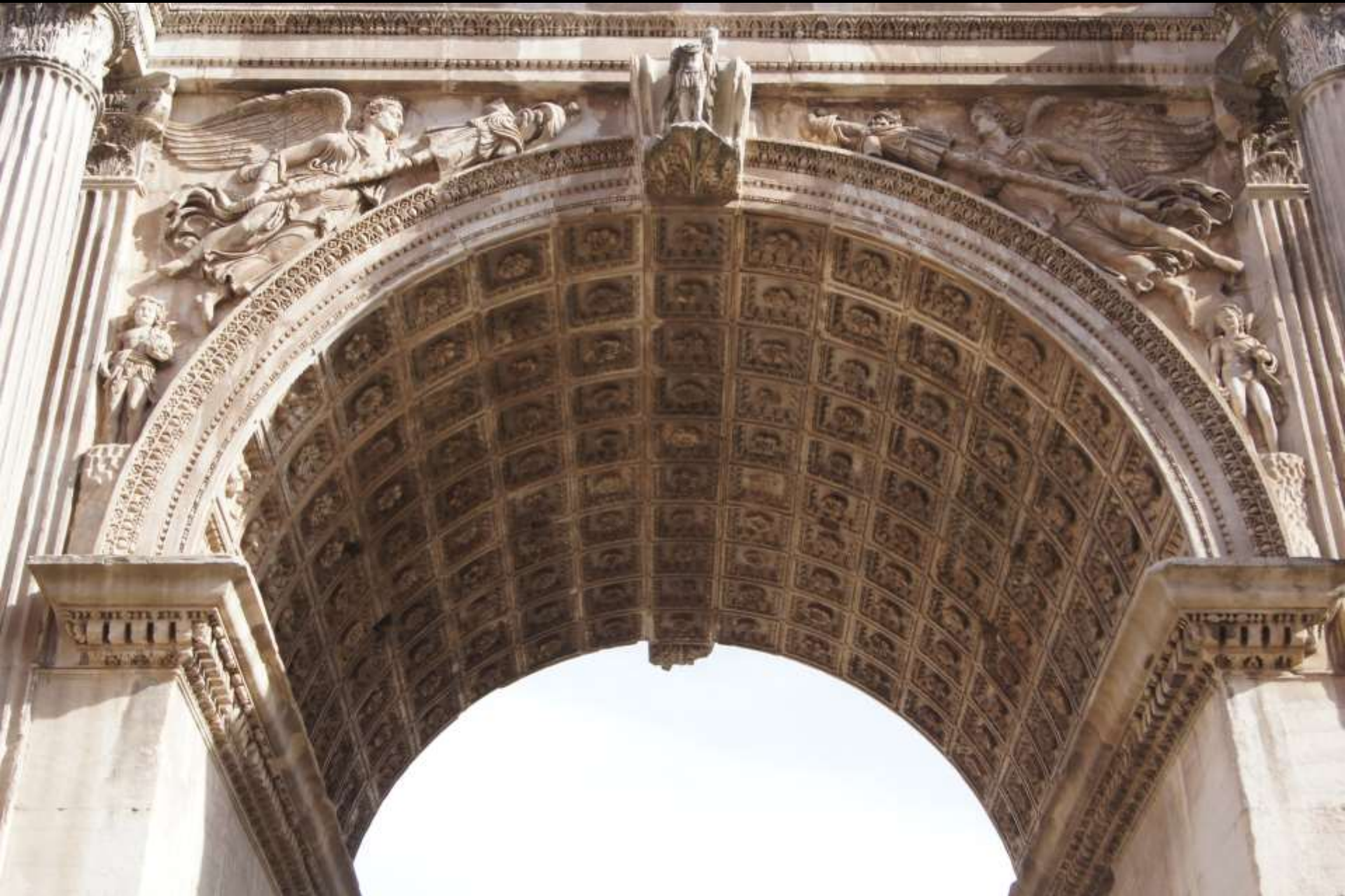
Rom, Triumphbogen des Septimius Severus: kassettierte Tonne (Steinmetzarbeit vom Gerüst aus ausgeführt)
