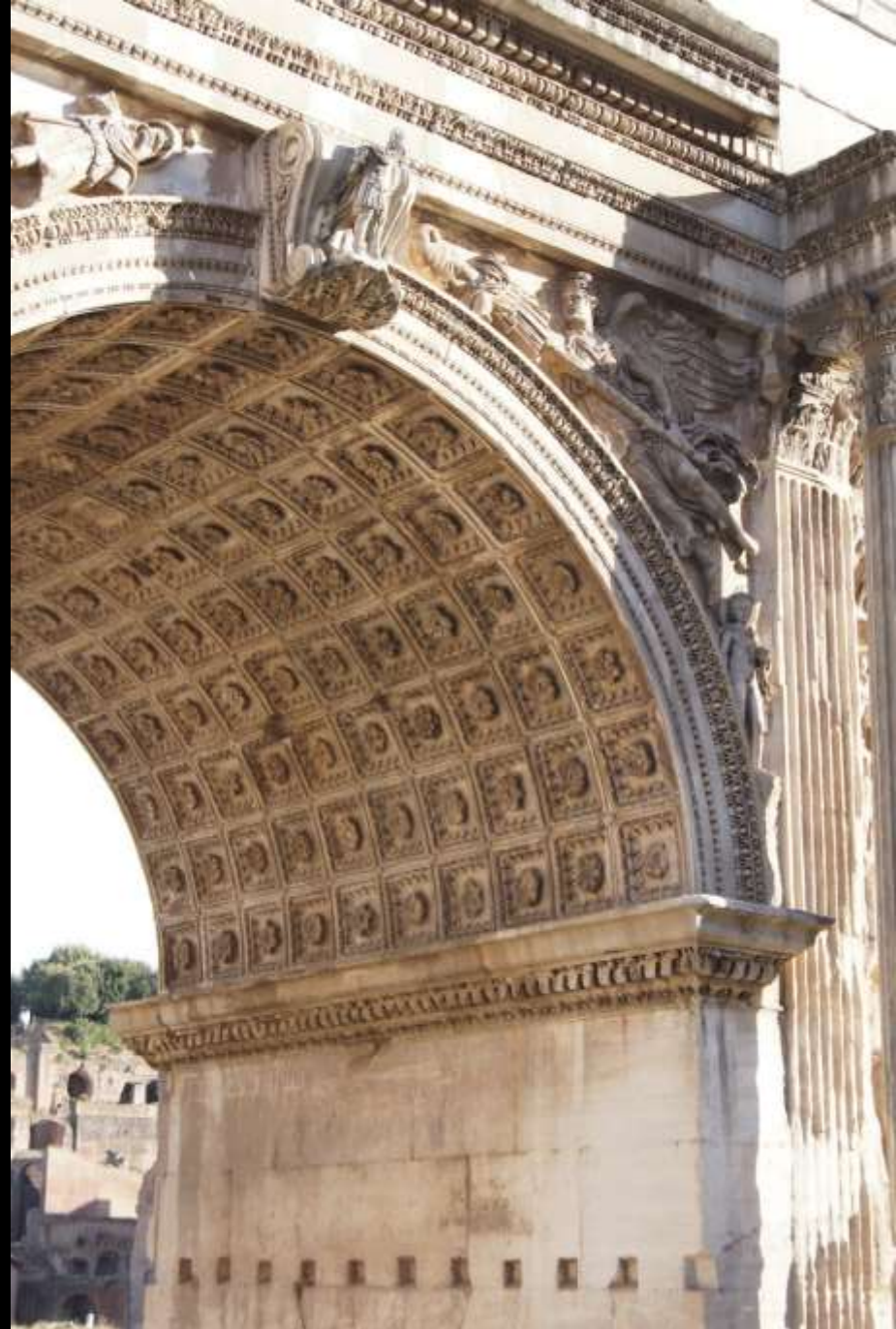
Kassetten an der Maxentiusbasilika und am Severusbogen: opus caementicium vs. Werkstein
