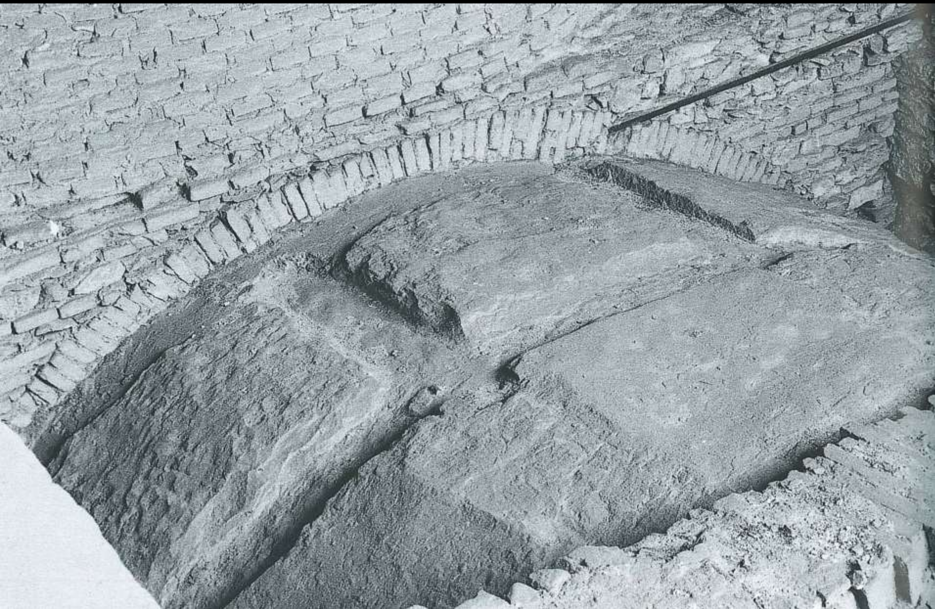
Florenz, Pazzikapelle an Santa Croce, Vorhalle: Kassetierung in Werkstein mit Backstein-Übermauerung (Foto: Gargiani 2003)
