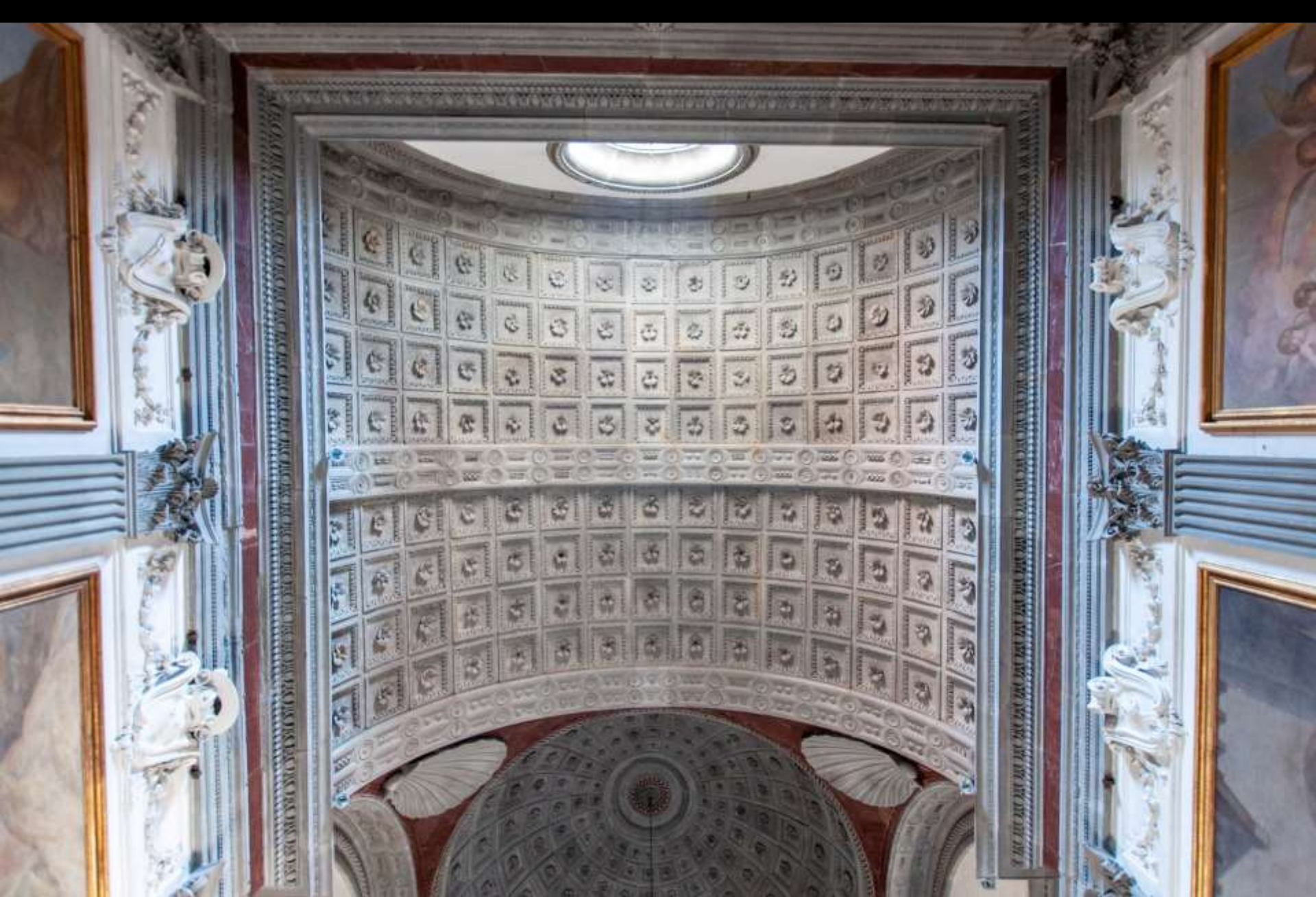
Pistoia, Madonna dell'Umiltà, Vorhalle, kassettierte Werkstein-Tonnengewölbe (Giuliano da Sangallo um 1500; Foto: Clemens Knobling)
