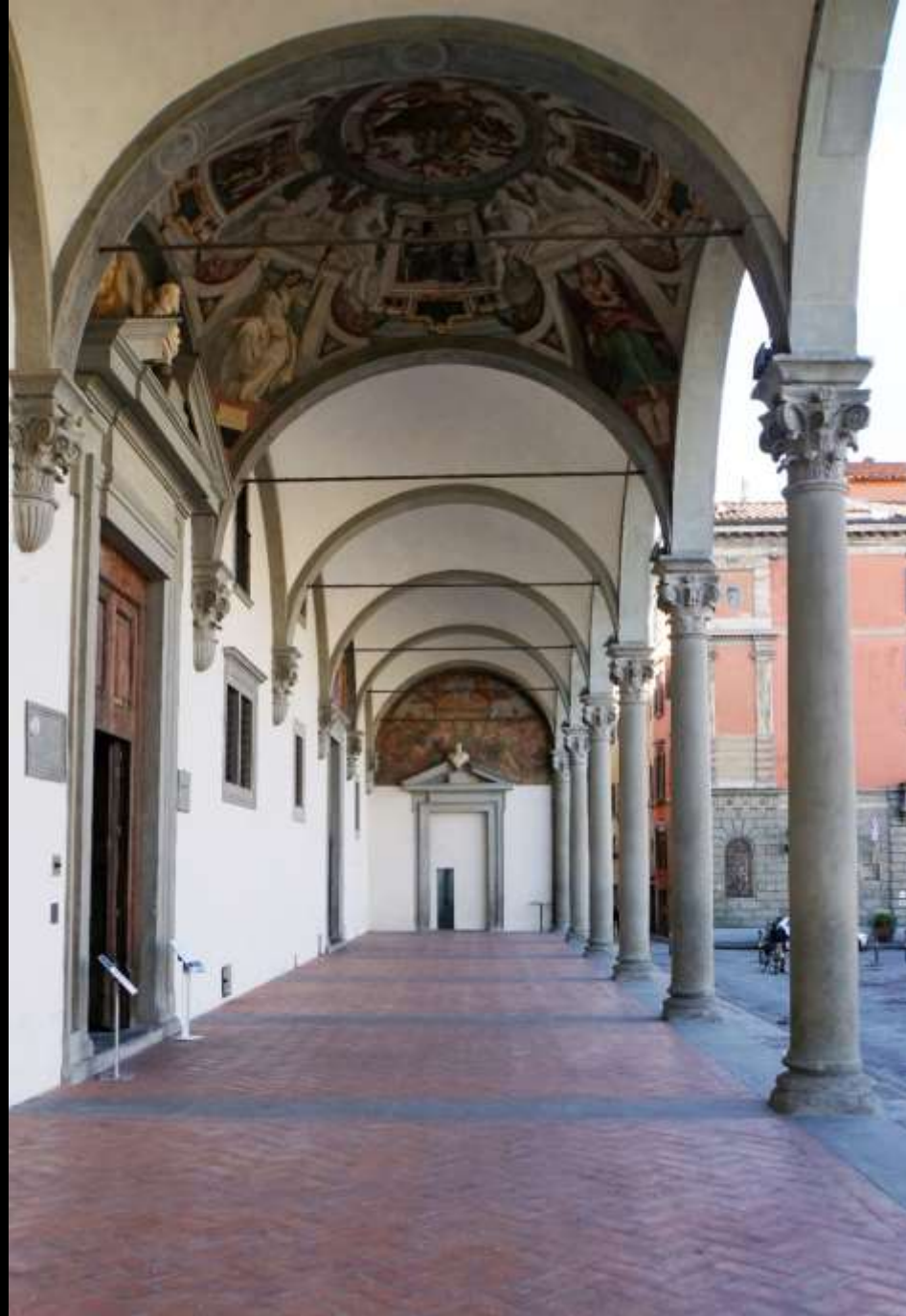
Florenz, Spedale degli Innocenti, Loggia (Filippo Brunelleschi, ab 1419). Wölbung mit Hängkuppeln und Eisen.
