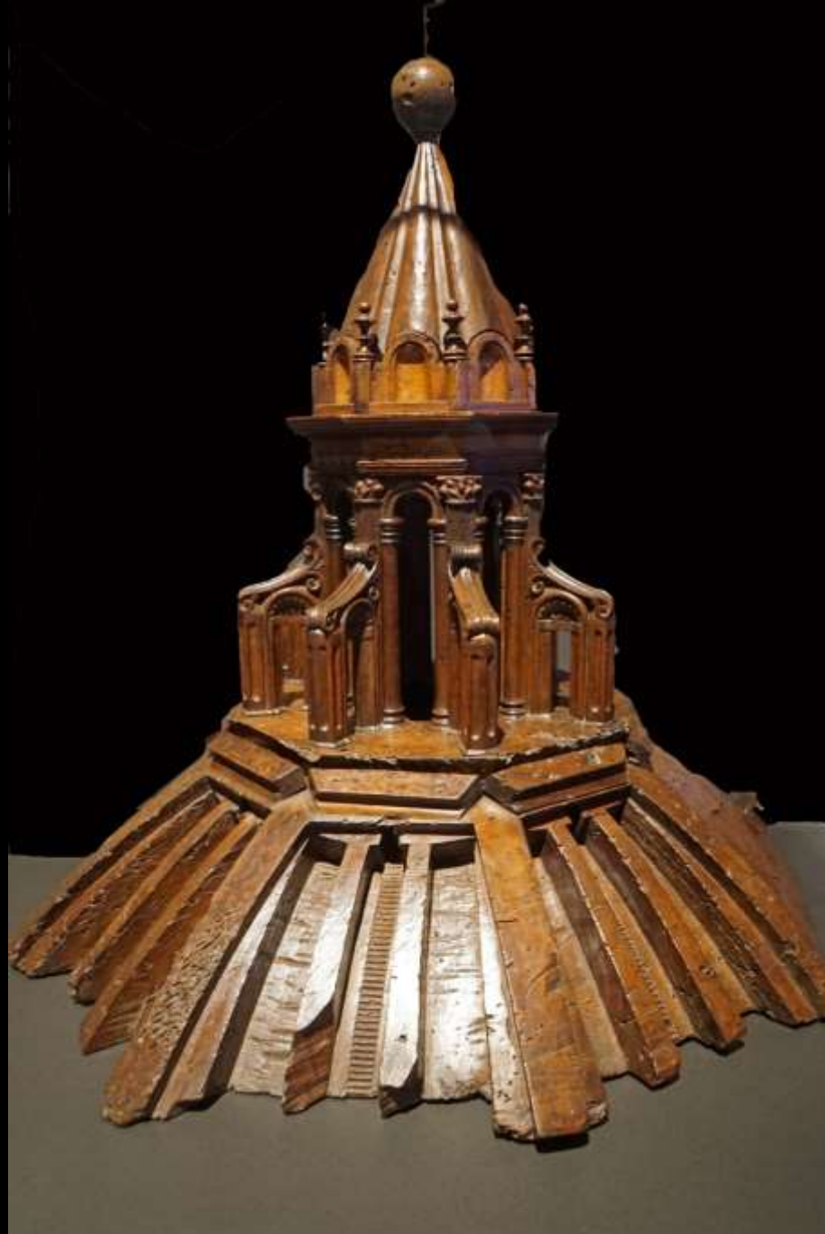
Florenz, Dom. Modell der Laterne von Filippo Brunelleschi. Rippensystem der Kuppel.
