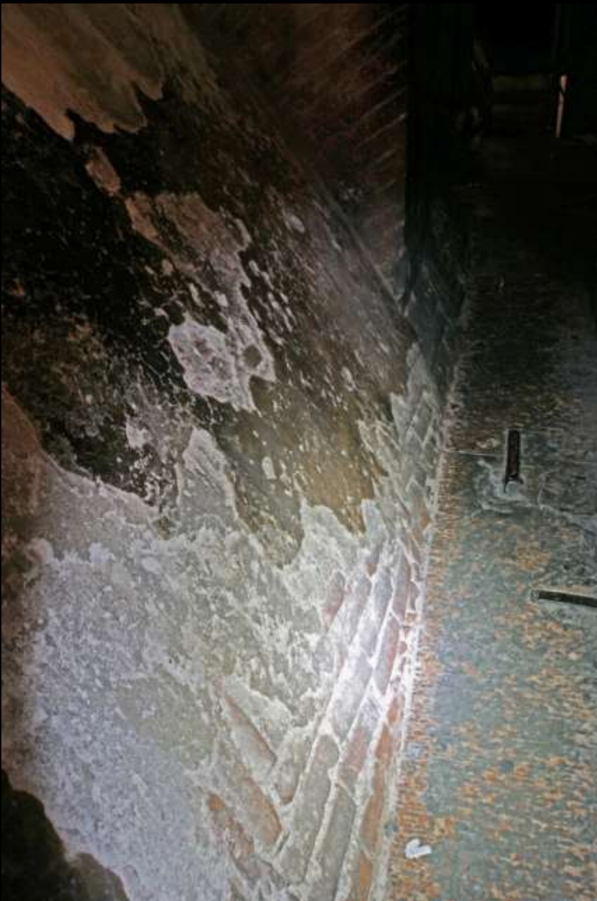
Florenz, Dom. „Durchhängende“ Mauerschichten (rechts: Rocchi Coopmans de Yoldi 2006)
