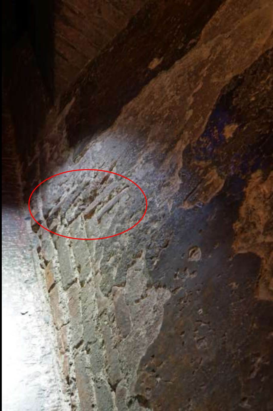
Florenz, Dom. „Spinapesce“-Mauerwerksverband in der Kuppelschale
