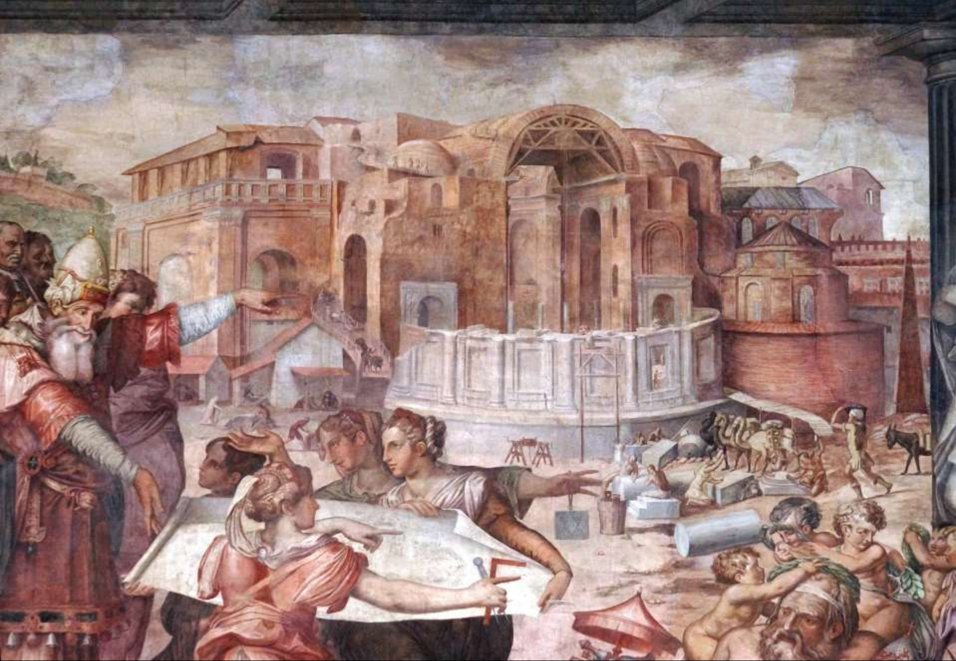
Rom, Petersdom, Baustelle, Einwölben des südlichen Kreuzarms unter Antonio da Sangallo d. J. um 1546 (Fresko von Giorgio Vasari, Palazzo della Cancelleria, Rom, 1546)
