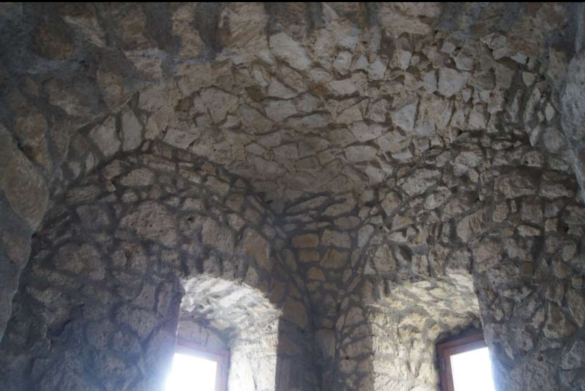
Cellere (Prov. Viterbo), Sant' Egidio (Antonio da Sangallo d.J, 1513), Wölbung eines Nebenraums in Bruchstein
