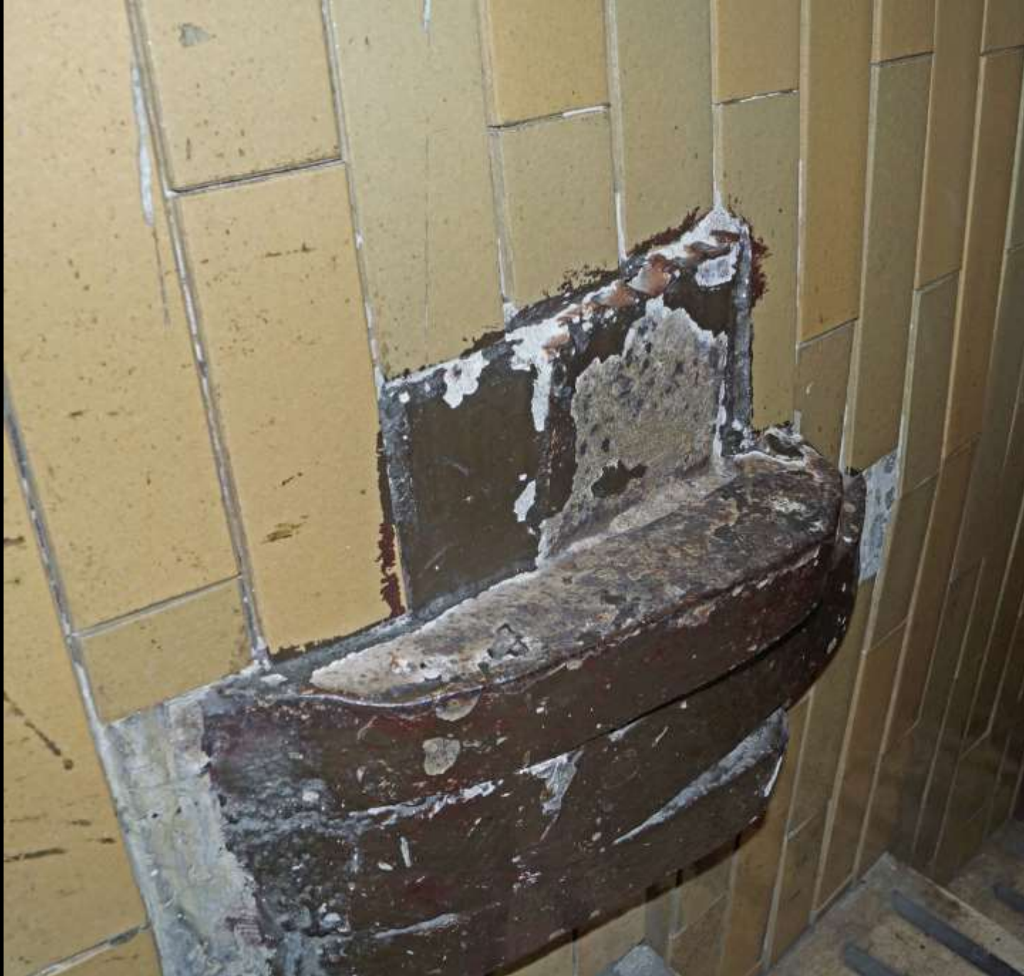
Rom, St. Peter, unterster Eisengürtel an der Kuppel
