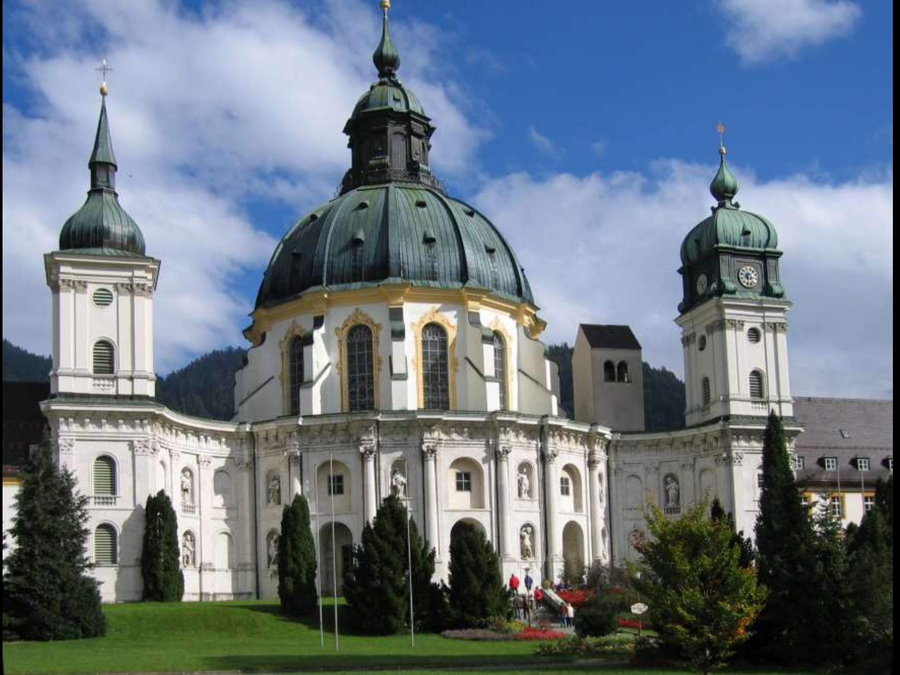
Ettal, Abteikirche, Umbau eines gotischen Zentralbaus (1710–36, Henrico Zuccalli)
