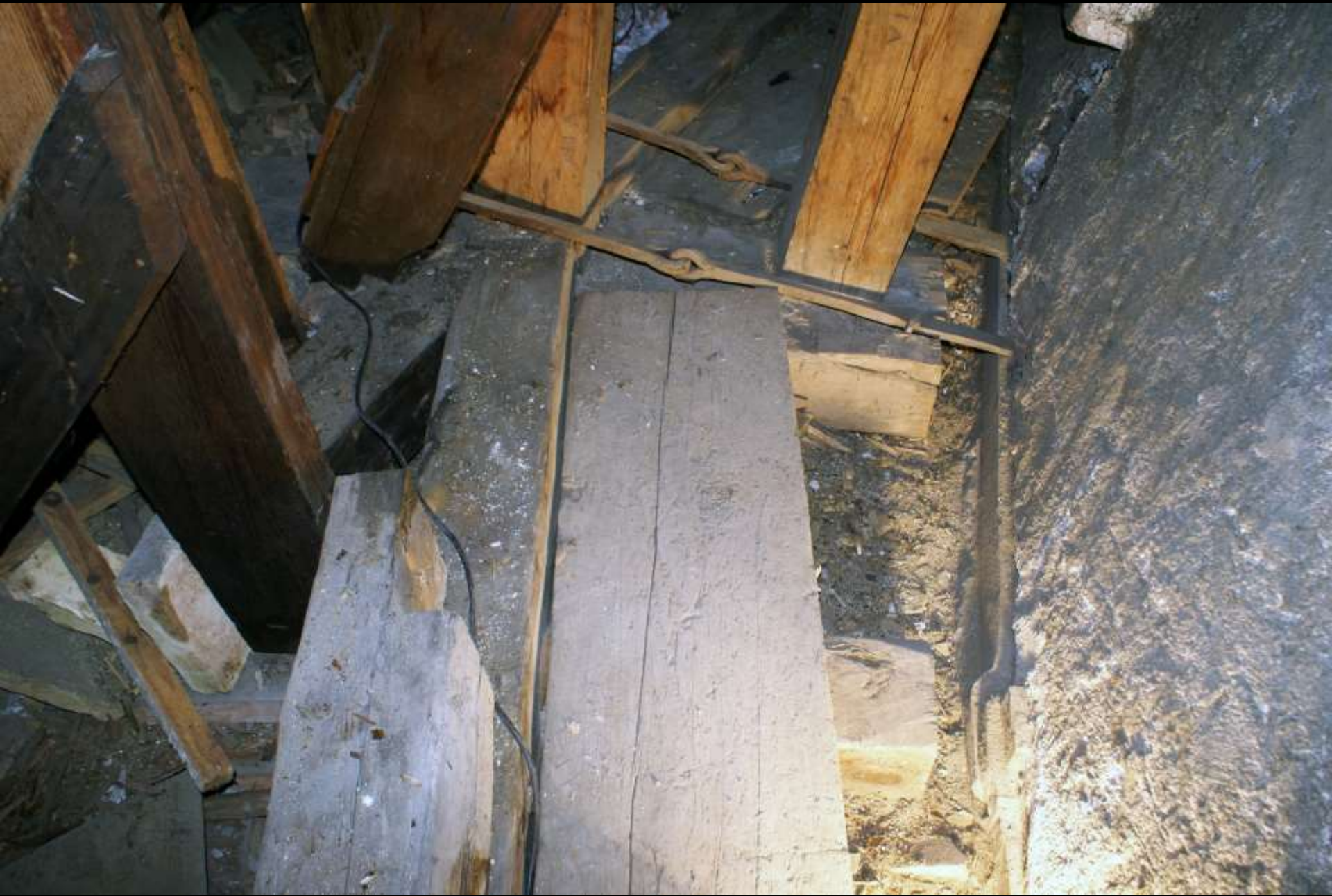
Ettal, Kuppel, eiserner Ringanker am Kuppelansatz (Henrico Zuccalli, um 1710)
