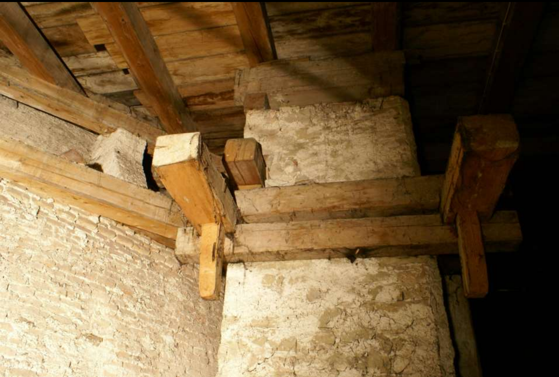
Murnau, Pfarrkirche (1717–1727). Kuppel mit Holzankern.
