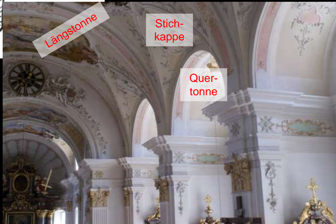
Statisches Prinzip der Wandfeilerkirche
