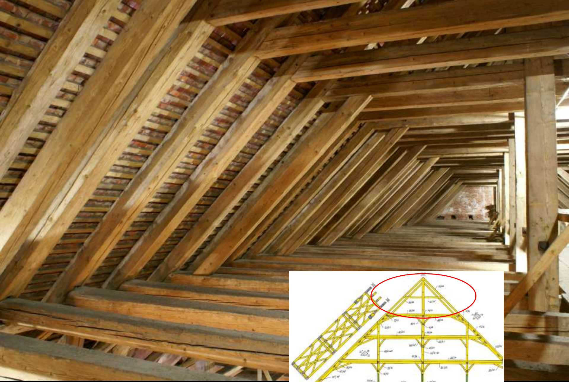
Fürstenfeld, Klosterkirche. Dachwerk. Firstzone und Hahnenbalkenlage.
