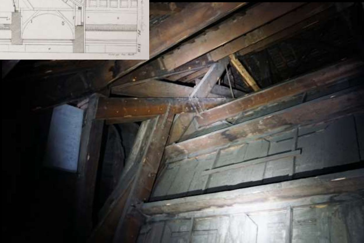
Paris, Saint-Philippe-du-Roule, Holzkonstruktion der Tonnengewölbe
