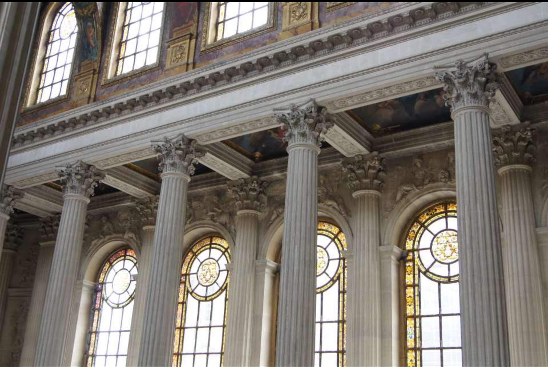
Versailles, Schlosskapelle, eisenbewehrte Architrave (Jules Hardouin-Mansart, 1698–1710)
