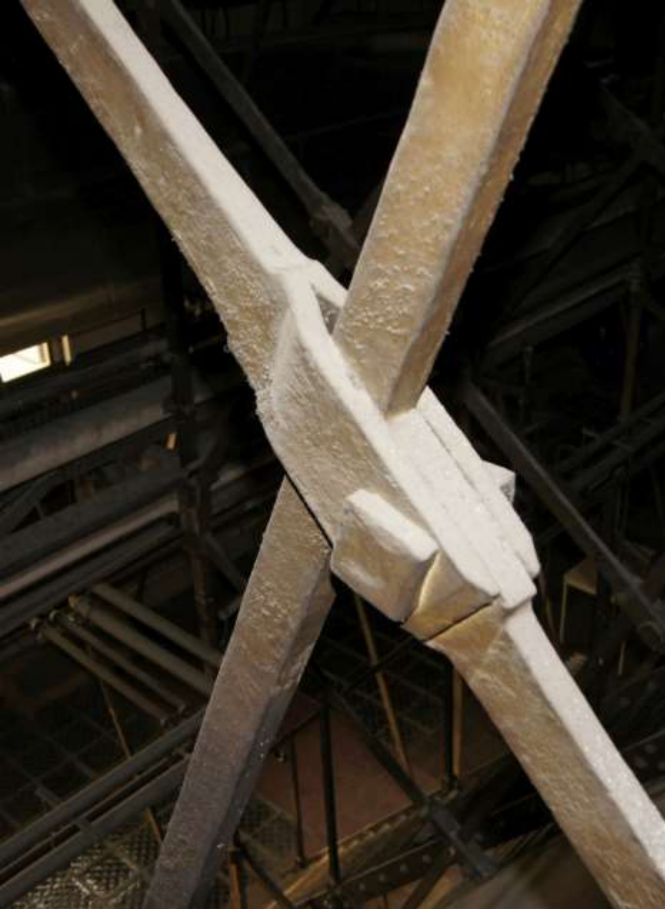
Paris, Dachkonstruktion der Börse (1821-27) Anschlussdetails der „Speichen“
