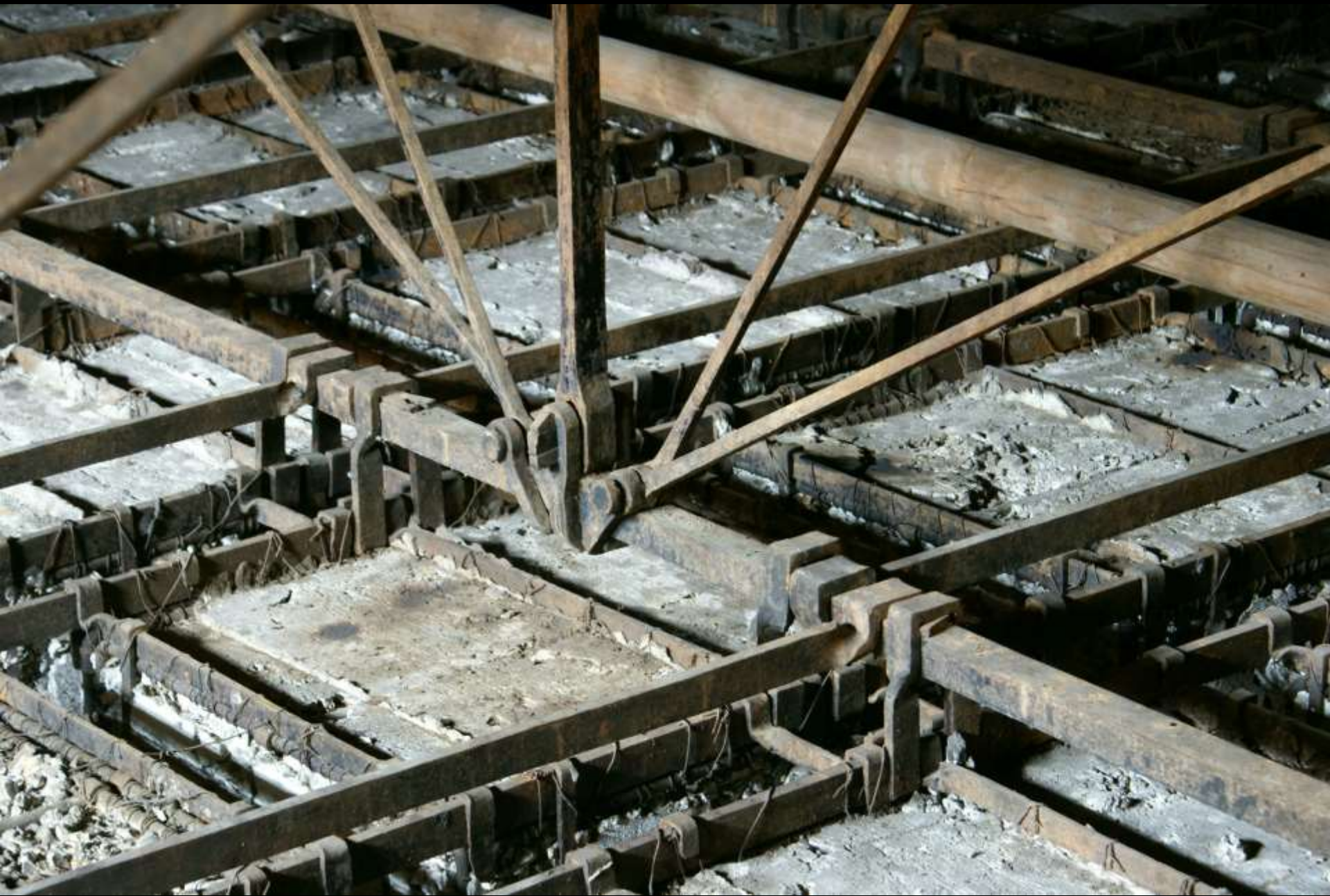
Walhalla bei Regensburg, Dachwerk über dem „Adyton“: abgehängte Eisen-Draht-Putz-Decke (Leo v. Klenze und „Mechanicus Manhard“ 1836-40)
