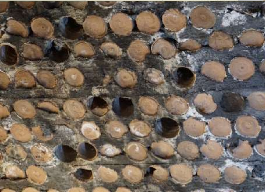
Französische Tradition und Innovation: Massivbau mit Eisenbewehrung, Bauen mit hohlen Tontöpfen
