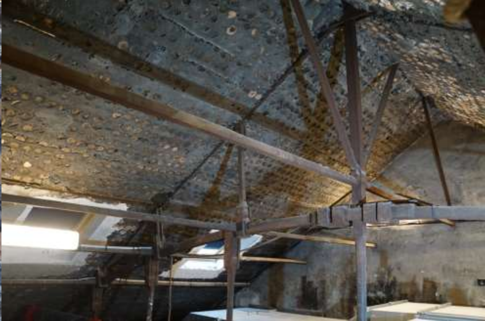
Französische Tradition und Innovation: Massivbau mit Eisenbewehrung, Bauen mit hohlen Tontöpfen
