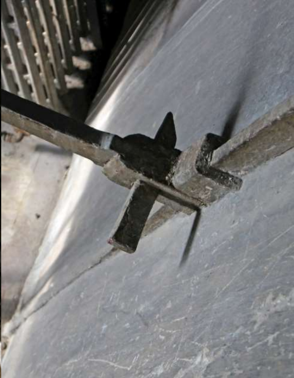
Paris, Dachkonstruktion der Börse (1821-27) Anschlussdetails der „Speichen“
