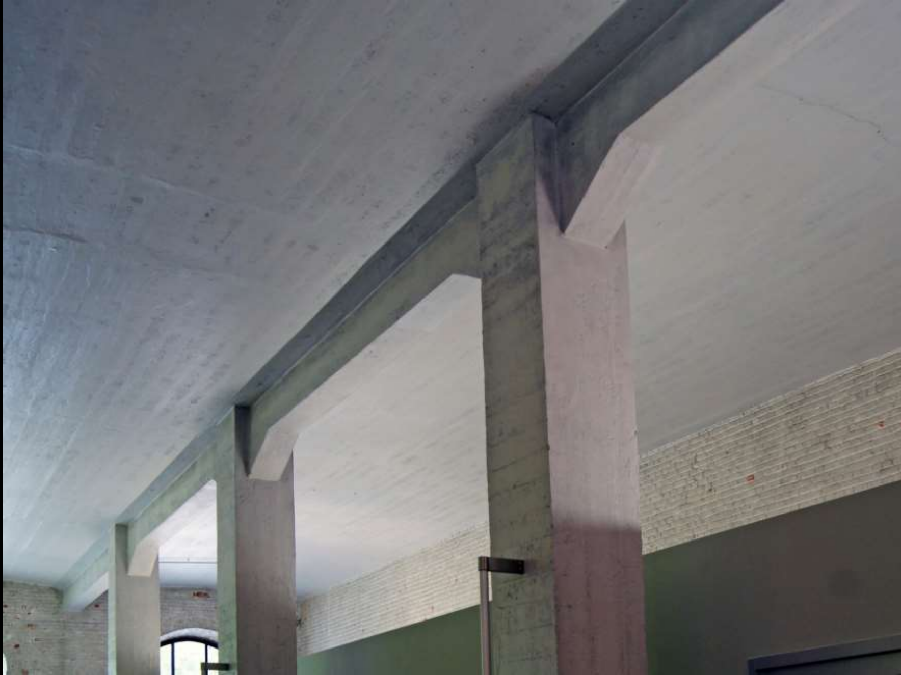
Hennebique: System Stütze-Unterzug-Platte Lagerhaus Thurn & Taxis, Brüssel (1904-06)
