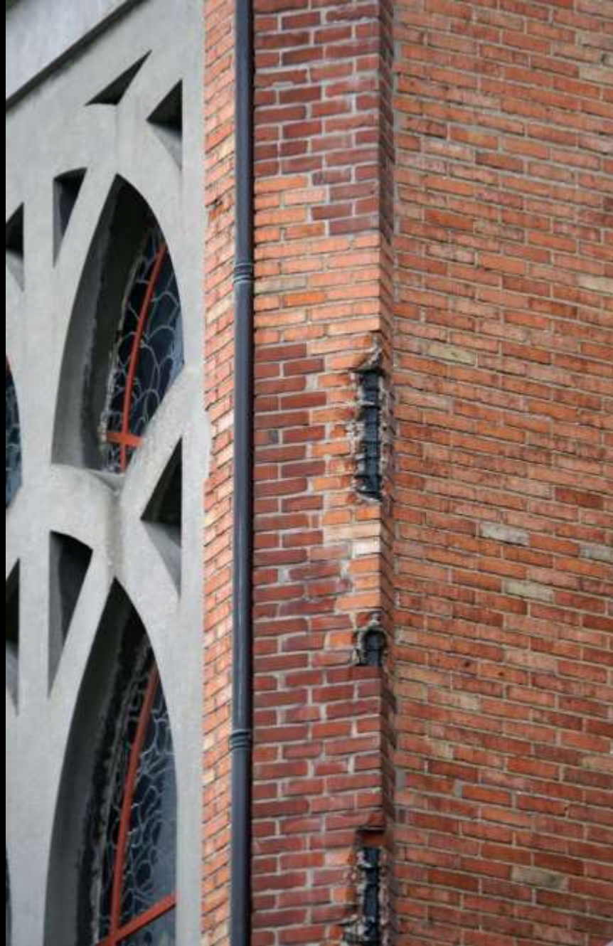
Paris, Saint-Jean de Montmartre (Anatole Baudot, 1894-1904) Anwendungen der Cottancin-Bauteile
