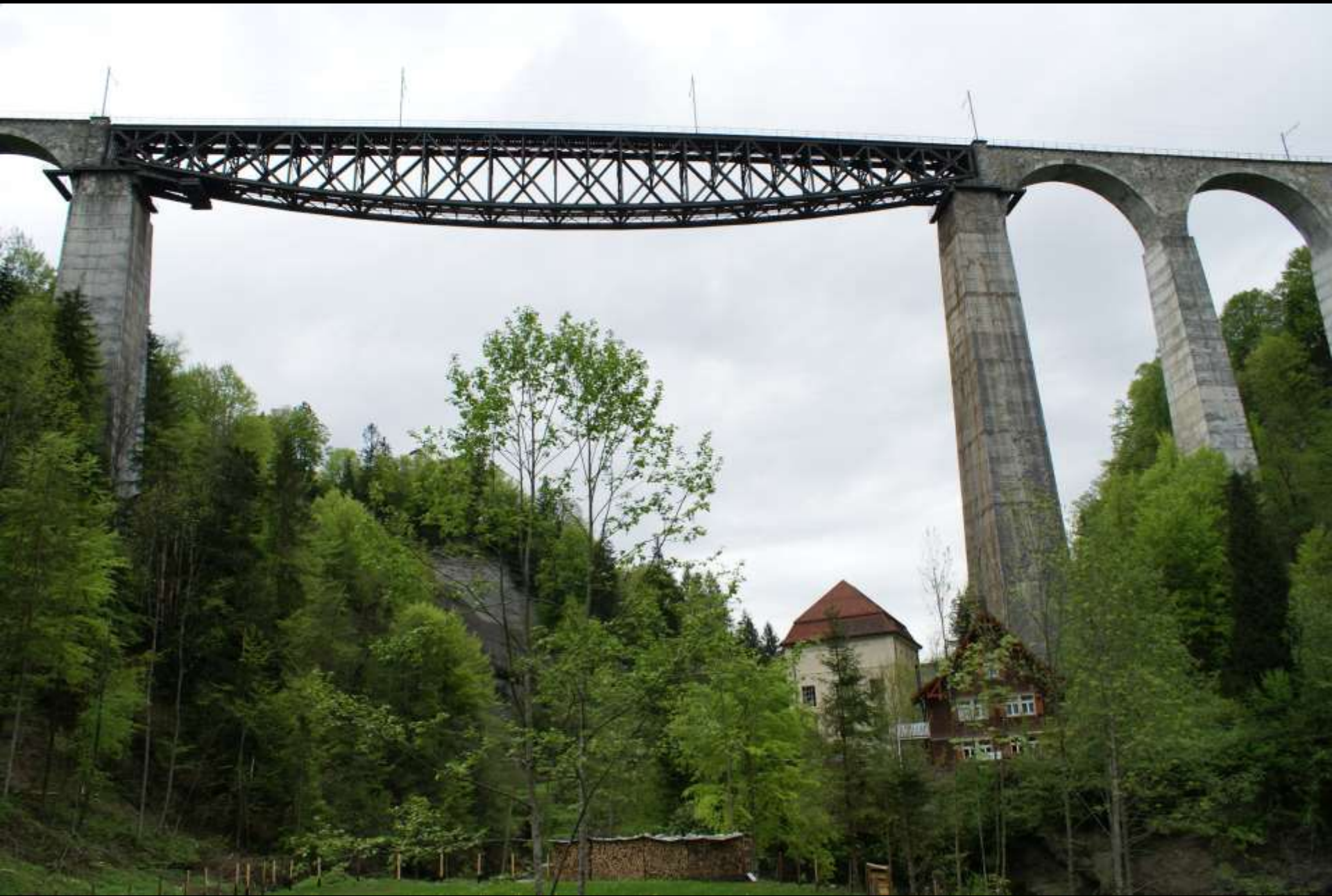
Sitterviadukt der Bodensee-Toggenburg-Bahn (1908–10, 120 m Spannweite)
