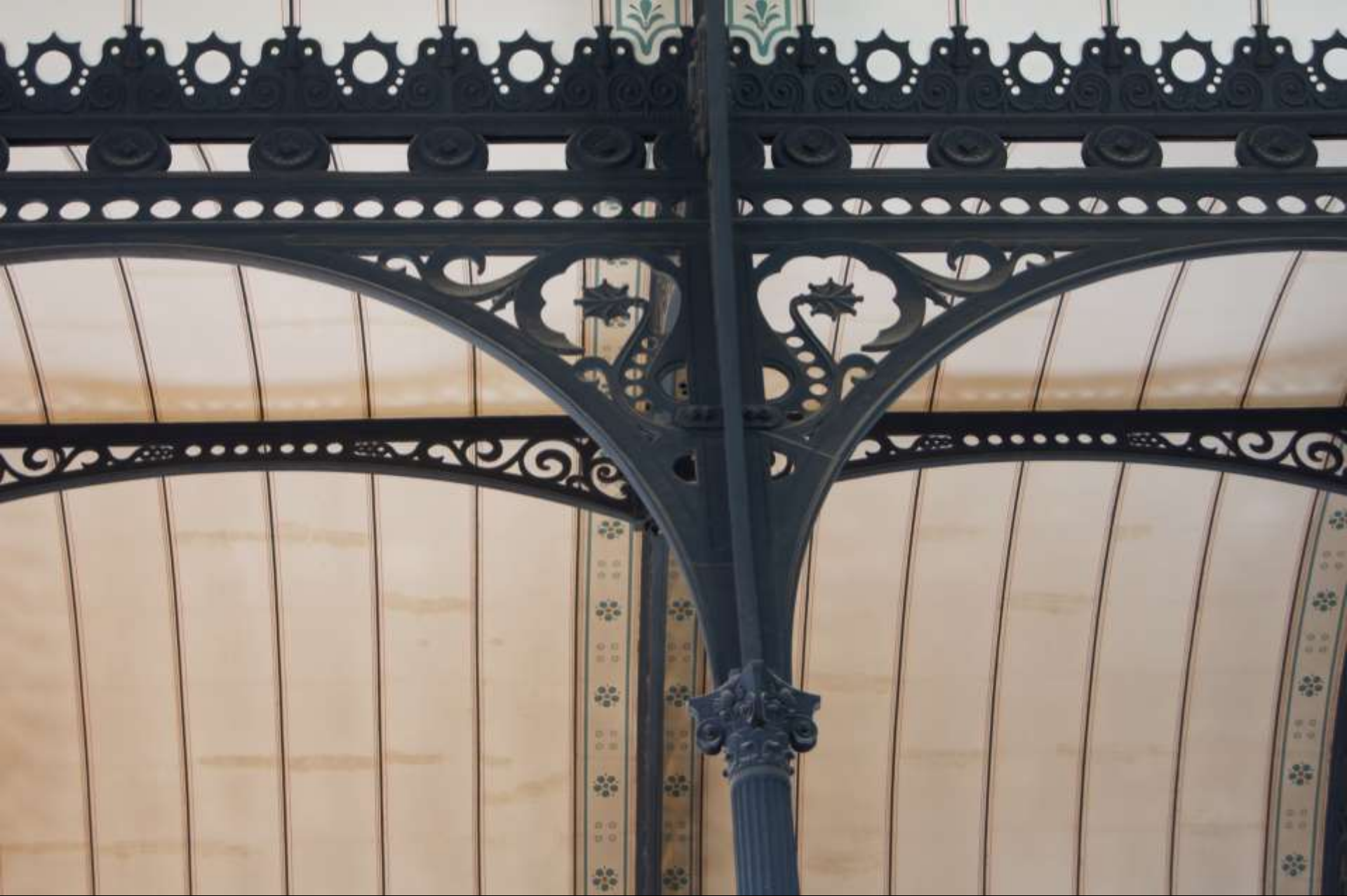
Paris, Bibliothèque Sainte-Geneviève (Henri Labrouste, 1850) Detail der Gusseisenkonstruktion
