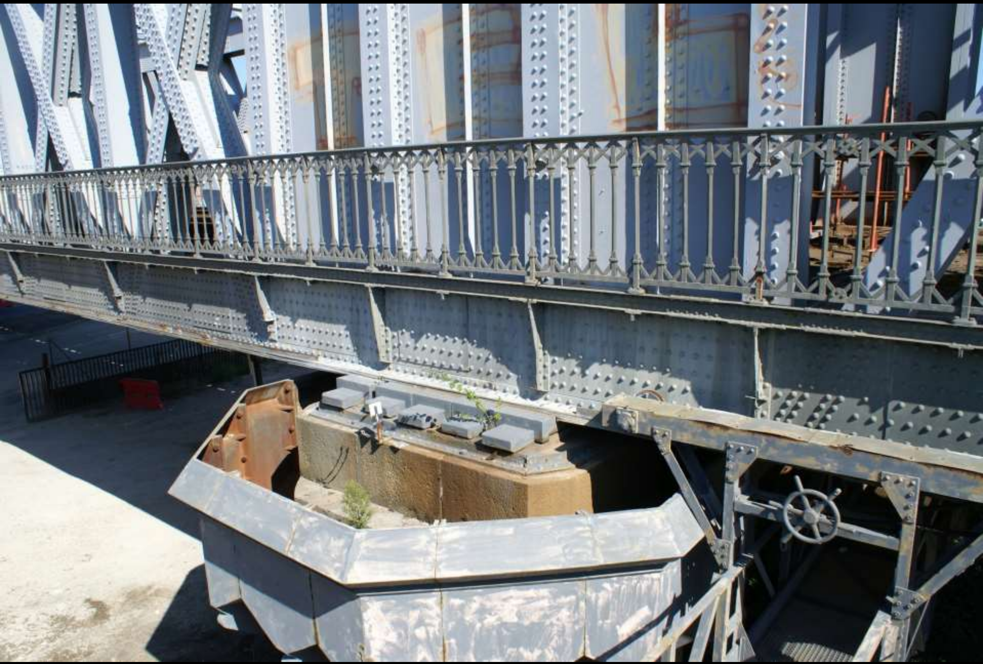
Bordeaux, Eisenbahnbrücke (1859). Verschiebliches Lager
