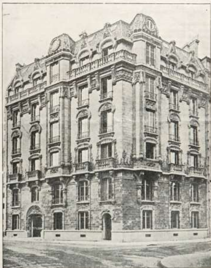
FIG. II. — Vue extérieure après achèvement.
