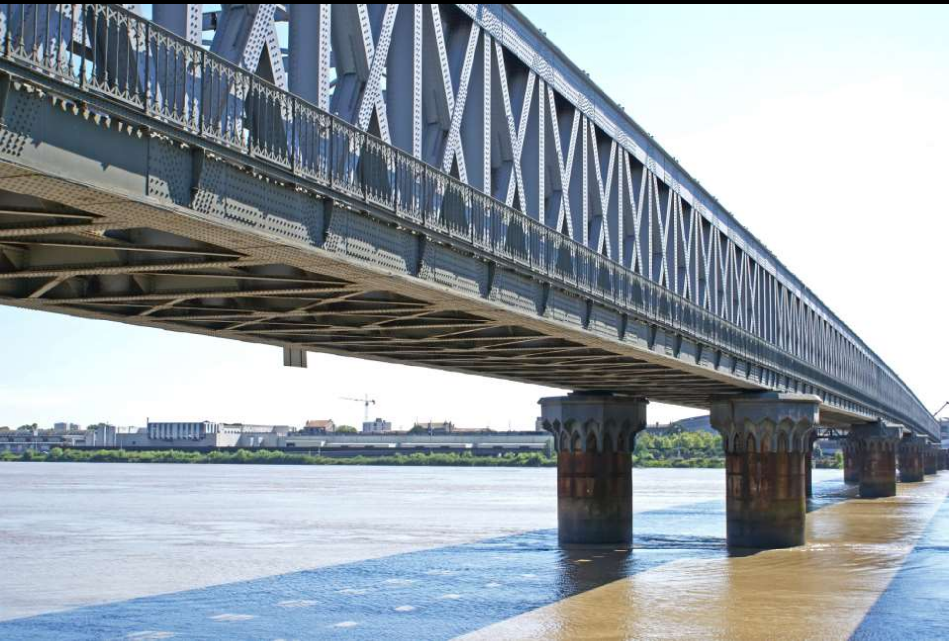
Bordeaux, Eisenbahnbrücke (1859). Prototyp einer Gitterfachwerkbrücke???
