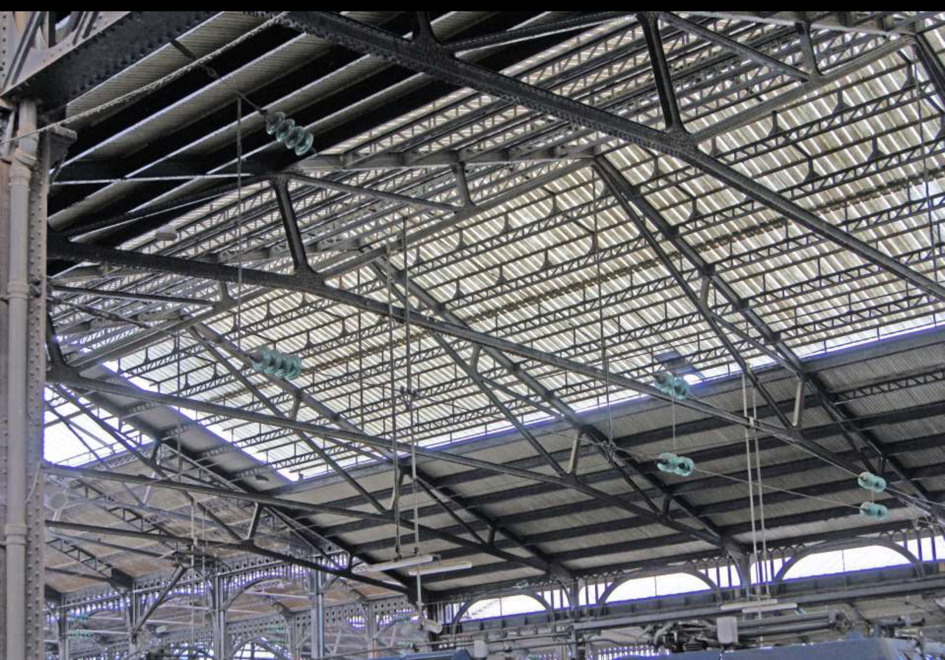
Paris, Gare Saint-Lazare (1851-53). Spannweite 40 m (Armand und Flachet).
