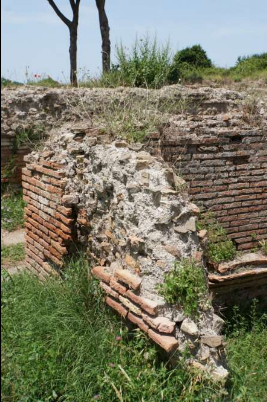
opus caementicium mit Backsteinverkleidung (Ostia, 2. Jh. n. Chr.; Foto: W. Potgeter)
