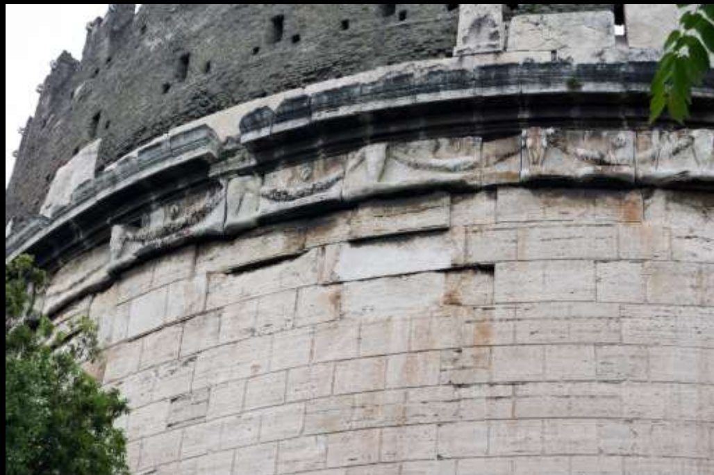
Grosssteinbauweise als reines Verkleidungsmauerwerk Rom, Grabmal der Caecilia Metella, 1. Jh. v. Chr.
