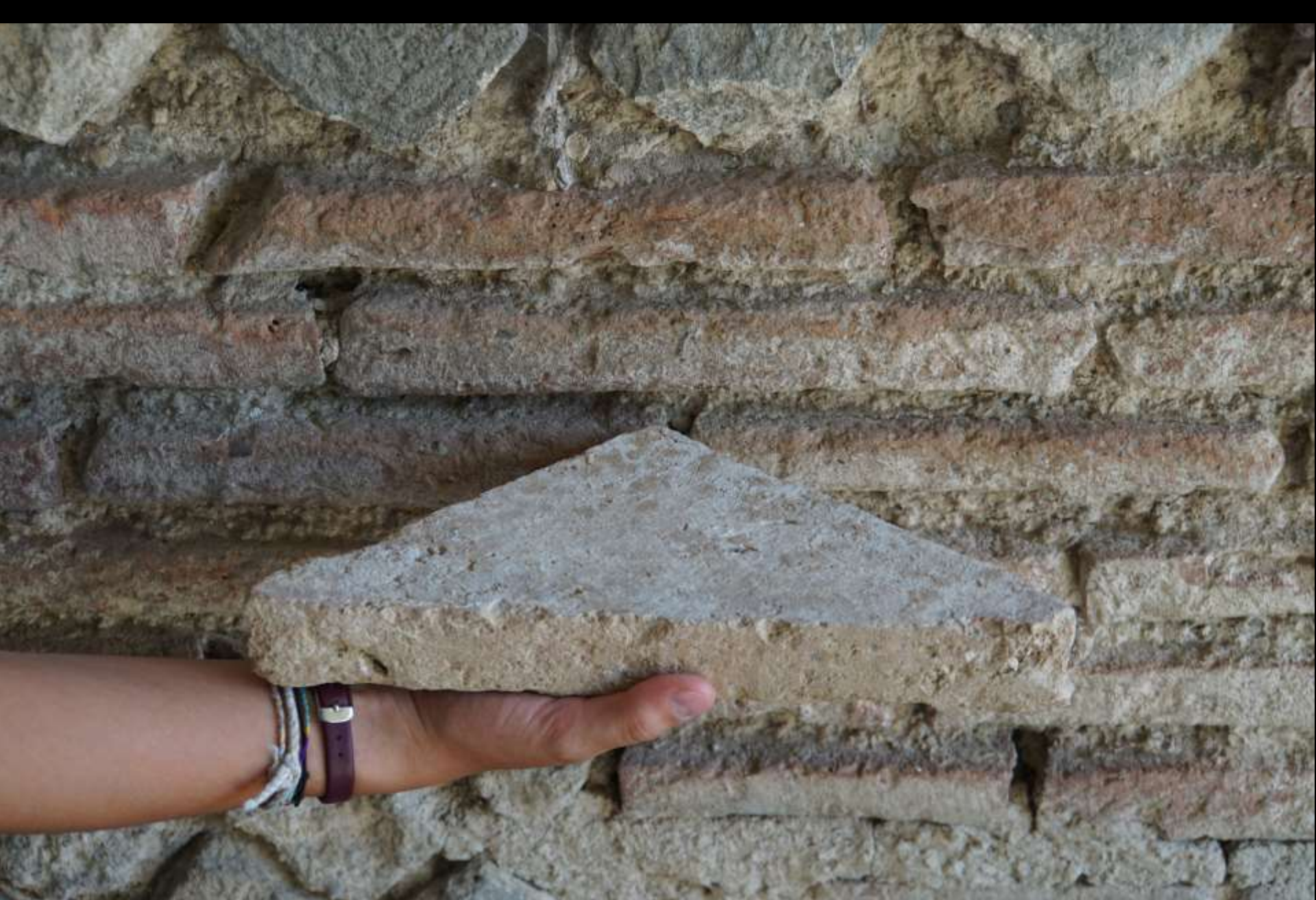
Verwendung dreieckig gebrochener Ziegel im Opus testaceum (1/4 bessalis) (Volsinii)
