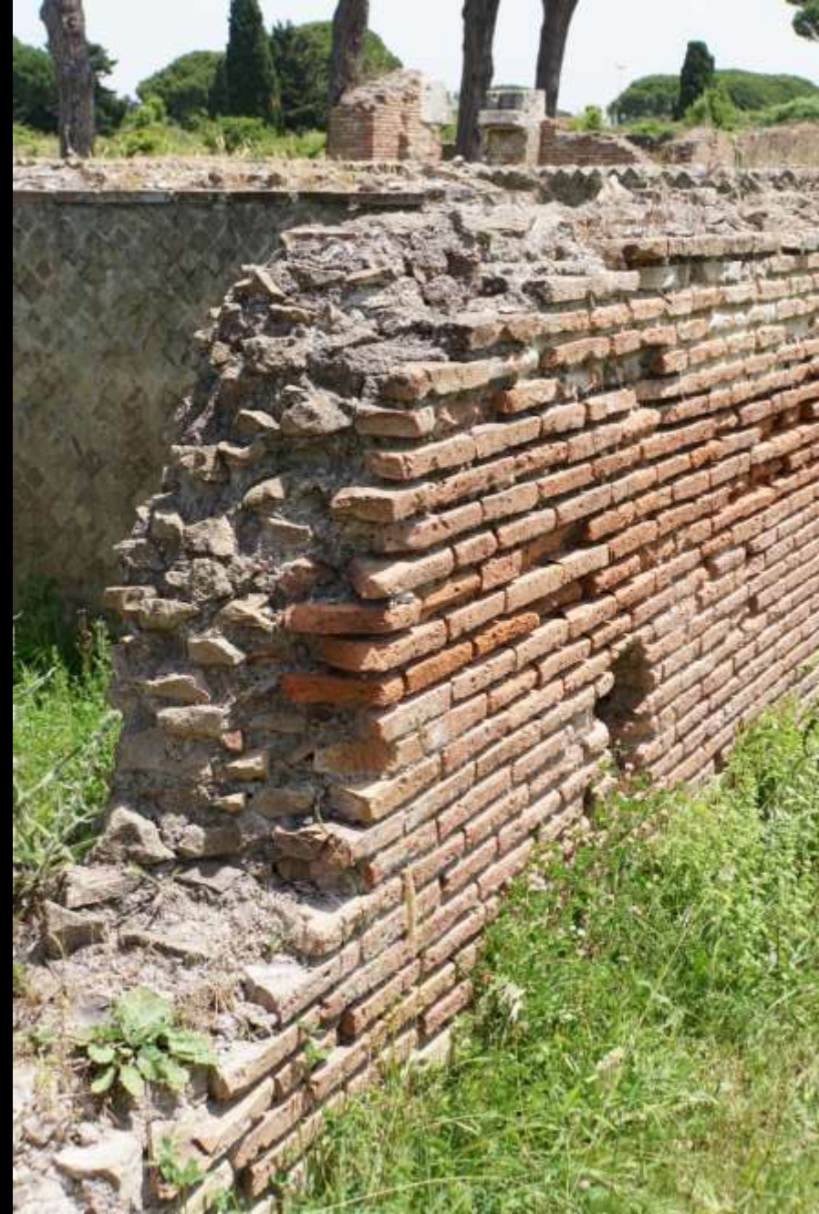
opus caementicium mit Backsteinverkleidung (Ostia, 2. Jh. n. Chr.; Foto: W. Potgeter)
