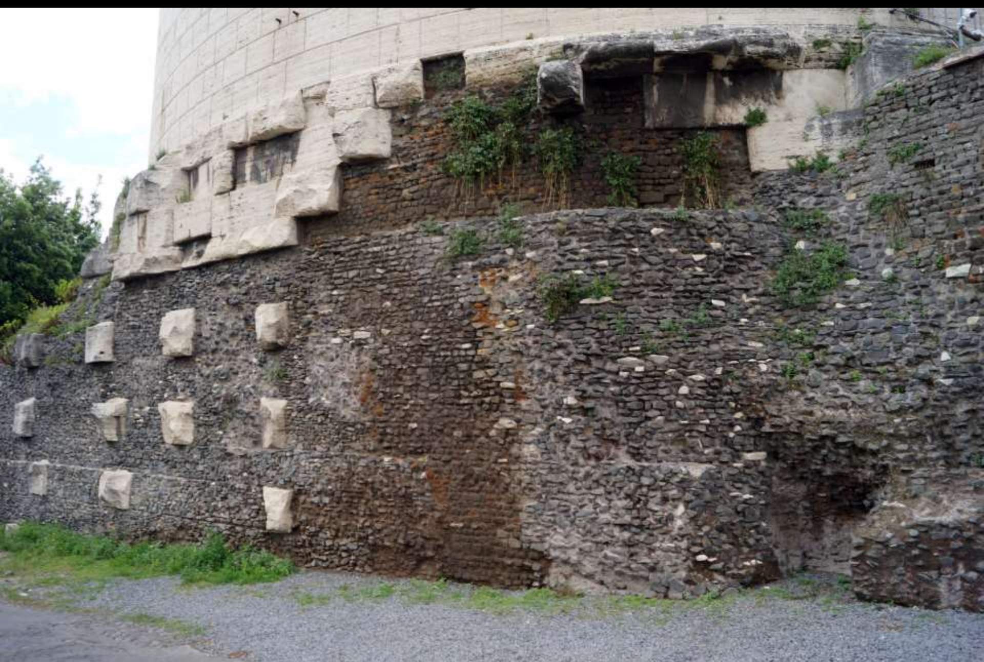
Grosssteinbauweise als reines Verkleidungsmauerwerk Rom, Grabmal der Caecilia Metella, 1. Jh. v. Chr.: Sockel
