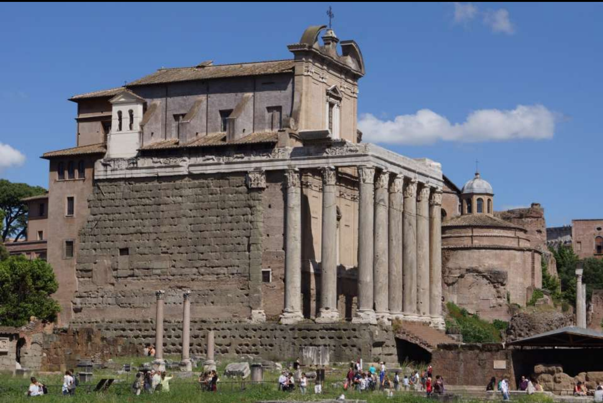
Rom, Tempel des Antoninus und der Faustina (2. Jh. n. Chr.). Unkannelierte monolithische (!) Buntmarmorsäulen.
