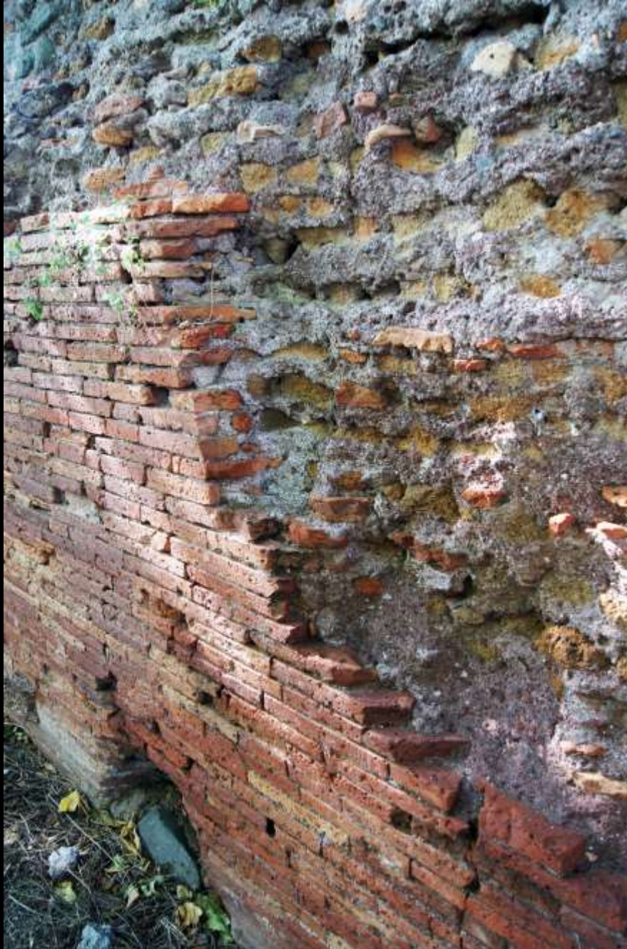
opus caementicium mit Backsteinverkleidung (Rom, Via Appia, Grabmal)
