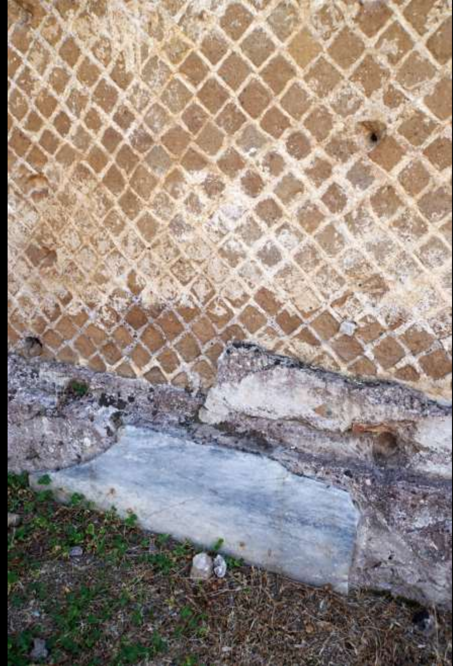
Endzustand von Opus reticulatum: dicker Putz, Malerei oder Marmorverkleidung aus dünnen Platten (Zeichnung: J.P. Adam 1989; Objekt: dorisches Peristyl, Tivoli, Villa Adriana, 2. Jh. n. Chr.)
