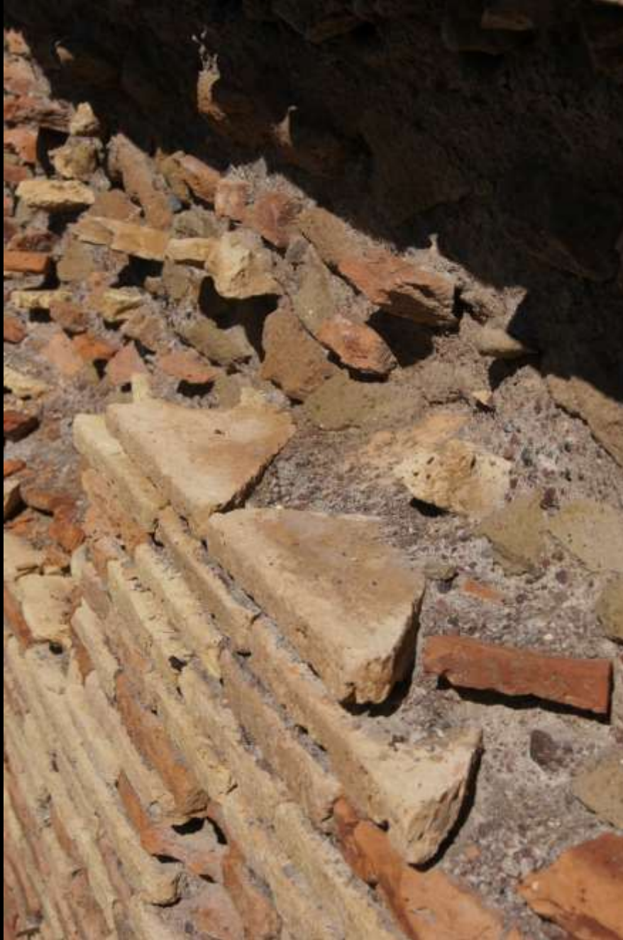
Verwendung dreieckig gebrochener Ziegel im Opus testaceum (Ostia)
