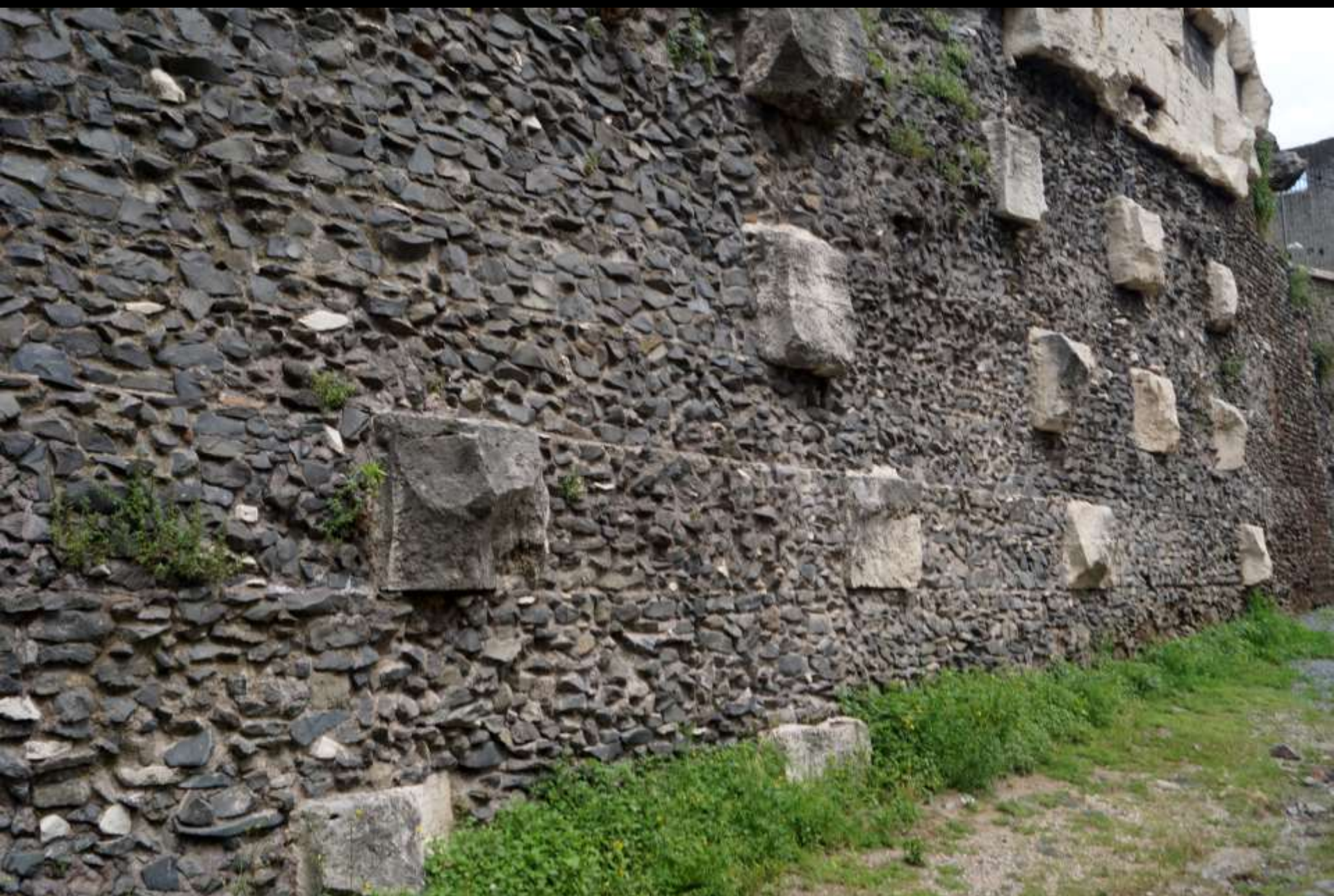
Grosssteinbauweise als reines Verkleidungsmauerwerk Rom, Grabmal der Caecilia Metella, 1. Jh. v. Chr.: Travertinquader als Verkleidung geschütteter Bruchsteine
