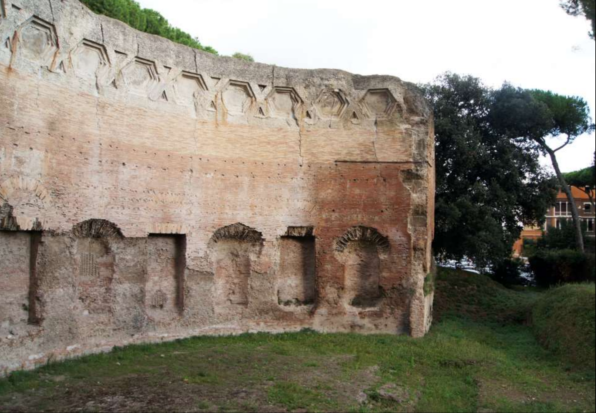
opus caementicium mit Backsteinverkleidung (Rom, Thermen des Trajan, 2. Jh. n. Chr.)
