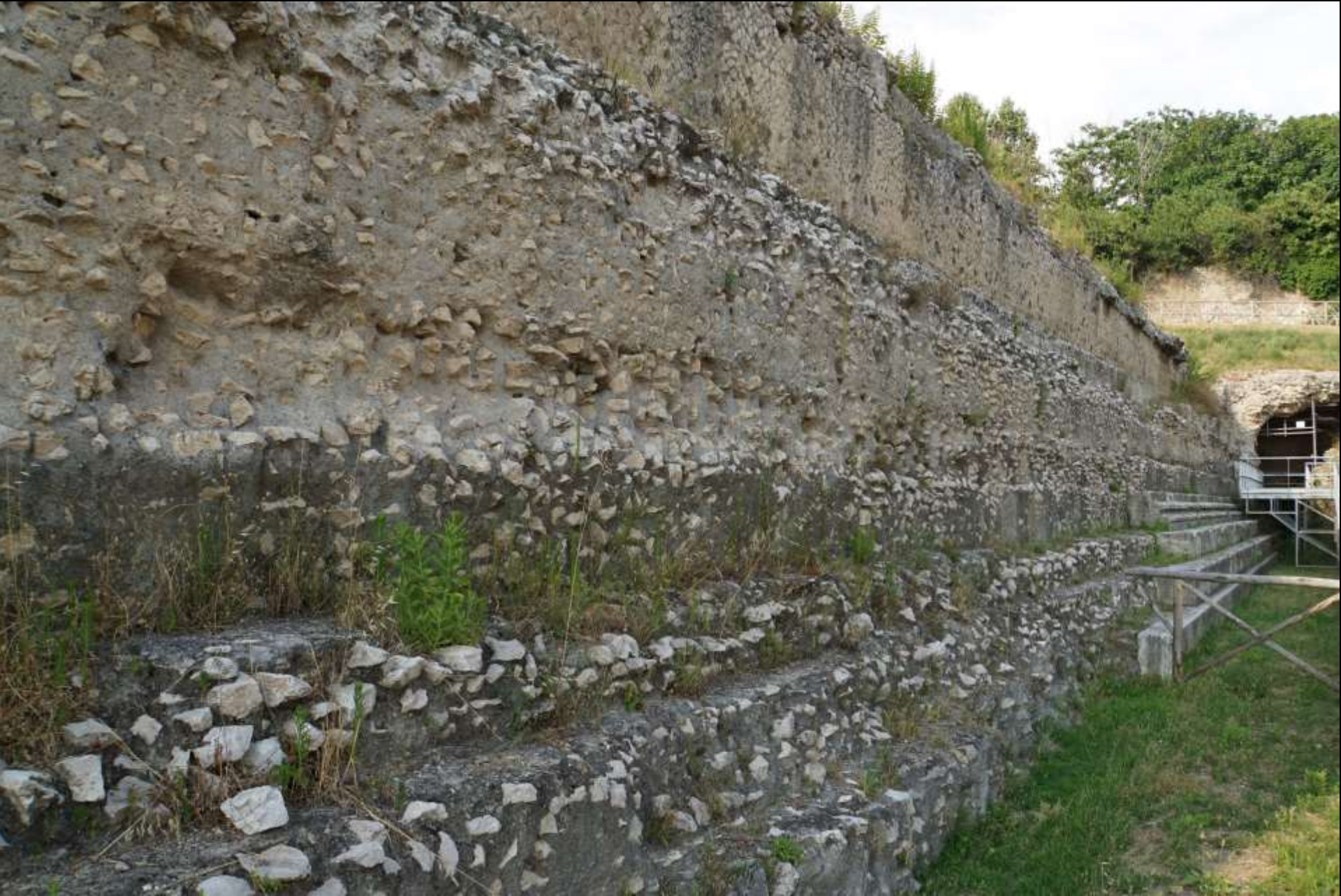
Lagenweise eingebrachtes opus caementicium im Sockel des Hercules-Victor-Tempels in Tivoli (1. Jh. v. Chr.)
