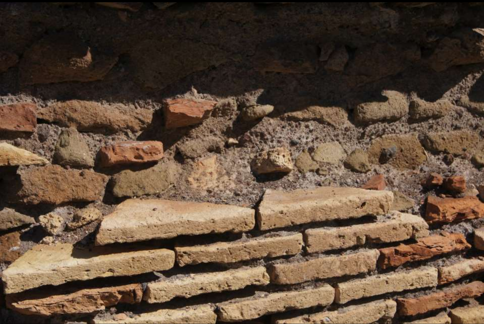
Verwendung dreieckig gebrochener Ziegel im Opus testaceum (Ostia, 2. Jh. n. Chr.)
