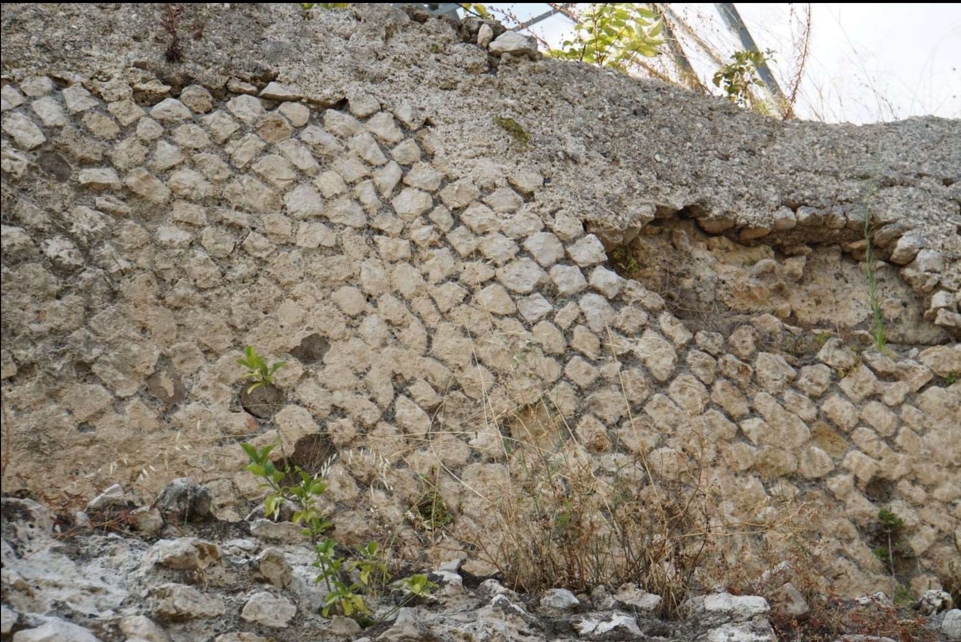
Opus caementicium im Sockel des Hercules-Victor-Tempels in Tivoli mit Verkleidung in opus incertum (1. Jh. v. Chr.)
