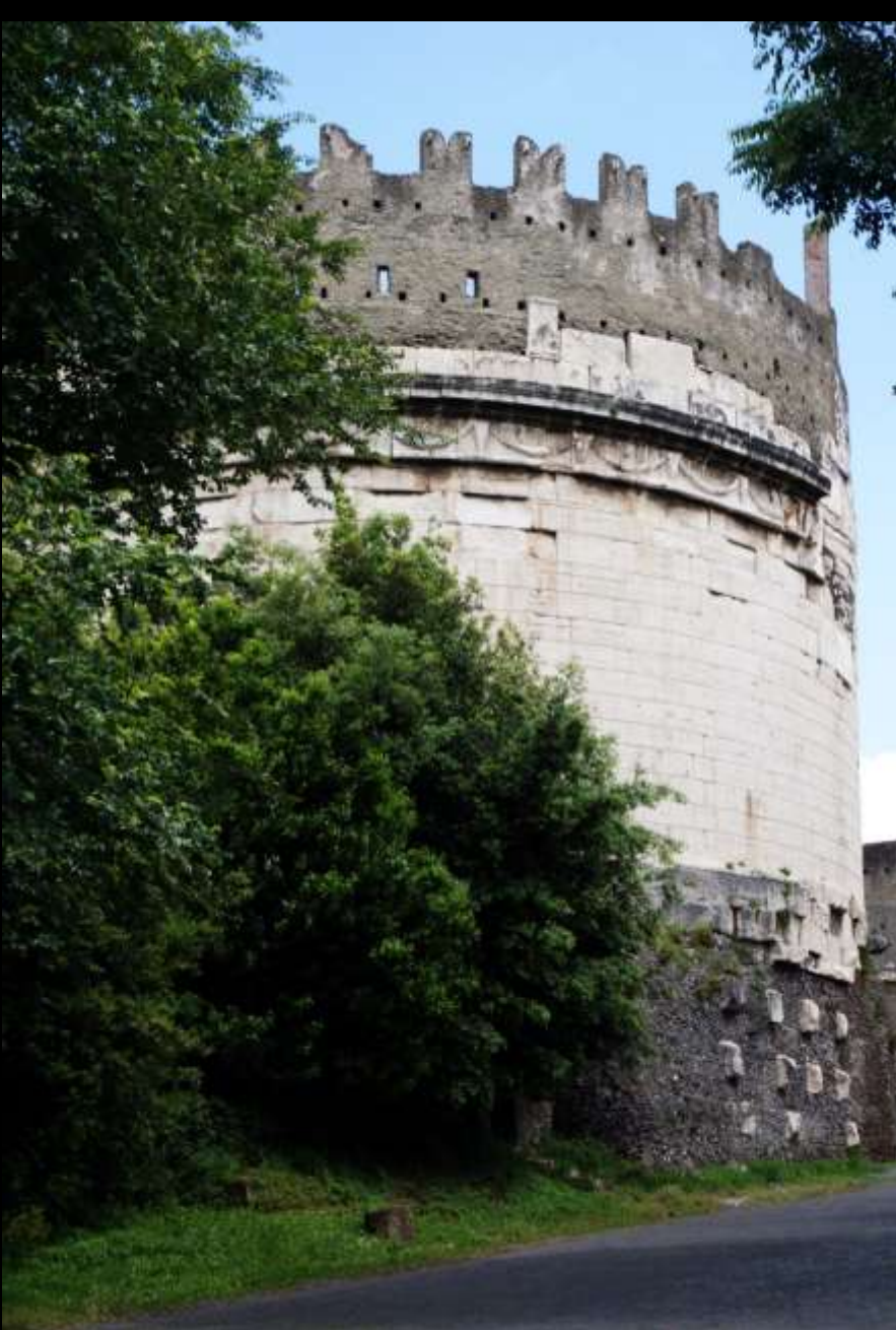
Grosssteinbauweise als reines Verkleidungsmauerwerk Rom, Grabmal der Caecilia Metella, 1. Jh. v. Chr.
