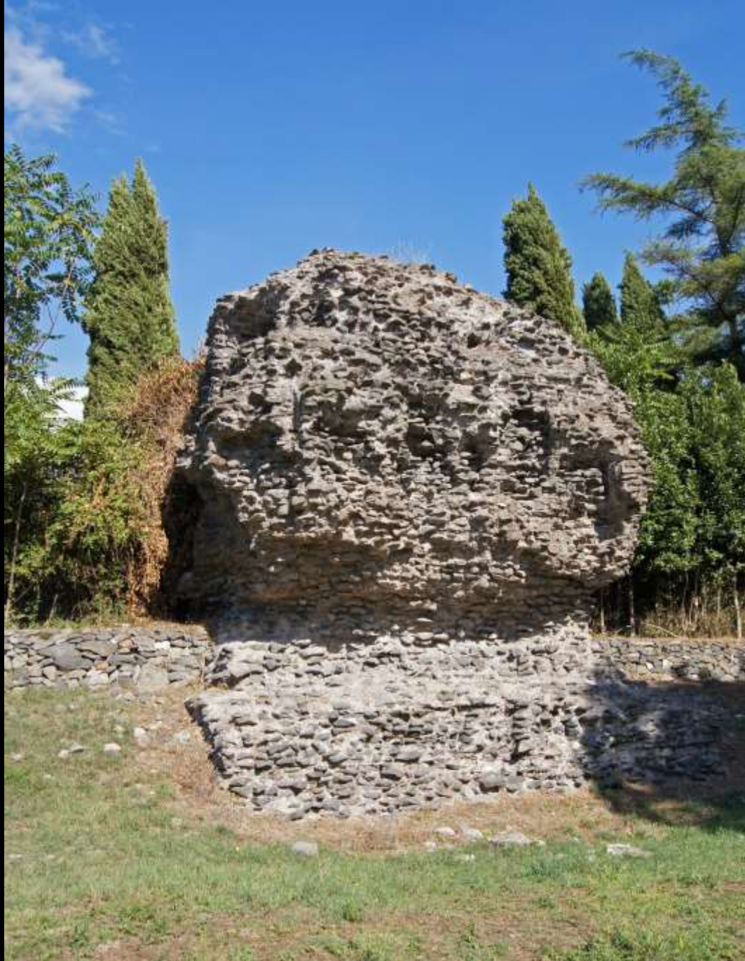
Allein erhaltener massiver Kern eines Grabmals an der Via Appia in Rom aus opus caementicium
