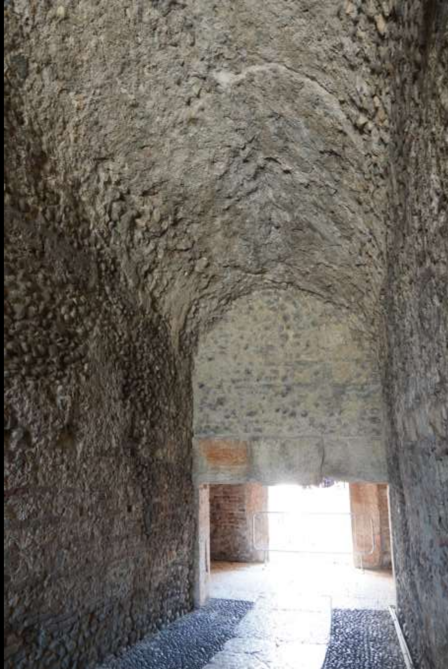
Amphitheater: Verona (1. Jh. n. Chr.): Gewölbte Konstruktionen aus opus caementicium unter der cavea
