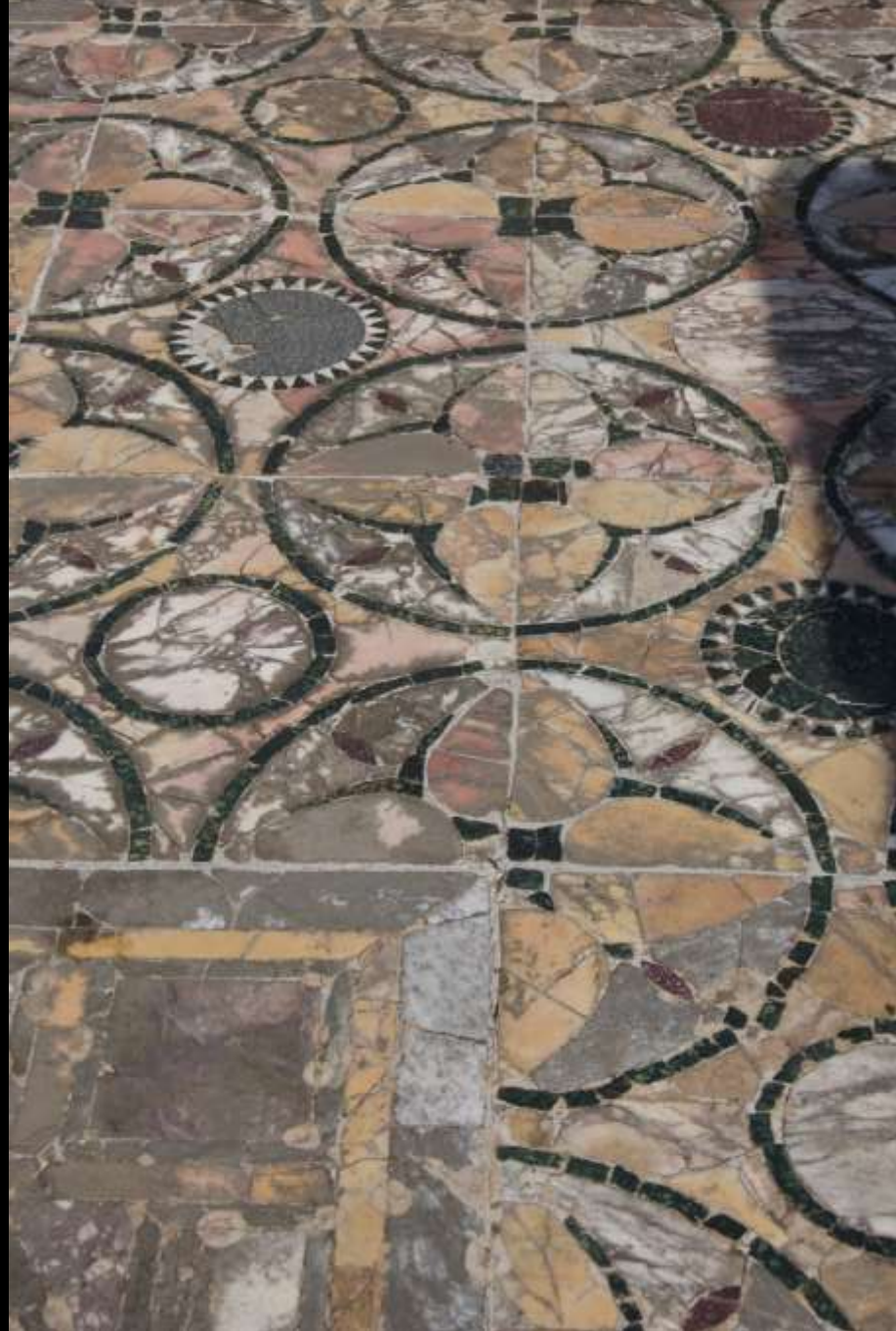
Wand- und Bodeninkrustation mit dünner Schicht aus Buntmarmor-Intarsien ( opus sectile ) (Ostia)
