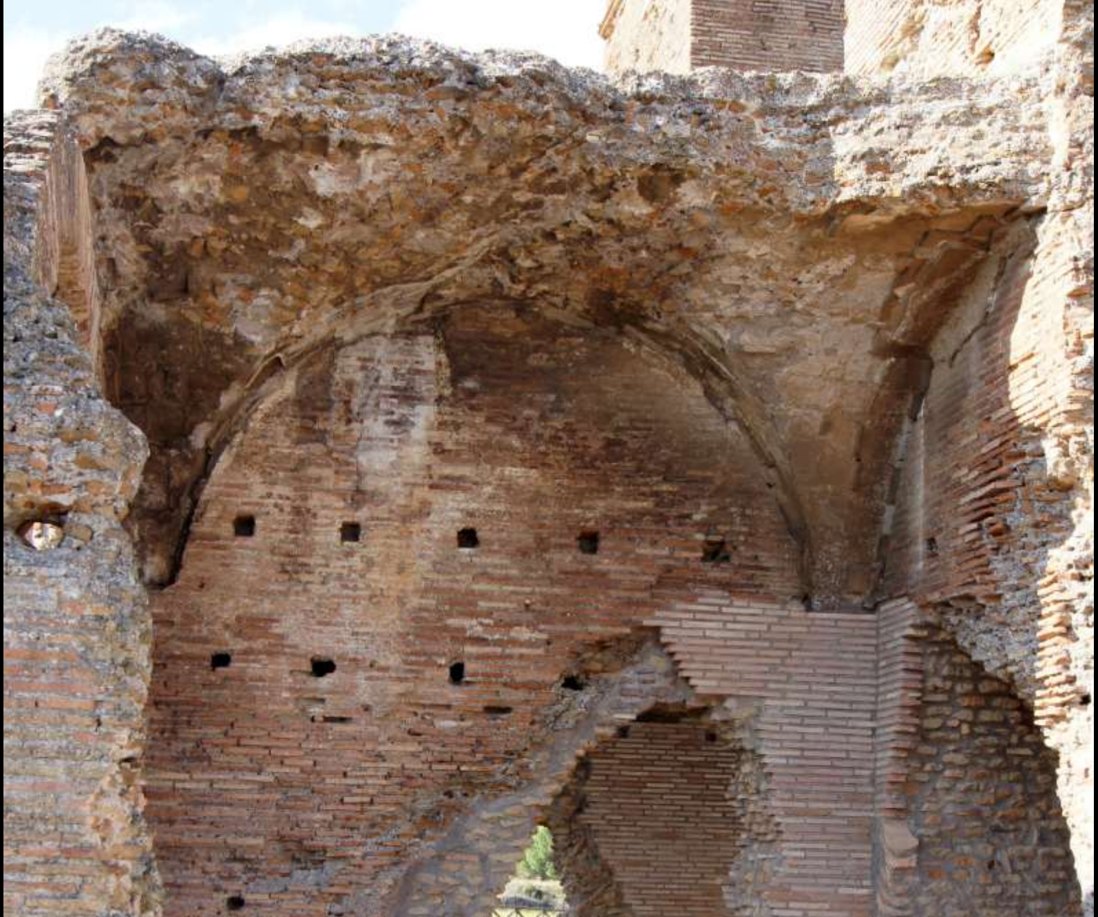
In horizontalen Lagen eingebrachtes Opus caementicium an einem Kreuzgewölbe (Via Appia, Villa der Quintilii, 2. Jh. n. Chr.)
