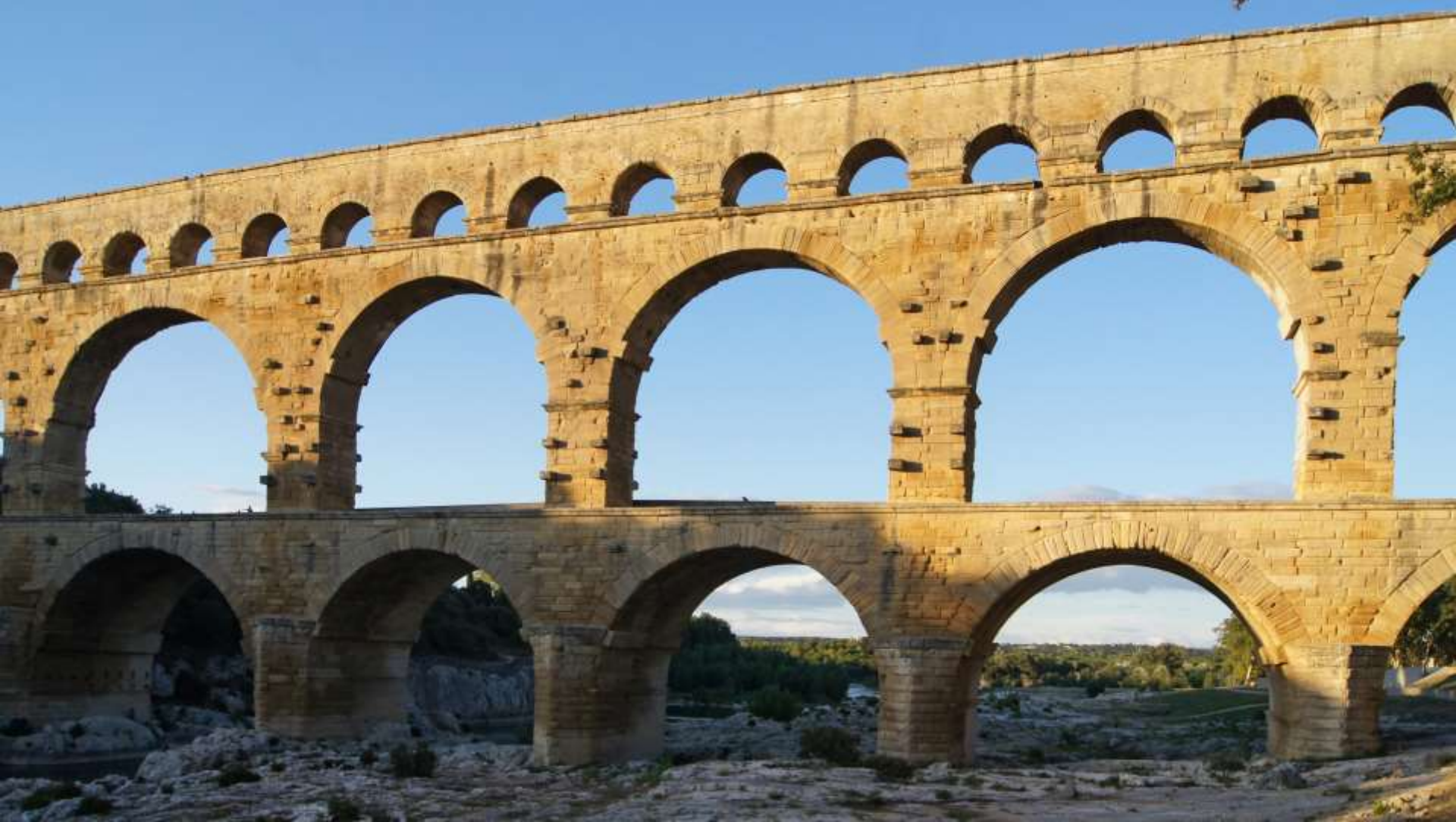
Wasserversorgung als Repräsentationsaufgabe: Aquädukt Nîmes, Pont du Gard (1. Jh. n. Chr.) in Grossteinbauweise
