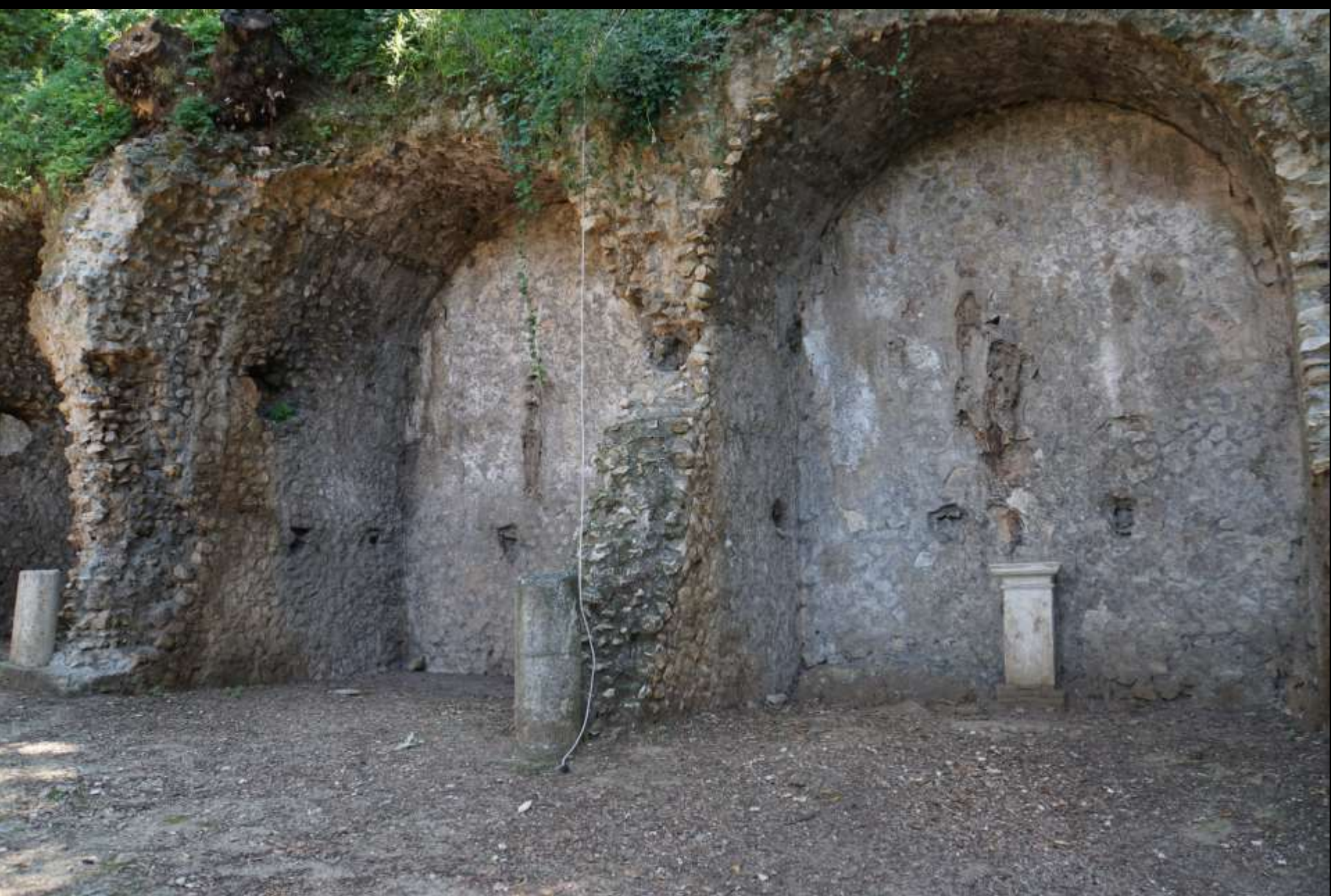
Auf Schalung hergestellte Tonnengewölbe aus Bruchstein (Tivoli, Villa des Manlius Volpiscus, 1. Jh. n. Chr.)
