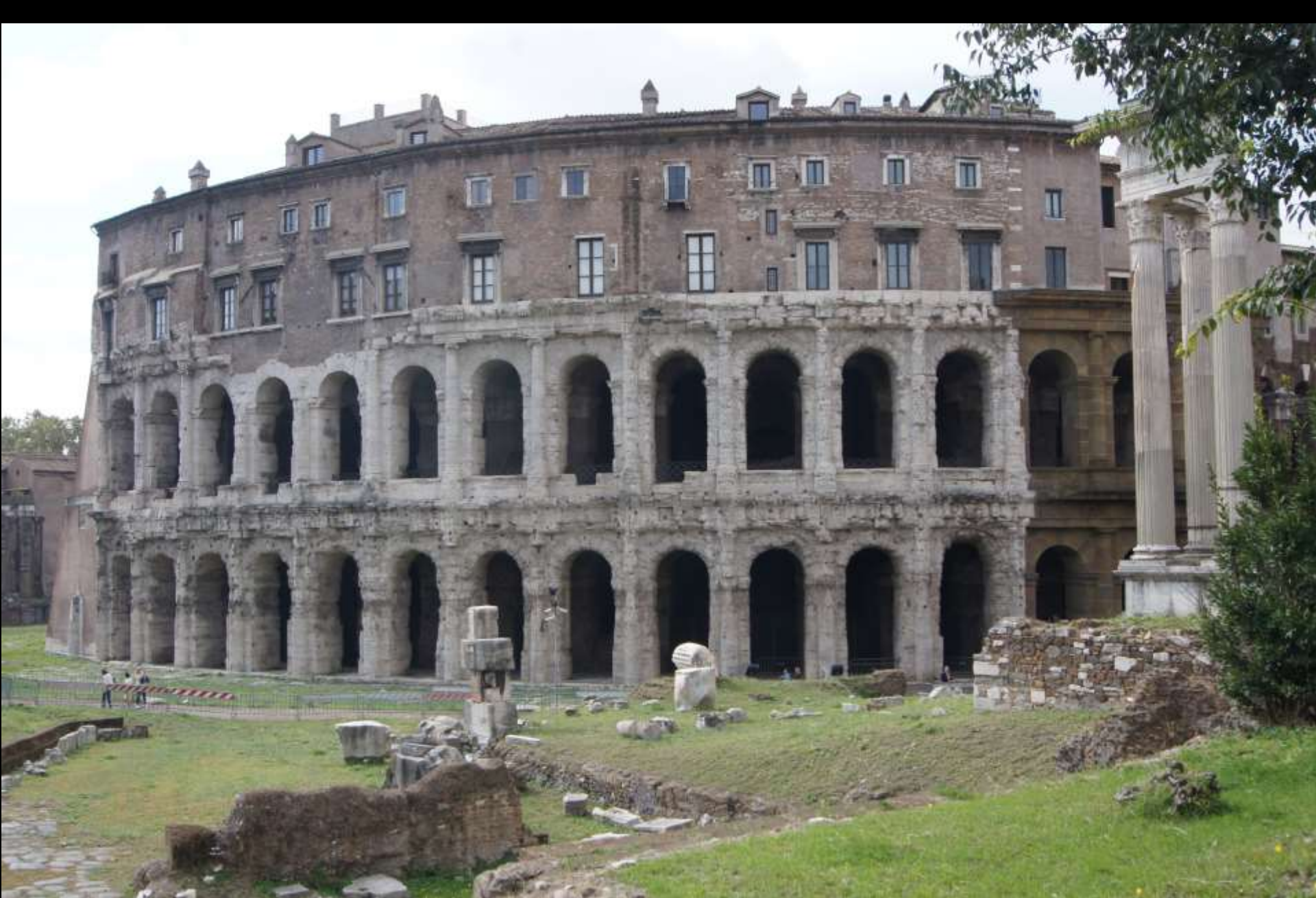
Fassade mit Bogenstellungen und aufgeblendeter Ordnung aus Halbsäulen (Rom, Marcellustheater, 1. Jh. v. Chr.)
