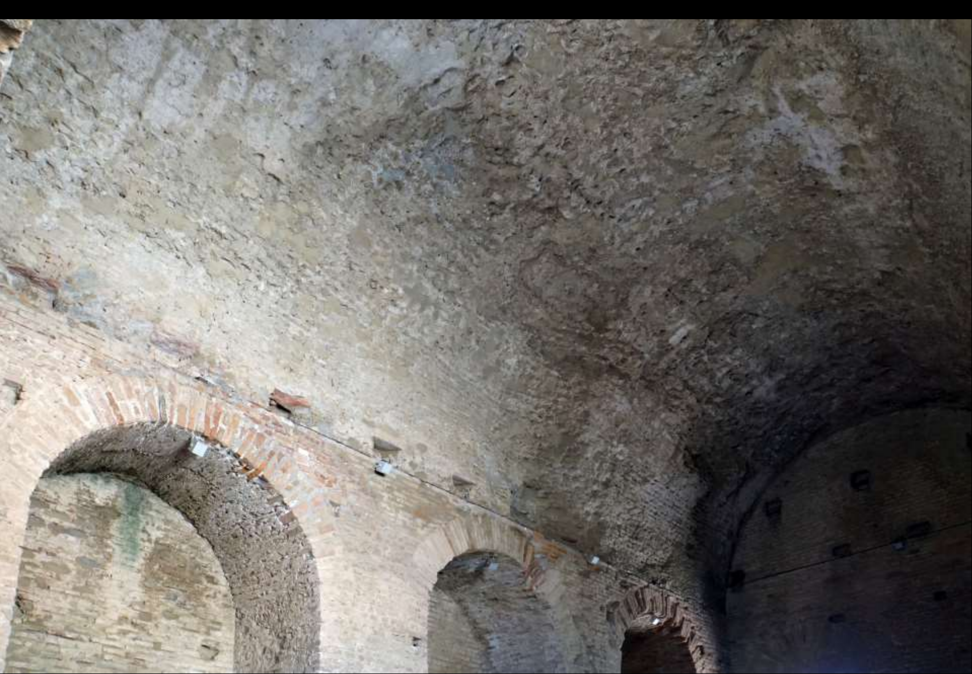
Tonnengewölbe und Lehrgerüstspuren (Taormina, römisches Theater)
