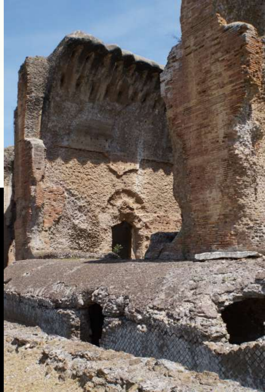
Tivoli, Villa Adriana, „Grosse Thermen“. Heizgang im Keller vor der Fassade.
