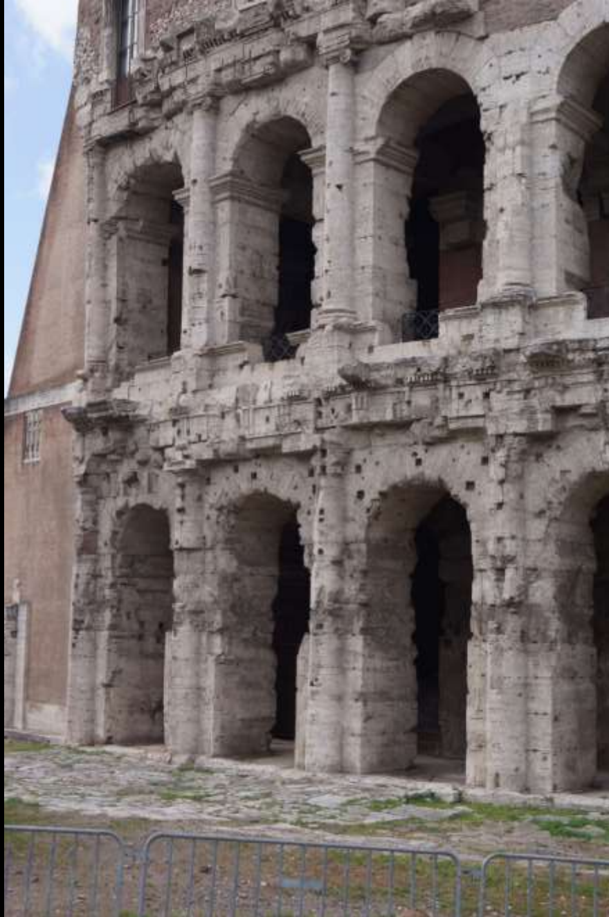
Fassade mit Bogenstellungen und aufgeblendeter Ordnung aus Halbsäulen (Rom, Marcellustheater, 1. Jh. v. Chr.)
