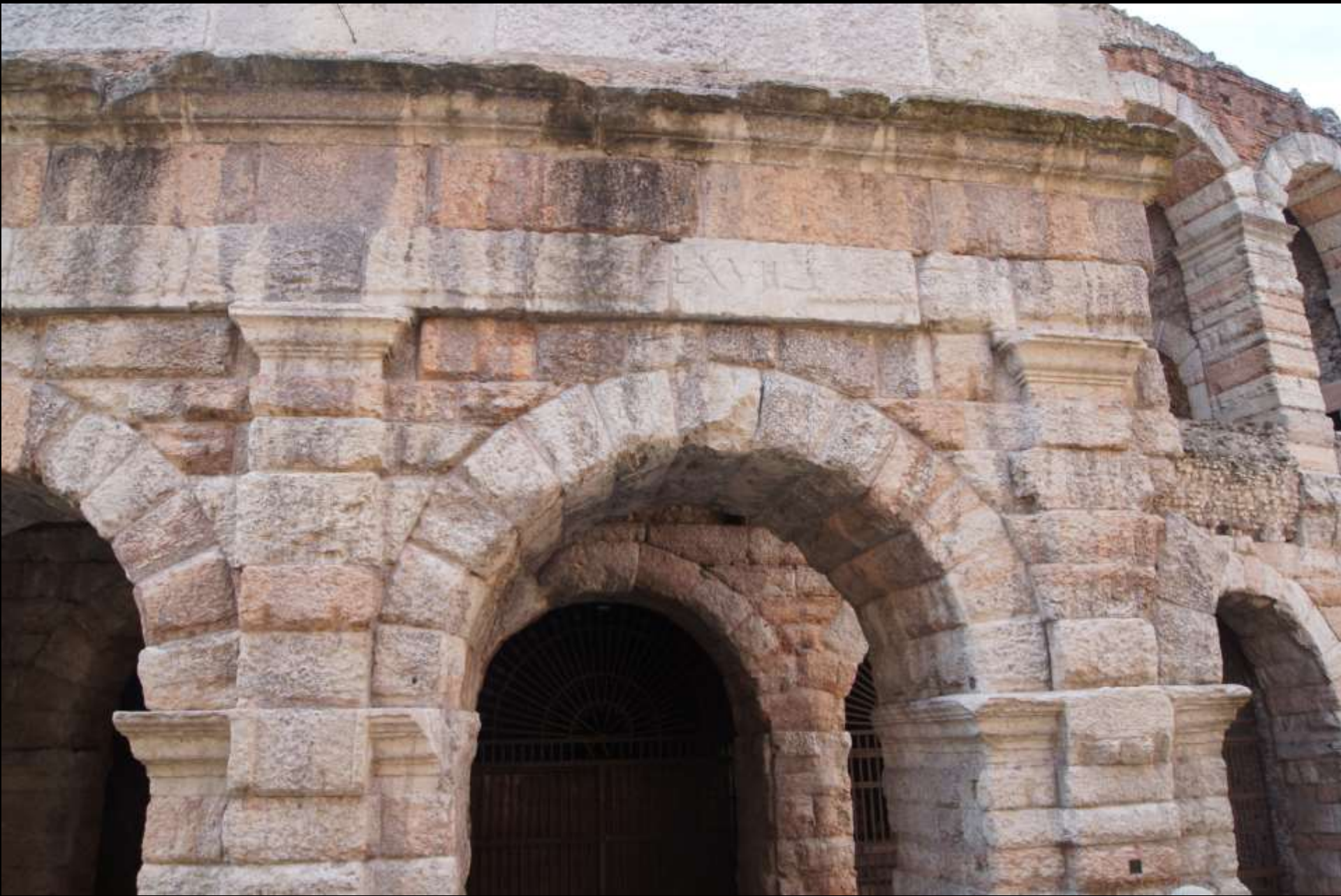
Fassade mit Bogenstellungen und aufgeblendeter Ordnung aus Pilastern (Verona, Amphitheater, 1. Jh. n. Chr.)
