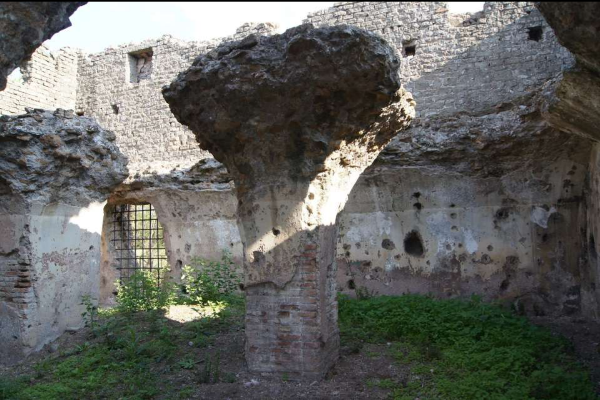
Rom, Wasserreservoir mit wasserdichtem Putz (Opus signinum), Villa dei Quintili (2. Jh. n. Chr.)
