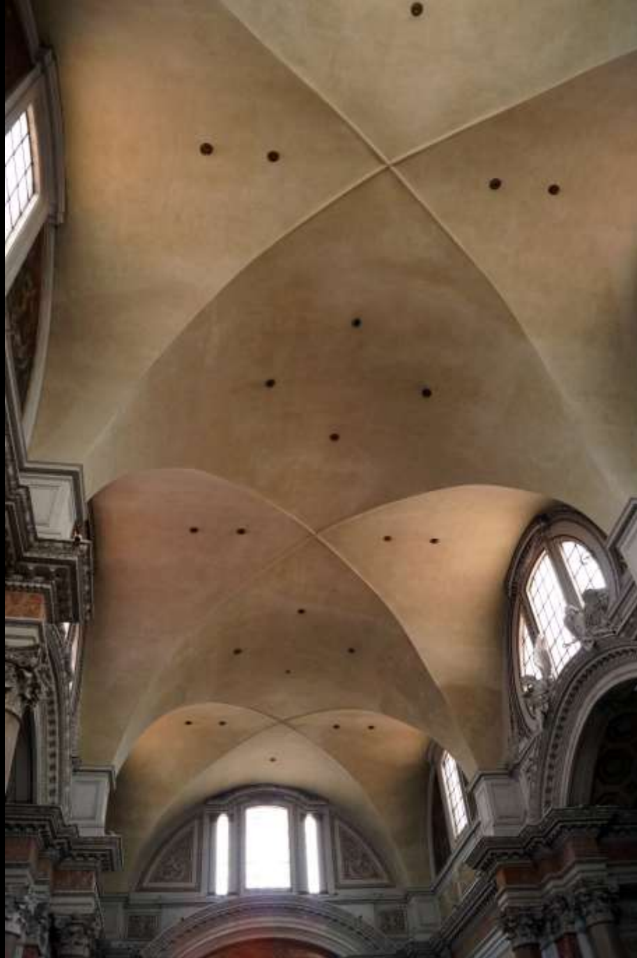
Rom, Diokletiansthermen, Frigidarium. Kreuzgewölbe.
