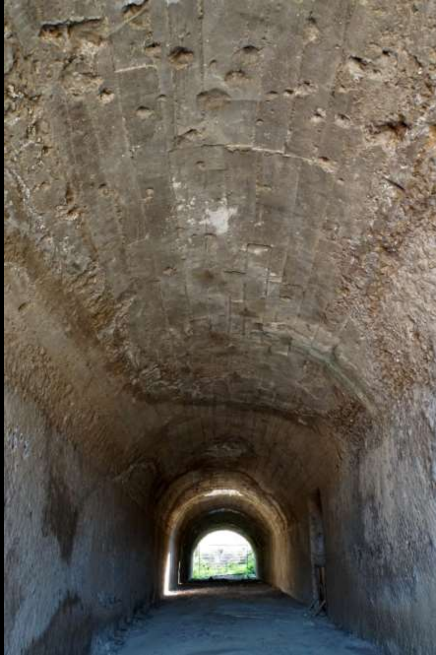
Tonnengewölbe (Tivoli, Villa Adriana, 2. Jh. n. Chr.)
