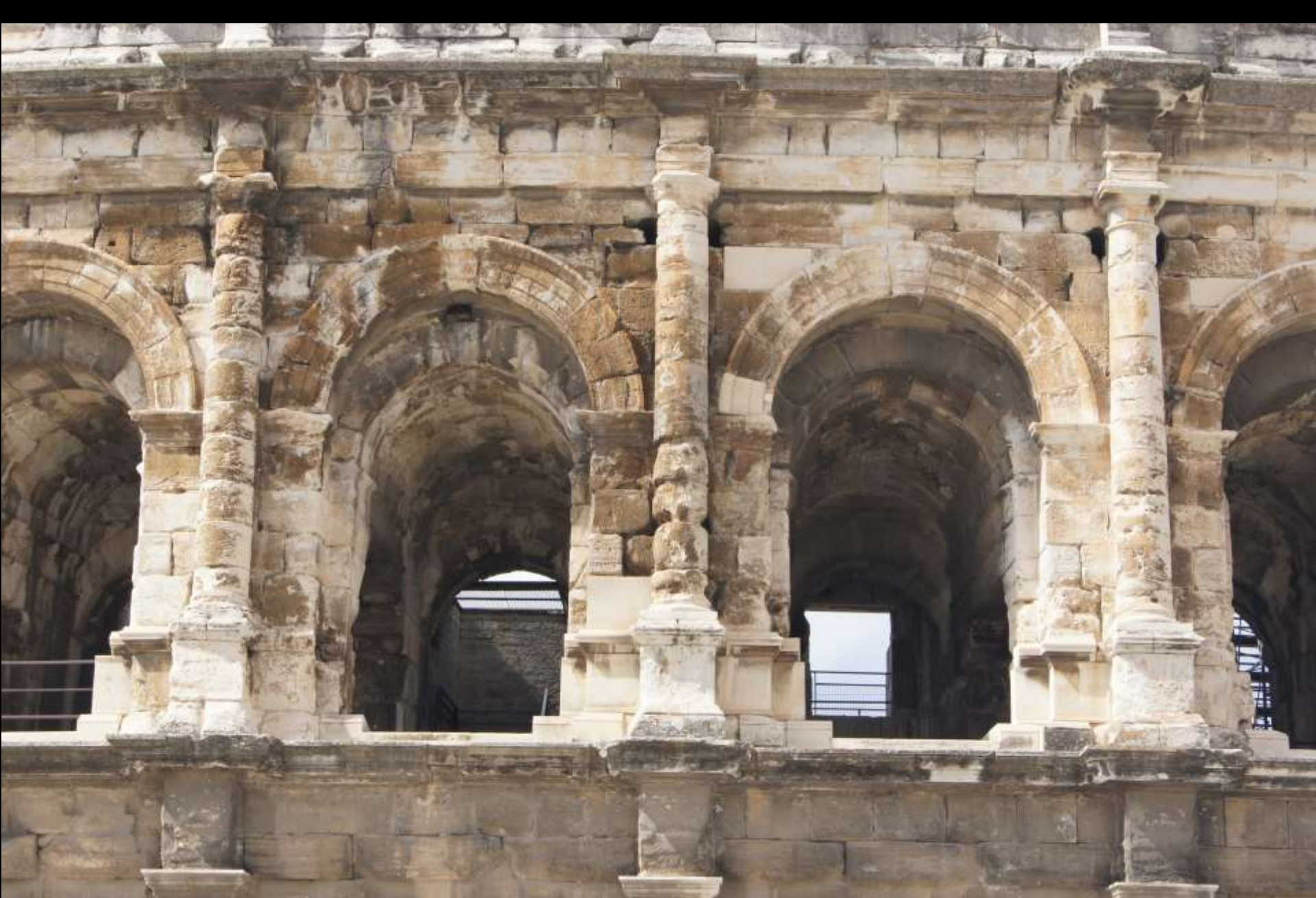
Fassade mit Bogenstellungen und aufgeblendeter Ordnung aus Halbsäulen. (Nîmes, Amphitheater, 1. Jh. n. Chr.)
