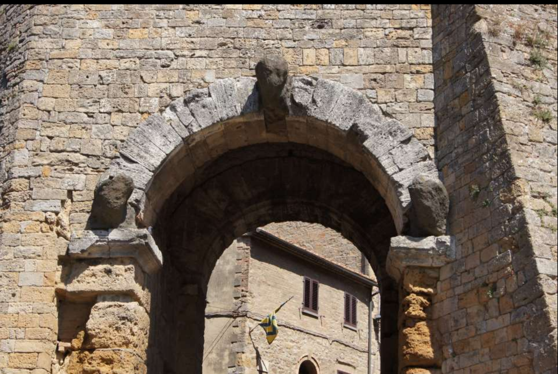
Keilsteinbogen (Volterra, römisches Stadttor, 3. oder 2. Jh. v. Chr., Feldseite)
