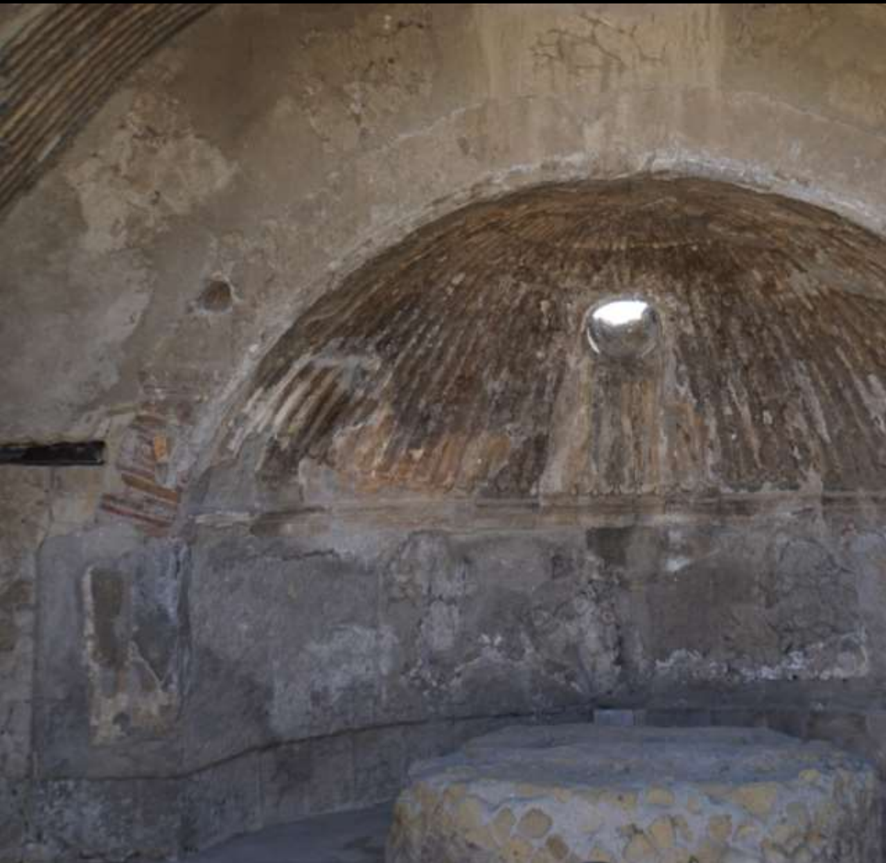
Caldarium mit Sockel für das labrum (Becken) (Thermen in Herculaneum; Foto: J. Schäfer)
