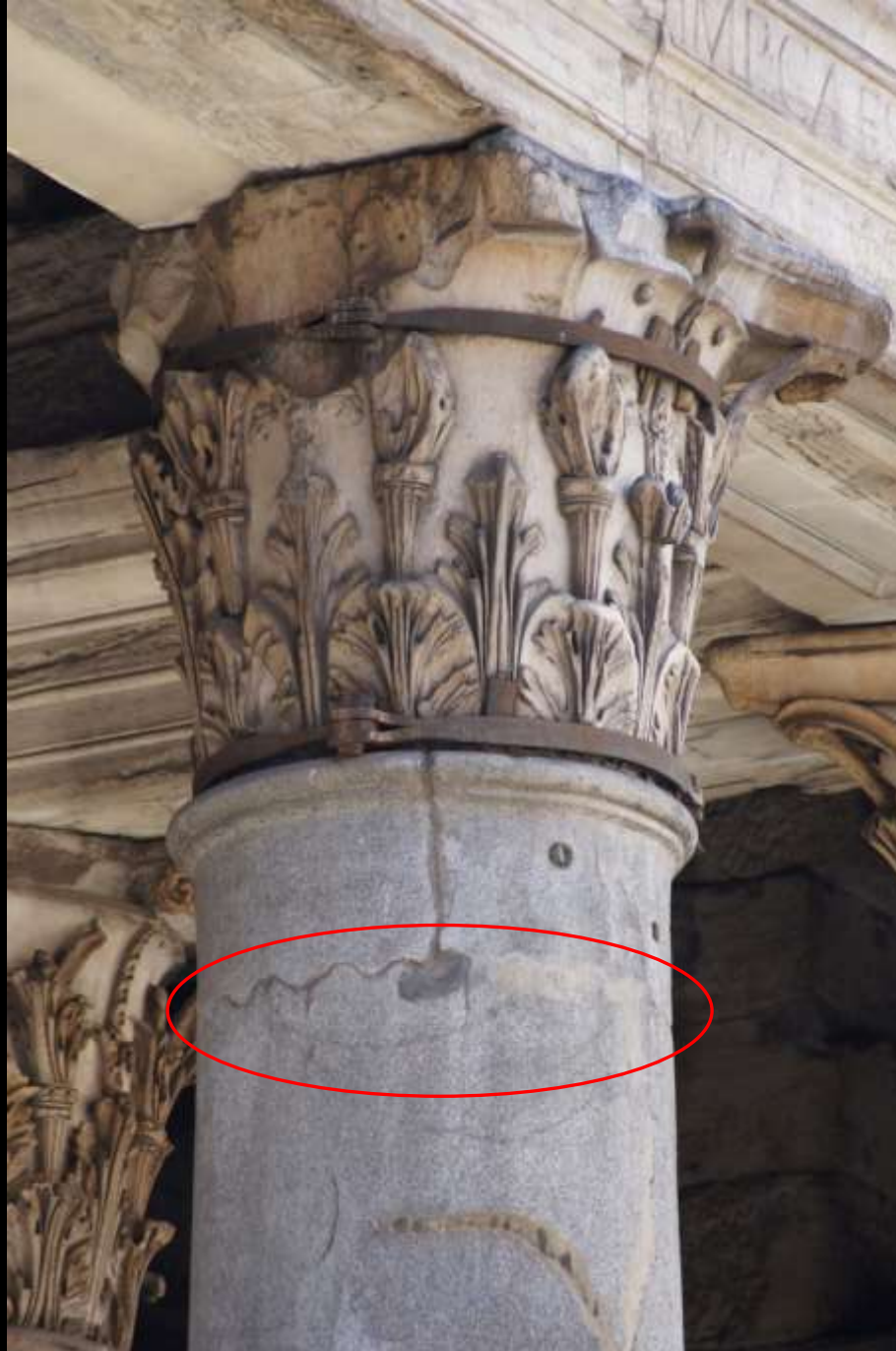
Rom, Pantheon. Portikus. Verlängerungsstück an einer der grauen Säulen
