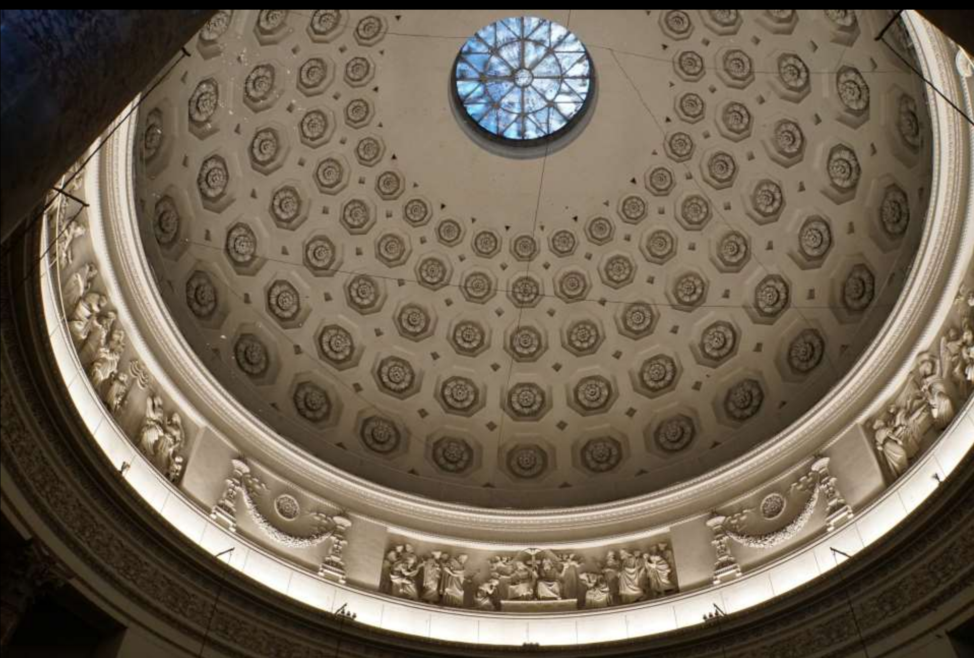
Rezeption des Pantheons in späterer Architektur Turin, Chiesa della Gran Madre di Dio (1818–31). Kuppeldurchmesser 21 m.
