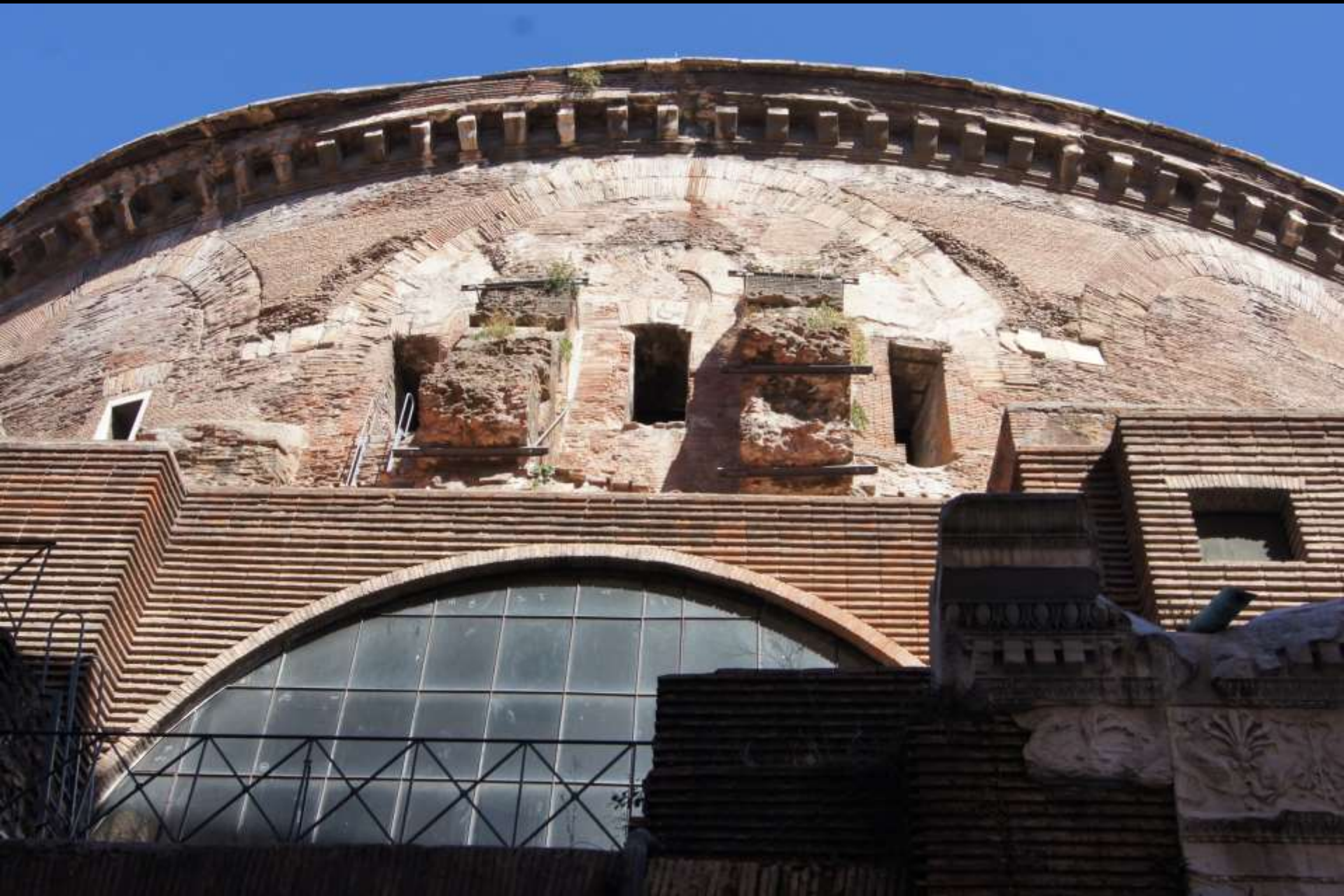
Rom, Pantheon. Aussenbau der Rotunde mit Strebepfeilern
