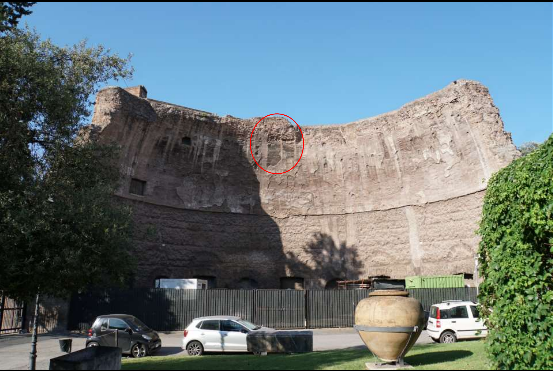
Schalbrettabrücke an einer Exedra der Diokletiansthermen (um 300 n. Chr.)
