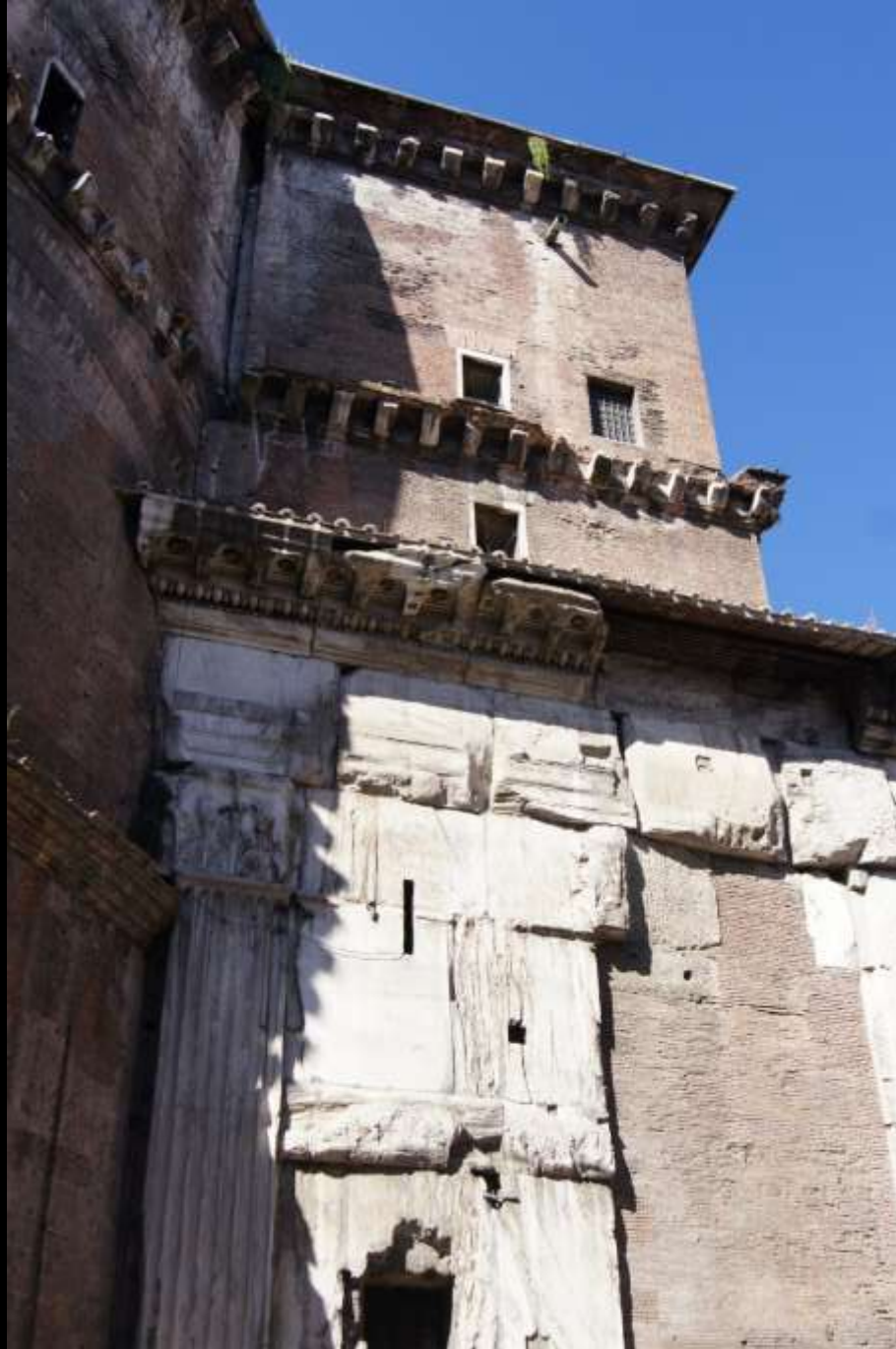
Rom, Pantheon. Aussenbau. Übergang vom Portikus zur Rotunde. Marmorverkleidung
