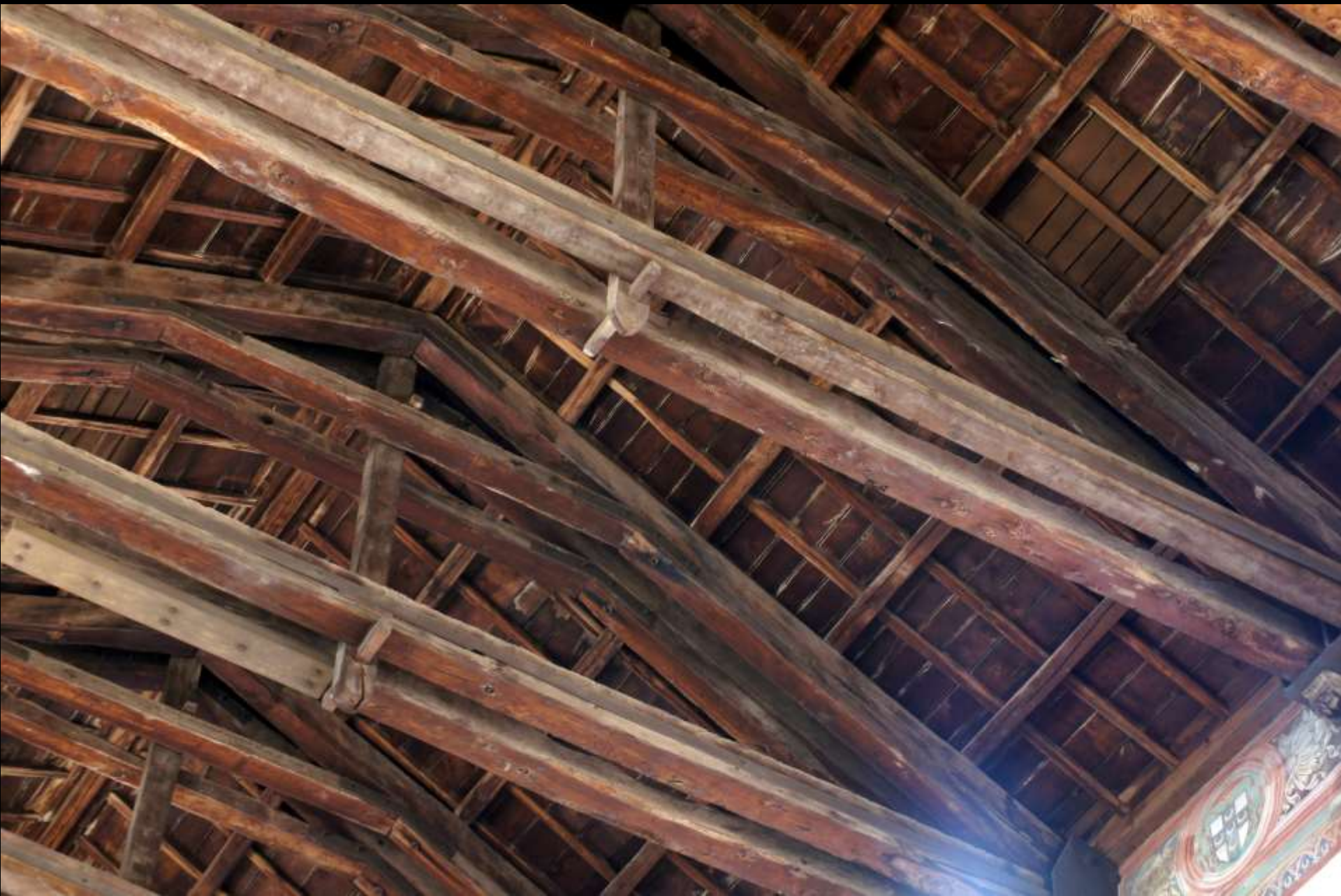
Rom, San Saba. Doppelbindersystem.
