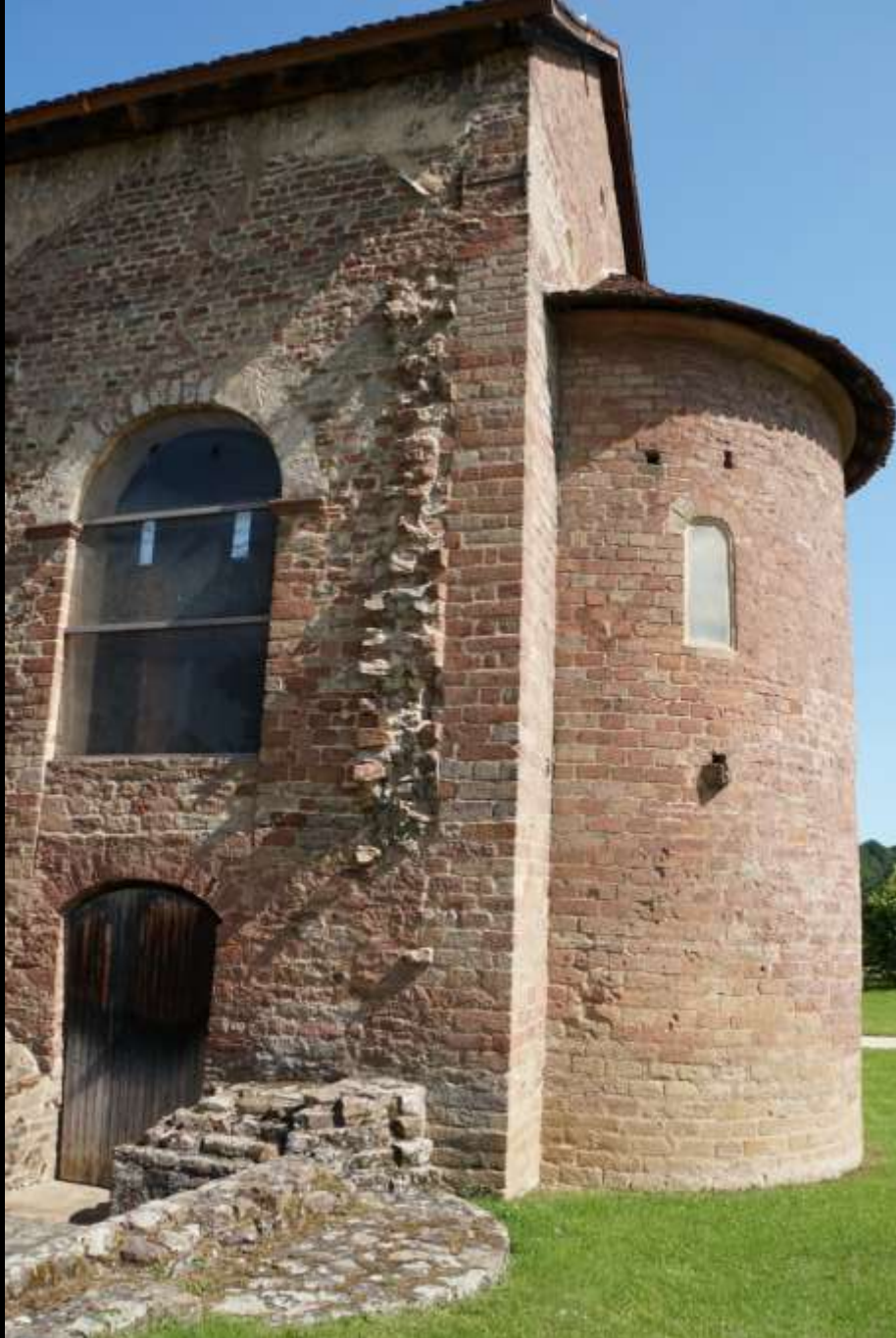
Steinbach bei Michelstadt im Odenwald, sogenannte Einhardsbasilika (1. H. 9. Jh.). Kleinquadermauerwerk
