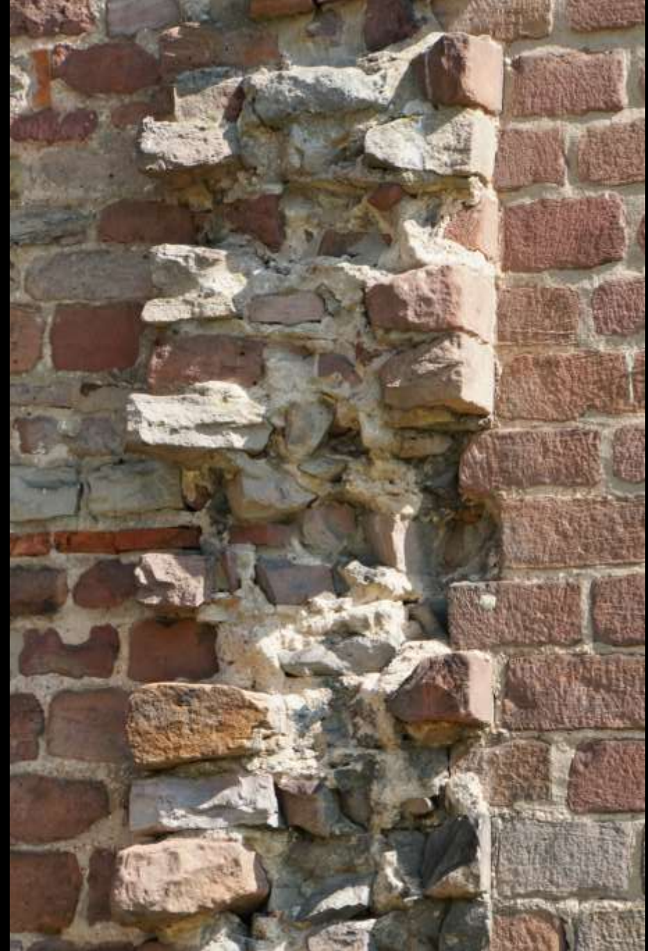
Steinbach bei Michelstadt im Odenwald, sogenannte Einhardsbasilika (1. H. 9. Jh.). Kleinquadermauerwerk
