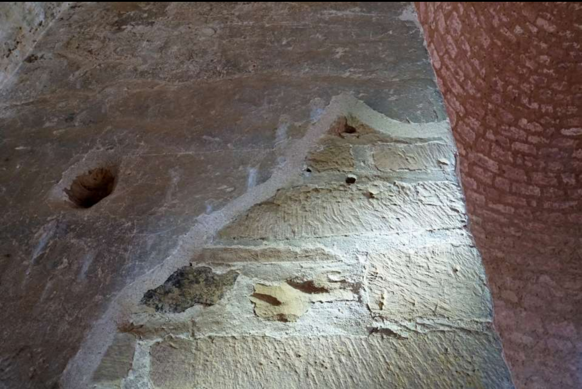
Steinbach bei Michelstadt im Odenwald, Einhardsbasilika (1. H. 9. Jh.). Verputztes Kleinquadermauerwerk
