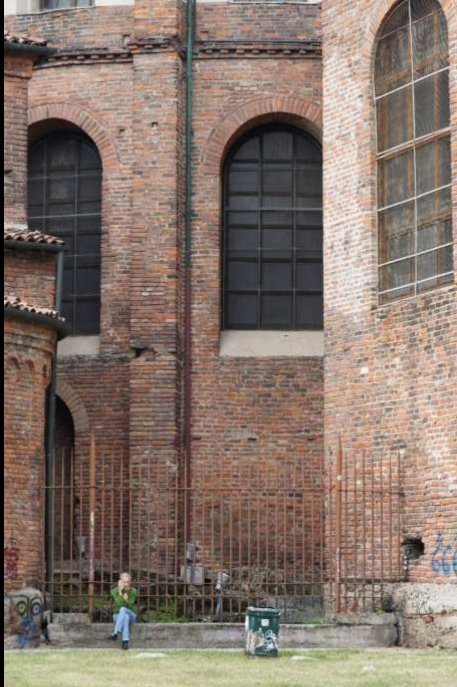
Mailand, San Lorenzo, Mauerwerk des spätantiken Kernbaus
