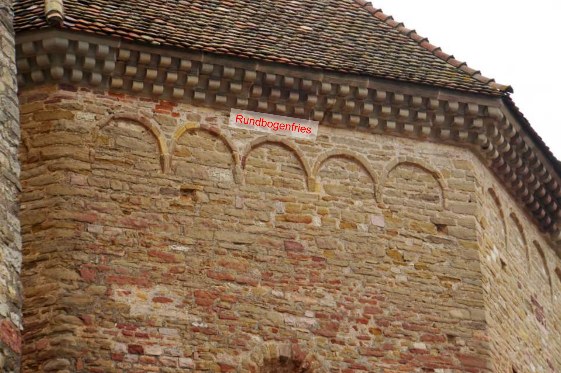
Ottmarsheim (Elsass), Abteikirche (1. H. 11. Jh.). Bruchstein, Rundbogenfries (Leitmotiv der Frühromanik) (ursprünglich verputzt, Klötzchenfries ist eine moderne Ergänzung)
