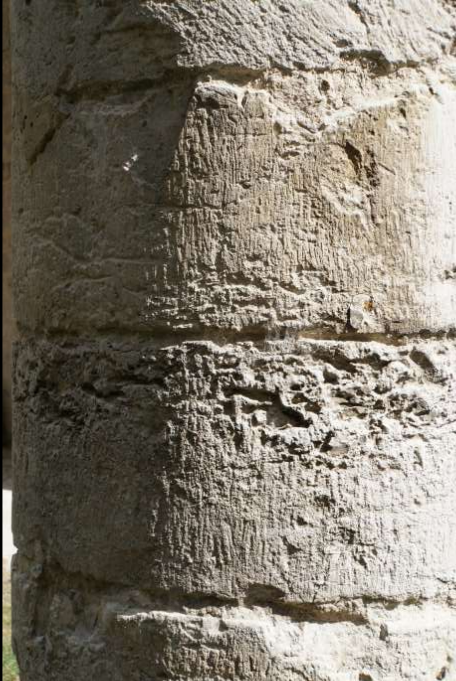
Jumièges (Normandie), Steinbearbeitung mit dem Beil („Glatfläche“).
