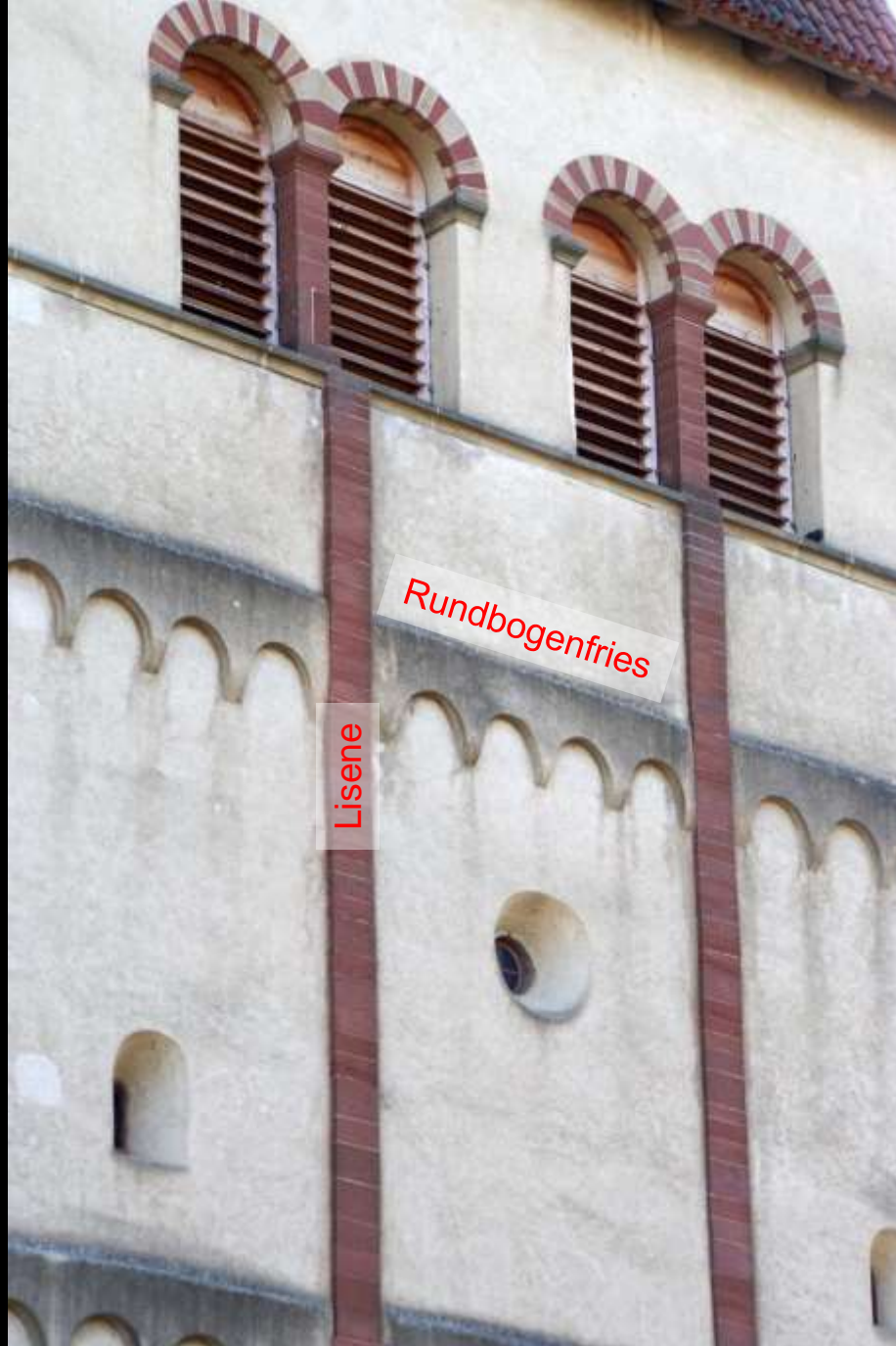
Reichenau, Münster Mittelzell, Wandgliederung mit Lisenen und Rundbogenfries. Leitmotiv der Frühromanik
