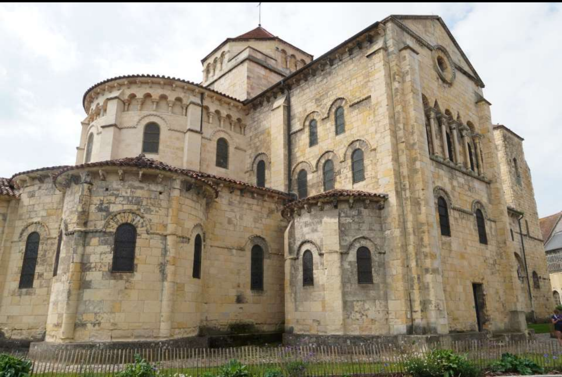
Nevers, Abteikirche Saint-Étienne, Blick auf den Umgangschor mit Radialkapellen. Werkstein
