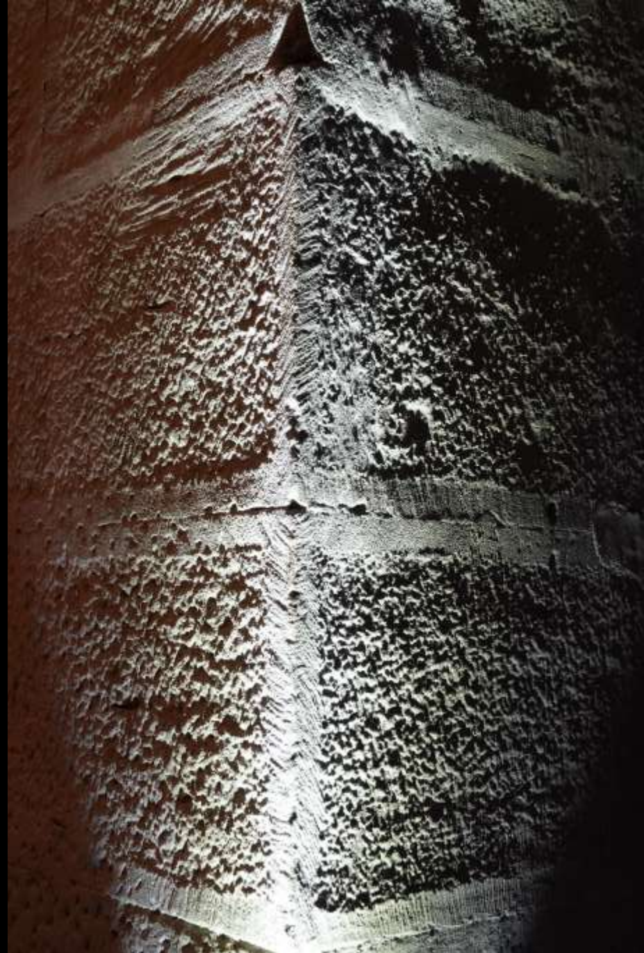
Konstanz, Münster. Steinbearbeitung an Bauteilen des 11. Jh.
