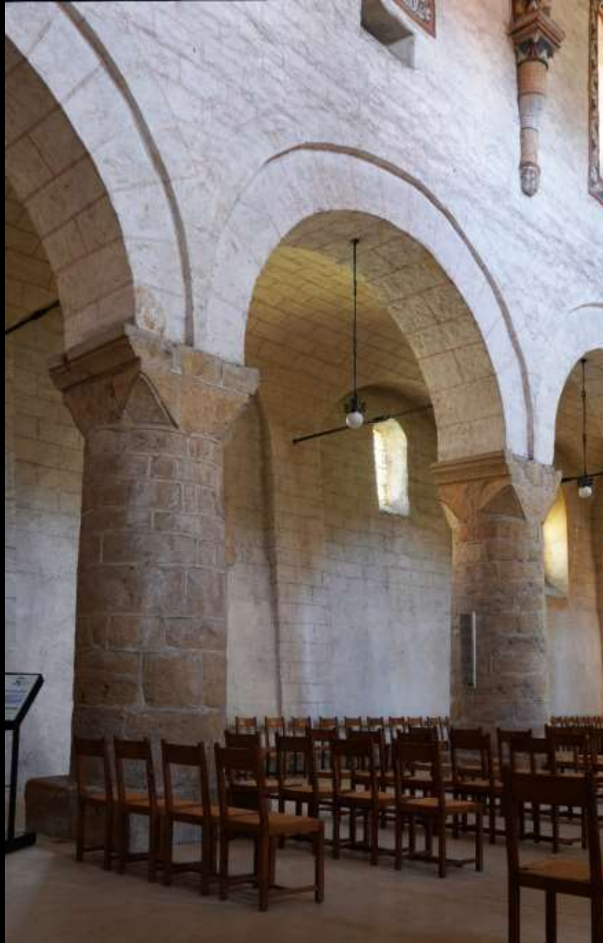
Romainmôtier, Abteikirche. In Werkstein gemauerte Rundpfeiler. Alles Übrige ist Bruchstein, hier verputzt.
