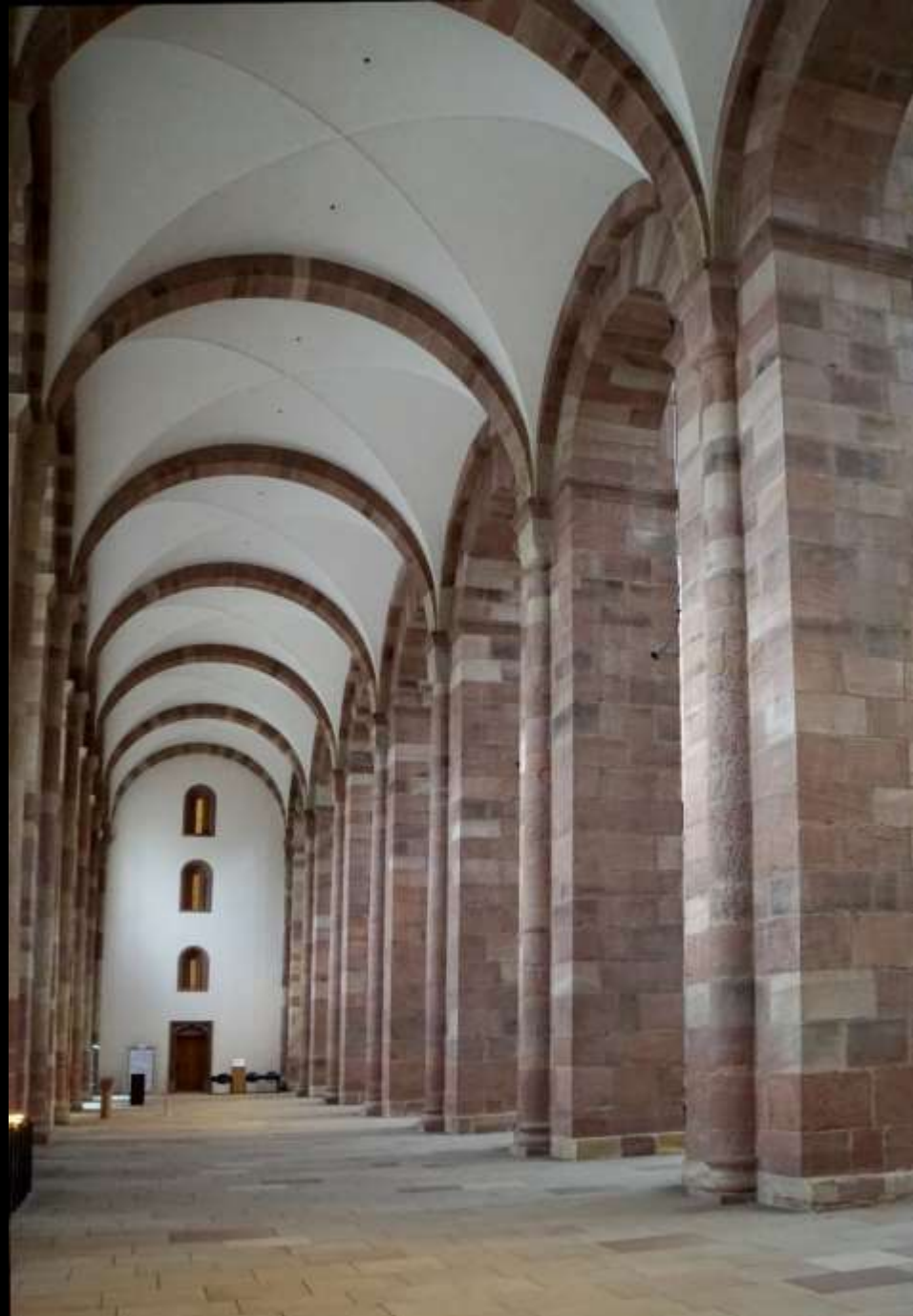
Speyer, Dom, Bau I, 1025–61, Seitenschiff mit Kreuzgratgewölben (9 m Spannweite) und Werksteinstützen.
