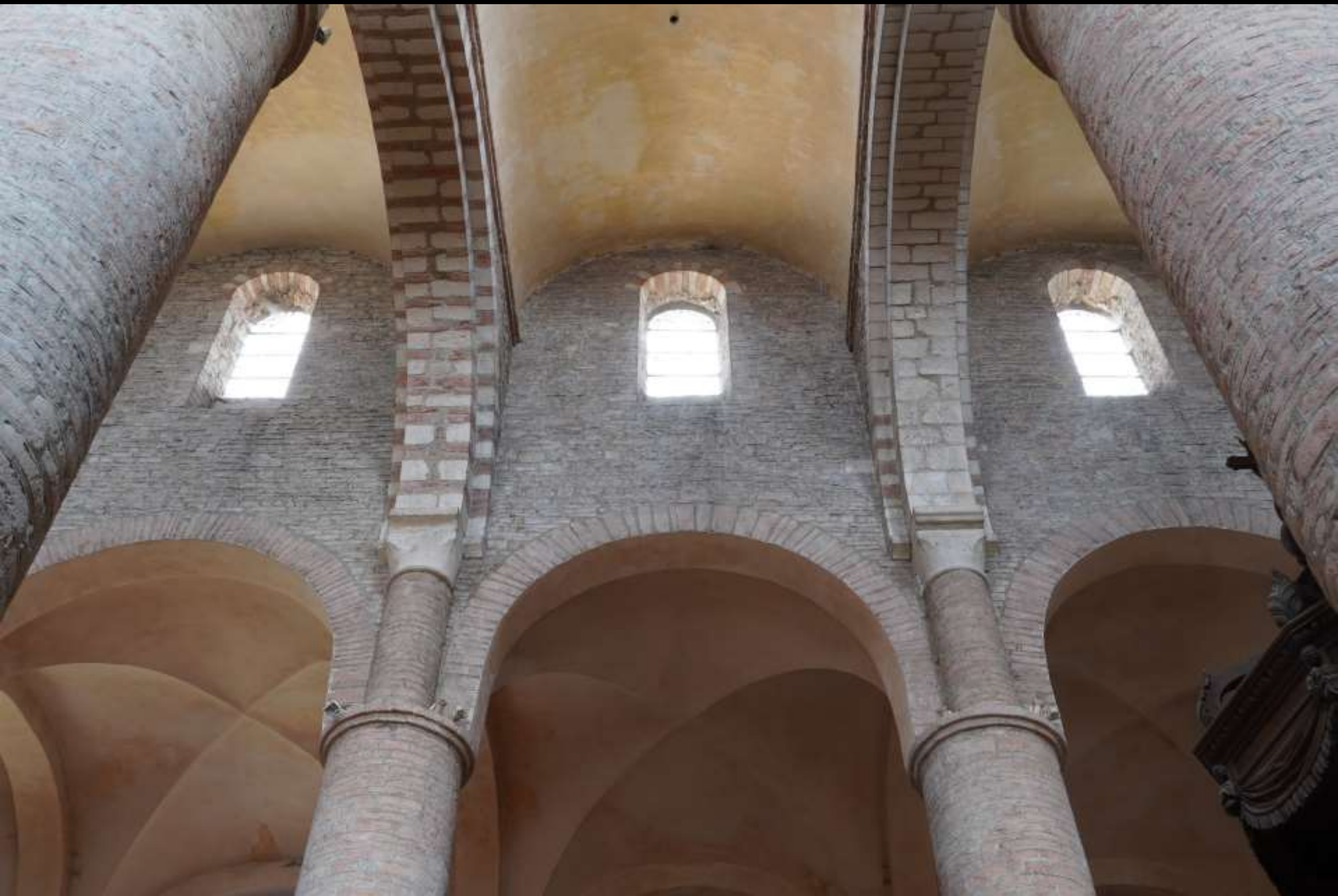
Tournus, Saint-Philibert. Langhaus, Mittelschiff, Quertonengewölbe.
