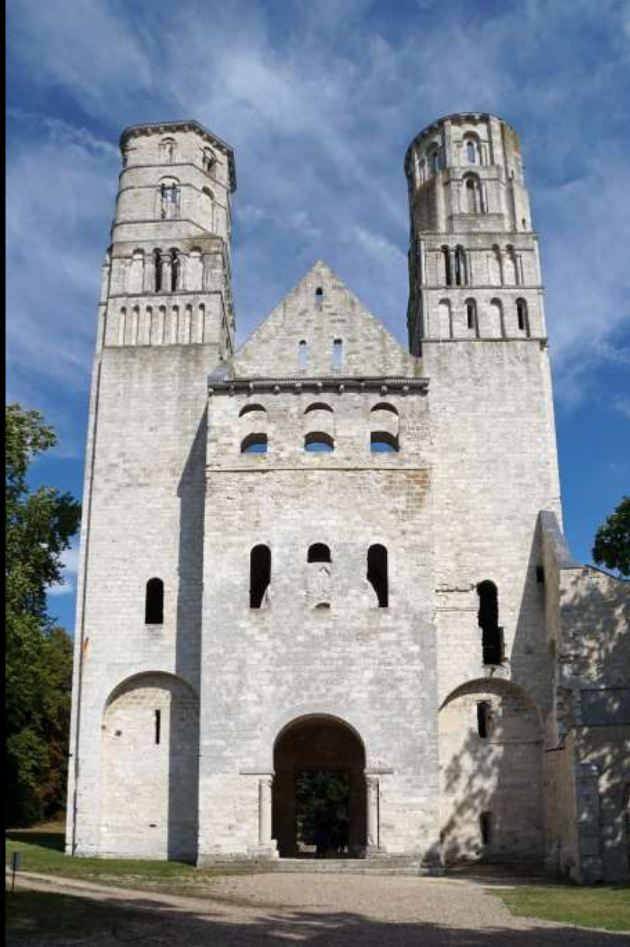
Jumièges (Normandie), Zweiturmfassade in reinem Werksteinmauerwerk.
