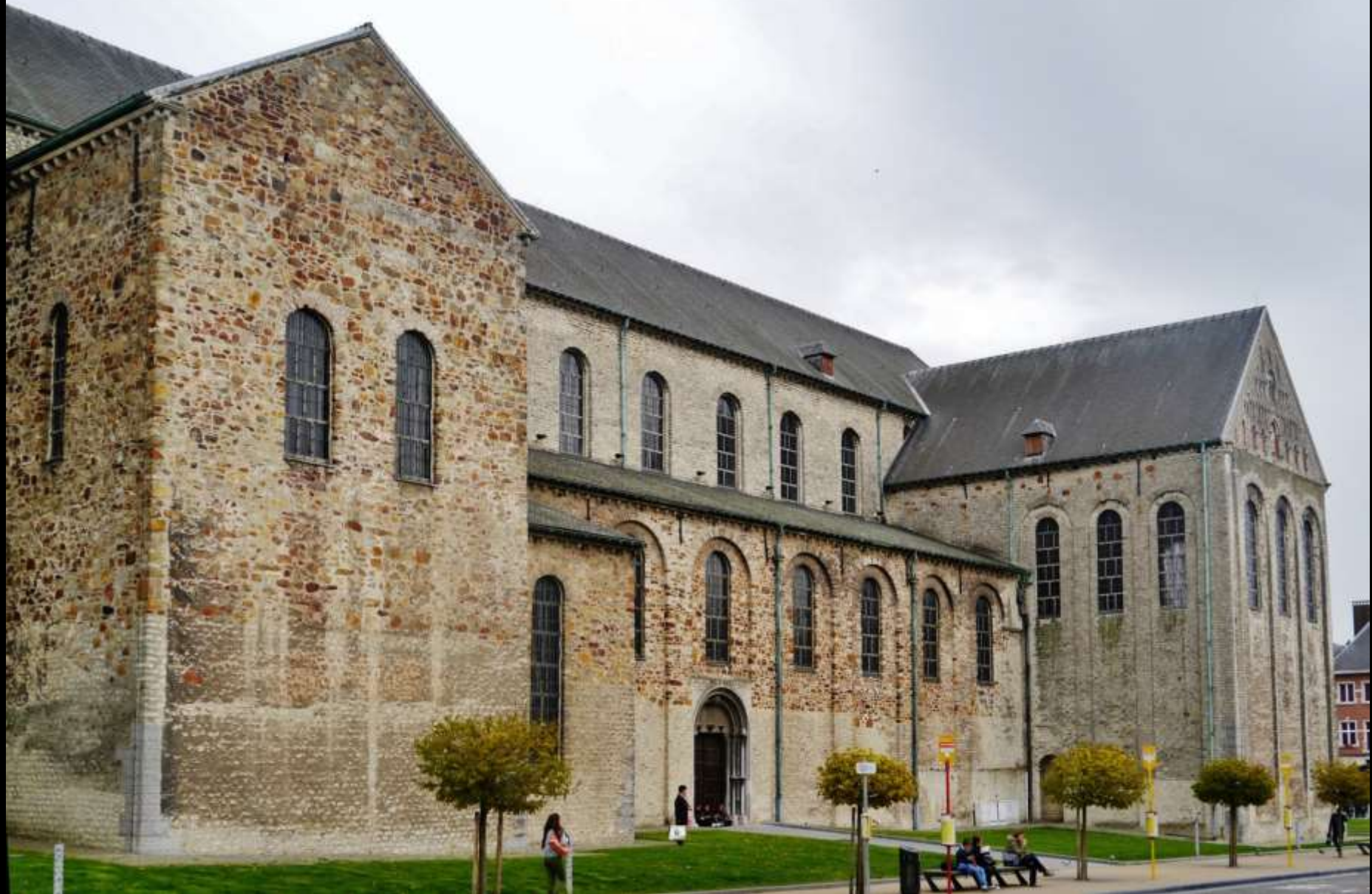
Nivelles (Belgien), Sainte-Gertrude (1. H. 11. Jh.). Bruchsteinbau mit Blendarkadengliederung bis zu schwerer Beschädigung im II. Weltkrieg verputzt (Wikimedia Commons, User Zainron, CC-BY-SA 4.0)
