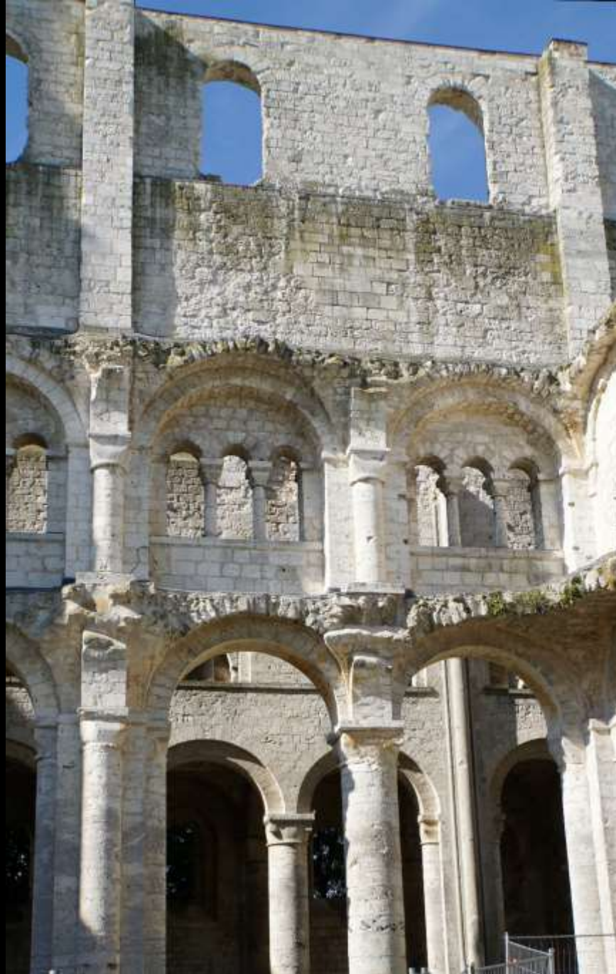
Jumièges (Normandie), Mittelschiffswand von aussen, mit Gewölbeansätzen von Seitenschiff und Empore.
