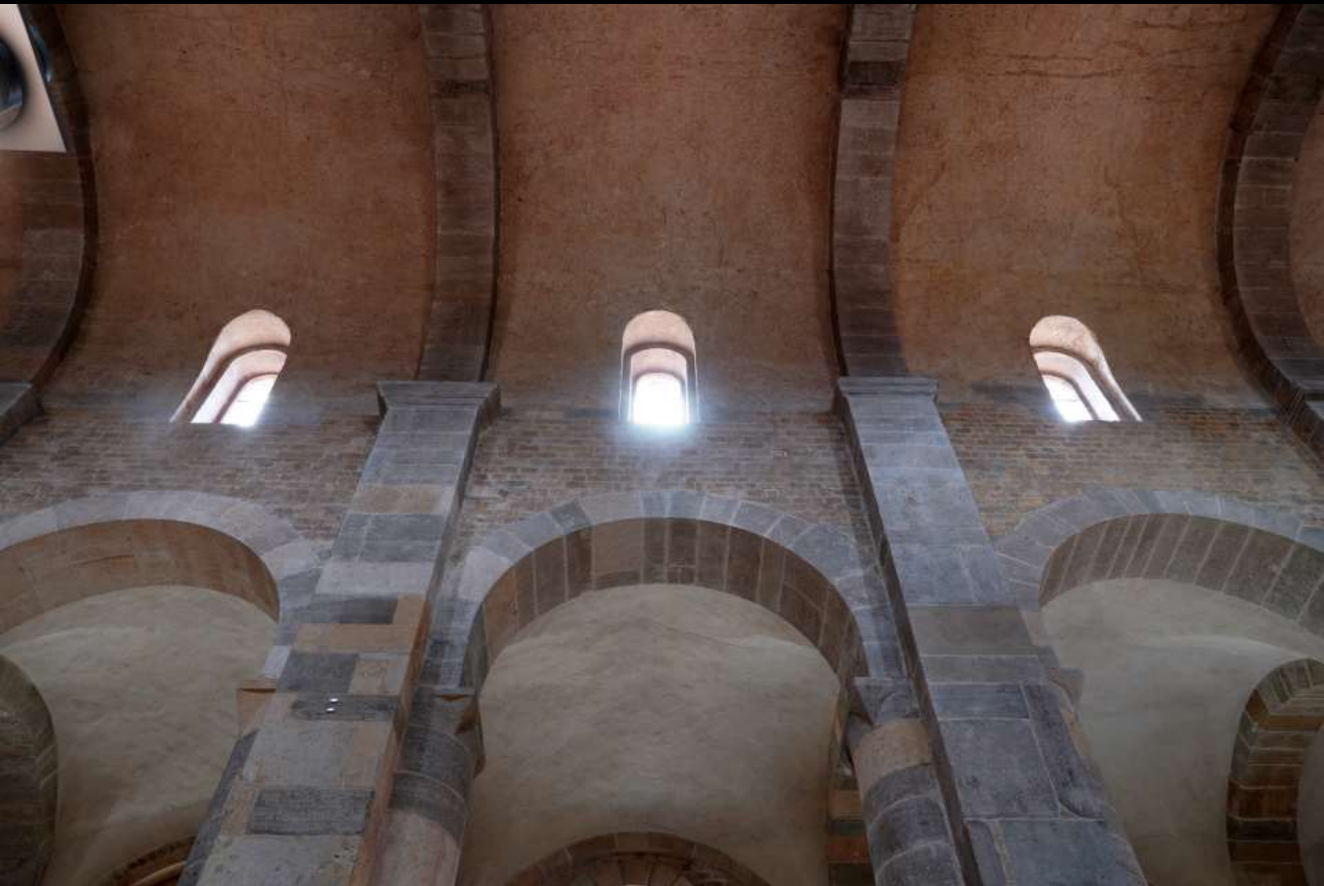
Payerne, Abteikirche, spätes 11. Jh. Langhausgewölbe. Tonne mit Gurtbögen aus Werkstein.
