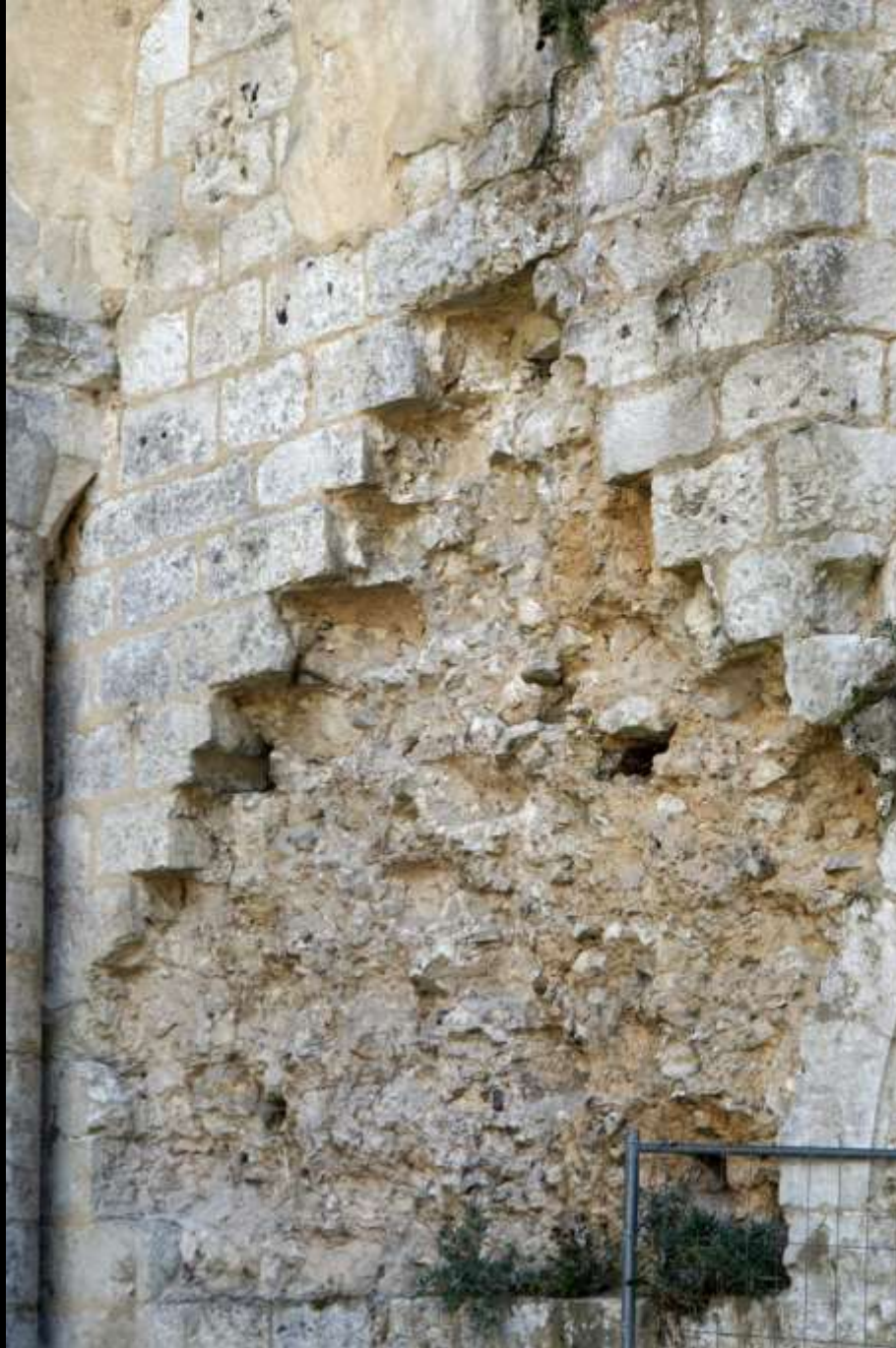
Jumièges (Normandie), mehrschalige Wand mit äusserer Werksteinhaut („moyen appareil“)
