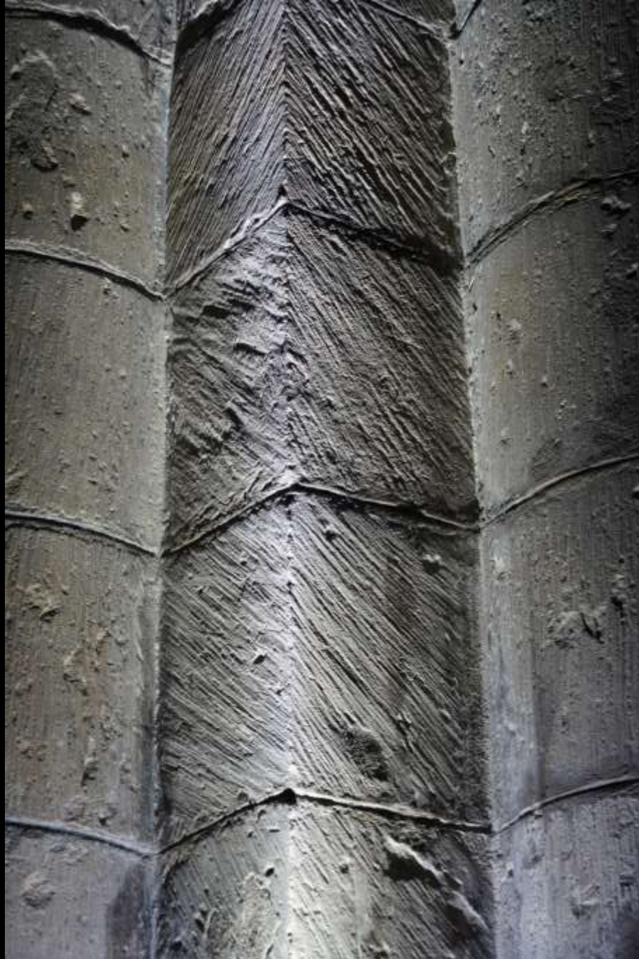
Nevers, Abteikirche Saint-Étienne, Steinbearbeitung mit Glatfläche
