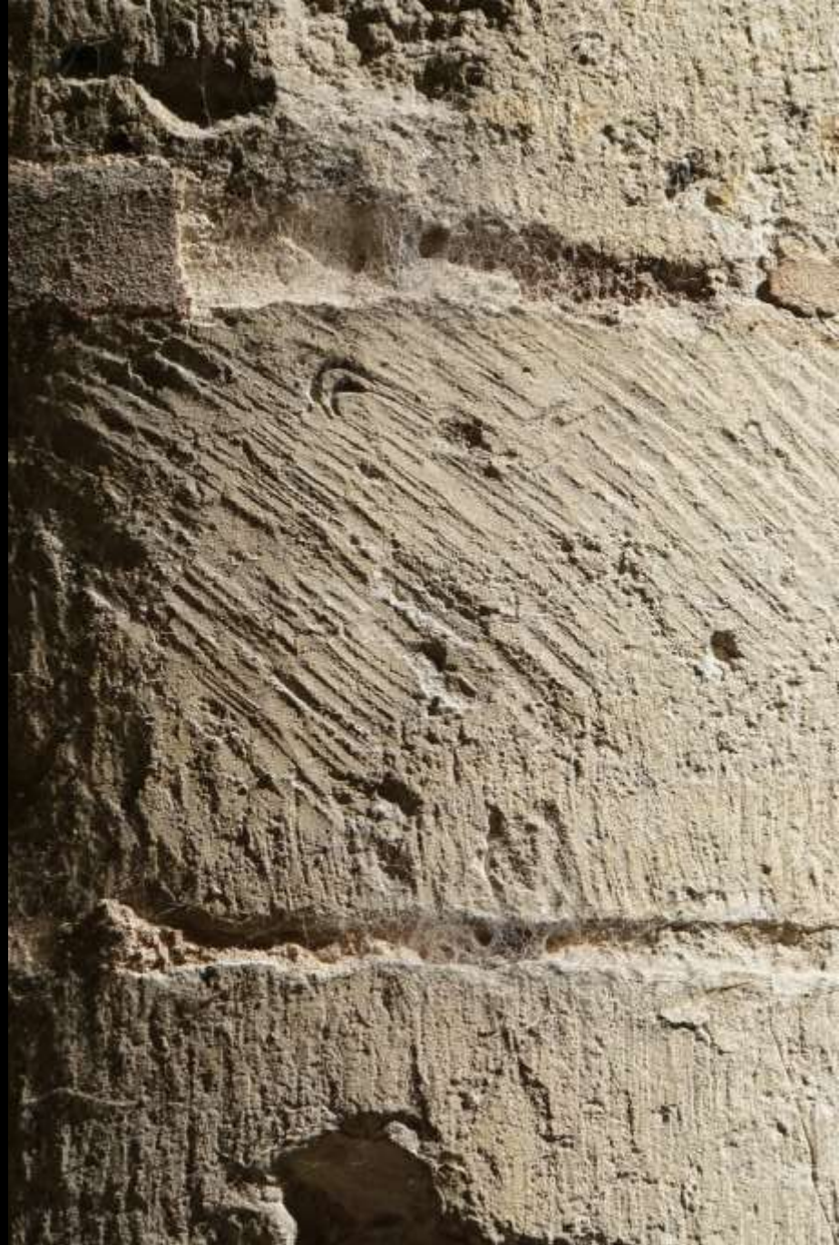
Jumièges (Normandie), Steinbearbeitung mit dem Beil („Glatfläche“).
