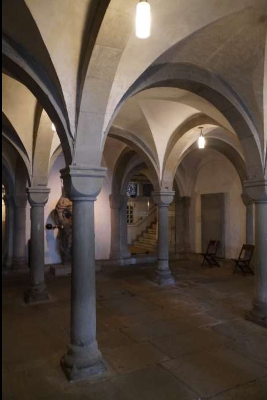
Zürich, Grossmünster, Krypta
