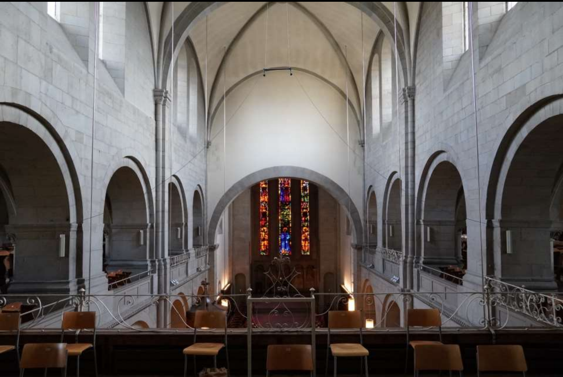
Zürich, Grossmünster, Innenansicht und Kreuzrippengewölbe
