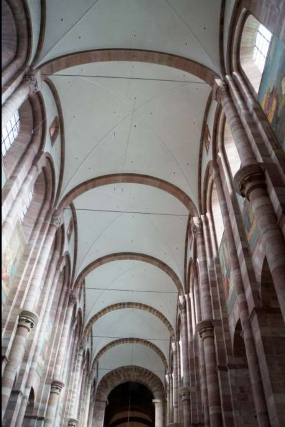
Speyer, Dom, Bau II. Ende 11. Jh. Kreuzgratgewölbe des Mittelschiffs (Kubach/Haas 1972)
