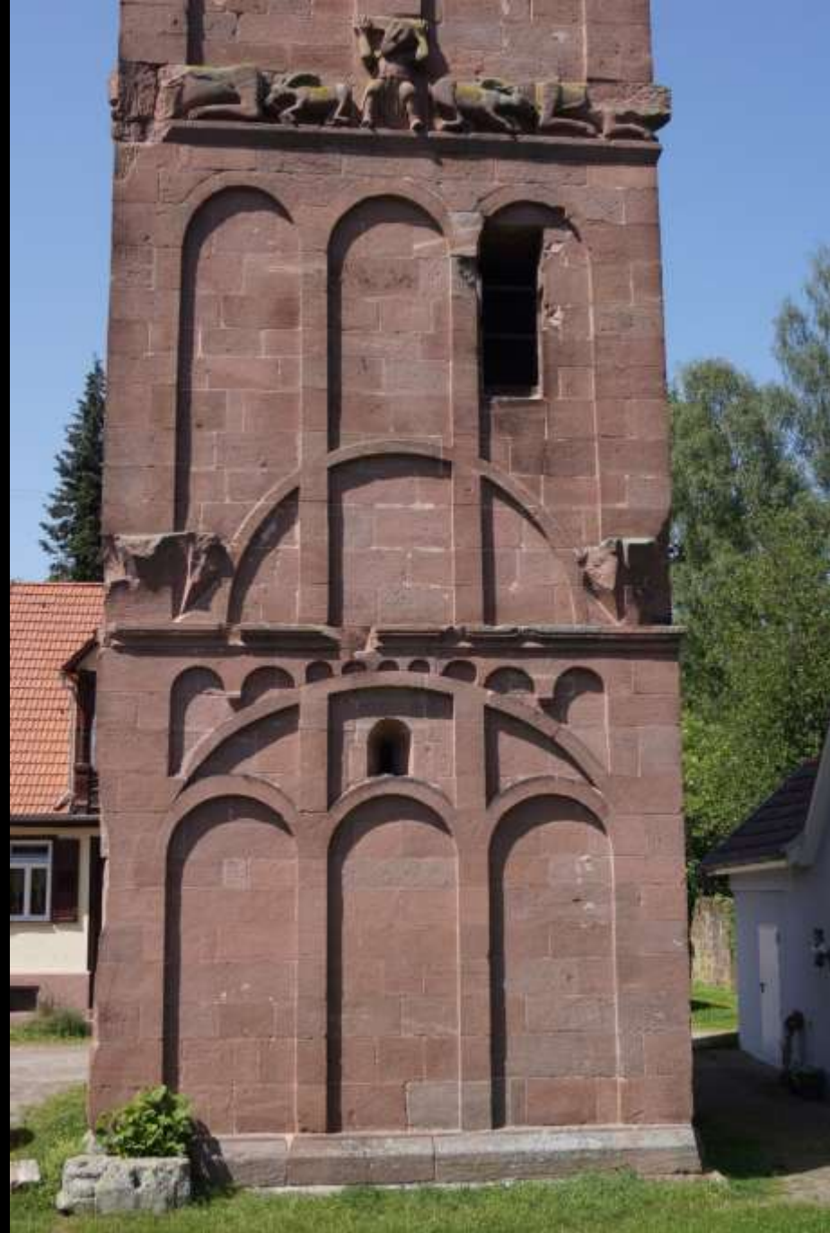
Rundbogenblenden. Hirsau, „Eulenturm“, um 1100
