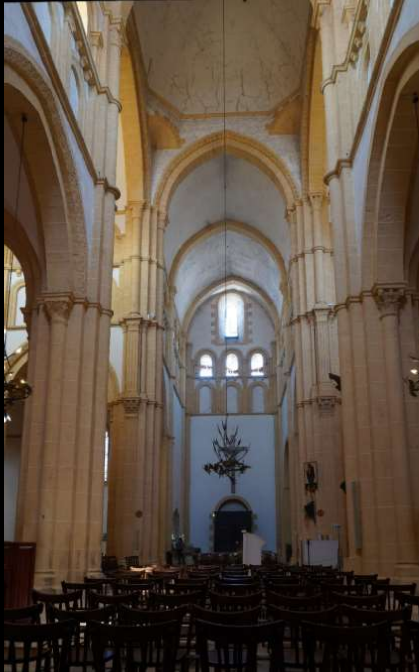
Paray-le-Monial, Abteikirche (12. Jh.) – Wölbung mit Spitztonne im Querschiff
