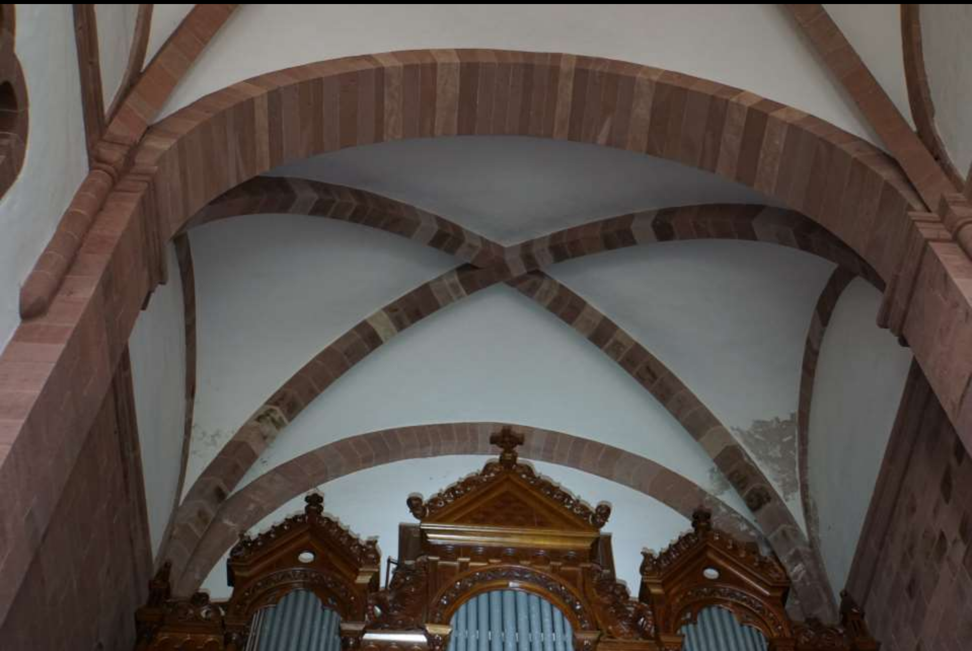
Murbach (Elsass), Ostfassade (1. H. 12. Jh.). Bandrippengewölbe.
