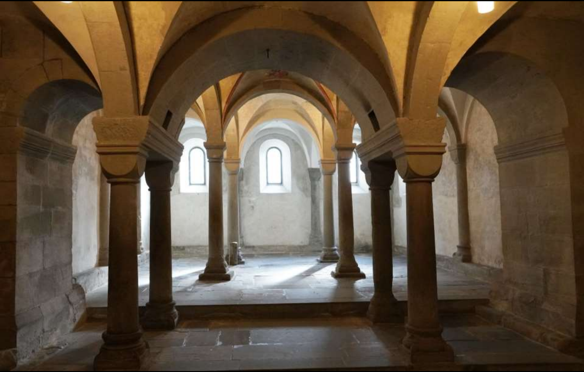
Zürich, Grossmünster, Krypta
