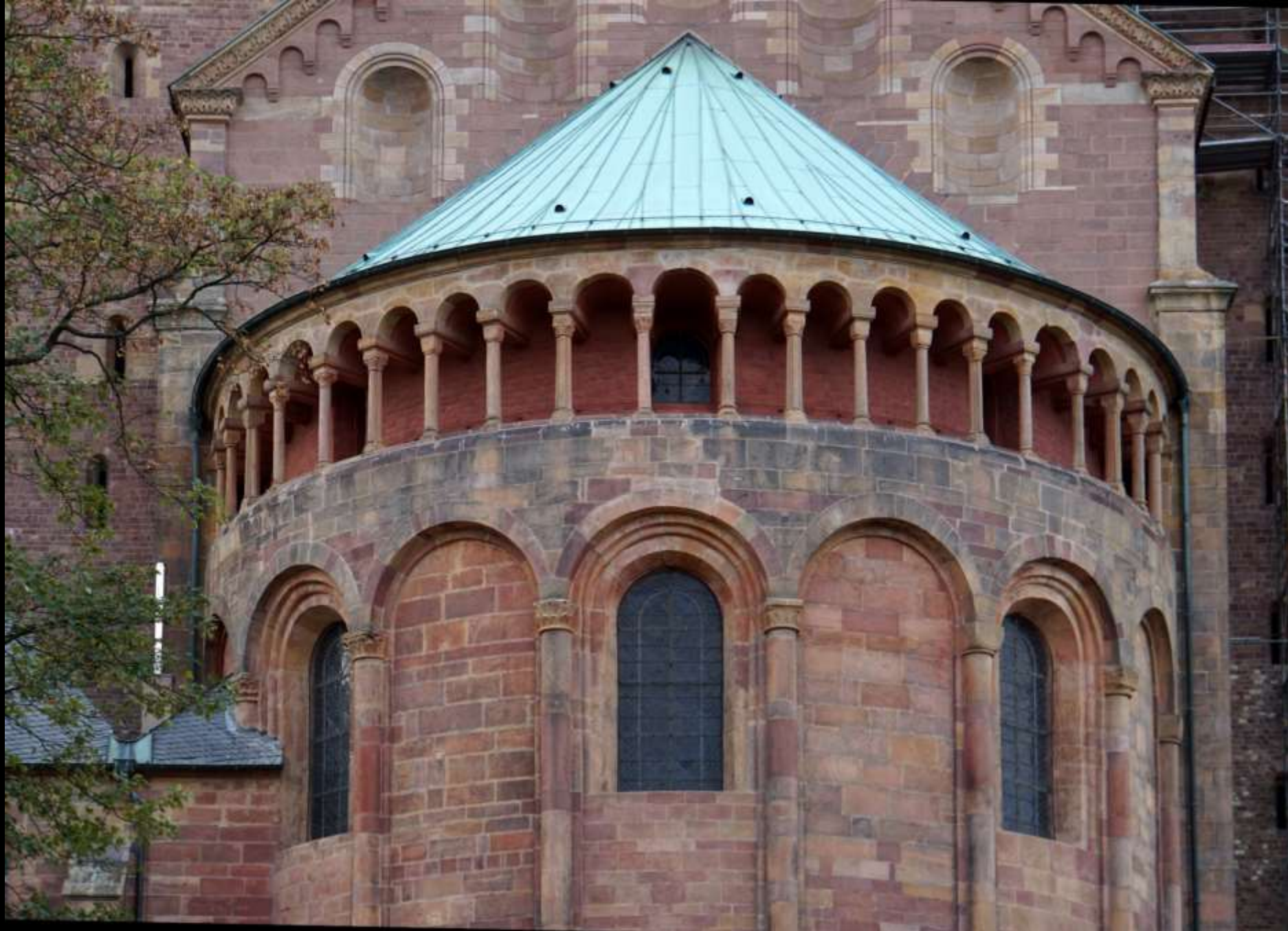
Speyer, Dom, Bau II. Ende 11. Jh. Apsis mit Rundbogenblenden und Zwerggalerie.
