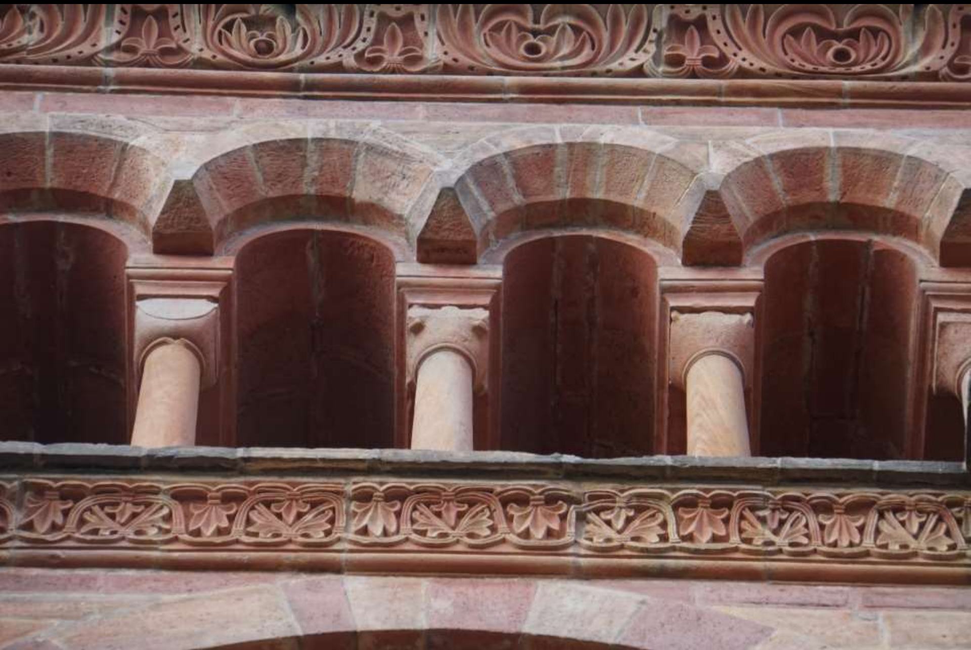
Speyer, Dom, Bau II. Ende 11. Jh. Zwerggalerie am S-Querhaus.
