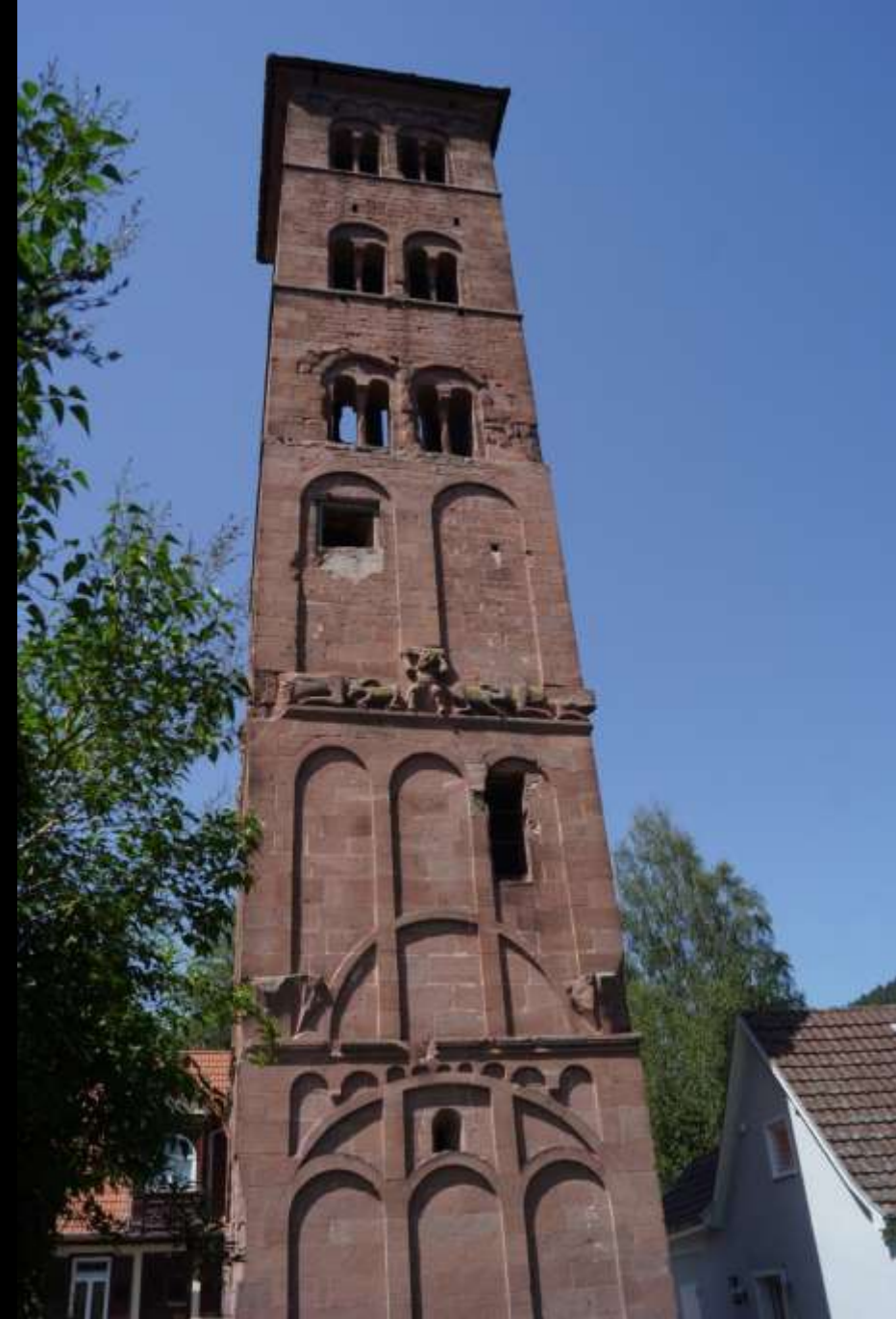
Rundbogenblenden. Hirsau, „Eulenturm“, um 1100
