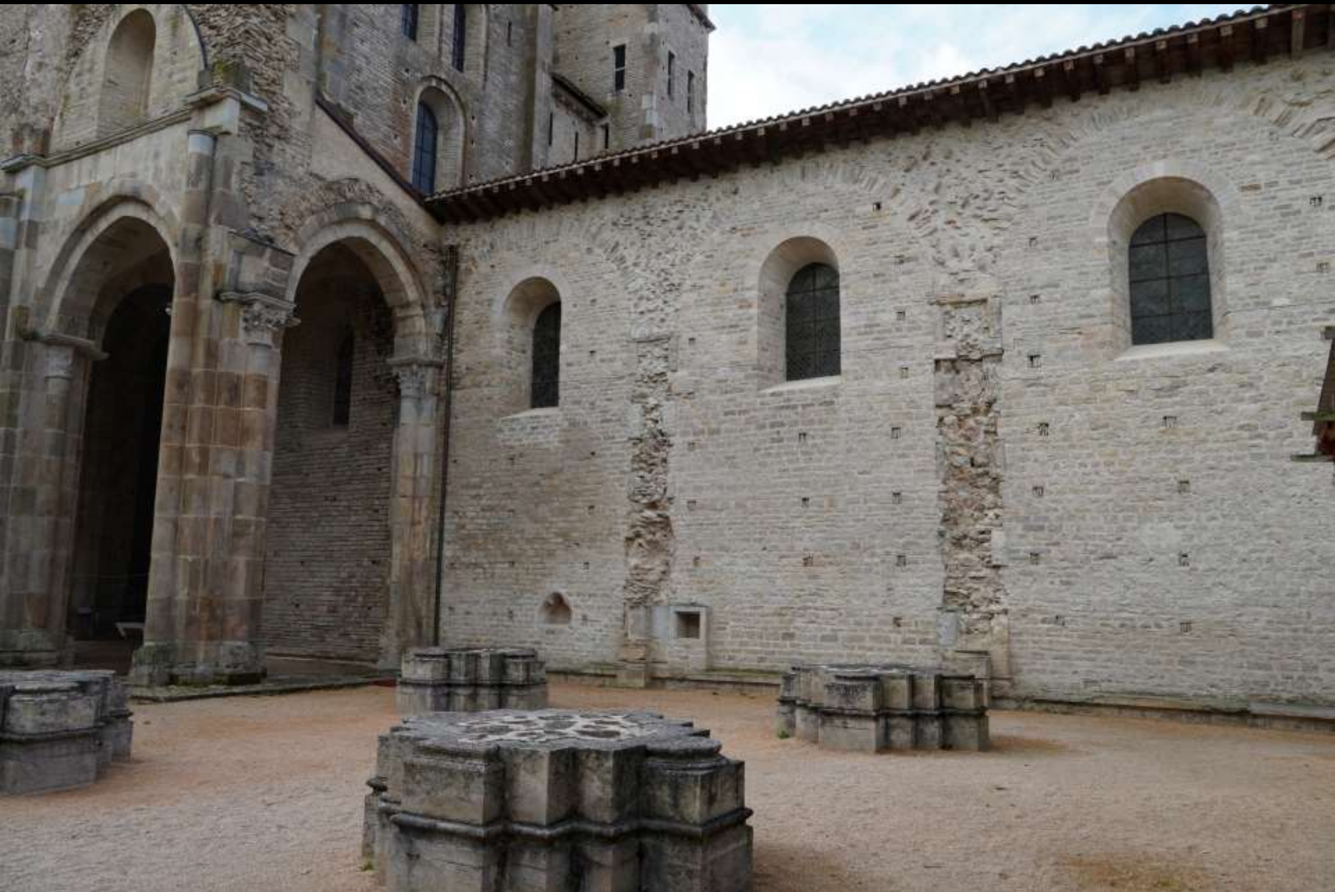
Cluny III, Kombination von tragenden/gliedernden Elementen aus Werkstein und Kleinquaderwänden
