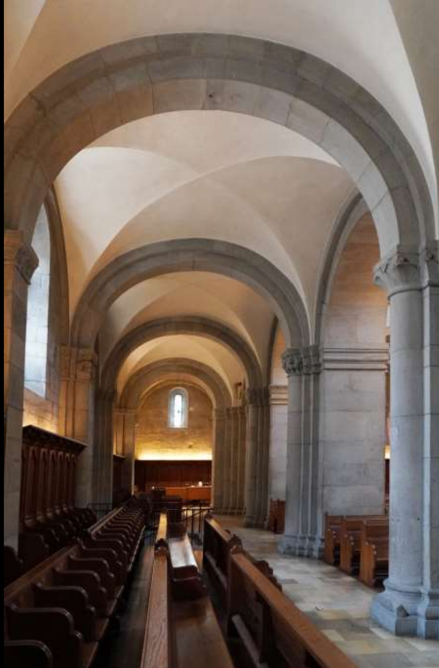
Zürich, Grossmünster, Seitenschiff mit Kreuzgratgewölbe
