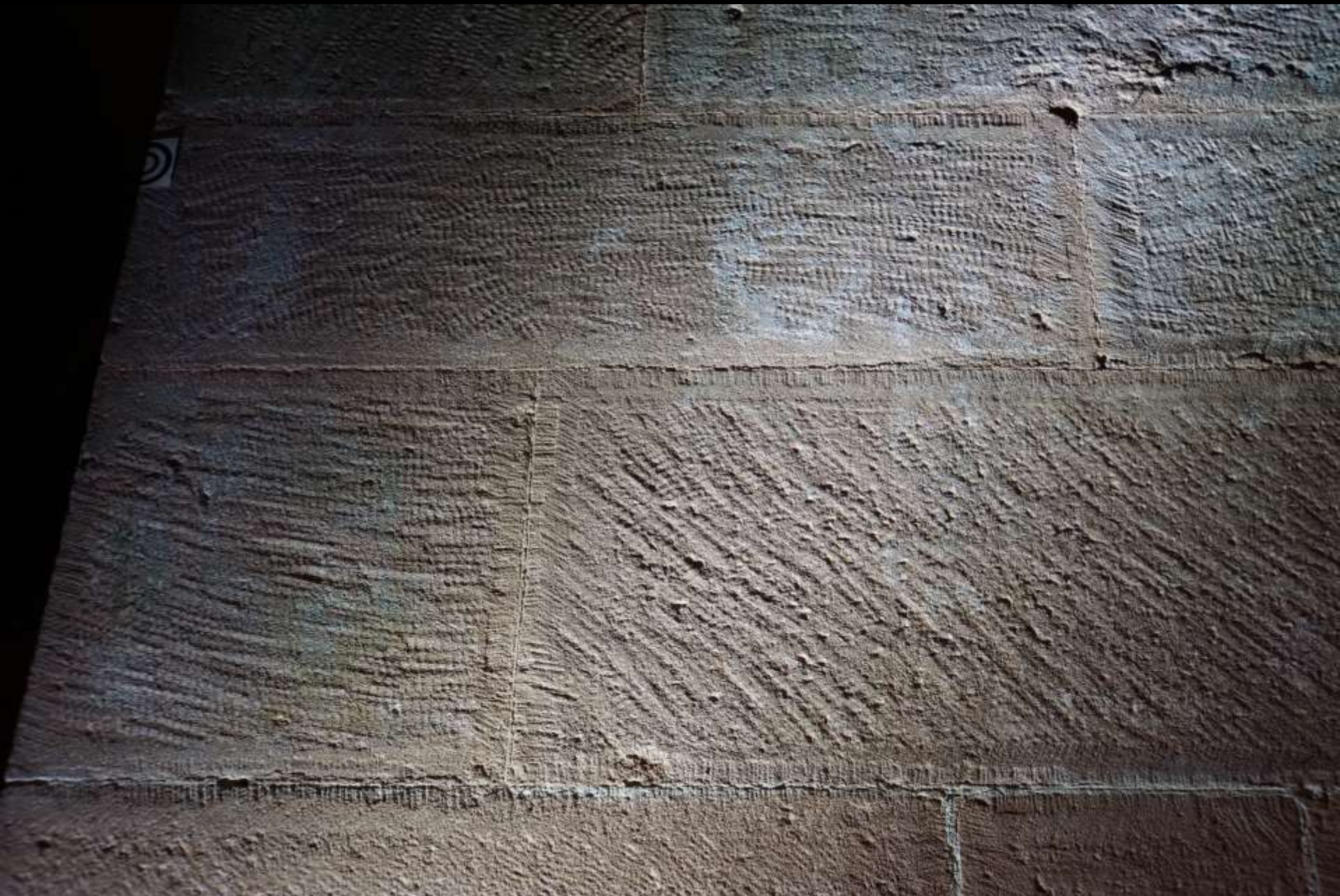
Worms, Dom (1125 – nach 1185). Steinbearbeitung mit „gotischem“ Werkzeug Zahnfläche
