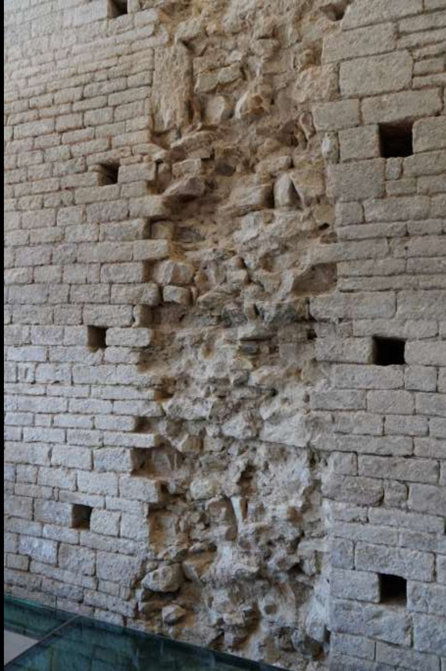
Cluny III, Wandaufbau der Seitenschiffswand
