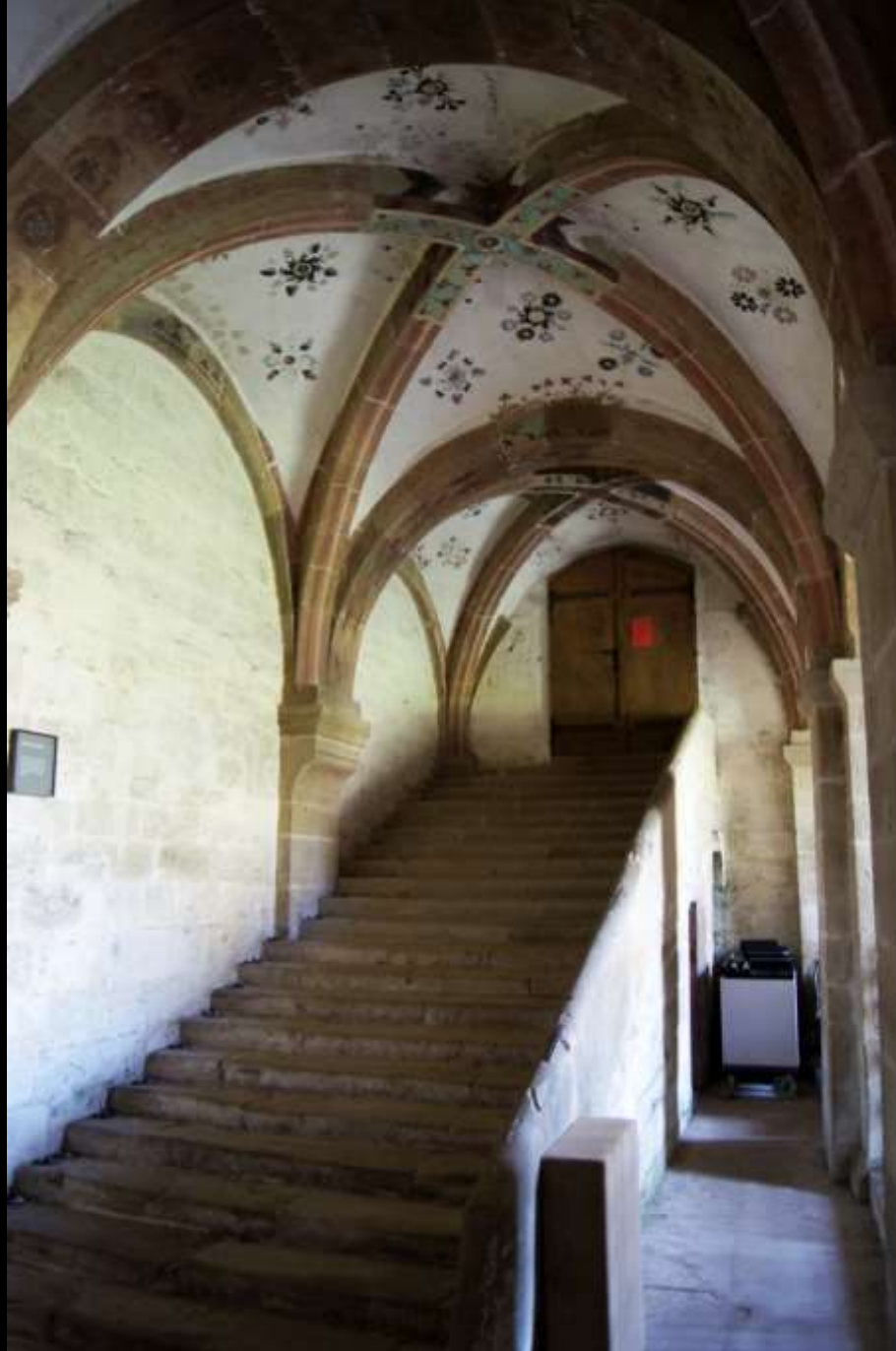
Maulbronn. Dormitoriumstreppe im nördlichen Querhaus
