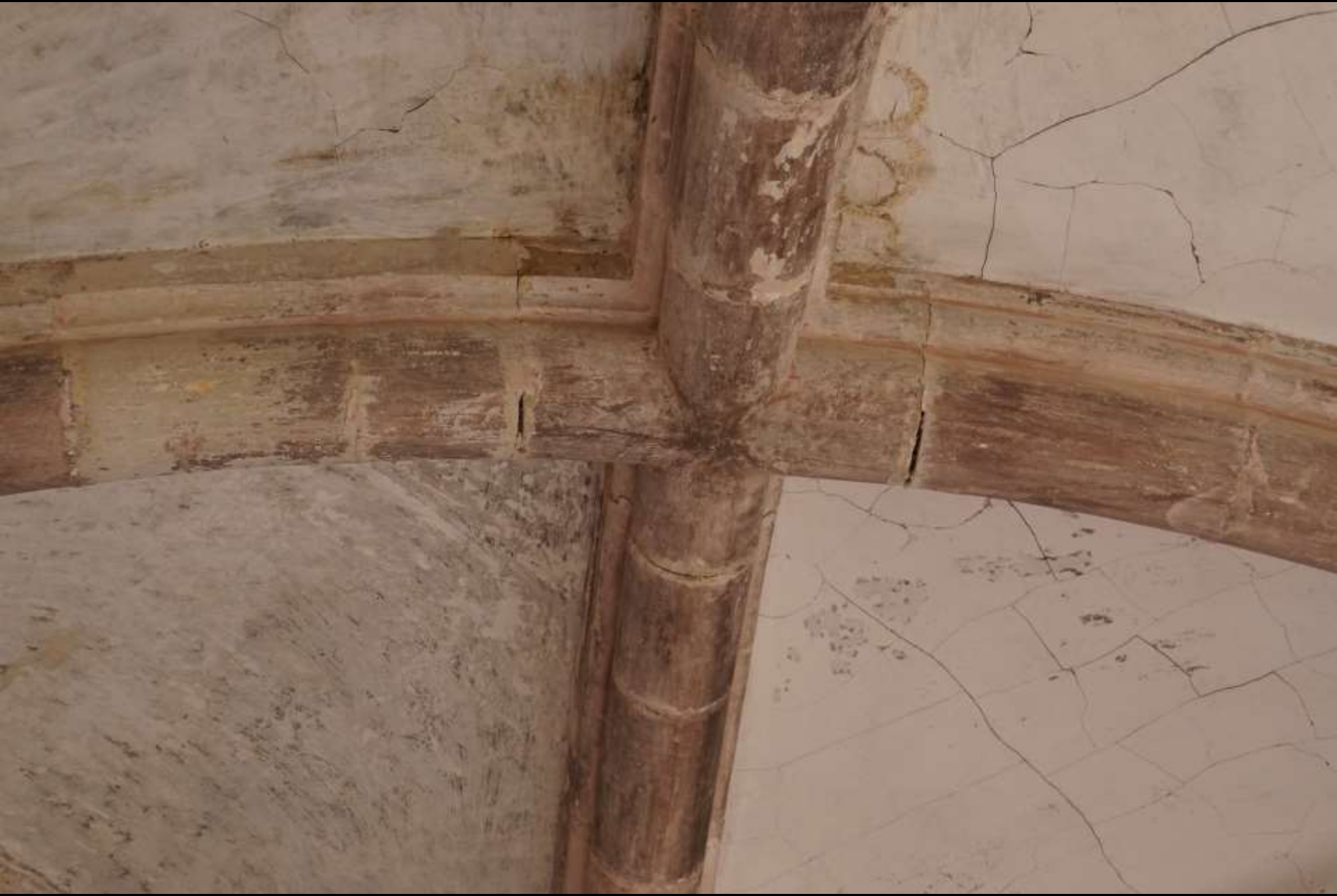
Kloster Fontenay, Burgund – Rippengewölbe im Mönchssaal
