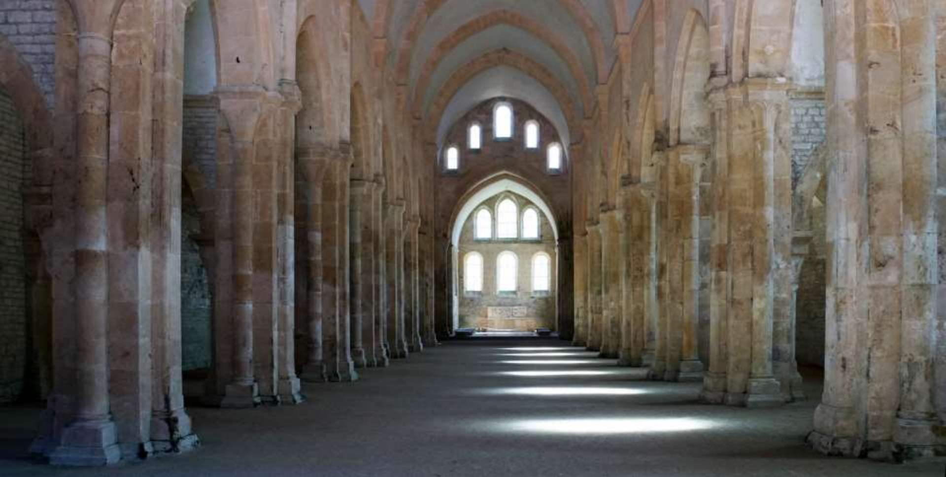
Kloster Fontenay, Burgund – Kirche (1139–47). Reine Tonnenwölbung burgundischer Tradition.
