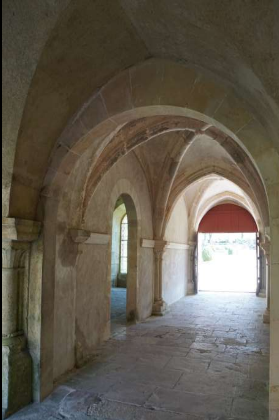
Kloster Fontenay, Burgund – Durchgang und Auditorium
