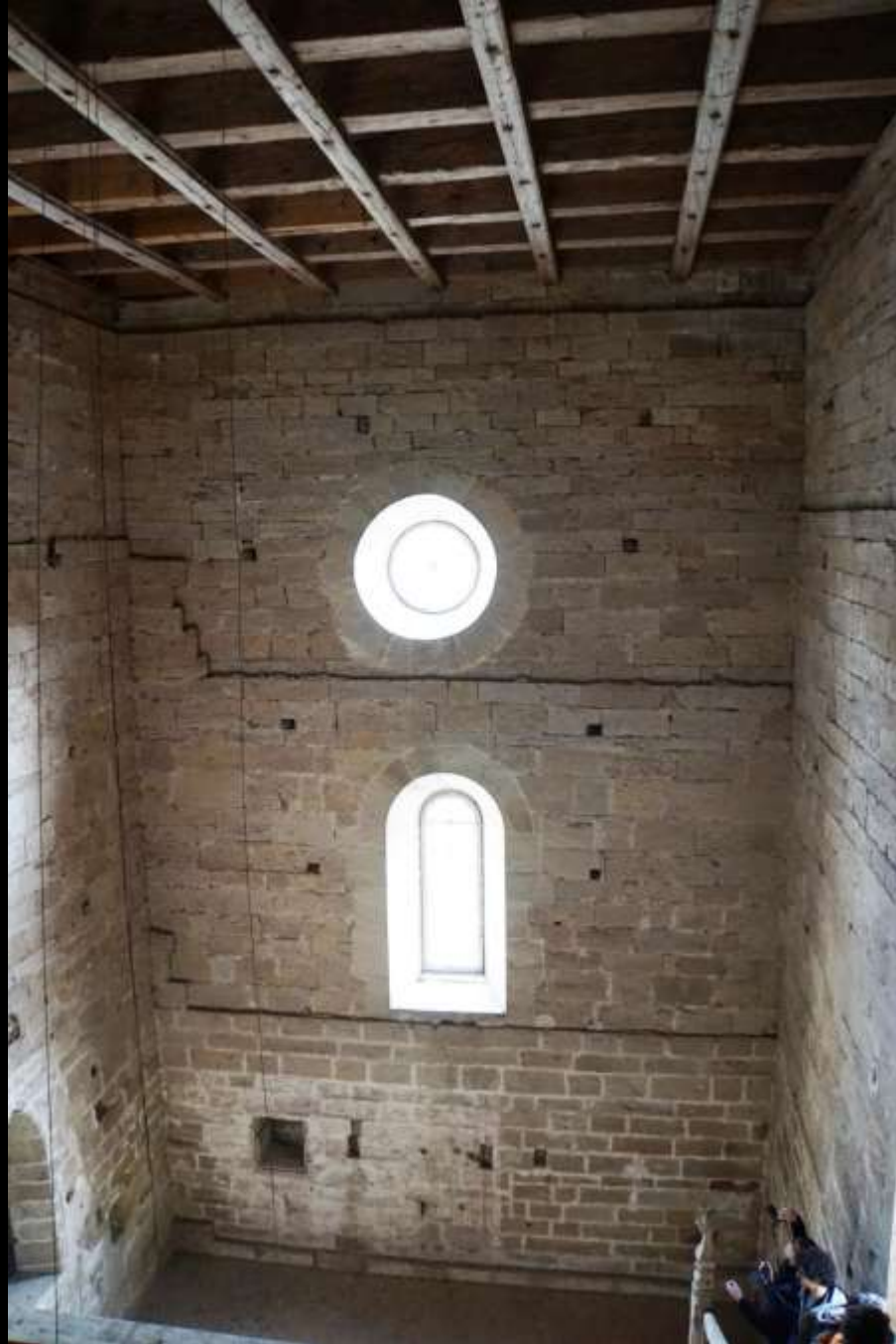
Maulbronn, Kirche. Südliches „Querschiff“ mit Resten der Holzdecke (um 1170)
