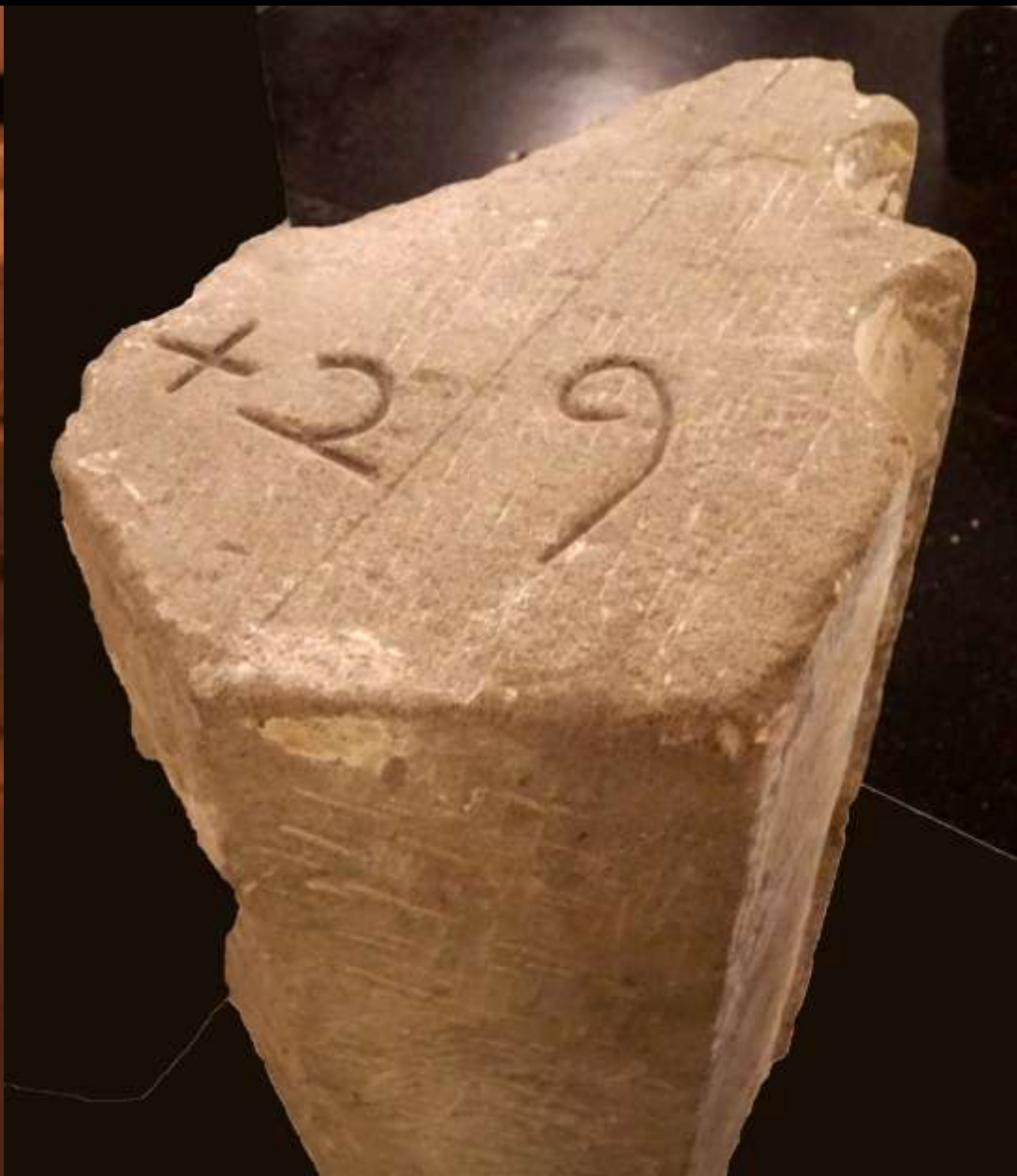
Gotisches Rippenstück mit Versatzmarke (Lapidarium der Kathedrale St. Gallen, 15. Jh.)
