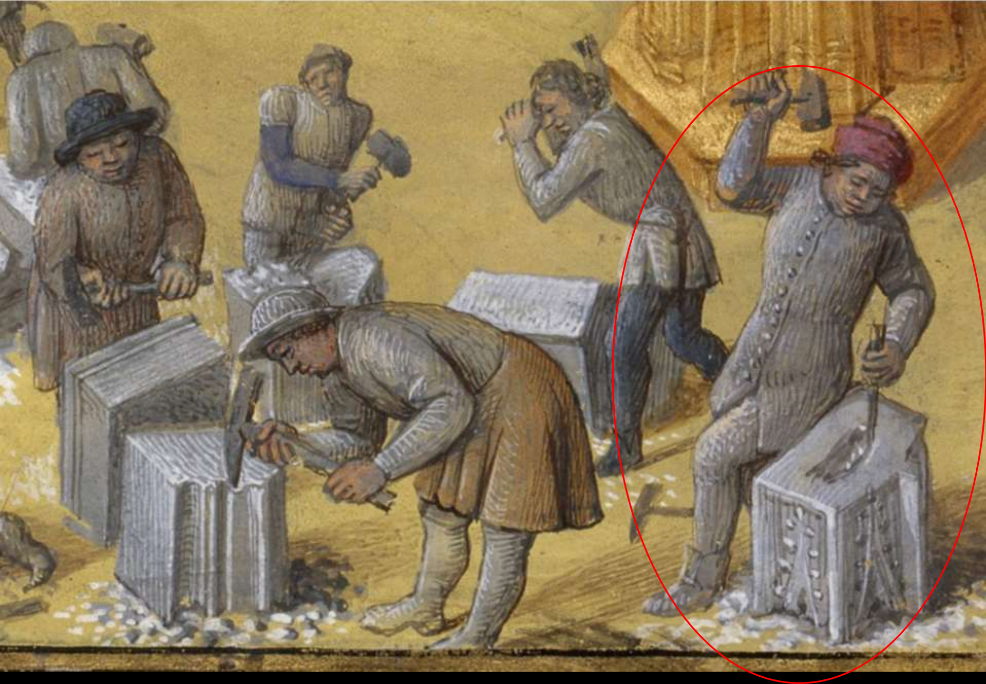
Ausarbeiten eines Wolfslochs
