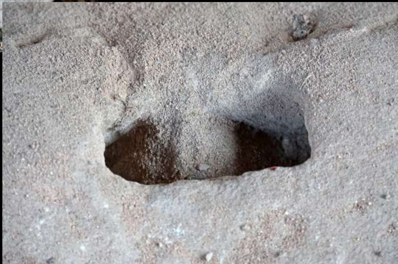
Loch für Spreizzange in einem Gesimsstein der Kirchenruine Limburg/Haardt (11. Jh.; Zange: Patte 1777)
