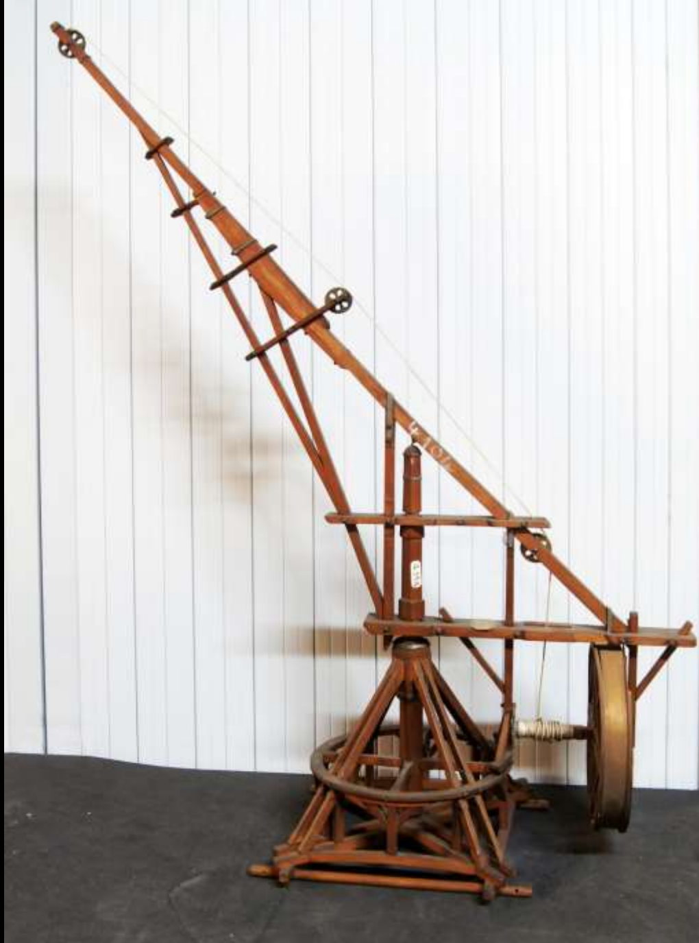
Drehkran des Panthéons in Paris, Brulé 1763 (Modell 18. Jh., Conservatoire des Arts et Métiers, Paris)
