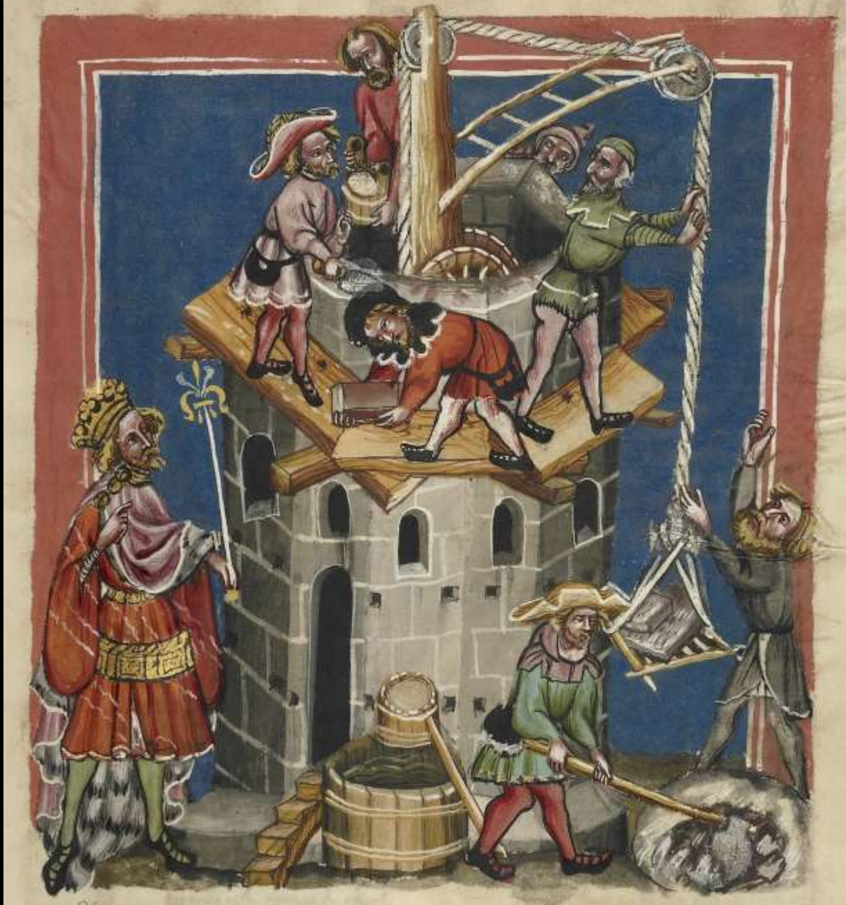
Verwendung eines einfachen Kranes ermöglicht u. U. Einsparungen am Gerüst: Kraggerüst und Galgenkran (Rudolf v. Ems. Weltchronik, Getty Ms. 33, fol. 13, um 1400)
