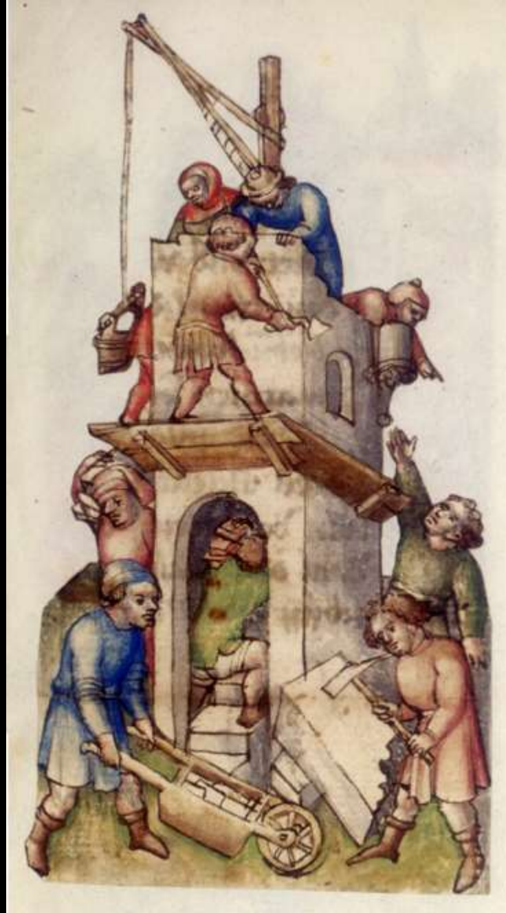
Verwendung eines einfachen Kranes ermöglicht u. U. Einsparungen am Gerüst: Kraggerüst und Galgenkran (Historienbibel, Albertina Wien 31036, fol. 6, um 1430)
