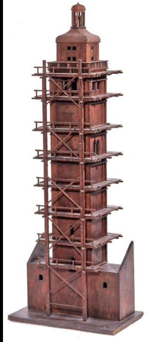
Augsburg, Perlachurm und Gerüst zur Aufstockung (Elias Holl 1614; Modell Maximilianmuseum Augsburg)
