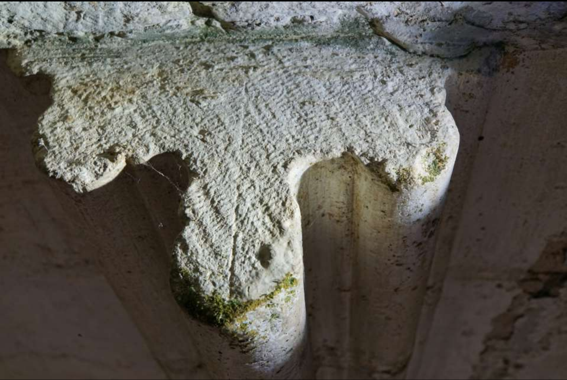
gotisches Rippenprofil mit Anzeichnung der Mittellinie (Saint-Thibault-en-Auxois)
