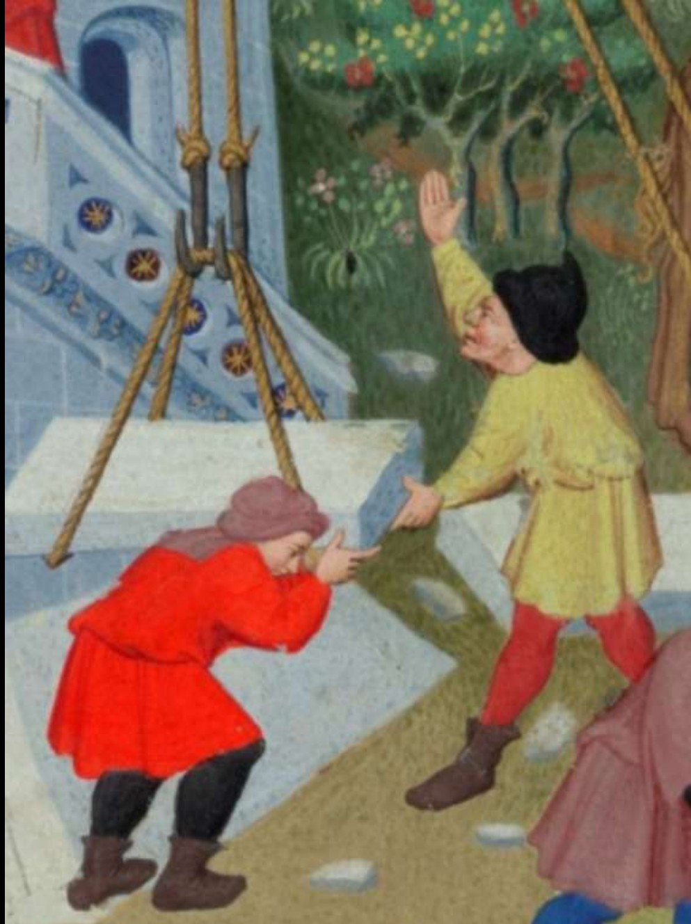
Heben und Versatz von Quadern mit Kran und „Kranztau“ (British Library Ms. Add. 18850, Stundenbuch des Herzogs von Bedford, fol. 17v, Detail)
