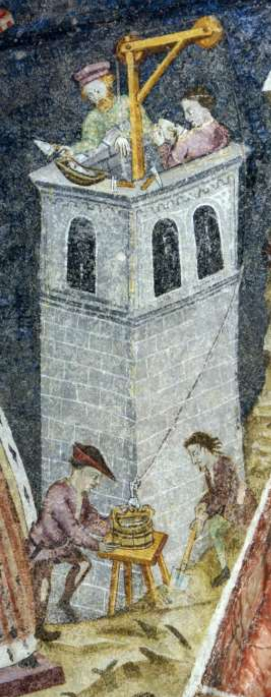
Galgenkran (Kreuzgang Neustift bei Brixen, Südtirol, Fresko 1. H. 15. Jh.)
