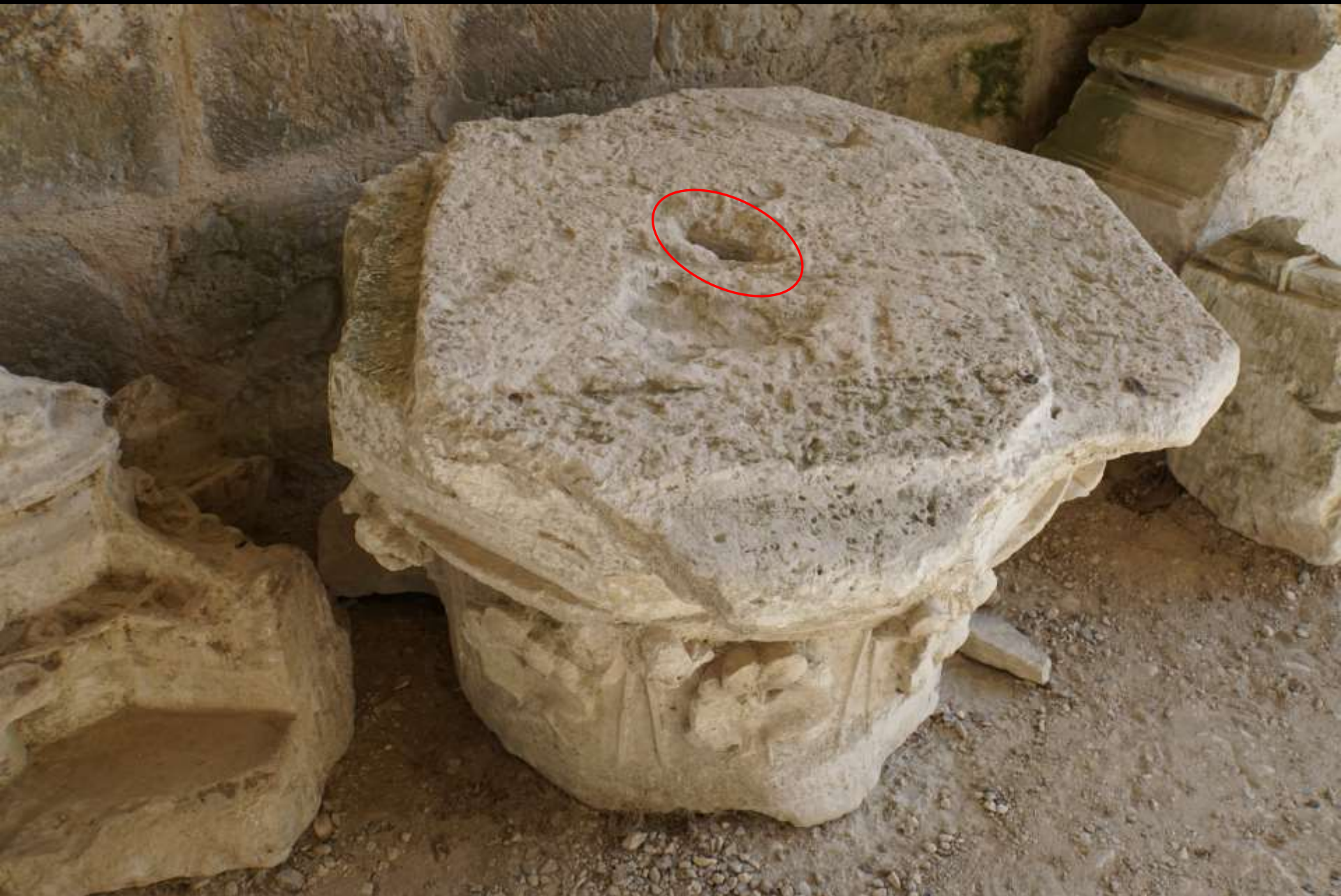
Wolfsloch in einem gotischen Werkstück (Jumièges)
