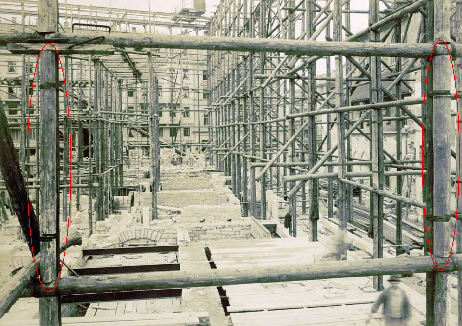
„Lantenen“-Gerüst (Fraumünsteramt Zürich, Baustelle um 1900; Foto R. Breiting, ZB Zürich)
