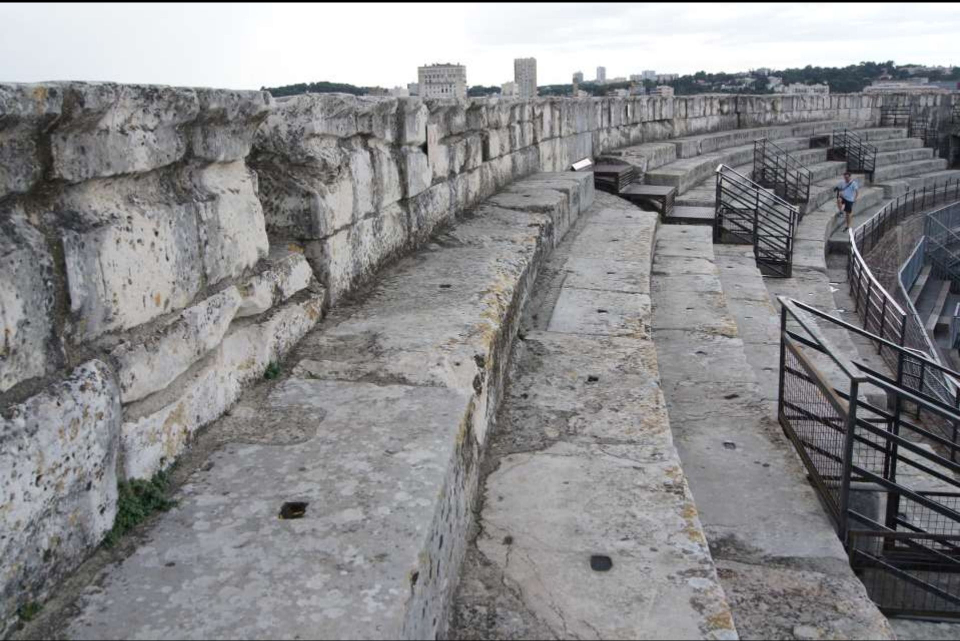
Wolflöcher in Quadern der obersten Sitzreihen des Amphitheaters in Nîmes (1. Jh. n. Chr.)
