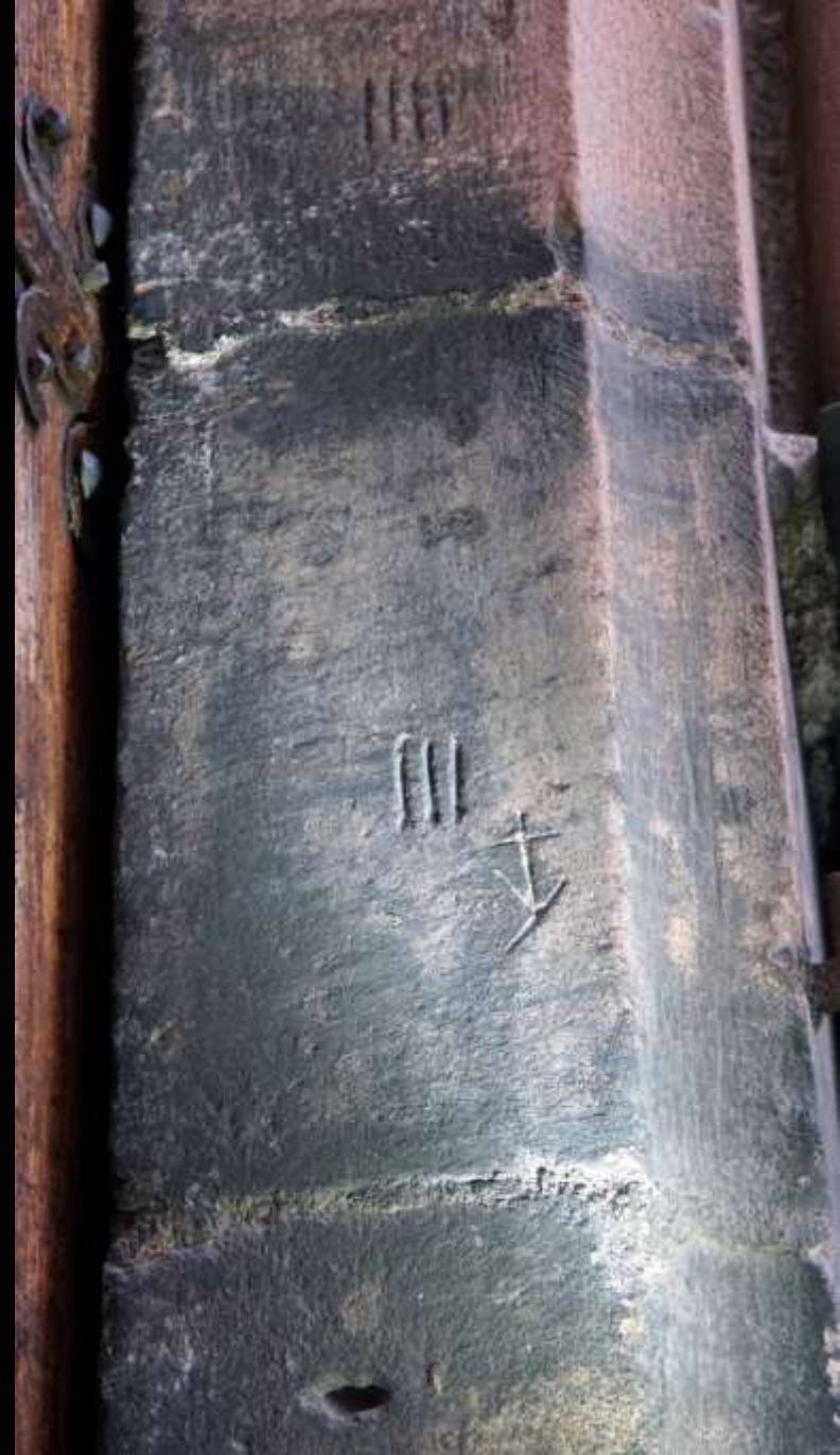
Versatzzeichen an einem umgesetzten frühgotischen Portal der Kirche St. Georg Schlettstatt
