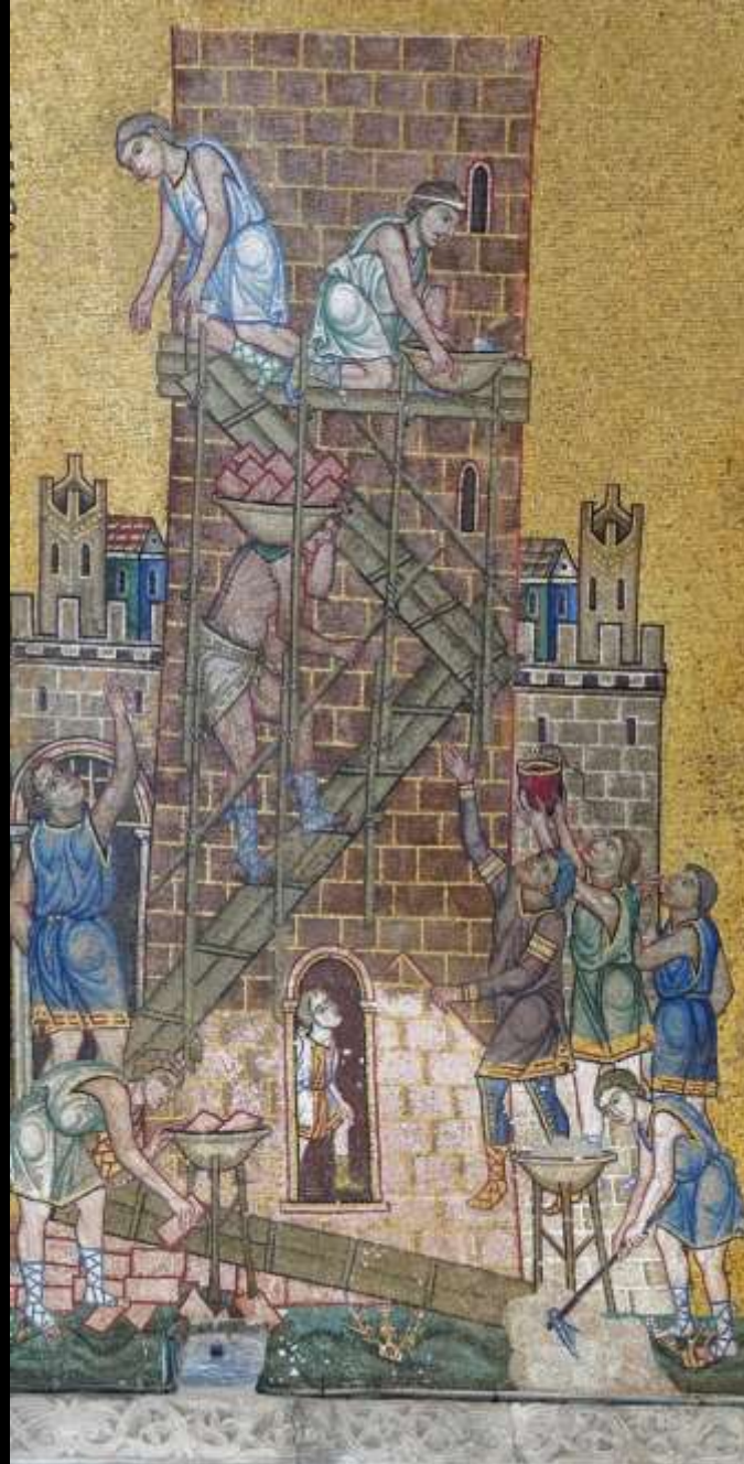
Transport von Backsteinen durch Träger auf Laufbrücken und Verwendung von Stangengerüsten (Venedig, San Marco, Narthex, Mosaik, 13. Jh.)
