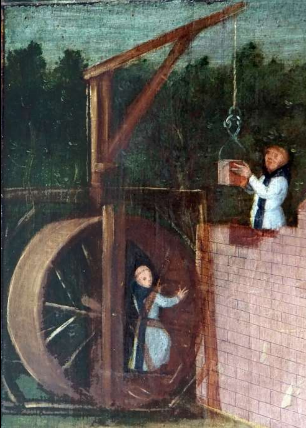
Tretradkran mit integrierter drehbarer (?) Kransäule (Maulbronn, Stiftertafel, um 1450)
