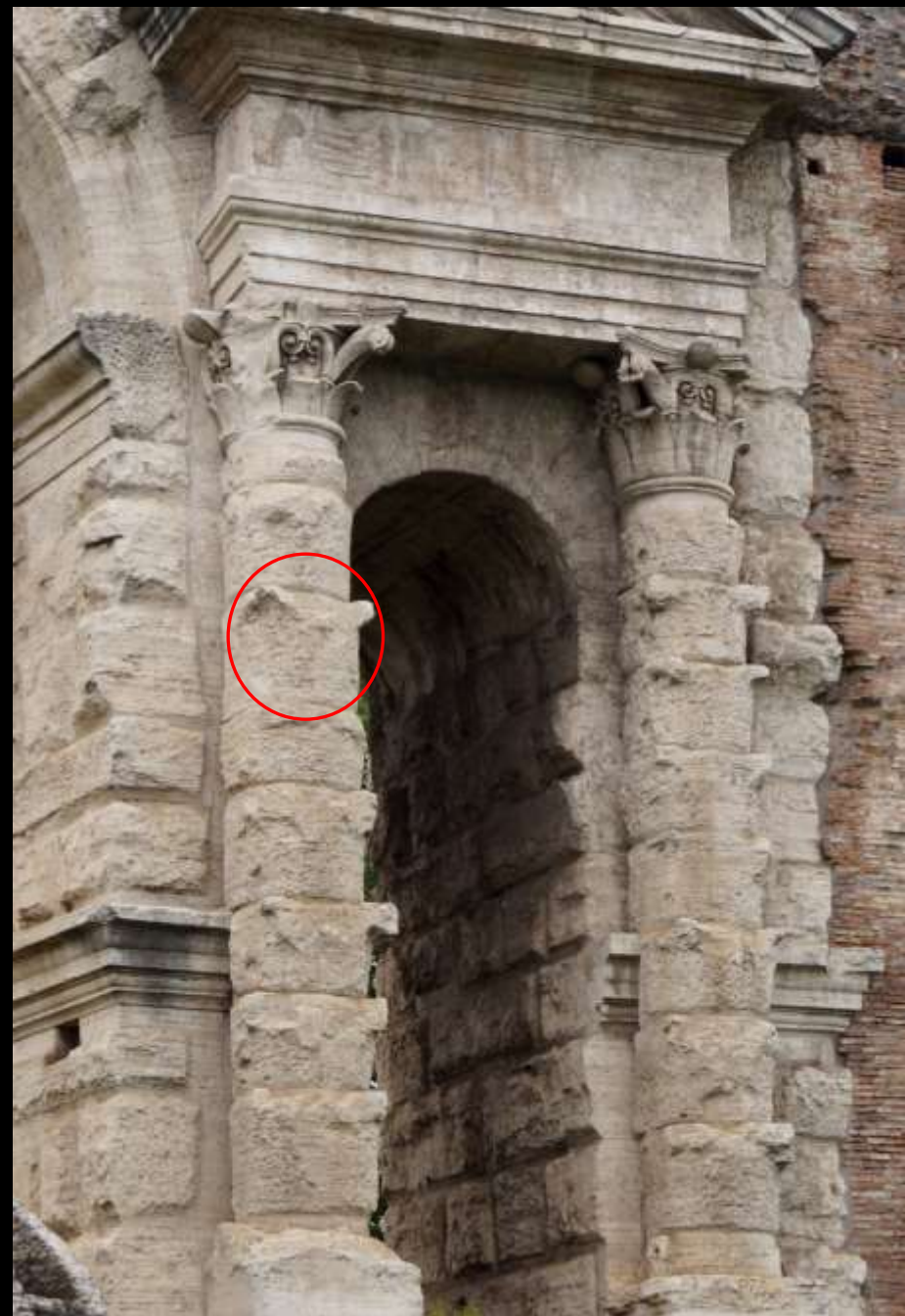
Bauwerk aus Bossenstein (Porta Maggiore, Rom, 1. Jh. n. Chr.). Bossen für Seilschlinge („Kranztau“)
