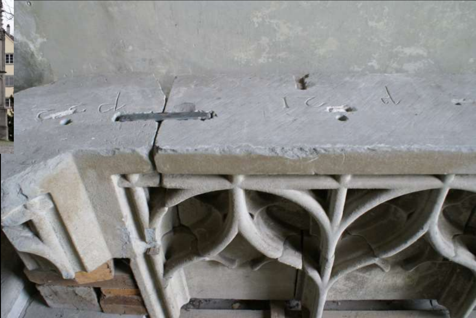
Versatzzeichen an ausgebauten Teilen eines Masswerkfrieses vom Münster in Konstanz (Anf. 16. Jh.)
