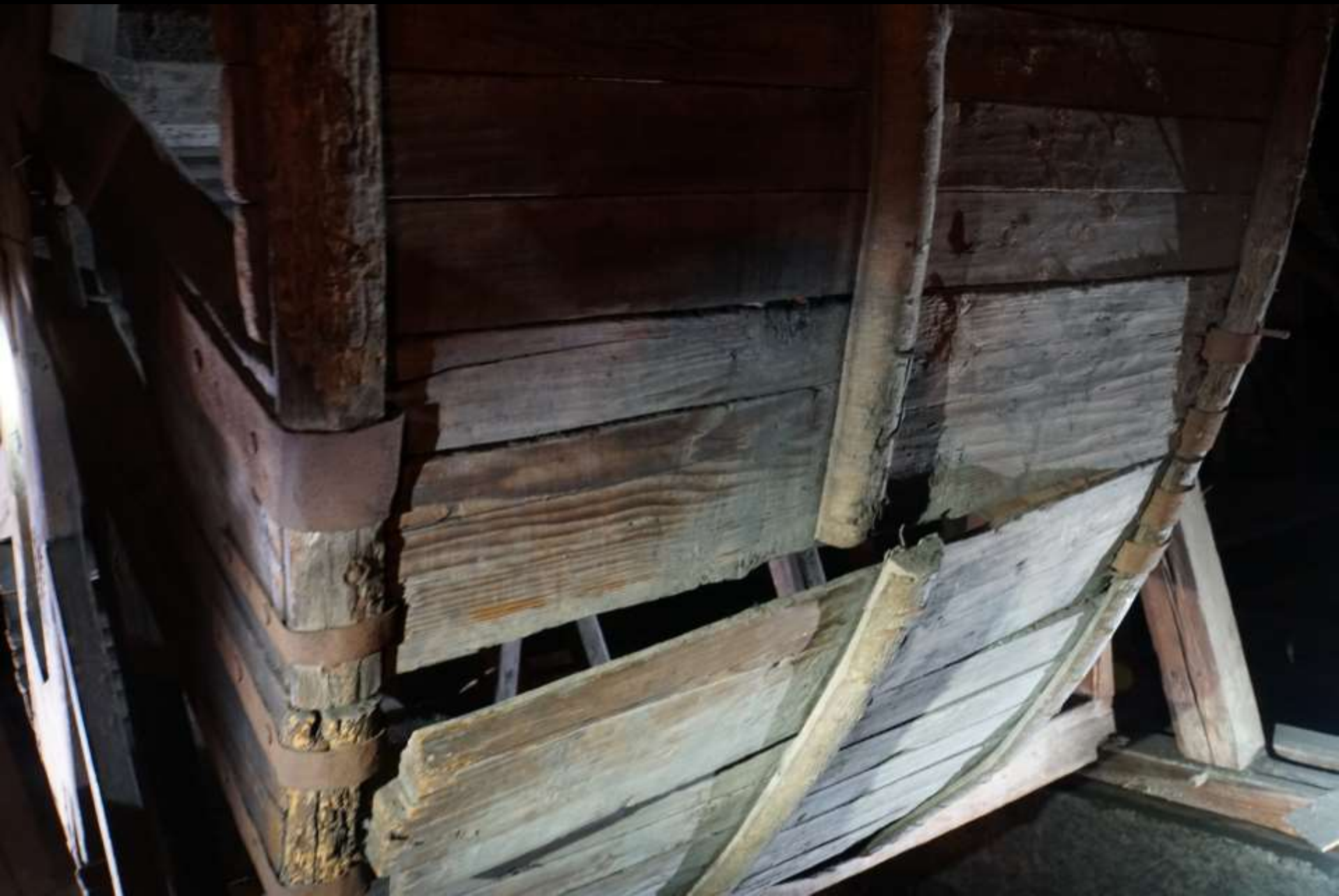
Basel, Leonhardskirche, Tretradaufzug (um 1500). Detail der zerlegbaren Käfigkonstruktion.
