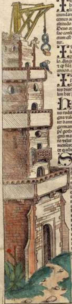
stabiler und wetterfester Galgenkran (Holzschnitt aus Hartmann Schedel, Weltchronik, fol. 17v, 1493)
