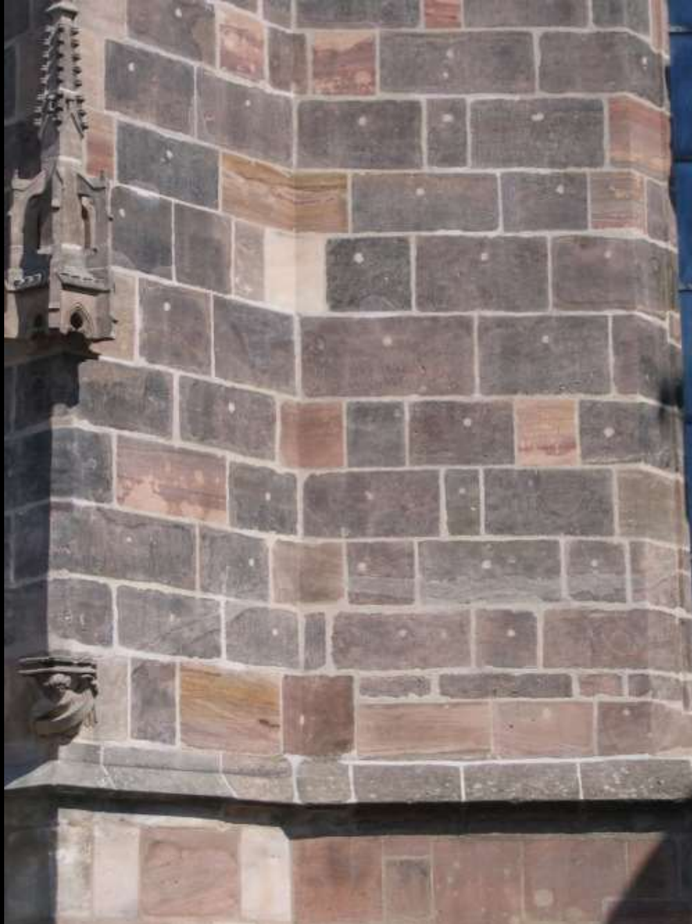
Vermörtelte Zangenlöcher (Nürnberg, Frauenkirche, 14. Jh.)
