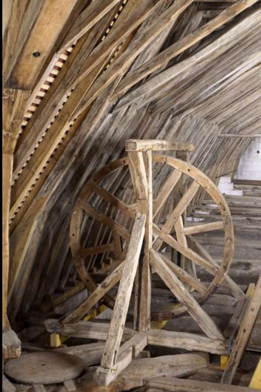
Winde mit Sprossenrad (undatiert, 14./15. Jh., Kathedrale Auxerre)
