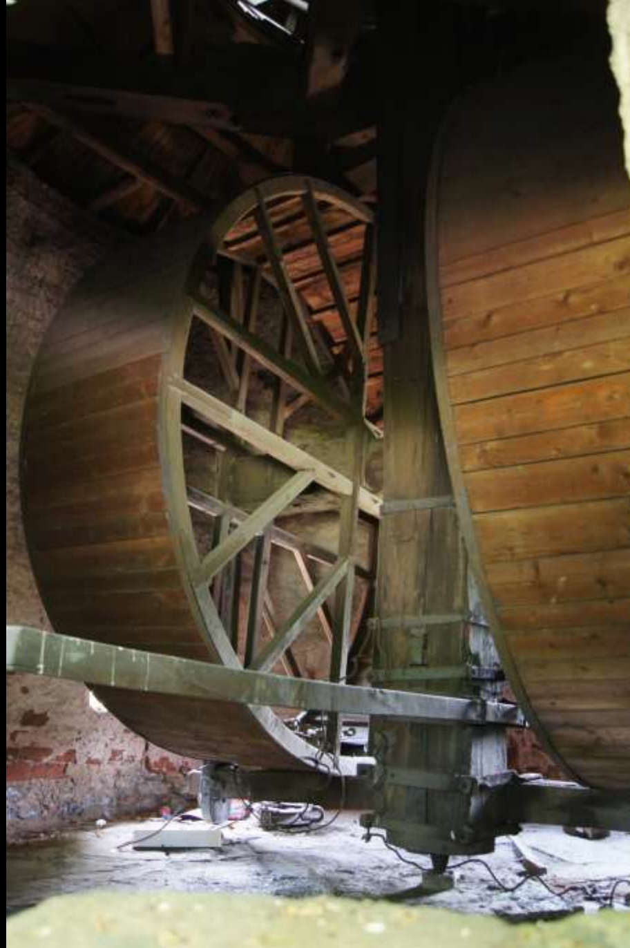
Trier, Treträder im Hafenkran an der Mosel (18. Jh.)
