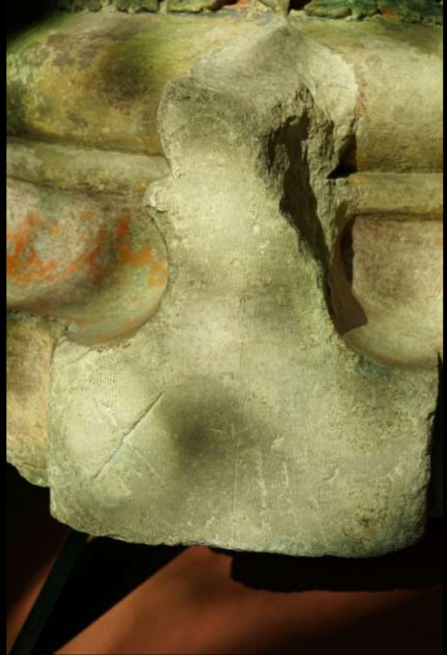
Schlussstein mit Versatzmarken (13. Jh.; Lapidarium von Saint-Benigne in Dijon)
