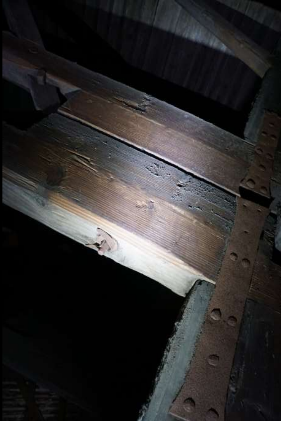
Basel, Leonhardskirche, Tretradaufzug (um 1500). Detail der zerlegbaren Käfigkonstruktion.
