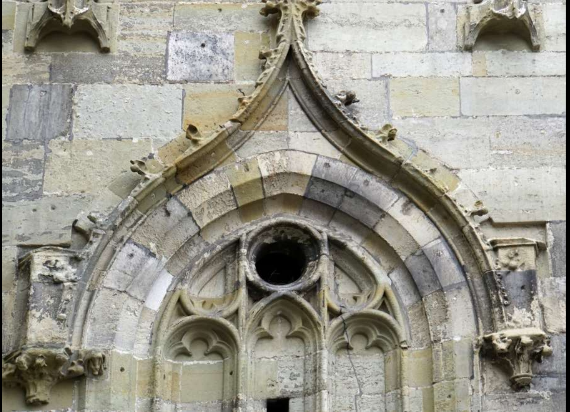
Zangenlöcher (Regensburg, Dom, 15. Jh.)
