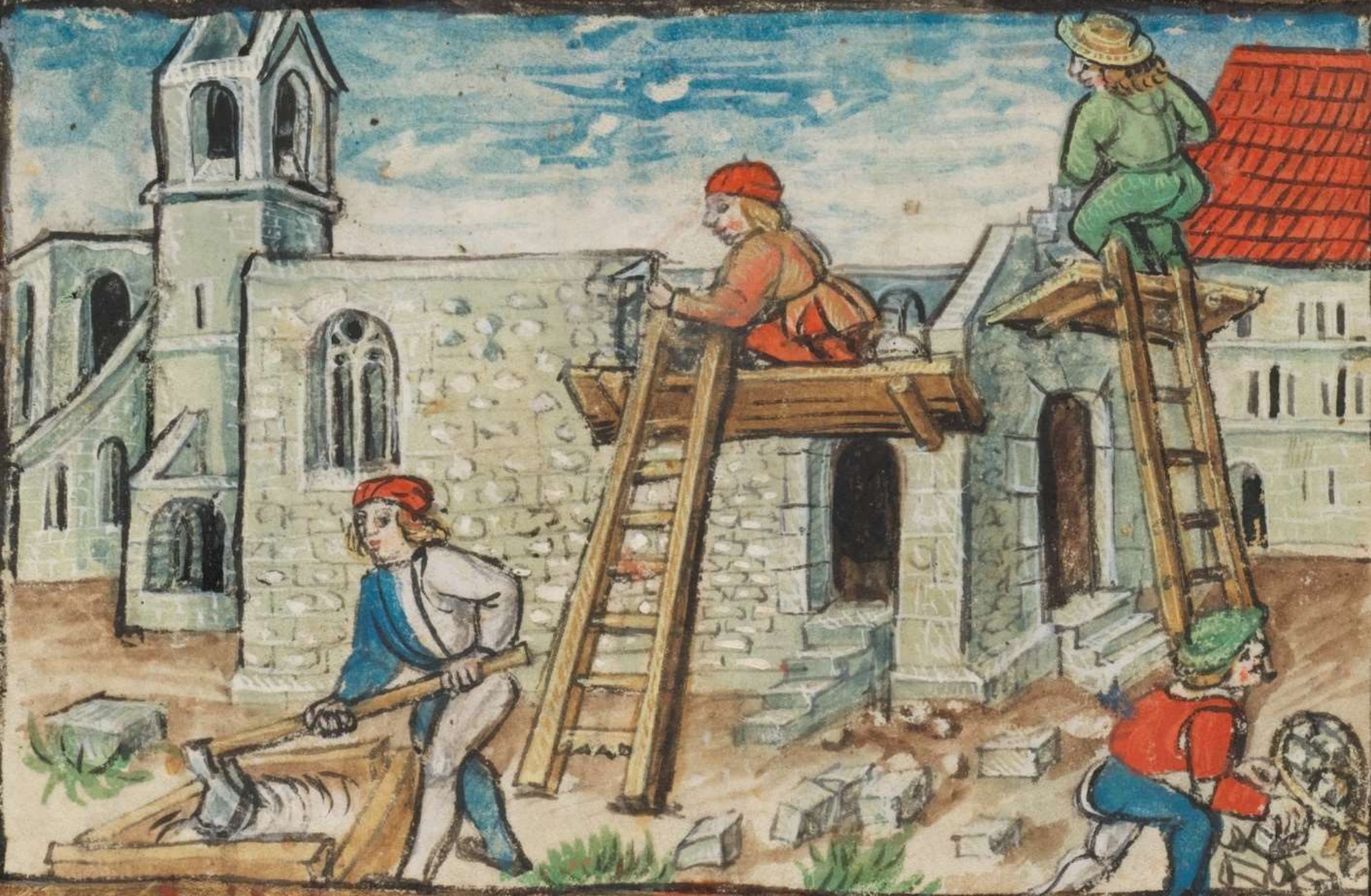
Das „Kraggerüst“ und das Bauen mit „kleinen Materialien“ (hier Bruchstein/pietra rasa). Transport via Leiter. (Diebold Schilling, Eidgenössische Chronik, Ende 15. Jh., Korporation Luzern, S 23, fol. 24)
