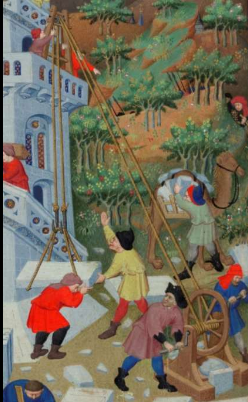
Winde mit Kurbel und Schwungrad (Bedford-Stundenbuch, um 1405-30, British Library Ms. add. 18850, fol 14v)
