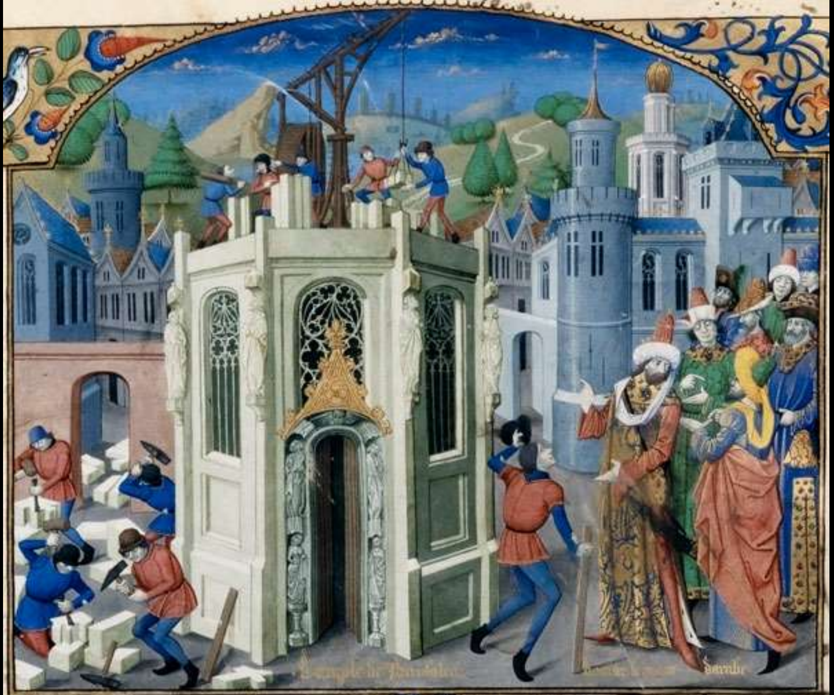
Französ. Drehkran (Guillaume de Tyr, Geschichte der Kreuzzüge, um 1460, BNF Paris, Ms. fr. 2629)
