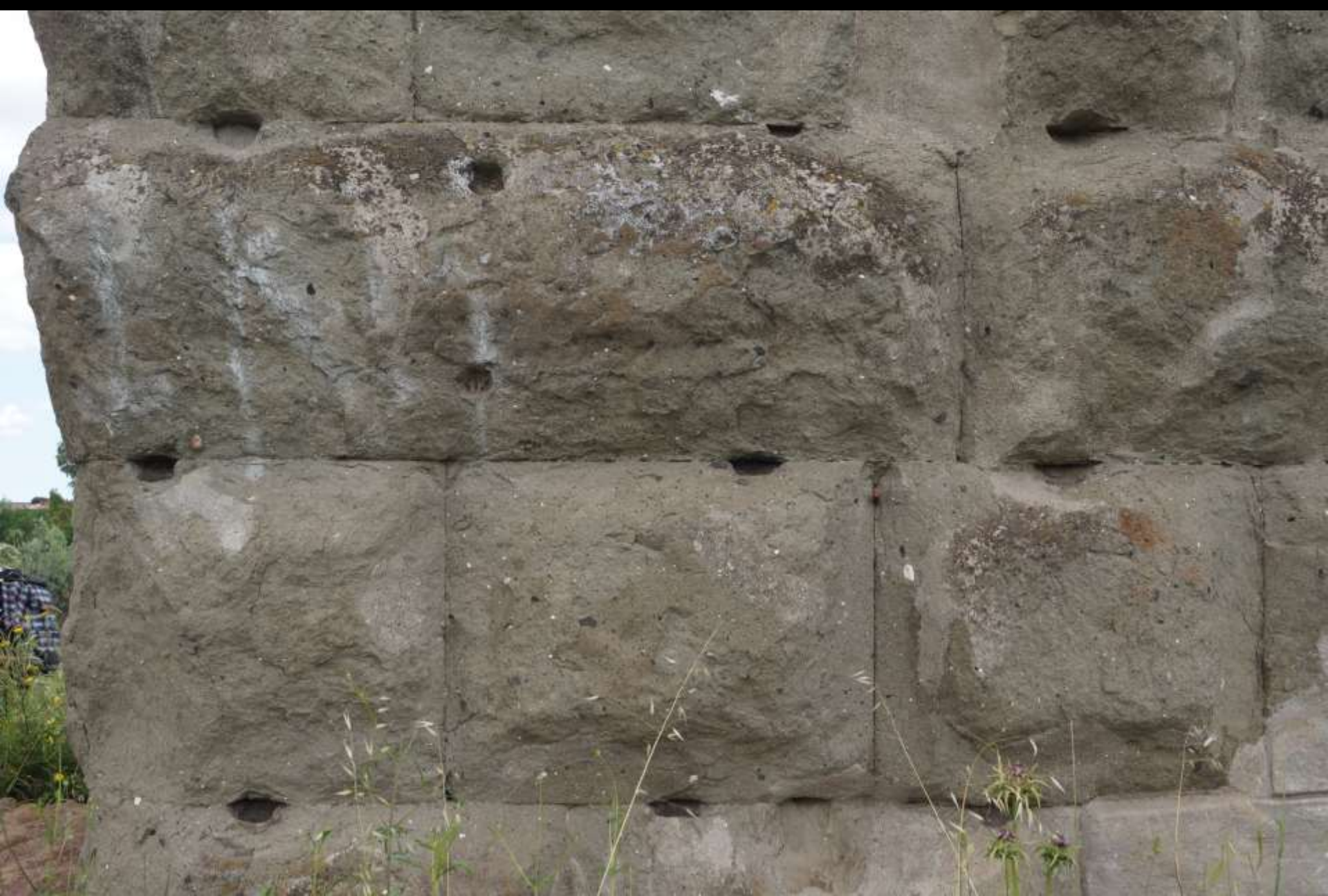
Bauwerk aus Bossensteinen (Aqua Claudia, Rom, 1. Jh. n. Chr.) Lager- und Stossfugen müssen dennoch präzise geglättet sein!
