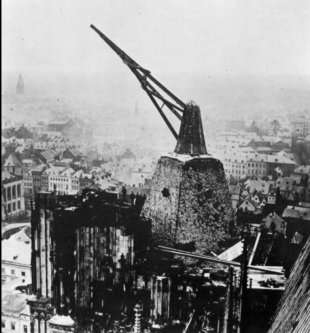
Der drehbare Kölner Domkran auf dem Südturm (Foto 1868)
