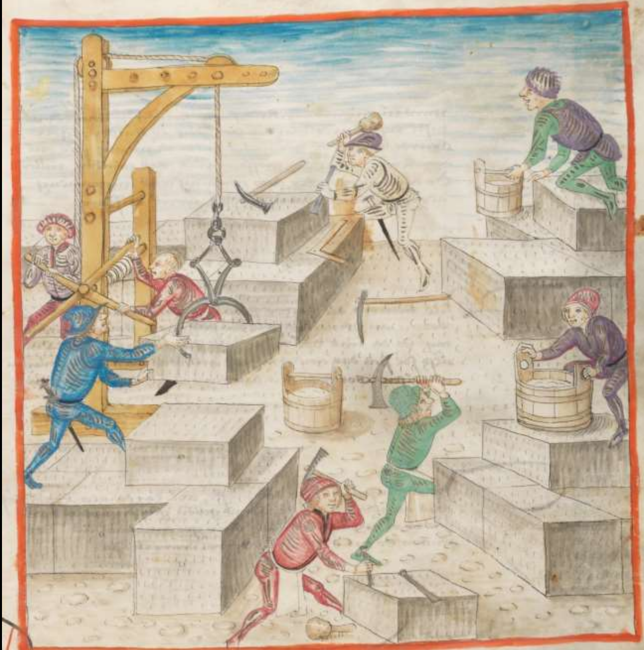
Starrer Galgenkran und Haspel mit Handspeichenbetrieb (Diebold Schilling, Chronik der Stadt Bern, 1478–83; Burgerbibliothek Bern, Mss.h.h.I.1, S. 451)
