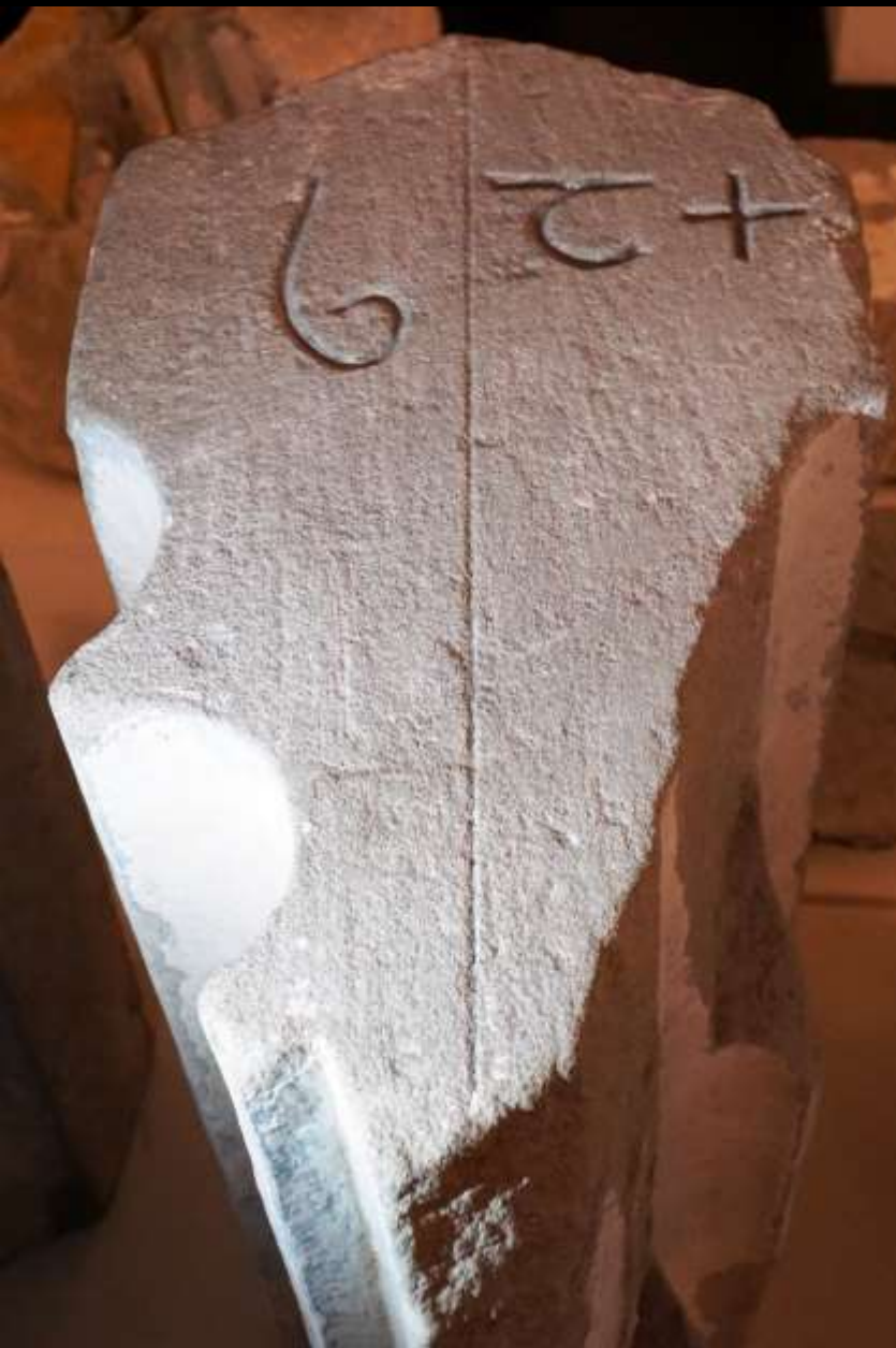
Gotisches Rippenstück mit Versatzmarke (Lapidarium der Kathedrale St. Gallen, 15. Jh.)
