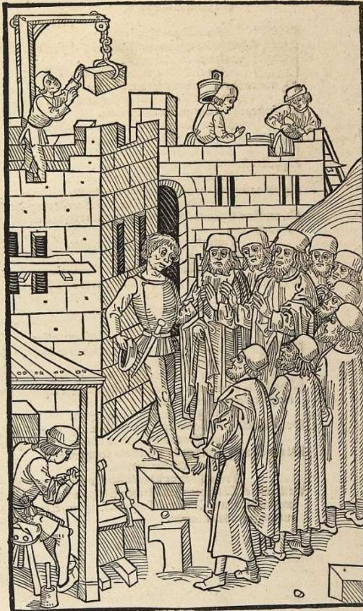
Galgengerüst, Zange und Zangenlöcher, Kraggerüst (Holzschnitt aus Guillaume Caoursin, Stabilimenta Rhodiorum, fol. 15v, 1496)
