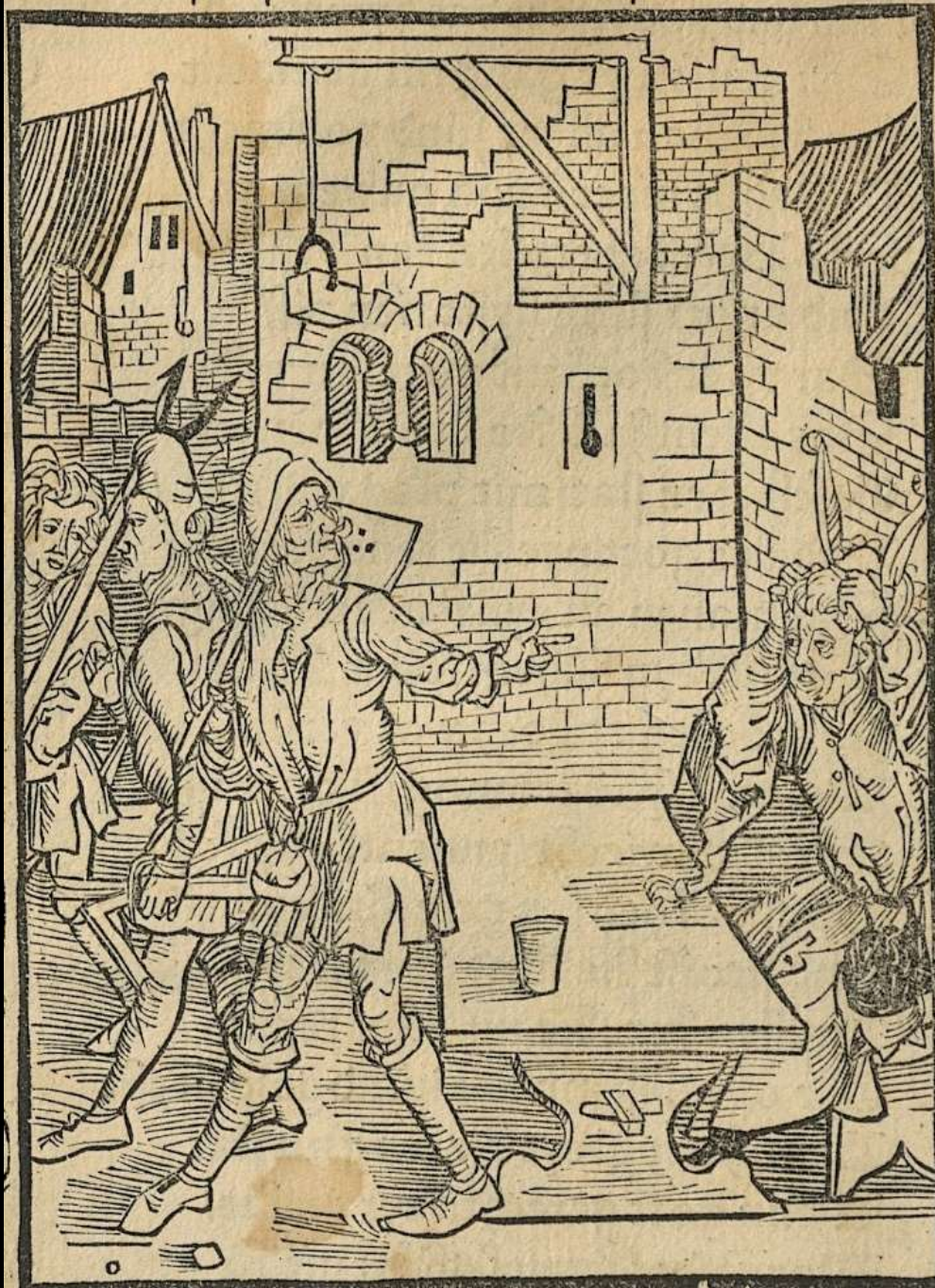
Steinversatz mit Zange (Sebastian Brant, Das Narrenschiff, Basel 1494)
