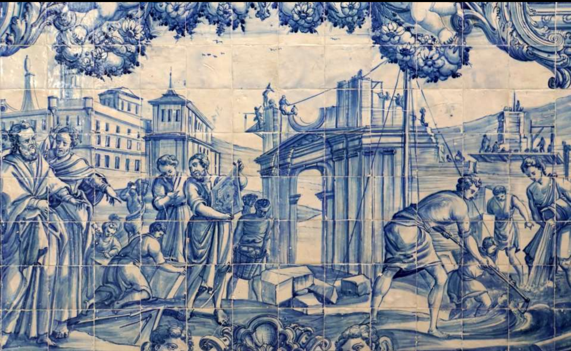
abgespannter Mastkran (Kachelbild, Lissabon, Sao Vicente de Fora, um 1700)
