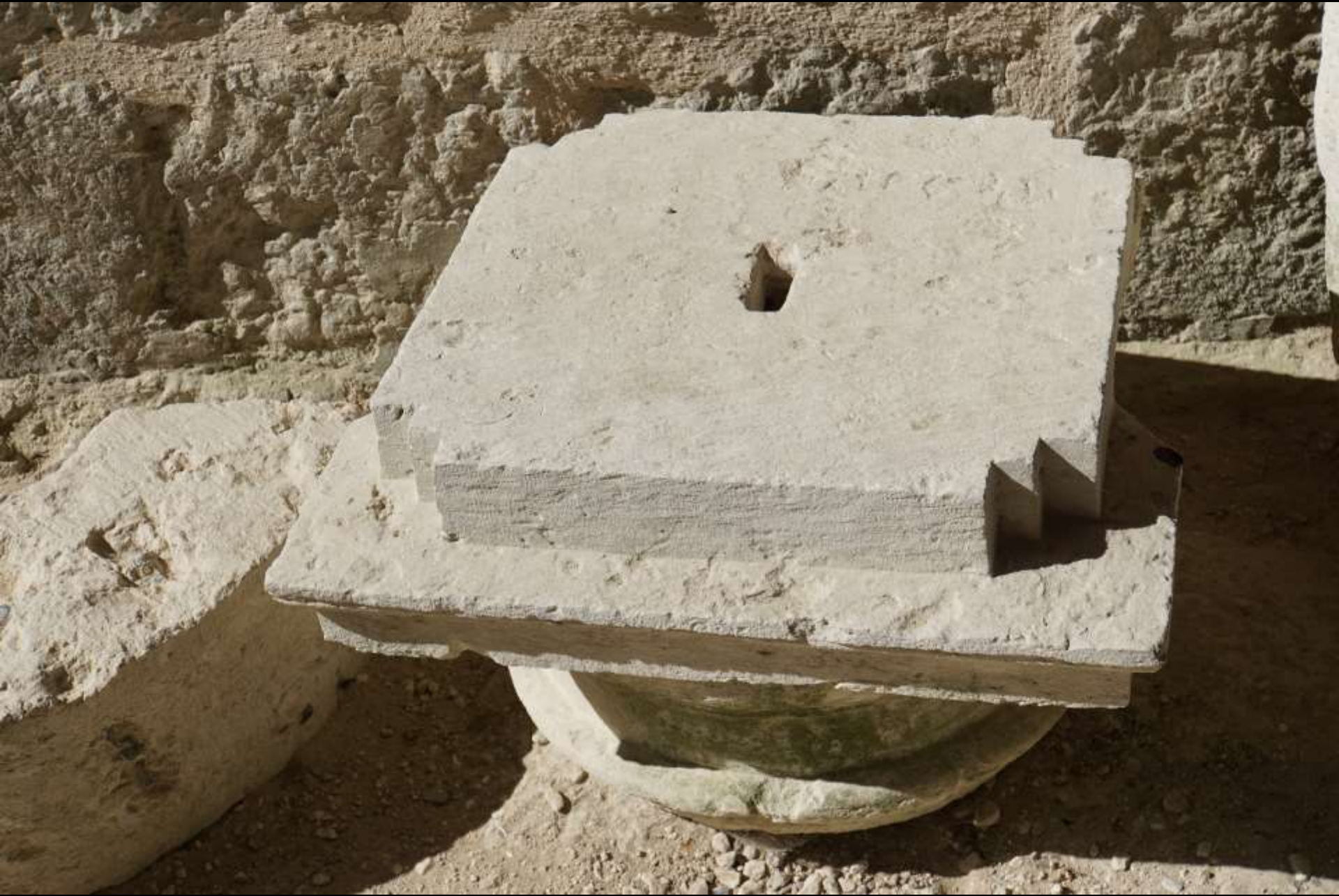
Wolfsloch in einem gotischen Werkstück (Jumièges)
