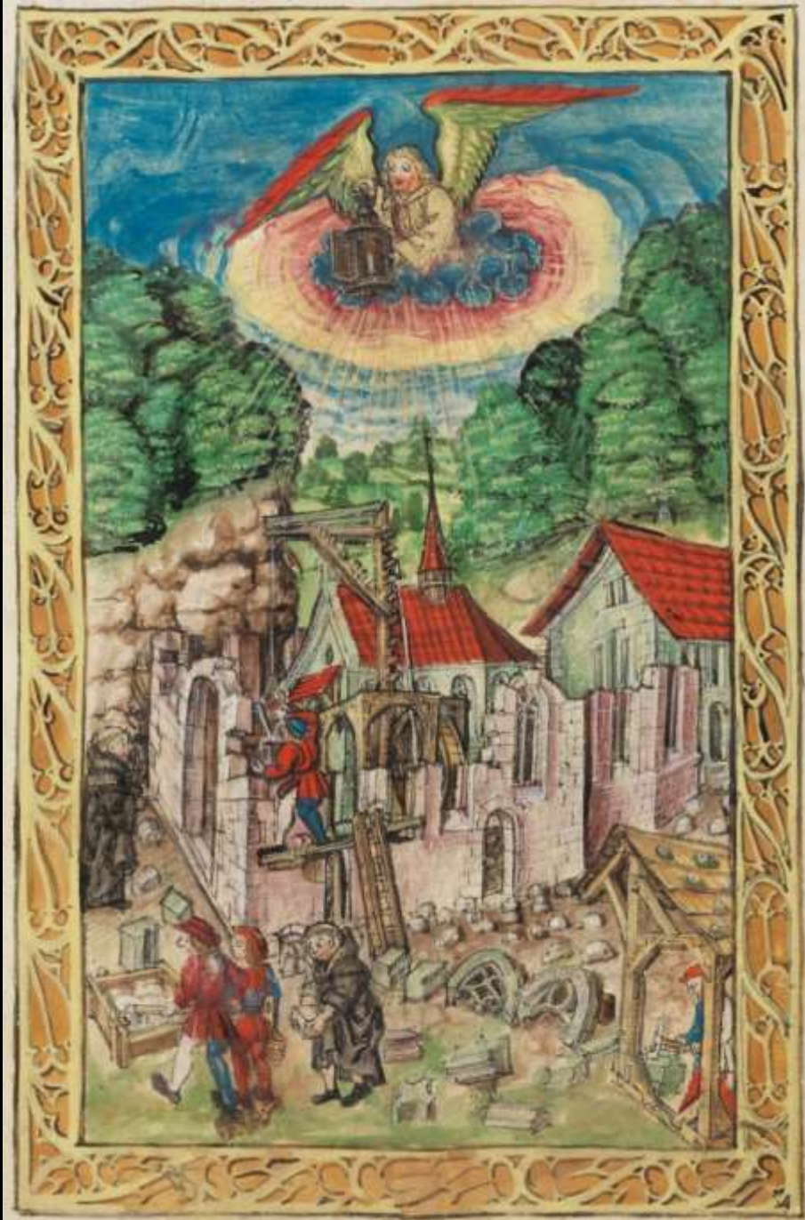
Tretradkran mit drehbarer (?) Kransäule (Diebold Schilling, Eidg. Chronik 1511-13, Korp. Luzern S23 fol.)
