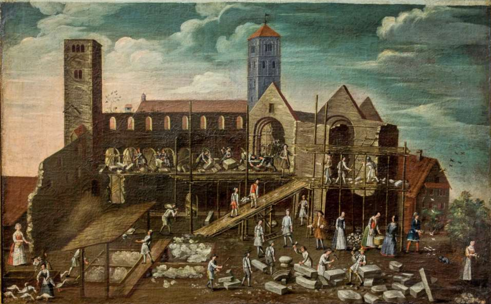
Baustelle mit Stangengerüsten auch bei partieller Werksteinverwendung – noch im 18. Jh. ganz ohne Kran! (Wiederaufbau der Stiftskirche Lindau, 1748; Lindau, Stadtmuseum)
