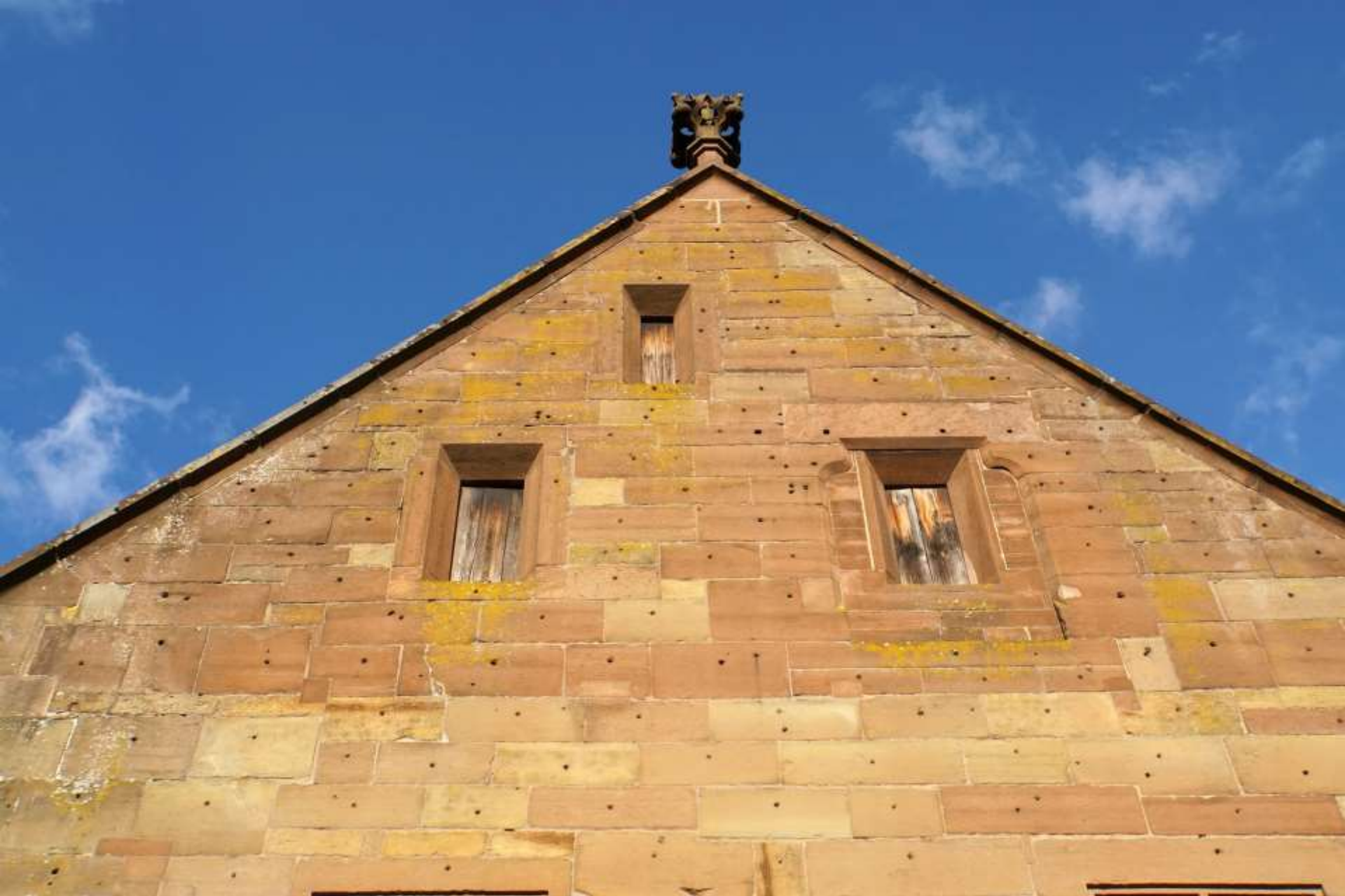
Zangenlöcher (Maulbronn, Wirtschaftsgebäude, 15. Jh.)
