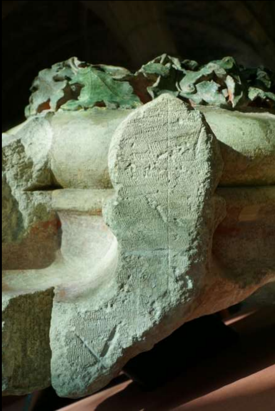
Schlussstein mit Versatzmarken (13. Jh.; Lapidarium von Saint-Benigne in Dijon)
