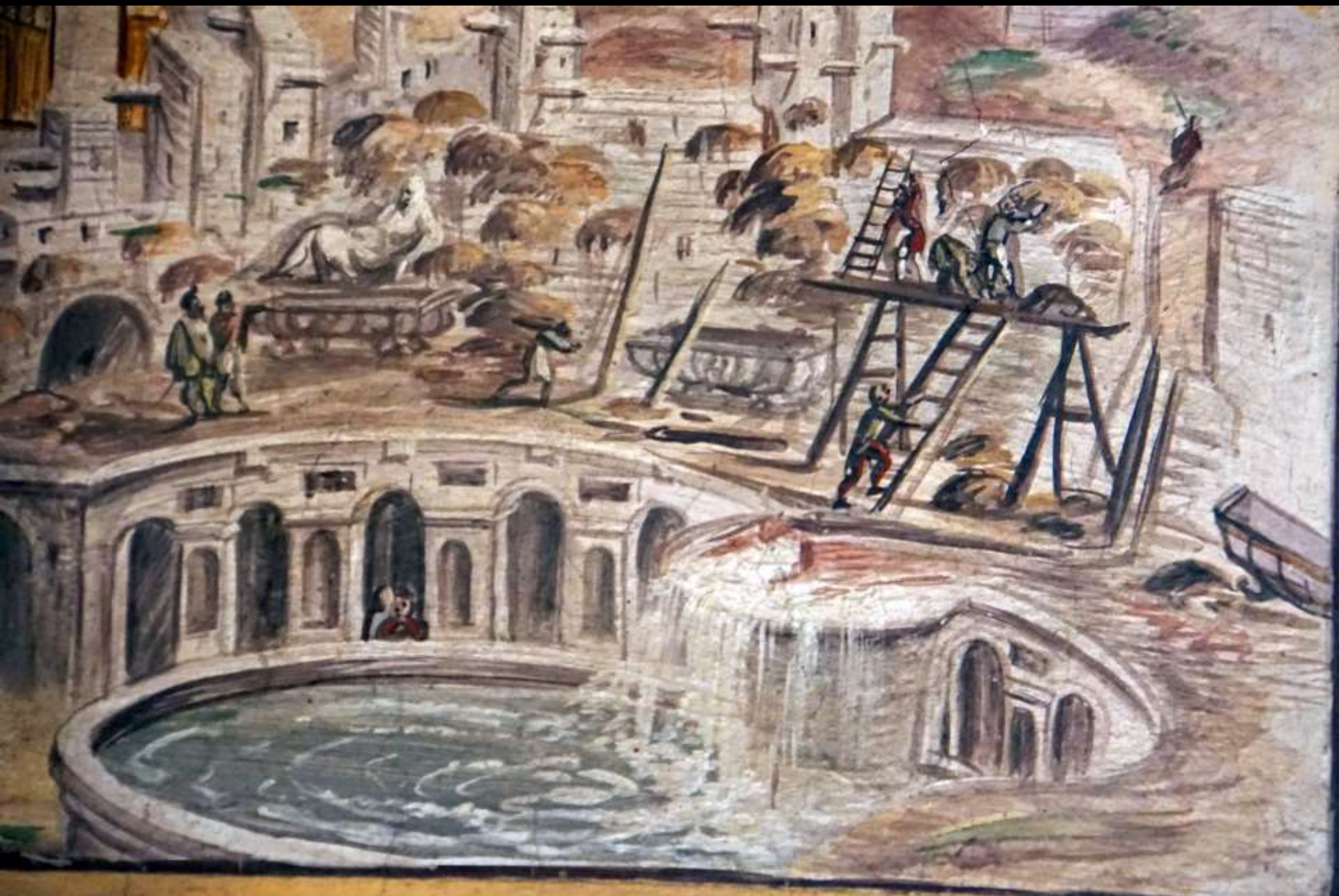
Bockgerüste (Tivoli, Villa d'Este, Fresko von Cesare Nebbia 1569: Bau der großen Fontäne)
