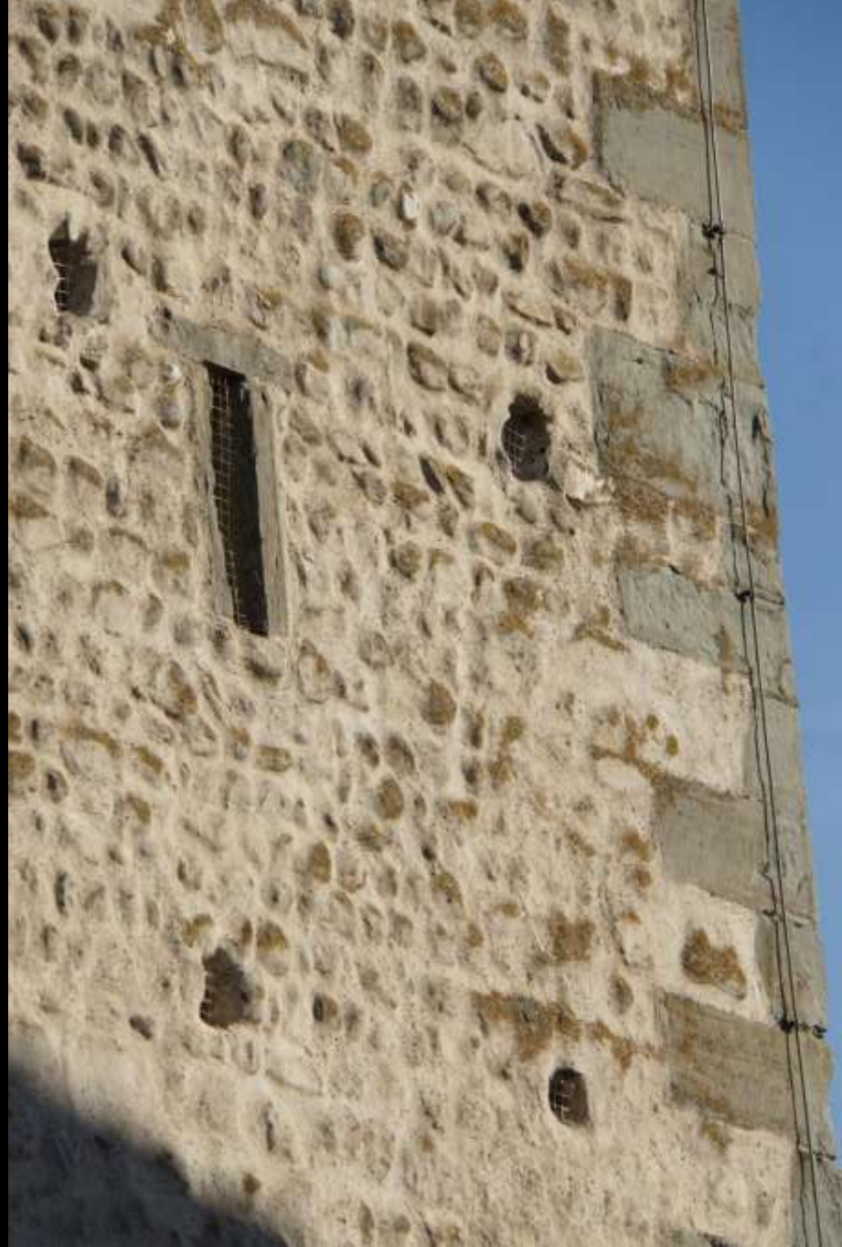
Wackenmauerwerk (Flusskiesel) als „pietra rasa“ (Niederzell/Insel Reichenau, Ende 11. Jh.)
