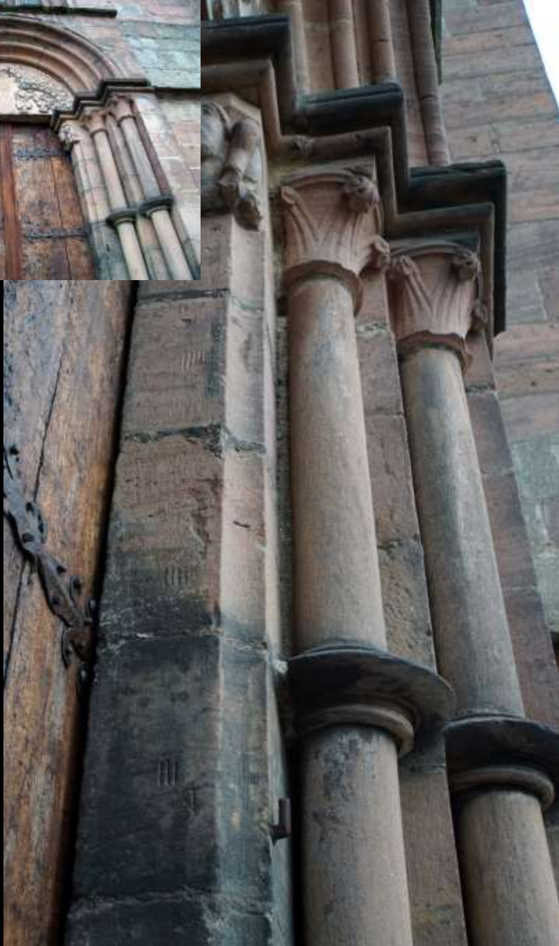
Versatzzeichen an einem umgesetzten frühgotischen Portal der Kirche St. Georg Schlettstatt
