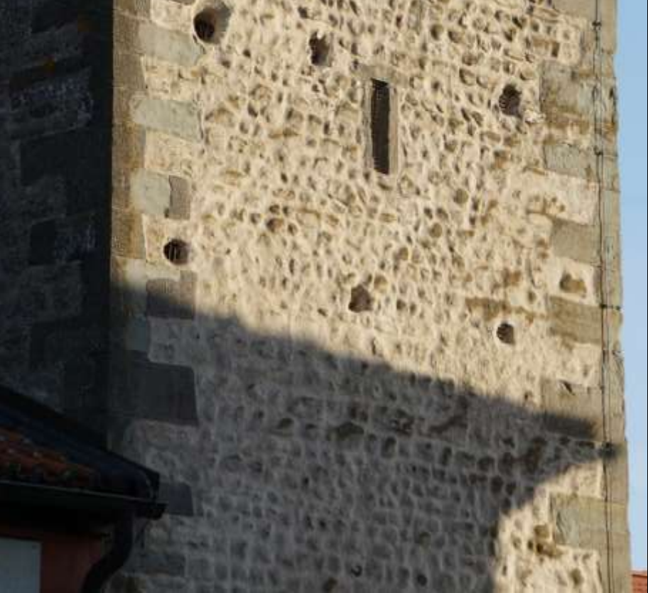
Wackenmauerwerk (Flusskiesel) als „pietra rasa“ (Niederzell/Insel Reichenau, Ende 11. Jh.)
