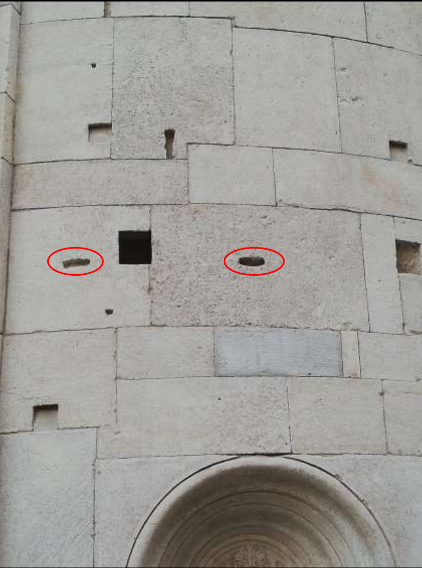
Wolfslöcher in wiederverwendeten (teils abgearbeiteten) altrömischen Quadern (Modena, Dom, Anf. 11. Jh.; Verona, Dom)
