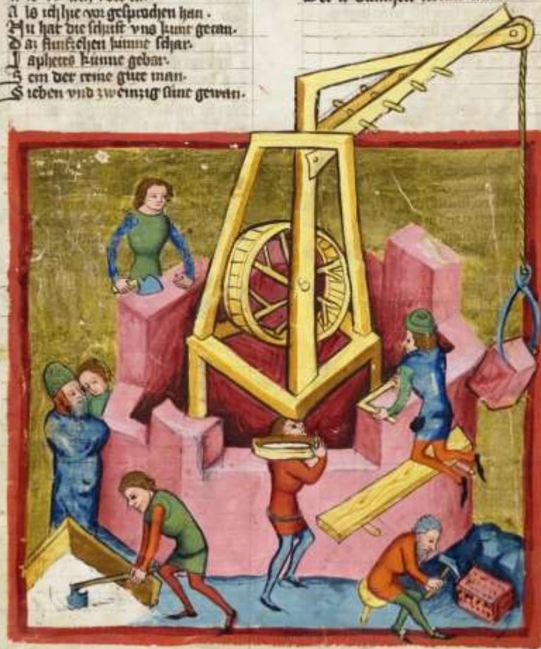
Tretradkran mit integrierter Kransäule
