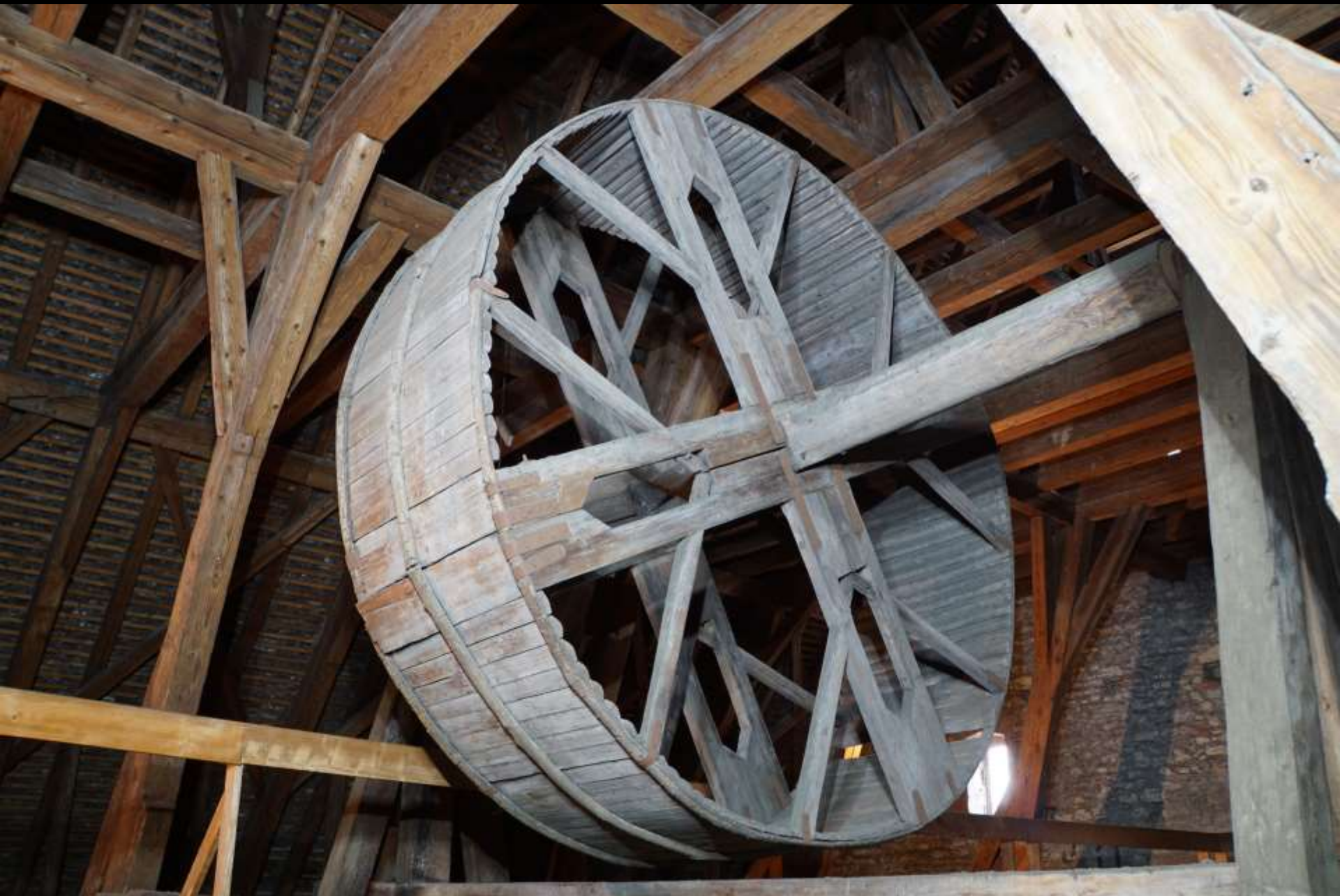
Basel, Leonhardskirche, Tretradaufzug (1489)
