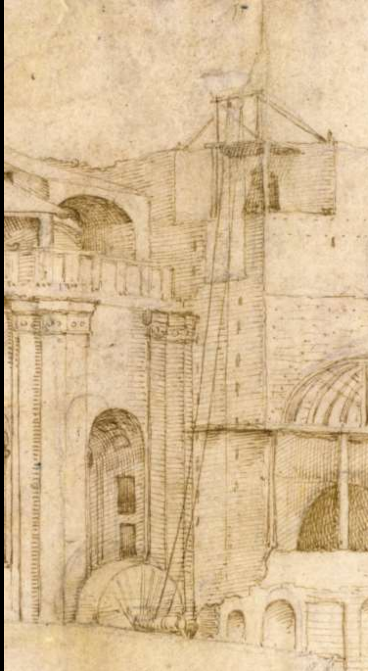
Baustelle von St. Peter in Rom 1515 (Ashby 329, Biblioteca Apostolica Vaticana, Rom, Ausschnitt)
