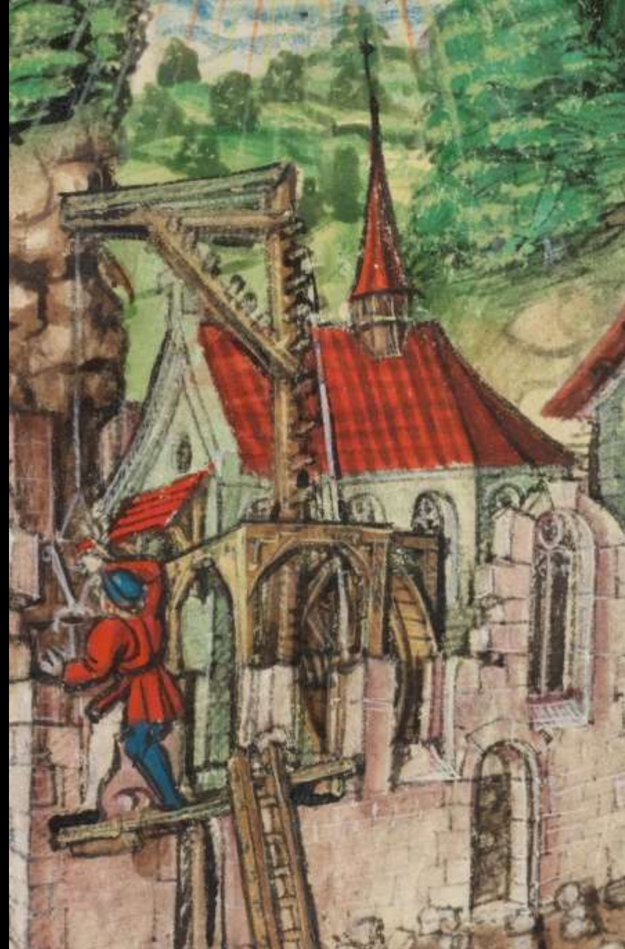
Tretradkran mit drehbarer (?) Kransäule (Diebold Schilling, Eidg. Chronik 1511-13, Korp. Luzern S23 fol.)
