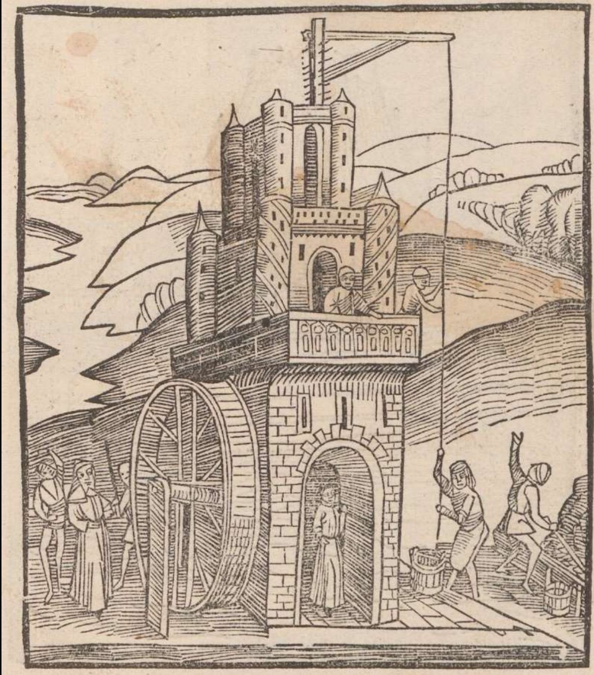
Tretrad und Galgenkran (Methodius, Revelationes Divinae , Basel 1498, fol. 6v.)
