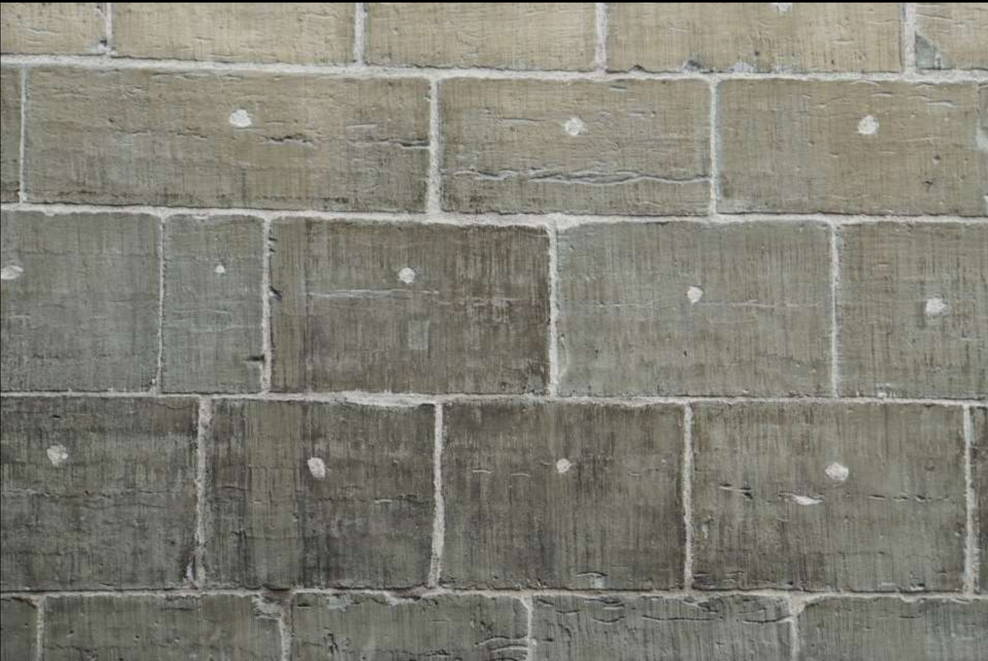
Vermörtelte Zangenlöcher (Fribourg, Münster, 15. Jh.)
