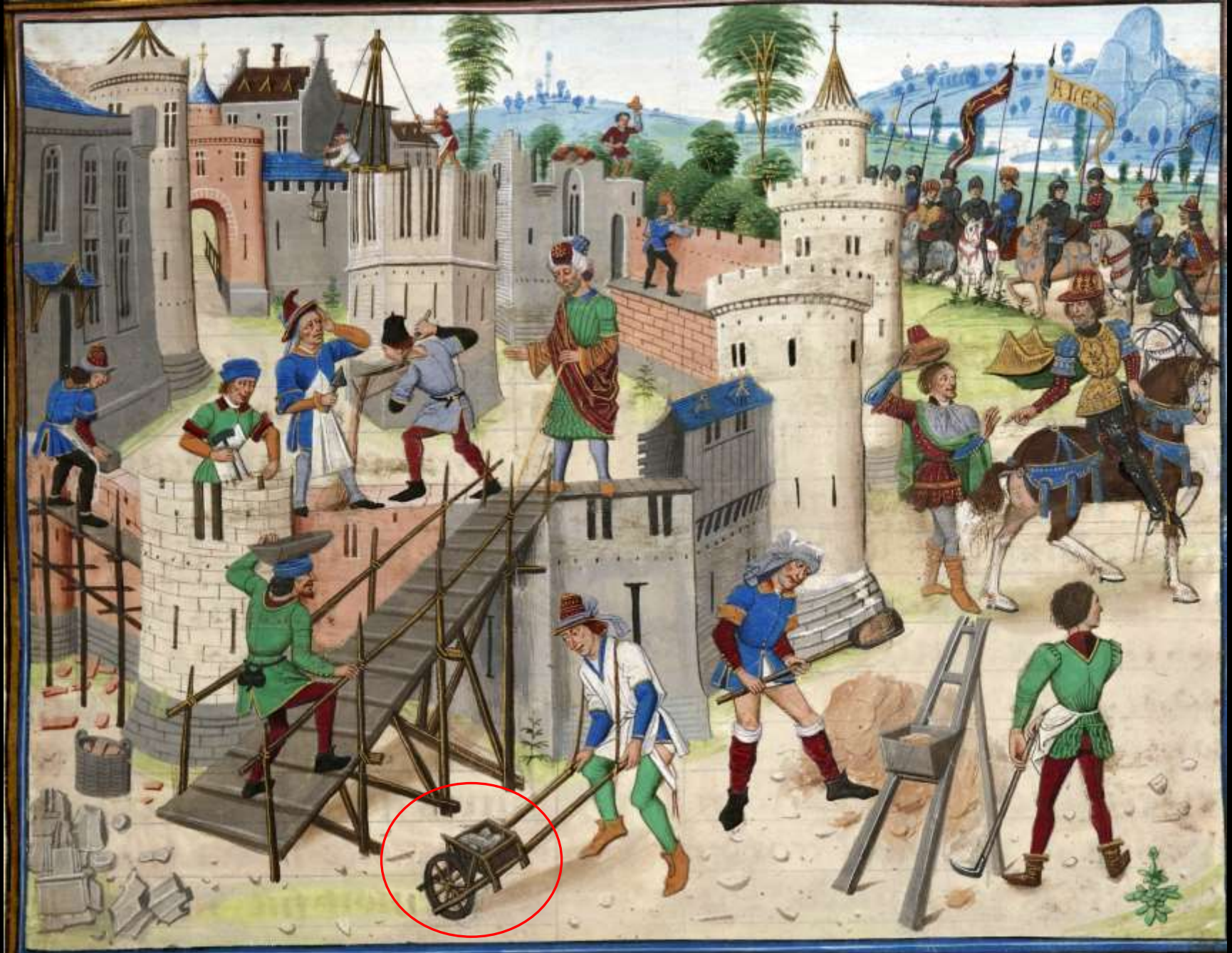
Stangengerüste und Transport von Bruchstein über Laufbrücken mit Schubkarren (Faits du grand Alexandre, Paris, BNF, Ms fr. 22547, 15. Jh.)
