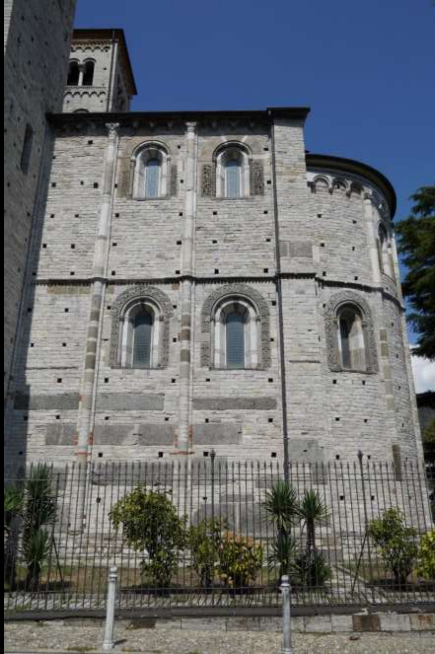
Spuren eines Stangengerüsts: Rüstlöcher (Como, Sant'Abbondio, 2. H. 11. Jh.)
