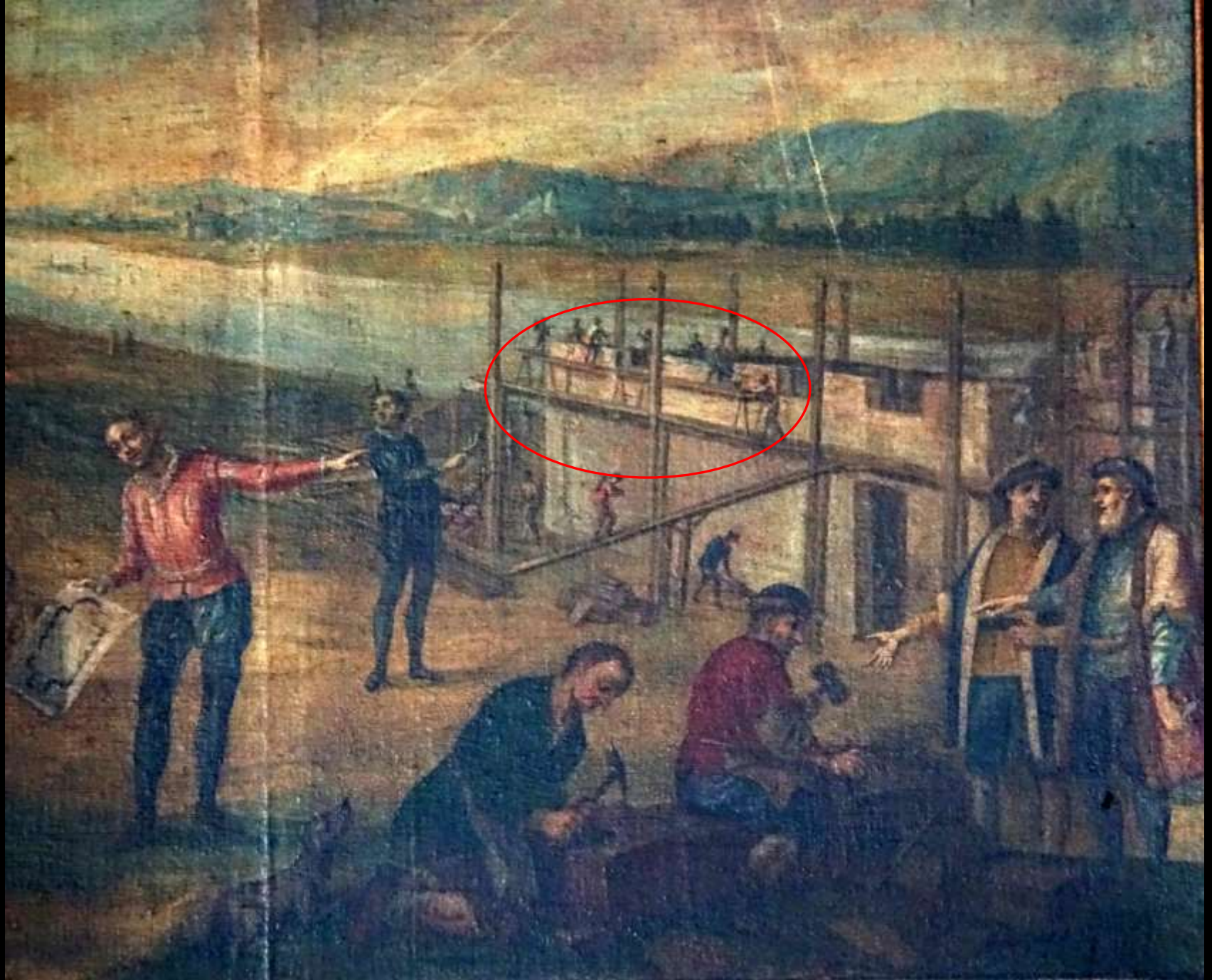
Lantenengerüst und Bockgerüste (München, Maria Thalkirchen, anonymes Jubiläumsbild, 1772)
