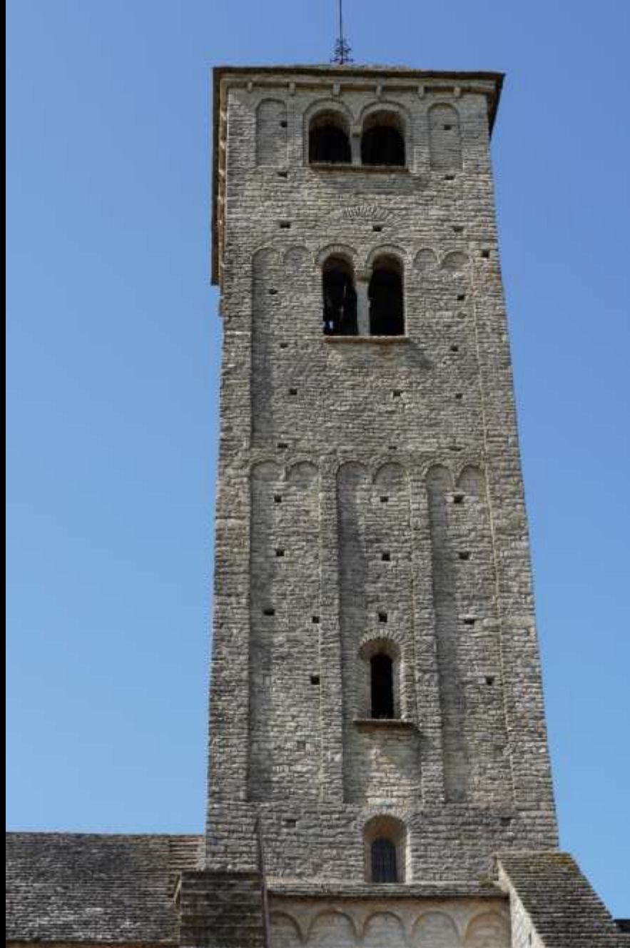
Spuren eines Stangengerüstes (?): Rüstlöcher (Chapaize/Burgund, 1. H. 11. Jh.)
