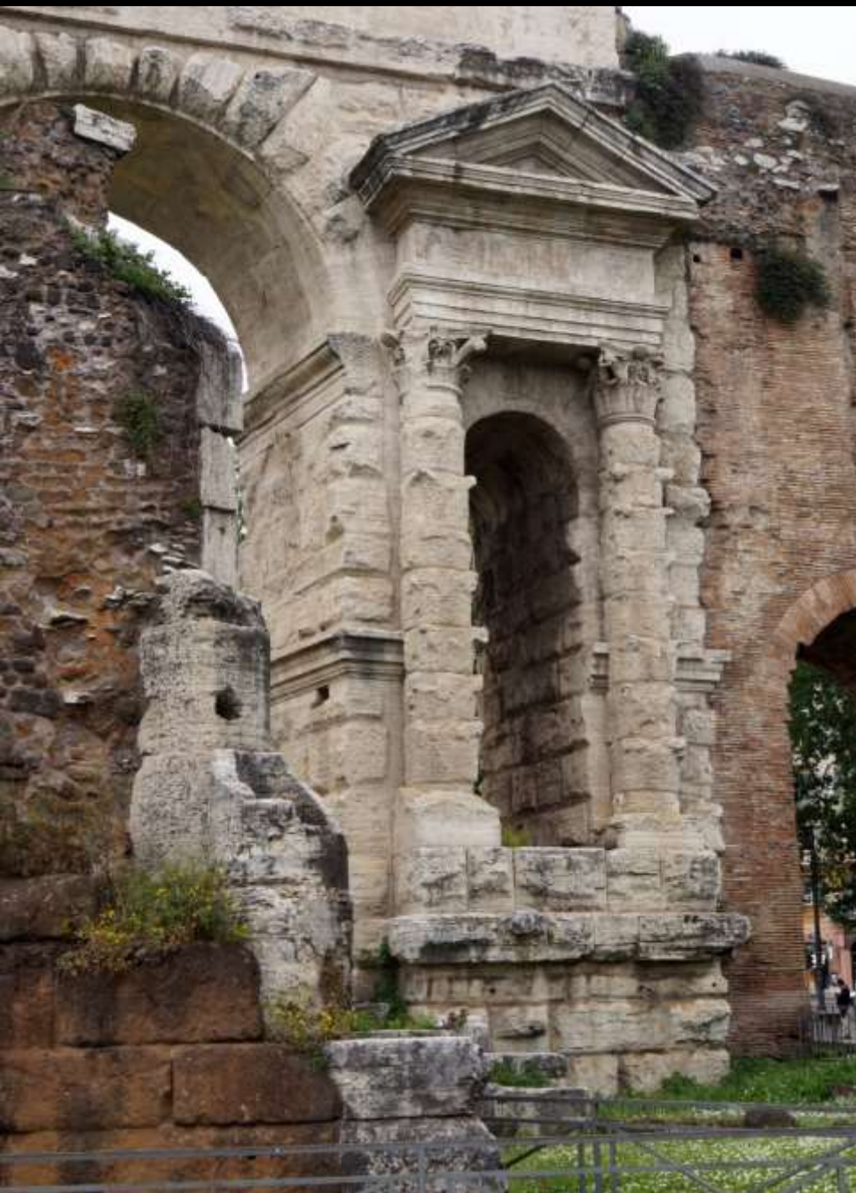
Bauwerk aus Bossenstein (Porta Maggiore, Rom, 1. Jh. n. Chr.). Bossen für Seilschlinge („Kranztau“)
