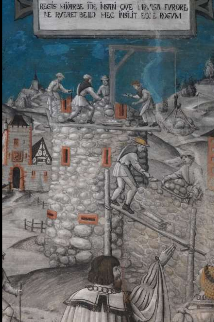
Bauen mit „Wacken“. Stangengerüst und Kraggerüst nebeneinander (Kloster St. Georgen, Stein am Rhein, Fresko, 1516, Detail)
