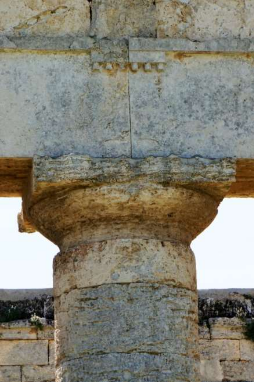
in Bosse versetzte Säulentrommeln (Segesta, Tempel, 5. Jh. v. Chr.)
