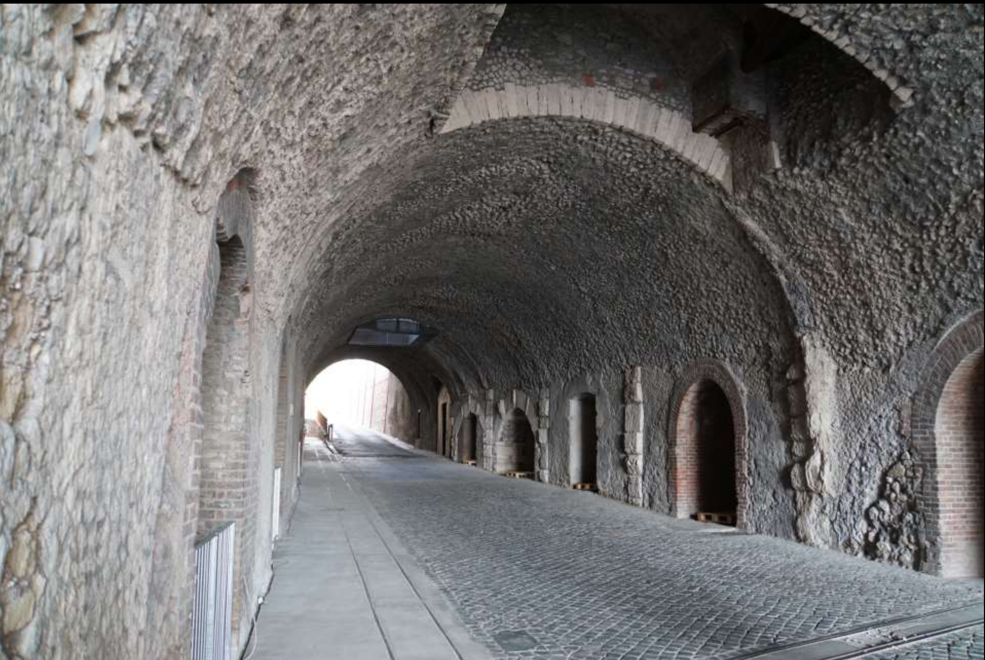
Auf Schalung hergestellte Tonnengewölbe aus Bruchstein (Tivoli, Strassendurchfahrt unter der Terrasse des Hercules-Victor-Tempels, 1. Jh. v. Chr.)
