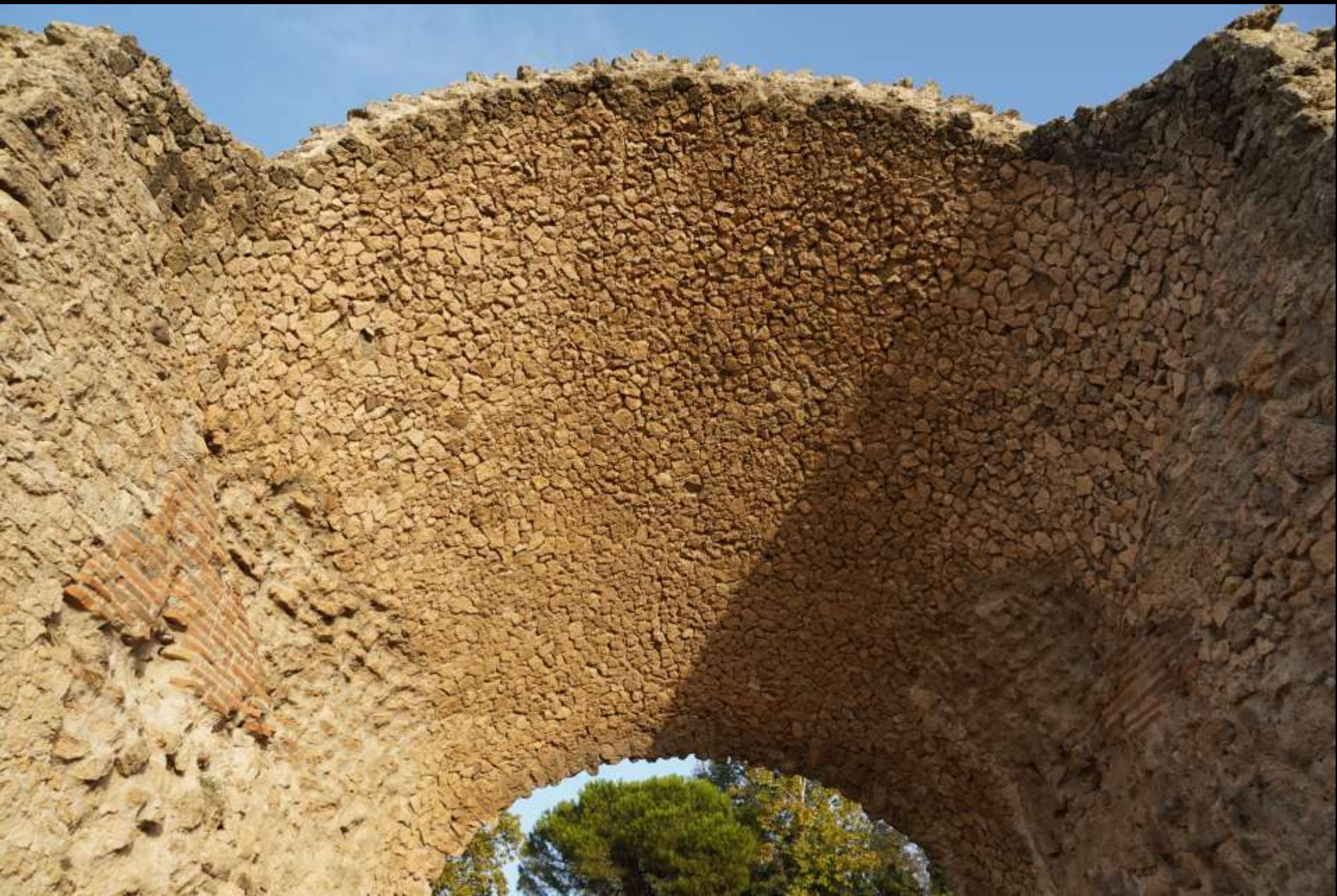
Auf Schalung hergestellte Tonnengewölbe aus Bruchstein (Paestum, Amphitheater, 1. Jh. v. Chr.)
