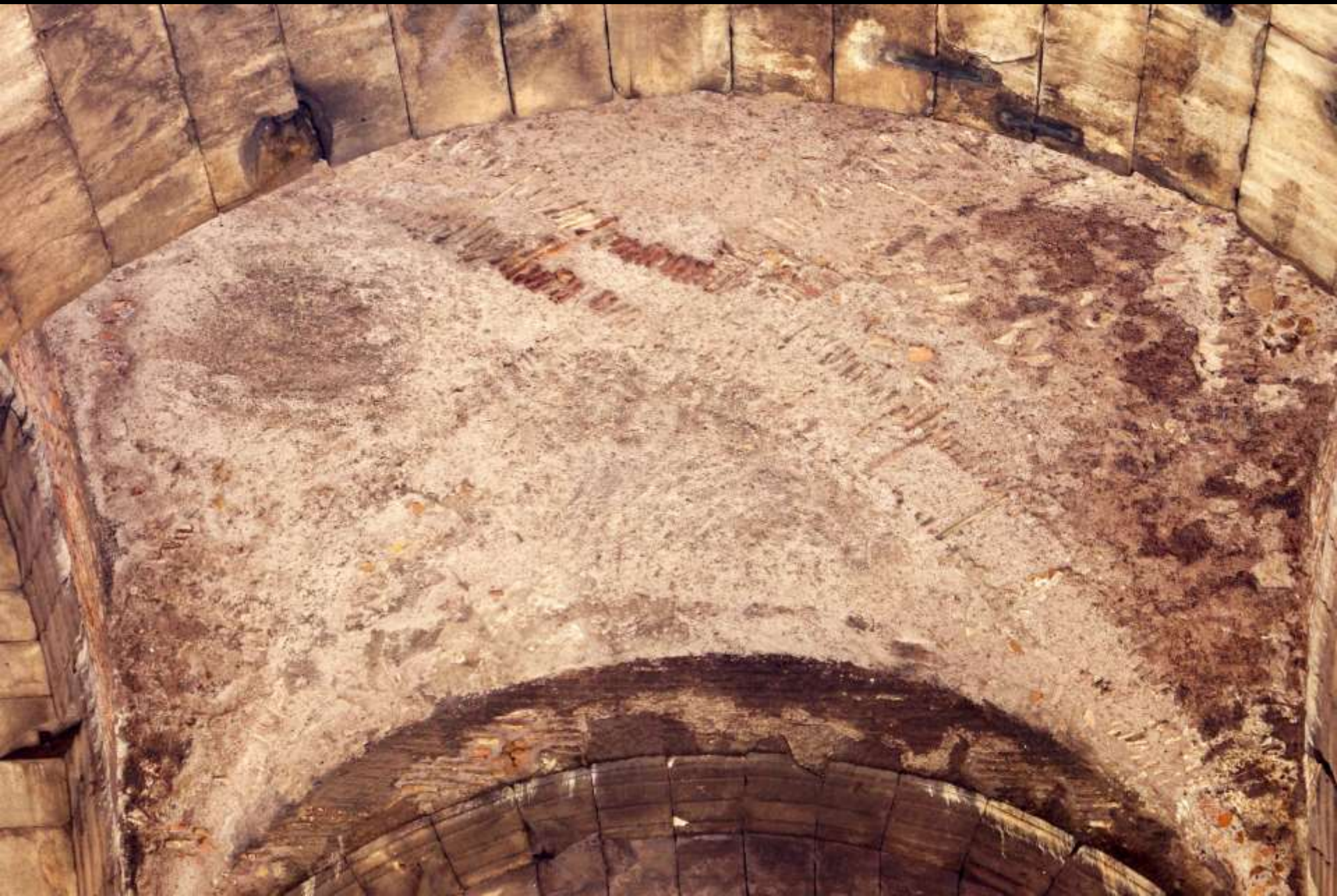
Rom, IANUS QUADRIFRONS. Gewölbe aus opus caementicium mit Rippen aus Backstein (4. Jh. n. Chr.)
