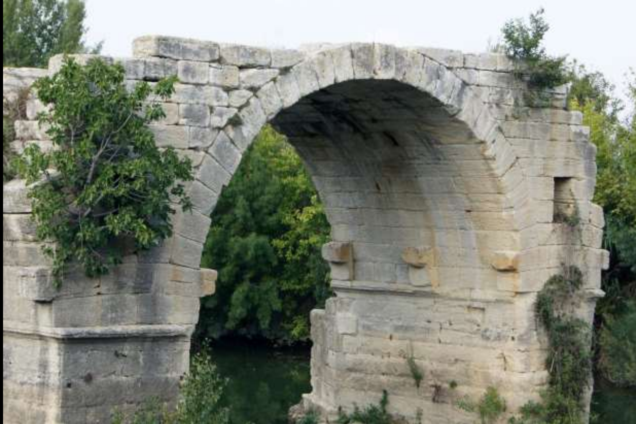
Wölben mit Werkstein Spuren der Herstellung
