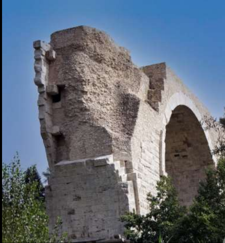
Werkstein mit Bruchsteinfüllung Brücken und Tore
