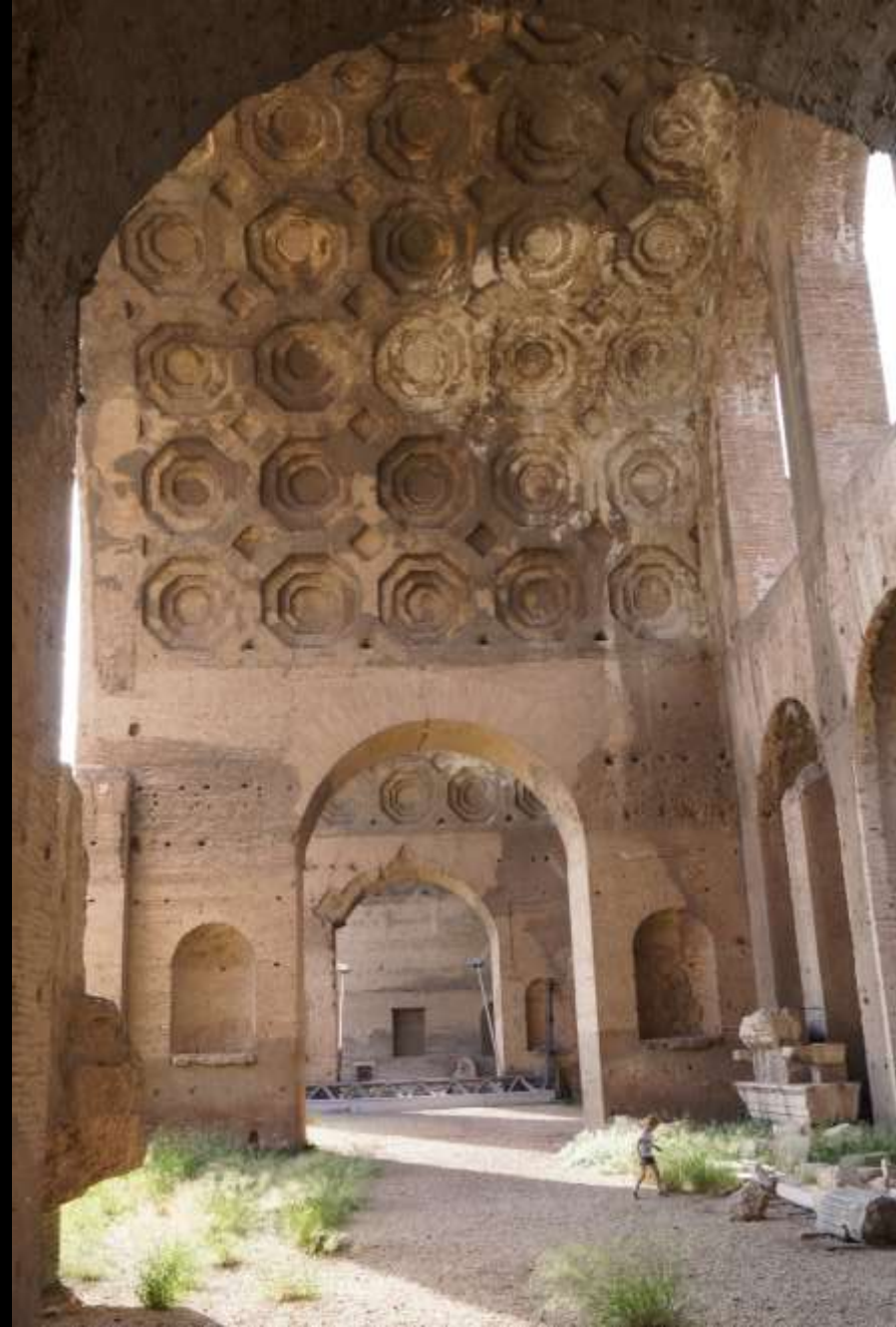
Tonnengewölbe als Widerlager des Kreuzgewölbes (Rom, Maxentiusbasilika)
