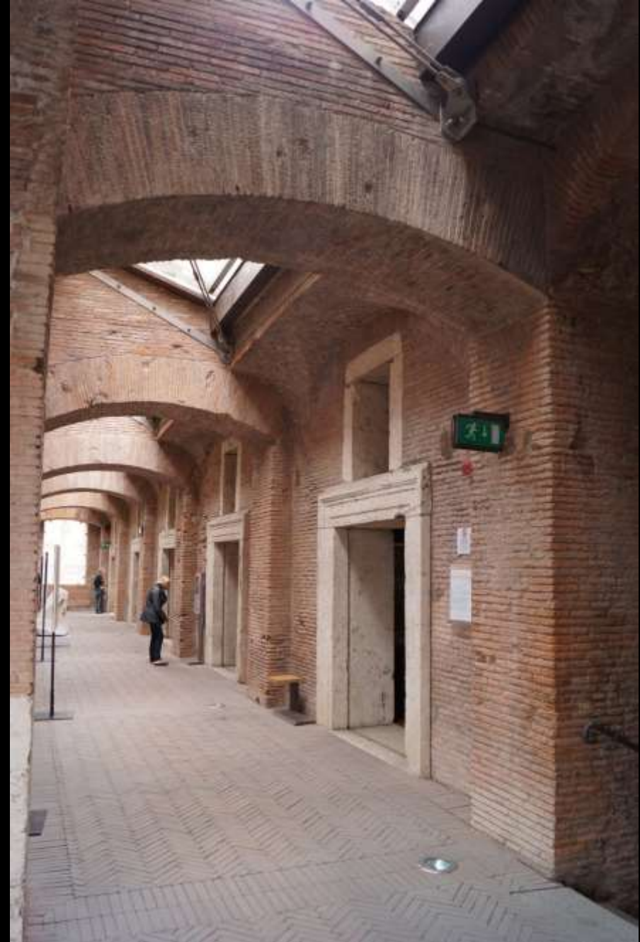
Ableitung des Gewölbeschubs durch Strebebögen (bipedalis) (Rom, Traiansmarkt, 2. Jh. n. Chr.)
