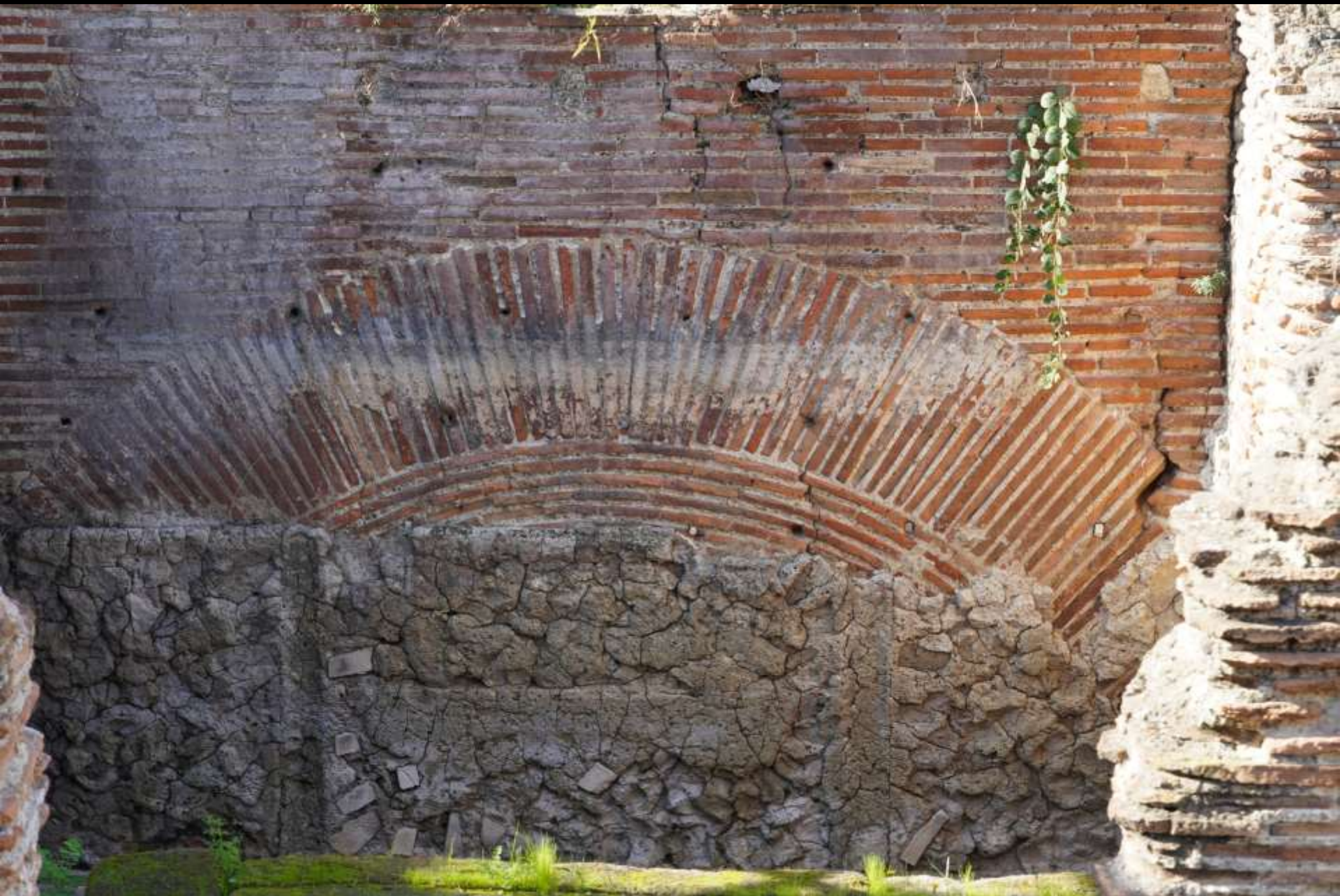
Pozzuoli, Macellum, Bogen aus Bipedalis-Platten (1. Jh. n. Chr.)
