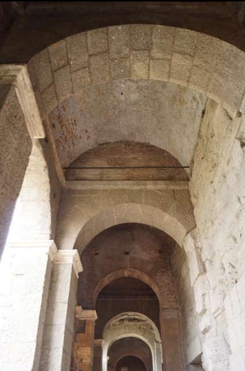
Gewölbe aus Bruchstein zwischen Werksteinbögen (Rom, Tabularium, 1. Jh. v. Chr.)
