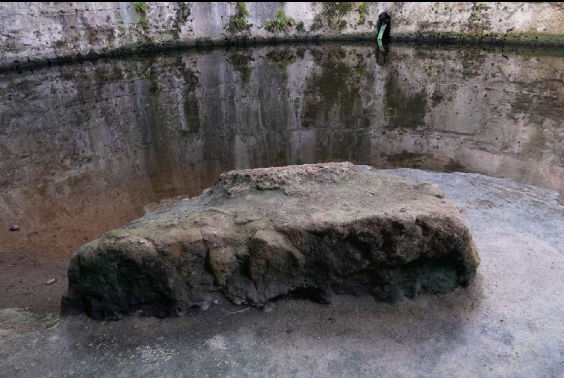
Baiae, sog. Tempel des Merkur (Badeanlage), 1. Jh. n. Chr.; Bauweise aus opus caementicium (abgestürztes Fragment mit Rest der äusseren Vermörtelung mit opus signinum)
