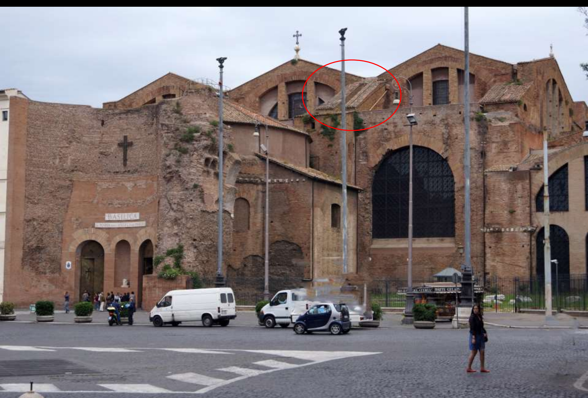
Rom, Diokletiansthermen, Frigidarium, heute Kirche Santa Maria degli Angeli Ableitung des Gewölbeschubs durch Strebemauern
