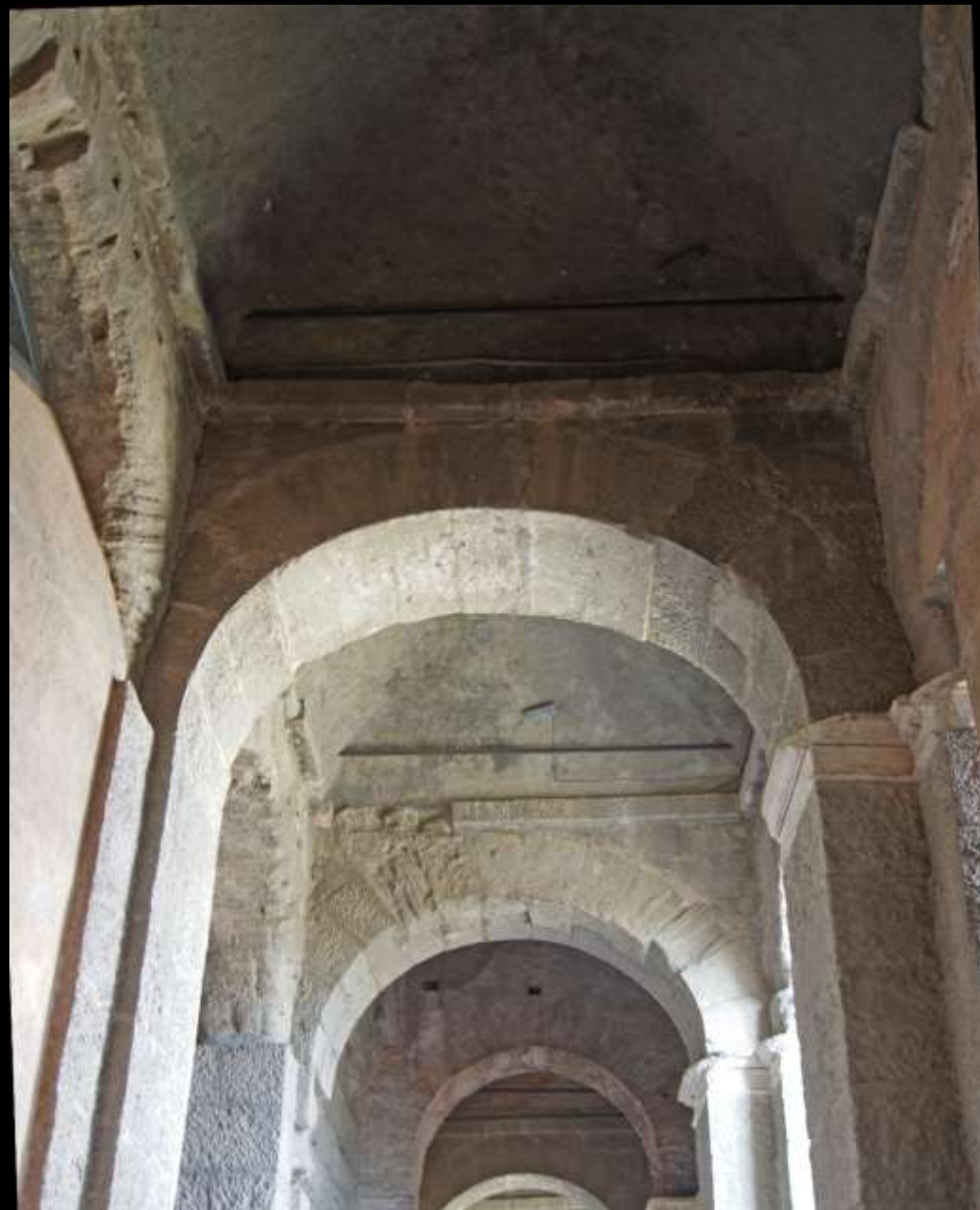
Gewölbe aus Bruchstein zwischen Werksteinbögen (Rom, Tabularium, 1. Jh. v. Chr.)
