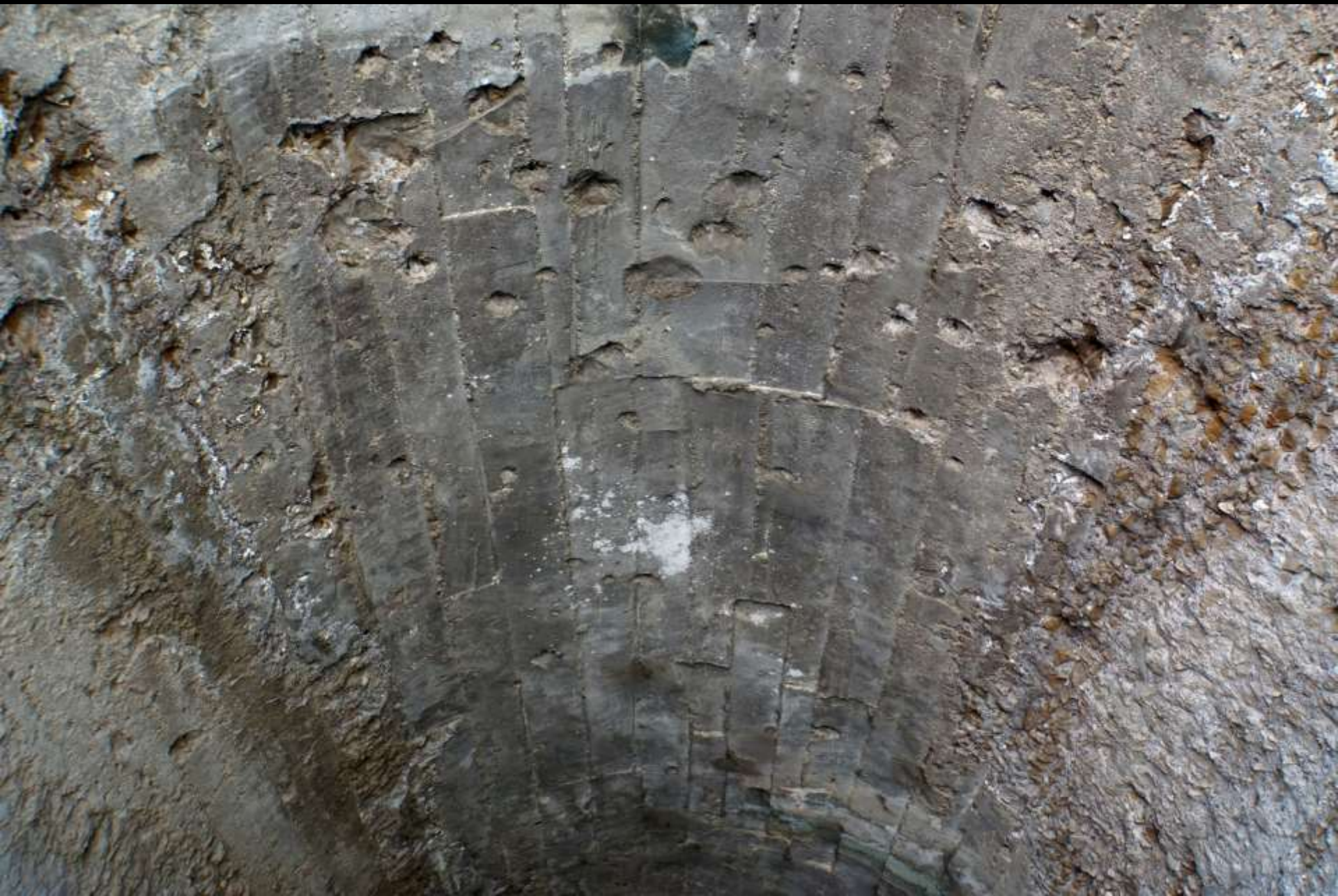
Abdrücke der Schalbretter an einem Tonnengewölbe (Tivoli, Villa Adriana, 2. Jh. n. Chr.)
