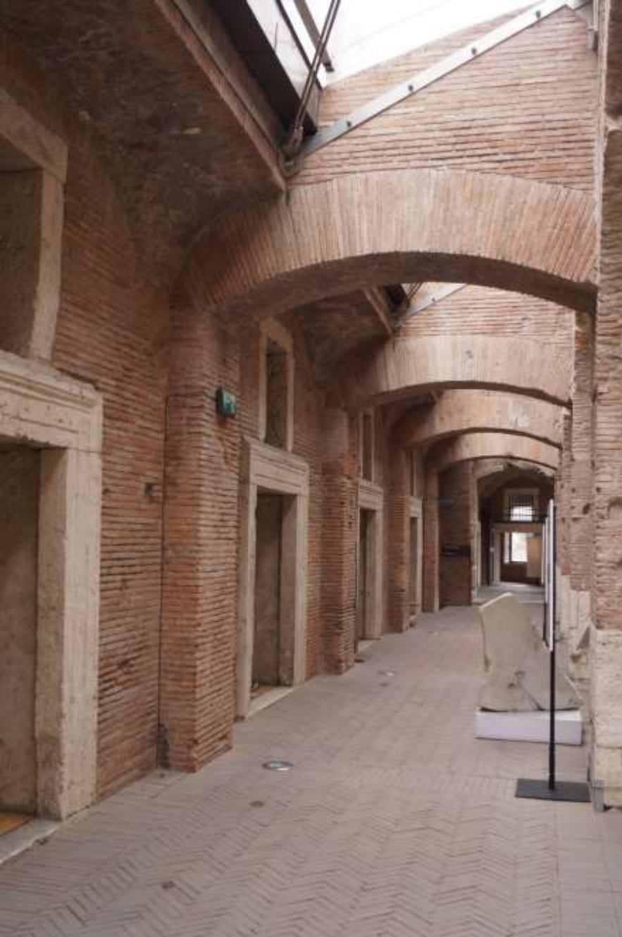
Ableitung des Gewölbeschubs durch Strebebögen (bipedalis) (Rom, Traiansmarkt, 2. Jh. n. Chr.)
