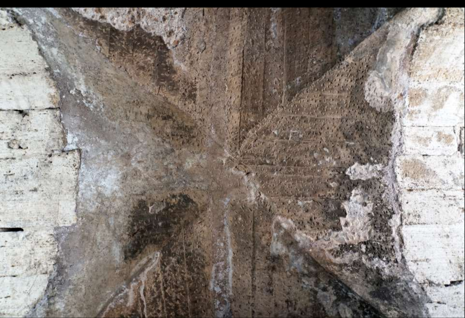
Kreuzgewölbe mit Schalbrettabdrücken (Rom, Colosseum, 1. Jh. n. Chr.)
