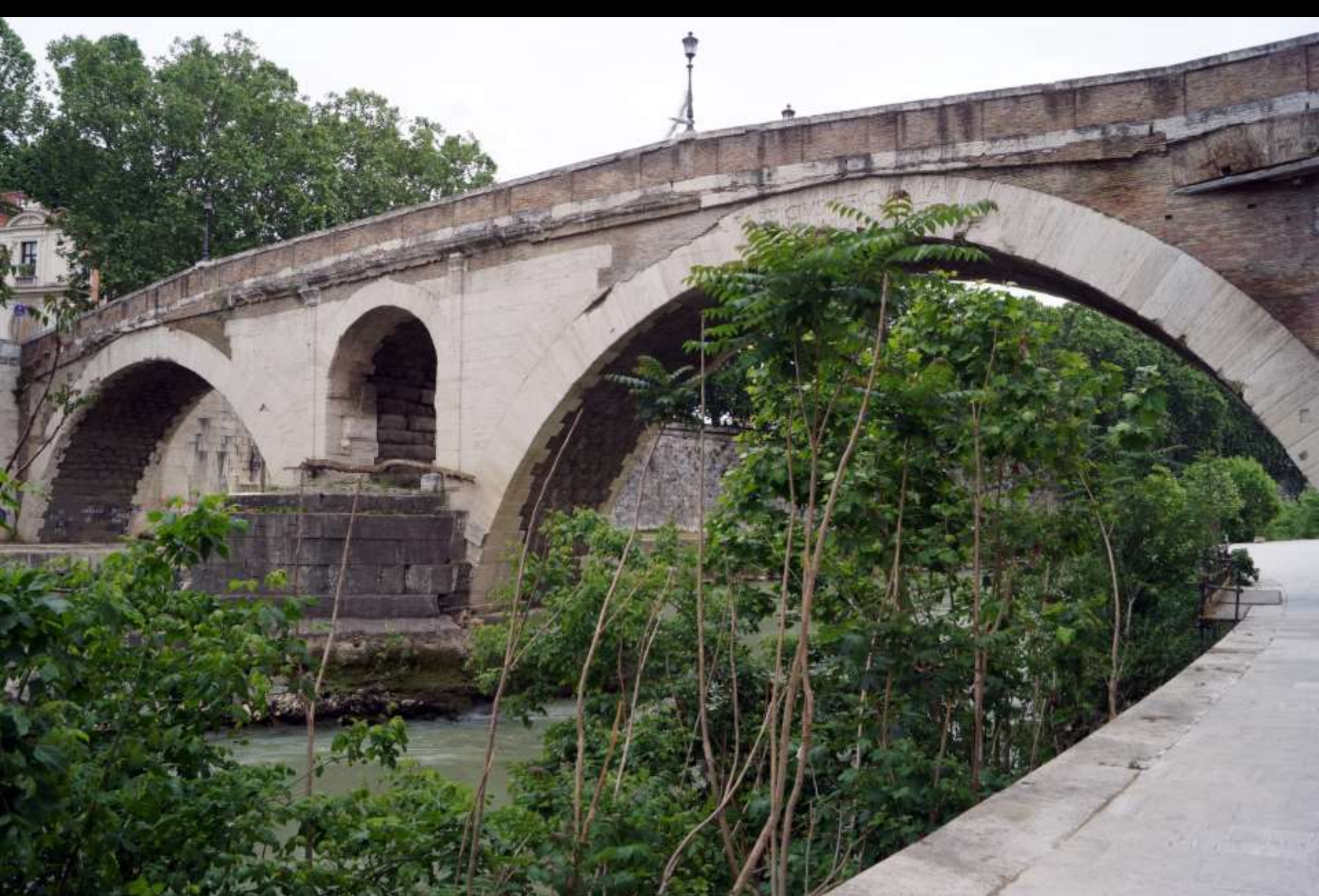
Reste der Travertinverkleidung an der Oberstromseite (Rom, Pons Fabricius, 62 v. Chr.)
