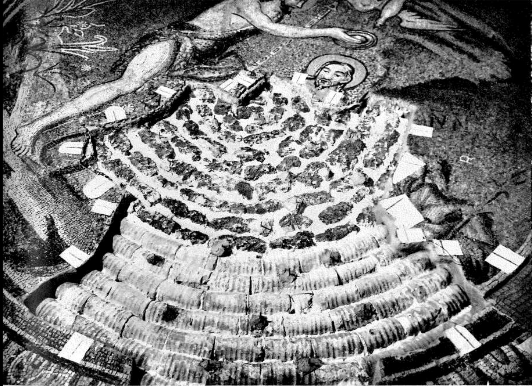
Ravenna, Baptisterium der Kathedrale, 5. Jh.; während der Restaurierung freiliegende tubi fittili der Kuppel (Foto: Bovini 1965)
