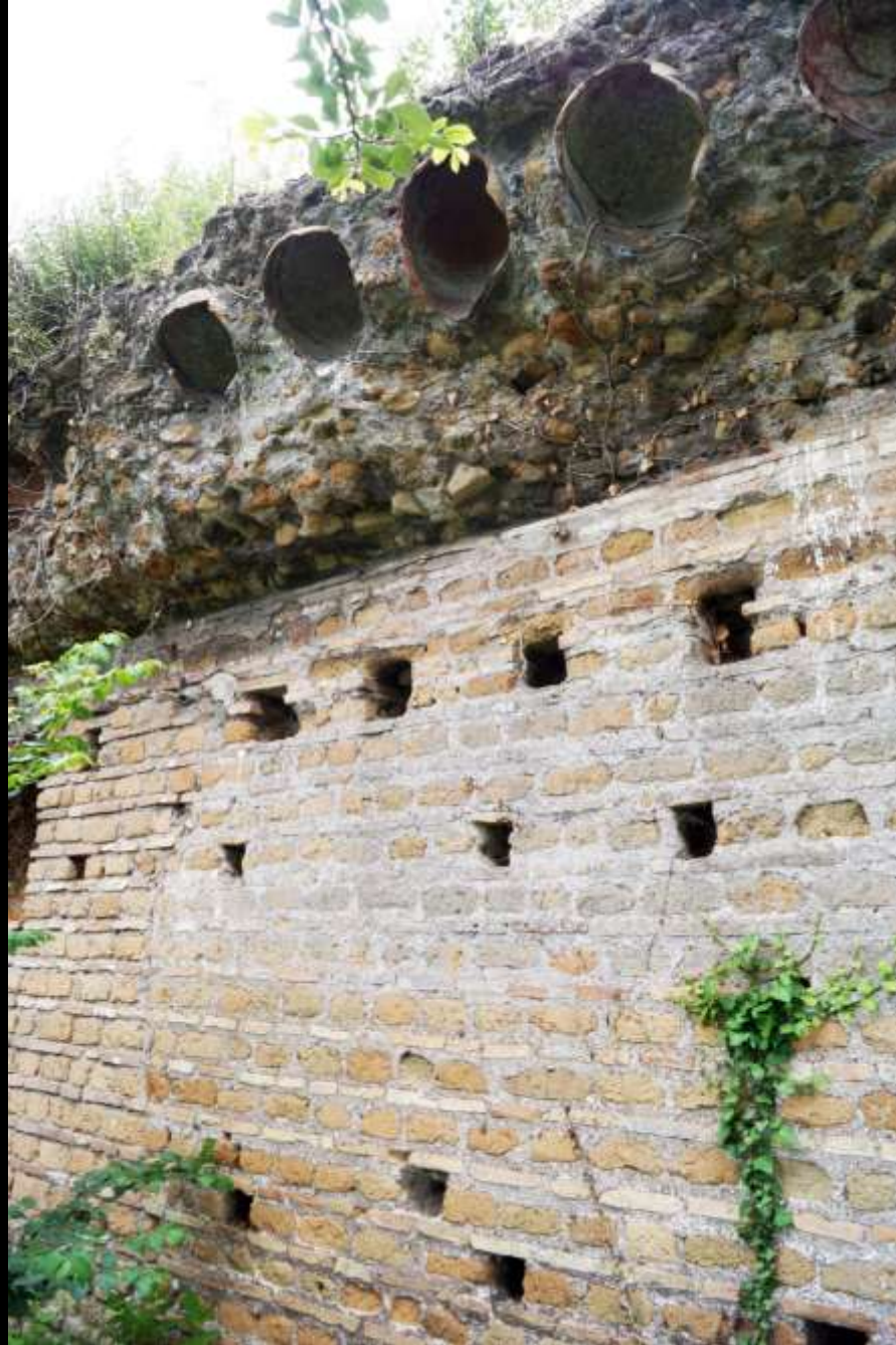
Rom, Via Appia, Circus des Maxentius. Gewölbeansatz mit eingebauten Tongefässen (3./4. Jh. n. Chr.)
