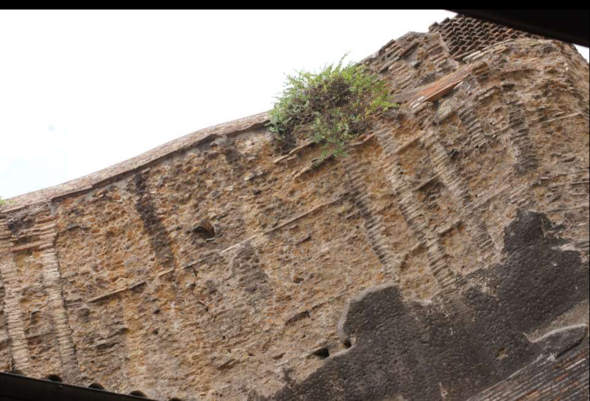
Rom, Agrippathermen, sogenannter „Arco della Ciambella“. Kuppel aus Opus caementicium mit Backsteinrippen (4. Jh. n. Chr.)
