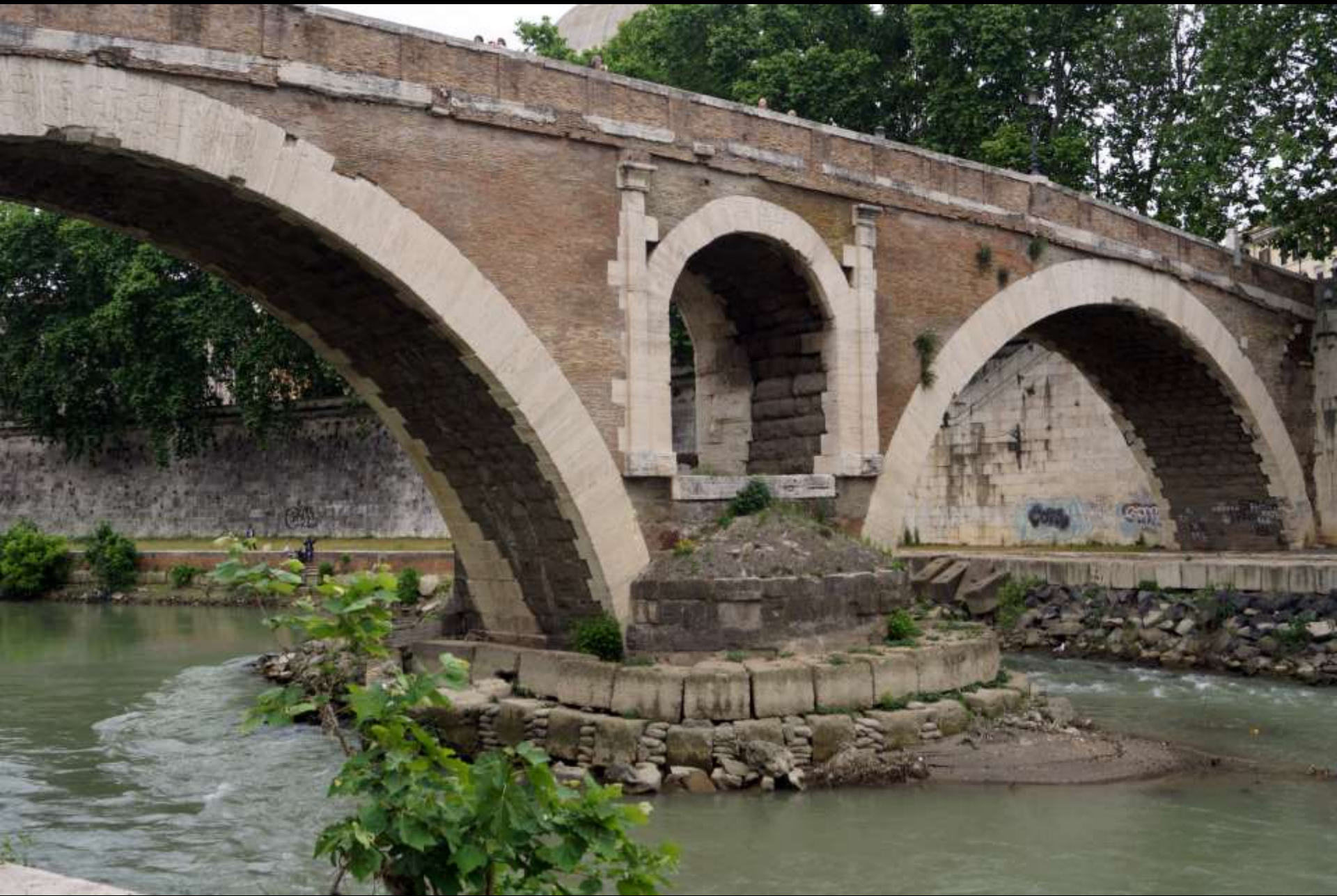
Bögen mit Keilsteinen aus Werkstein, mörtellos gefügt. Spannweite rund 25 m. (Rom, Pons Fabricius, 62 v. Chr.)
