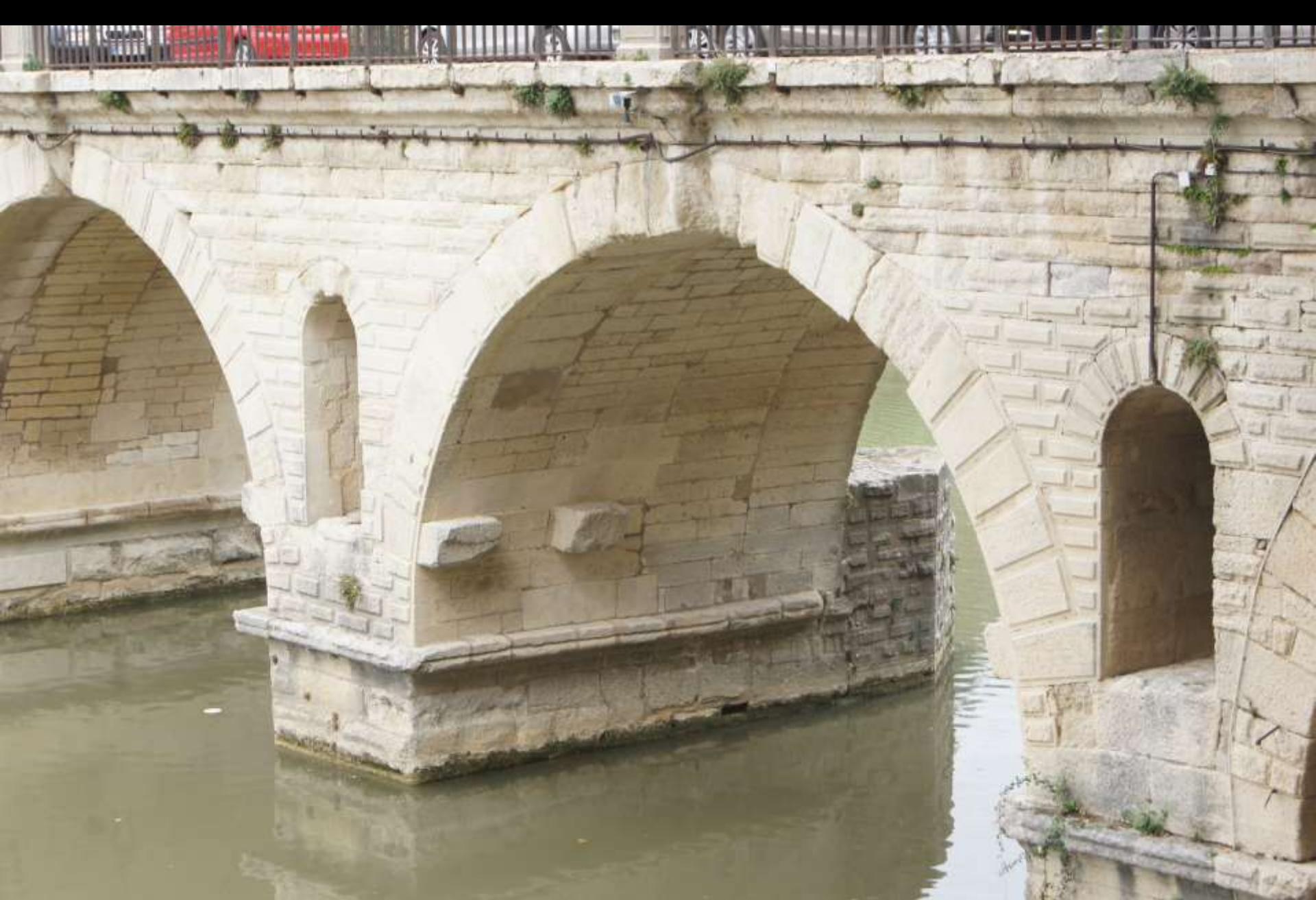
Kragsteine als Auflager für Lehrgerüst (Sommières, Brücke, 1. Jh. n. Chr.)
