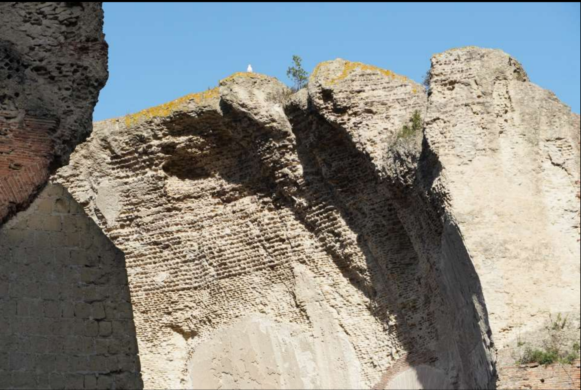
Baiae, sog. Tempel der Diana (Badeanlage), Kuppel aus Bruchsteinmauerwerk (Tuff) in horizontalen Schichten (Durchmesser 26,2 m; 2. Jh.)
