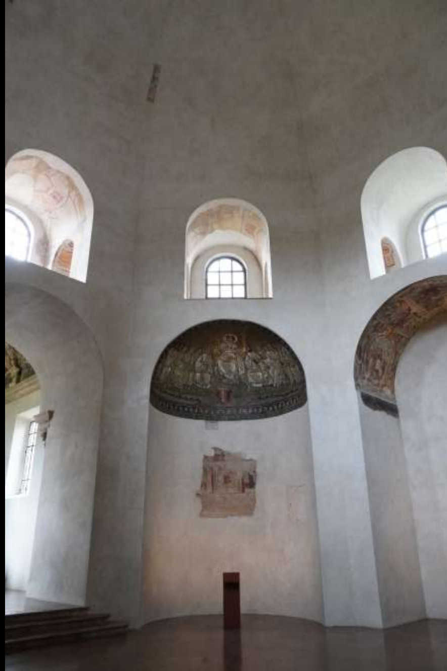
Mailand, kaiserliches Mausoleum bei San Lorenzo, heute Sant'Aquilino (Ende 4. Jh. n. Chr.) Kuppel massiv aus Backstein
