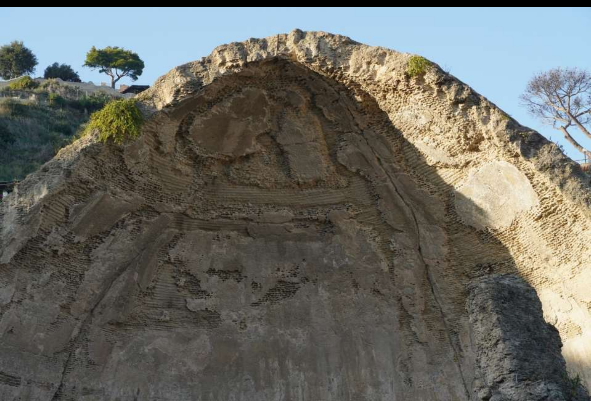
Baiae, sog. Tempel der Diana (Badeanlage), Kuppel aus Tuffsteinmauerwerk in horizontalen Schichten (Durchmesser 29,8 m; 3. Jh.)
