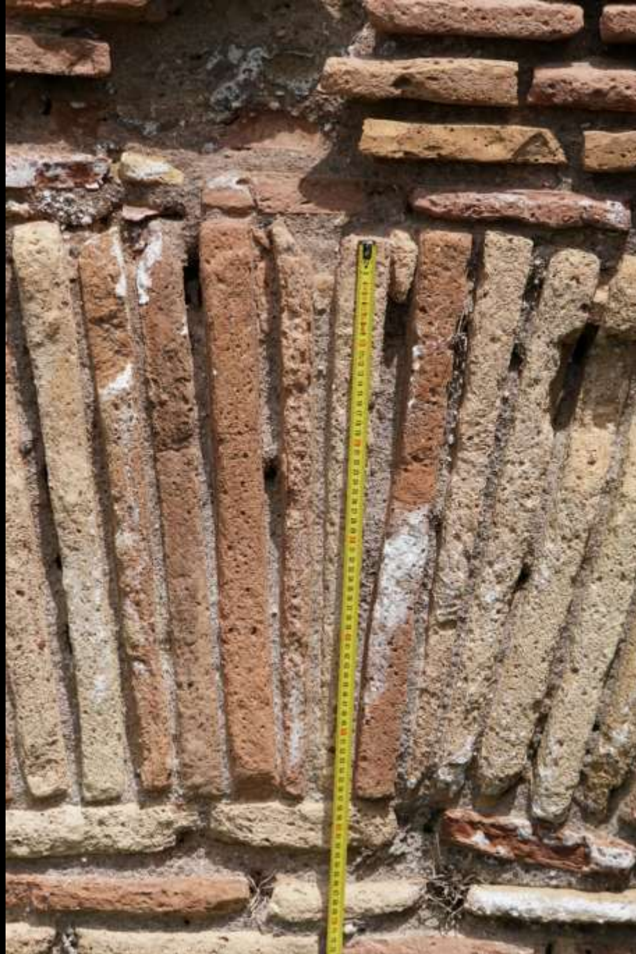
Ostia, gewölbte Fenster- und Türstürze aus bipedalis-Backsteinplatten mit keilförmiger Mörtelfuge (2. Jh. n. Chr.)
