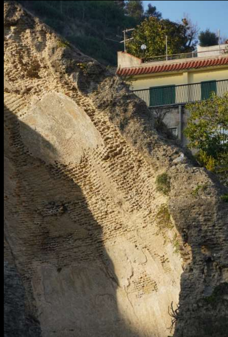
Baiae, sog. Tempel der Diana (Badeanlage), Kuppel aus Tuffsteinmauerwerk in horizontalen Schichten (3. Jh.)
