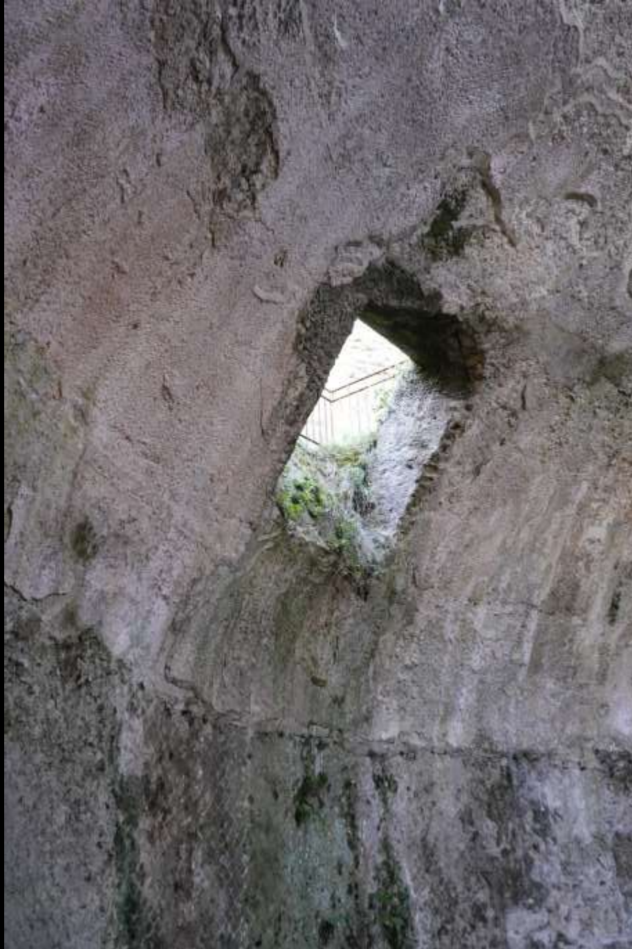
Baiae, sog. Tempel des Merkur (Badeanlage), 1. Jh. n. Chr.; Bauweise aus opus caementicium
