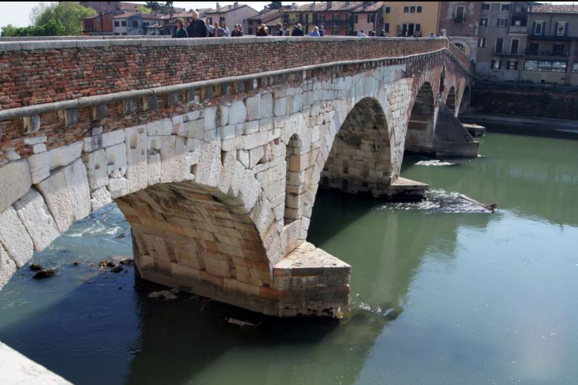
Lehrgerüstspuren: Balkenlöcher (Verona, Ponte di Pietra über die Etsch, 2. Jh. n. Chr.)
