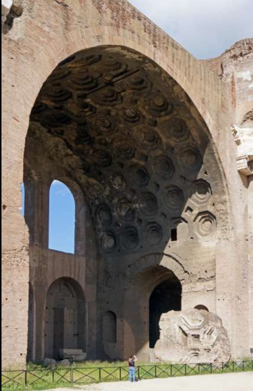
Tonnengewölbe als Widerlager des Kreuzgewölbes (Rom, Maxentiusbasilika)
