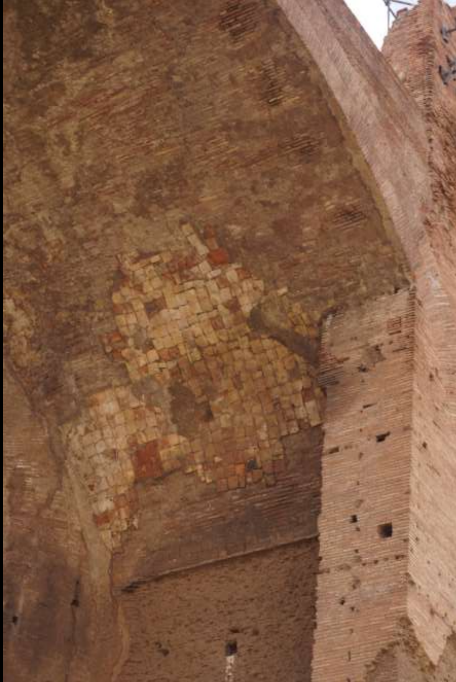
Backsteinplatten an Opus-Caementicium-Gewölben der Caracallathermen in Rom (2./3. Jh. n. Chr.)
