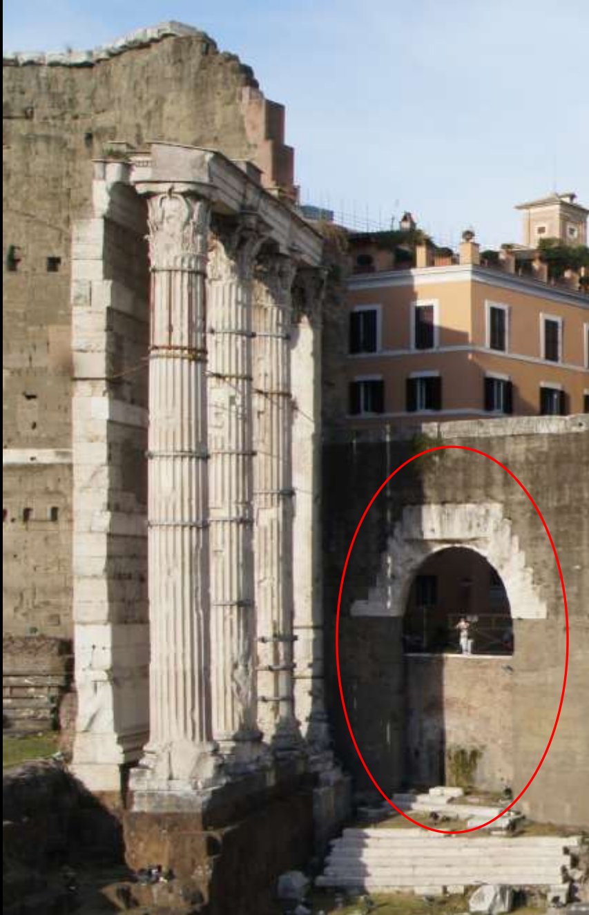
Bogen mit stufenförmiger Verzahnung mit dem Wandverband (Rom, Augustusforum, 1. Jh. v. Chr.)
