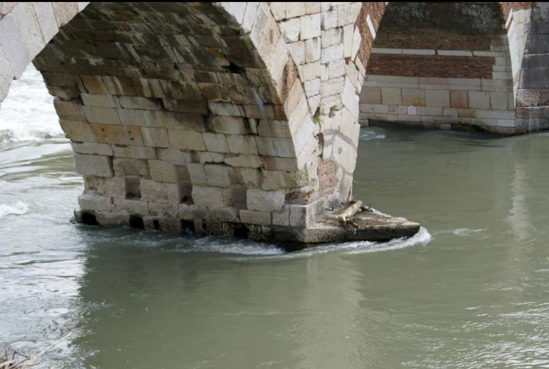
Lehrgerüstspuren: Balkenlöcher (Verona, Ponte di Pietra, 2. Jh. n. Chr.; mit Originalmaterial wiederaufgebaut)
