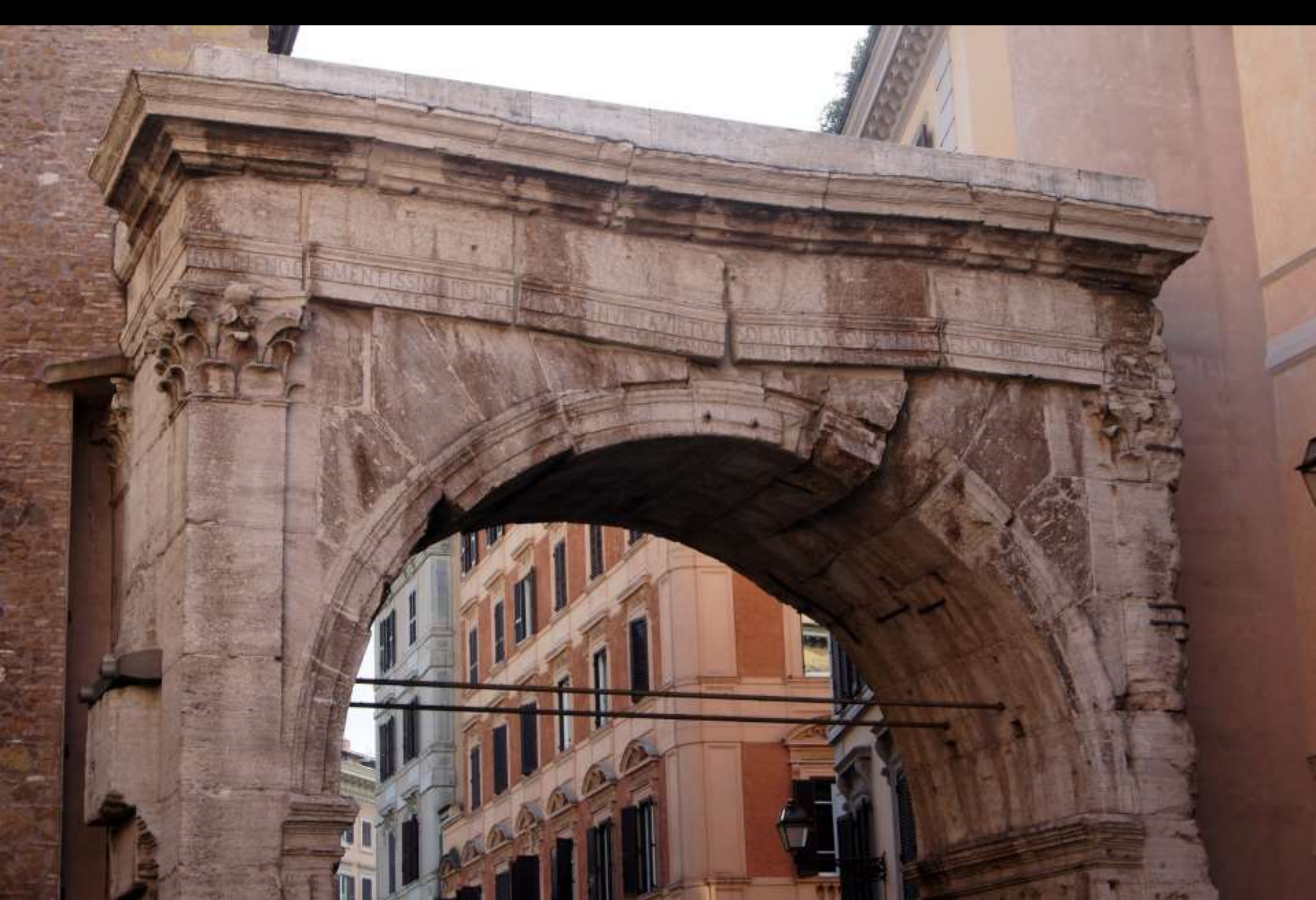
Stadttor aus Werkstein. Steinschnitt des Bogens in den Verband des opus quadratum eingepasst (Rom, Arco di Gallieno, 1. Jh. v. Chr.)
