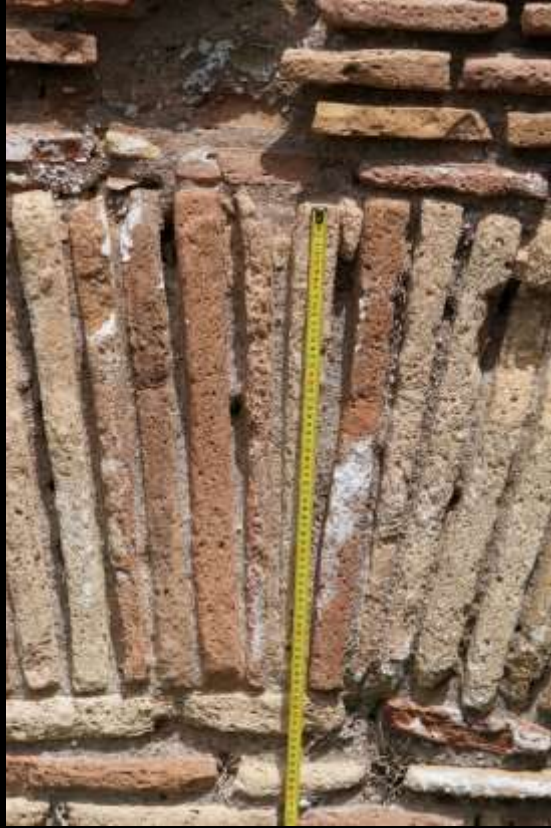
Wölben mit Backstein Der Mörtel kommt ins Spiel
