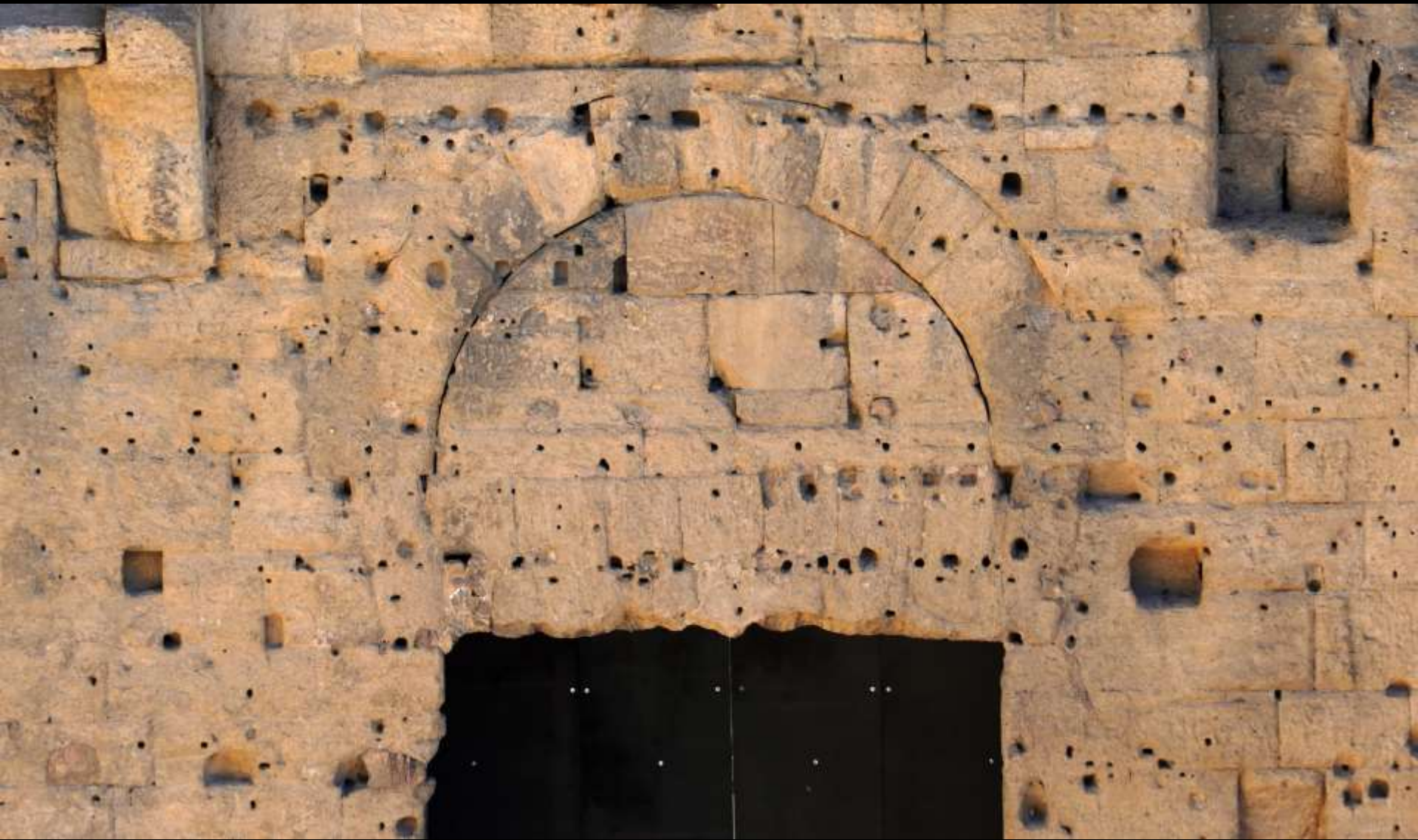
schieitrecter Bogen unter Entlastungsbogen (Orange, Theater, 1. Jh. n. Chr.)
