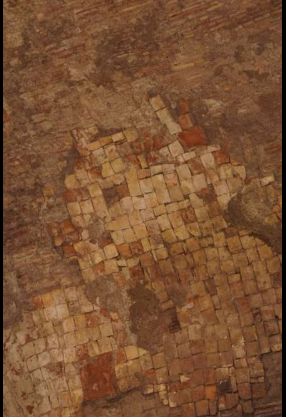
Backsteinplatten an Opus-Caementicium-Gewölben der Caracallathermen in Rom (2./3. Jh. n. Chr.)
