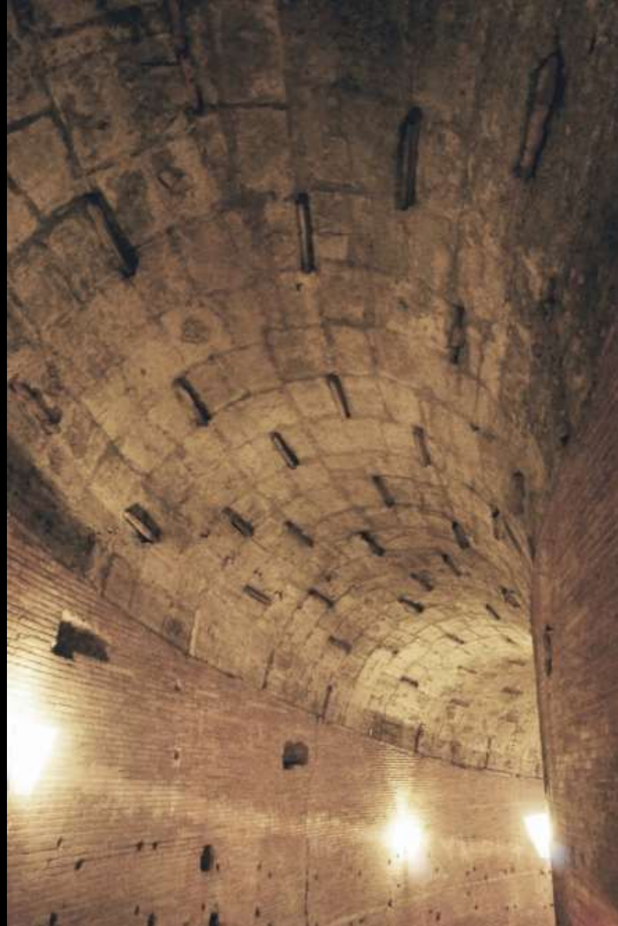
Spuren einer „verlorenen Schalung“ für opus caementicium (Hadriansmausoleum/„Engelsburg“, 2. Jh. n. Chr.)
