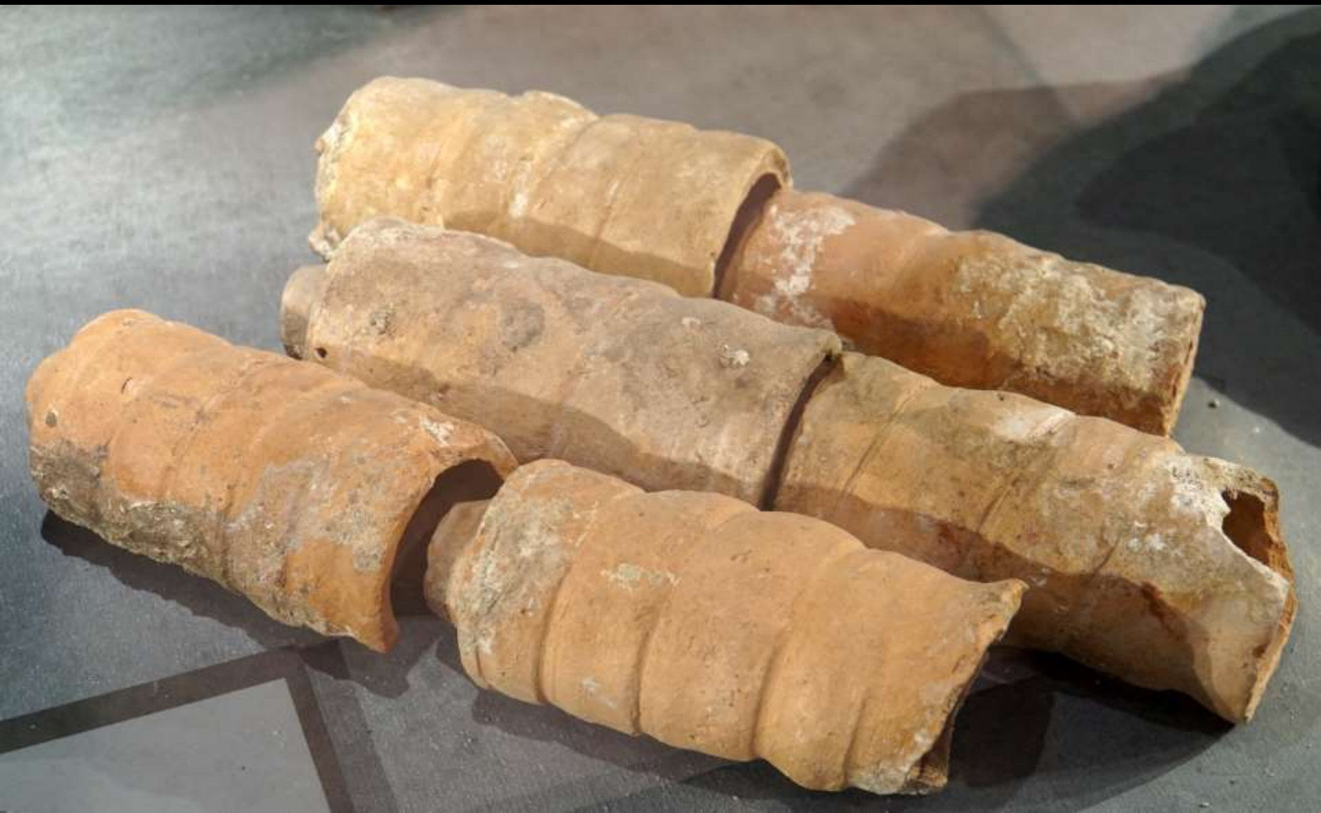
Mailand, frühchristliche Kathedrale Santa Tecla. Tonröhren („tubi fittili“) eines Kuppelgewölbes (4. Jh. n. Chr.)
