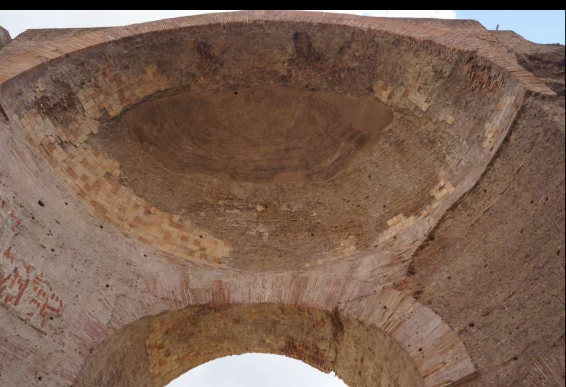
Backsteinplatten an Opus-Caementicium-Gewölben der Caracallathermen in Rom (2./3. Jh. n. Chr.)
