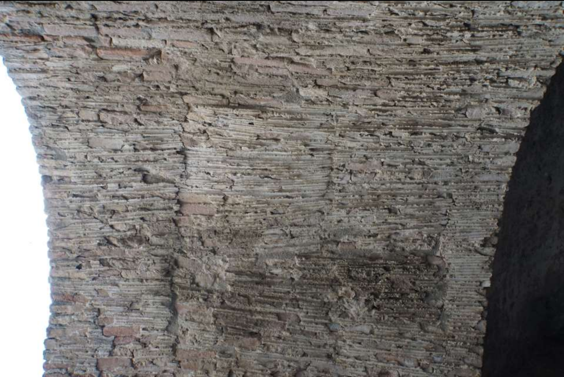
Taormina, römisches Theater. Abdrücke von Schalung aus „canna greca“ (Schilfrohr)
