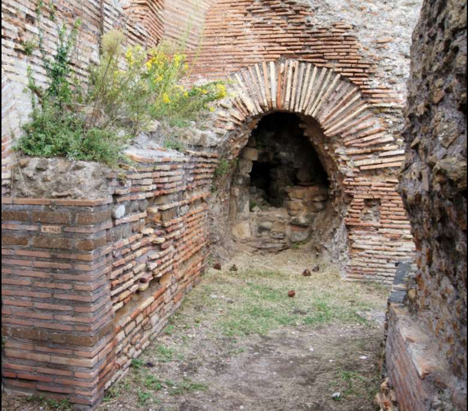
Bogen aus Backsteinplatten mit keilförmigen Mörtelfugen (Ostia, Forumsthermen, Praefurnium)
