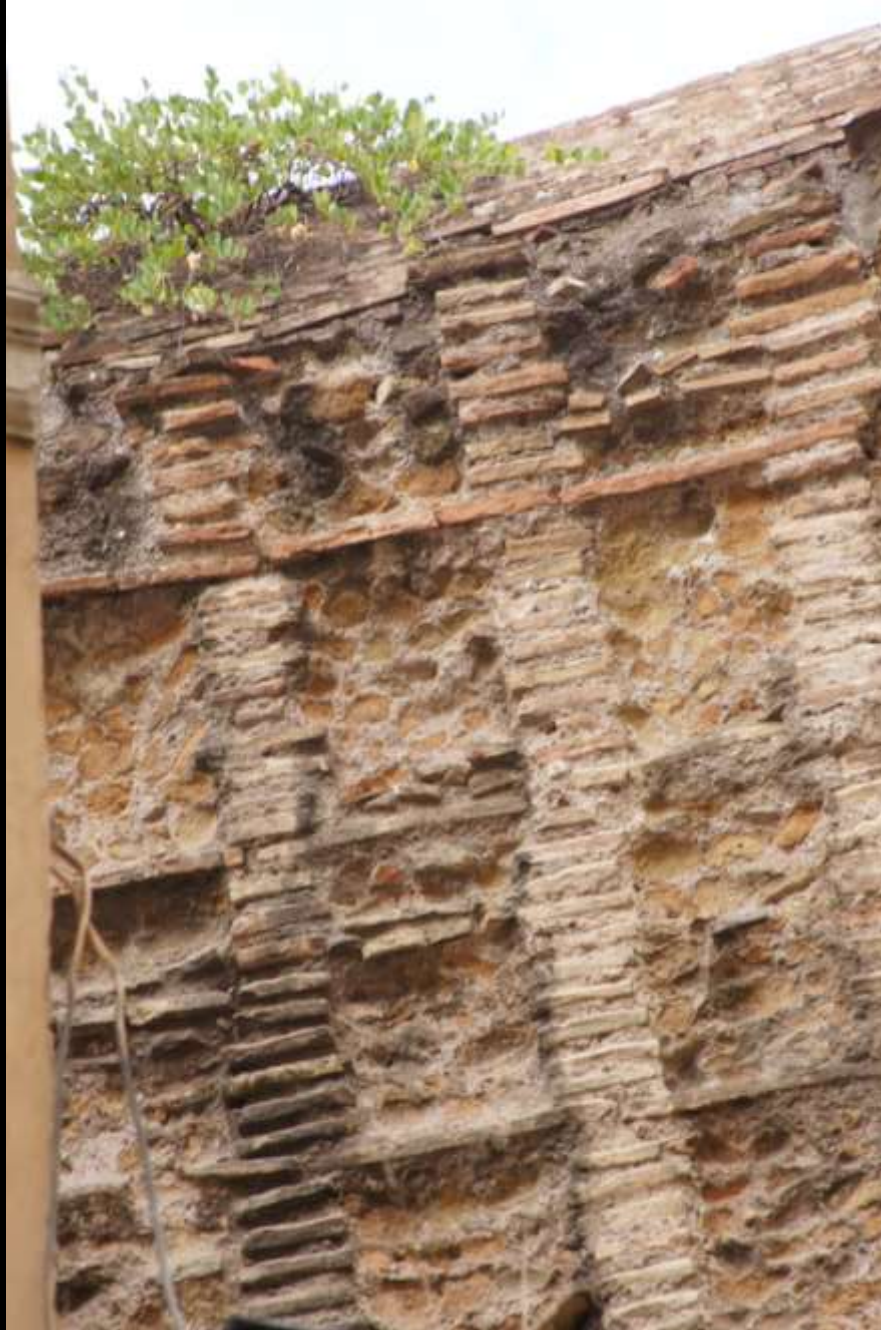
Rom, Agrippathermen, sogenannter „Arco della Ciambella“. Kuppel aus Opus caementicium mit Backsteinrippen (4. Jh. n. Chr.)
