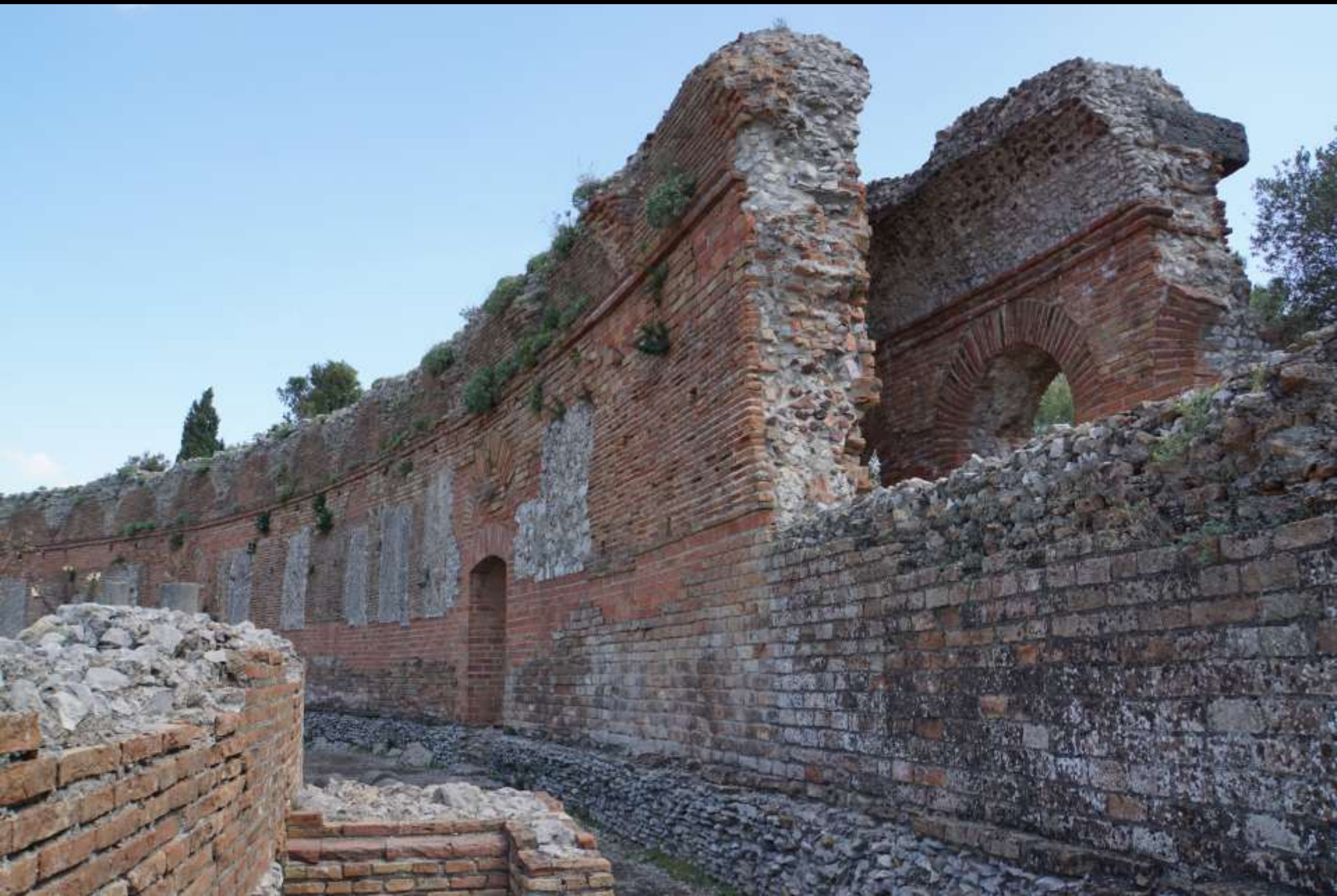
Opus caementicium mit unterschiedlichen Gesteinszuschlägen im Gewölbe (Tuff) und Widerlager (Kalk) (Taormina, römisches Theater, Summa Cavea)
