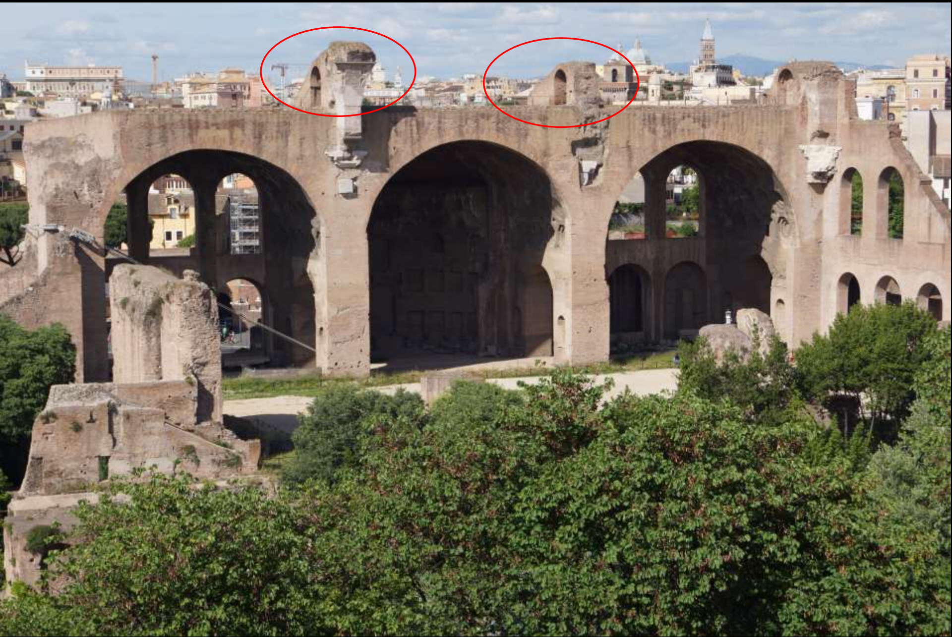
Rom, Maxentiusbasilika, Anf. 4. Jh. n. Chr. Strebemauern des Kreuzgewölbes.
