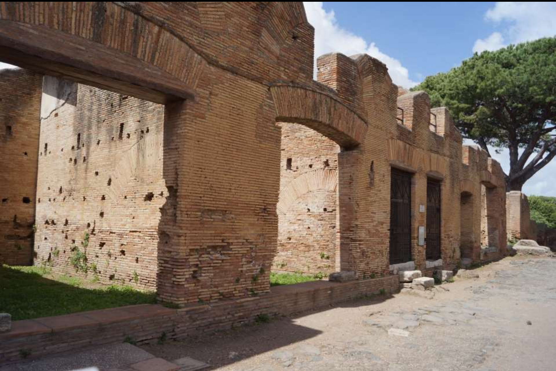
Ostia, gewölbte Fenster- und Türstürze aus bipedalis-Backsteinplatten (2. Jh. n. Chr.)
