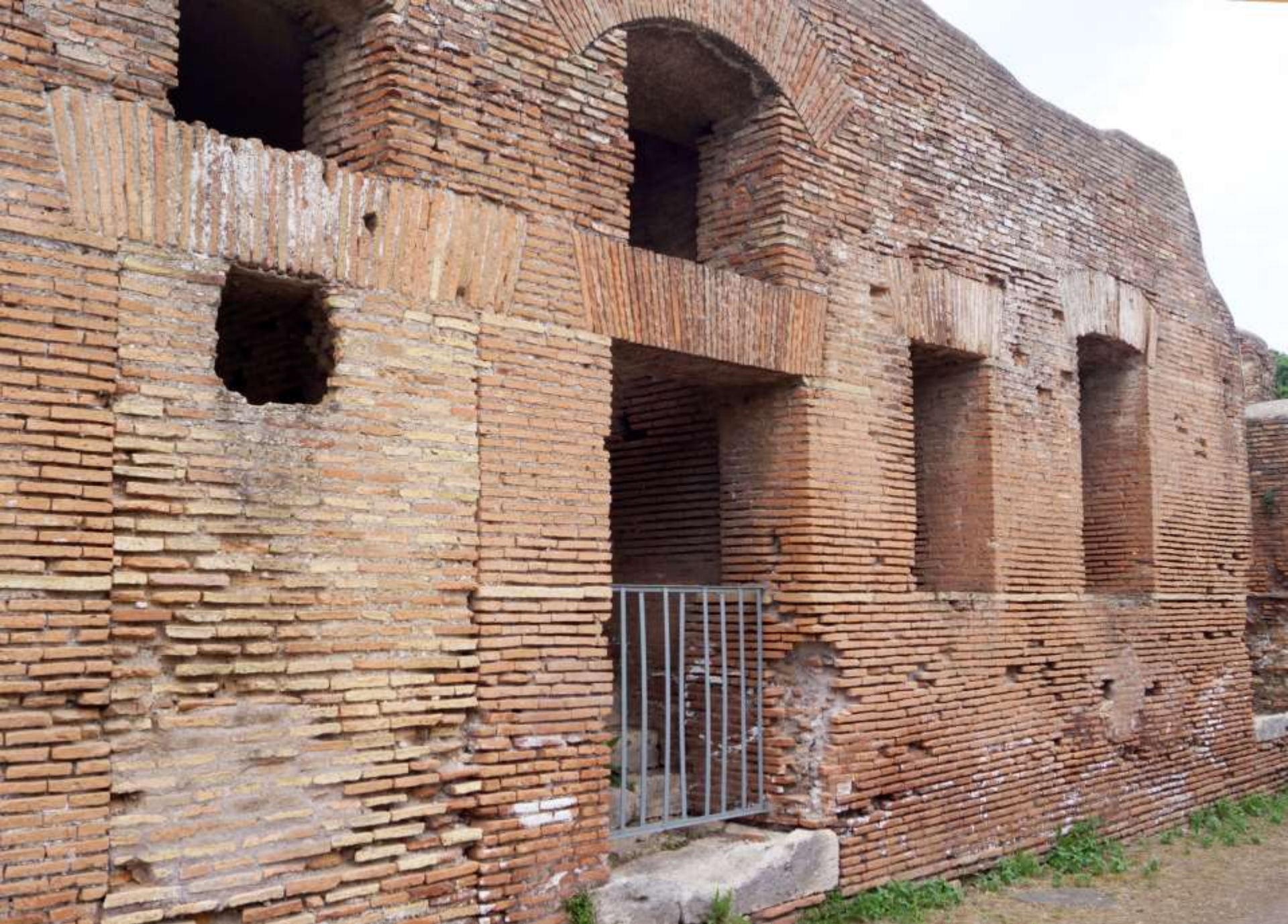
Ostia, gewölbte Fenster- und Türstürze aus bipedalis-Backsteinplatten (2. Jh. n. Chr.)
