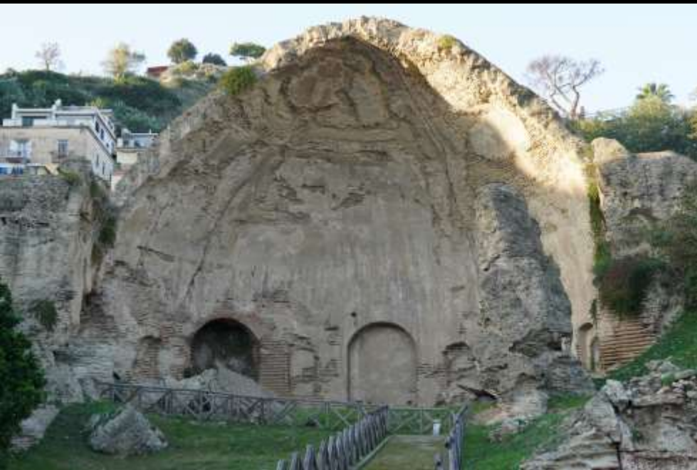
Baiae, sog. Tempel der Diana (Badeanlage), Kuppel aus Tuffsteinmauerwerk in horizontalen Schichten (3. Jh.)
