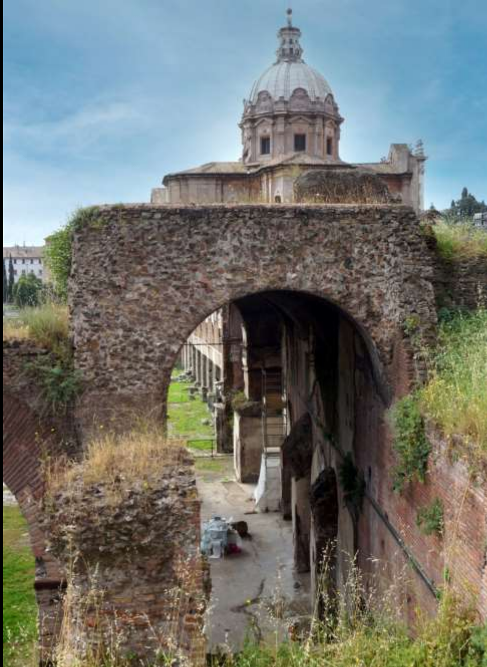
Gewölbe aus regellosem opus caementicium (Rom, Basilica Argiletica, um 100 n. Chr.)
