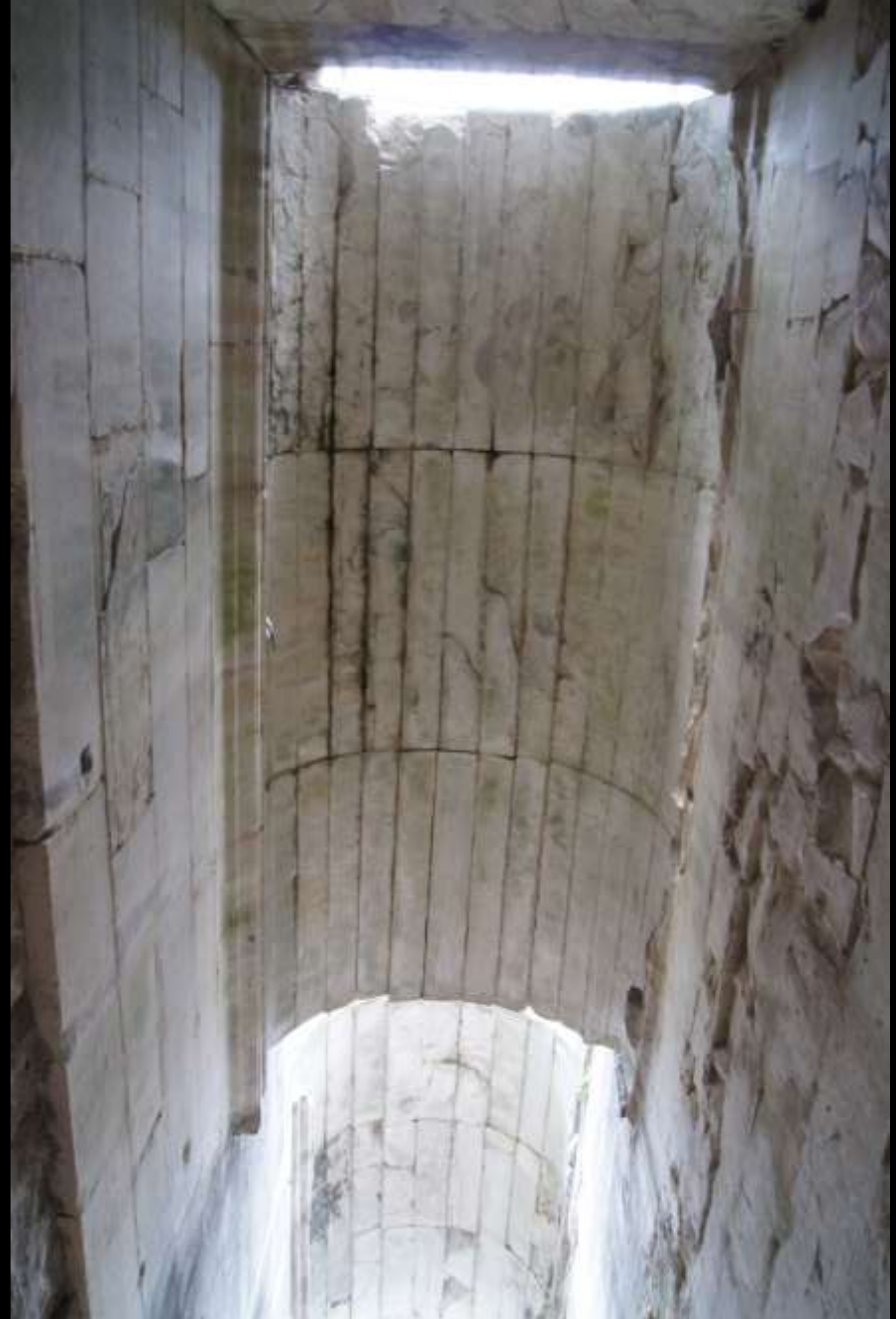
Tonnengewölbe aus nebeneinandergestellten Werksteinbögen. (sog. Diana-Tempel in Nîmes)
