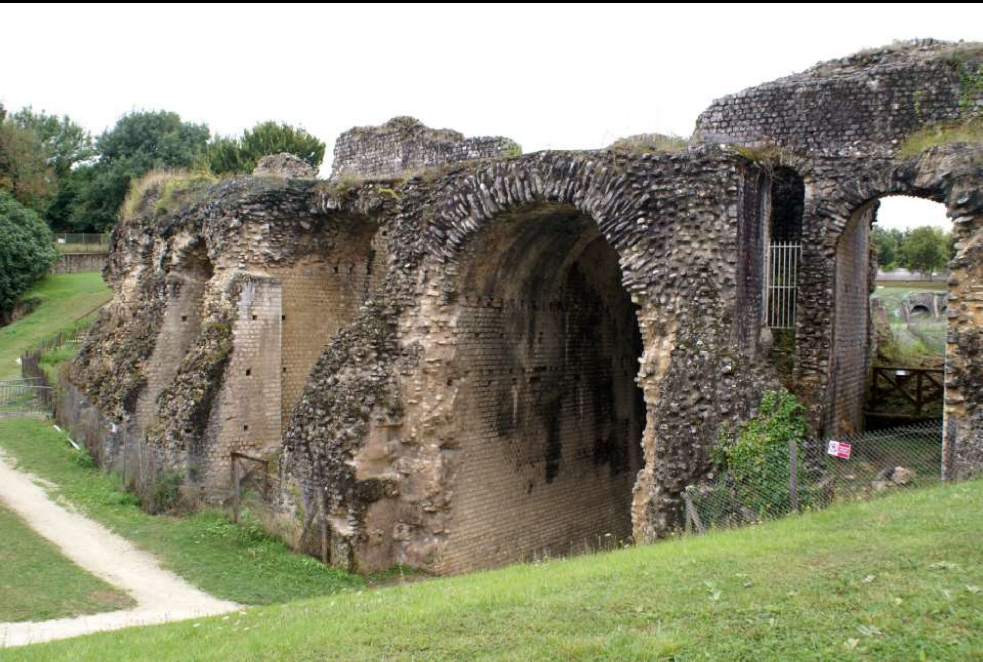
Gewölbe aus radial gestellten Bruchsteinplatten (Saintes, Amphitheater, 1. Jh. n. Chr.)
