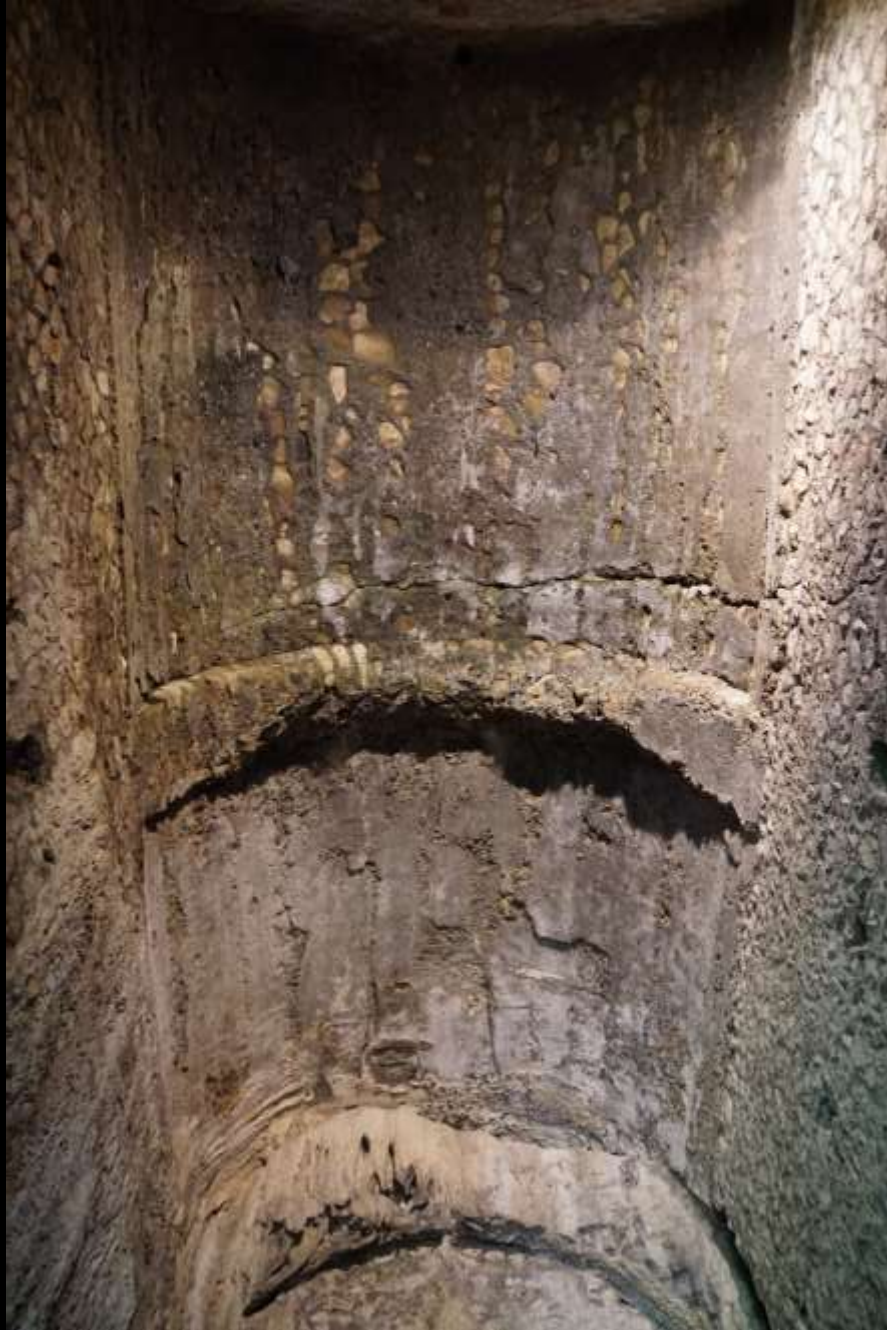
Auf Schalung hergestellte Tonnengewölbe aus Bruchstein (opus caementicium) (Tivoli, Villa des Manlius Volpiscus, 1. Jh. n. Chr.)
