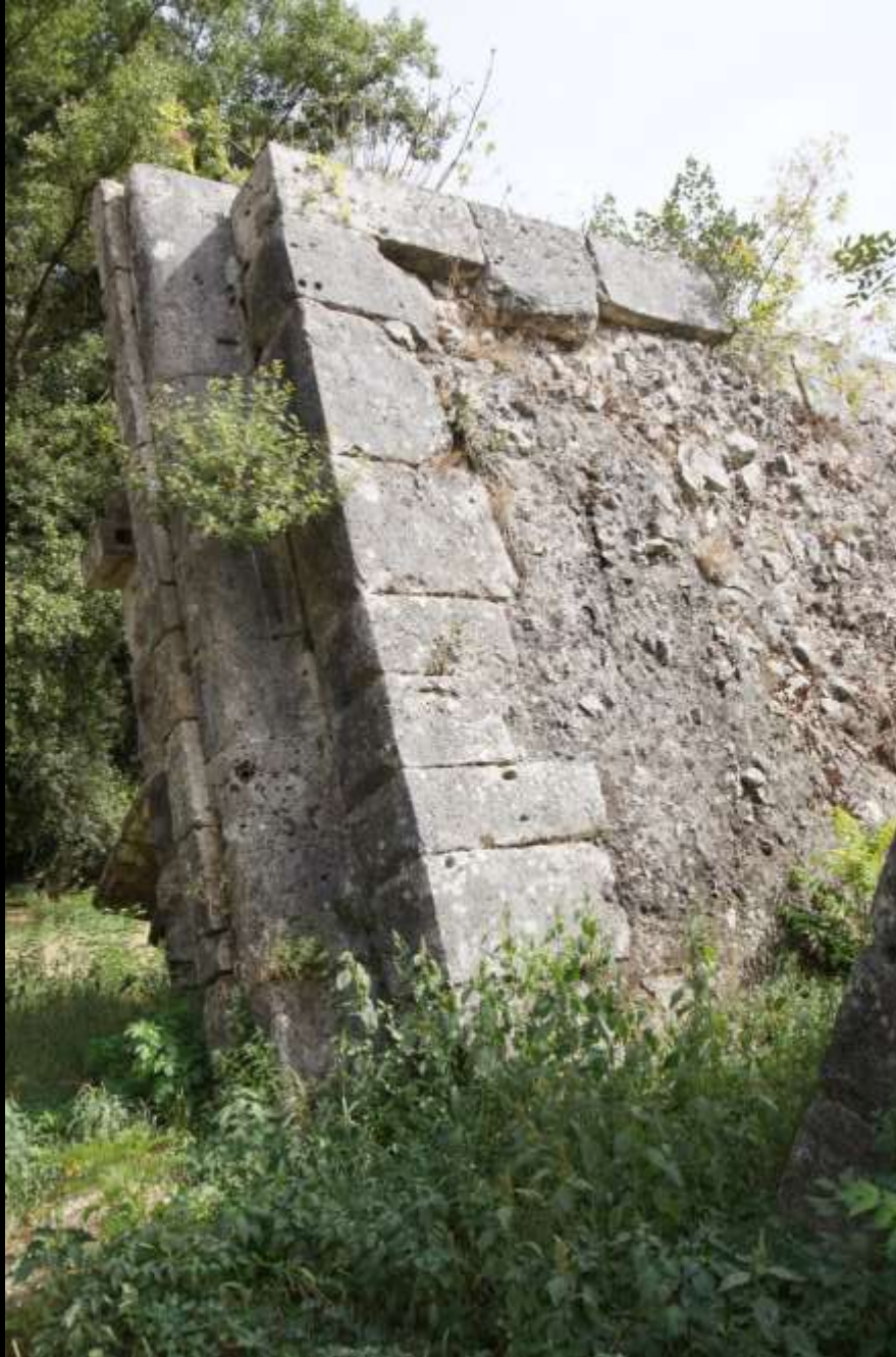
Pfeiler aus Werkstein, innen mit opus caementicium gefüllt (Narni, Ponte di Augusto, 1. Jh. v. Chr.)
