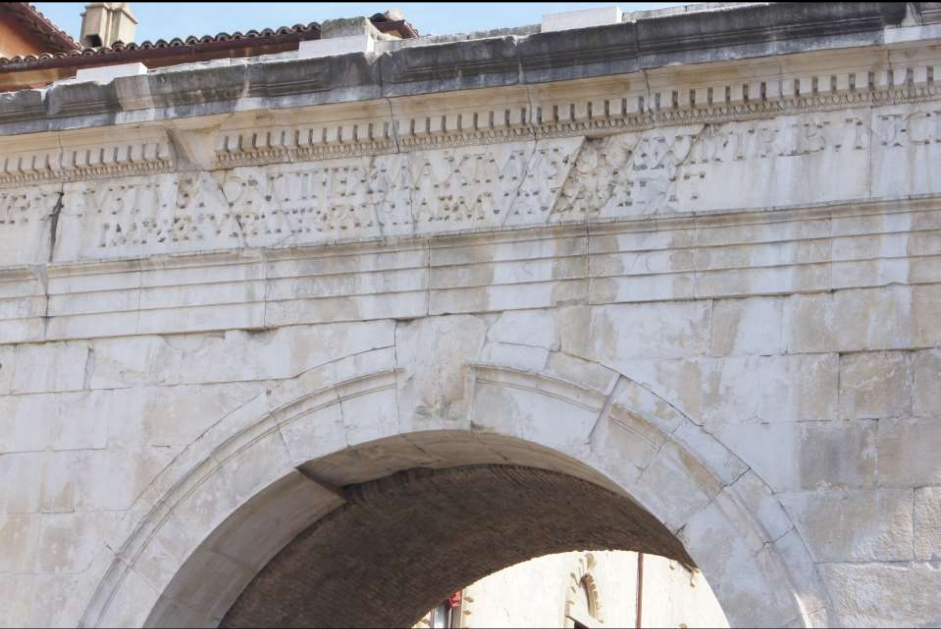
Stadttor aus Werkstein. Steinschnitt des Bogens mit Extrados. (Fano)
