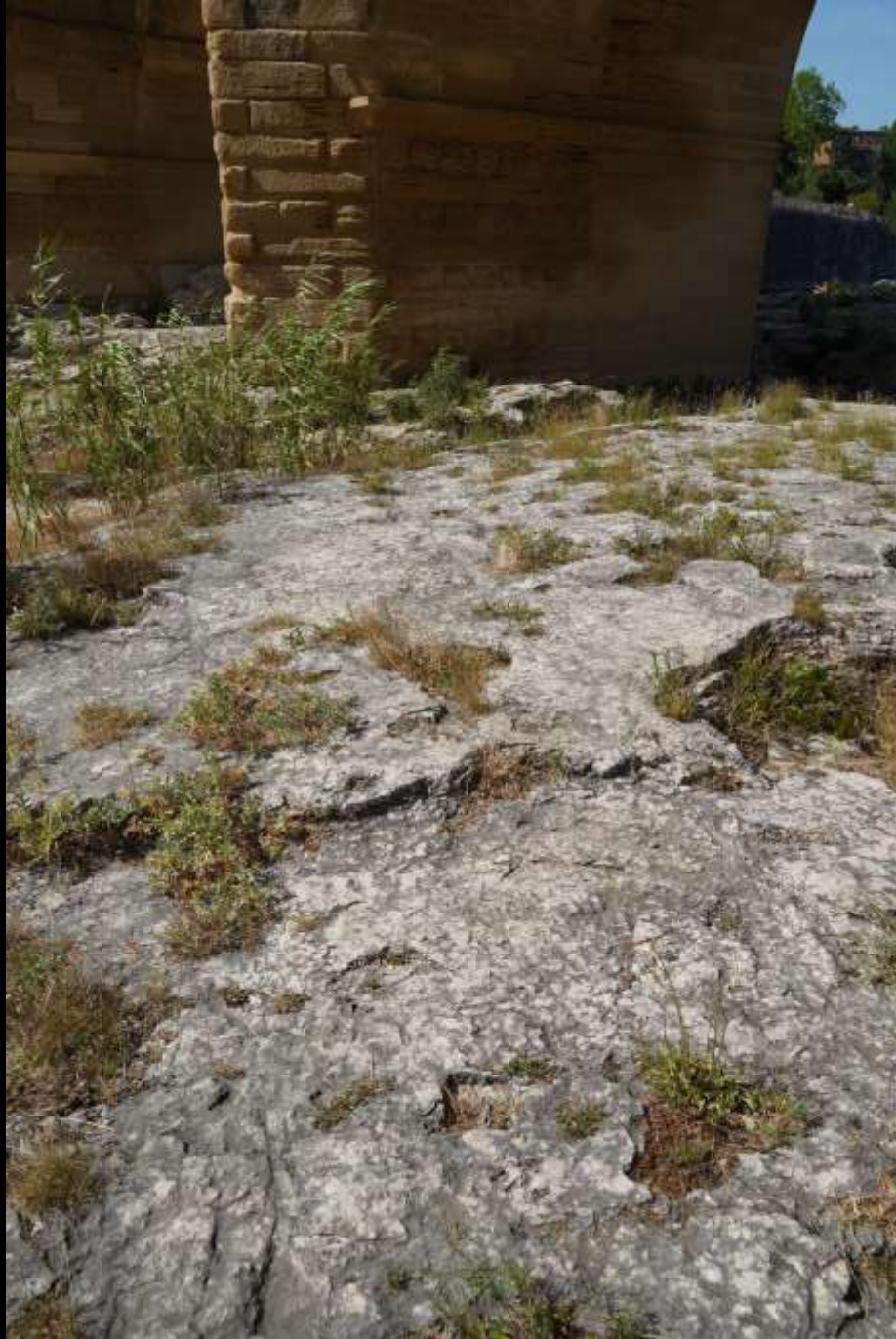
Befunde der Baustelleneinrichtung am Pont-du-Gard
