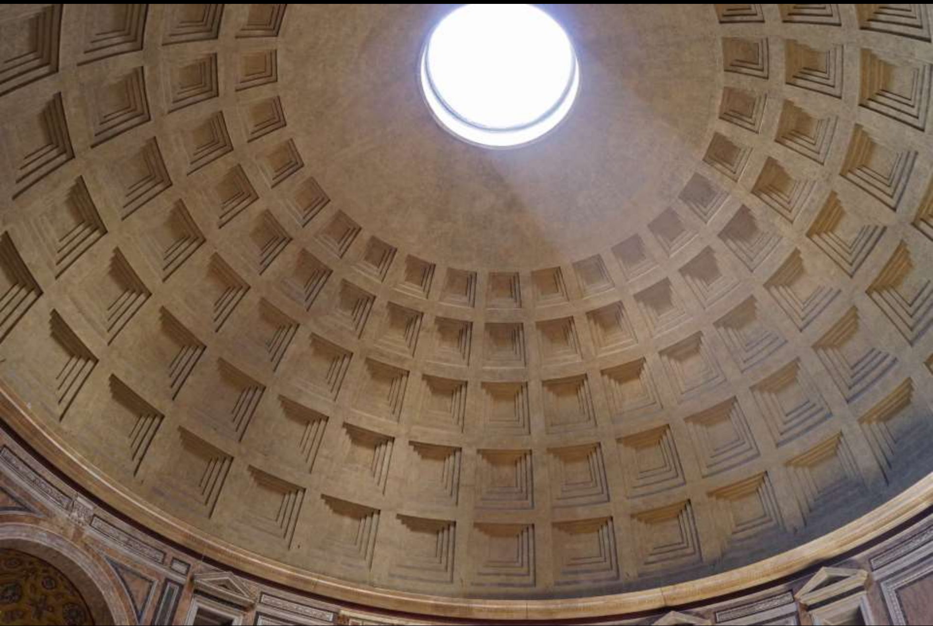
Rom, Pantheon. Kuppel mit Kassetten
