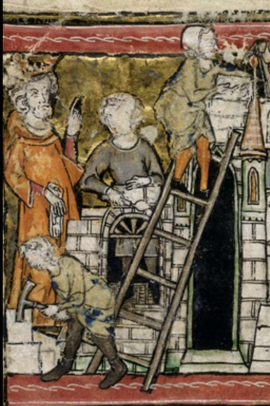
„Gewölbescheibe“ zum Bau von Wandöffnungen (British Library London, Royal Manuscripts 14 E III, fol. 85 v., Ausschnitt; 15. Jh.)
