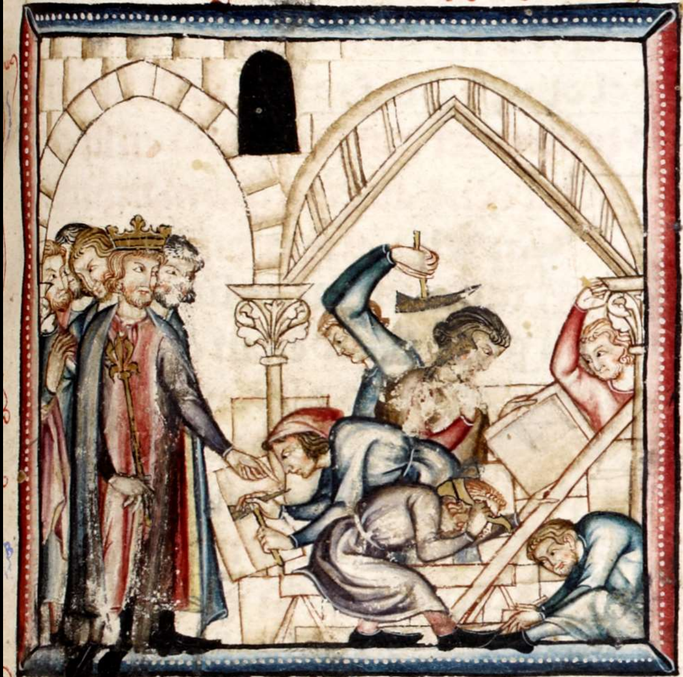
Leichter, freigespannter Lehrbogen (Rechtskodex Alfons' X. von Kastilien; British Library Ms. Add. 20787, fol. 75 r., um 1290)
