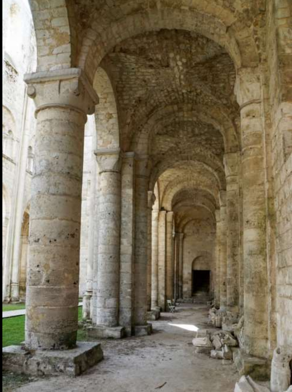
Jumièges (Normandie, 1040–67), Seitenschiffe mit Kreuzgratgewölben.
