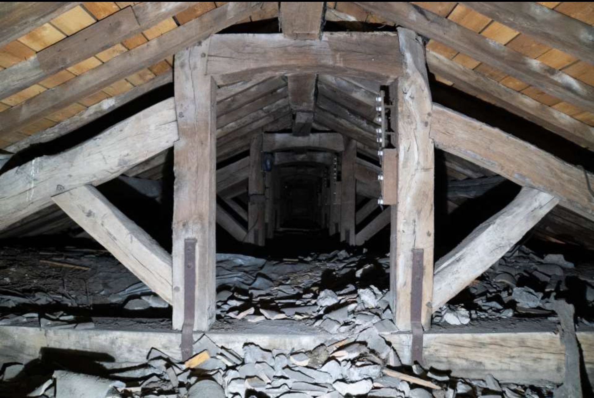
Tournus, Saint-Philibert. Langhaus, Mittelschiff, Gewölbe von oben.
