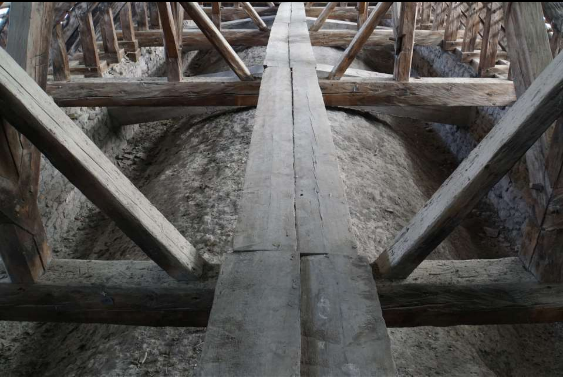
Abteikirche Payerne VD, Langhausgewölbe von oben
