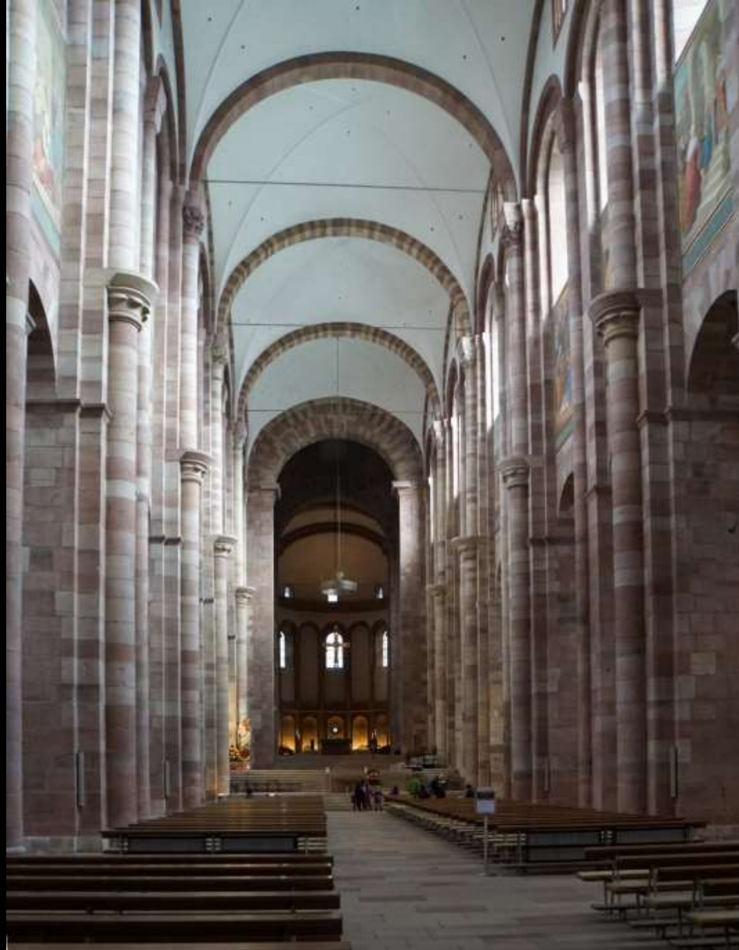
Speyer, Dom, Bau II. Ende 11. Jh. Spannweite 14 m, lichte Höhe 32.5 m.
