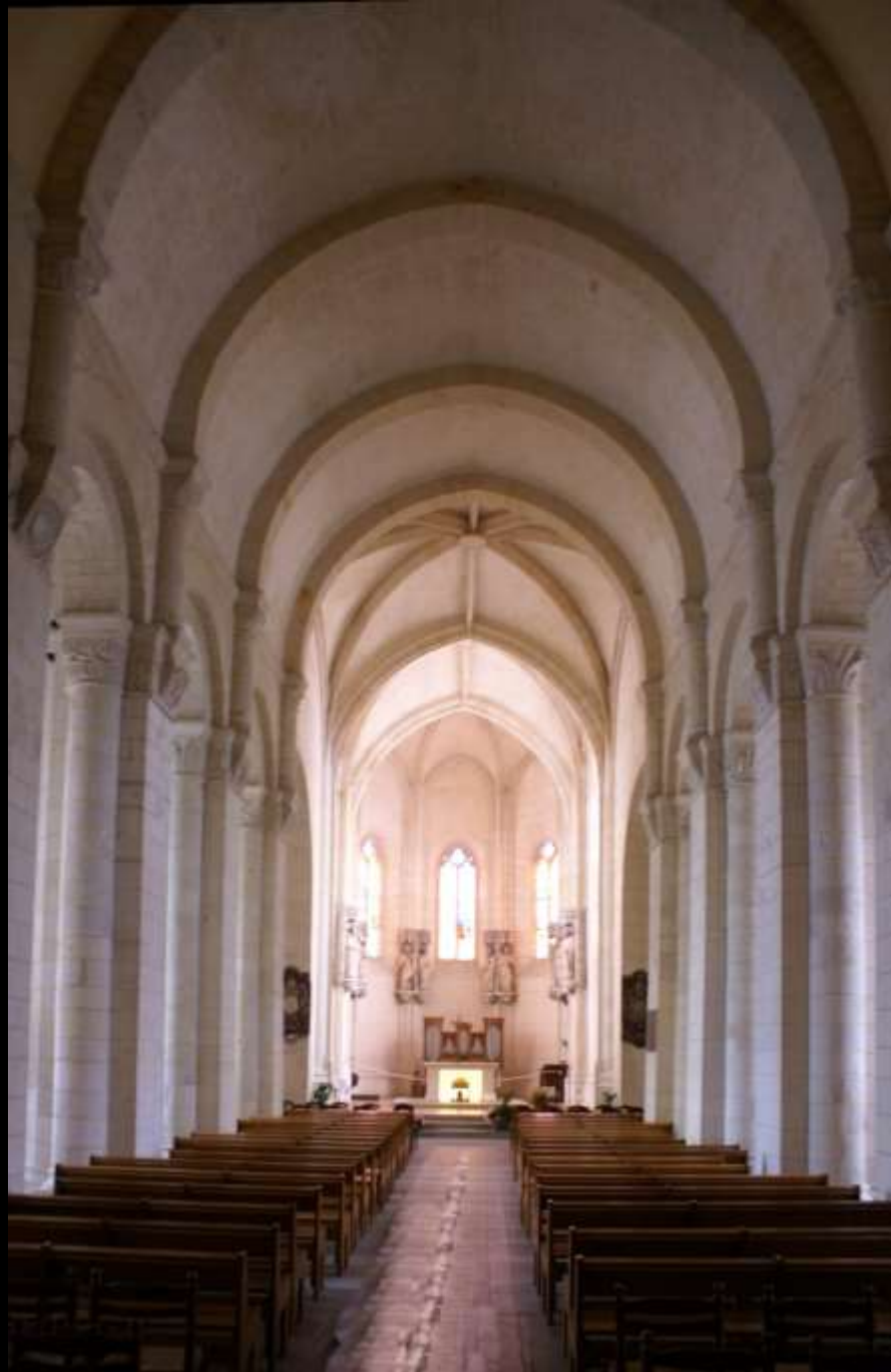
Saintes (Charente), St-Eutrope. Wölbung mit Spitztonne im Mittelschiff, Halbtonne im Seitenschiff (1. H. 12. Jh.)
