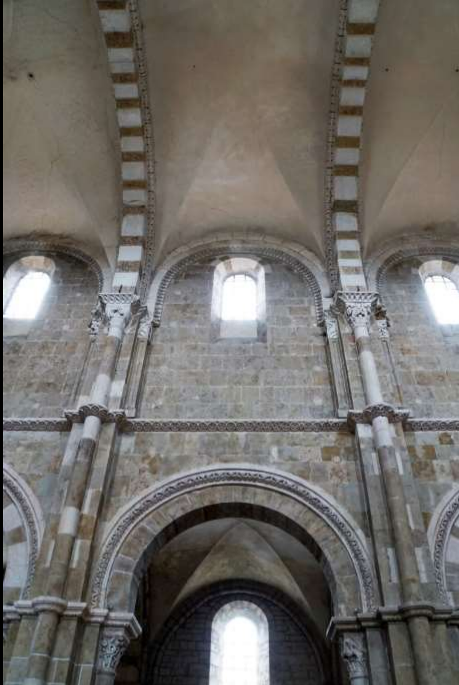
Vézelay, Tonne mit Stichkappen in Annäherung an Kreuzgewölbe
