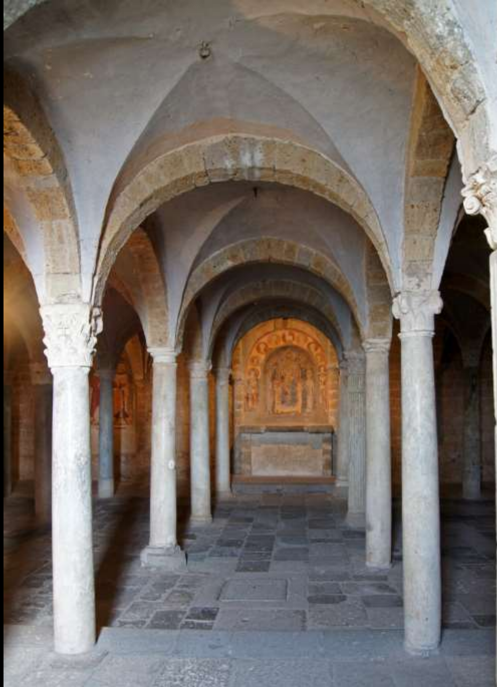
Kreuzgewölbe mit überhöhten Schildbögen (Krypta San Pietro, Tuscania, 12. Jh.)
