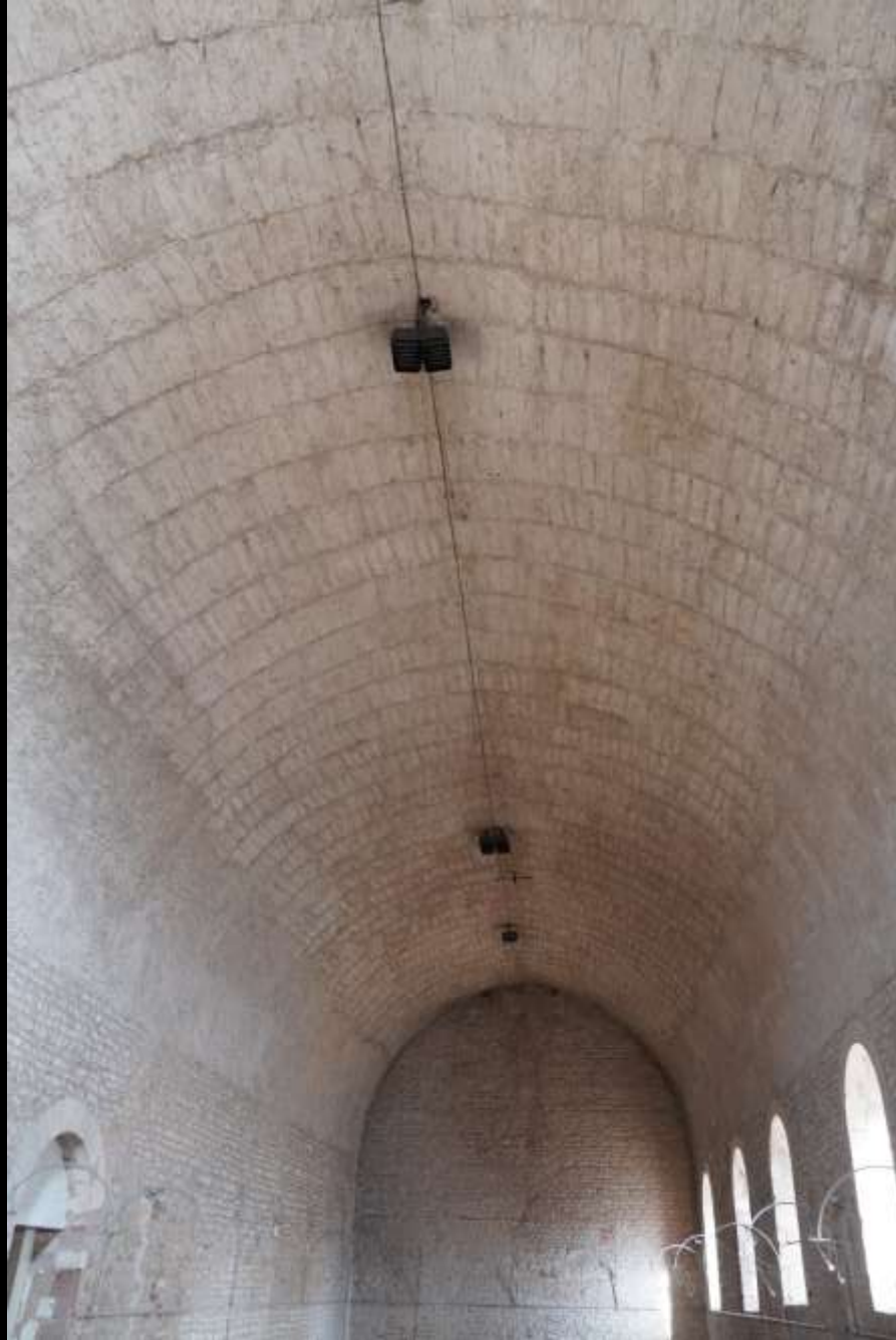
Tonnengewölbe aus Bruchsteinmauerwerk: Schaldbrettabdrücke (Tournus, Saint-Philibert, Refektorium, Ende 11. Jh.)
