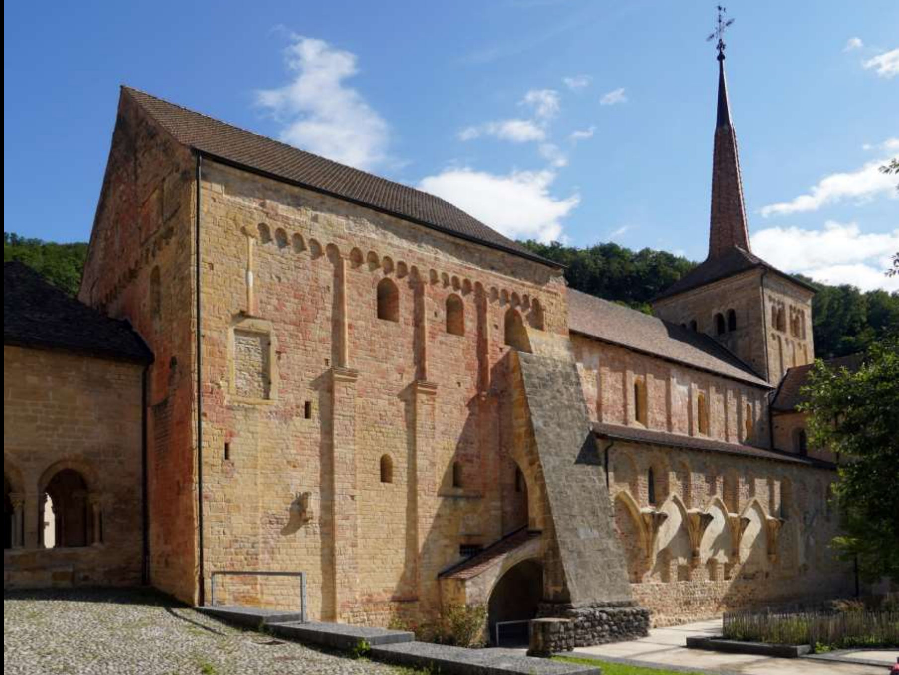
Romainmôtier, Abteikirche. Westbau (um 1100) und Kirche (1. Drittel 11. Jh.) von Südwest.
