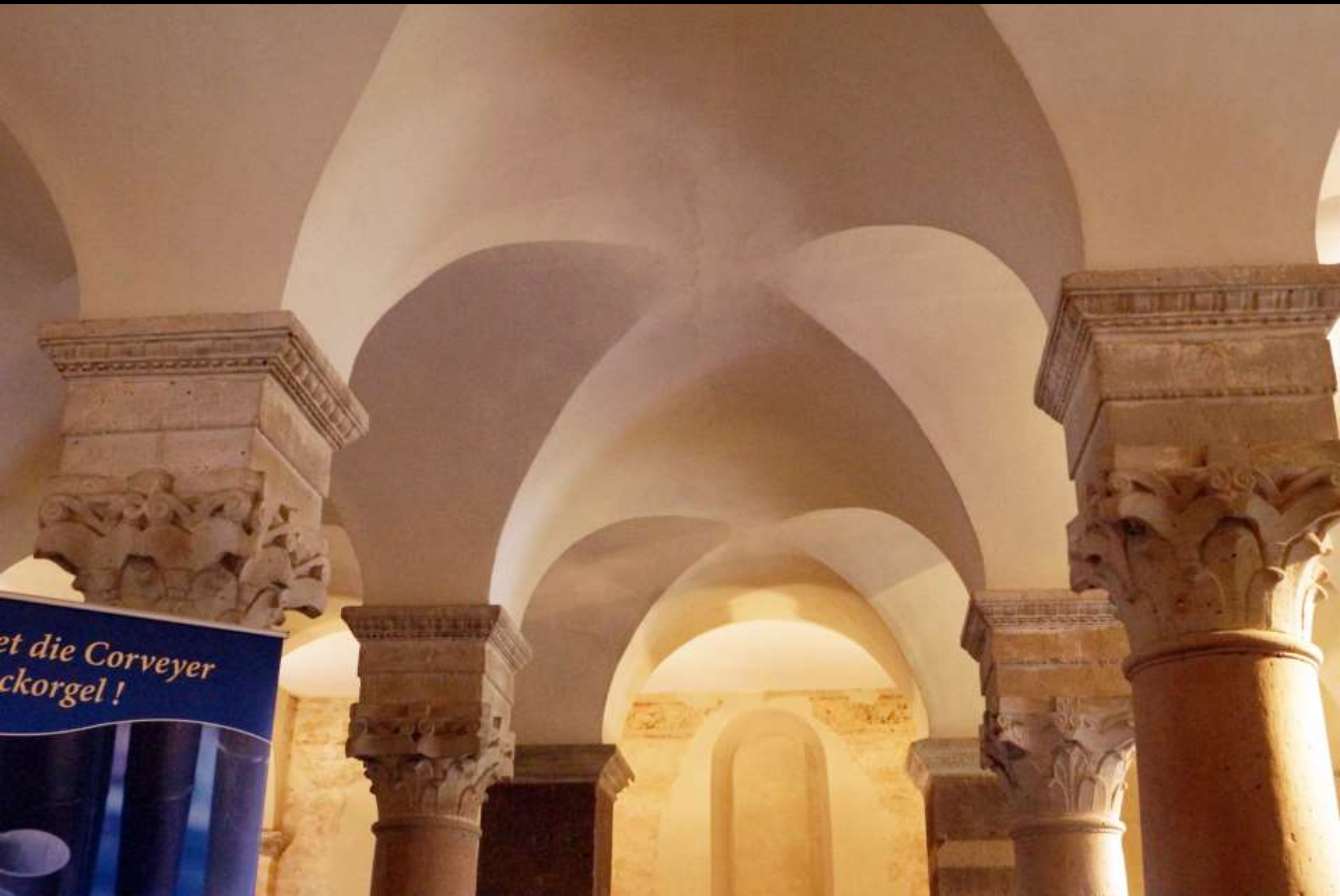
Corvey/Weser, Abteikirche, Westwerk. Gewölbe des untersten Stockwerks.
