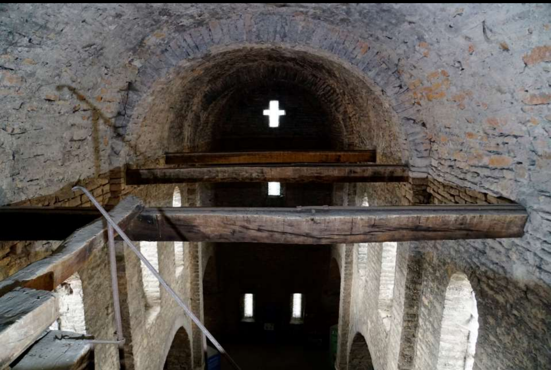
Tournus, Saint-Philibert. Vorkirche, Obergeschoss. Tonnengewölbe und Zuganker im Mittelschiff. (Foto: Louis Vandeabeele, IDB)
