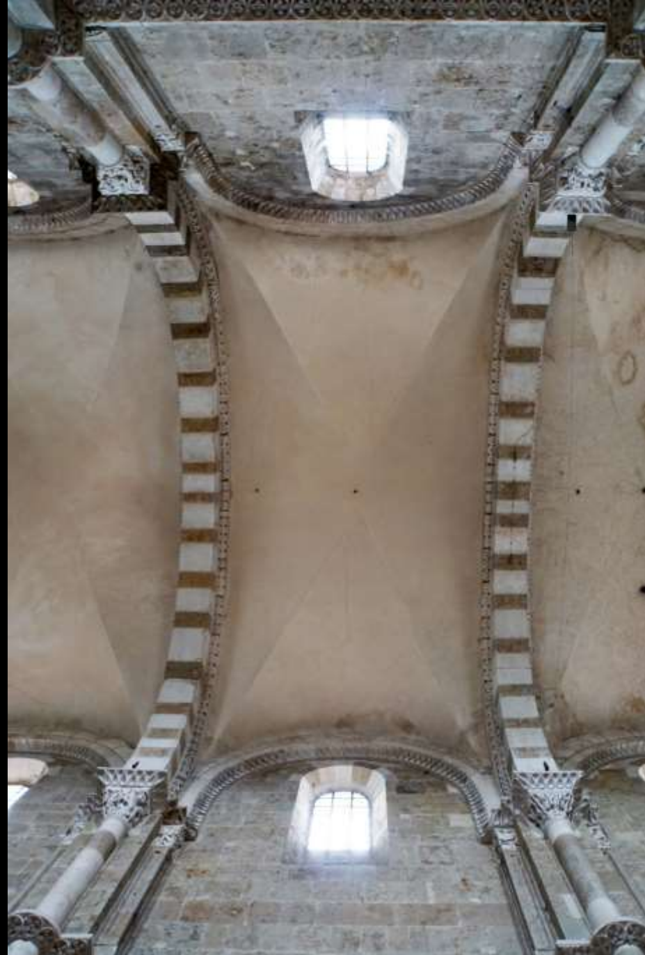
Vézelay, Tonne mit Stichkappen in Annäherung an Kreuzgewölbe
