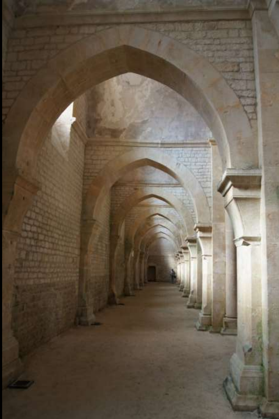
Quertonnen im Seitenschiff (Abteikirche Fontenay/Burgund, 1. H. 12. Jh.)
