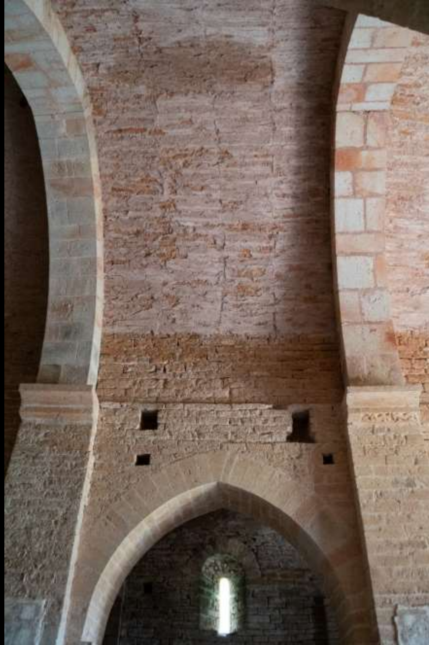
Tonnengewölbe aus Bruchsteinmauerwerk: Schalbrettabdrücke (Brancion (Burgund), Kirche, Anf. 12. Jh.)
