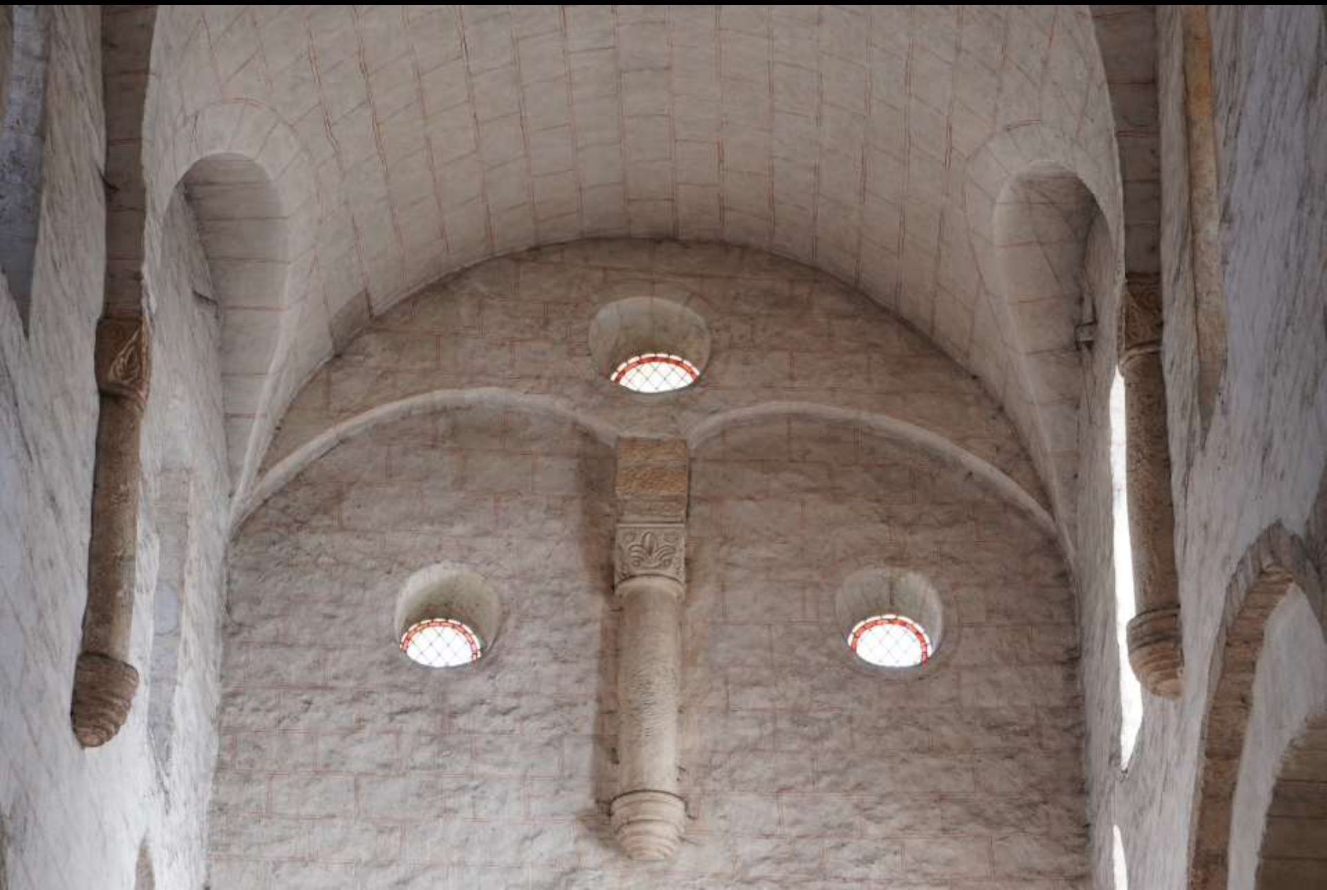
Romainmôtier, Abteikirche. Querschiff mit Tonnengewölbe (1. Drittel 11. Jh.)
