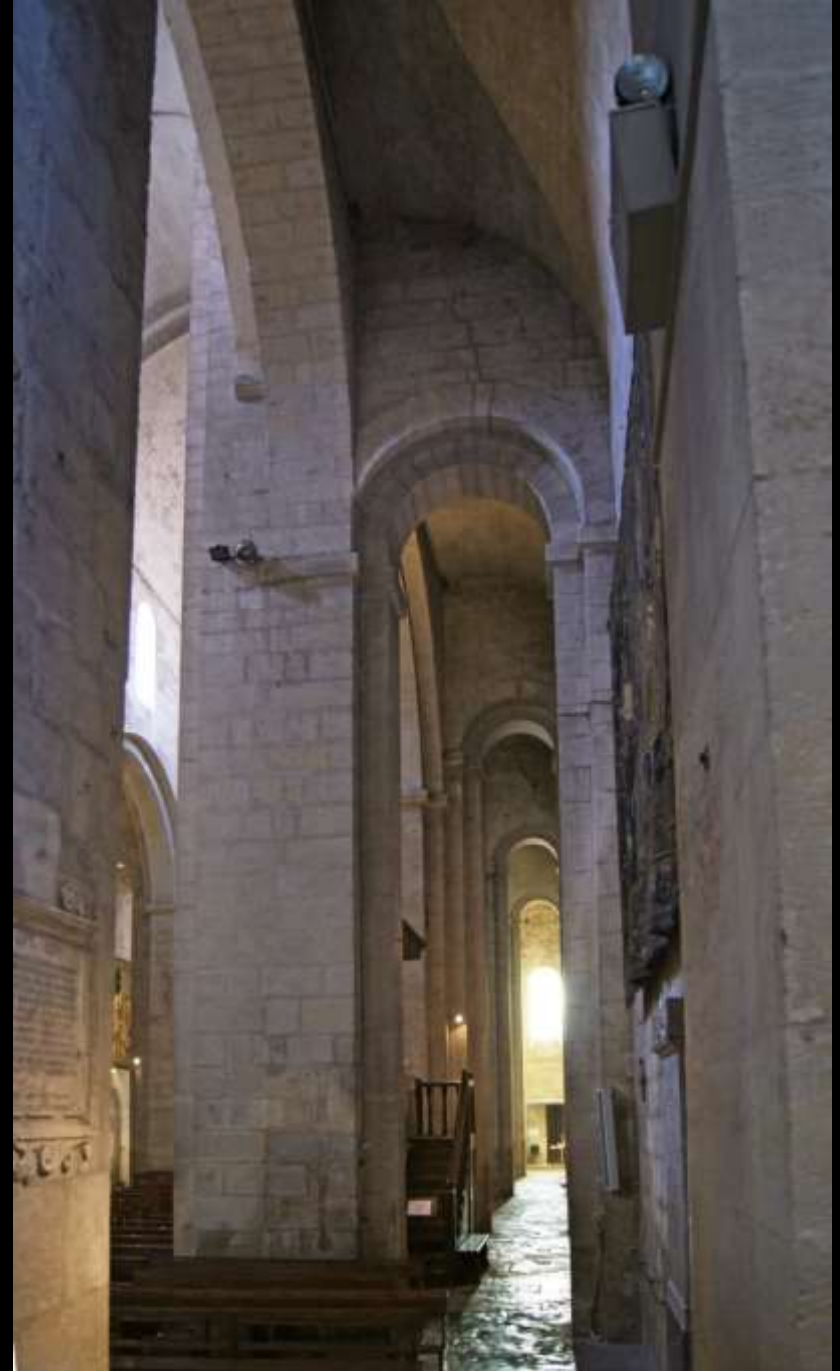
Arles (Provence), Saint-Trophime (12. Jh.). Spitztonne in Werkstein und Viertelkreistonne im Seitenschiff.
