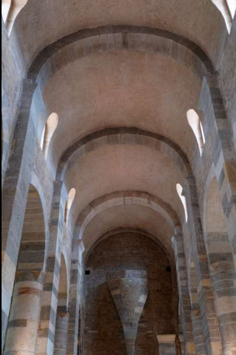
Payerne, Abteikirche, spätes 11. Jh. Langhausgewölbe
