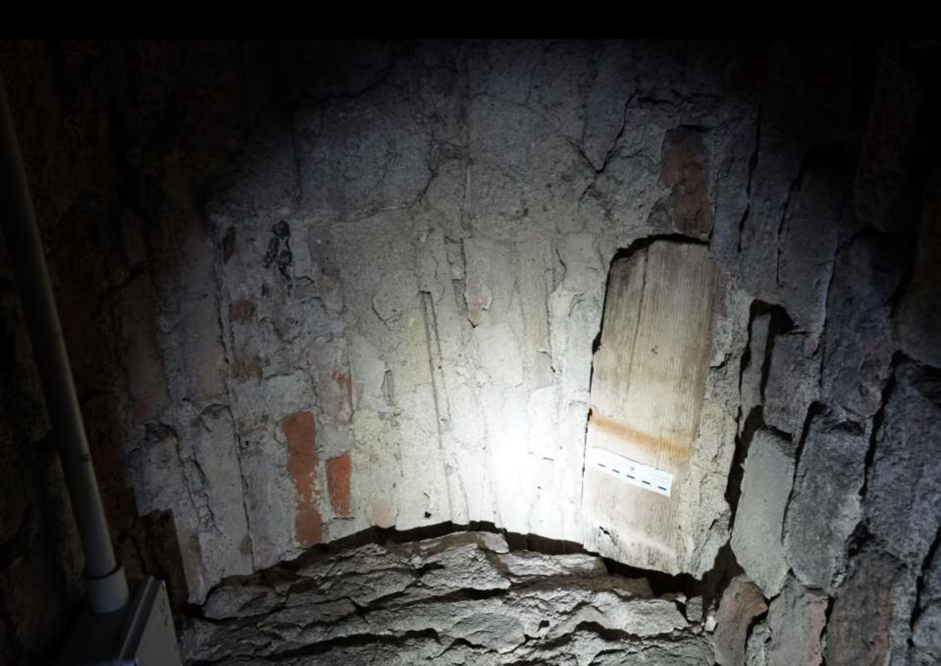
Backsteingewölbe, Schalbrettabrücke und Reste von Schalbrettern (Padua, Sant'Antonio, 13. Jh.)
