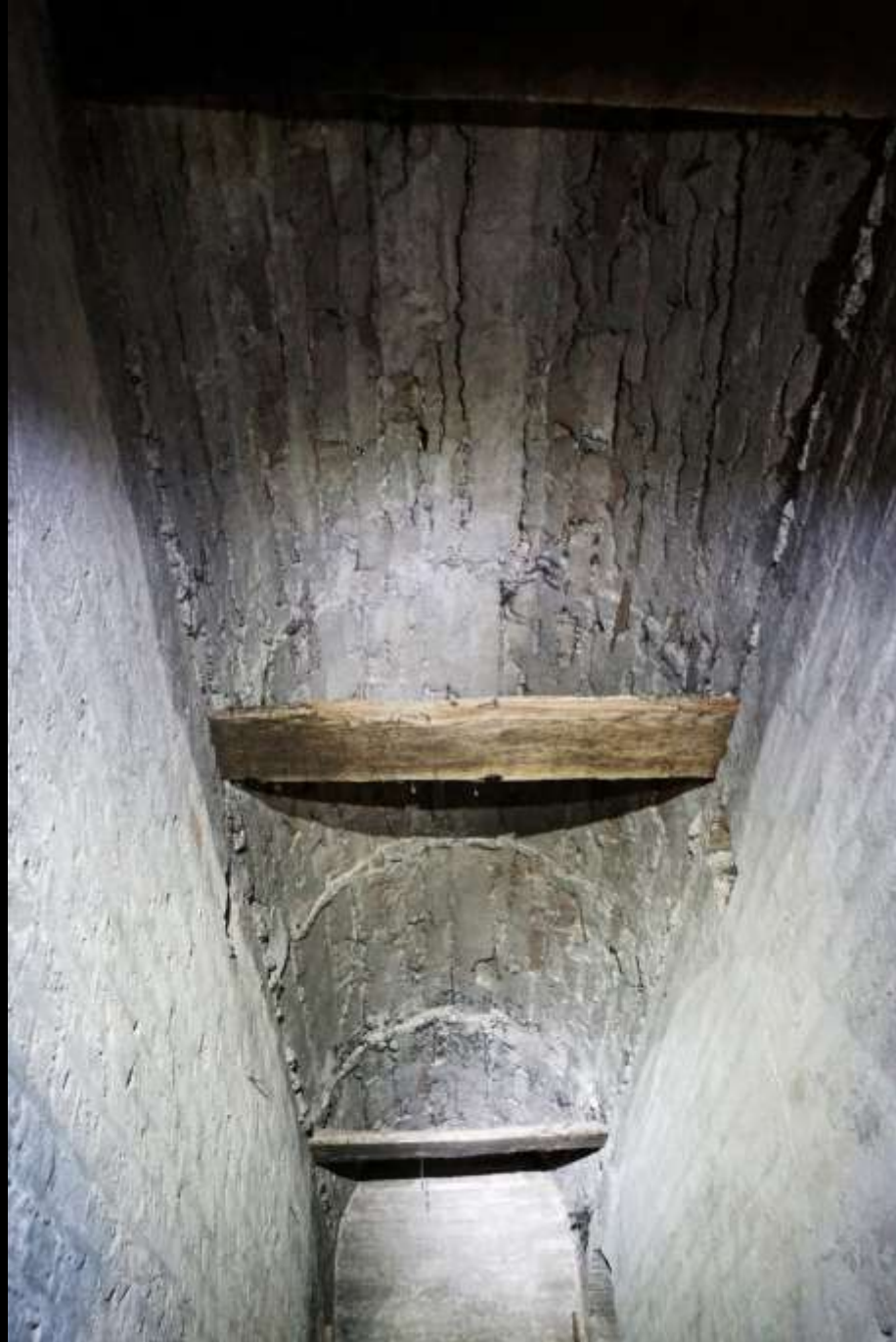
Schalbrettabdrücke und Reste von leichten Lehrbögen (Padua, Sant'Antonio, 13. Jh.)
