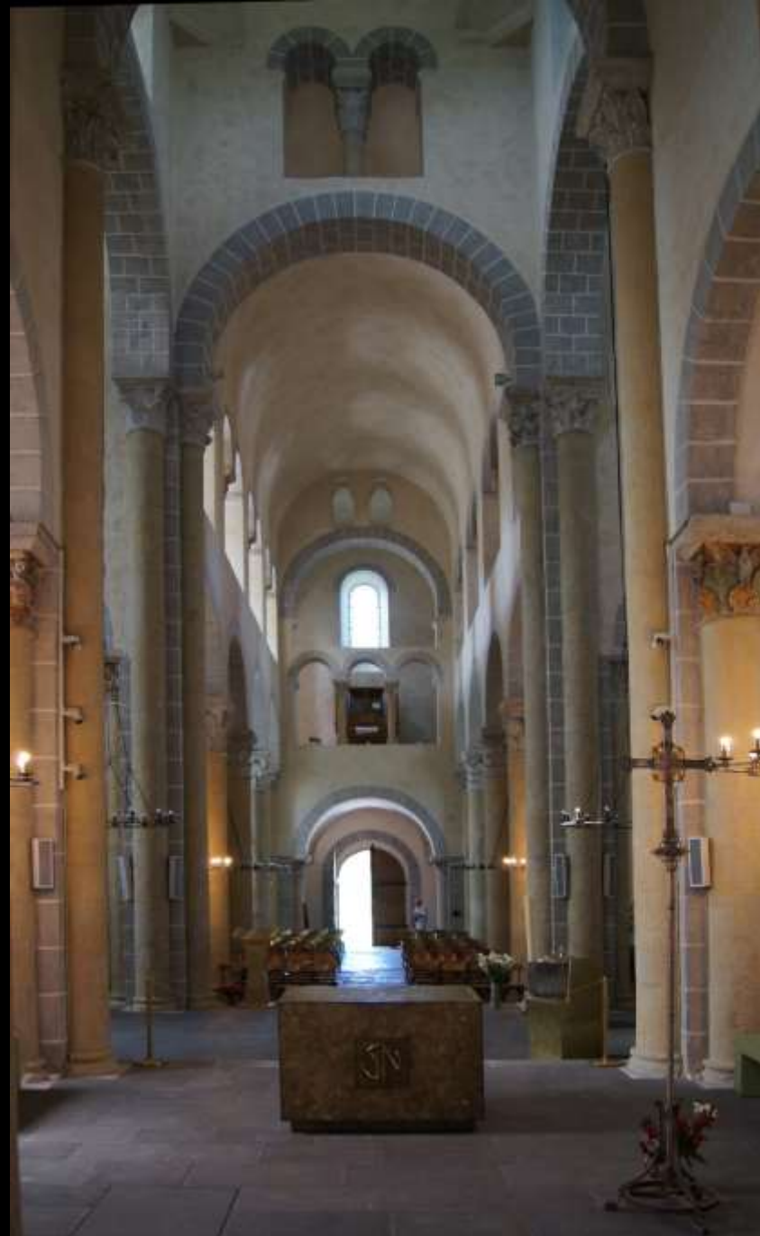
Saint-Nectaire (Auvergne; 12. Jh.). Traditionelle Wölbung mit gurtlosen Halbkreistonnen.
