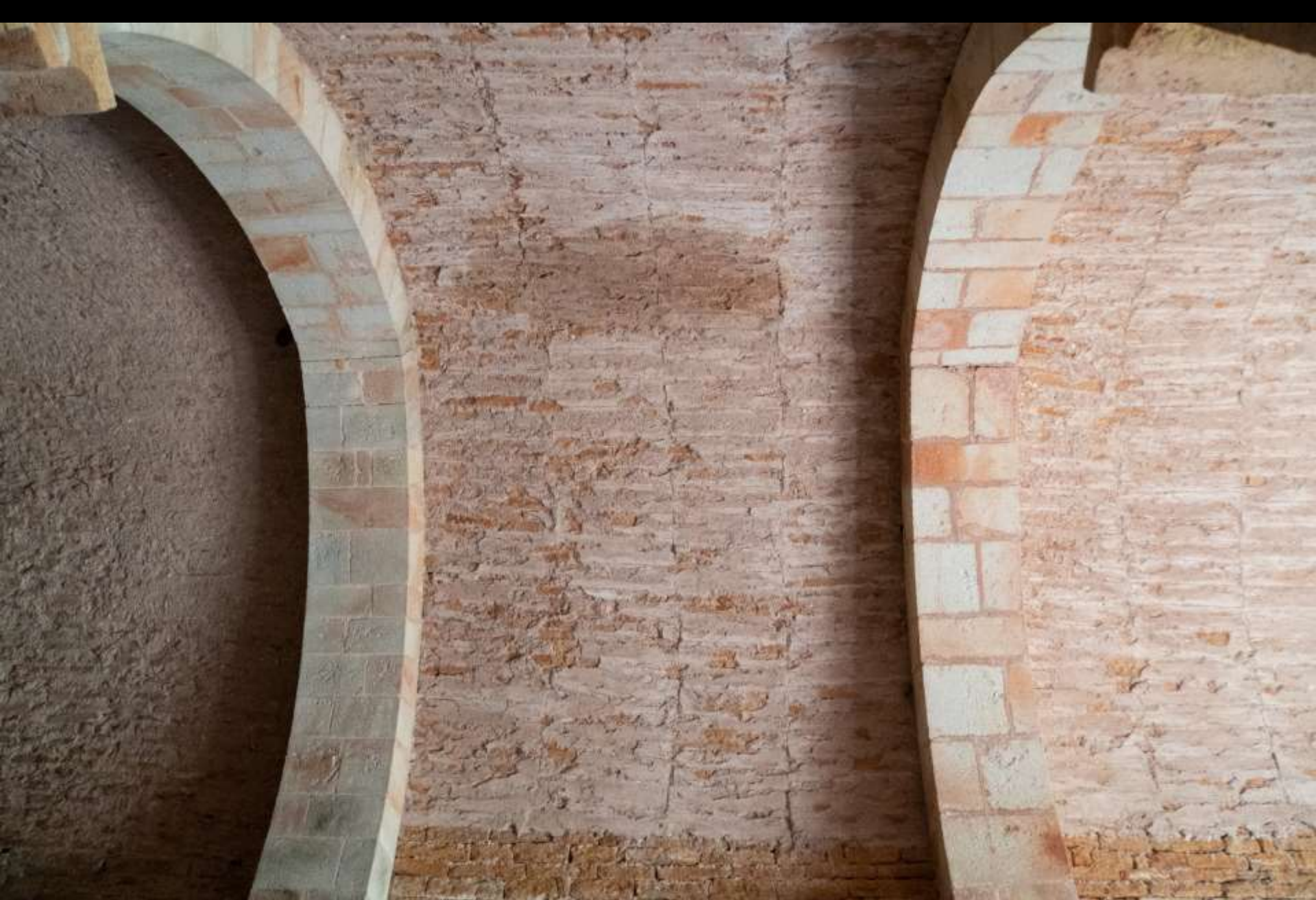
Tonnengewölbe aus Bruchsteinmauerwerk: Schalbrettabdrücke (Brancion (Burgund), Kirche, Anf. 12. Jh.)
