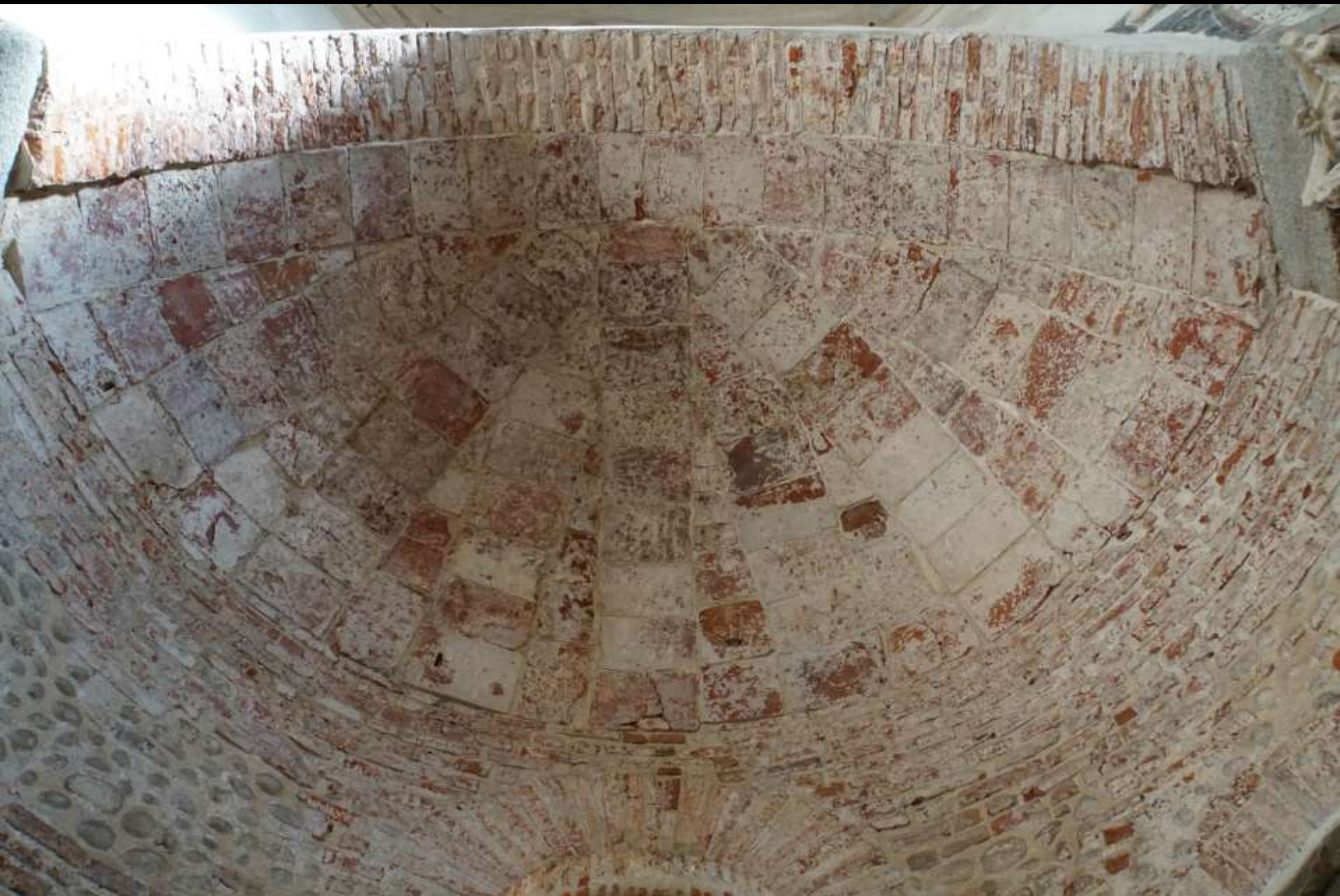
Novara, Baptisterium (6. Jh. n. Chr.). Gewölbe mit Tonplattenschalung
