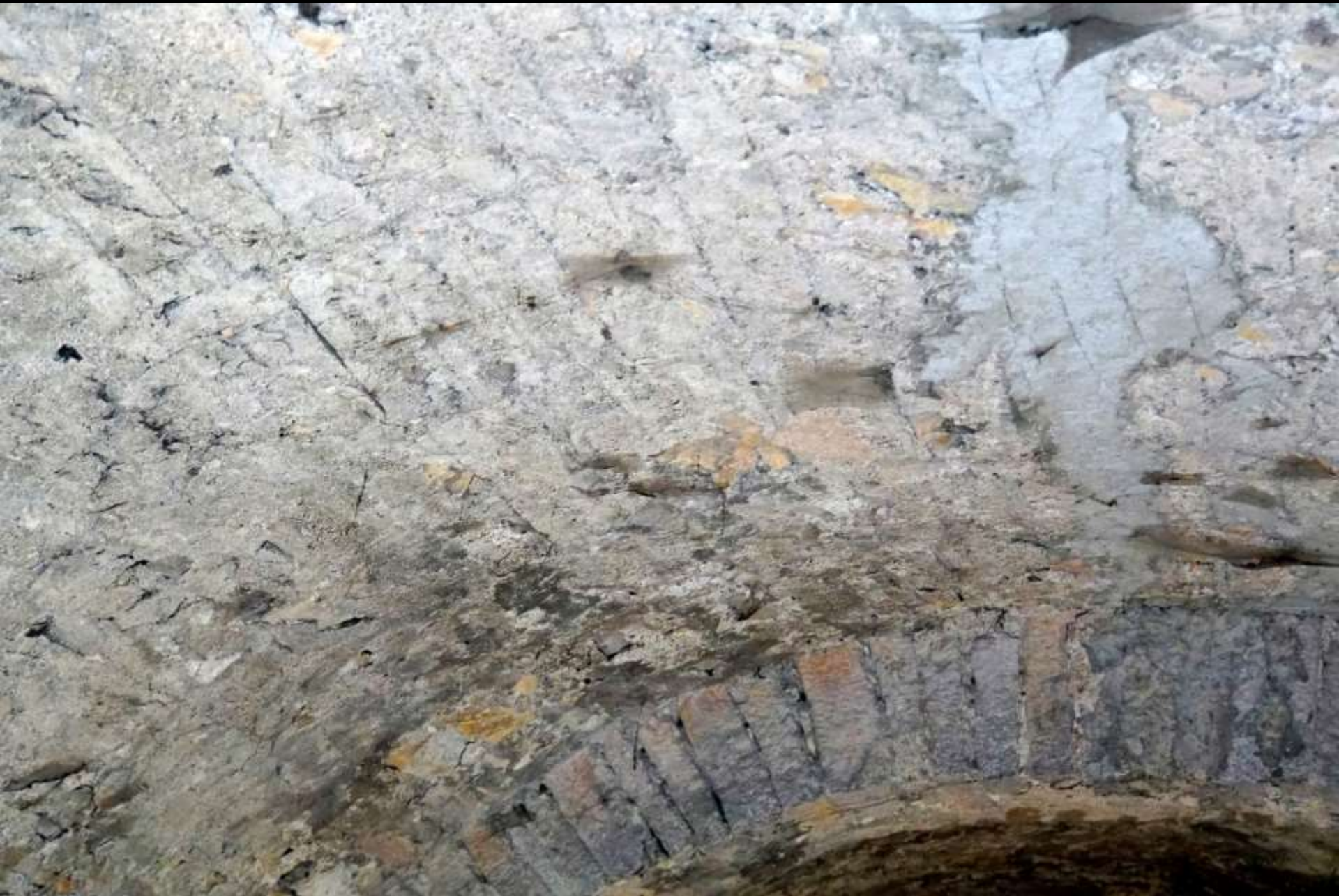
Tournus, Saint-Philibert. Vorkirche, Obergeschoss. Tonnengewölbe, Schalbrettabdrücke. (Foto: Louis Vandenabeele, IDB)
