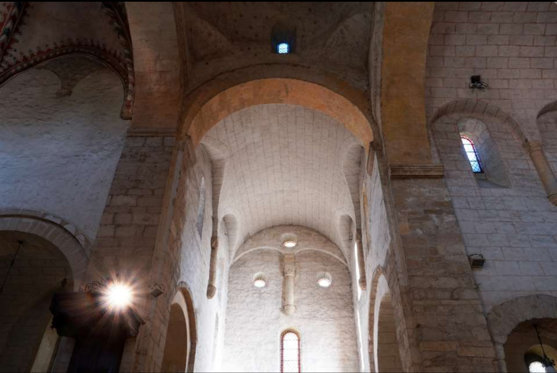
Romainmôtier, Abteikirche. Querschiff mit Tonnengewölbe (1. Drittel 11. Jh.)
