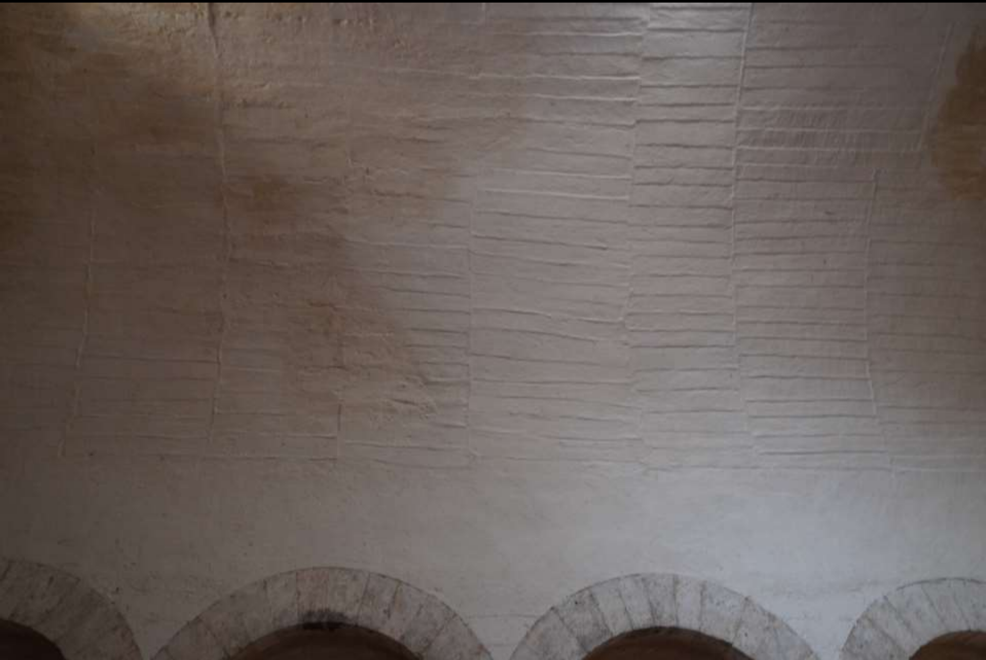
Tonnengewölbe aus Bruchsteinmauerwerk: Schalbrettabdrücke (Tournus, Saint-Philibert, Klosterpforte, 11. Jh.)
