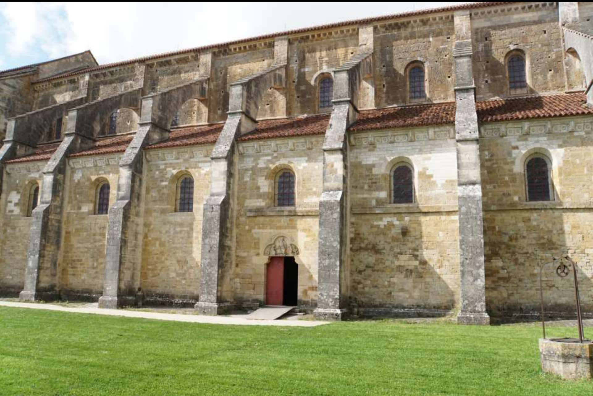
Vézelay, nachträglich aussen angebaute Stützpfeiler und Strebebögen
