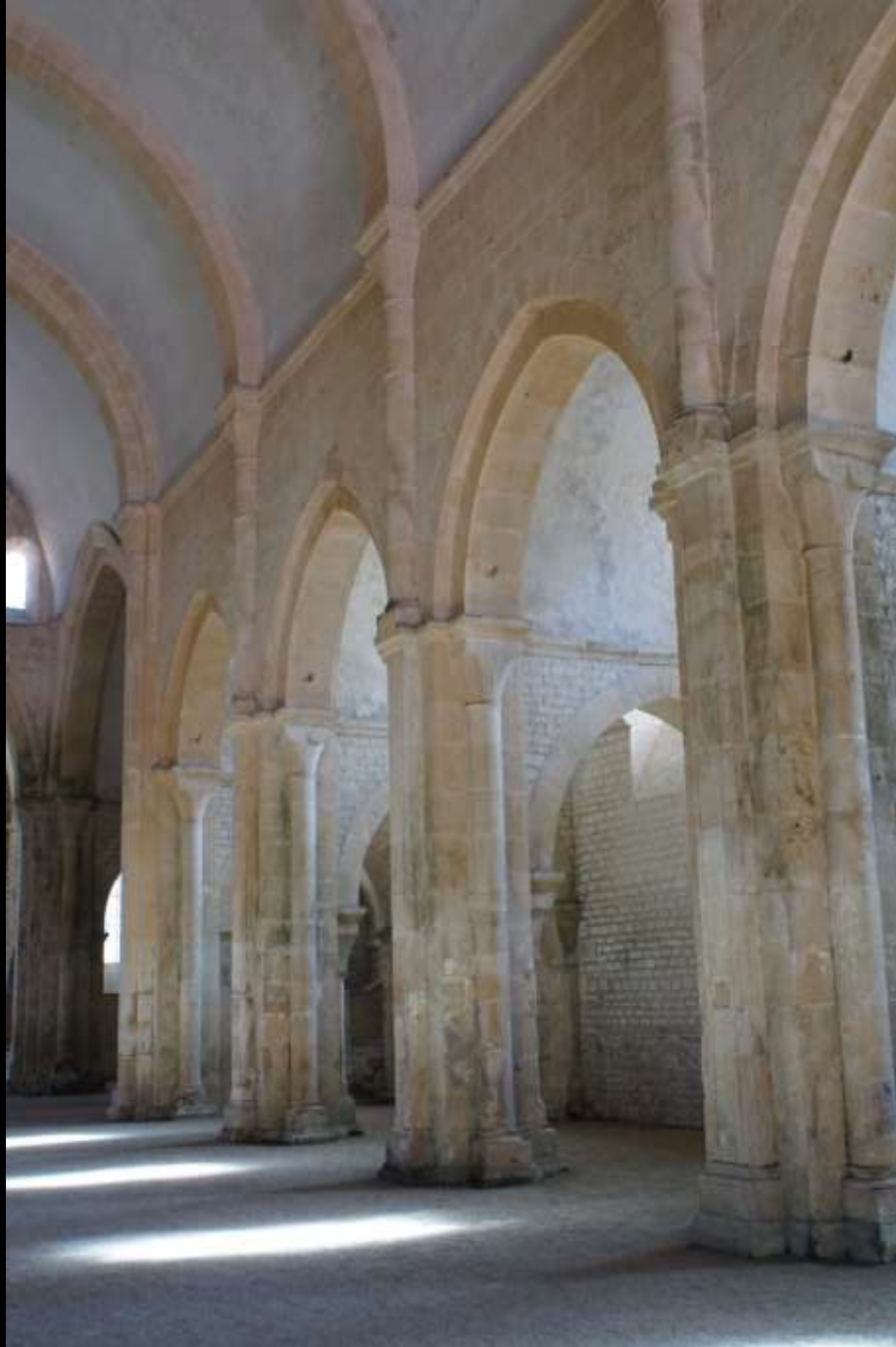
Spitztonne und Quertonnen im Seitenschiff (Abteikirche Fontenay/Burgund, 1. H. 12. Jh.)
