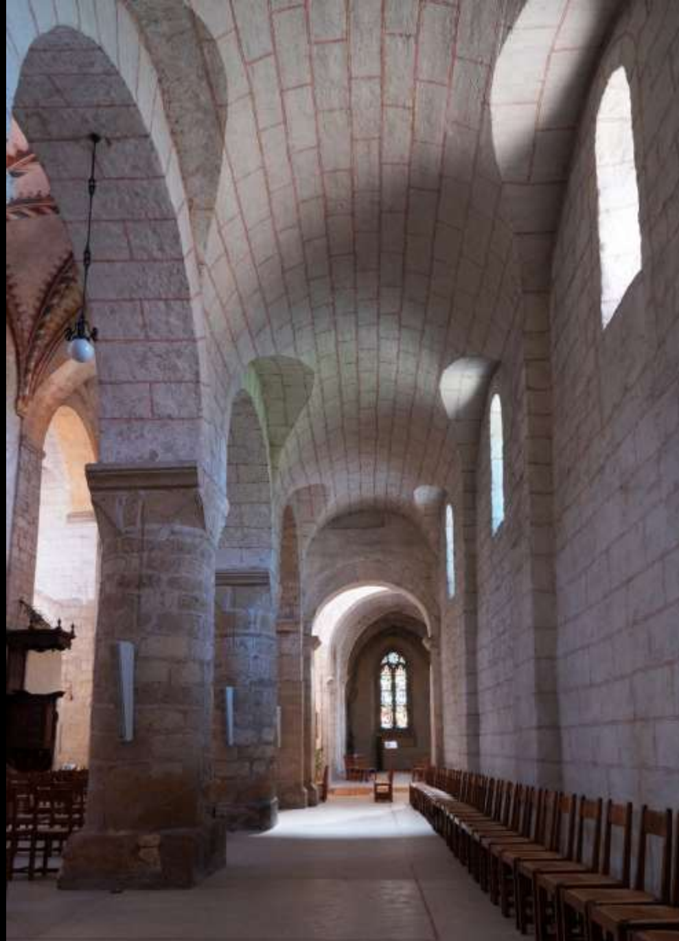
Romainmôtier, Abteikirche. Seitenschiff mit Tonnengewölbe (1. Drittel 11. Jh.)
