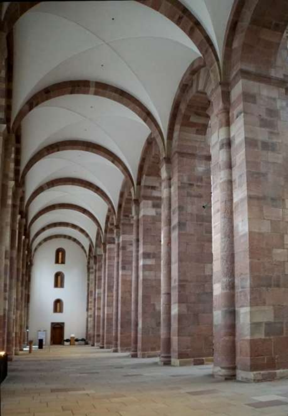
Speyer, Dom, Bau I, 1025–61, Seitenschiff mit Kreuzgratgewölben (7.8 m Spannweite!)
