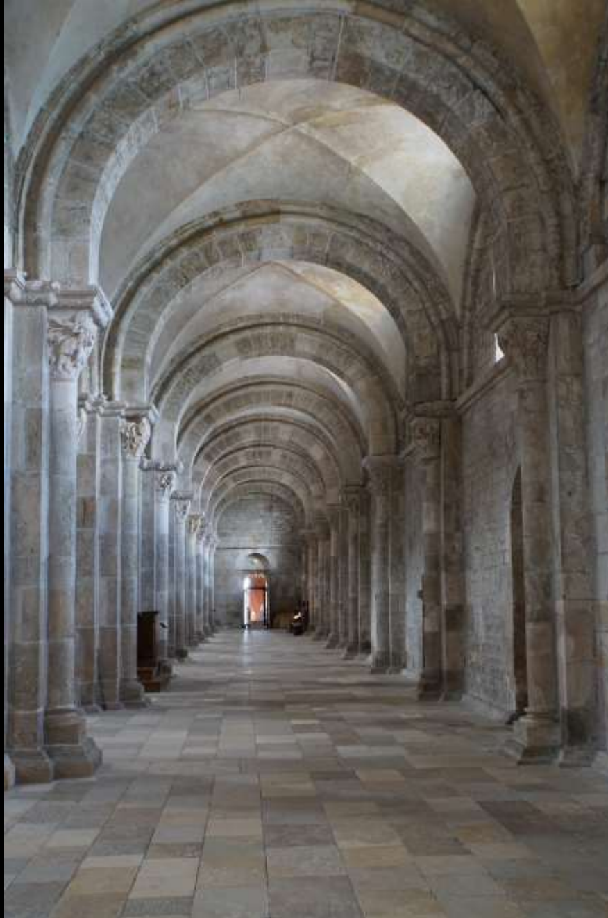
Vézelay, quadratische Kreuzgewölbe-Joche im Seitenschiff Kreuzgewölbe mit gestelzten Gurten und annähernd halbkreisförmigen Kreuzgraten
