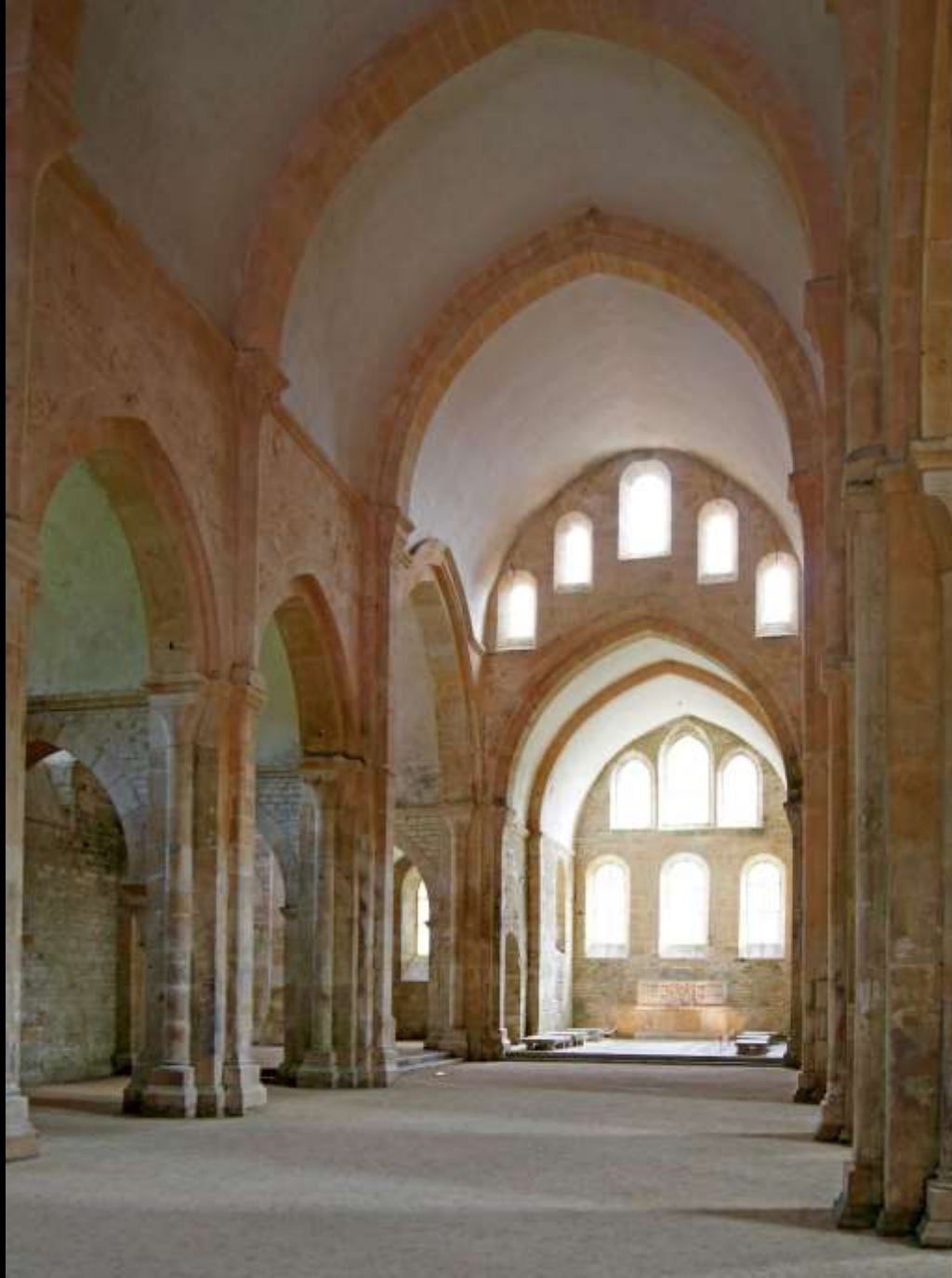
Spitztonne und Quertonnen im Seitenschiff (Abteikirche Fontenay/Burgund, 1. H. 12. Jh.)
