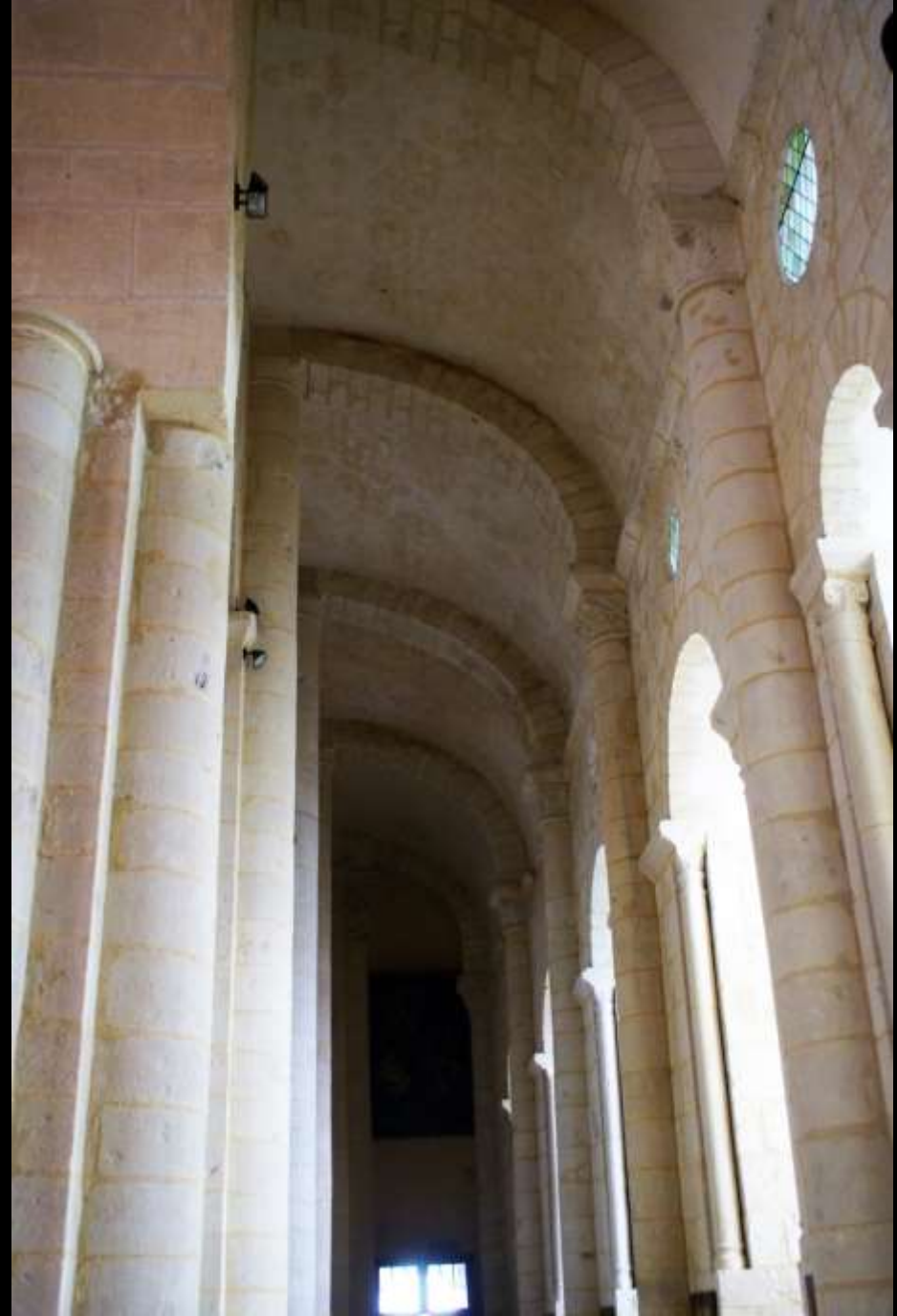
Saintes (Charente), St-Eutrope. Wölbung mit Spitztonne im Mittelschiff, Halbtonne im Seitenschiff (1. H. 12. Jh.)
