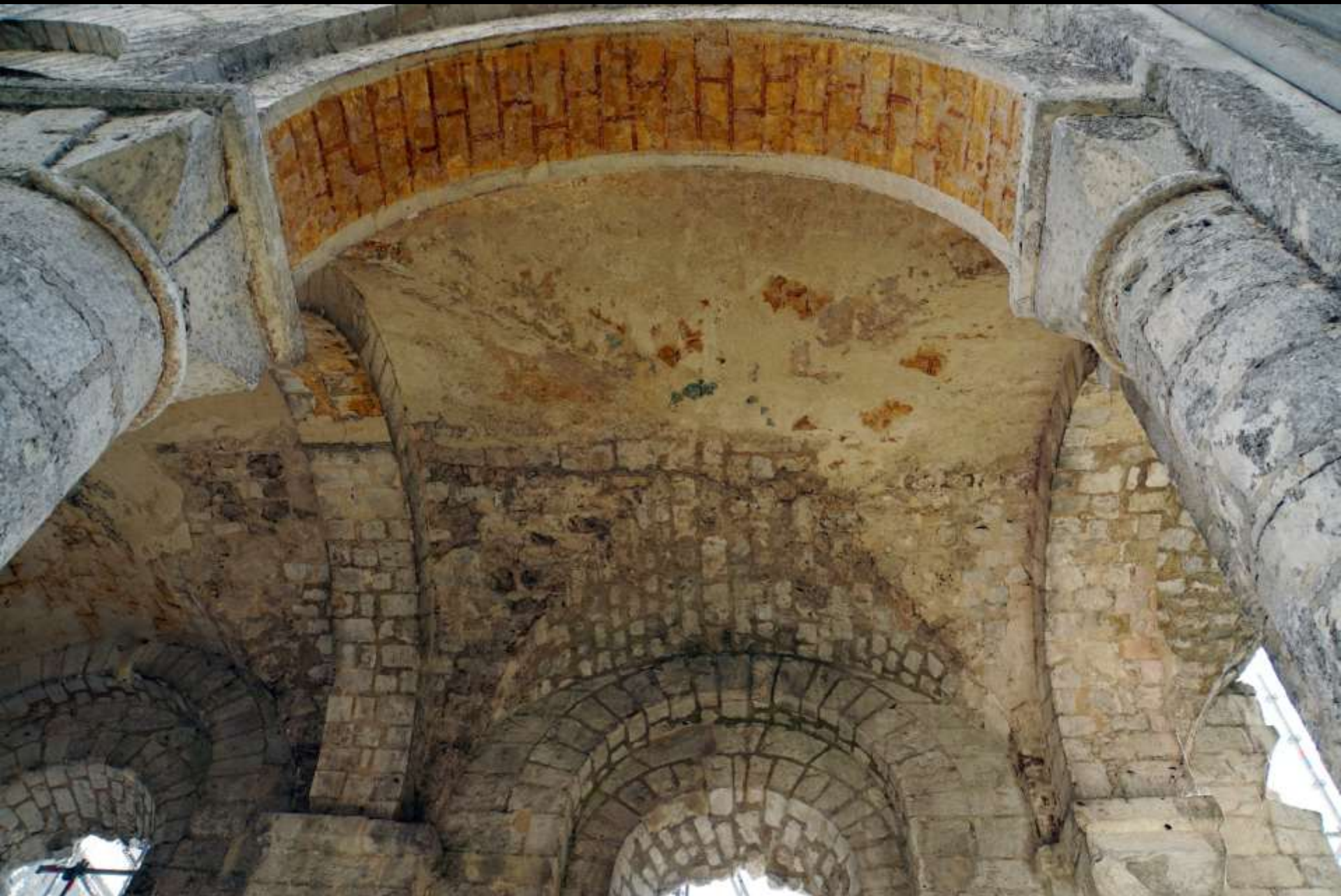
Jumièges (Normandie), Seitenschiffe mit Kreuzgratgewölben.
