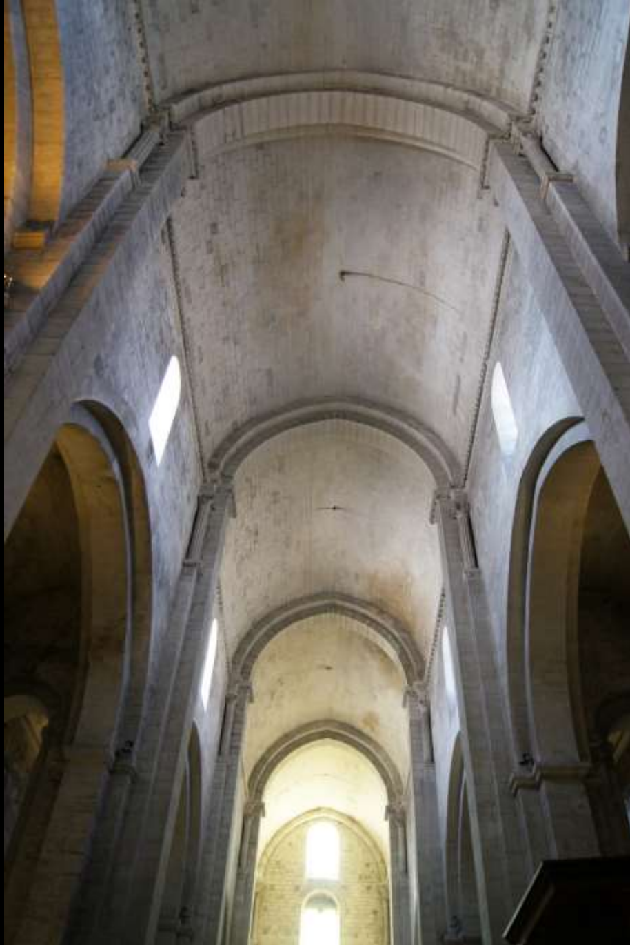
Arles (Provence), Saint-Trophime (12. Jh.). Spitztonne in Werkstein und Viertelkreistonne im Seitenschiff.
