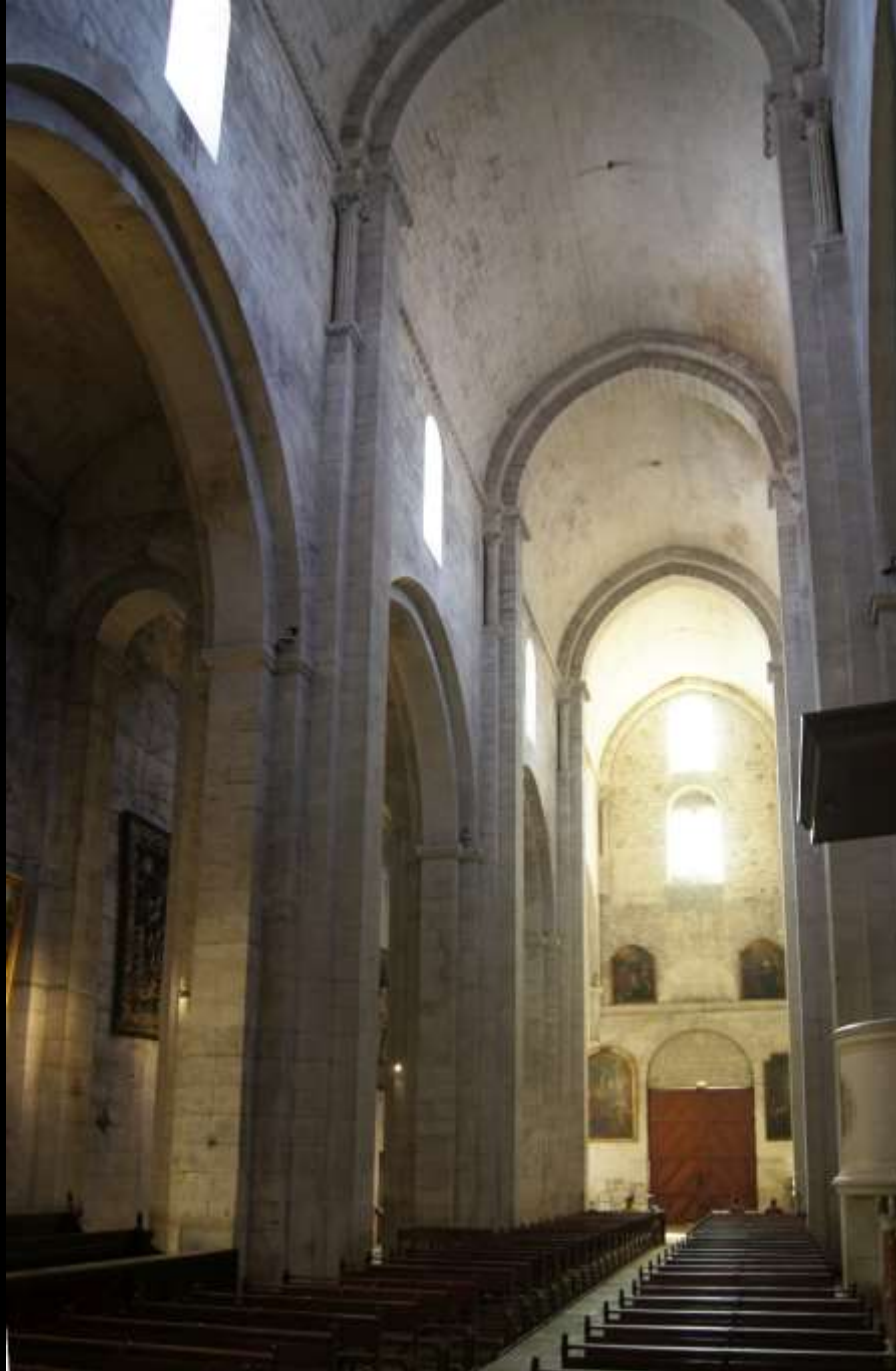
Arles (Provence), Saint-Trophime (12. Jh.). Basilika mit Tonnengewölbe
