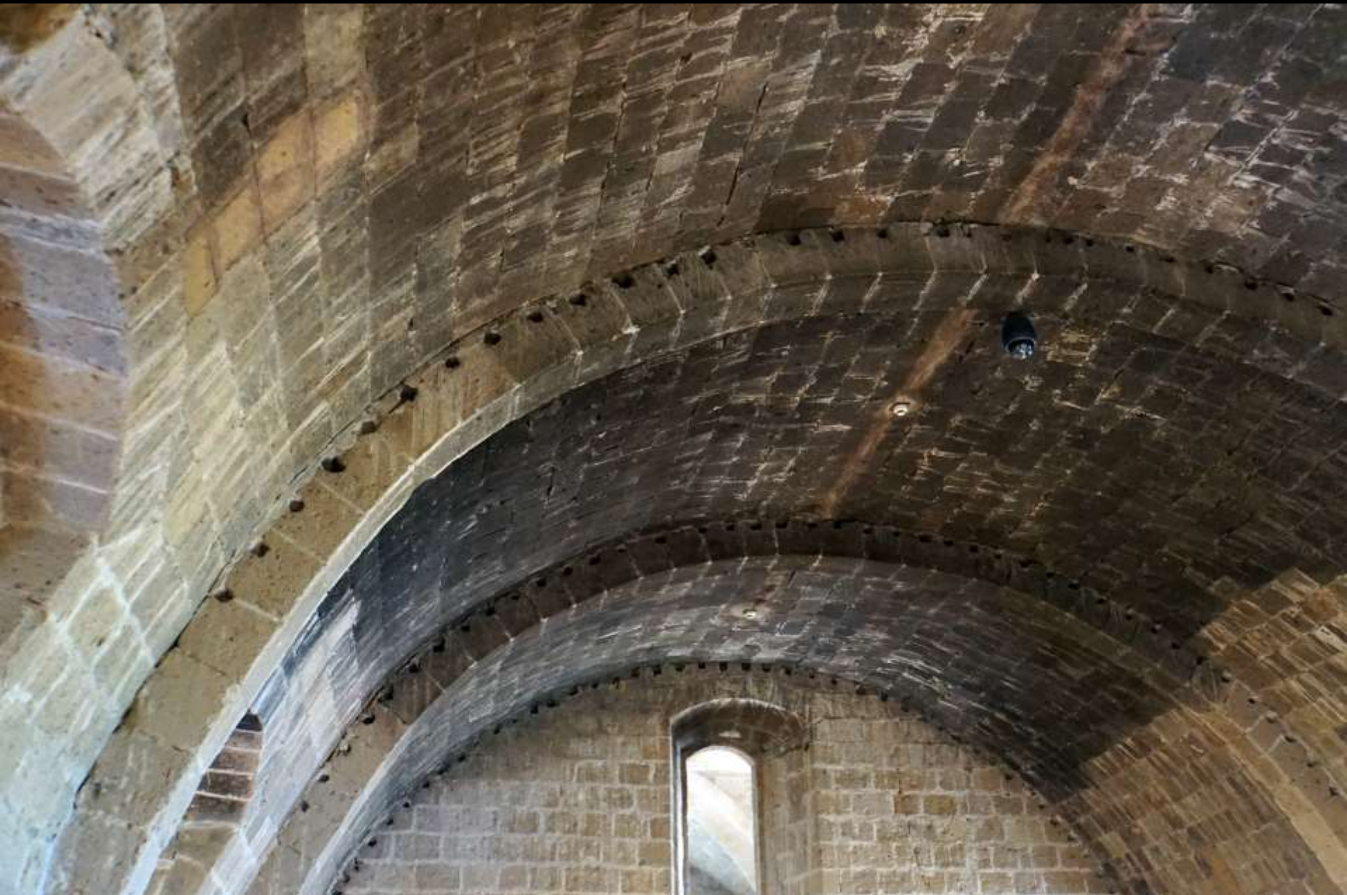
Orvieto, Papstpalast. Gurtrippen als Schalungsträger (13. Jh.)
