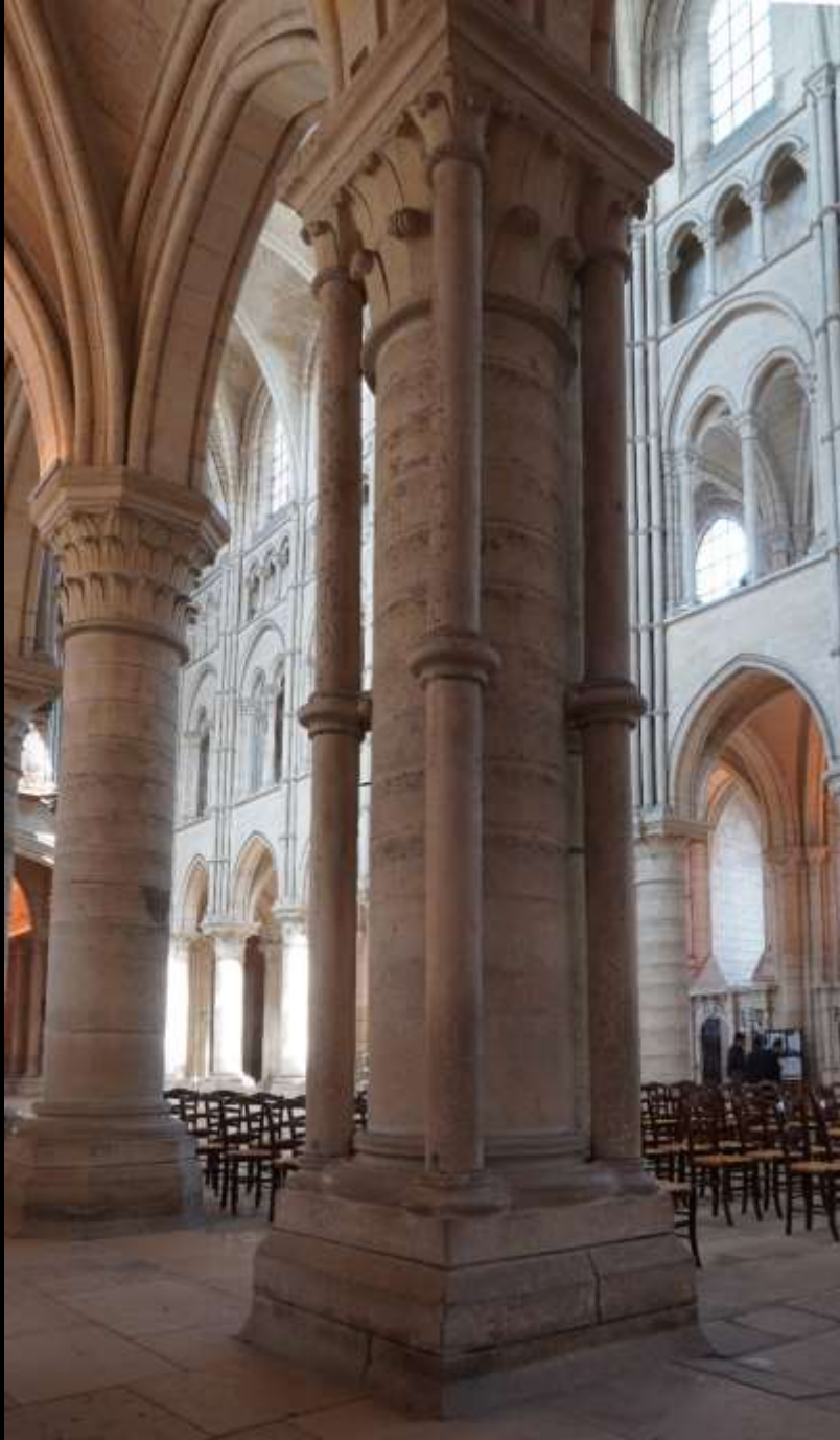
Laon, Kathedrale, Säule, umringt mit freistehenden Säulchen (en délit)
