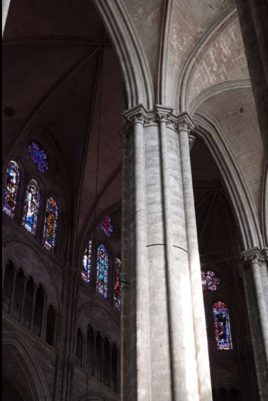
Bourges, Kathedrale, mit dem Rundpfeiler gemeinsam aufgemauerte Dienste
