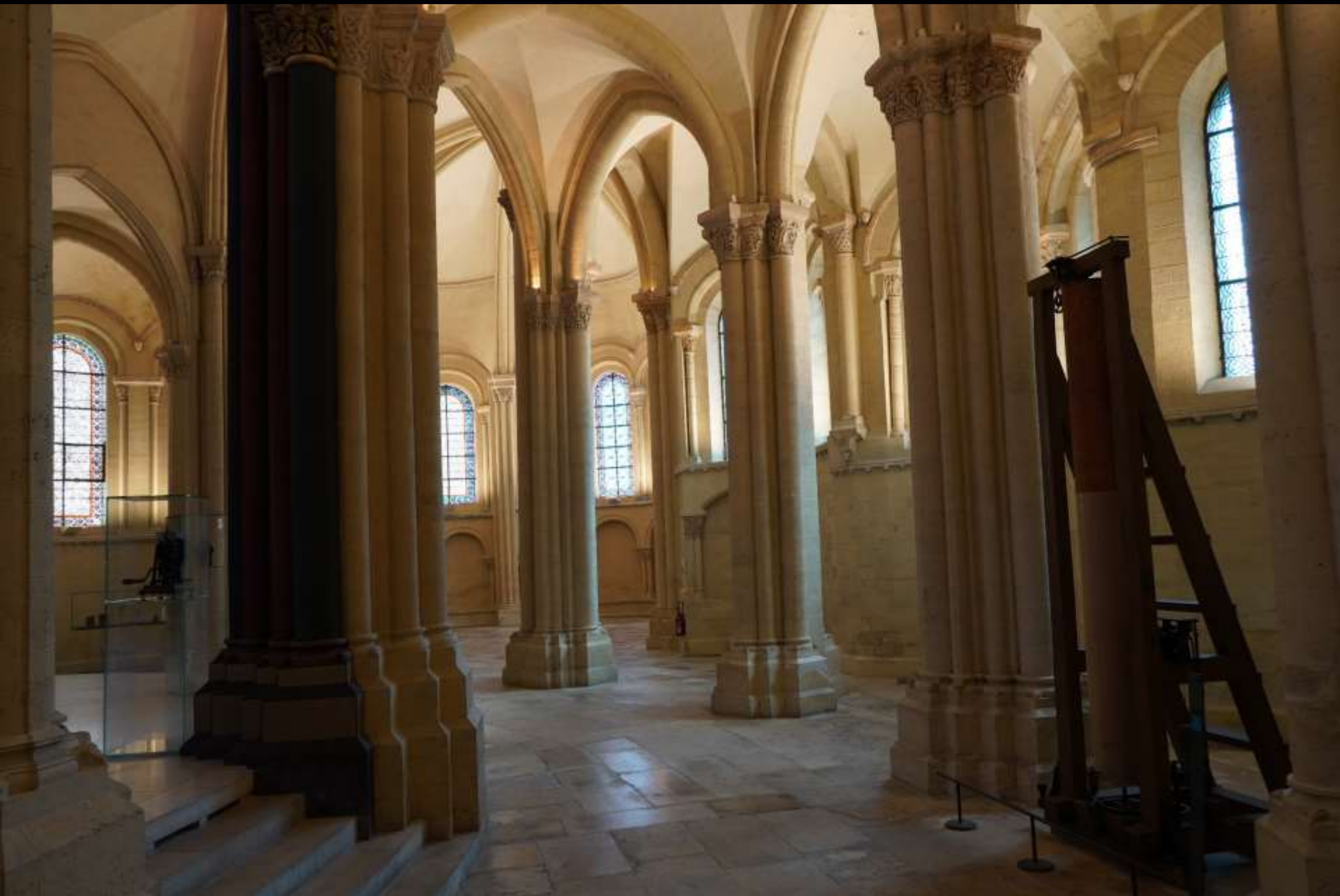
Paris, Saint-Martin-des-Champs, ab 1130. Chorumgang mit verbundenen Kapellen und reicher Befensterung
