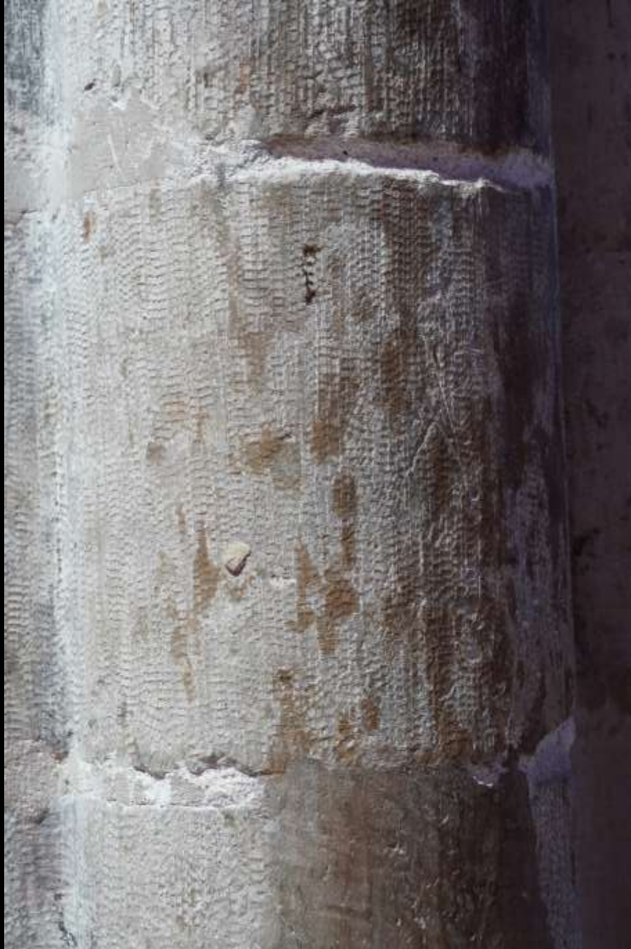
Bourges, Kathedrale, Steinbearbeitung mit Zahnfläche („bretture“)
