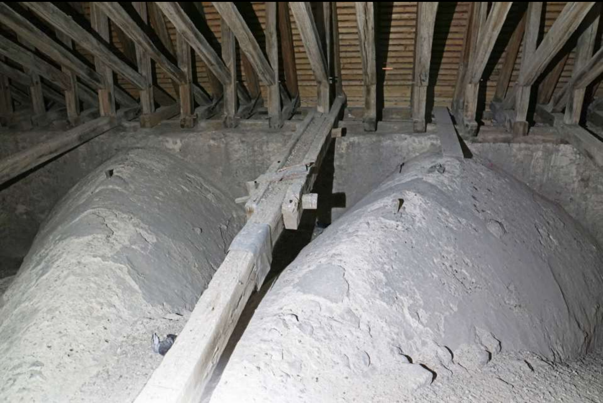
Sens, sechsteiliges Gewölbe von oben
