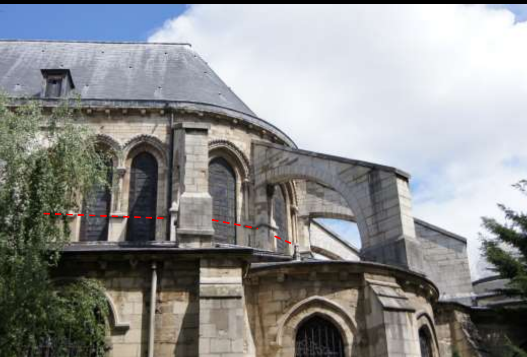
Paris, Saint-Germain-des-Prés, ab 1145. Wandaufbau und Rekonstruktion des Ursprungszustands
