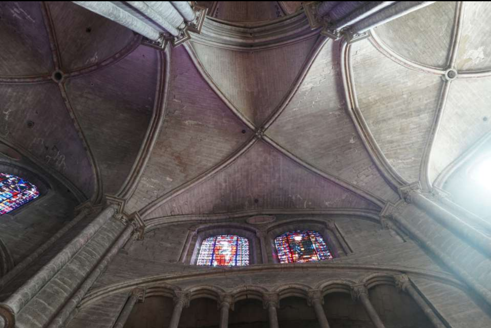
Bourges, Kathedrale, Gewölbe im inneren Chorumgang
