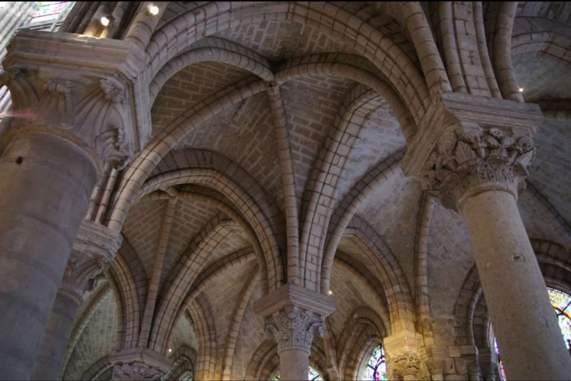
Saint-Denis, Chorumgang, Rippengewölbe und korinthisierende Kapitelle
