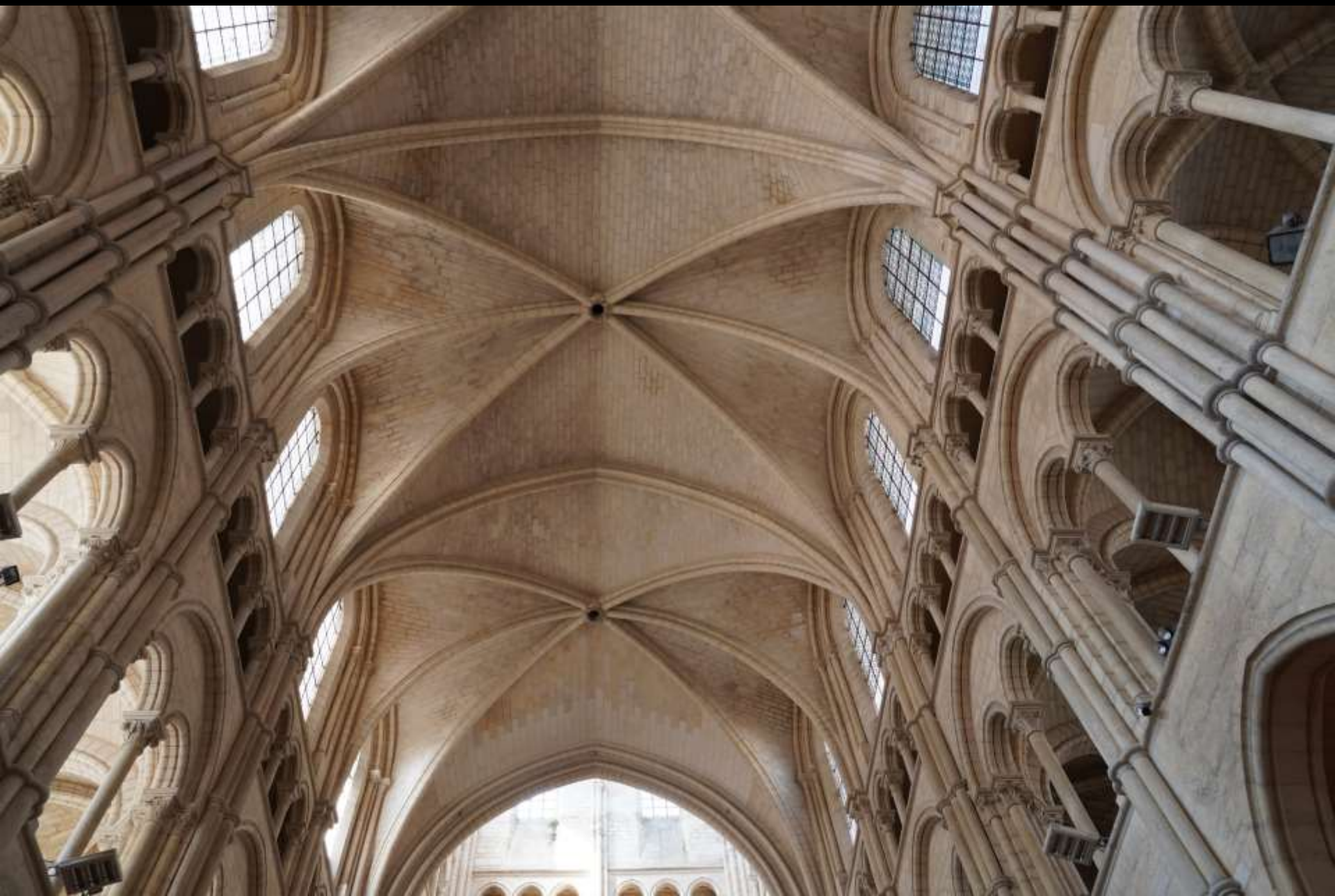
Laon, Kathedrale, sechsteiliges Gewölbe mit Werksteinkappen
