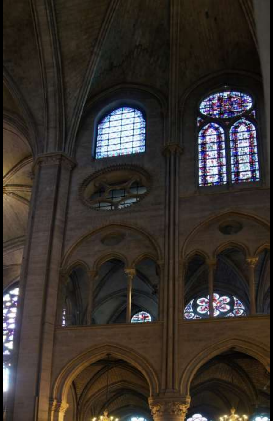
Paris, Kathedrale Notre-Dame, heutiger und von Viollet-le-Duc rekonstruierter ursprünglicher Wandaufbau
