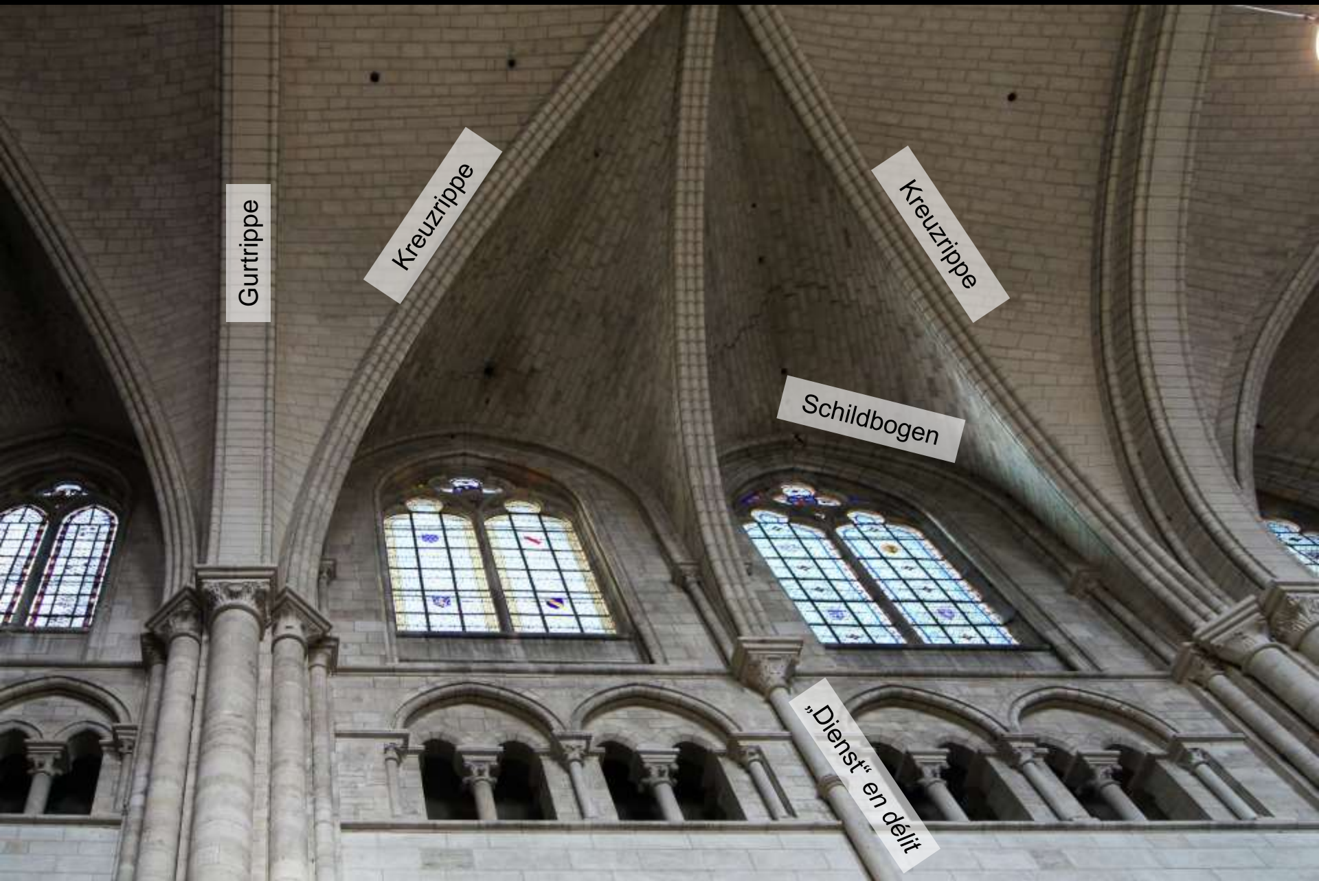
Sens, Kathedrale. Mittelschiffsgewölbe und Zuordnung von Stützen und Rippen
