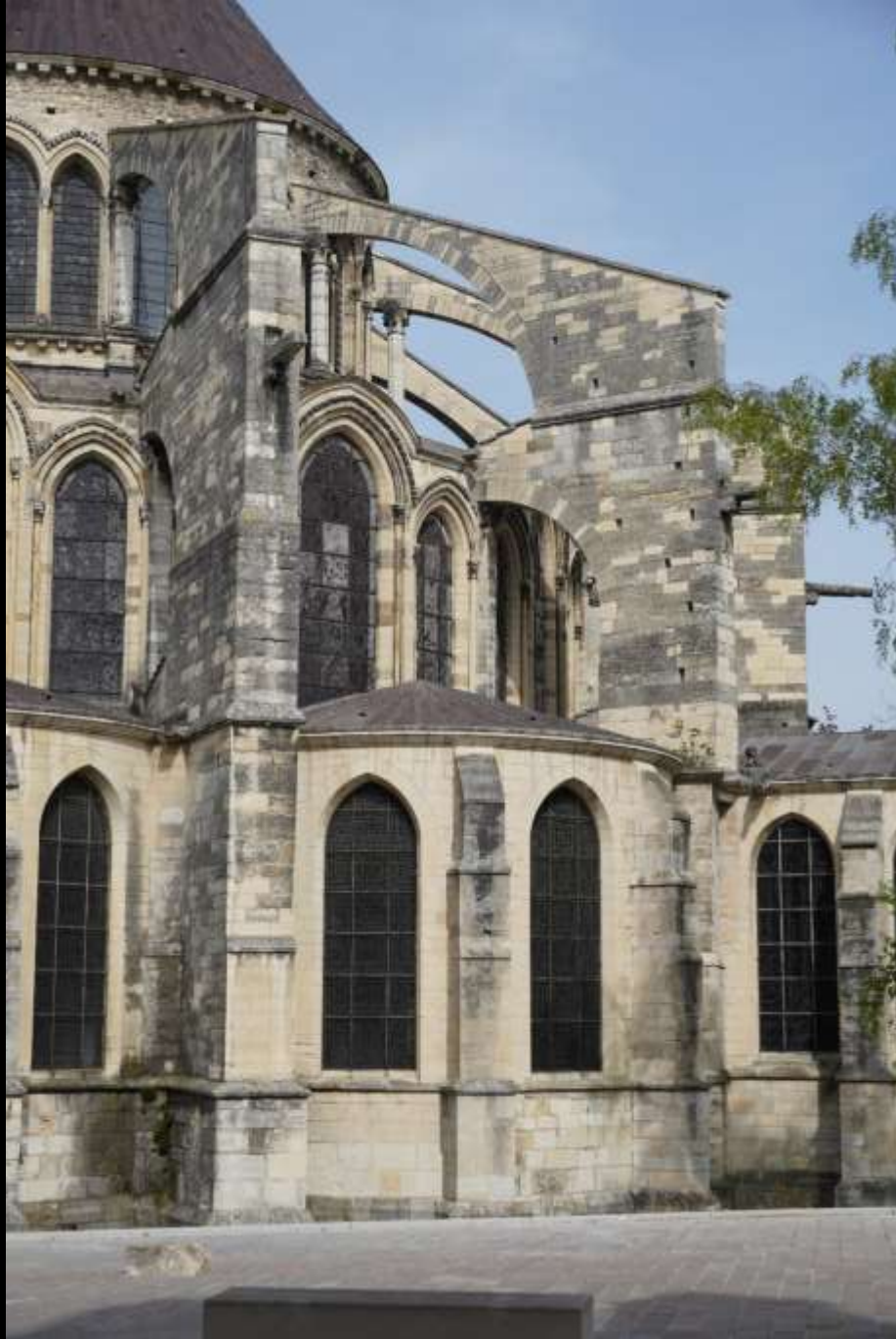
Zum Vergleich: Strebewerk der Abteikirche Saint-Remi in Reims, um 1170 (King 1858)
