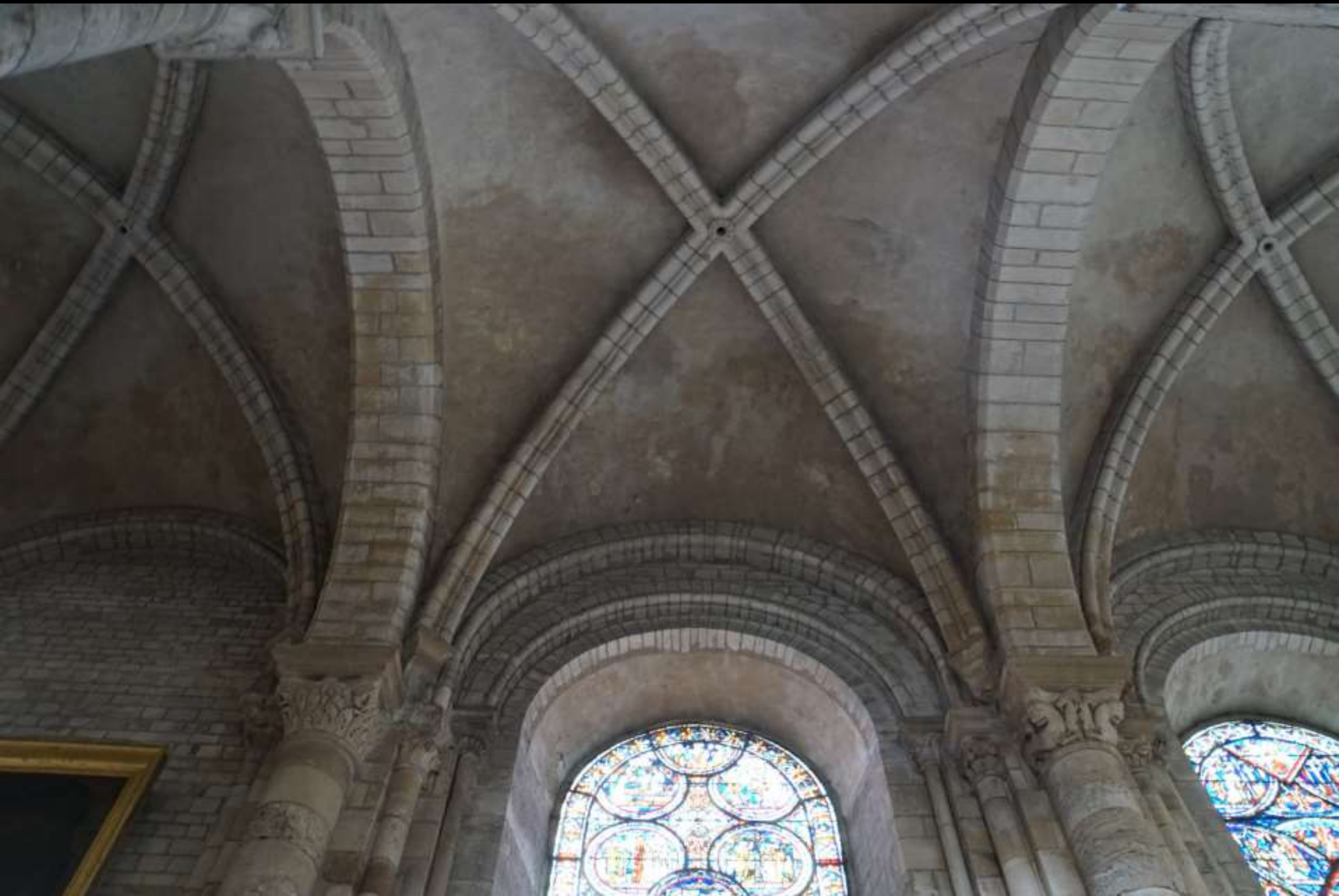
Sens, Kathedrale. Seitenschiffsgewölbe und Stützen.
