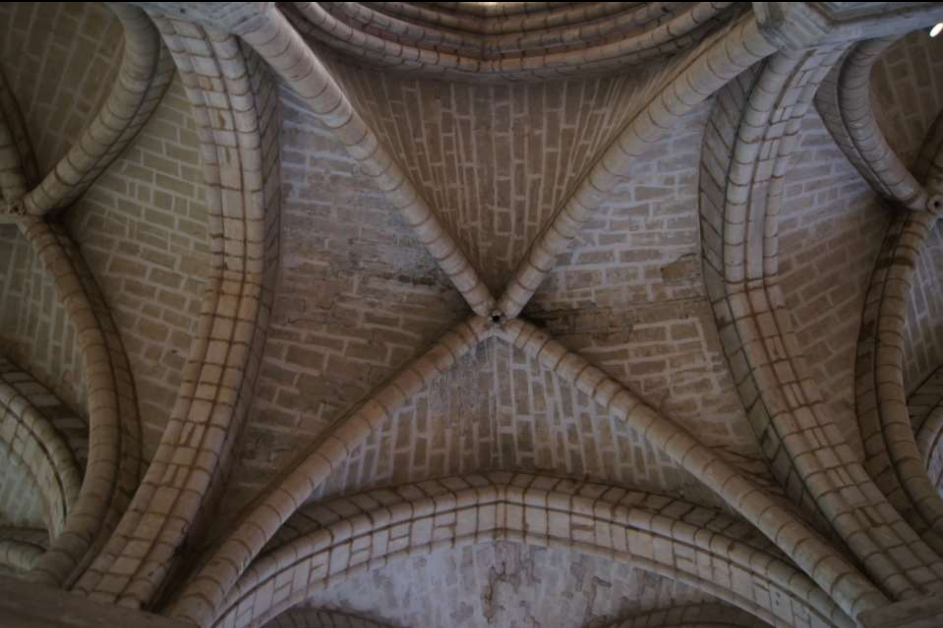
Saint-Denis, Chorumgang, verzogene spitzbogige Rippengewölbe und Kappen aus Werkstein
