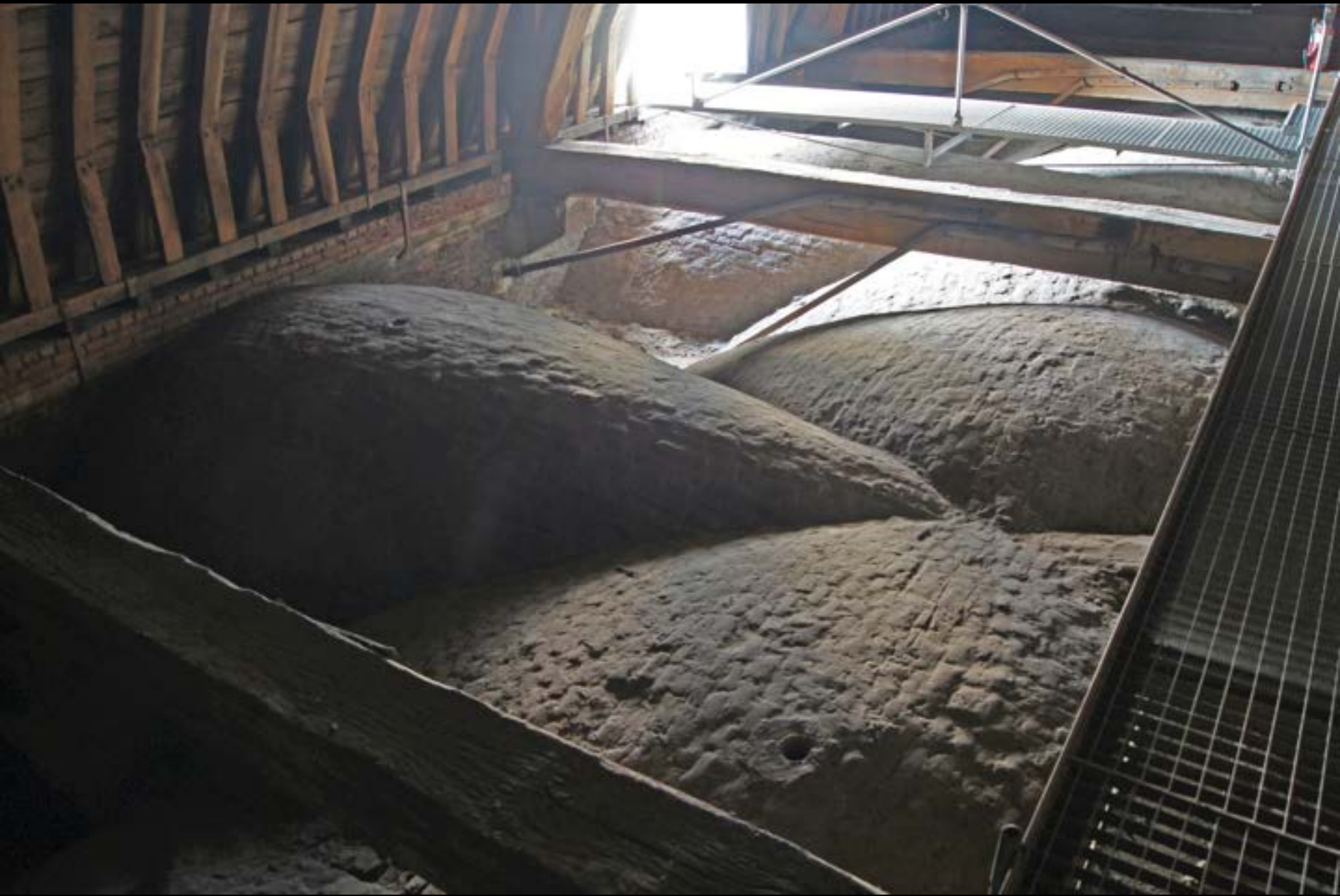
Brüssel, Notre Dame du Sablon (15. Jh.). Gebüste Kreuzrippengewölbe aus Backstein
