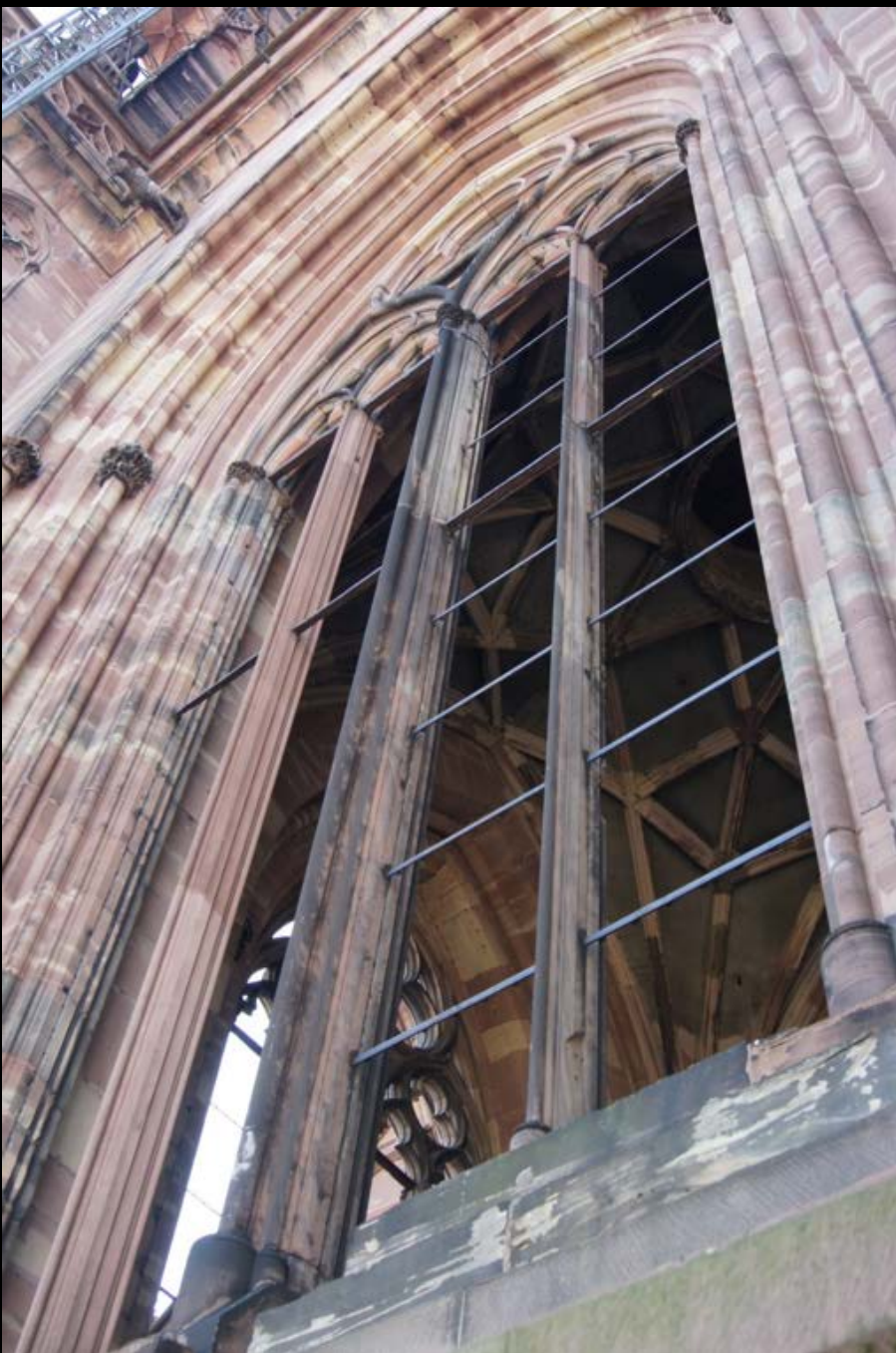
Strassburg, Münster, Westfassade (1275 – frühes 14. Jh.). Eiserne Konstruktionselemente
