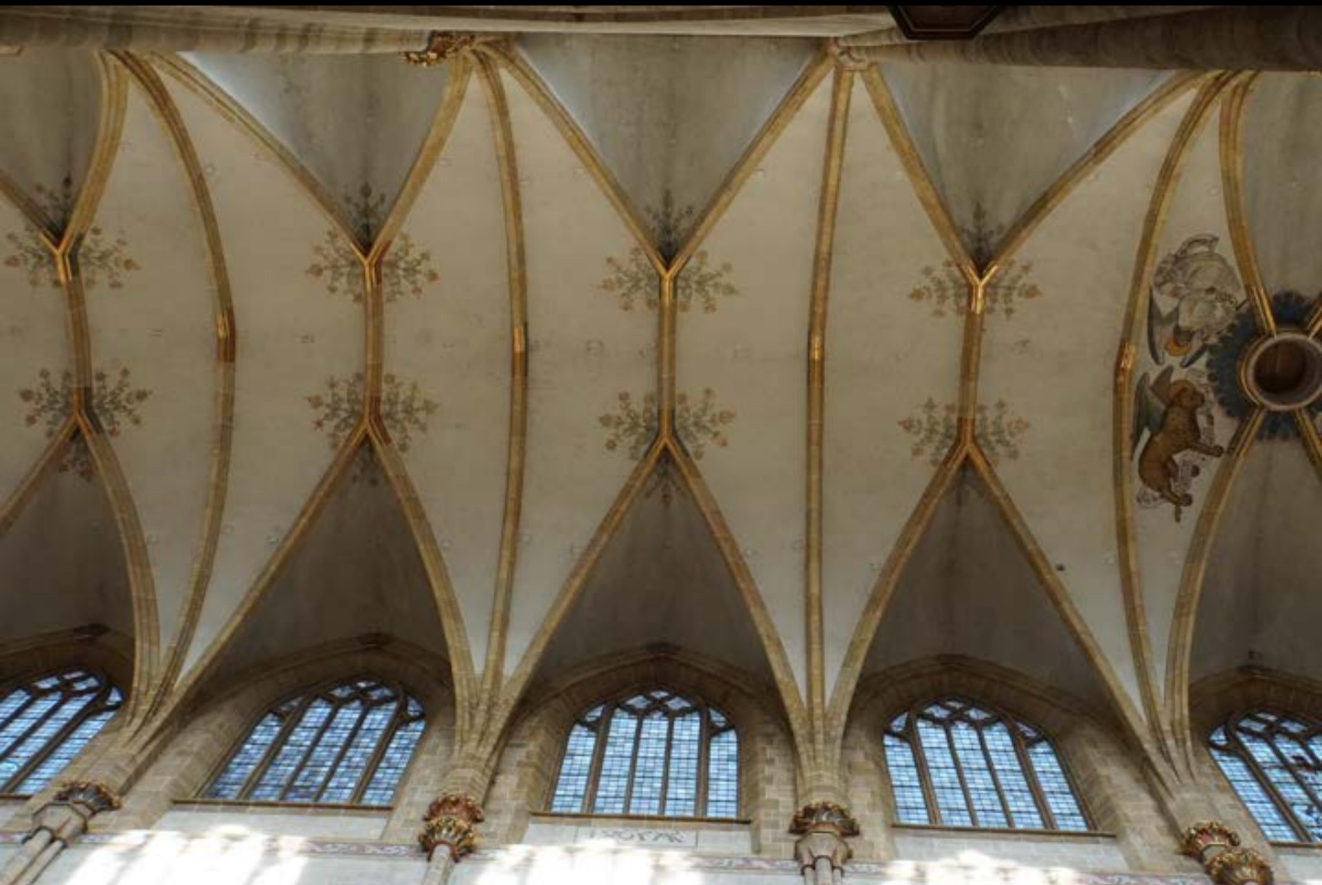
Ulm, Münster, Gewölbe des Langhaus-Mittelschiffs (um 1500)
