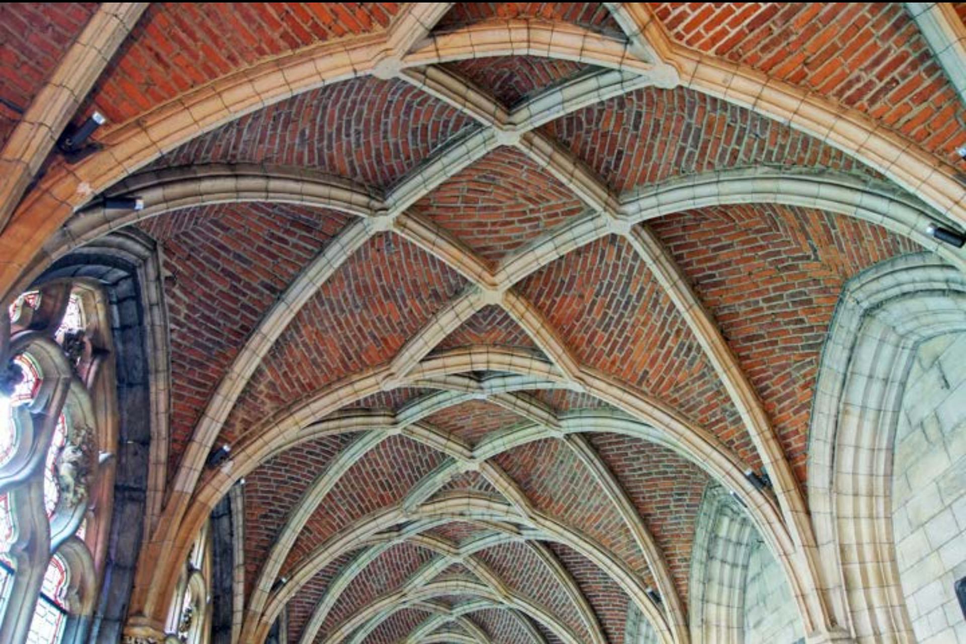
Lüttich, Saint-Paul, Kreuzgang (15. Jh.). Schwalbenschwanzverband des Kappenmauerwerks.
