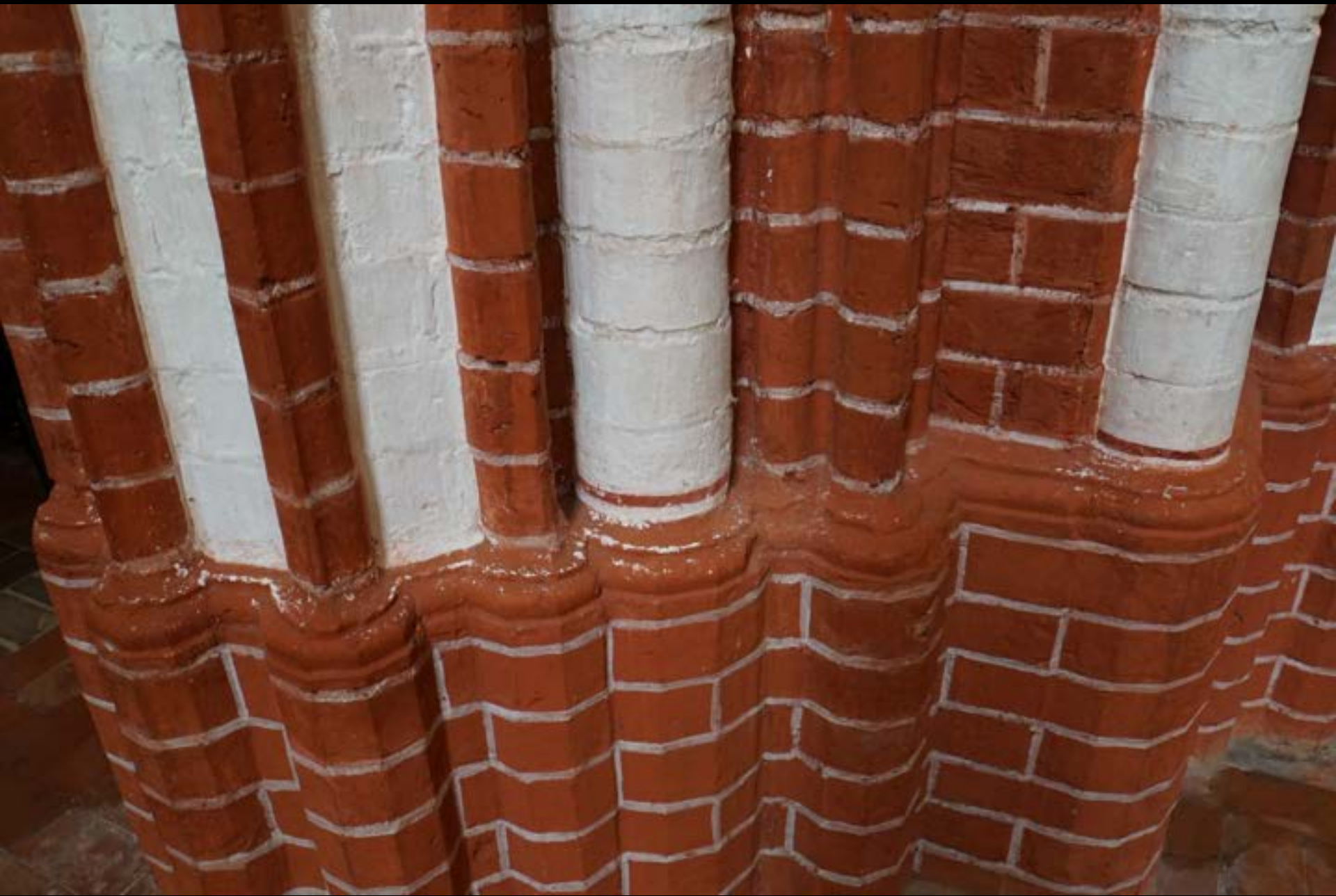
Doberan, Abteikirche (um 1300). Konstruktion der Bündelpfeiler
