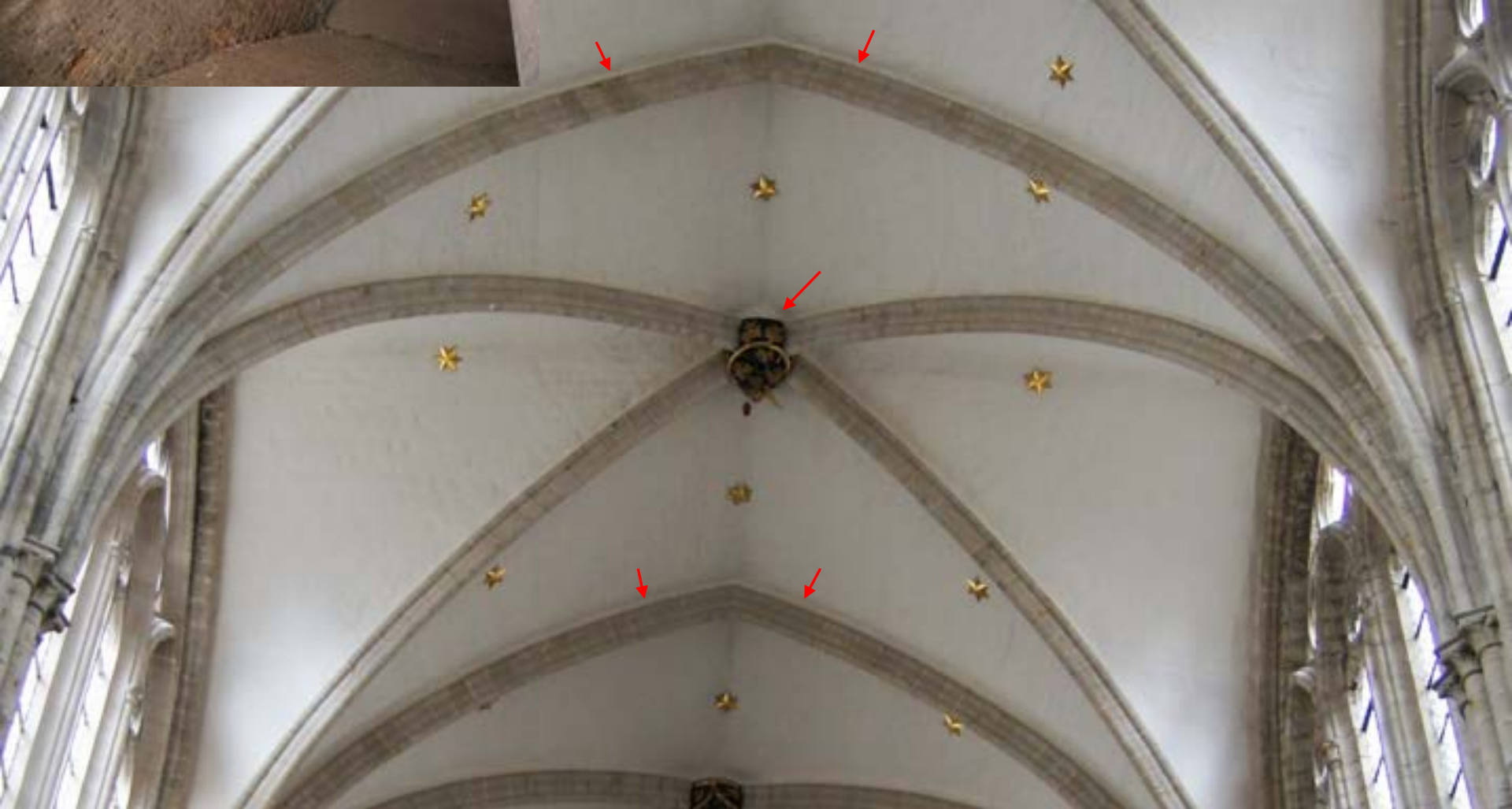
Kreuzrippengewölbe mit horiz. Scheitel, Brüssel, Saint-Michel-Sainte-Gudule, Langhaus, 14. Jh.
