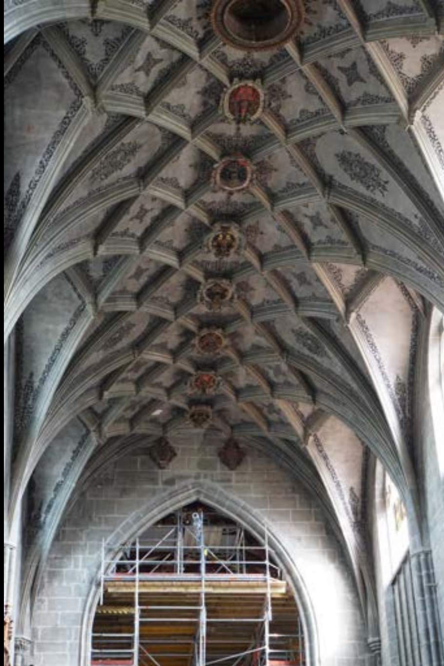
Bern, Münster, Langhausgewölbe
