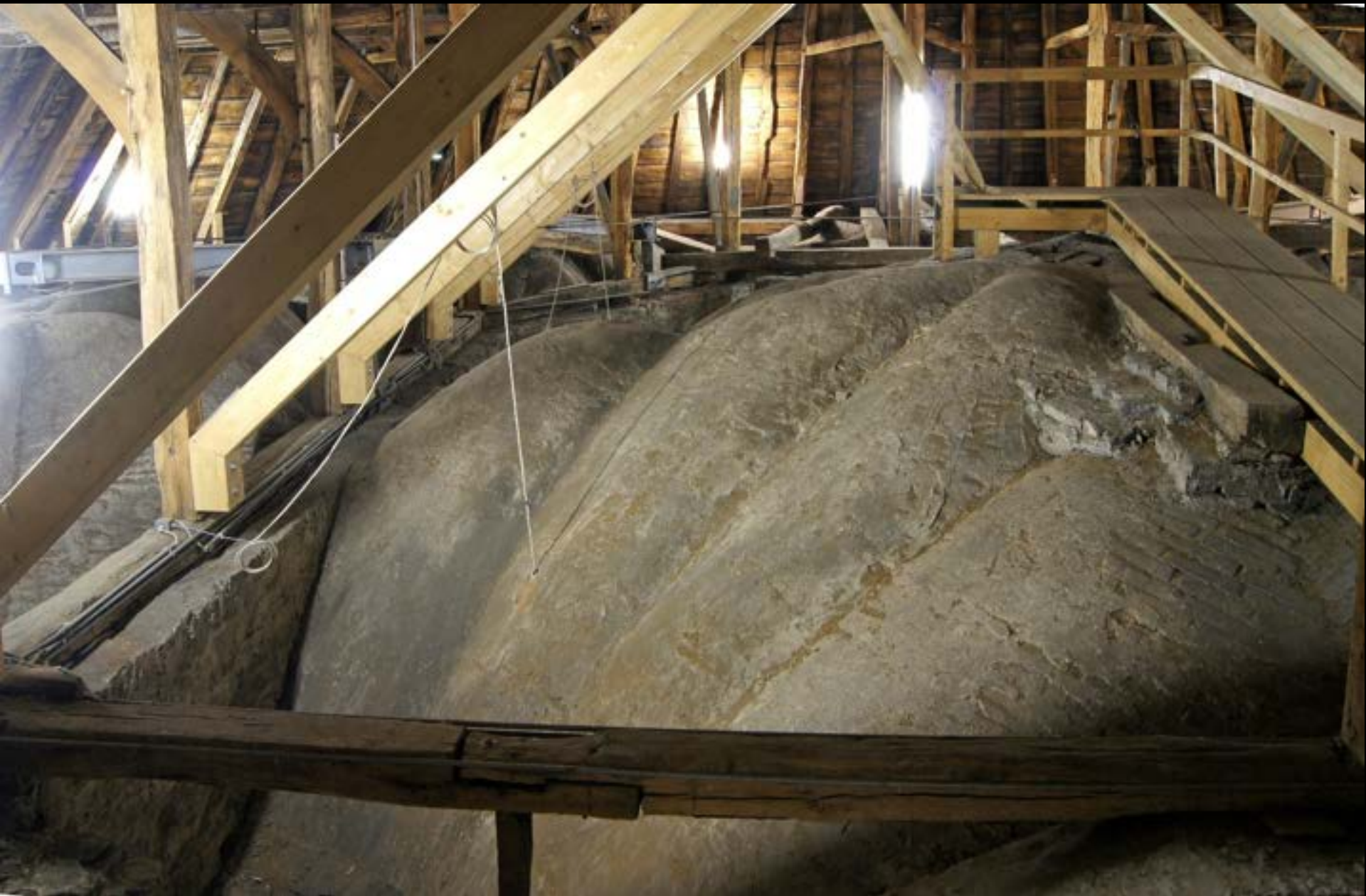
Lippstadt, Grosse Marienkirche, Chorgewölbe von oben (1499). Freihändig gewölbte Kappen.
