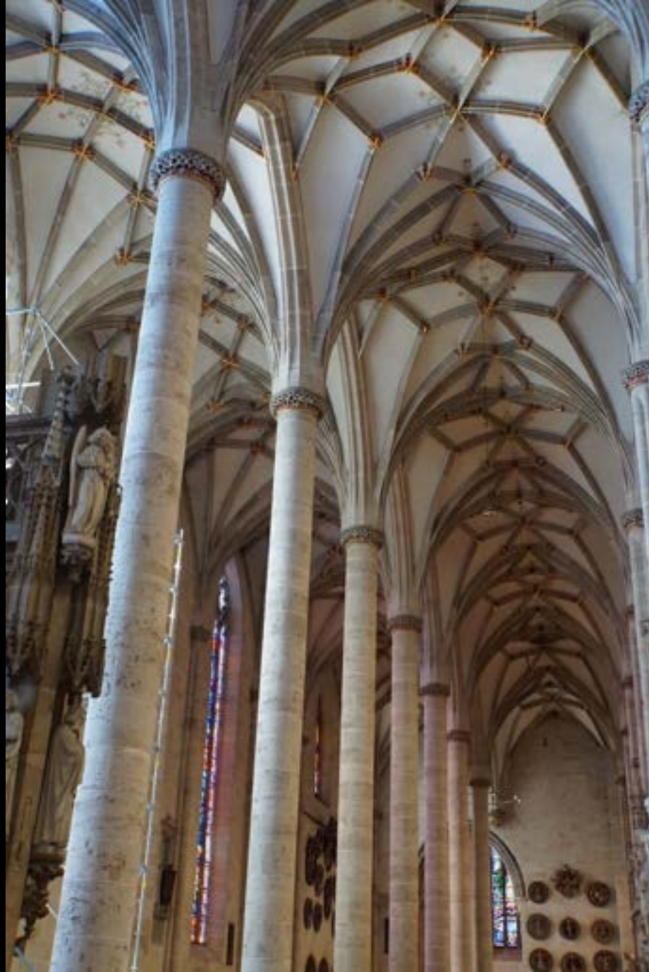
Ulm, Münster, Rautensterngewölbe der Seitenschiffe (Anf. 16. Jh.)
