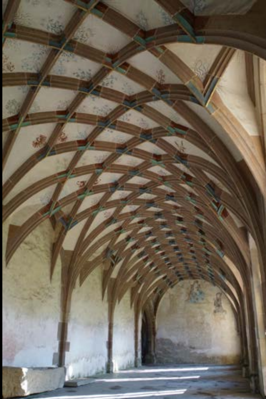
Maulbronn, Parlatorium. Parallelrippen-Netzgewölbe ohne Jocheinteilung (Ende 15. Jh.)
