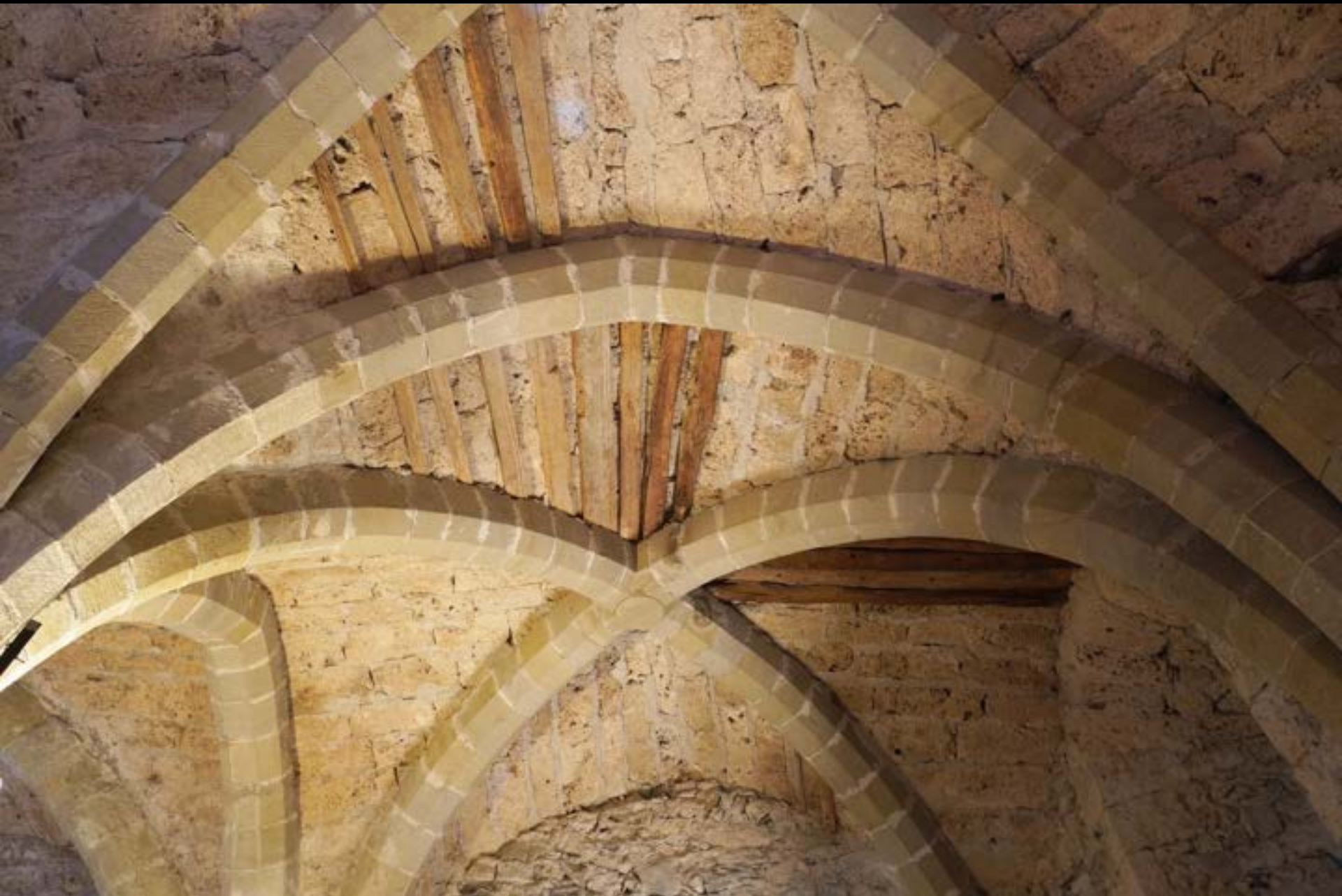
Rippen als Schalungsträger: erhaltene Schalungslatten (Schloss Chillon VD, 13. Jh.)
