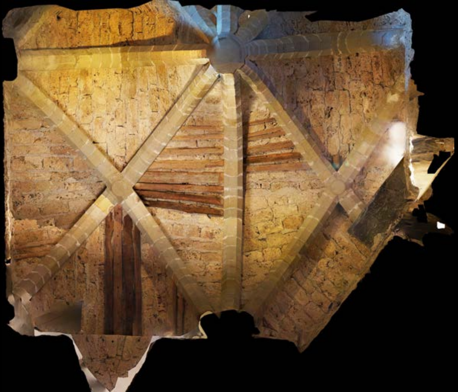
Rippen als Schalungsträger: erhaltene Schalungslatten (Schloss Chillon VD, 13. Jh.; Orthogonalprojektion)
