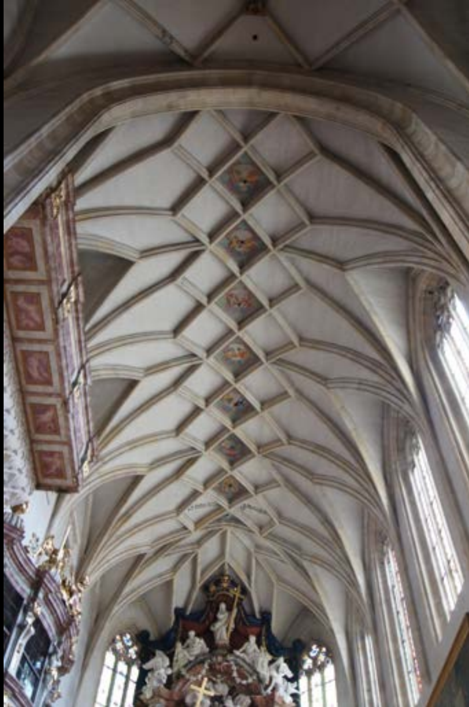
Graz, Dom, Rautennetzgewölbe (2. H. 15. Jh.)
