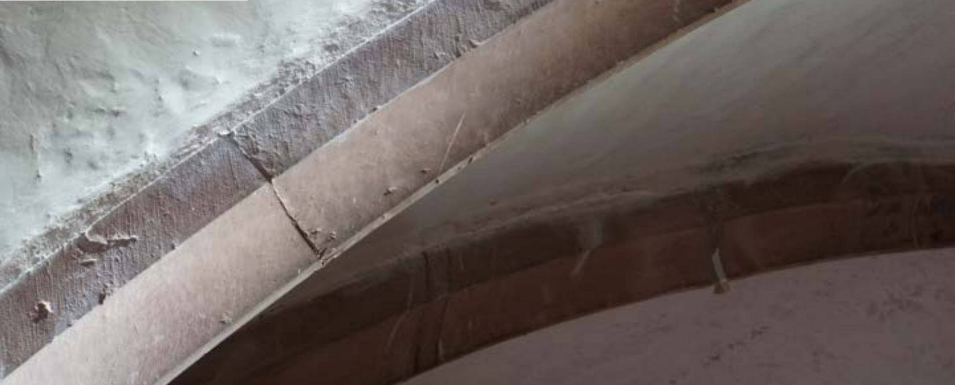
Rippen als Schalungsträger (Basel, ehem. Kirche Grosses Klingental, um 1290)
