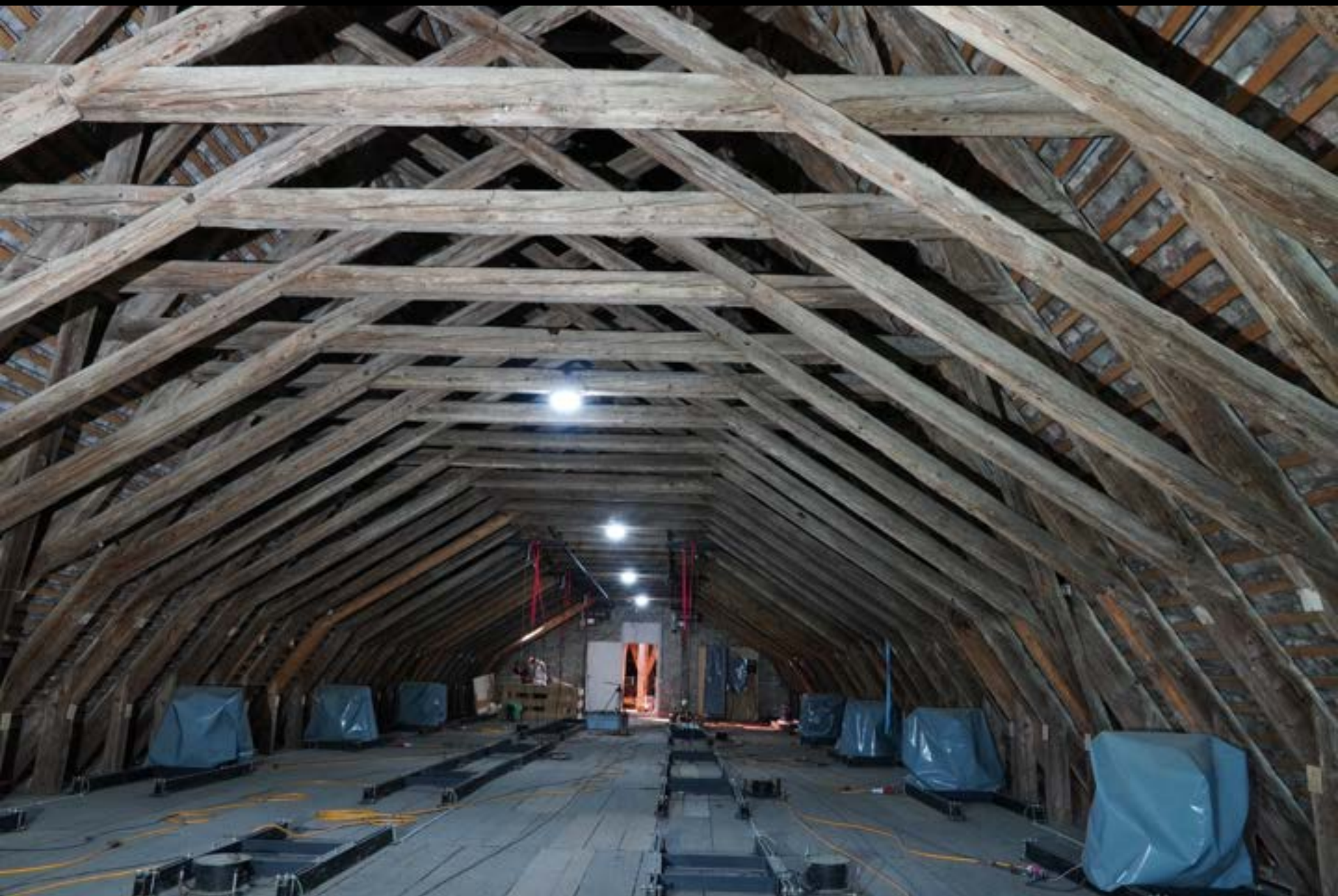
Königsfelden (AG), ehem. Franziskanerklosterkirche (1310–30), Dachwerk
