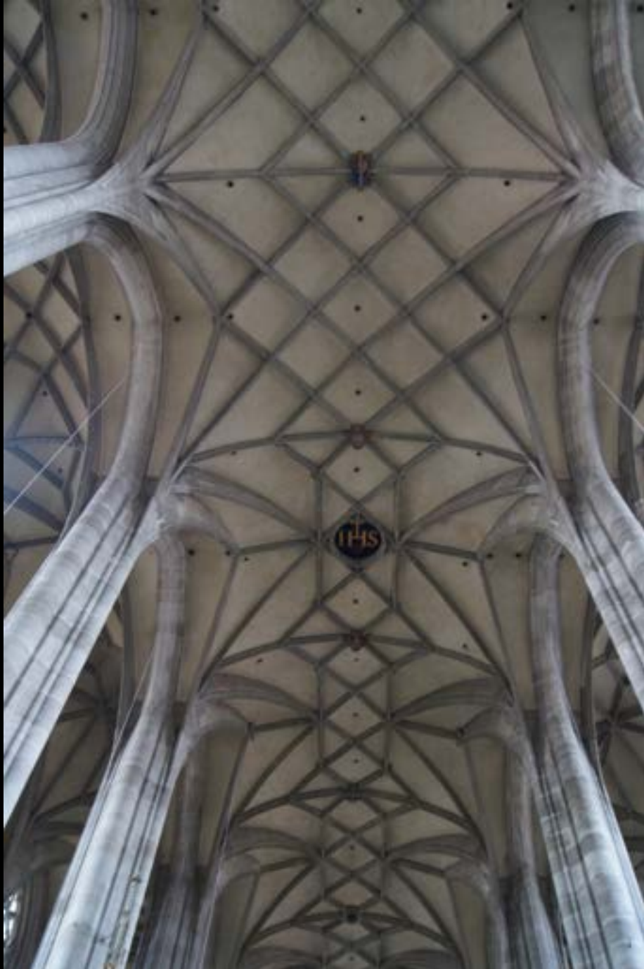
Dinkelsbühl, St. Georg. Parallelrippengewölbe mit Gurtbogen (Ende 15. Jh.)
