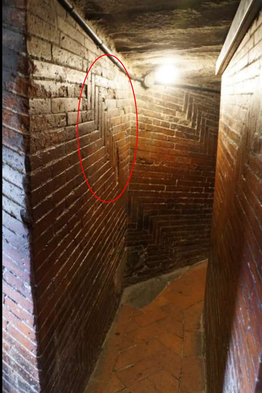
Florenz, Dom. Demonstrativer „Spinapesce“-Mauerwerksverband an den Laufgängen
