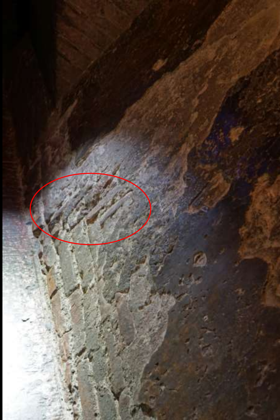
Florenz, Dom. „Spinapesce“-Mauerwerksverband in der Kuppelschale
