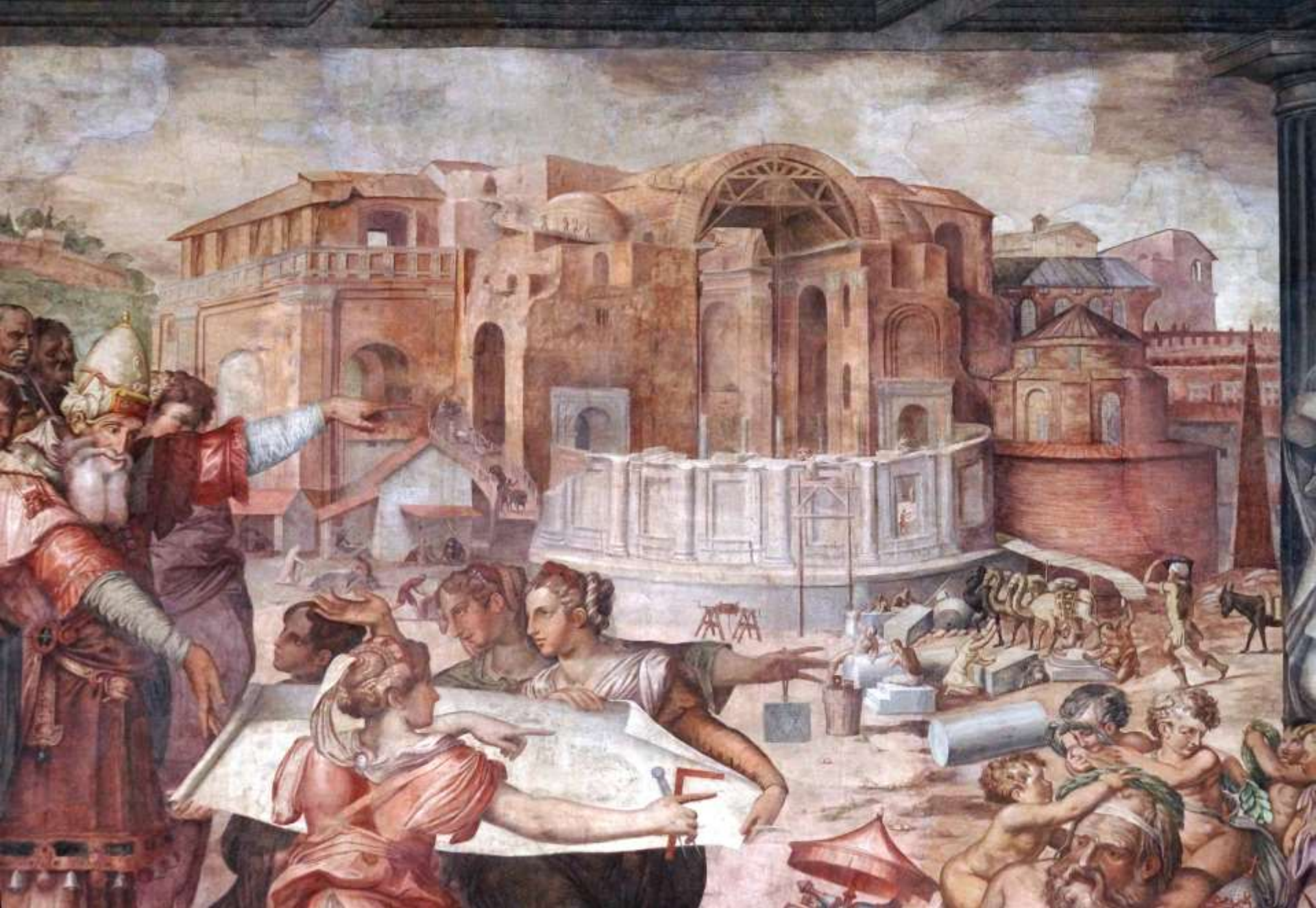
Rom, Petersdom, Baustelle, Einwölben des südlichen Kreuzarms unter Antonio da Sangallo d. J. um 1546 (Fresko von Giorgio Vasari, Palazzo della Cancelleria, Rom, 1546)
