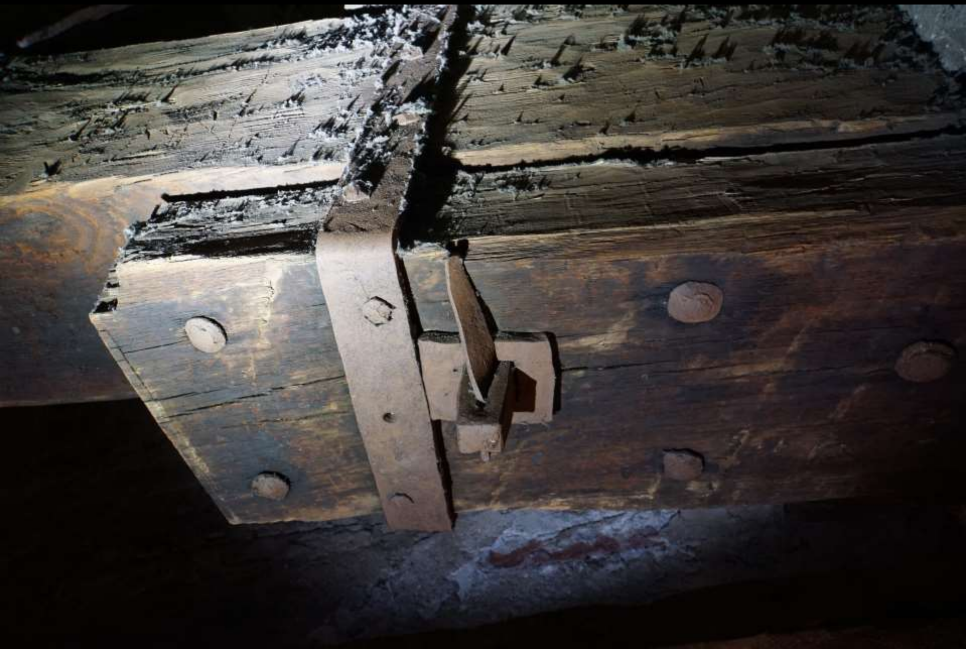
Florenz, Dom, Kuppel. Hölzerner Ringanker
