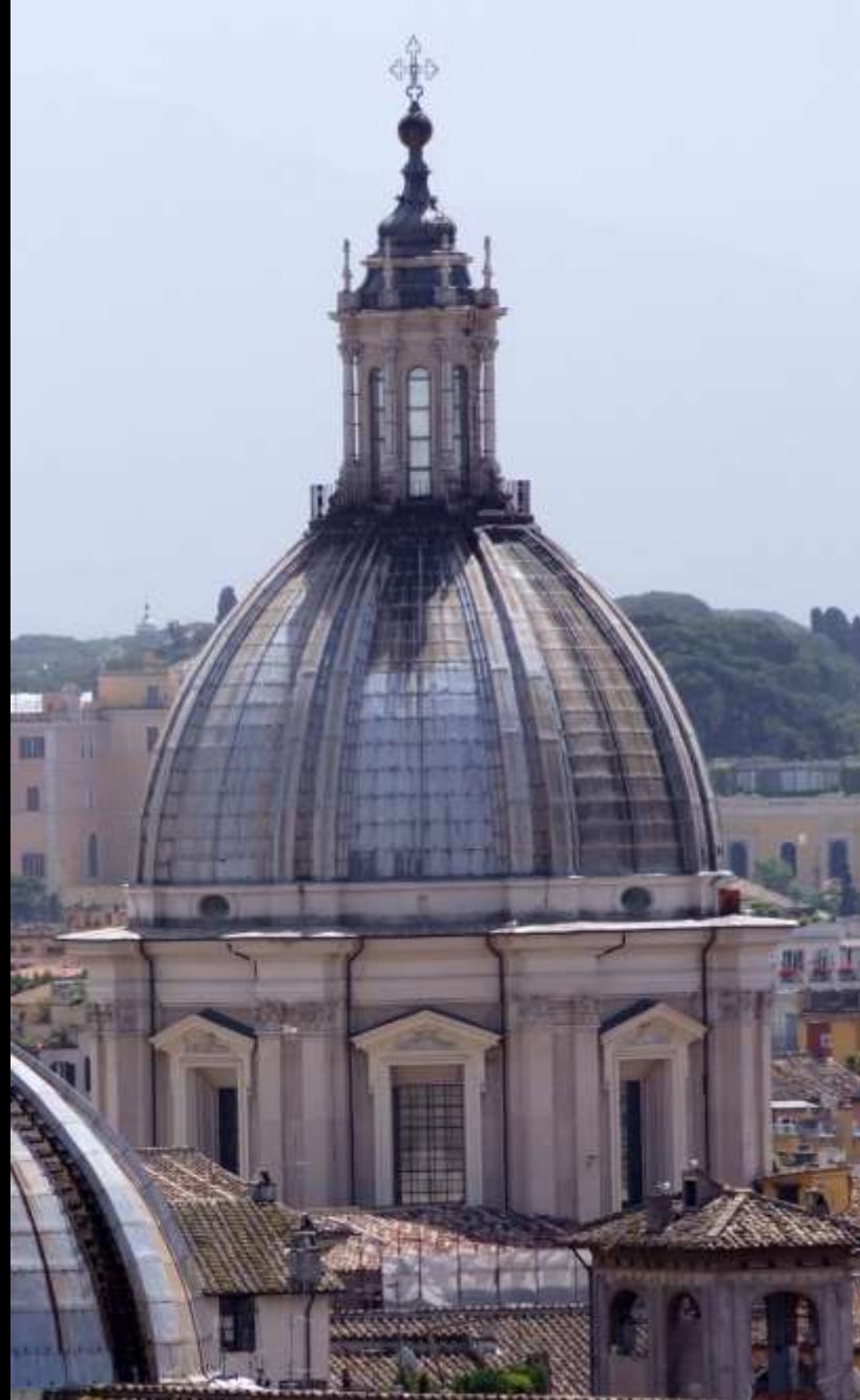
Rom, Sant'Agnese in Agone, Kuppel über hohem Tambour mit belichtetem Kuppelfuss (Kuppel ausgeführt 1653–57, Francesco Borromini)
