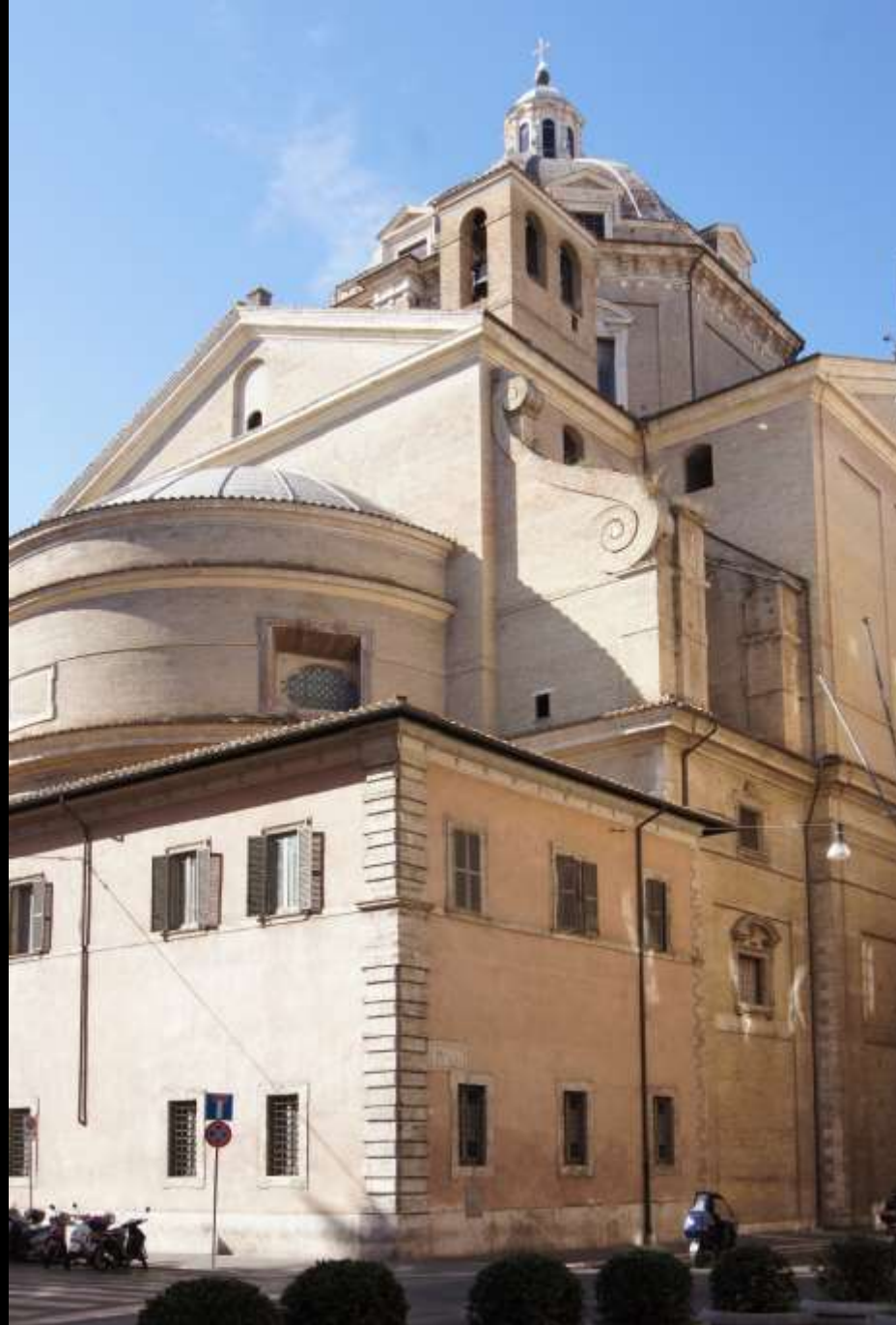
Rom, Chiesa del Gesù. Strebemauern des Tonnengewölbes am Chor.
