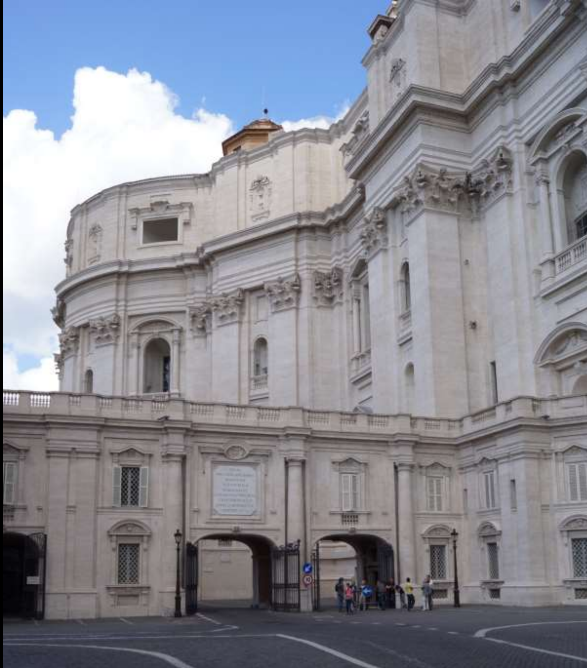
Rom, St. Peter, südlicher Querhausarm. Werksteinarchitektur Michelangelos aus Travertin von Tivoli.
