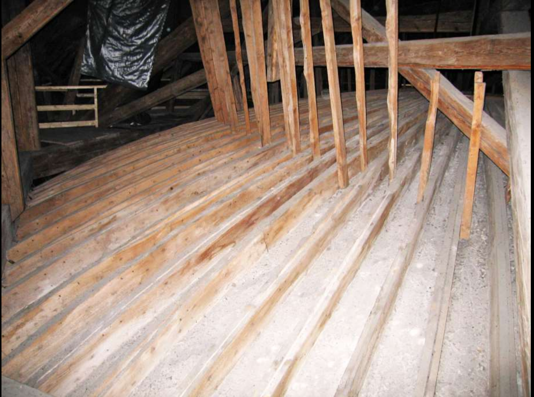
Ganz leichte Gewölbekonstruktion: Bohlenbogen-Latten-Gewölbe (Beispiele aus Bayern)
