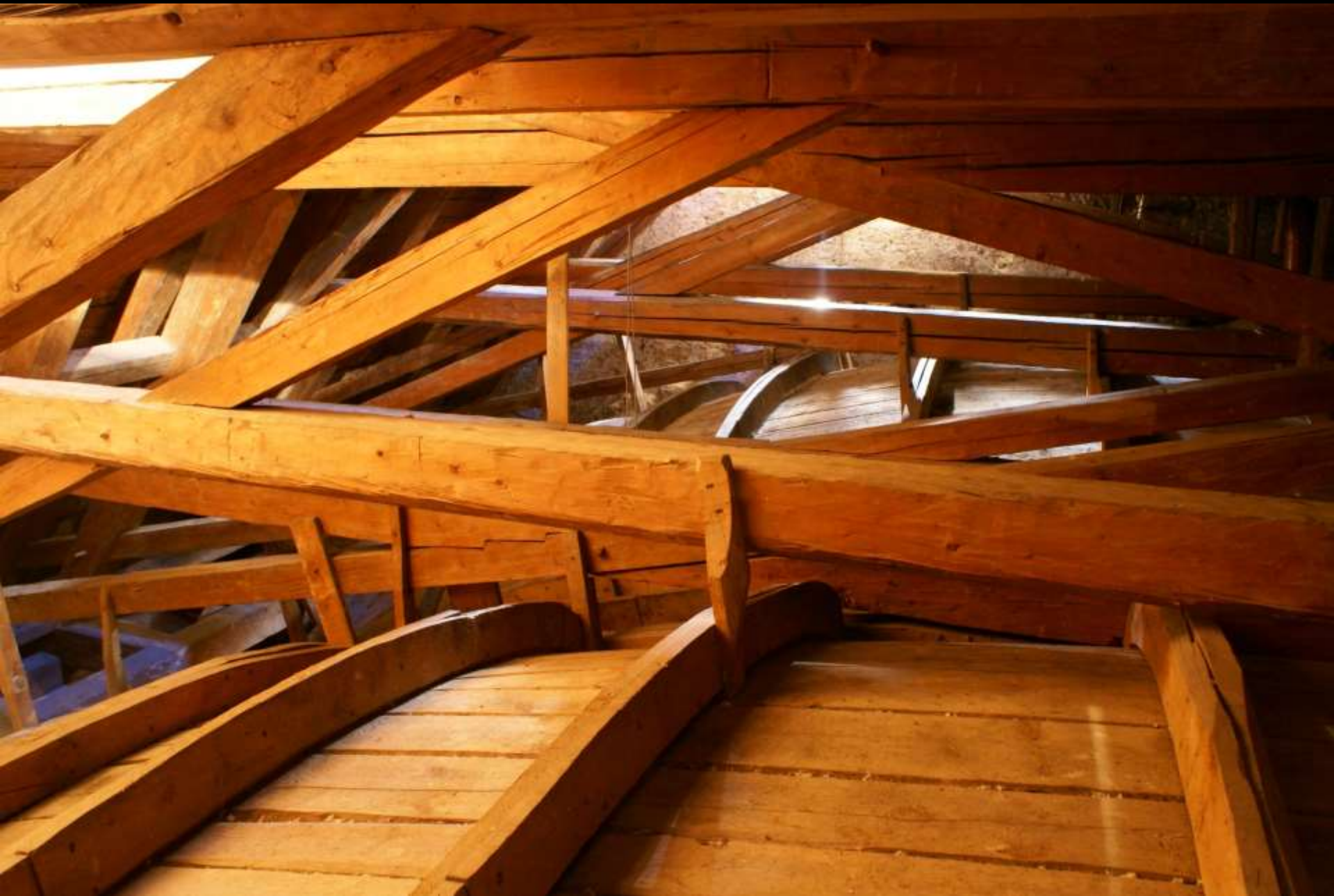
Garmisch, Pfarrkirche (1730–1733, Joseph Schmuzer). Am Dachwerk aufgehängte Holzgewölbe
