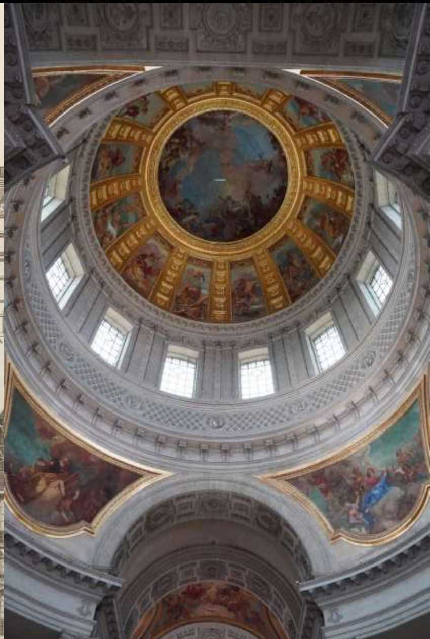
Paris, Invalidendom (1677–91, Jules Hardouin-Mansart; Stich: Blondel 1752). Innere Kuppel in Trommel bzw. Attika eingeschlossen, Aussenkuppel aus Holz
