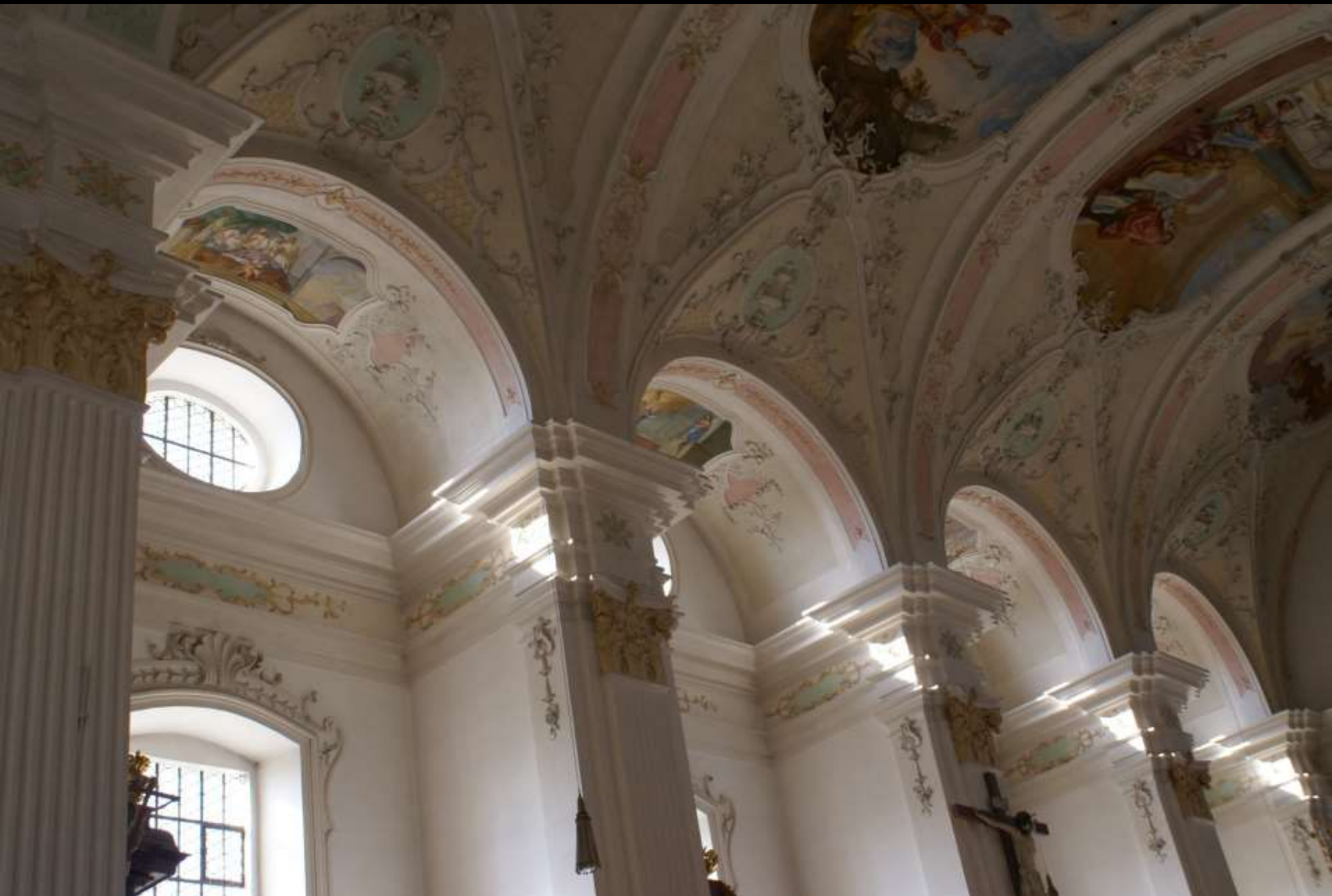
Weyarn, Stiftskirche. Tonnengewölbe des Mittelschiffs und Quertonnen der Wandpfeilerkapellen. (1687–93, Lorenzo Sciasca)
