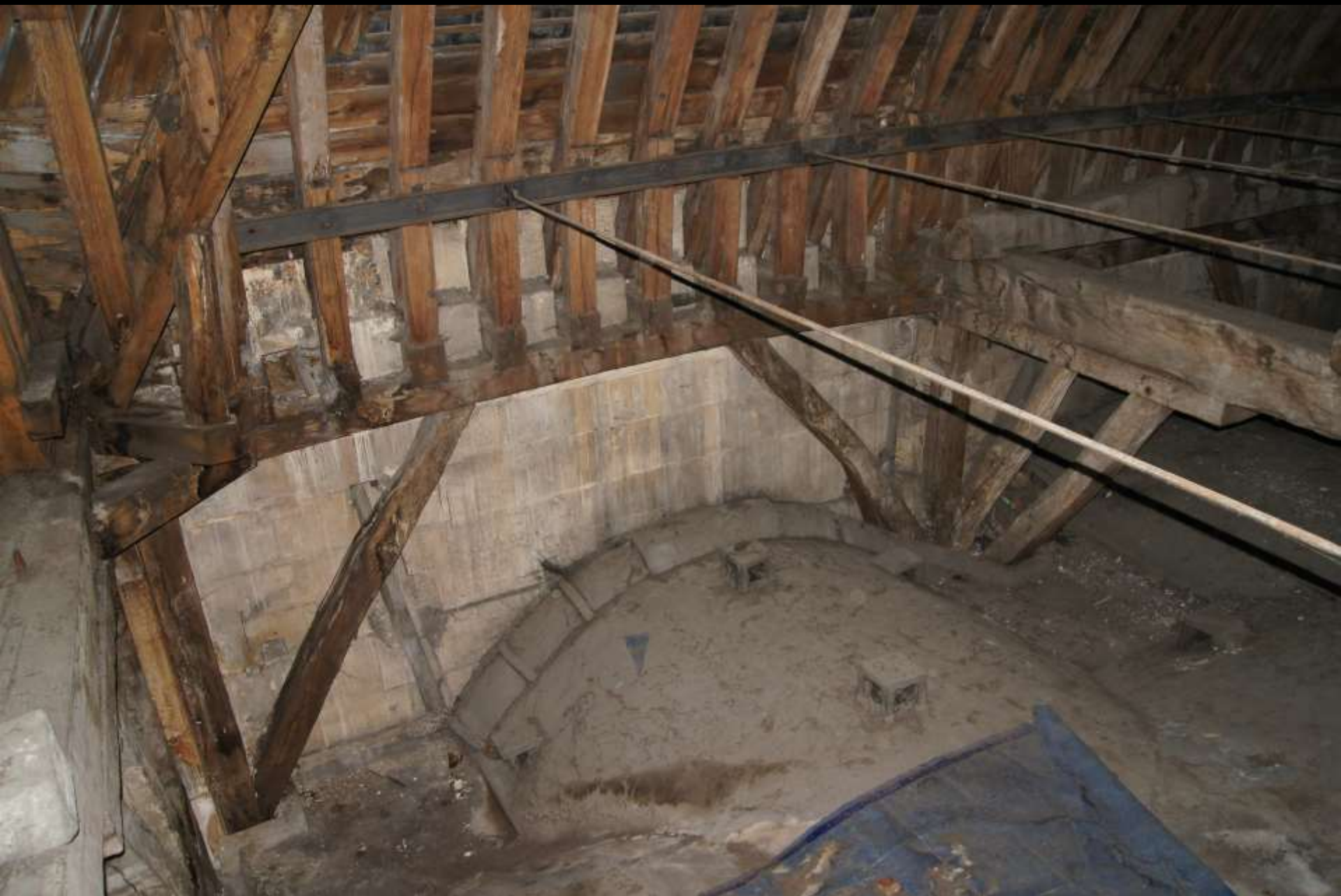
Versailles, Schlosskapelle, gemauerte Gewölbe von oben (Jules Hardouin-Mansart, 1698–1710)
