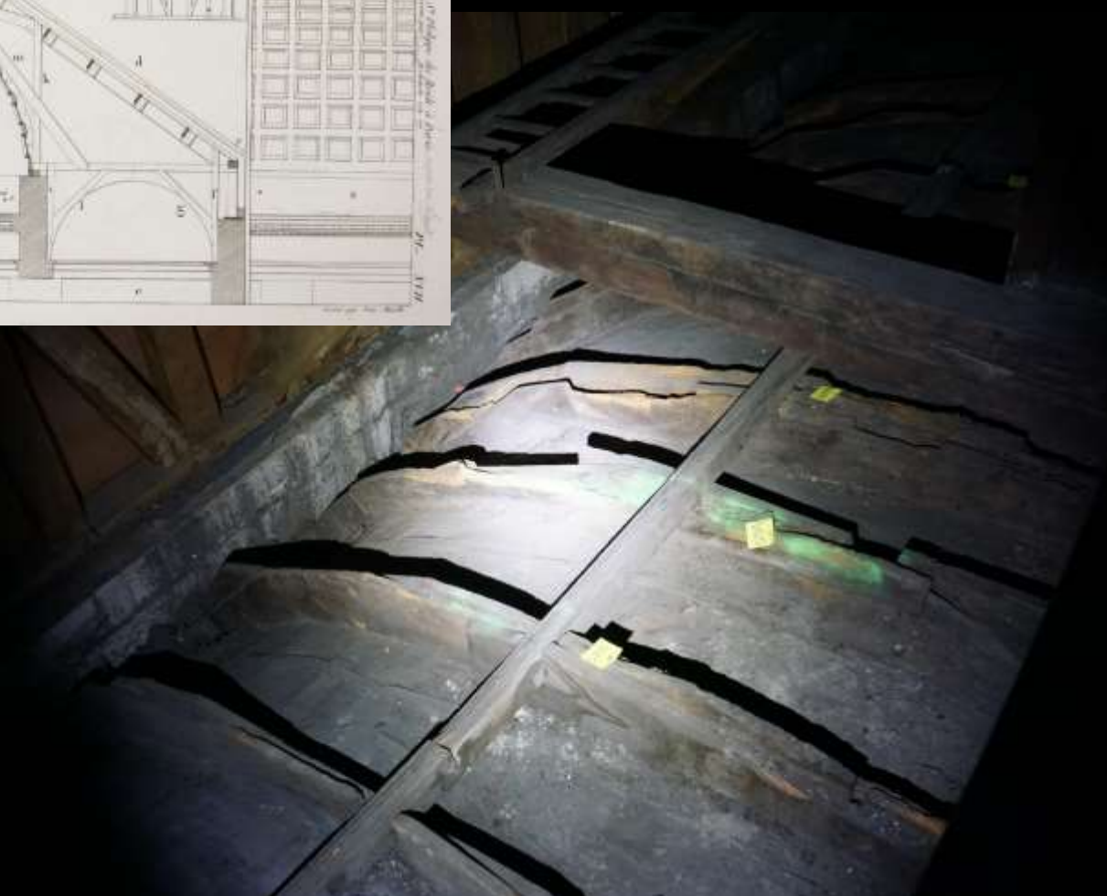
Paris, Saint-Philippe-du-Roule, Holzkonstruktion der Tonnengewölbe
