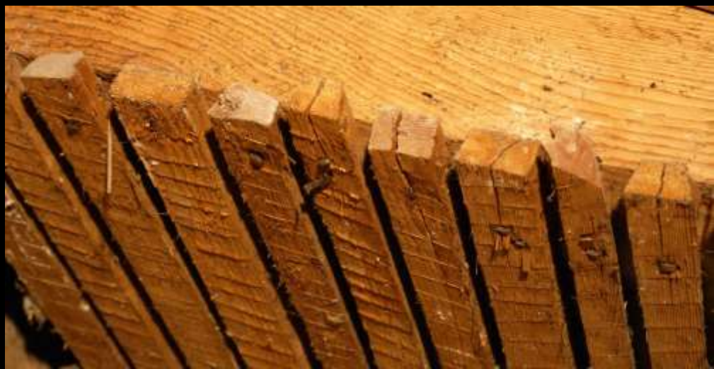
Ganz leichte Gewölbekonstruktion: Bohlenbogen-Latten-Gewölbe (Beispiele aus Bayern)
