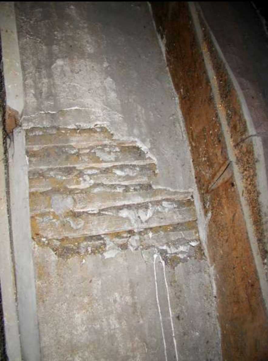
Ganz leichte Gewölbekonstruktion: Bohlenbogen-Latten-Gewölbe (Beispiele aus Bayern)
