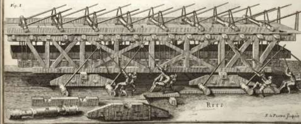
Paris, Louvre, Ostfassade, Maschinen zum Transport der Deckplatte (1674) (Abb.: Perrault 1684)
