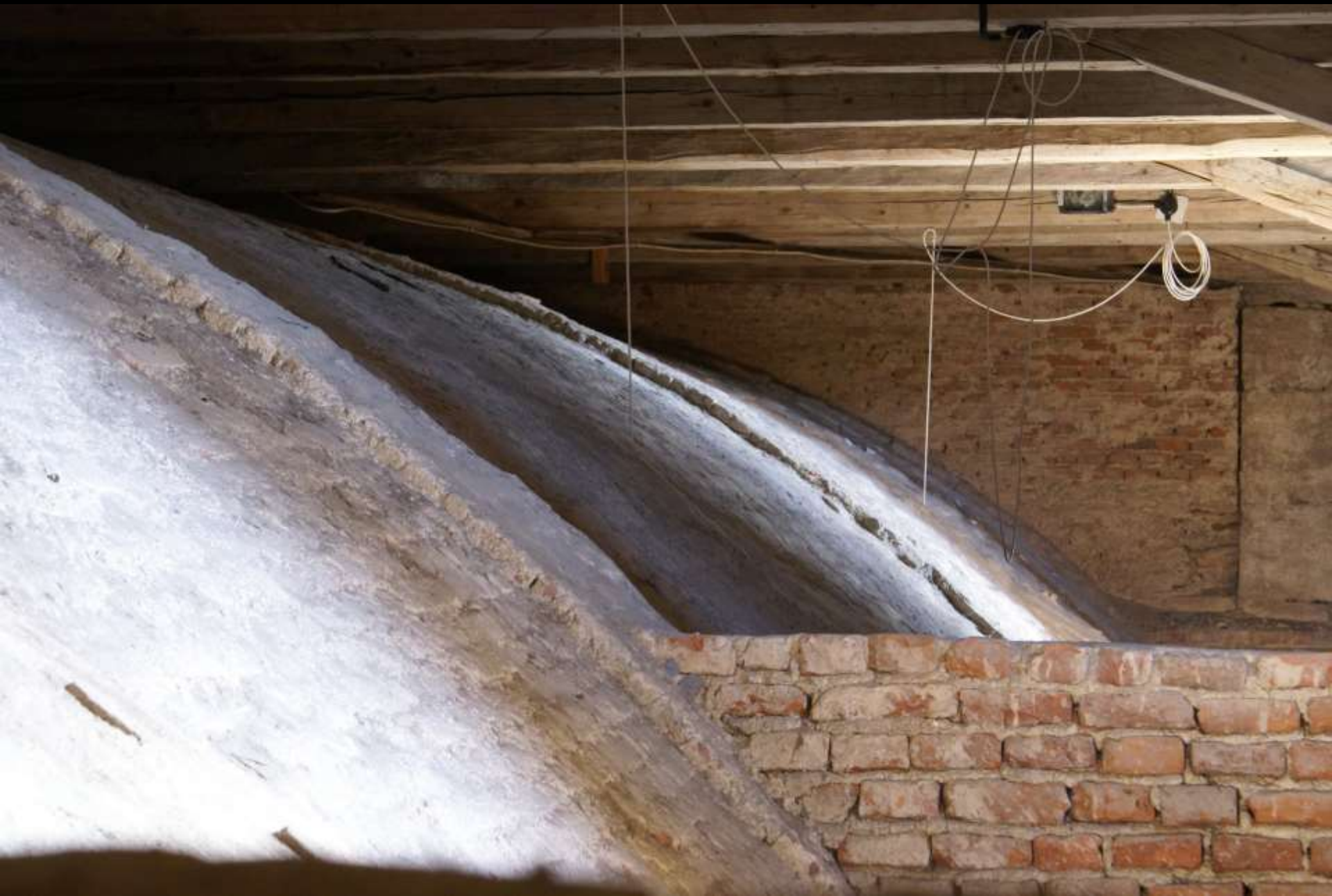
Weyarn, Stiftskirche. Tonnengewölbe des Mittelschiffs. (1687–93, Lorenzo Sciasca)
