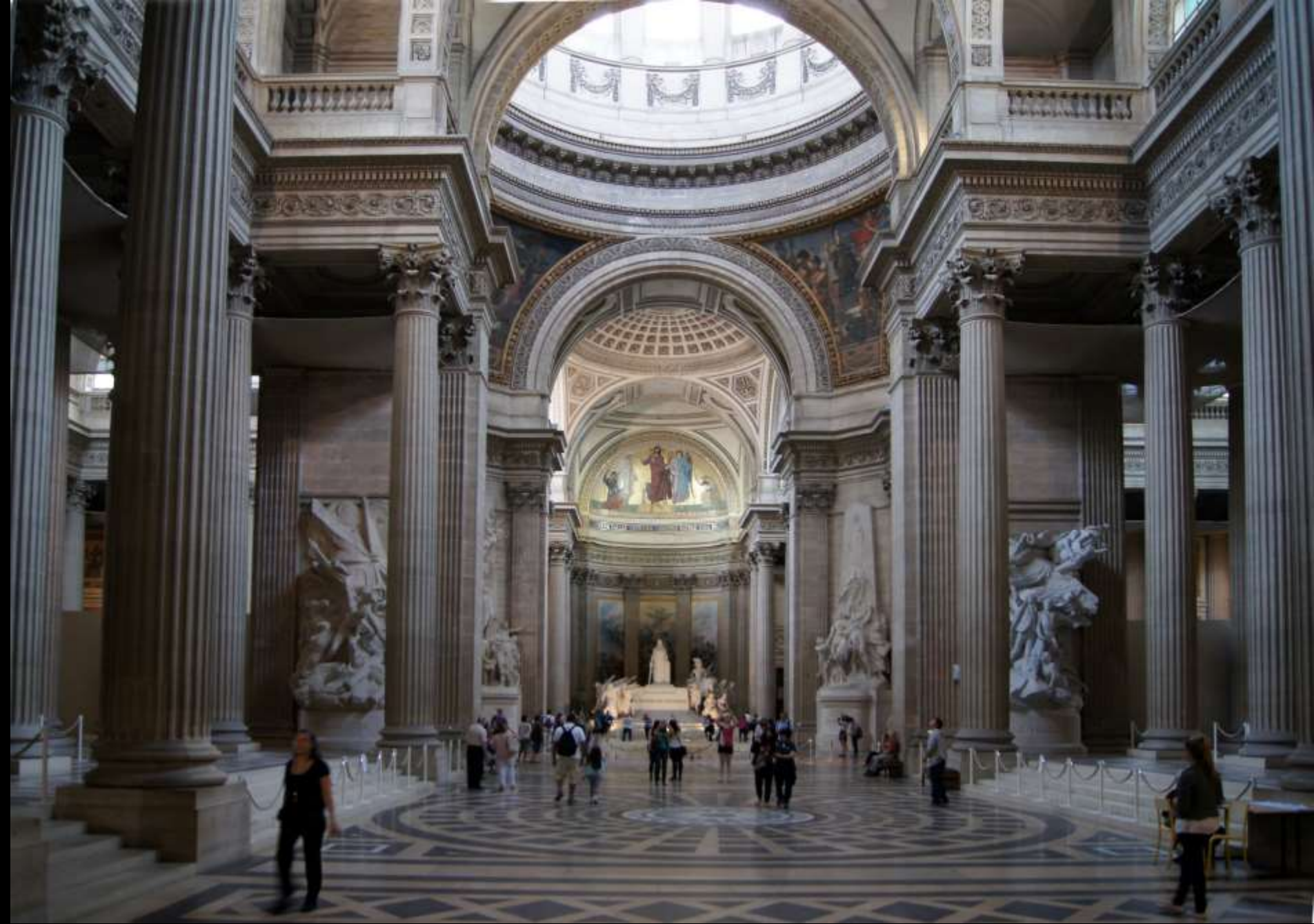
Paris, Sainte-Geneviève (heute Panthéon), Säulen-Architrav-Architektur des Inneren (Jacques-Germain Soufflot, 1764–90)
