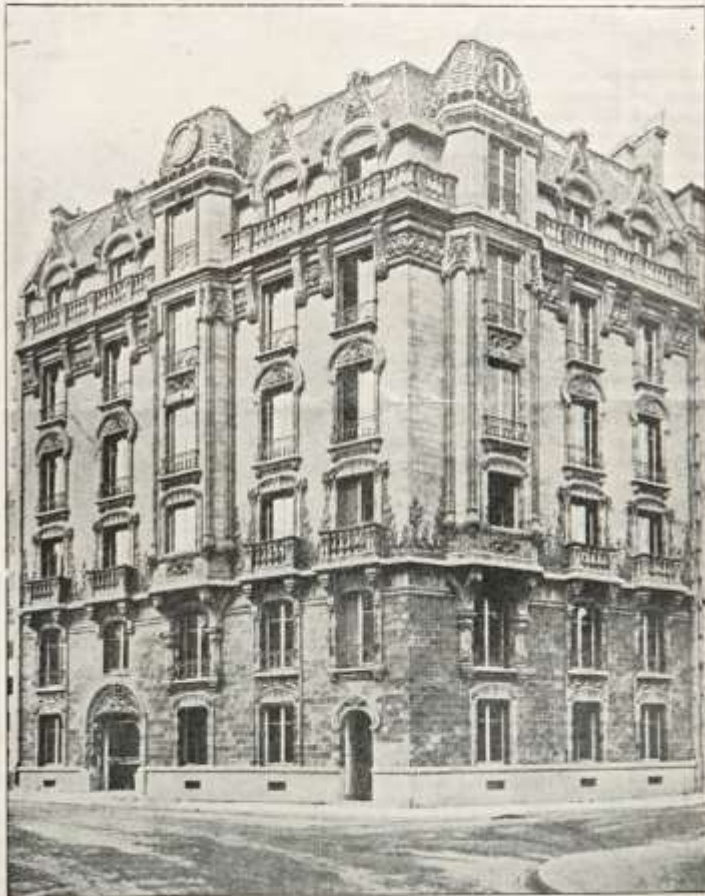
FIG. II. — Vue extérieure après achèvement.
