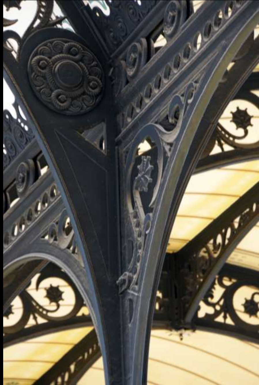
Paris, Bibliothèque Sainte-Genève (Henri Labrouste, 1850) Detail der Gusseisenkonstruktion
