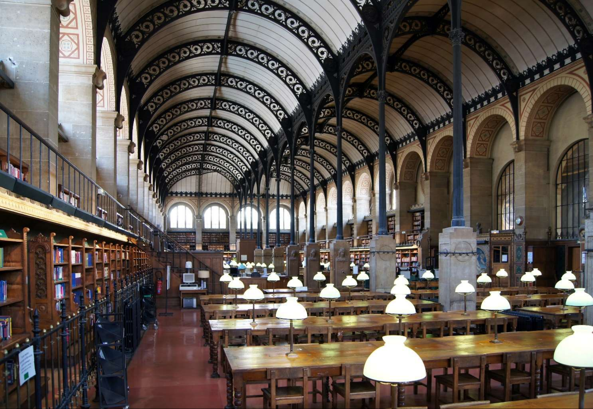
Paris, Bibliothèque Sainte-Genève (Henri Labrouste, 1850) Gestaltung der sichtbaren Konstruktion in Gusseisen
