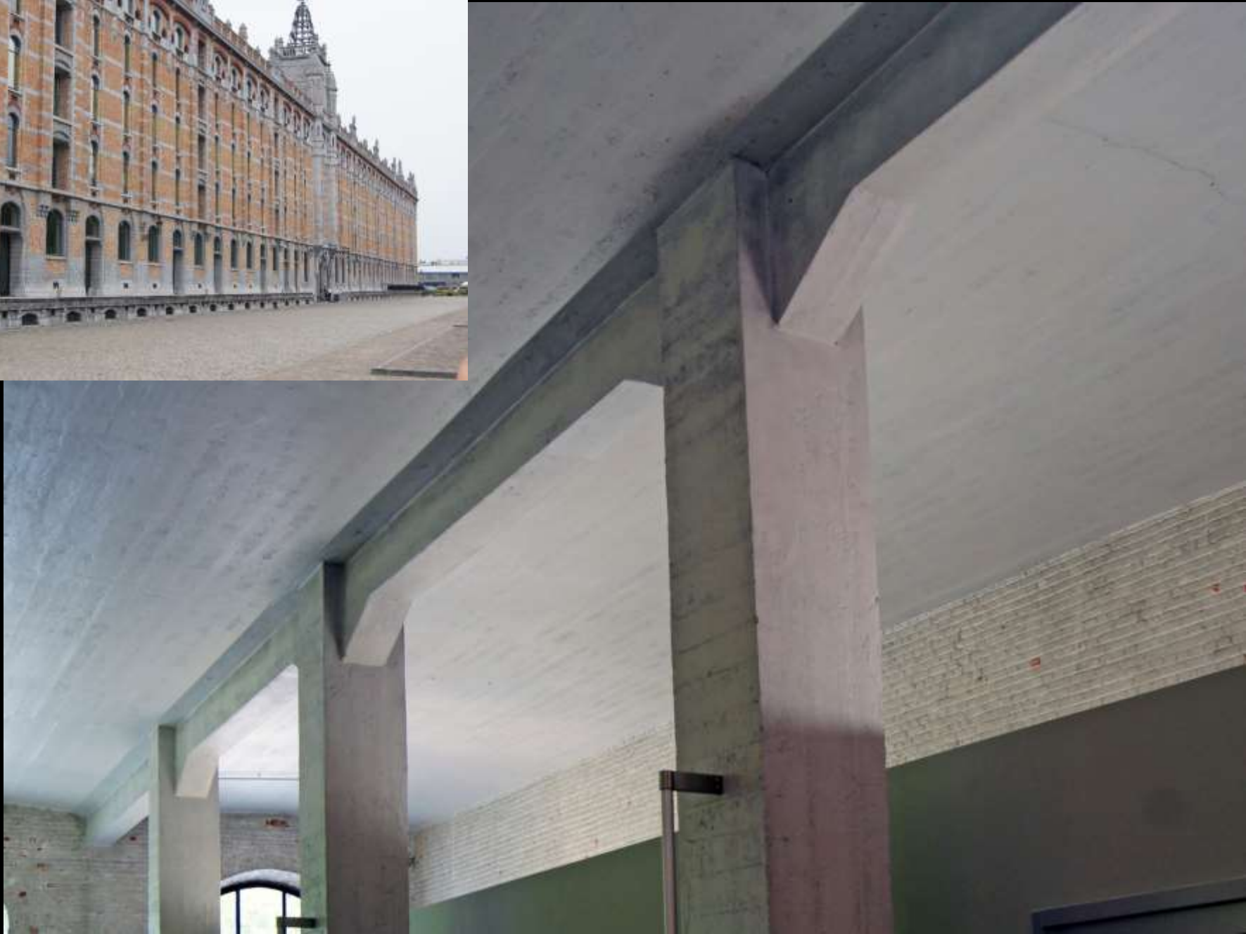
Hennebique: System Stütze-Unterzug-Platte Lagerhaus Thurn & Taxis, Brüssel (1904-06)
