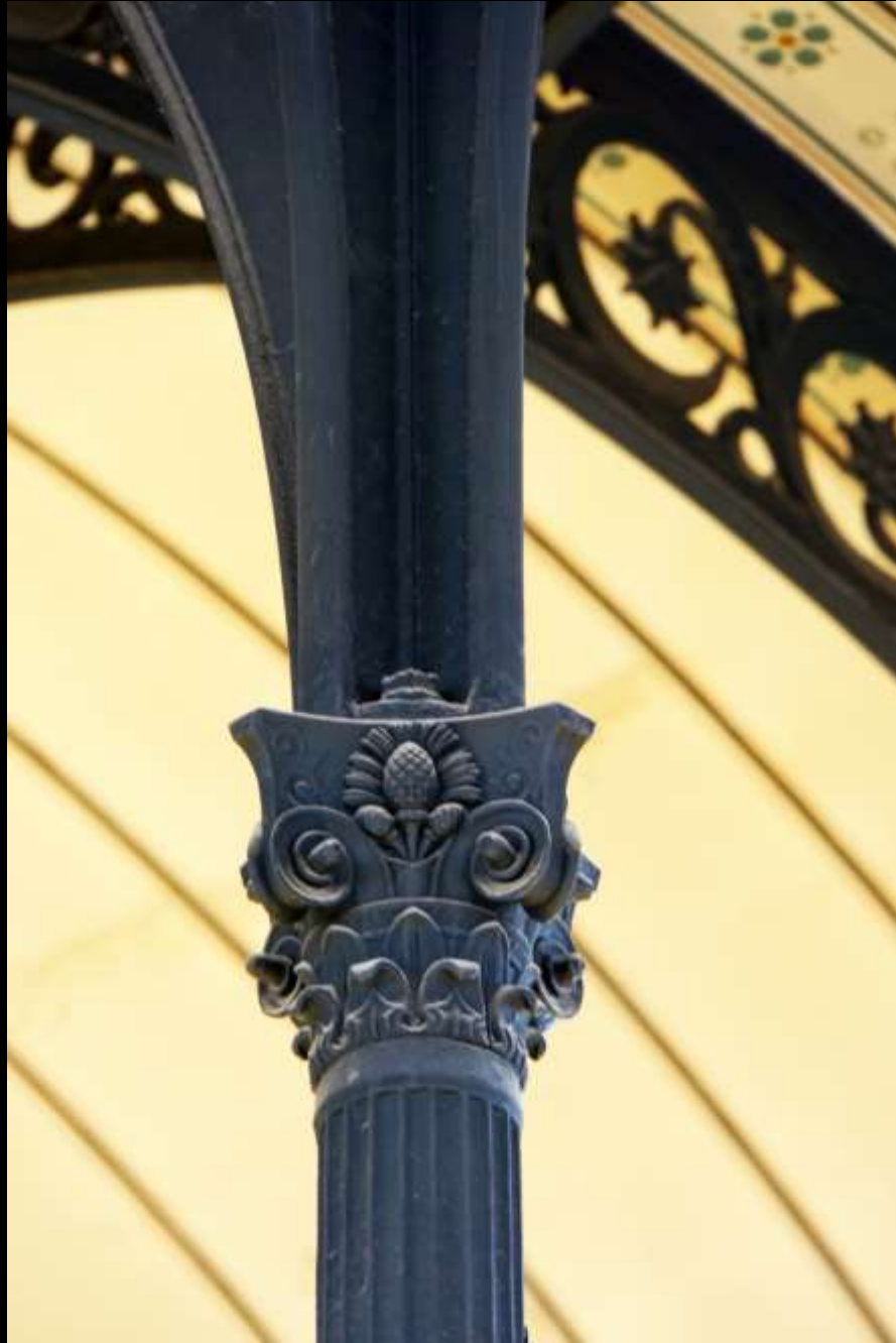
Paris, Bibliothèque Sainte-Genève (Henri Labrouste, 1850) Detail der Gusseisenkonstruktion
