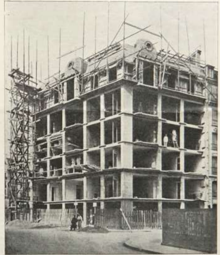
FIG. I. — Osature en Béton Armé.
