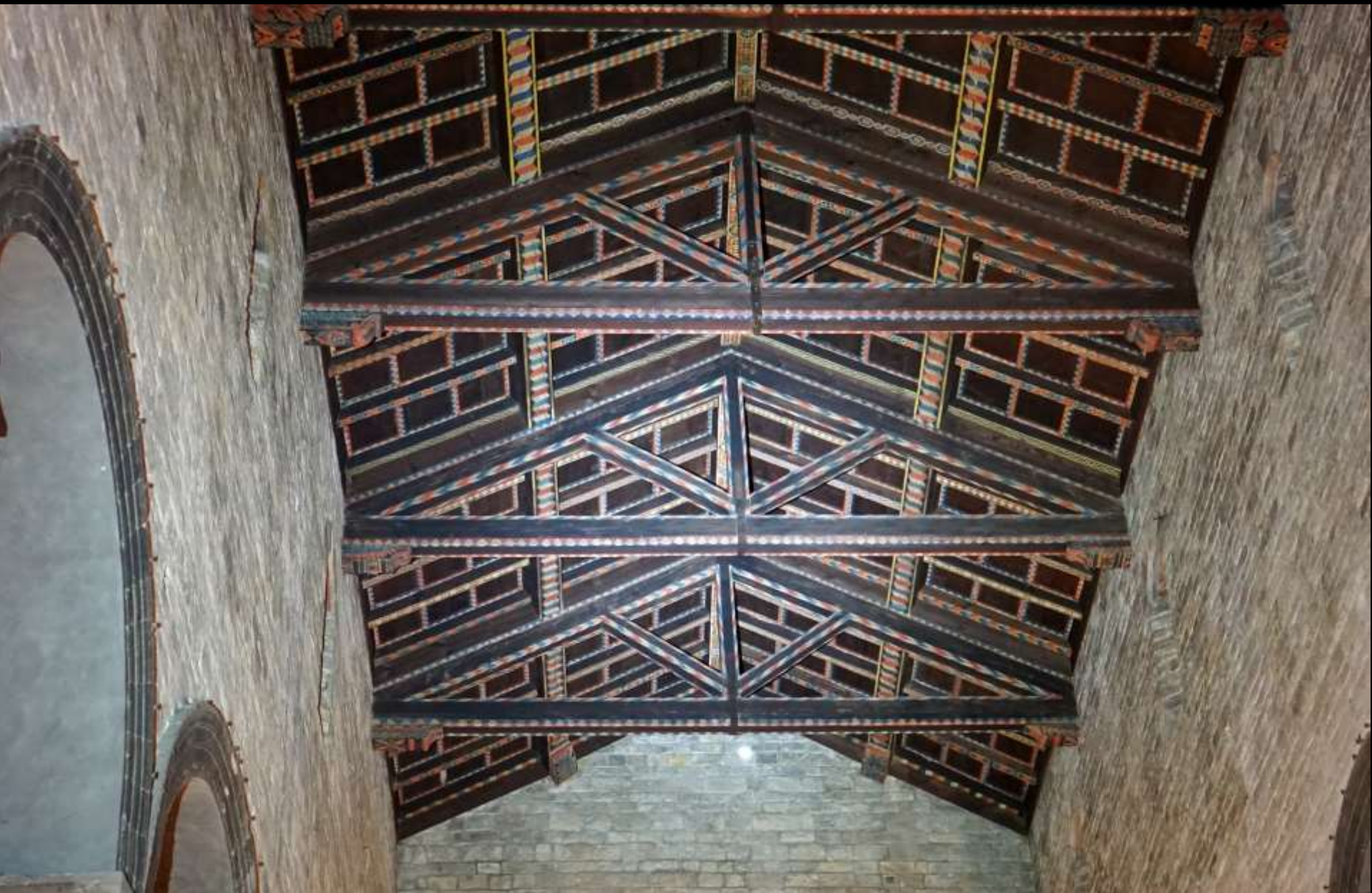
Pfeftendachbinder mit Spriessen (saette). Florenz, Santi Apostoli, 1333. „Hängesäule“ hängt nicht (nodo chiuso)
