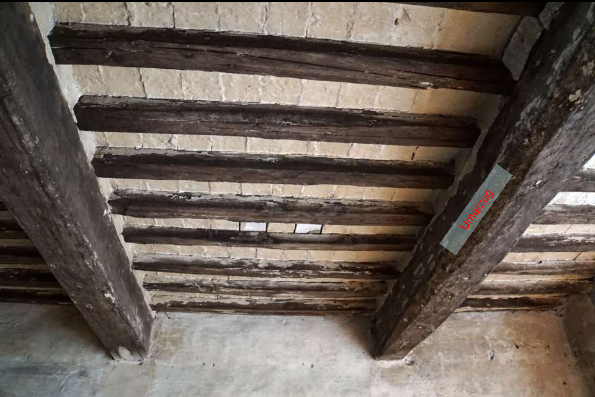
Balkendecke mit Unterzügen und Flachziegeln (frühneuzeitliche Balkendecke, Acquapendente)
