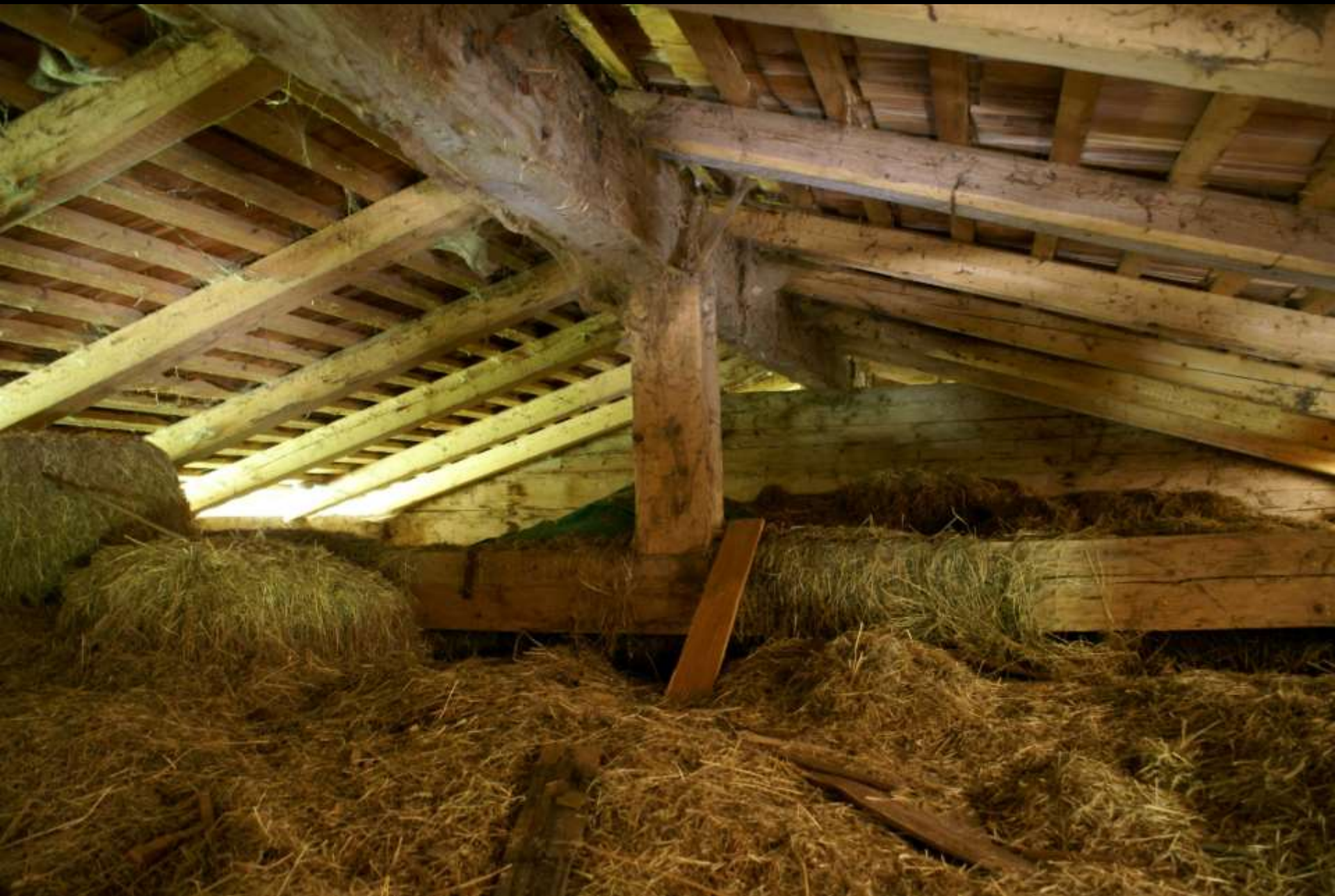
Pfettendach; Zwischenstützung der Firstpfette auf einem Balken und kurzen Ständer (Königsalm)
