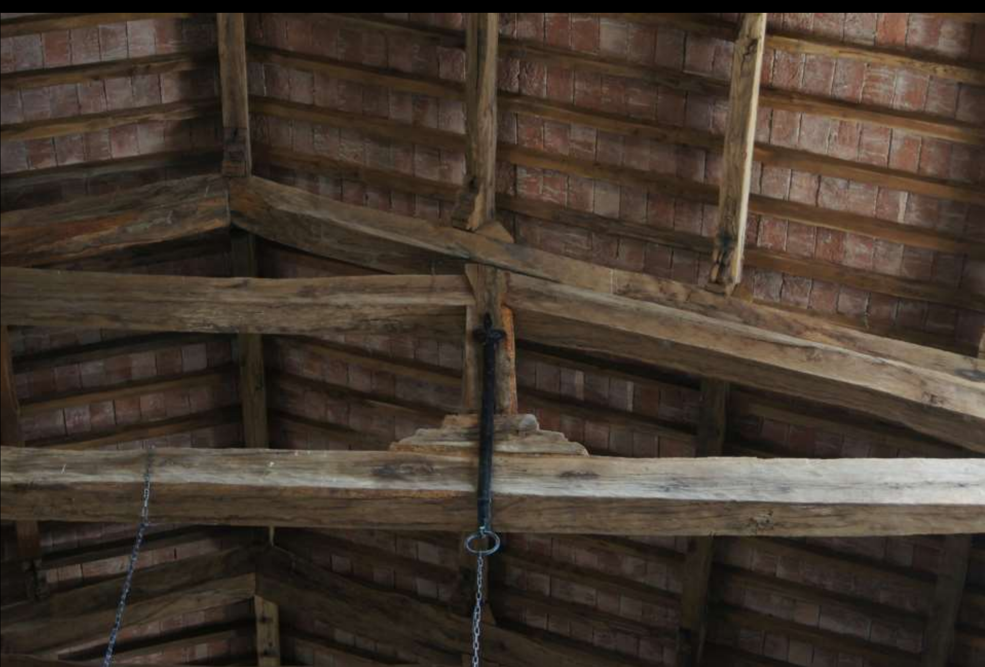
Canino (Latium), San Francesco (Ende 15. Jh.) Pfettendachbinder mit doppeltem Hängewerk und controcattena
