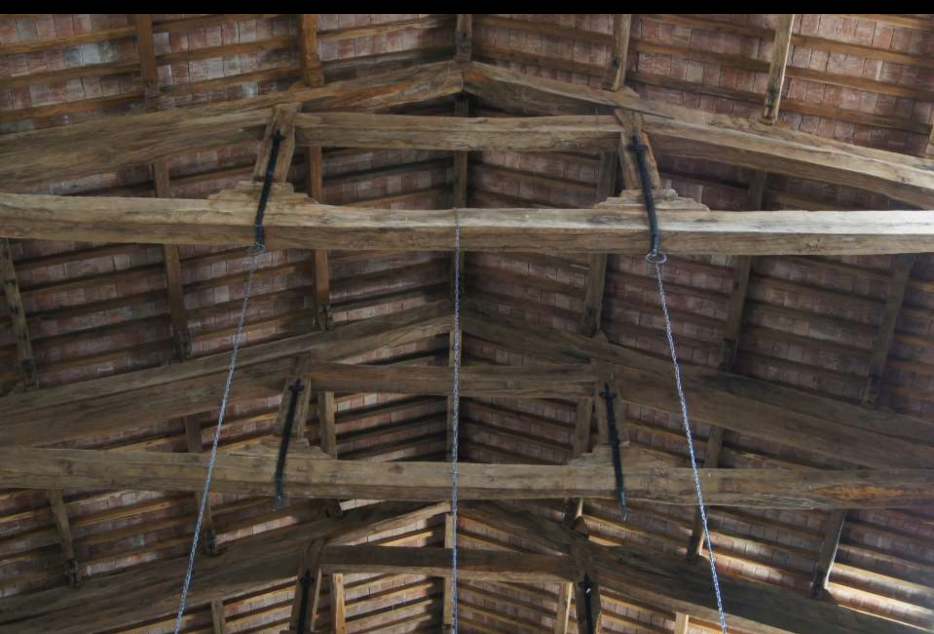
Canino (Latium), San Francesco (Ende 15. Jh.) Pfettendachbinder mit doppeltem Hängewerk und controcatena
