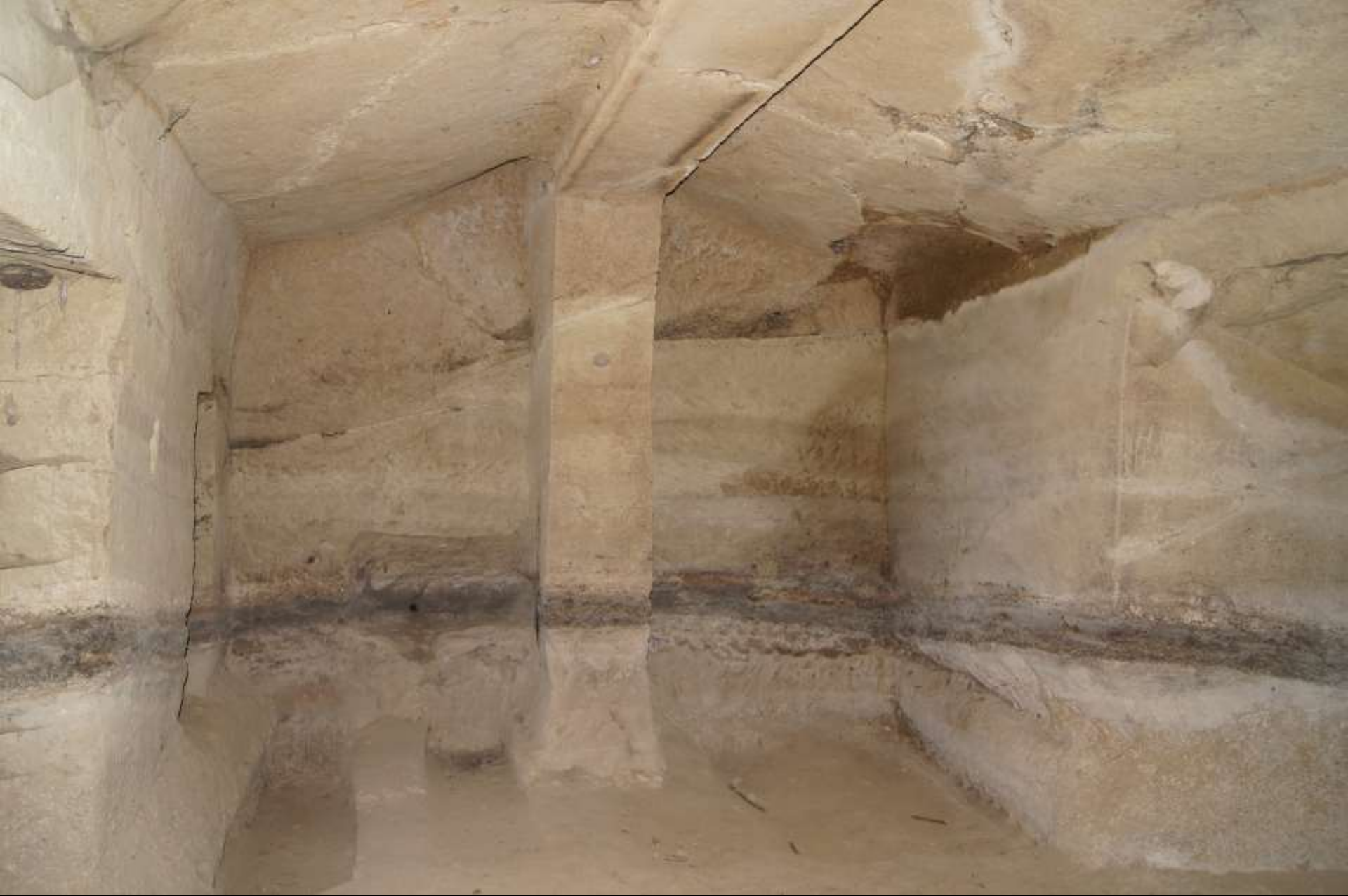
Stützung der Firstpfette durch einen Firstständer (etrusk. Grab, Necropoli di Pianezze, Grotte di Castro, Latium, 6. Jh. v. Chr.)
