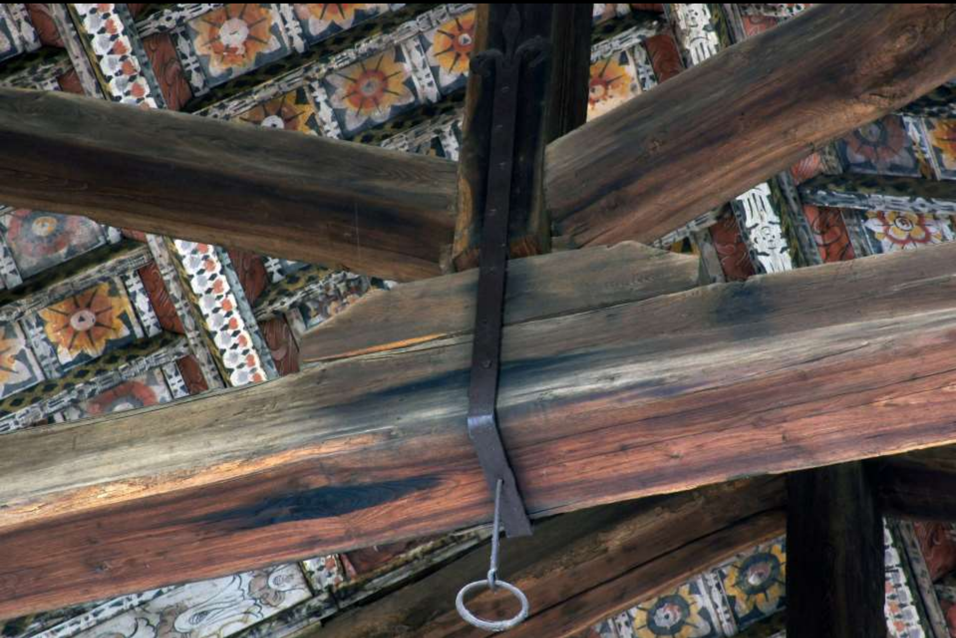
Viterbo, Santa Maria della Verità. „Nodo aperto“ am unteren Ende des monaco , Resultat des Wiederaufbaus
