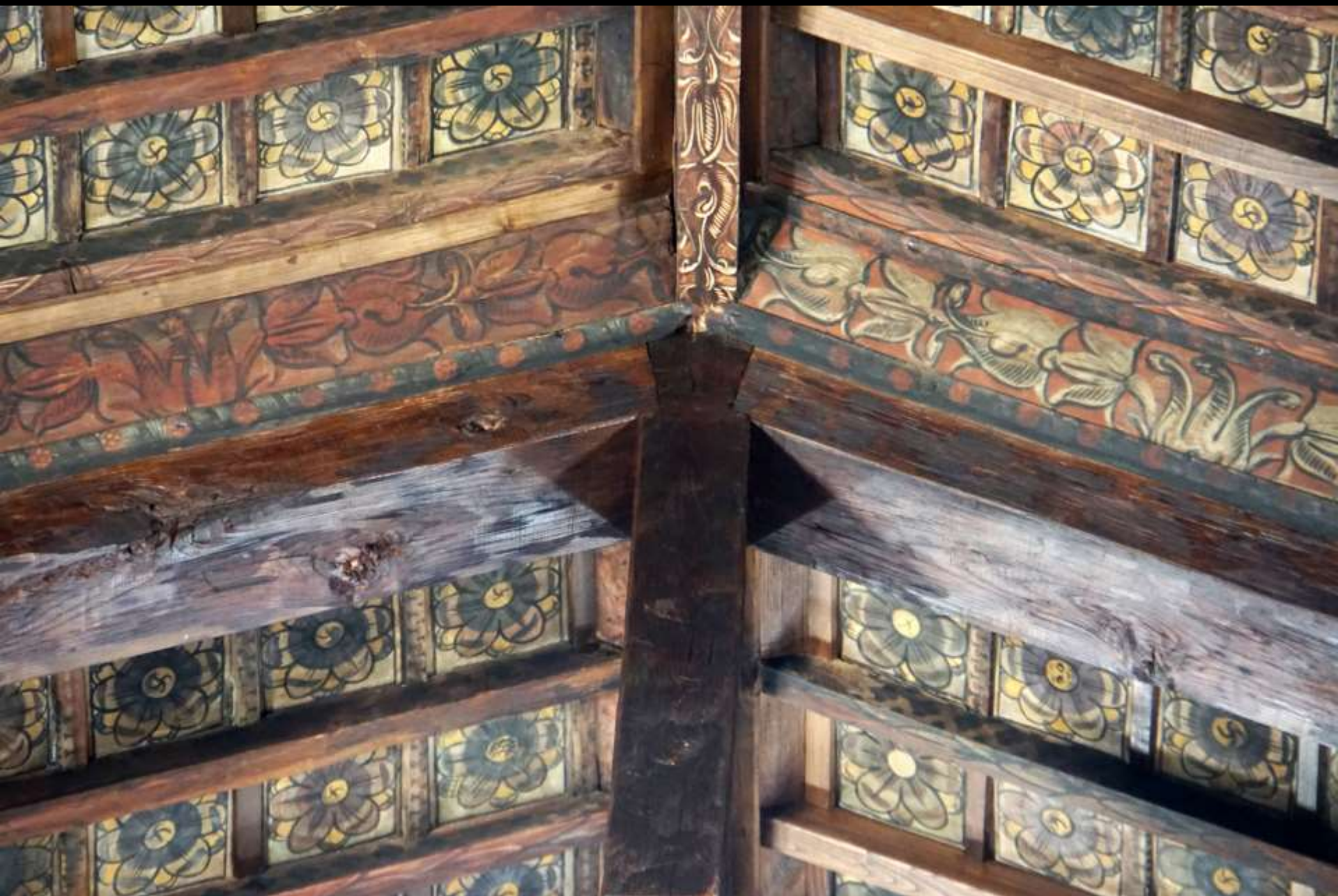
Pfettendachbinder einfachster Art (Viterbo, Santa Maria Nuova, 1460). Anschluss Hauptsparren-Hängesäule
