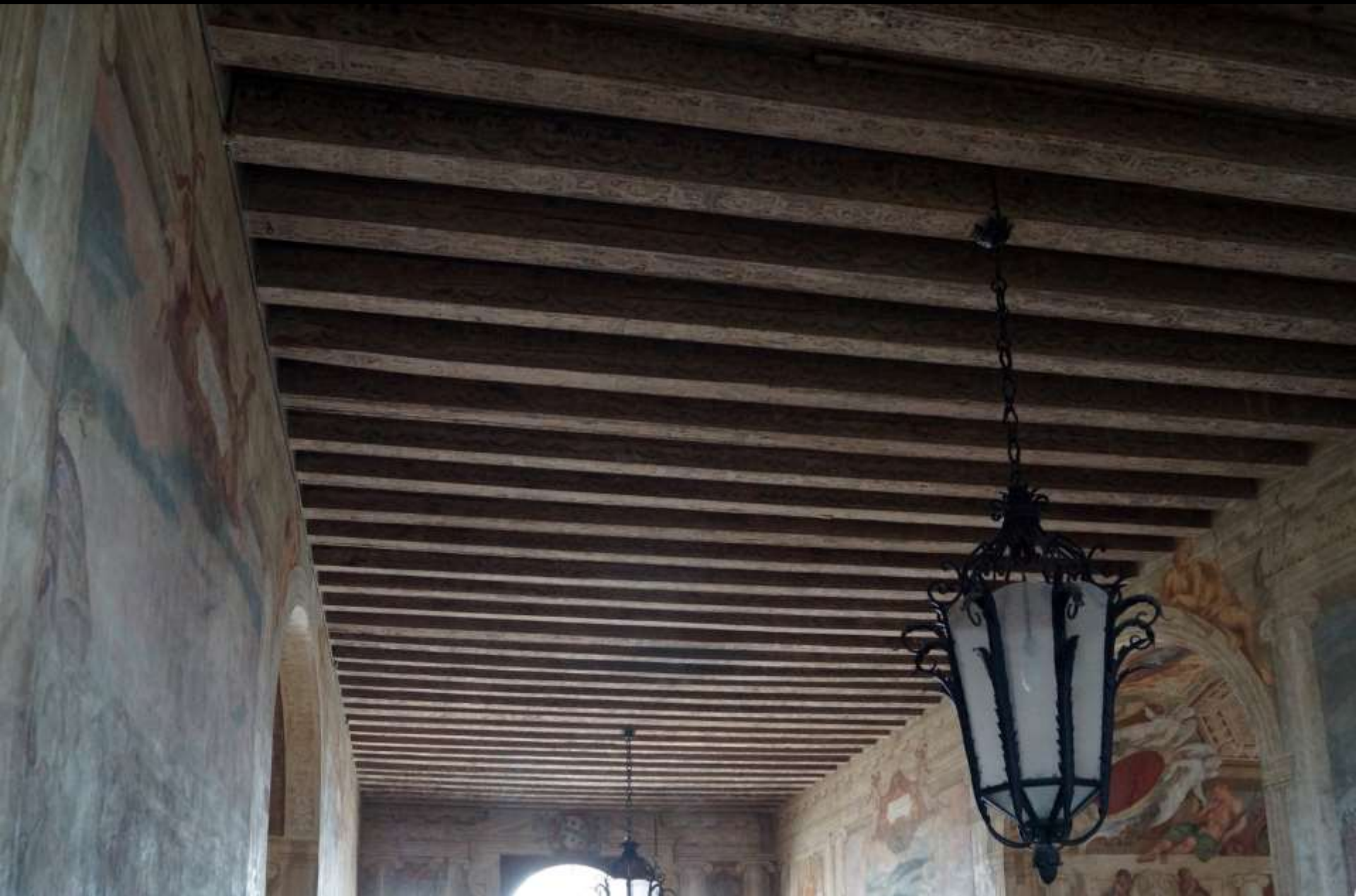
Balkendecke (Villa Barbarigo, Noventa Vicentina, spätes 16. Jh.)
