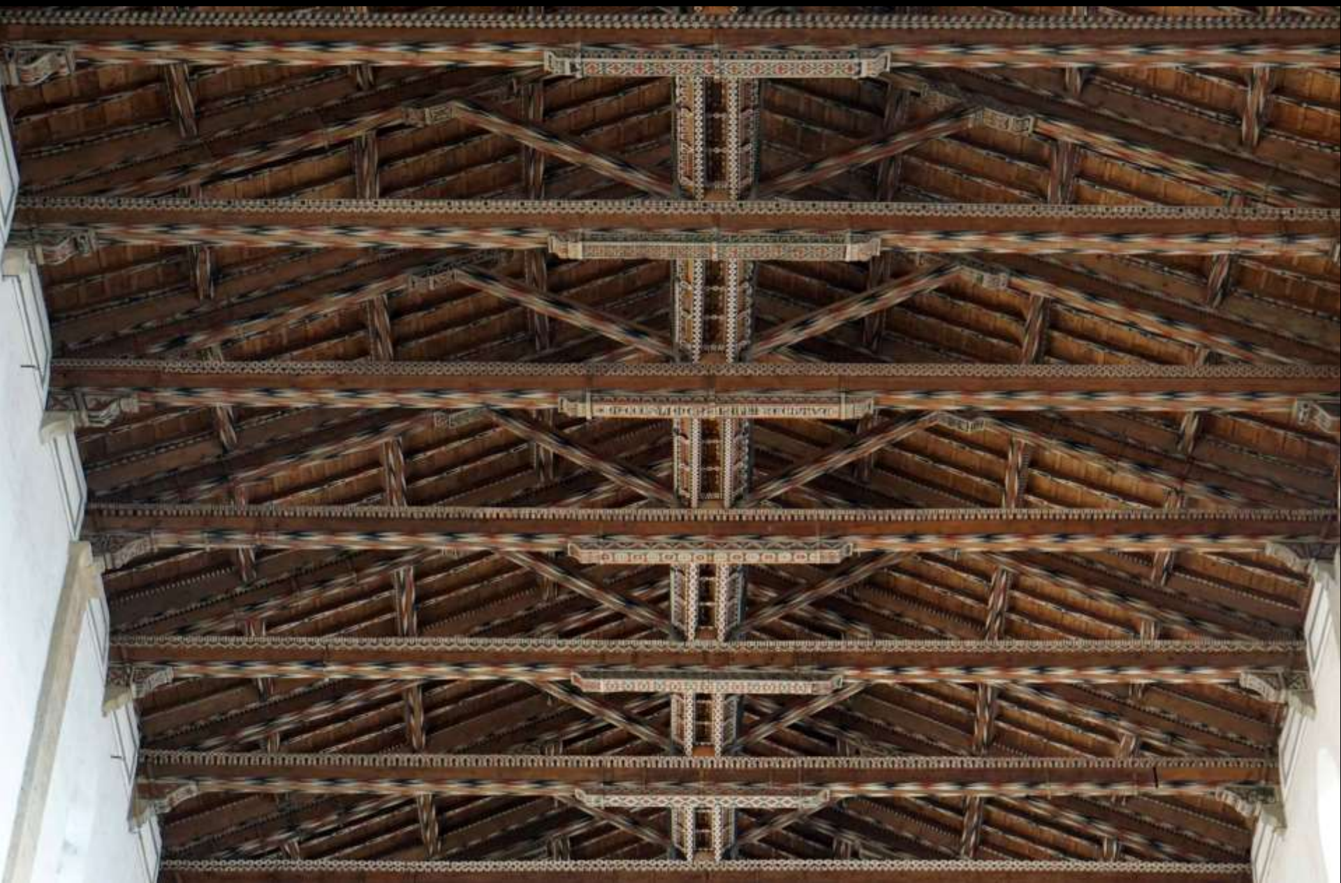
Florenz, Santa Croce, 1341 (i) und 1383 (i). Lichtweite 20 m. Zerrbalken mittig gestossen.
