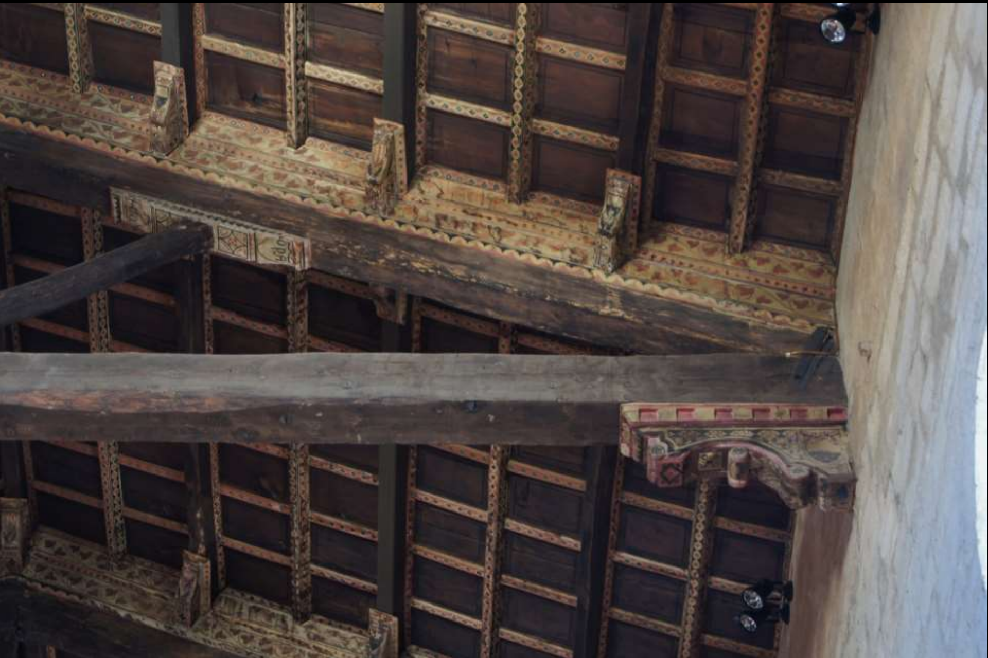
San Quirico d'Orcia, Stiftskirche (Dachwerk wohl 1733)
