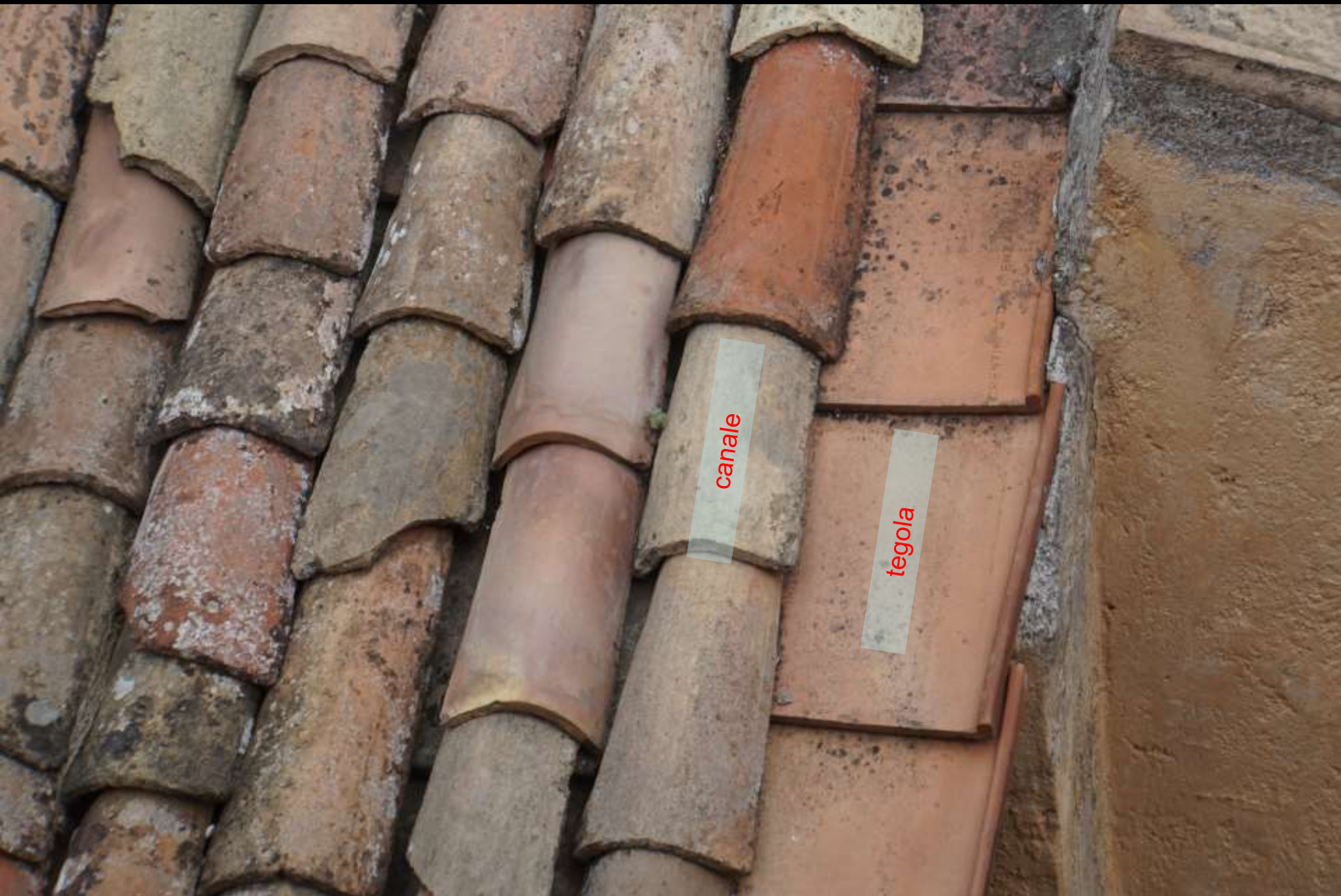
Römische Dachdeckung: tegole (Flachziegel) und canali (Mönch)
