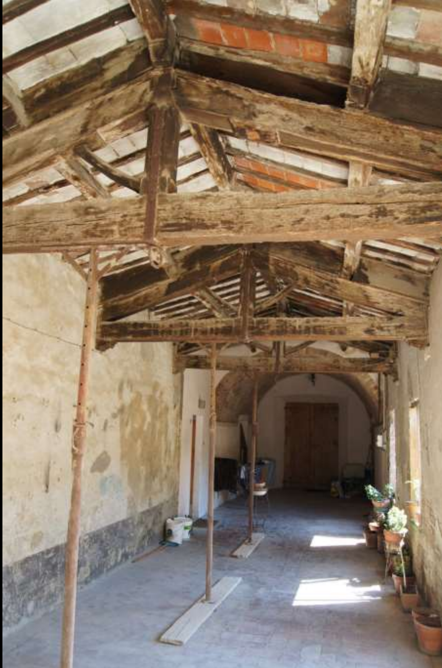
Einfache Hängewerksbinder (Ospedale Santa Maria della Scala, San Quirico d'Orcia, Toskana, wohl 15. Jh.)
