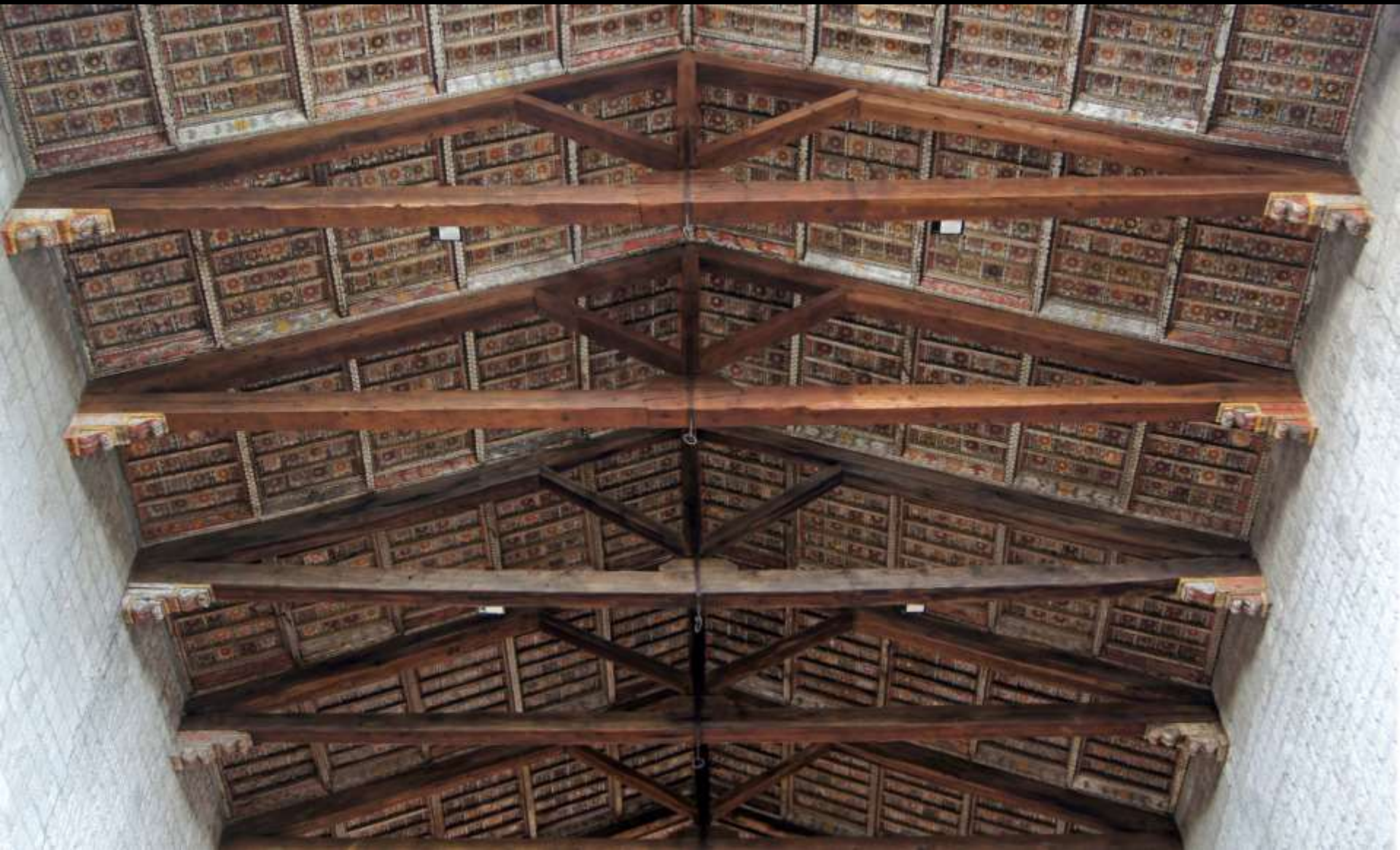
Viterbo, Santa Maria della Verità (1491; heutiger Zustand nach Kriegsbeschädigung und Wiederaufbau) alle in der Mitte gestossenen Bundbalken sind neu
