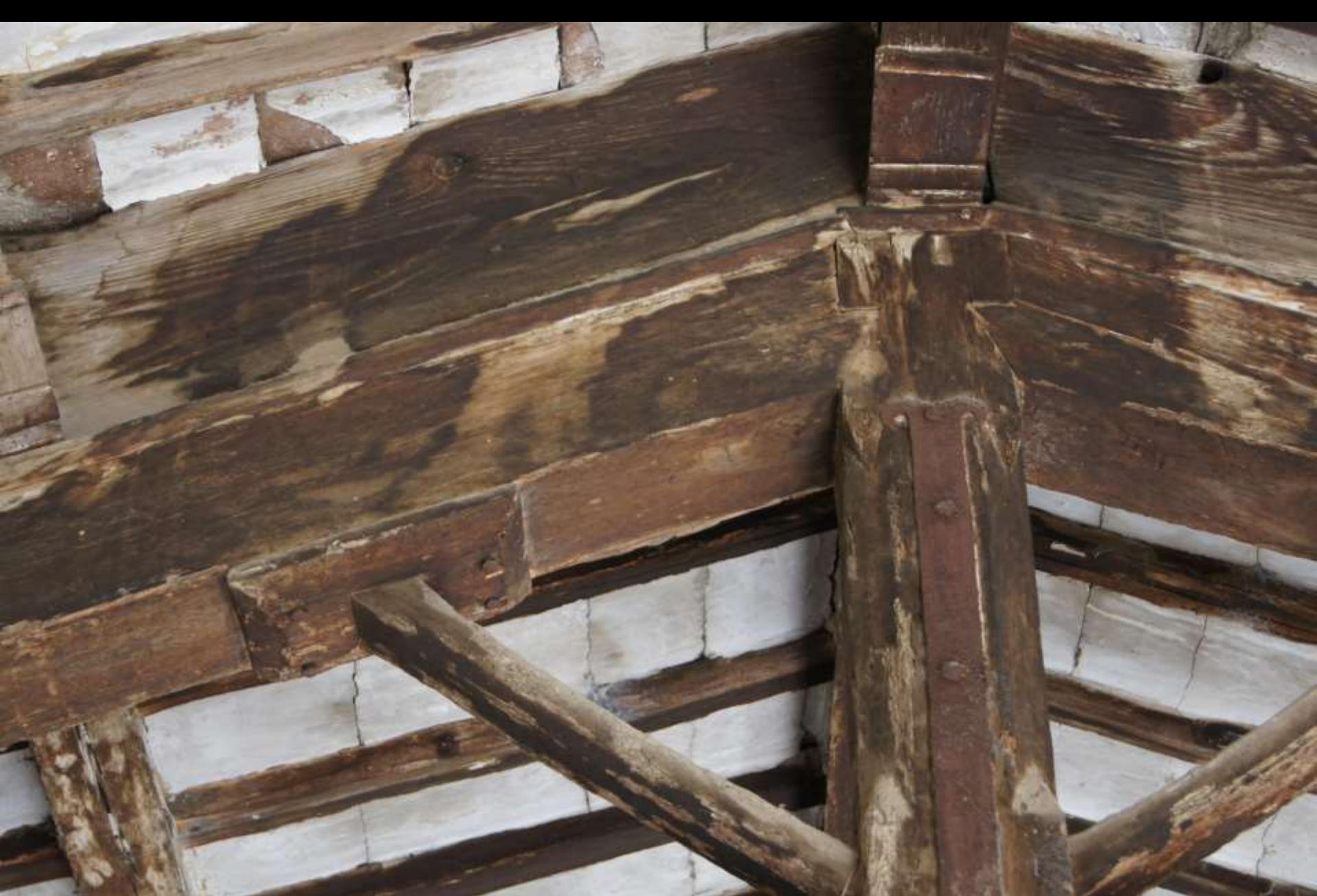
Firstknoten mit Fersenversatz (Ospedale Santa Maria della Scala, San Quirico d'Orcia, Toskana, wohl 15. Jh.)
