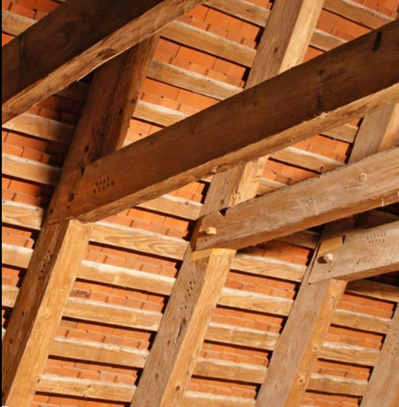
Dachwerk der Abteikirche Salem (frühes 14. Jh.): Anschluss der Kehlbalken mit Hakenblatt
