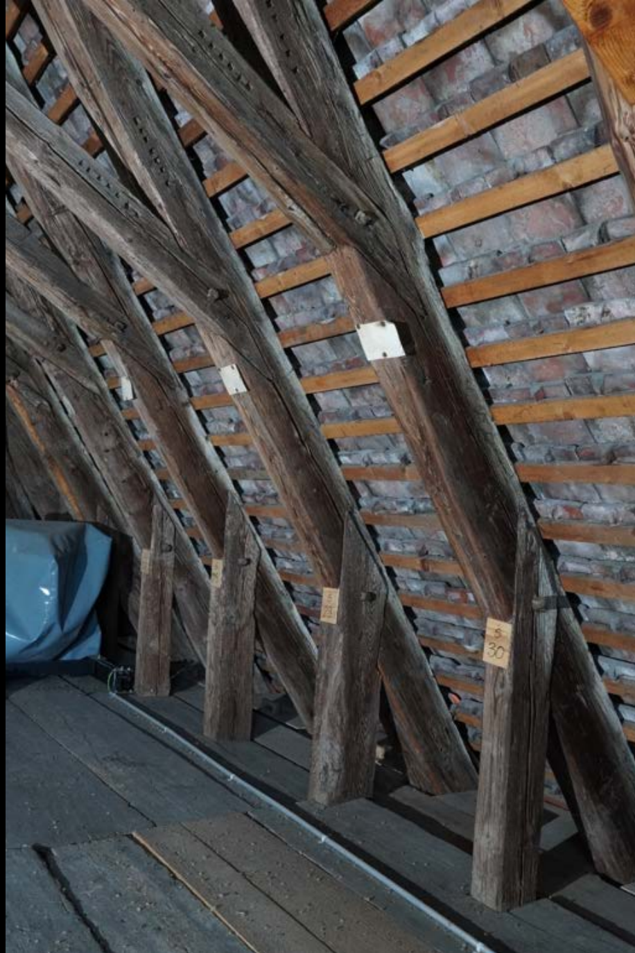
Kreuzstrebandach (Klosterkirche Königsfelden bei Windisch AG, 1315d). Sparrenknechte
