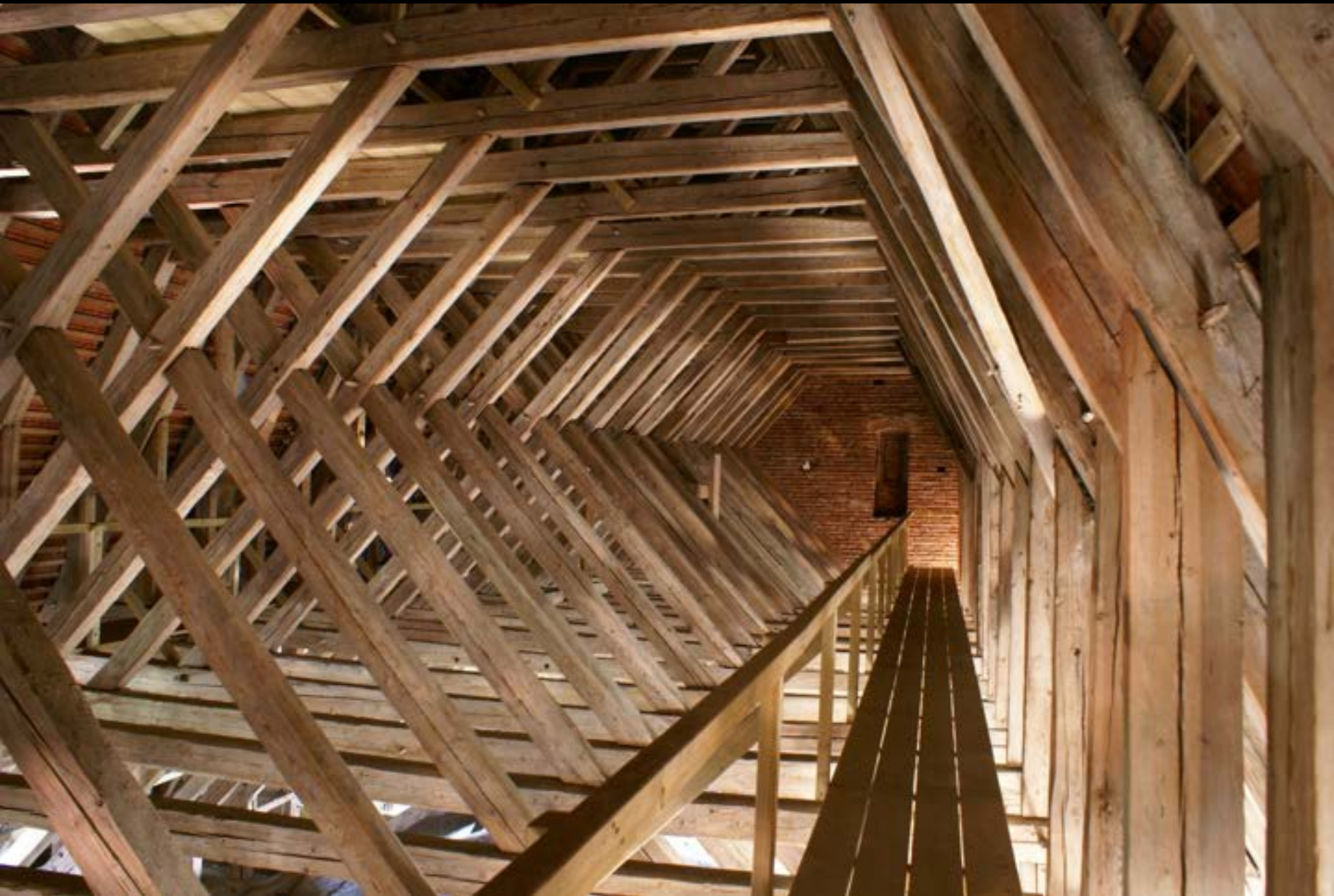
München, Maria Ramersdorf, Langhausdach (14. Jh.)
