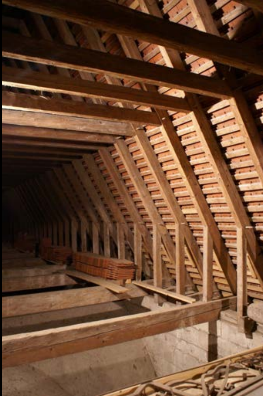
Dachwerk der Abteikirche Salem (frühes 14. Jh.). Nur jeder 3. Zerrbalken geht durch!
