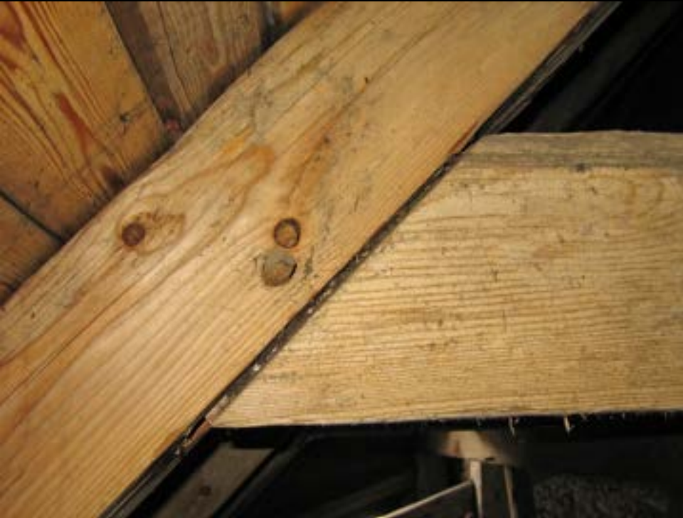
typische Situation am schrägen Zapfen Kehlbalken - Sparren
