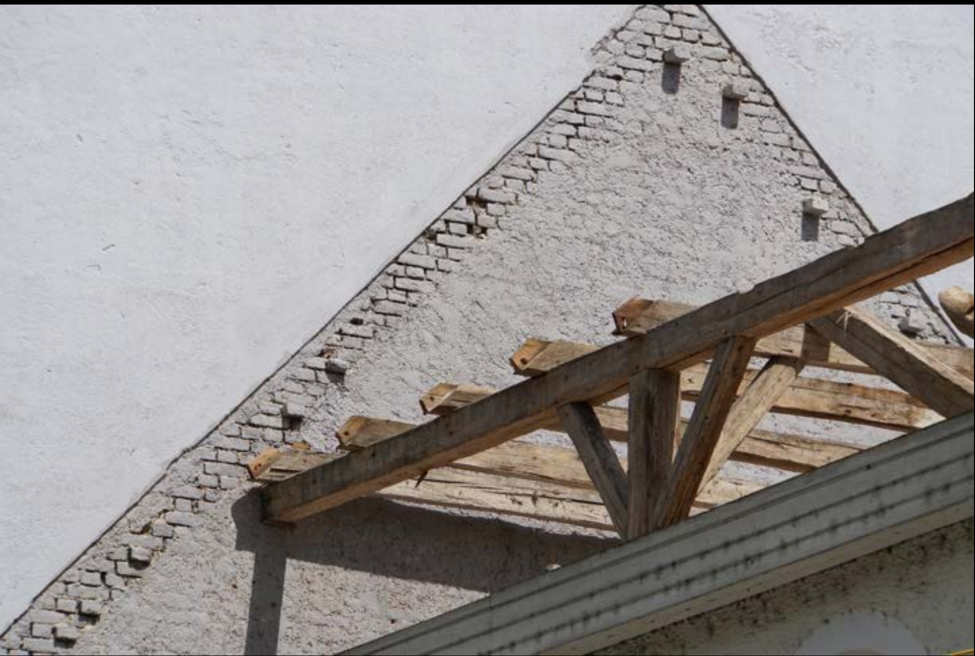
„Stehender Stuhl“ als Aufbauhilfe
