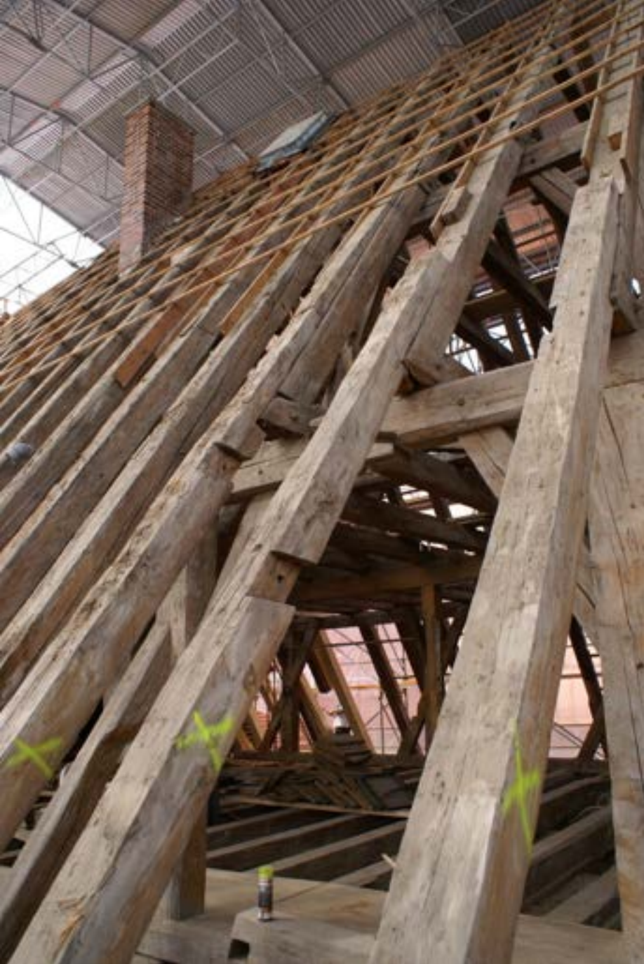
Dichte Gespärrefolge und Dachlattung (Beyharting, Klostergebäude)
