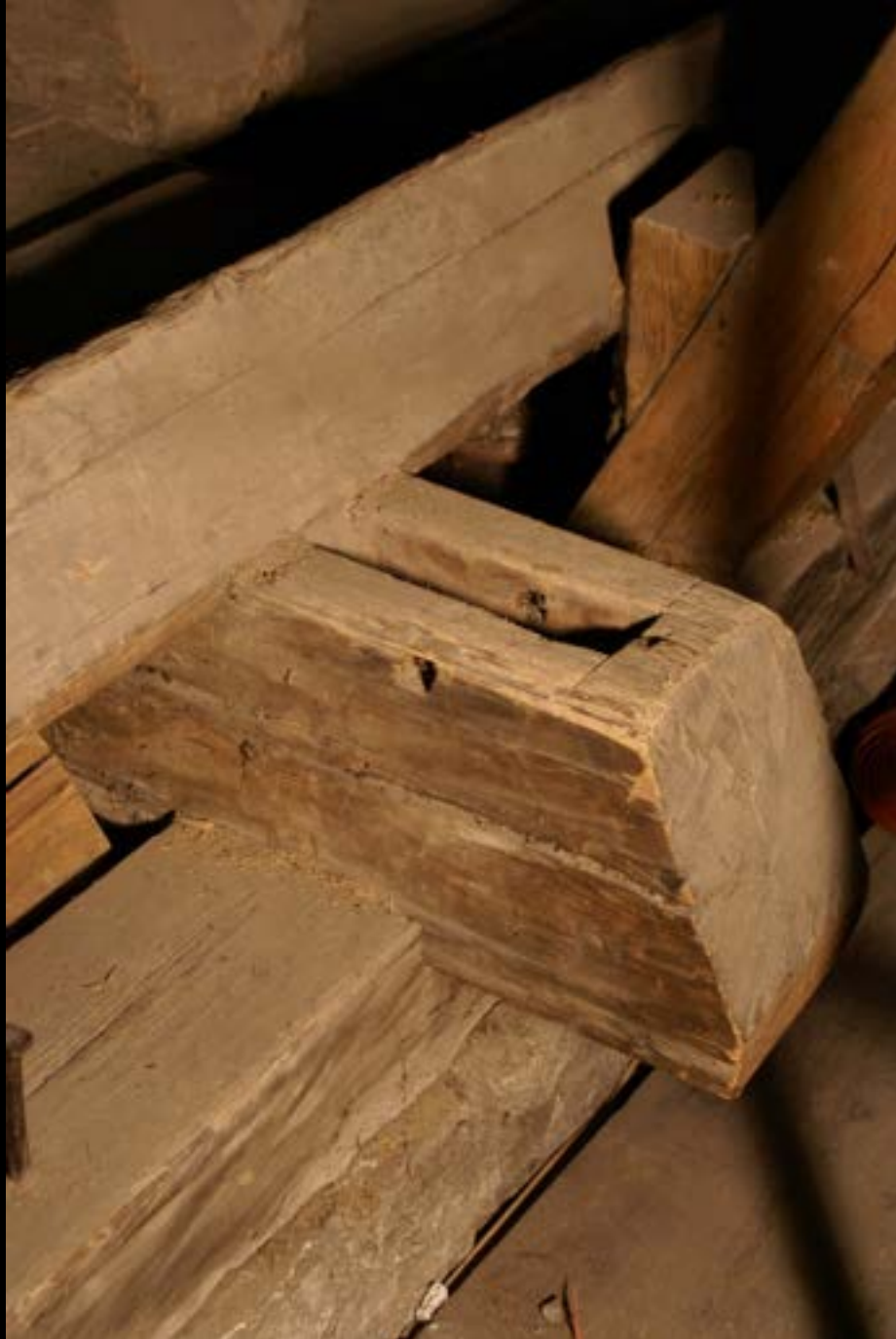
Zapfenloch für einen Sparren mit „abgestirntem Zapfen“
