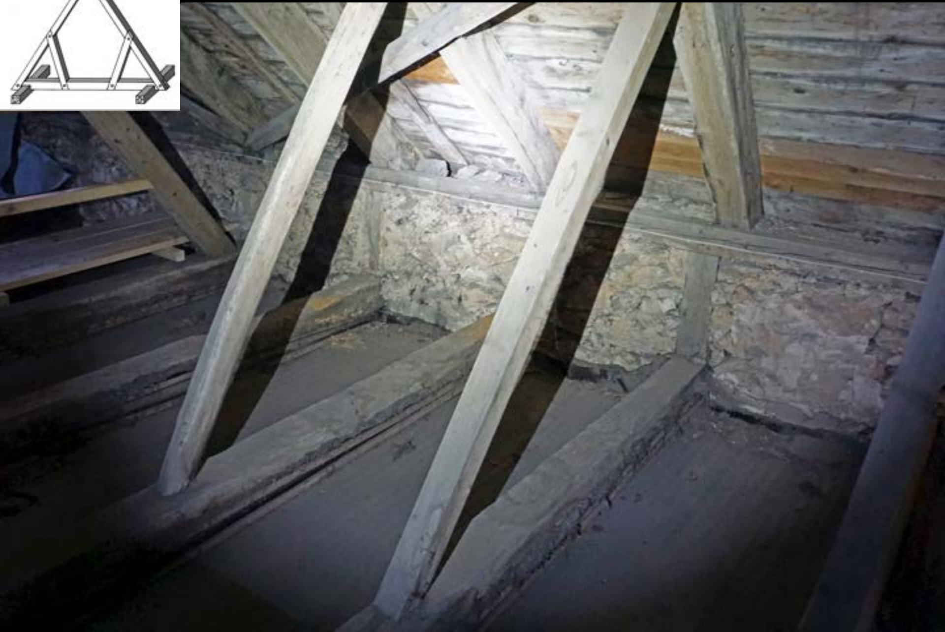
Dietkirchen/Lahn, Stiftskirche St. Lubentius, Dachwerk wohl 1. H. 12. Jh., Fusspunkt
