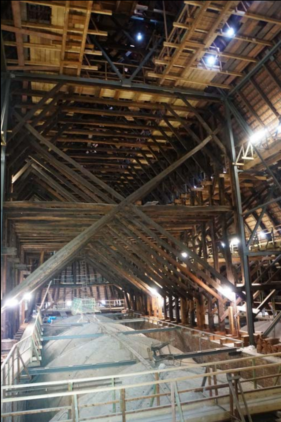
Hannover, Marktkirche. Aufgeständertes Kehlbalckendach, Kreuzstreben
