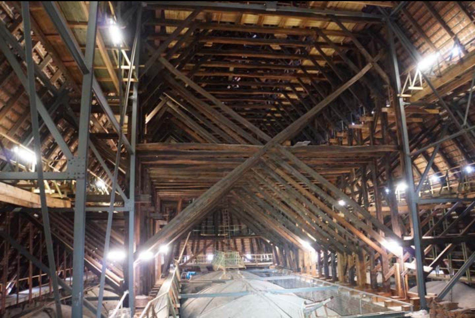
Hannover, Marktkirche. Dachwerk. Aufgeständertes Kehlbalkendach, Kreuzstreben
