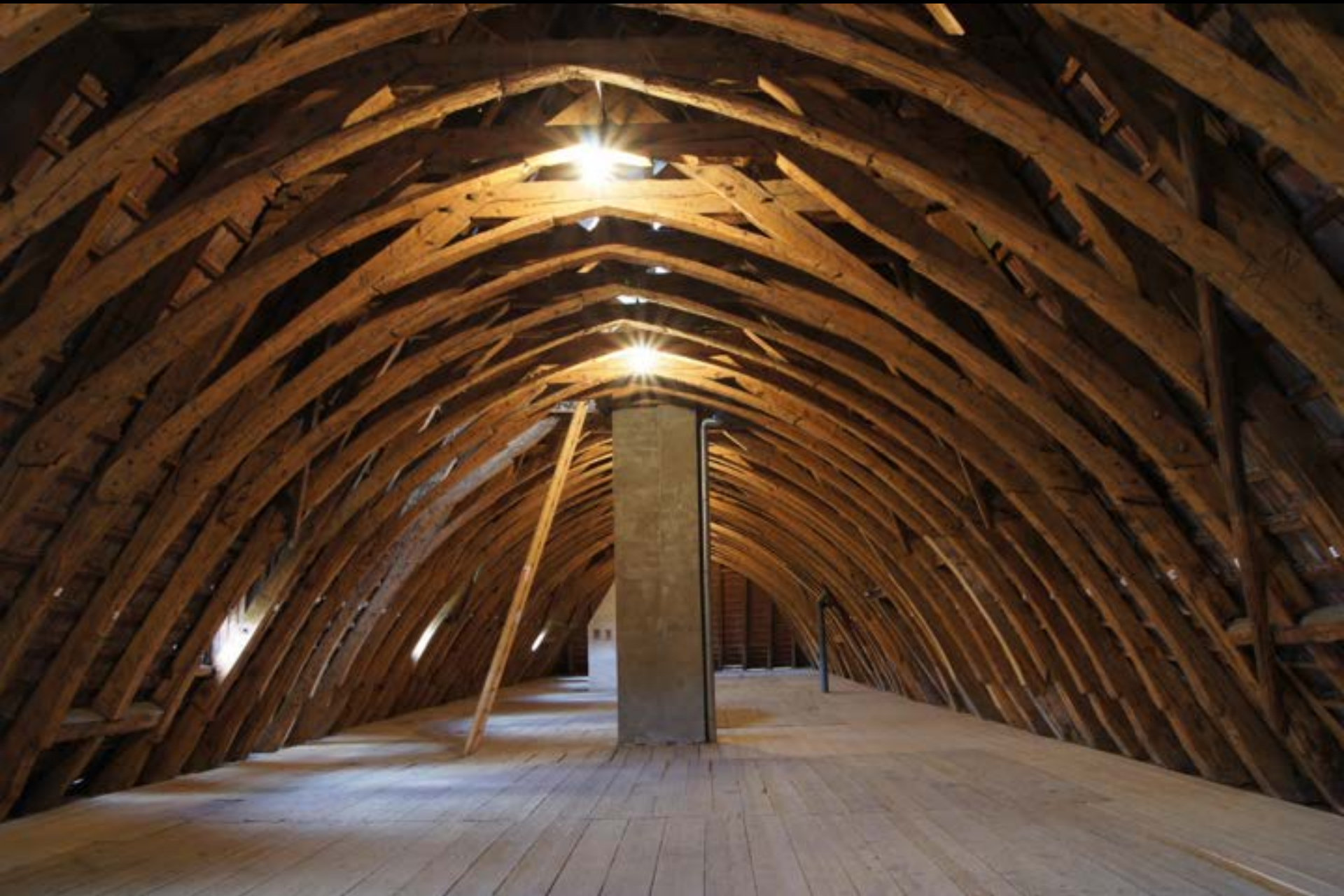
Kreuzstrebendach in Tonnenform (Erfurt, Predigerkloster, 1279)
