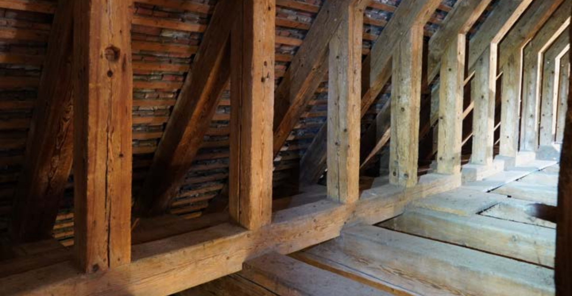
Dachwerk des Münsters Konstanz (1239d): „Ständerwand“ und Sparrenknechte, beides auf Schwelle
