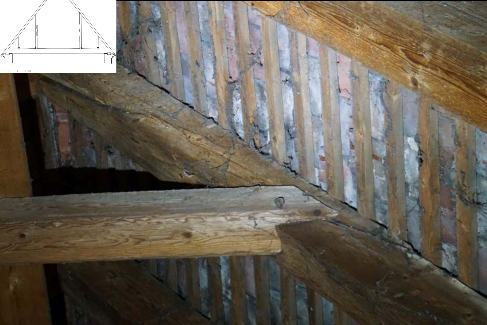
Dachwerk des Münsters Konstanz (1239d): Hahnenbalken (Kehlbalken)
