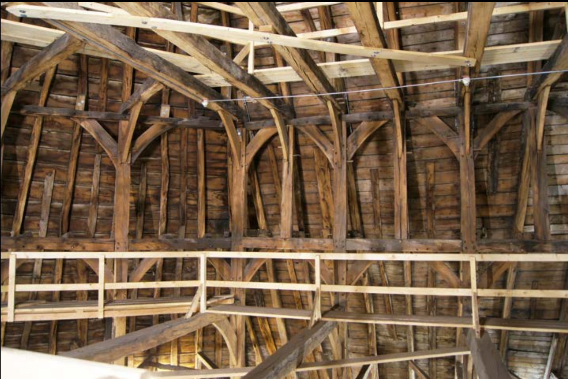
„Aufgeständertes Kehlbalckendach“ bei gotischer Hallenkirche (Ständer in jedem Gespärre!) Lippstadt, Grosse Marienkirche
