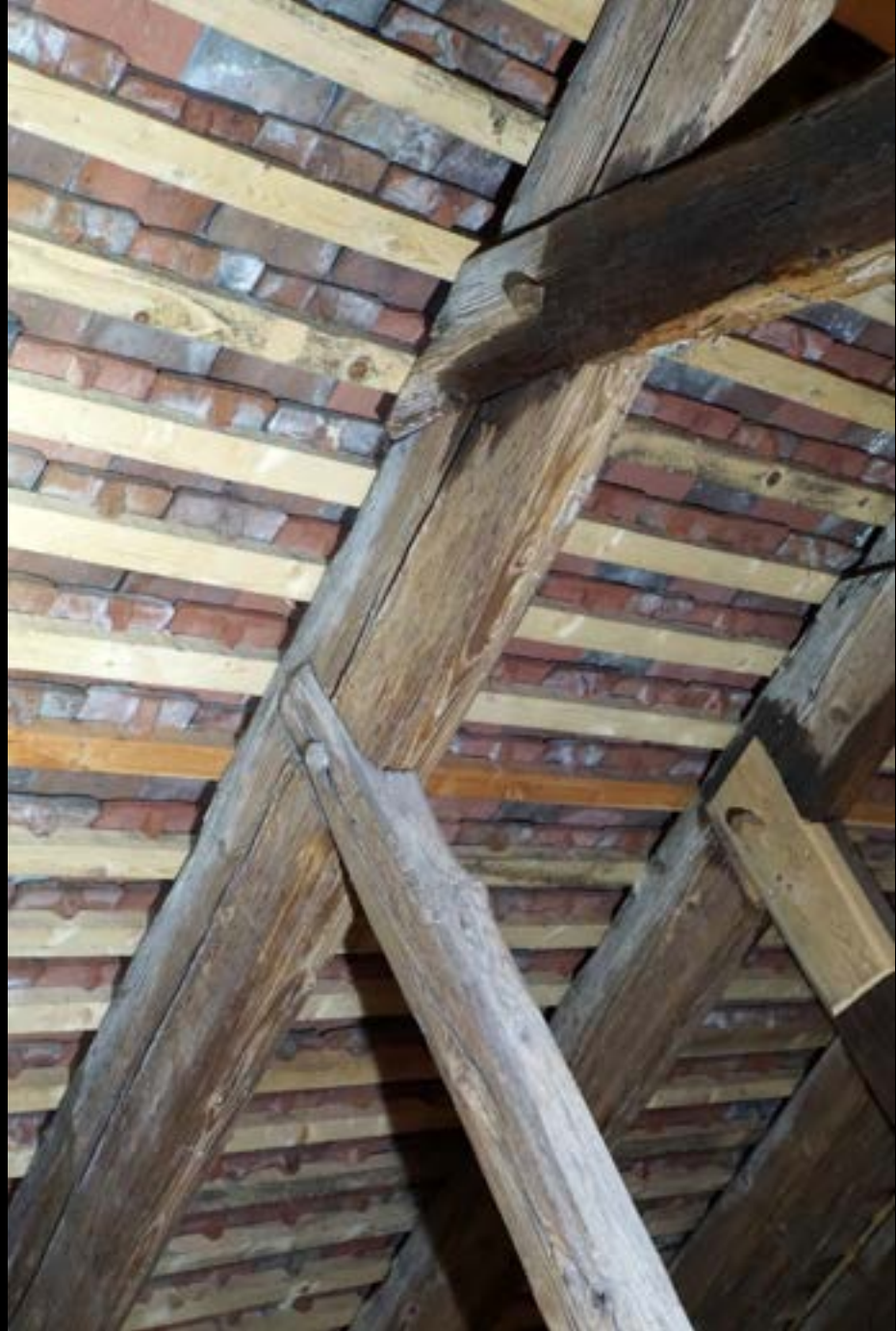
Dachwerk der Klosterkirche Maulbronn (1170d). Anblattung der Kehlbalcken und Sparrenknechte an den Sparren
