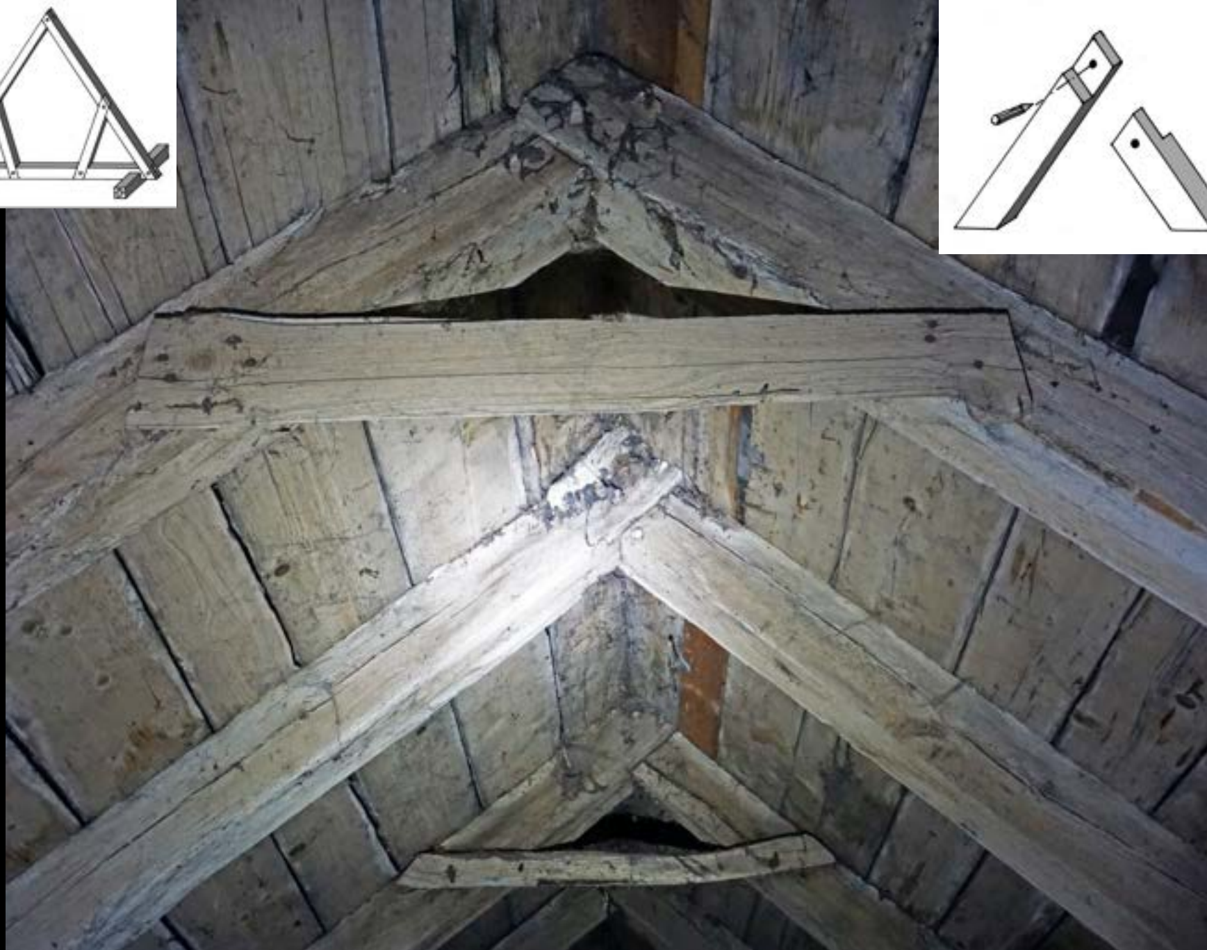
Dietkirchen/Lahn, Stiftskirche St. Lubentius, Dachwerk wohl 1. H. 12. Jh., Firstknoten
