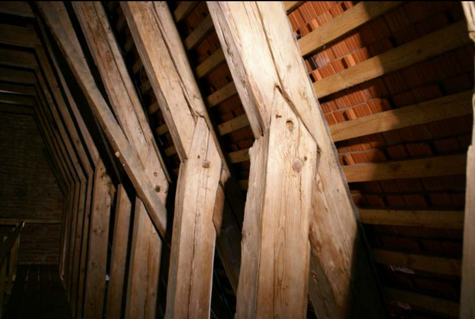
München, Maria Ramersdorf, Anschlüsse der Hängesäulen (14. Jh.)
