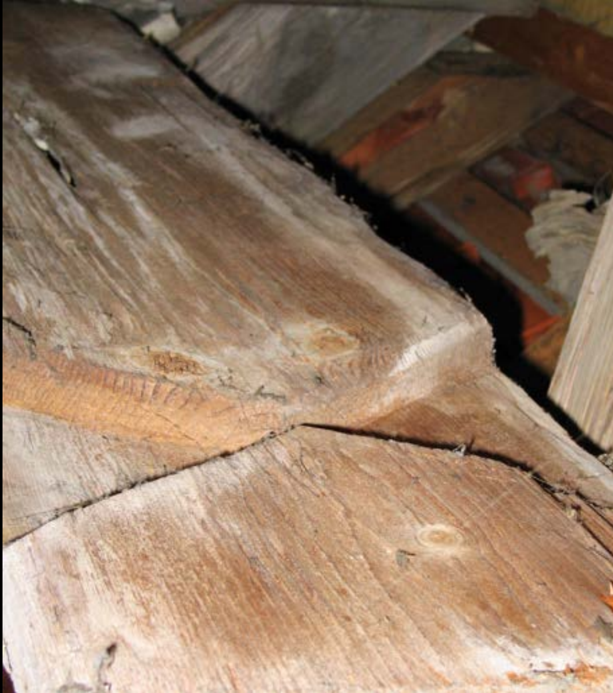
Verbindung zwischen Mauerlatte und Gespärre: Kreuzkamm
