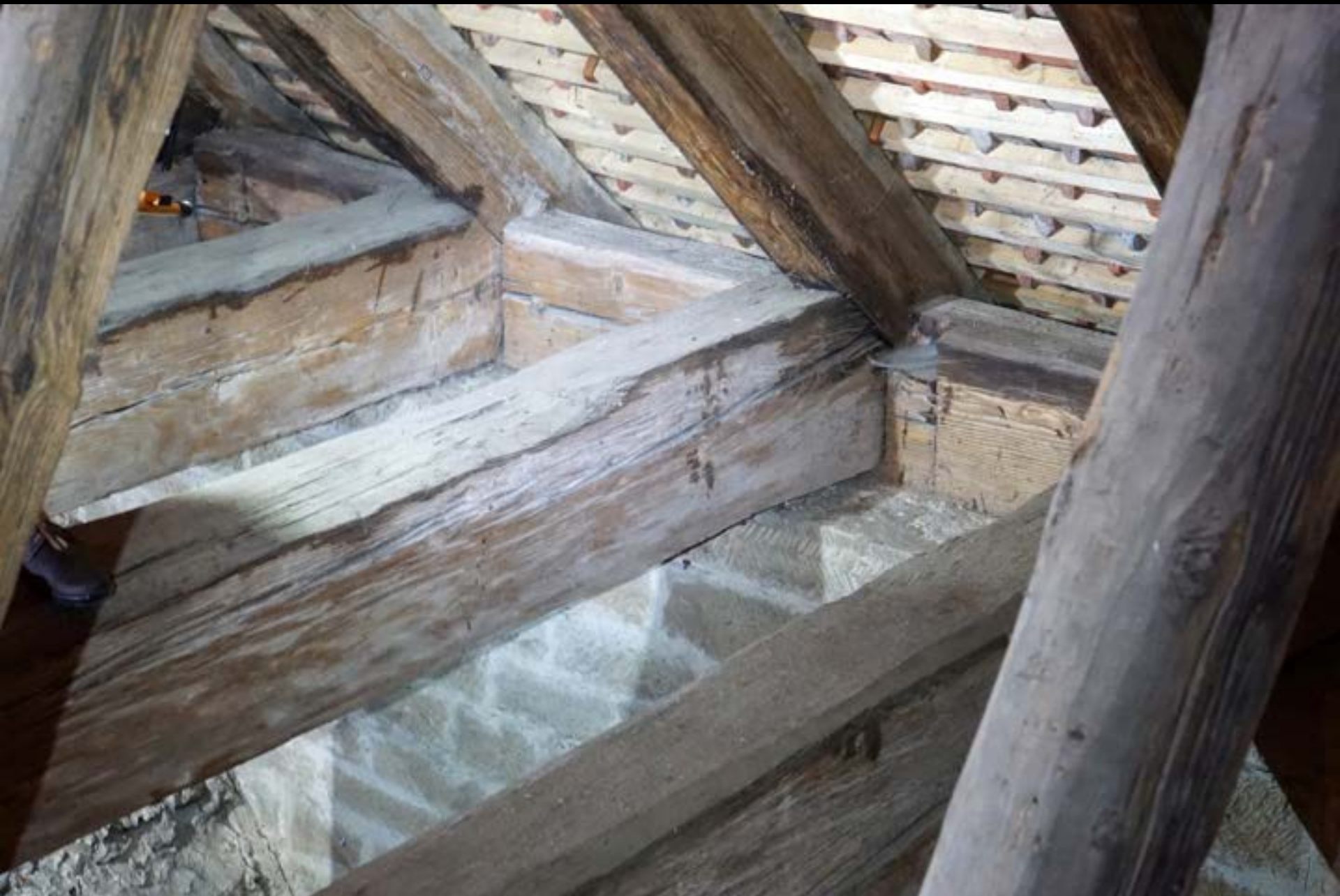
Dachwerk der Klosterkirche Maulbronn (1170d). Gespärrefusspunkte und Mauerlatte
