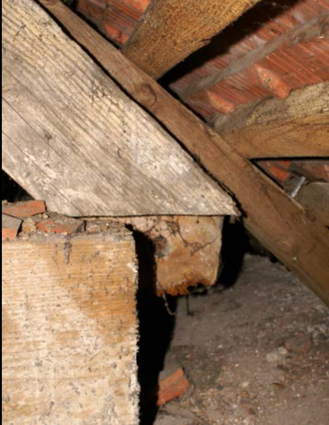
Gespärrefusspunkt mit „abgestirntem Zapfen“, freigelegt durch Abschneiden des Zerrbalkenkopfes
