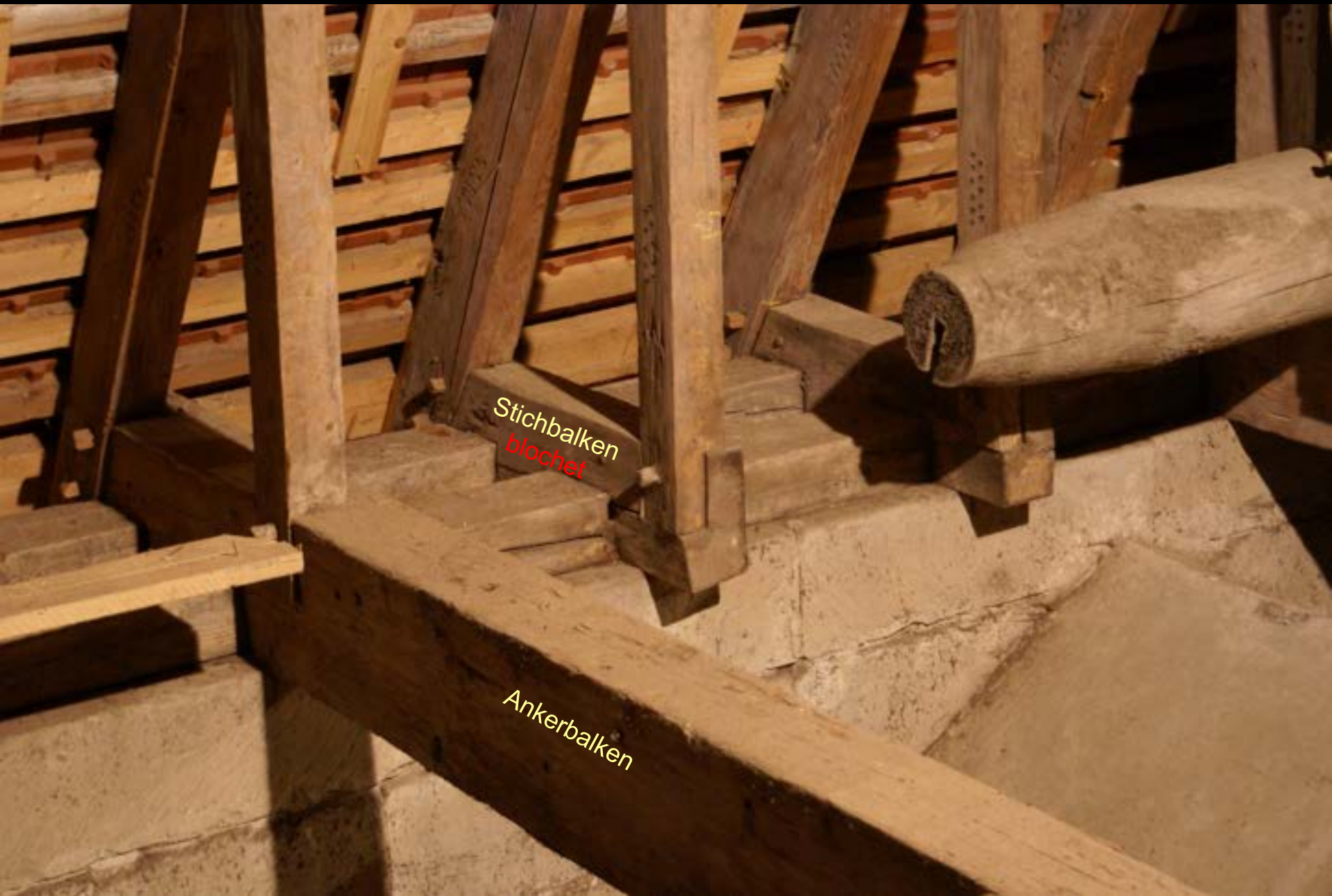
Dachwerk der Abteikirche Salem (frühes 14. Jh.): neue Rolle der Mauerlatte
