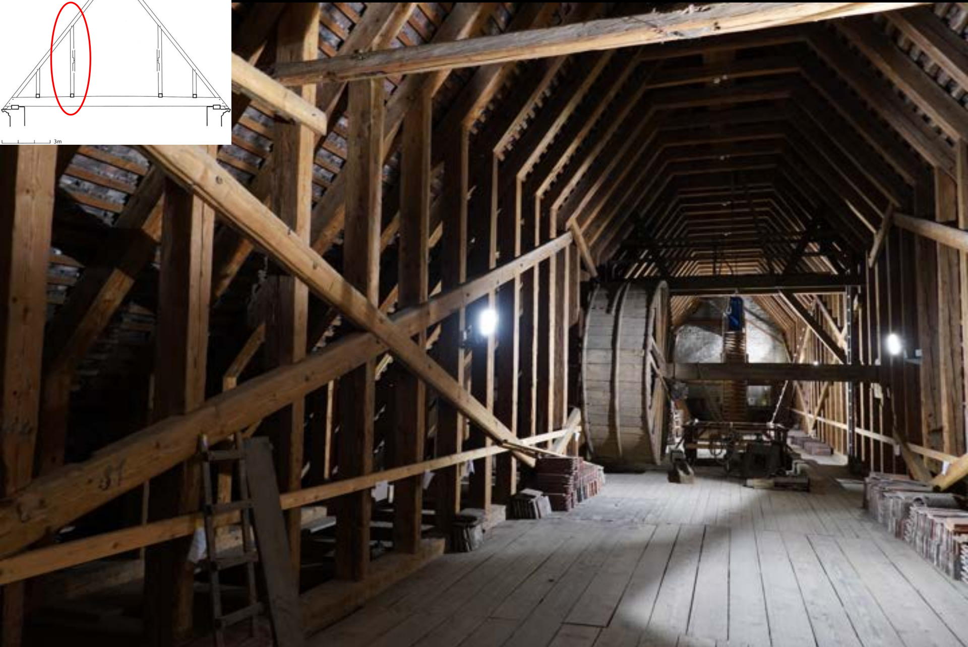
Dachwerk des Münsters Konstanz (1239d). „Ständerwand“ (poteaux) und Windrispen (contreventement)
