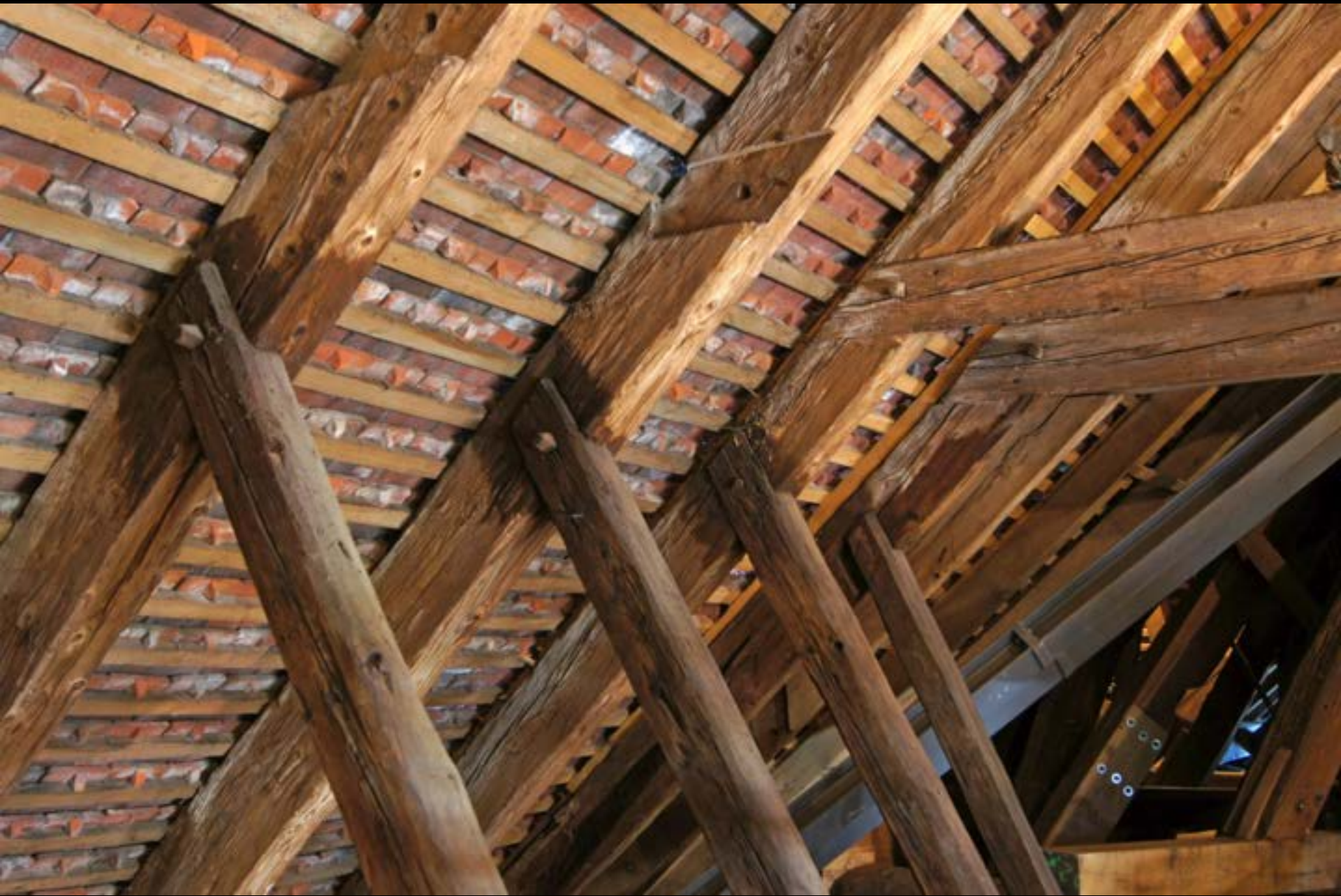
Dachwerk der Klosterkirche Maulbronn (1170d). Anblattung der Kehlbalken und Sparrenknechte an den Sparren
