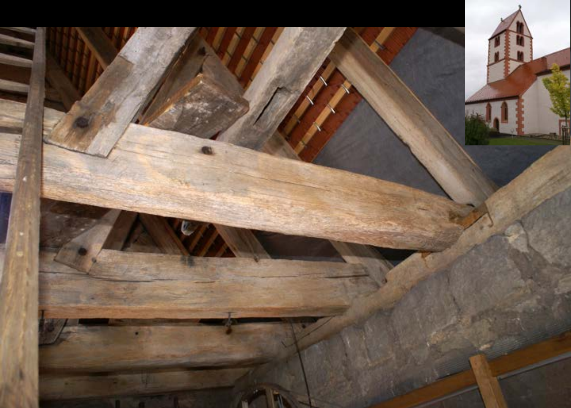
Anschlüsse am Zerrbalken (Brendlorenzen, Turmdach, 1260d)
