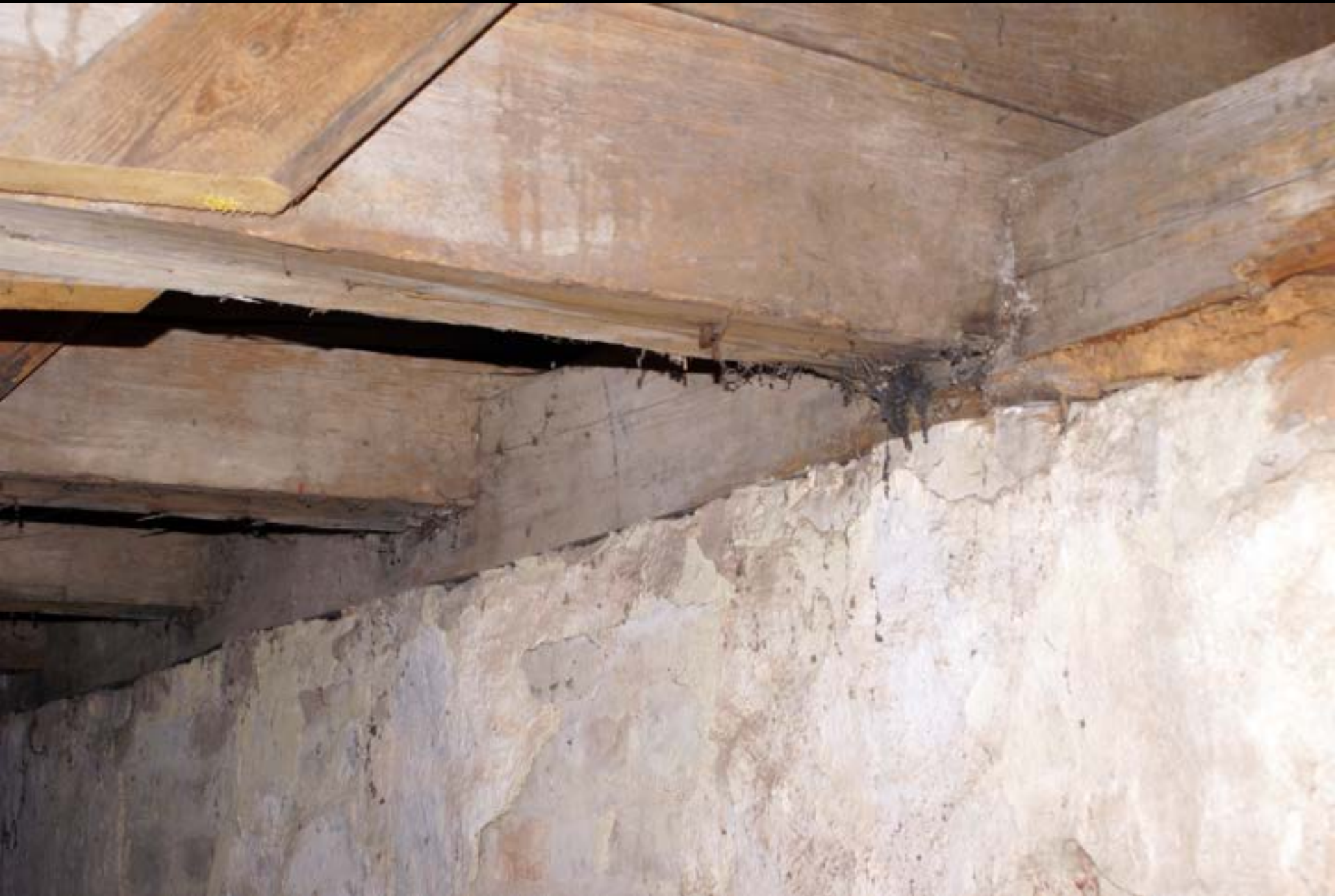
Anschluss Zerrbalken-Mauerlatte (Freising, Dom, 1227)
