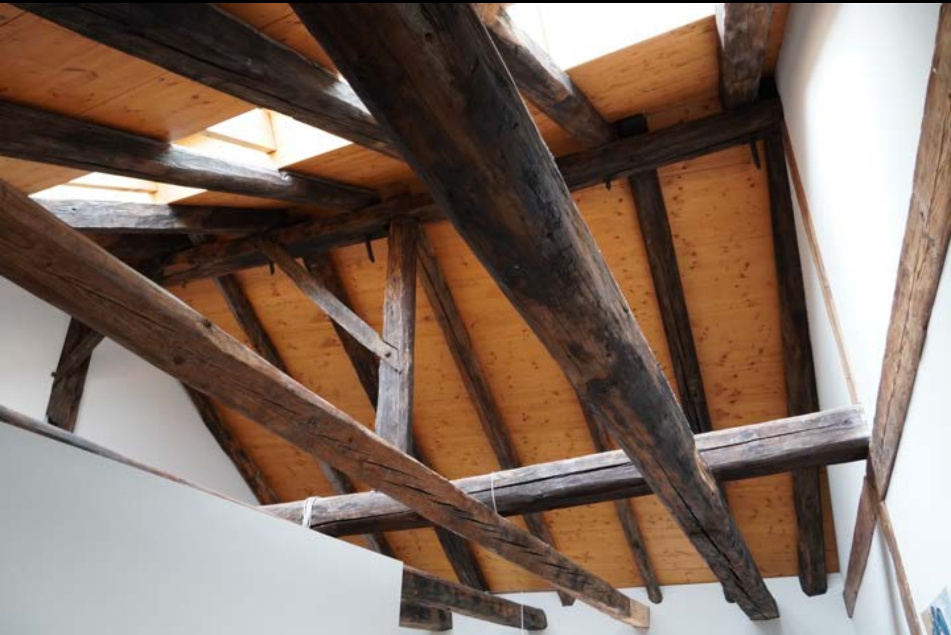
Konstanz, Wohnhaus Hussenstrasse, Pfettendach auf Längstragwerk gelagert
