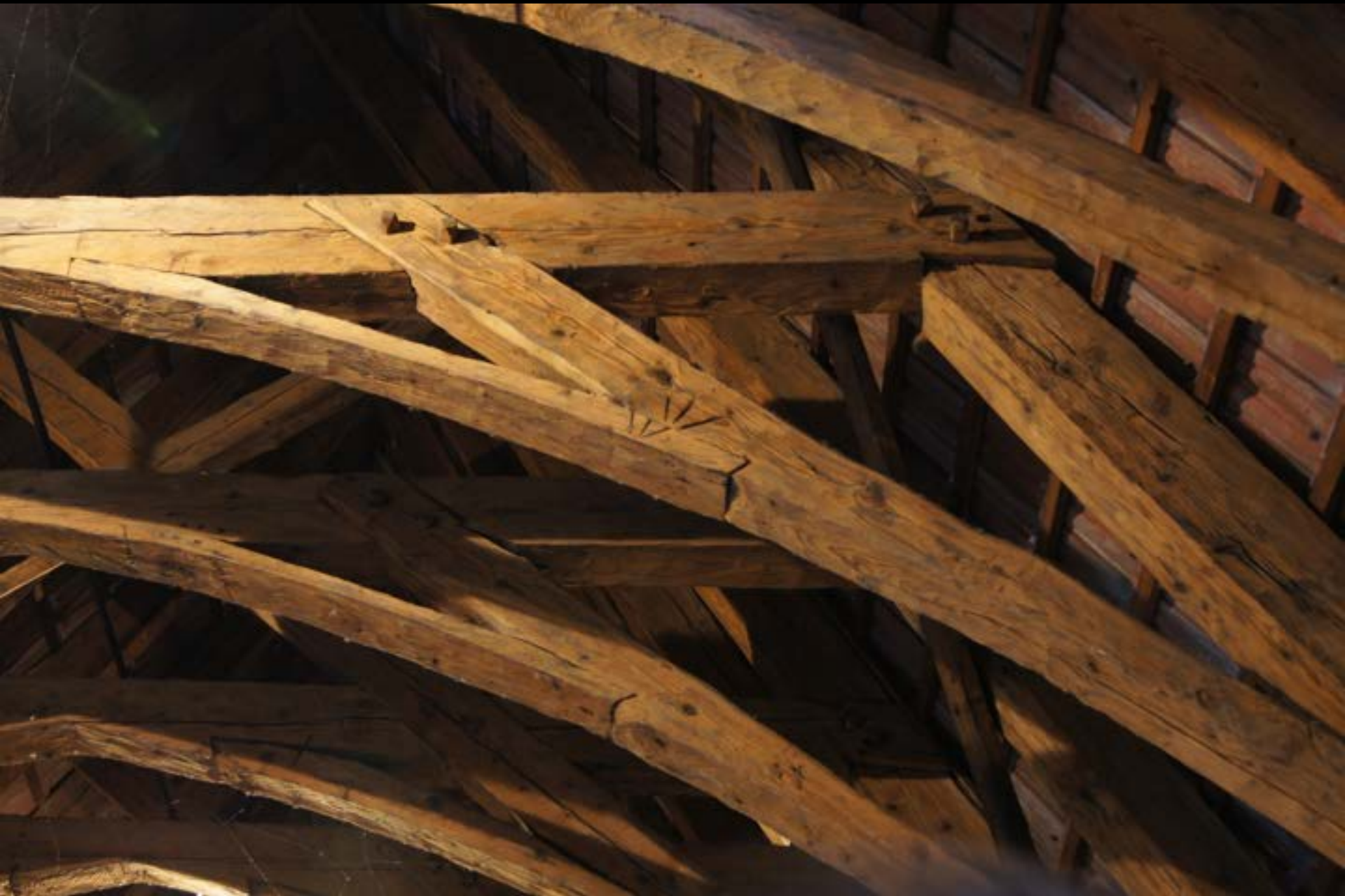
Kreuzstrebdach in Tonnenform (Erfurt, Predigerkloster, 1279)
