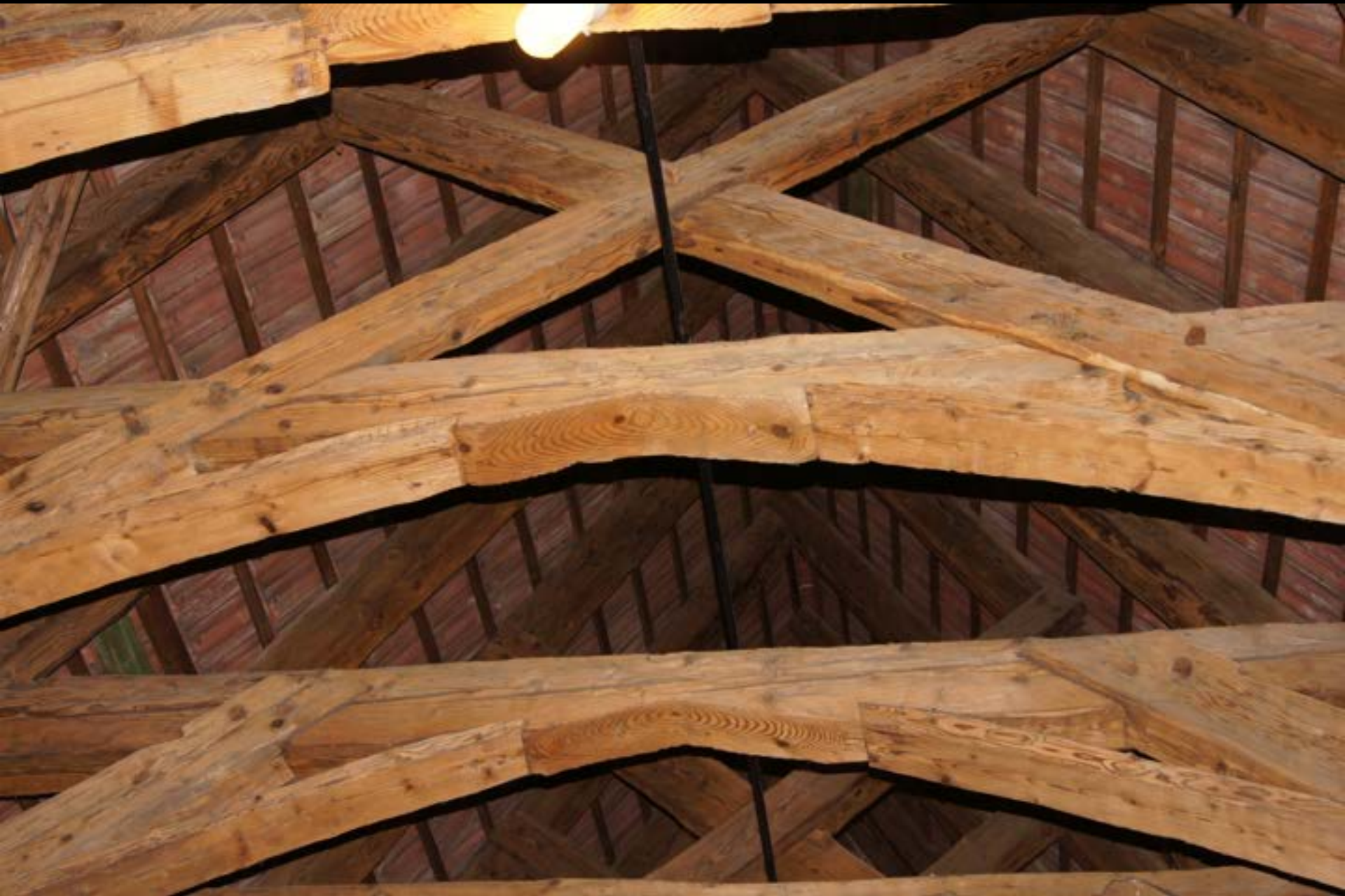
Kreuzstrebendach in Tonnenform (Erfurt, Predigerkloster, 1279)
