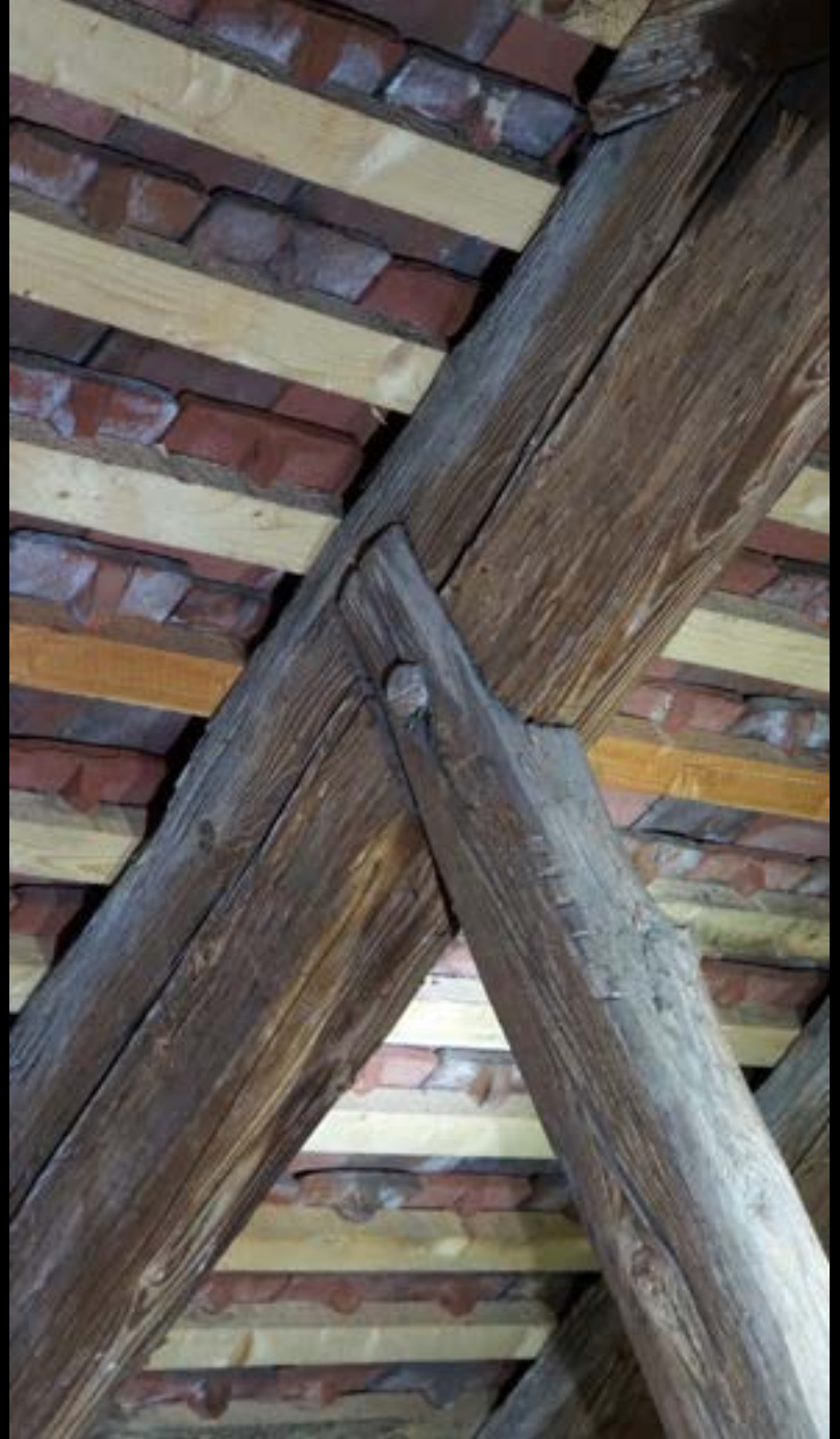
Dachwerk der Klosterkirche Maulbronn (1170d). Anblattung der Kehlbalcken und Sparrenknechte an den Sparren
