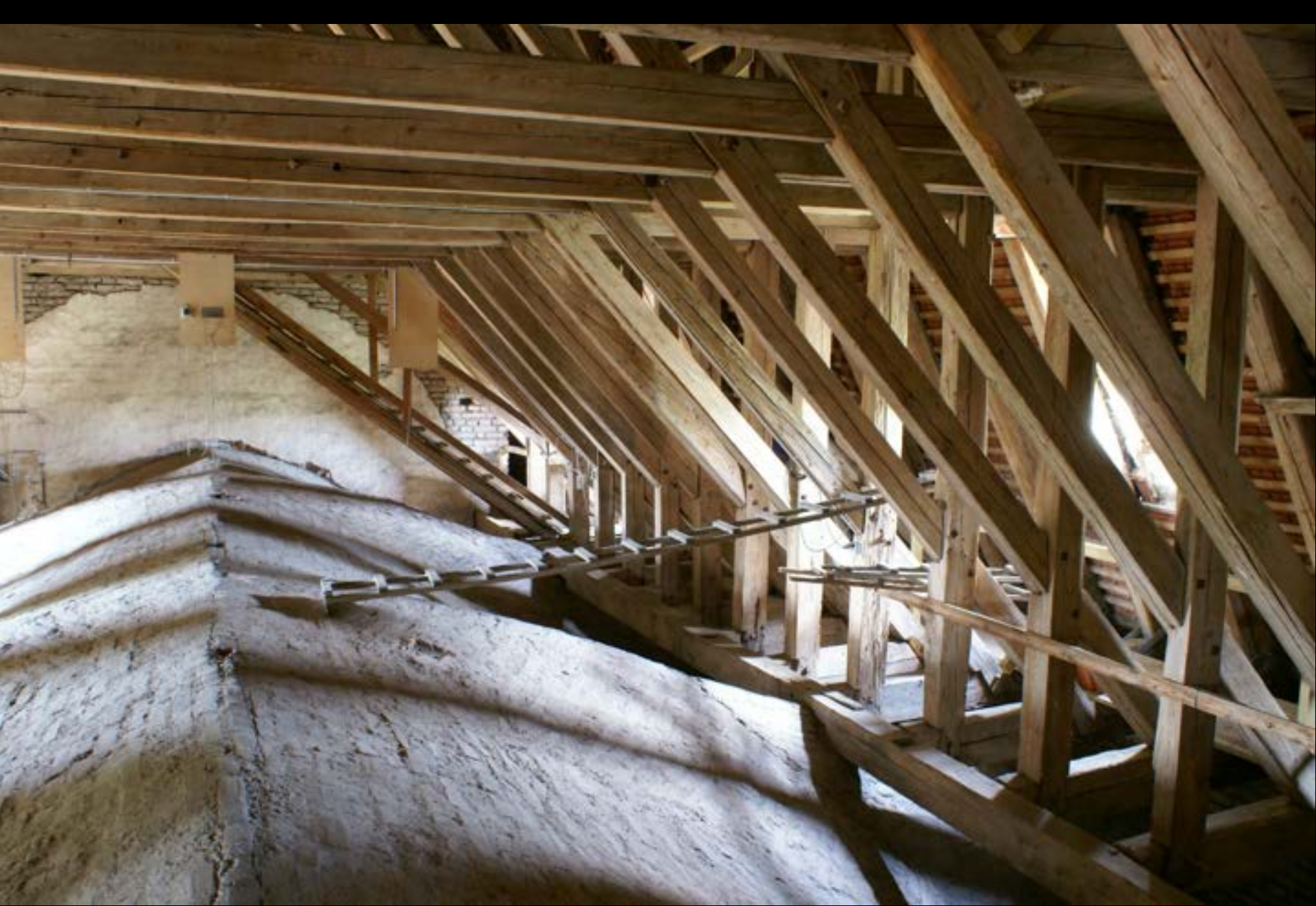
München, Maria Ramersdorf, Langhausdach (14. Jh.)
