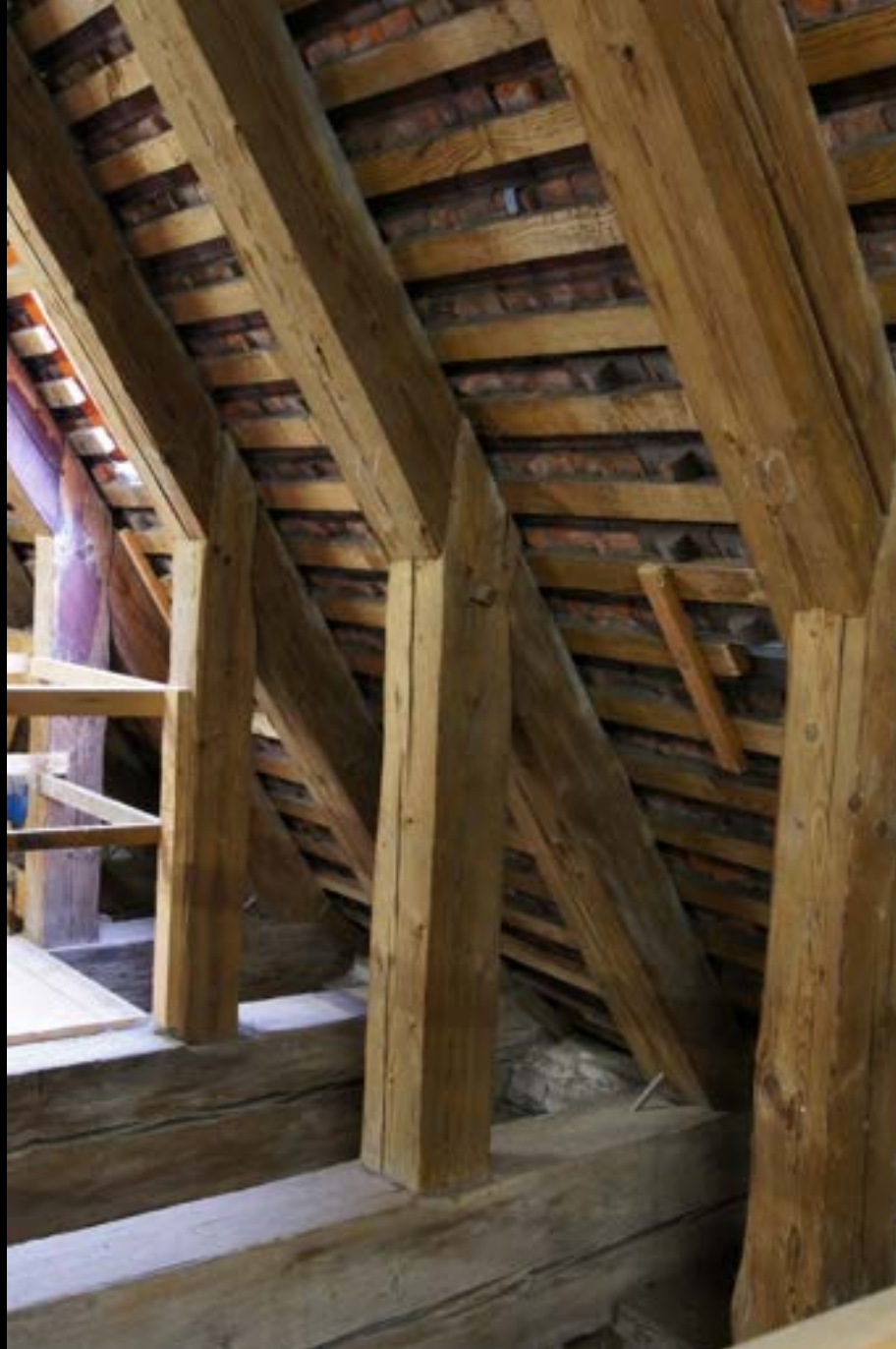
Gespärrefusspunkt mit Sparrenknechten (Augsburg, Dom, Langhaus, 15. Jh.)
