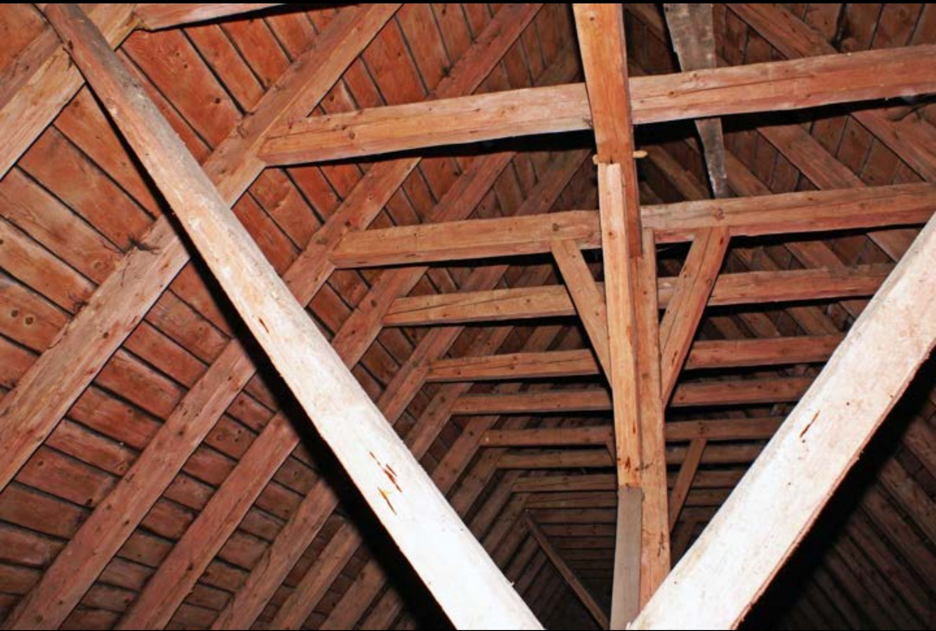
Wallfahrtskirche St. Ottilia, Möschenfeld (Dachwerk 1675/76d). „Einfach stehender Stuhl“ im oberen Stockwerk.
