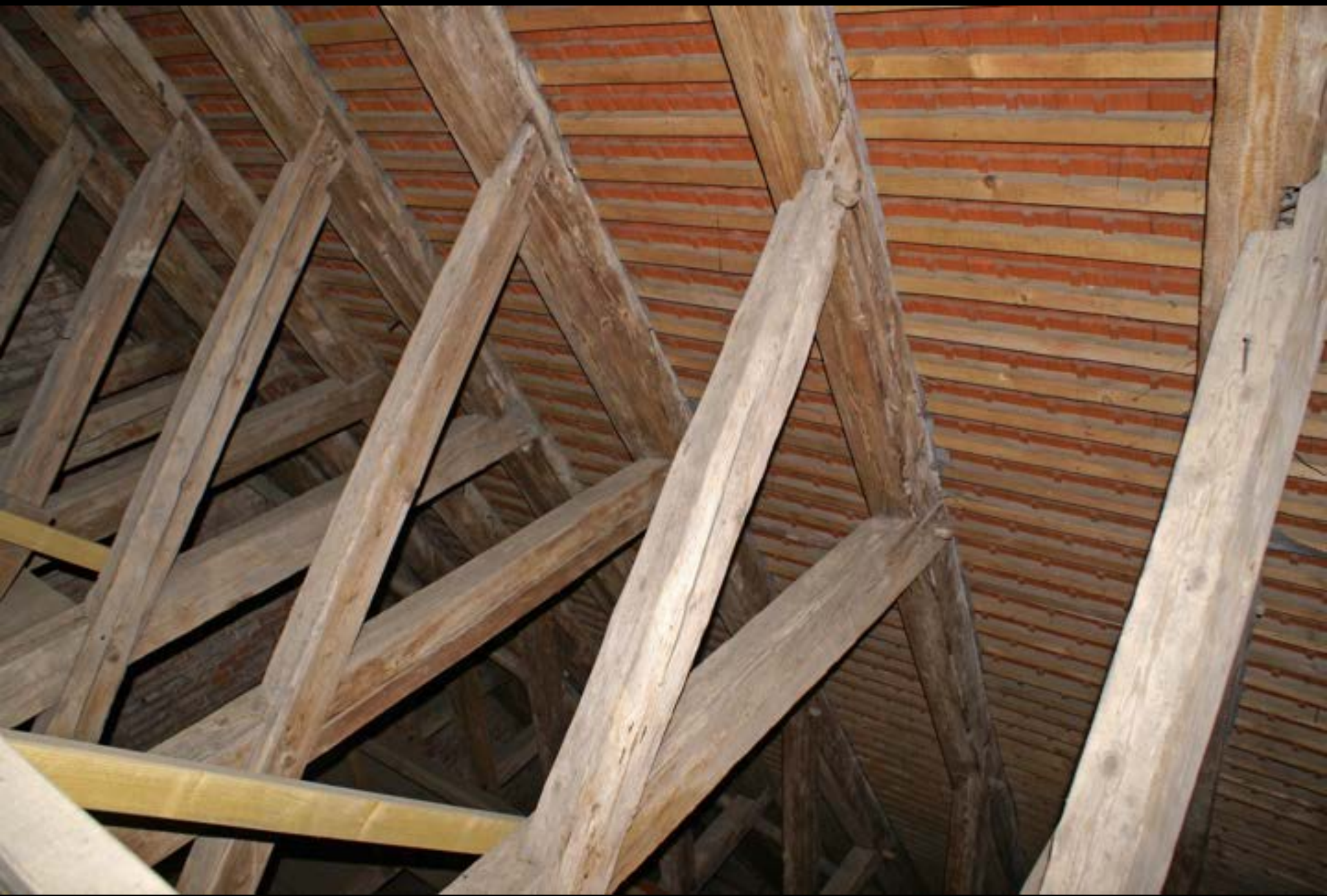
München, Maria Ramersdorf, Anschlüsse der Kehlbalken und Kreuzstreben (14. Jh.)
