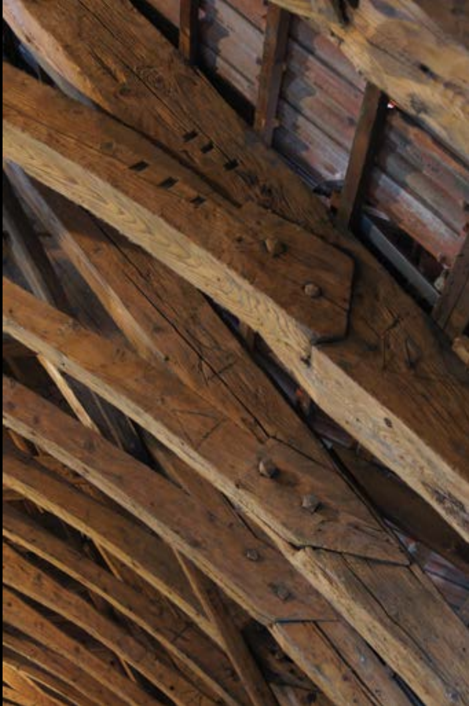
Kreuzstrebdach in Tonnenform (Erfurt, Predigerkloster, 1279)
