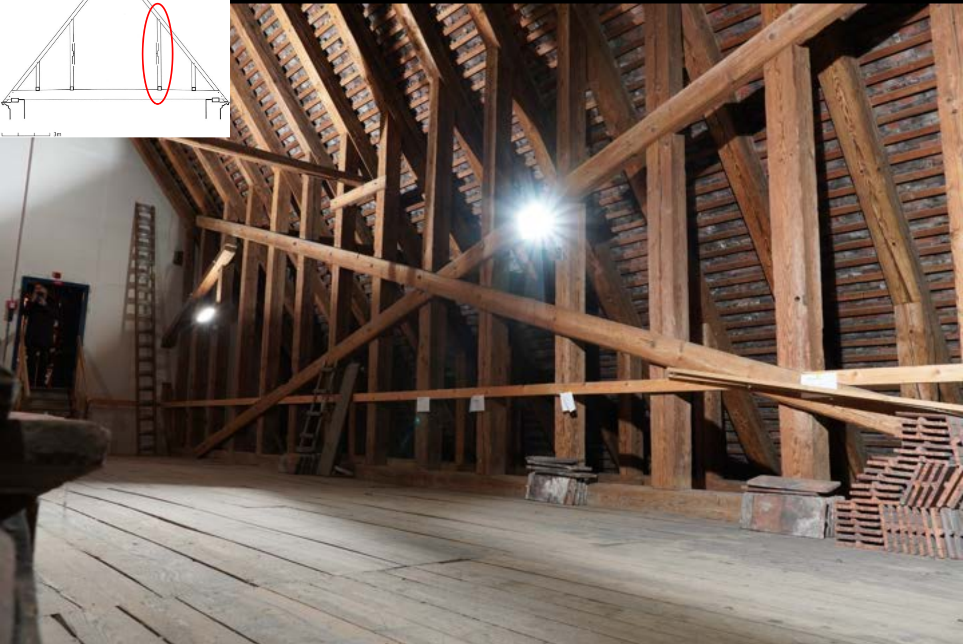
Dachwerk des Münsters Konstanz (1239d). „Ständerwand“ und Windrispen
