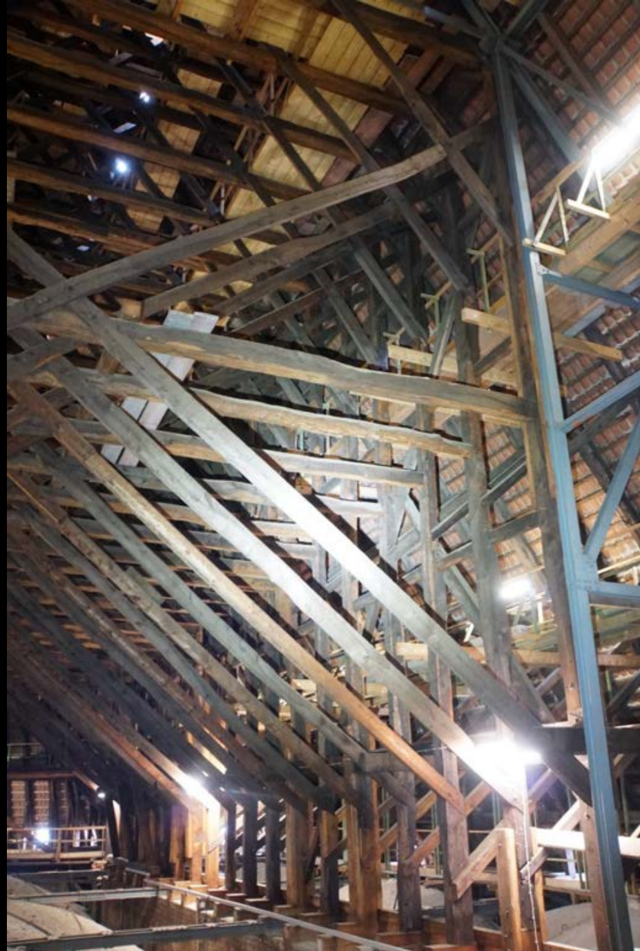
Hannover, Marktkirche. Aufgeständertes Kehlbalckendach, Kreuzstreben
