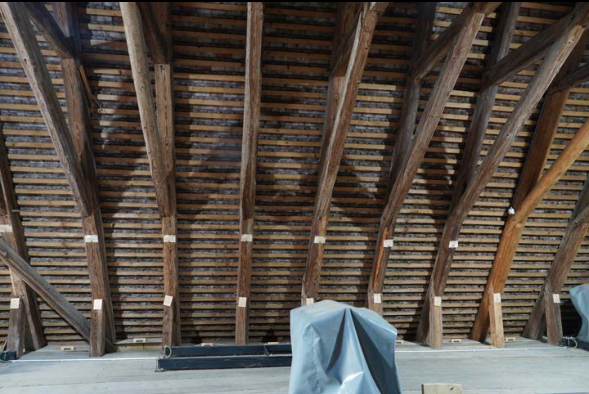
Kreuzstrebdach (Klosterkirche Königsfelden bei Windisch AG, 1315d). Fehlen eines Längsverbandes
