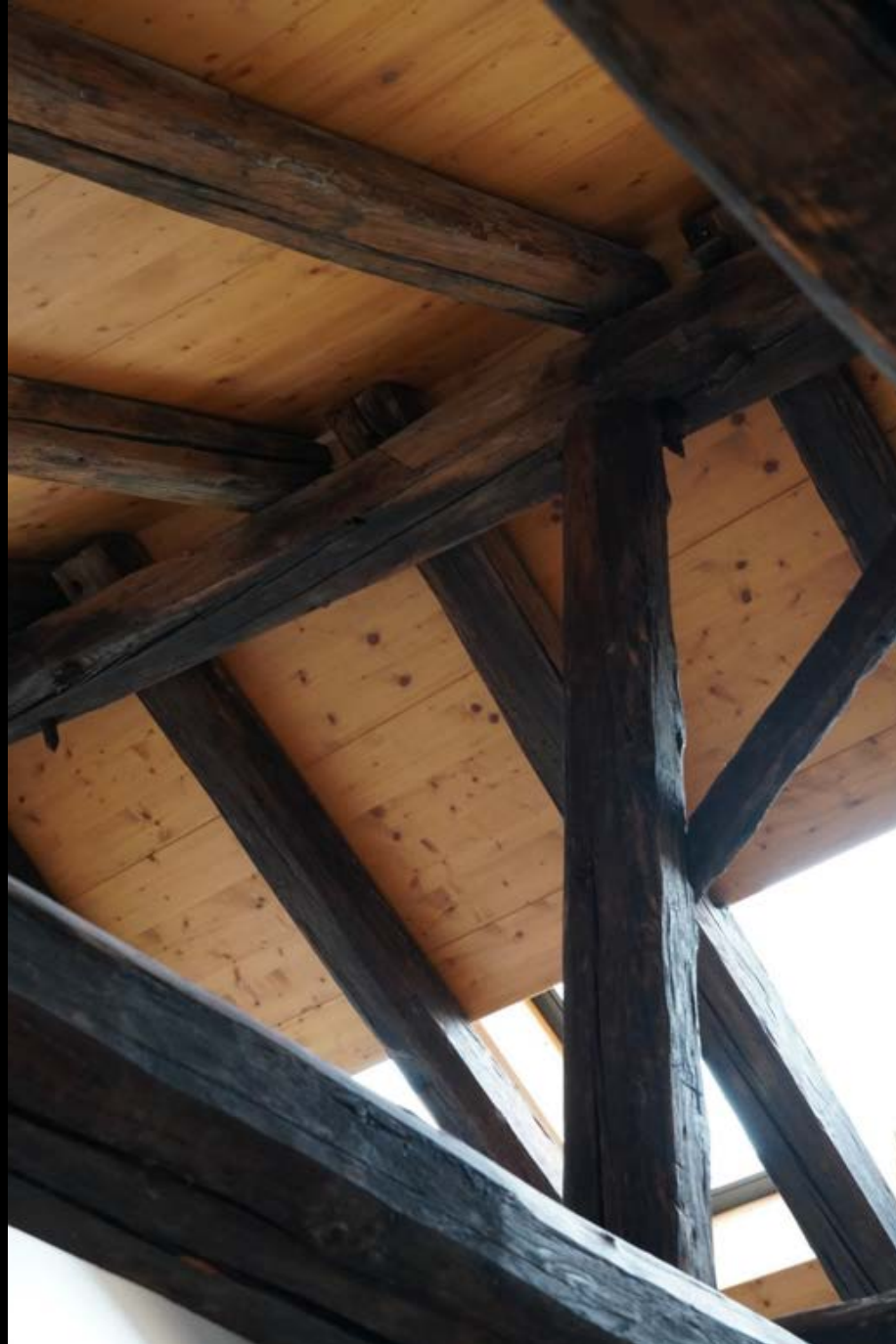
Konstanz, Wohnhaus Hussenstrasse, Pfettendach auf Längstragwerk gelagert
