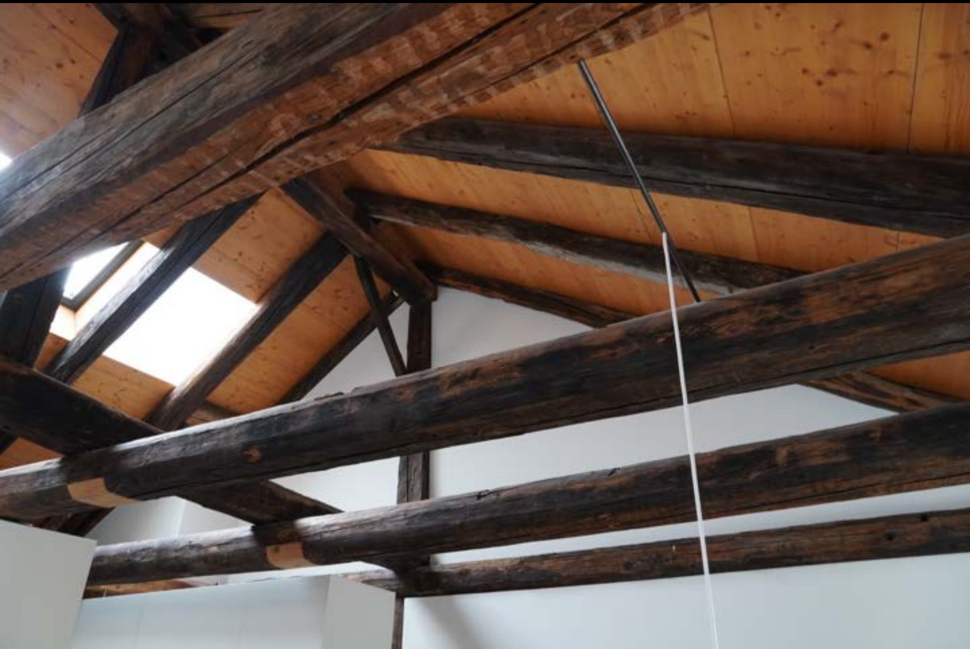
Konstanz, Wohnhaus Hussenstrasse, Pfettendach auf Längstragwerk gelagert
