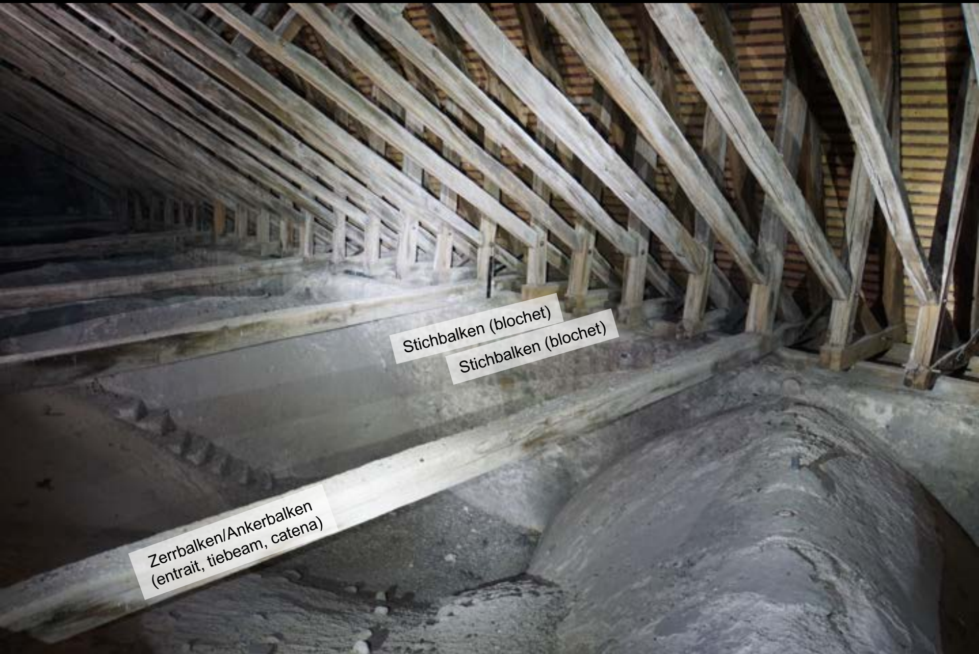
Sens, Kathedrale, Chor, Dach. Nur einzelne durchgehende Ankerbalken, sonst Stichbalken
