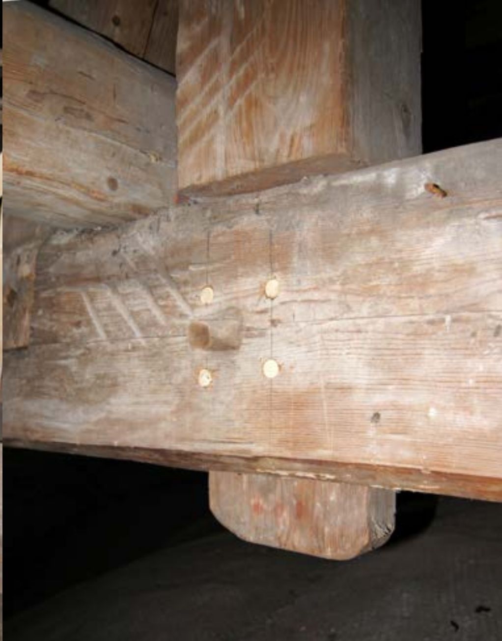
Integration von Hängewerk und Stuhl Zugfester Anschluss und unsinnige neue Ertüchtigung (Augsburg, St. Ulrich und Afra, Ende 15. Jh.)
