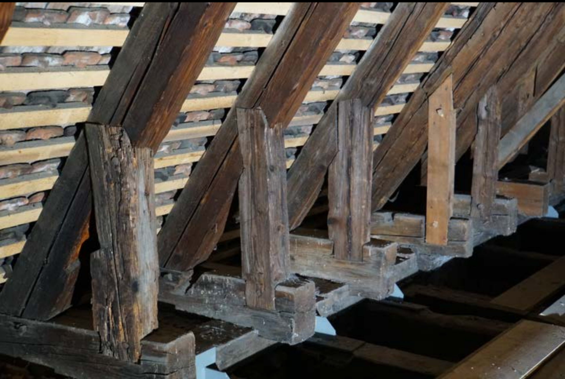
Kreuzstrebendach: Stichbalken Sparrenknechte (Basel, Grosses Klingenthal, 13. Jh.)
