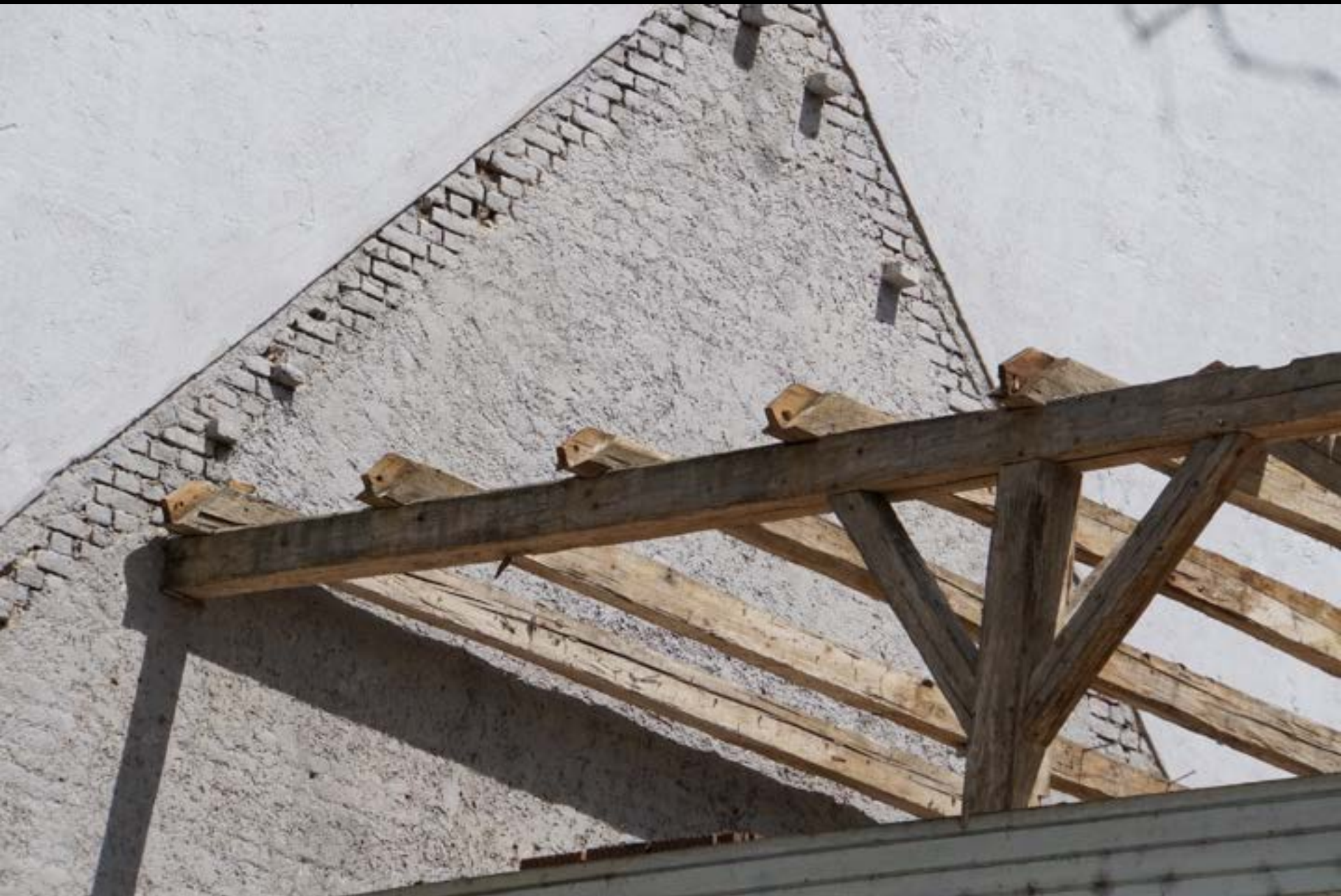
„Stehender Stuhl“ als Aufbauhilfe: Kehlbalken als Arbeitsebene
