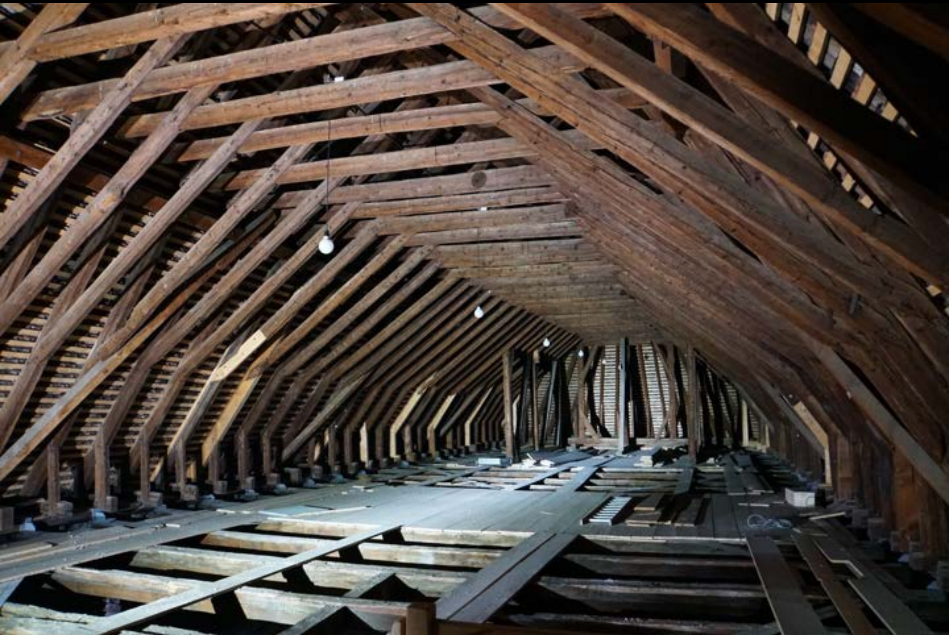
Kreuzstrebdach: Stichbalken und Ankerbalkenlage (Basel, Grosses Klingenthal, 13. Jh.)
