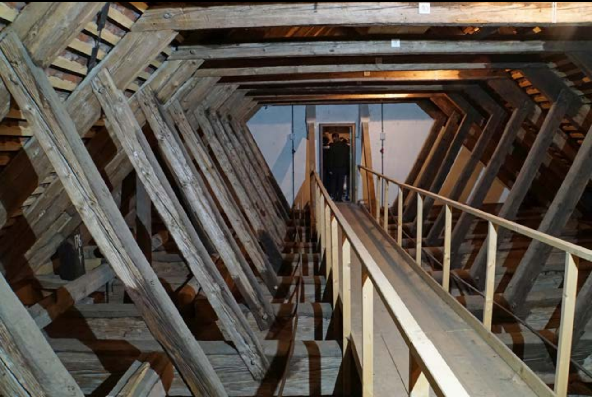
Dachwerk der Klosterkirche Maulbronn (1170d)
