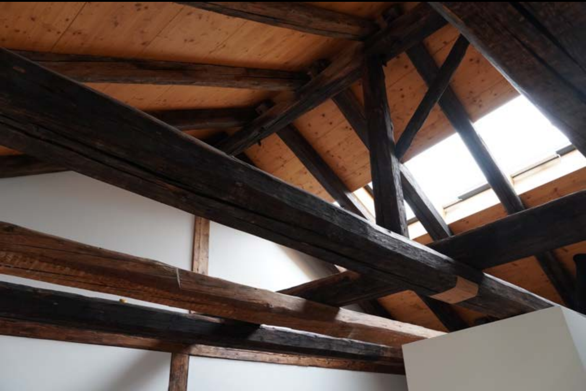
Konstanz, Wohnhaus Hussenstrasse, Pfettendach auf Längstragwerk gelagert
