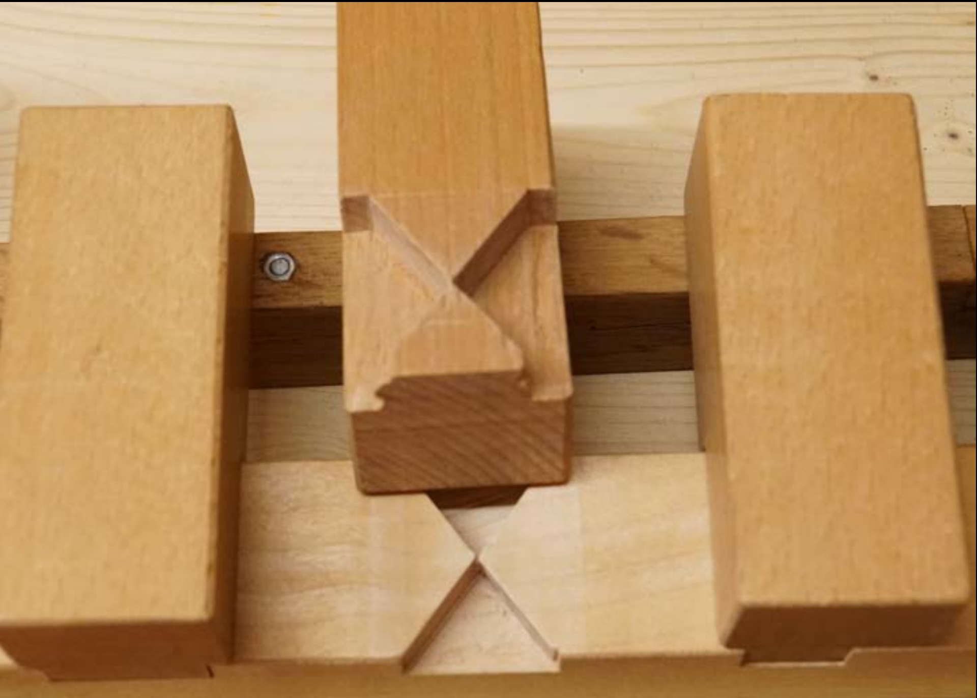
Verbindung zwischen Mauerlatte und Gespärre: Kreuzkamm (Fachwerkmuseum Unterstammheim)
