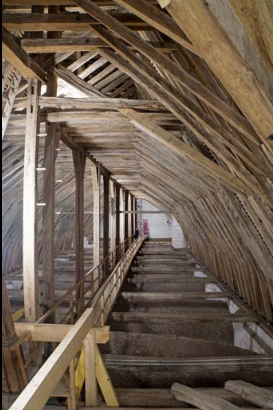
Auxerre, Kathedrale, Dachwerk über dem Langhaus (1357d und 1379d)
