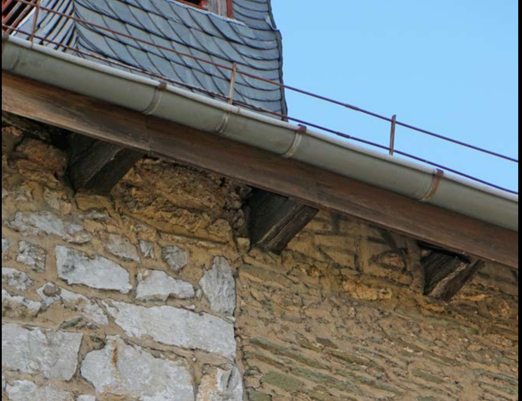
Dietkirchen/Lahn, Stiftskirche St. Lubentius, Dachwerk wohl 1. H. 12. Jh., Dachüberstand
