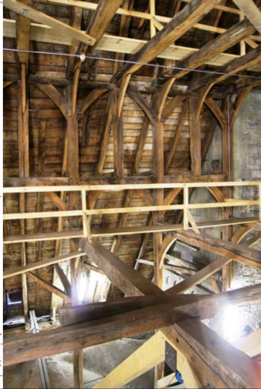
„Aufgeständertes Kehlbalkendach“ bei gotischer Hallenkirche Lippstadt, Grosse Marienkirche (M. Hoyer 2014 nach R. Schneider)
