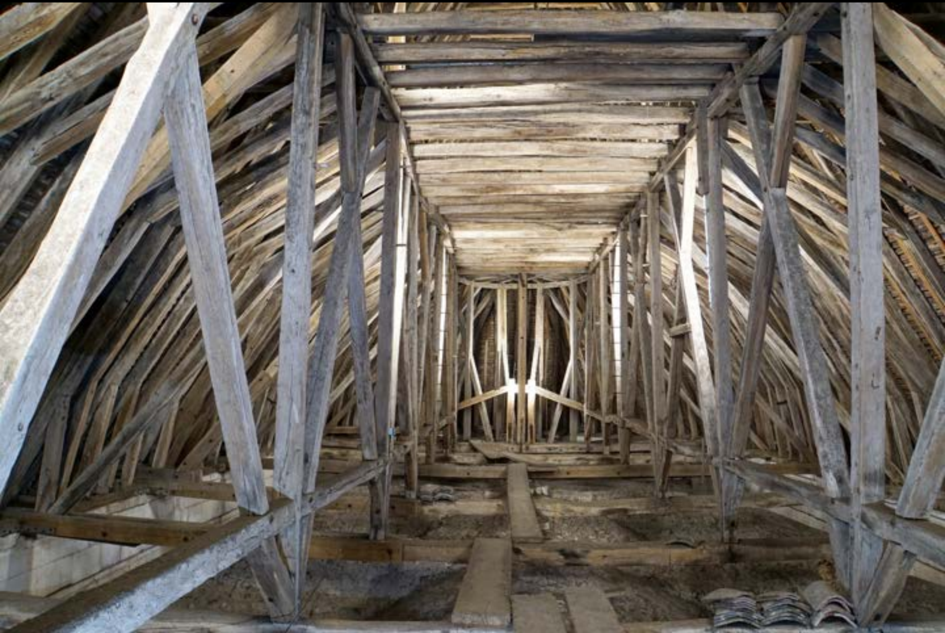
Dachwerk der Kathedrale von Auxerre (1236)
