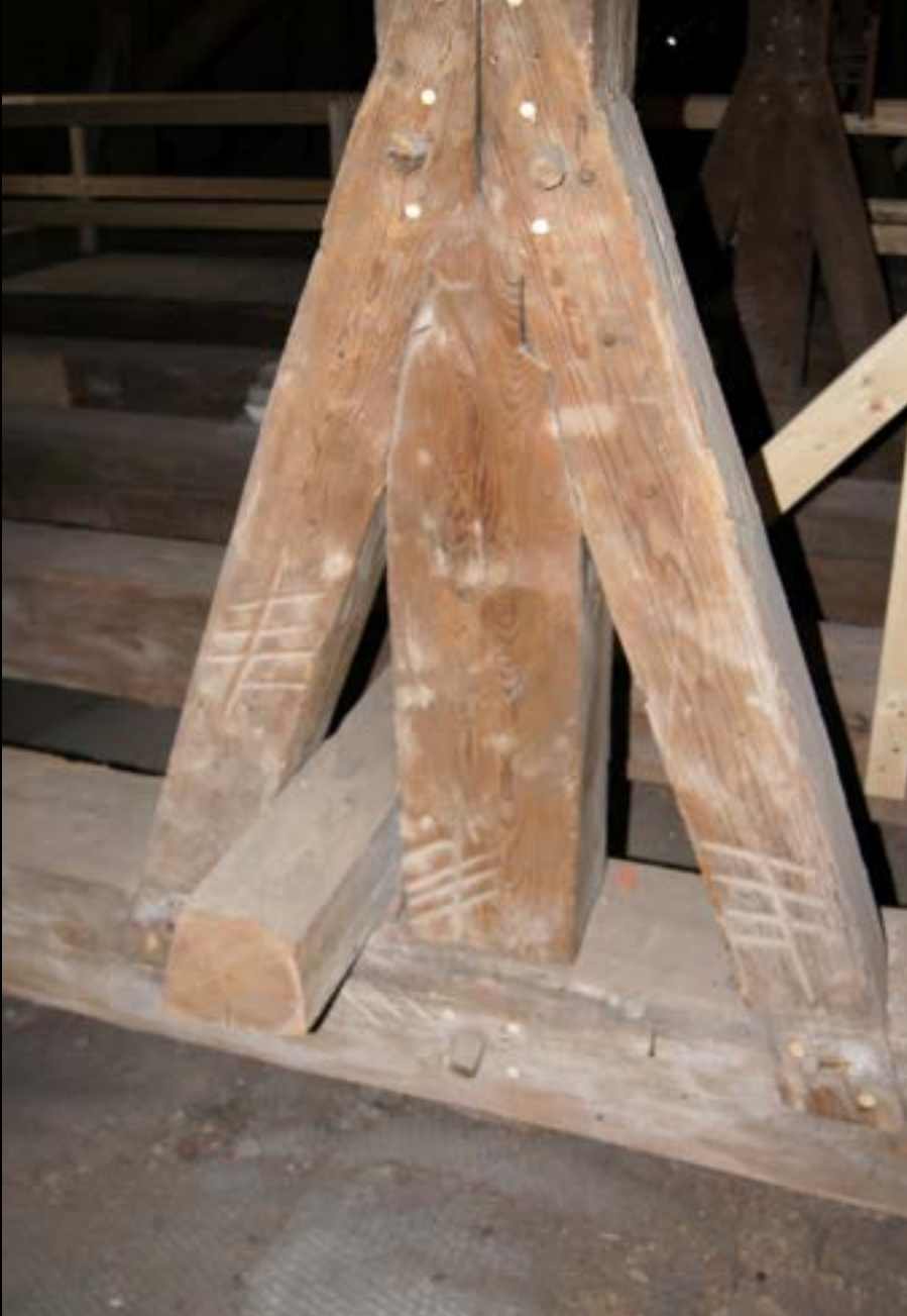
Integration von Hängewerk und Stuhl Zugfester Anschluss und unsinnige neue Ertüchtigung (Augsburg, St. Ulrich und Afra, Ende 15. Jh.)
