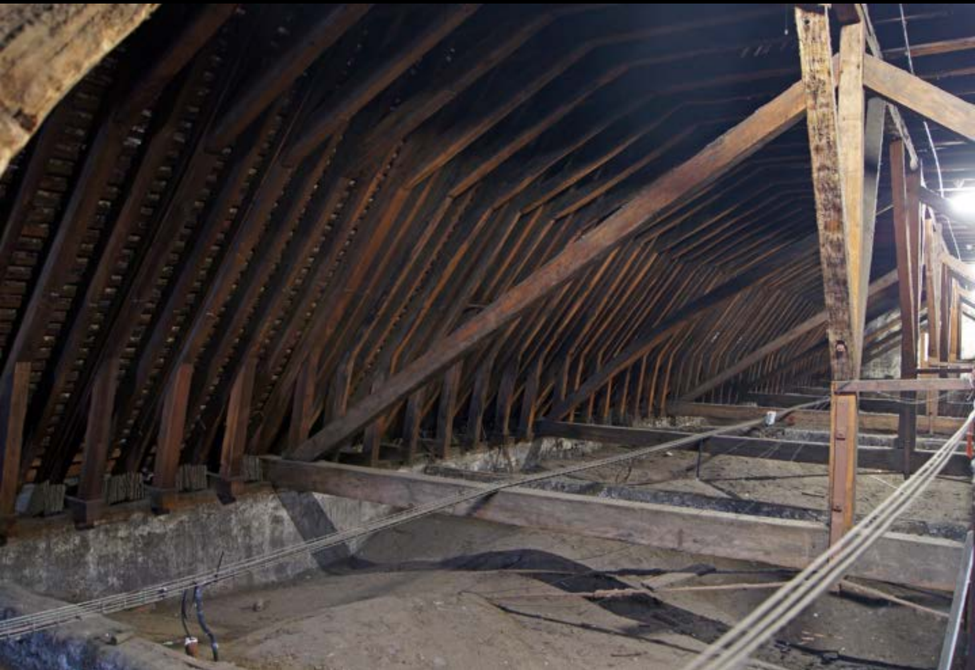
Dachwerk des Refektoriums von Saint-Martin-des-Champs, Paris (1220d)
