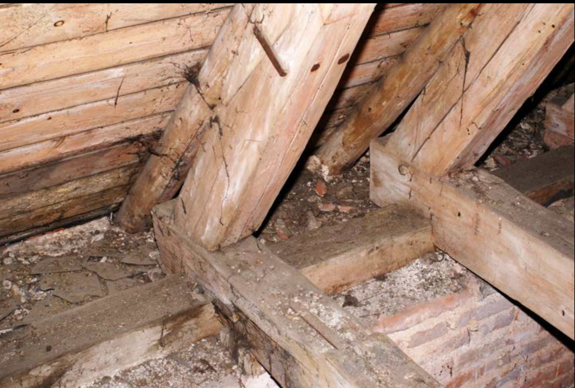
Mauerlatte und Gespärre, Aufschieblinge (Möschenfeld)
