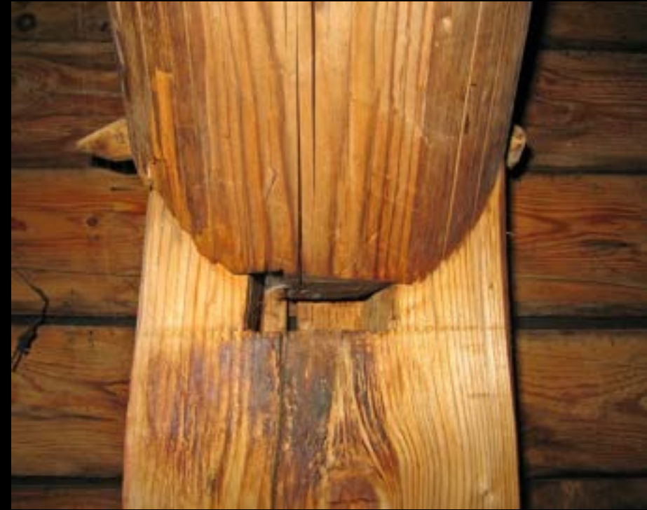
typische Situation am schrägen Zapfen Kehlbalken - Sparren
