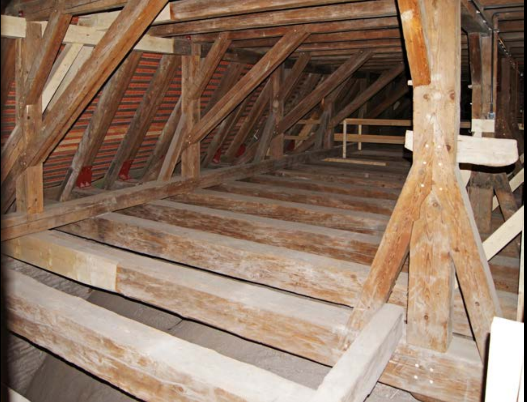
Integration von Hängewerk und Stuhl Aussteifung der Binderespärre durch Hängewerke (Augsburg, St. Ulrich und Afra, Ende 15. Jh.)
