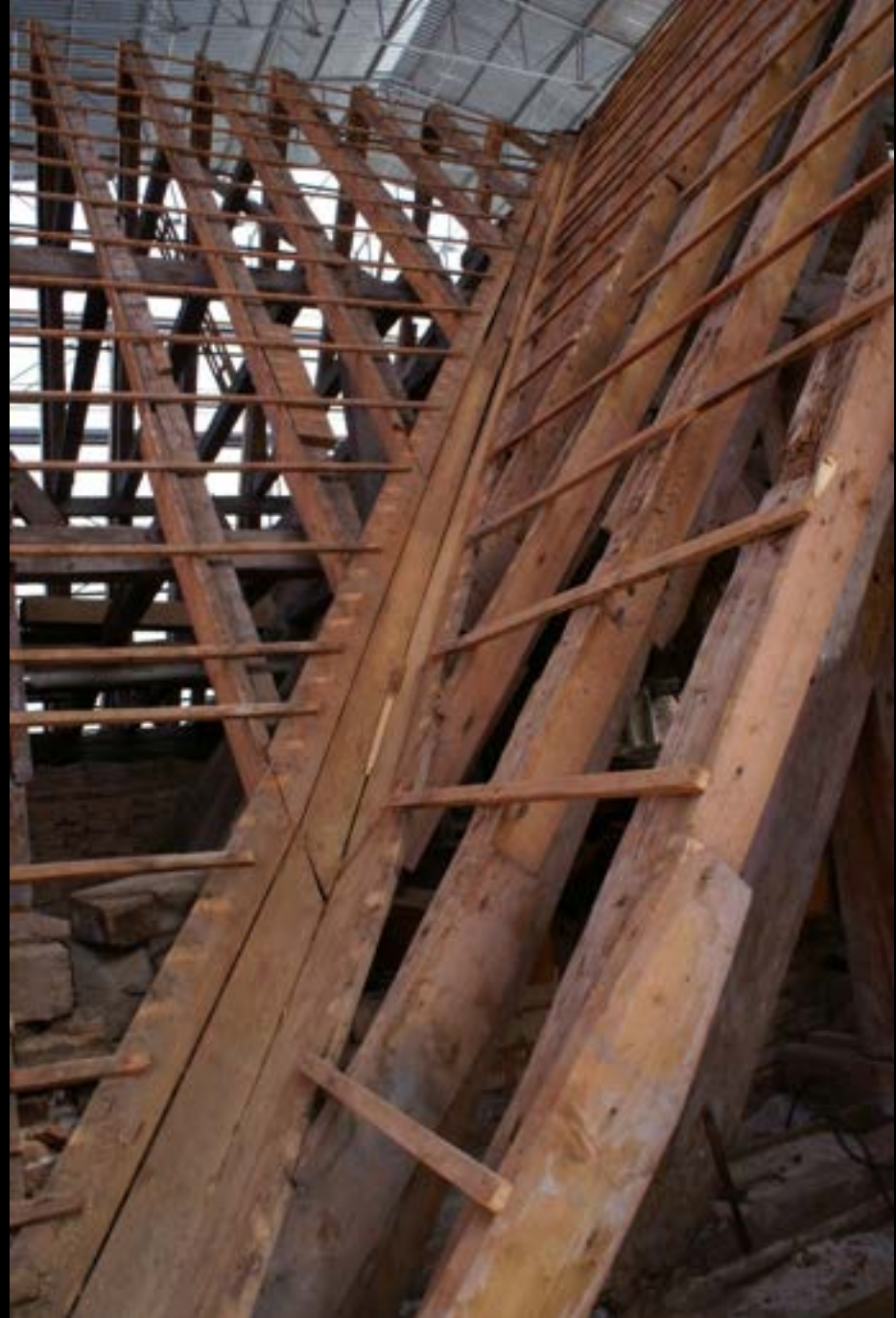
Dichte Gespärrefolge und Dachlattung (Beyharting, Klostergebäude)
