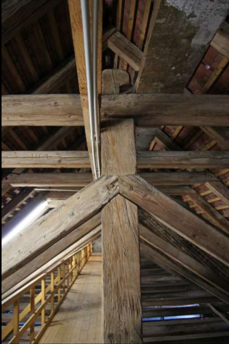
Oberes Ende der Hängesäule mit Zapfenschloss (Kempten, Stiftskirche St. Lorenz, um 1660)
