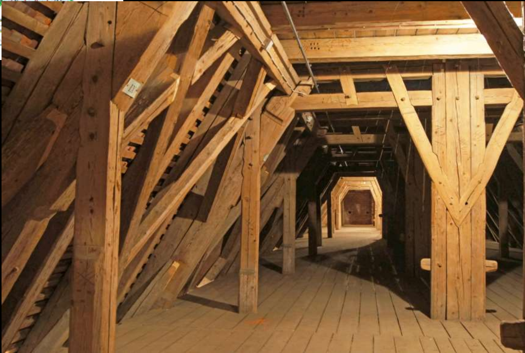
Ingolstadt, Liebfrauenkirche: Oberdach: Hängesäulen
