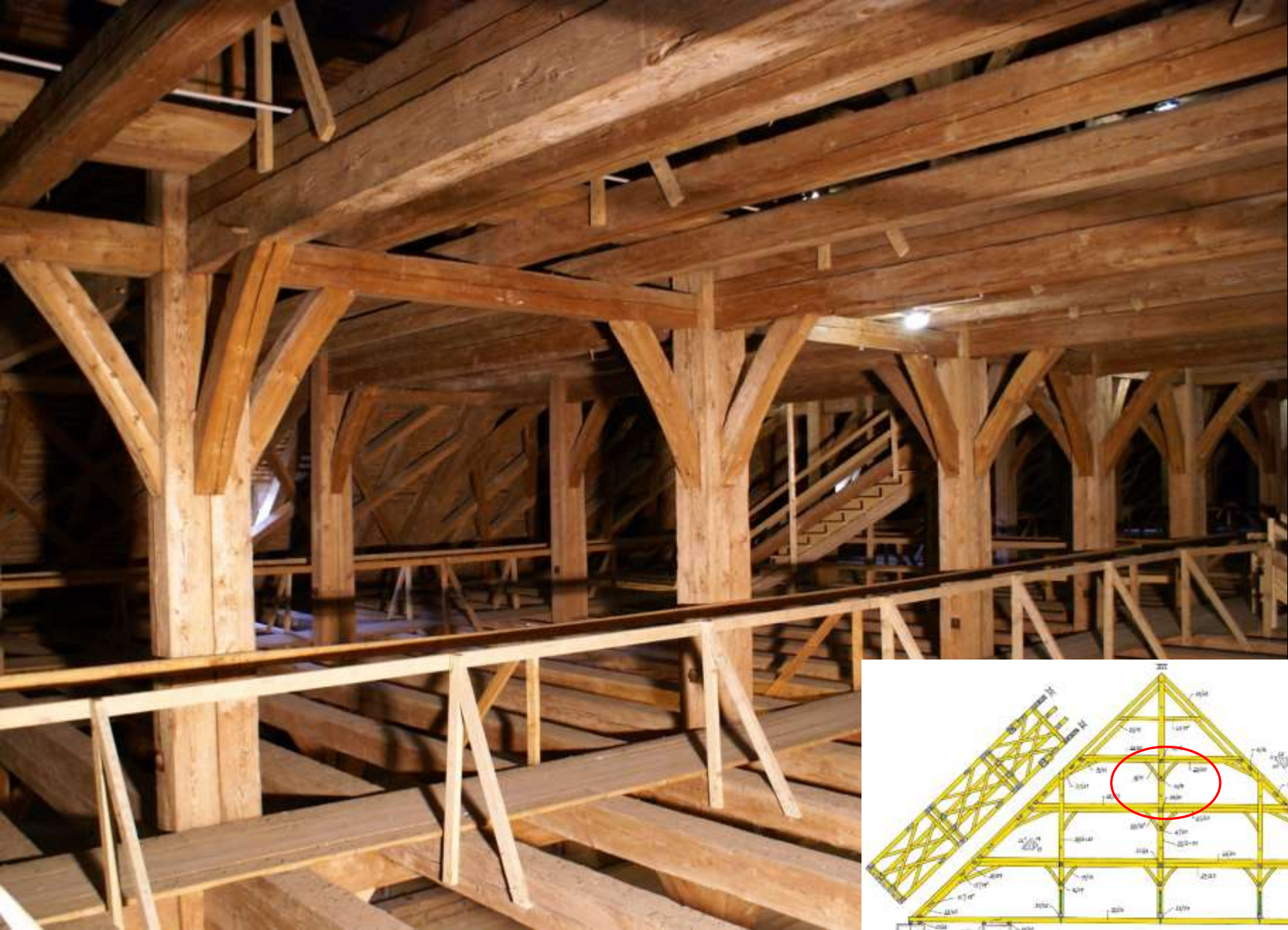
Fürstenfeld, Klosterkirche. Dachwerk. Zweiteilige Hängesäulen und Längsunterzug
