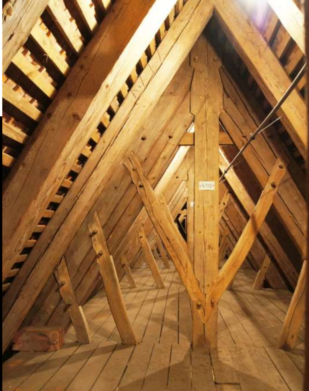
Ingolstadt, Liebfrauenkirche: Firstzone, Hängehölzer des Hängewerks
