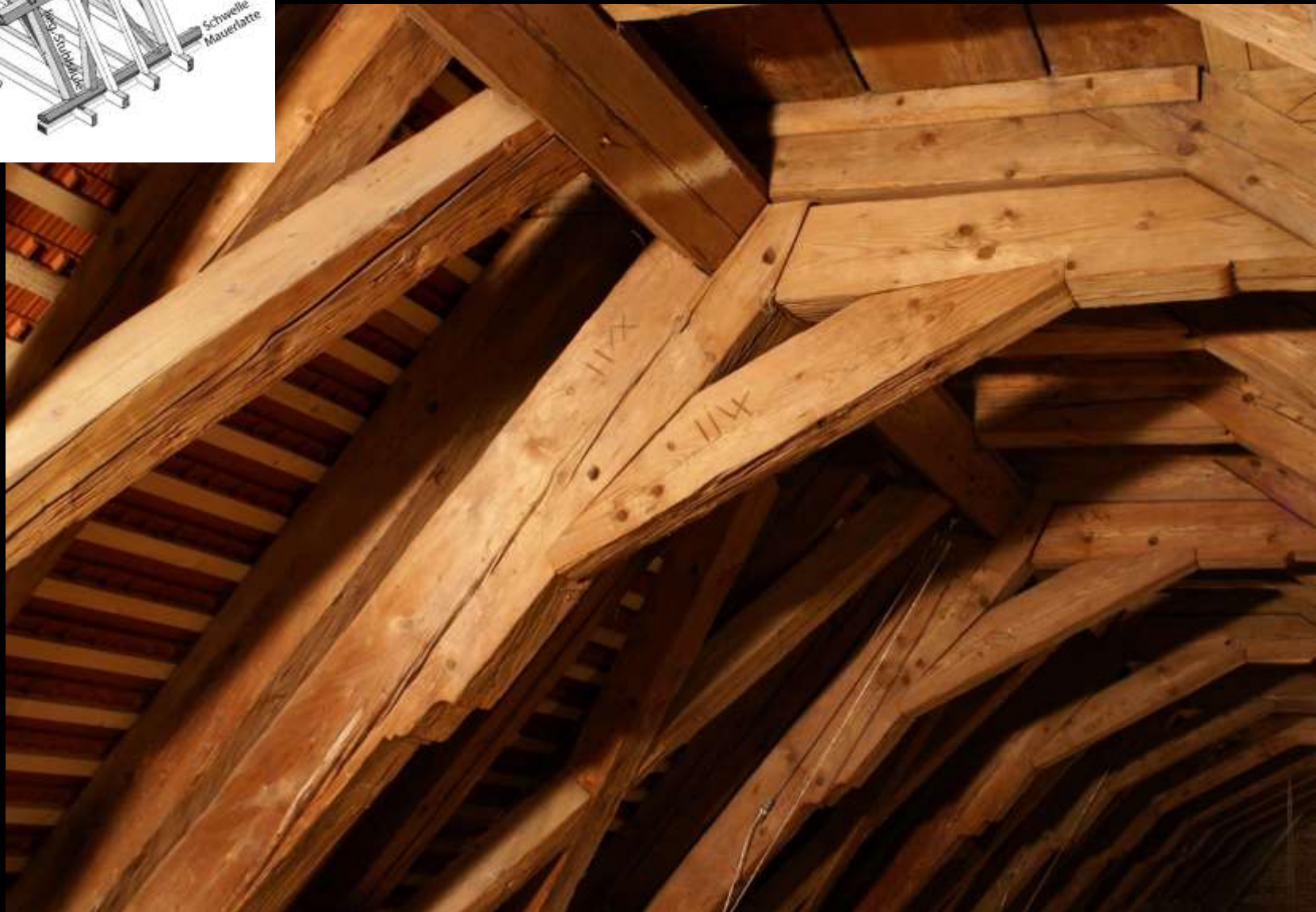
liegender Stuhl, kanonische Form: oberer Eckpunkt (Augsburg, ev. St. Ulrich, 1709)
