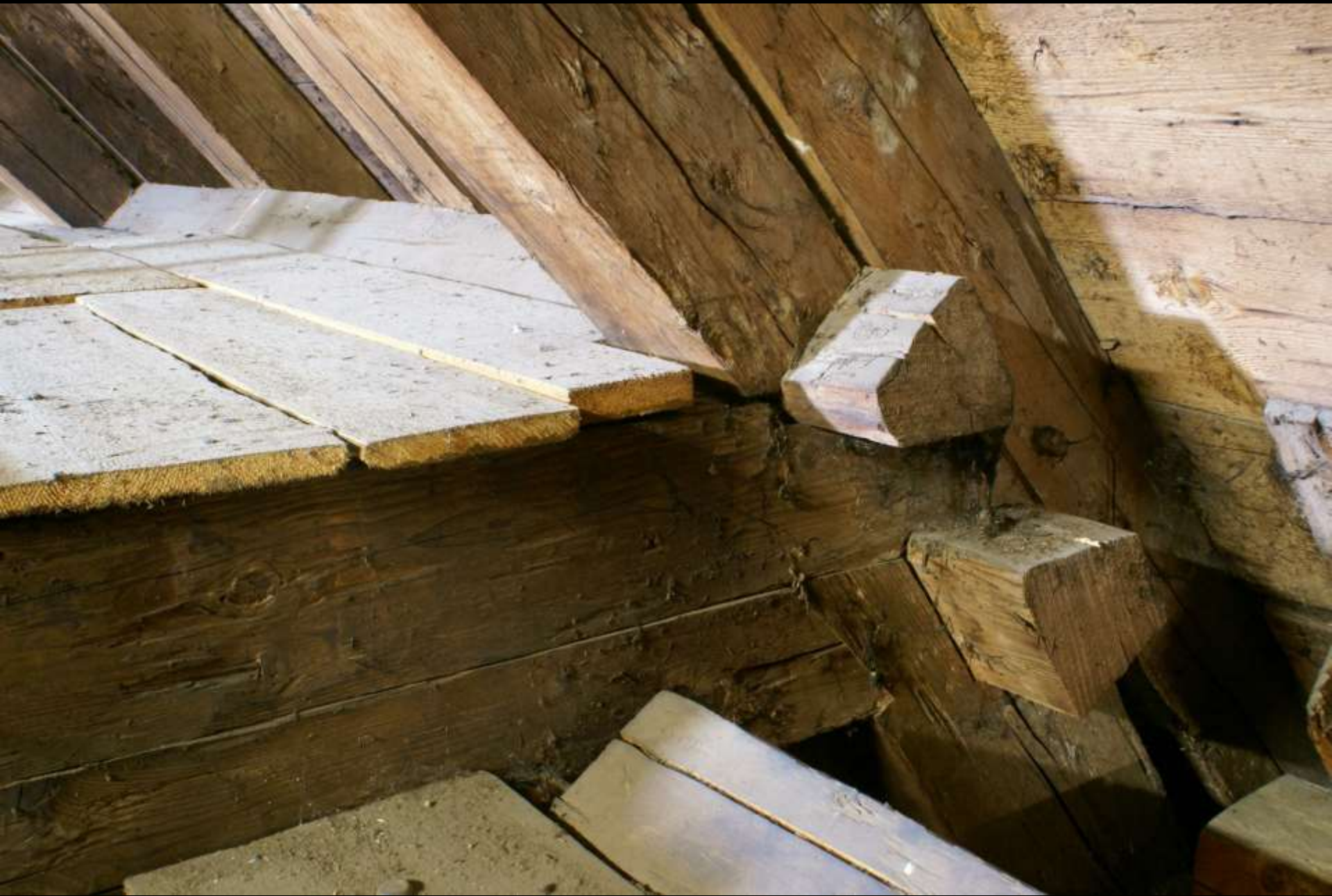
liegender Stuhl: Rähm und Schwelle bei gestapelten liegenden Stühlen (Oberammergau, 18. Jh.)
