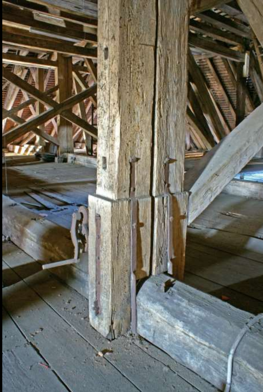
Doppelte, den Überzug umfassende Hängesäule (Erlangen, Hugenottenkirche, 2. H. 17. Jh.)
