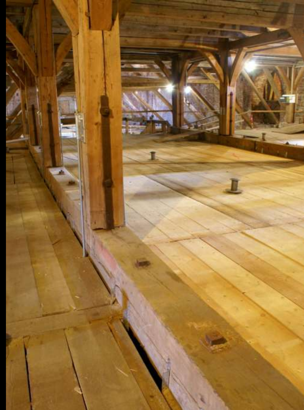
Fürstenfeld, Klosterkirche. Dachwerk. Überzug über der Zerrbalkenlage
