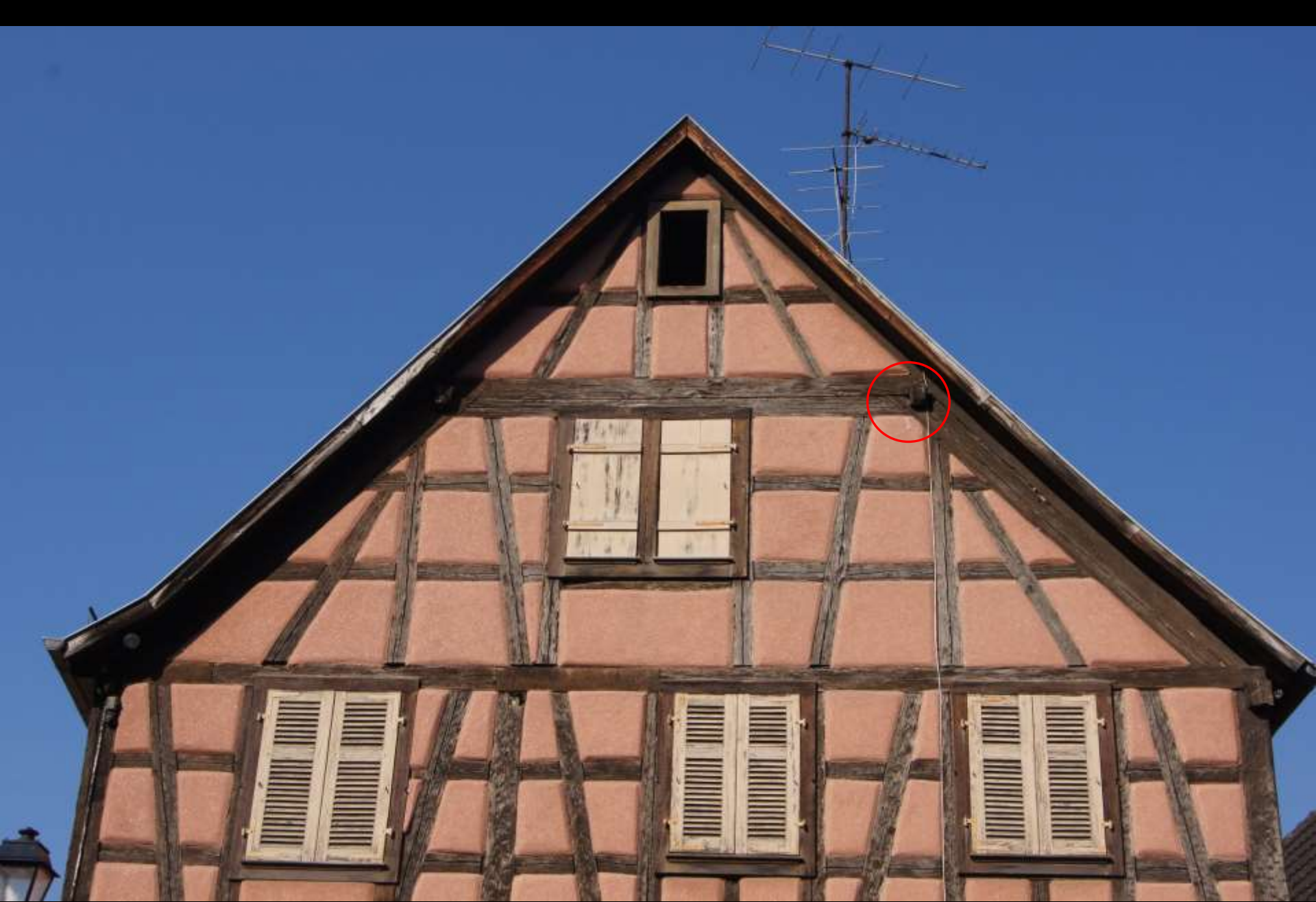
ablesbarer liegender Stuhl am Fachwerkgebel (Kaysersberg)
