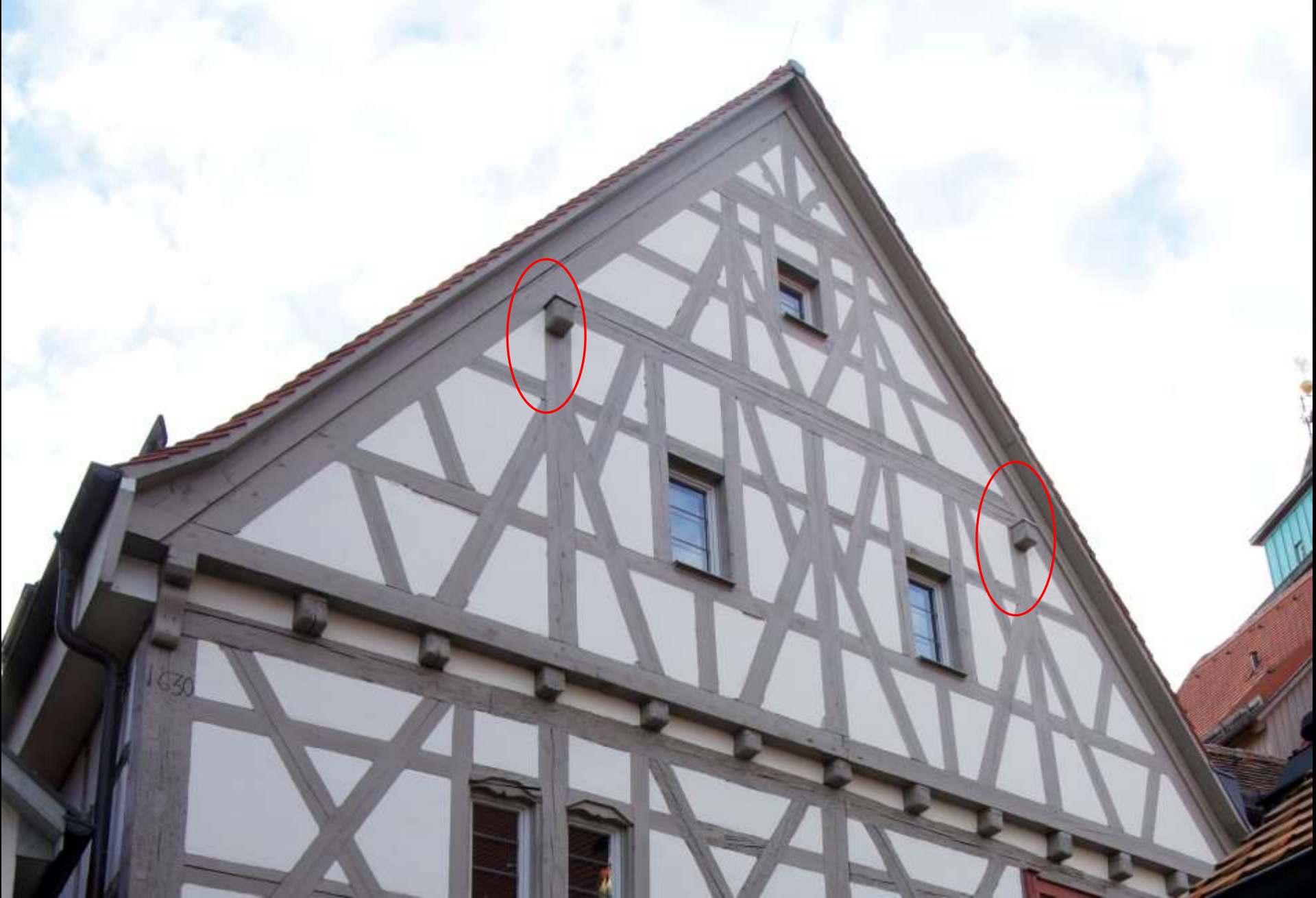
ablesbarer stehender Stuhl am Fachwerkgiebel (Markgröningen)
