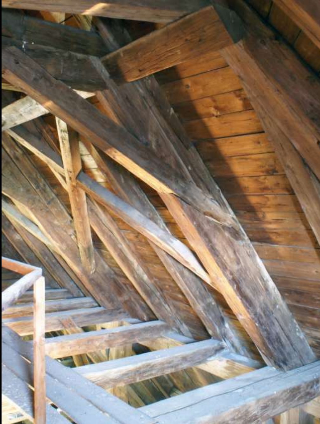
liegender Stuhl: Sonderformen – fehlende Fusschwelle (Tuntenhausen, 1.H. 17. Jh.)
