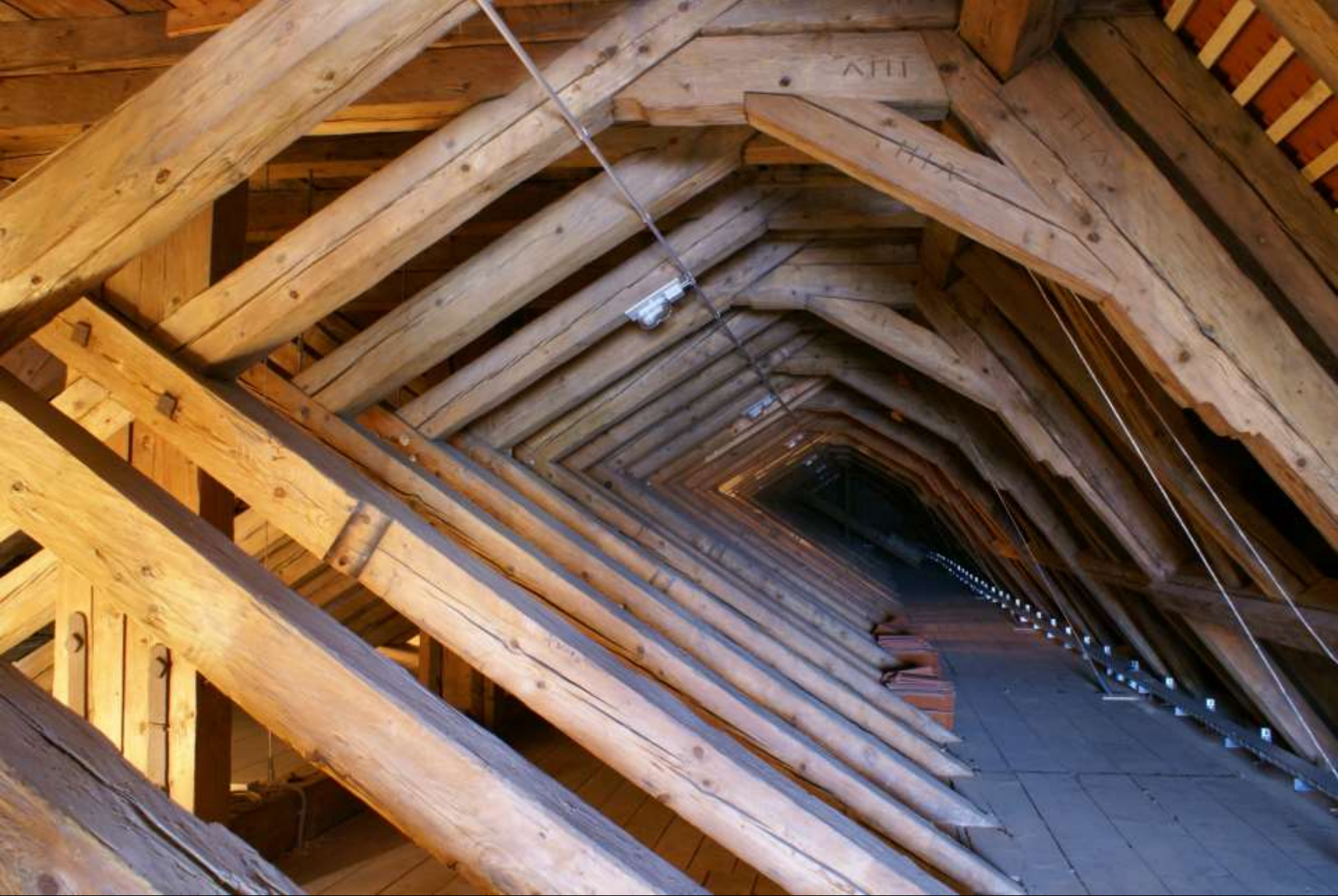
ev. St. Ulrich, Augsburg (1709-10). Dachwerk
