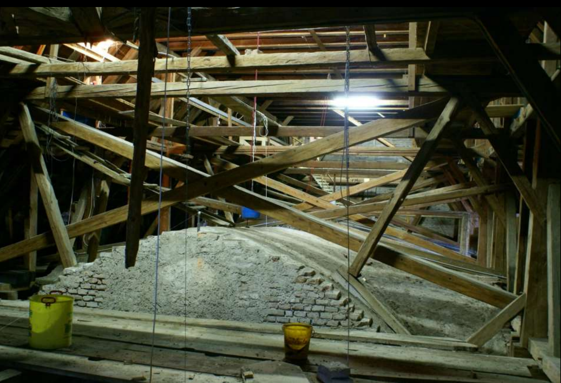
Tuntzenhausen, Wallfahrtskirche (1627-29). Dachwerk.
