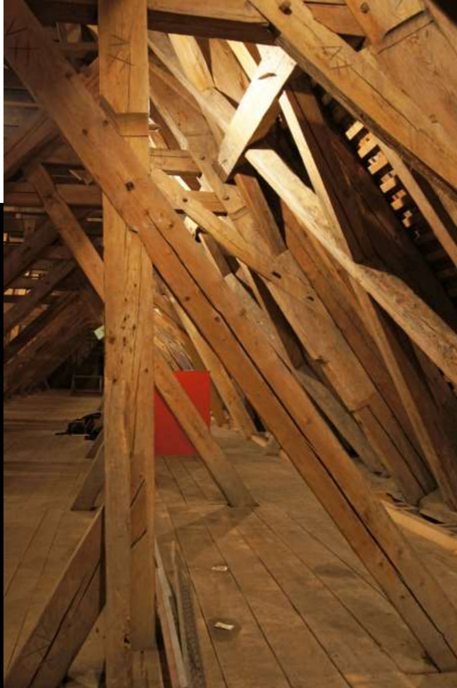
Ingolstadt, Liebfrauenkirche: Seitenschiffsdach, druchgehende liegende Stuhlsäule
