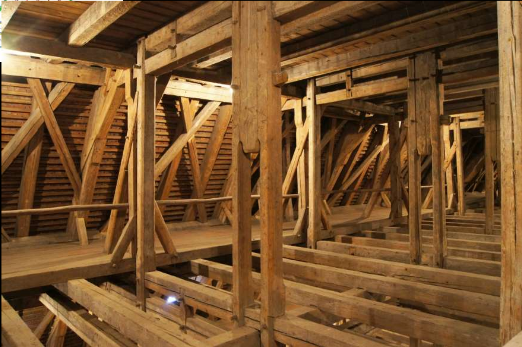
Ingolstadt, Liebfrauenkirche: Oberdach: Übergang von einfacher zu doppelter Hängesäule
