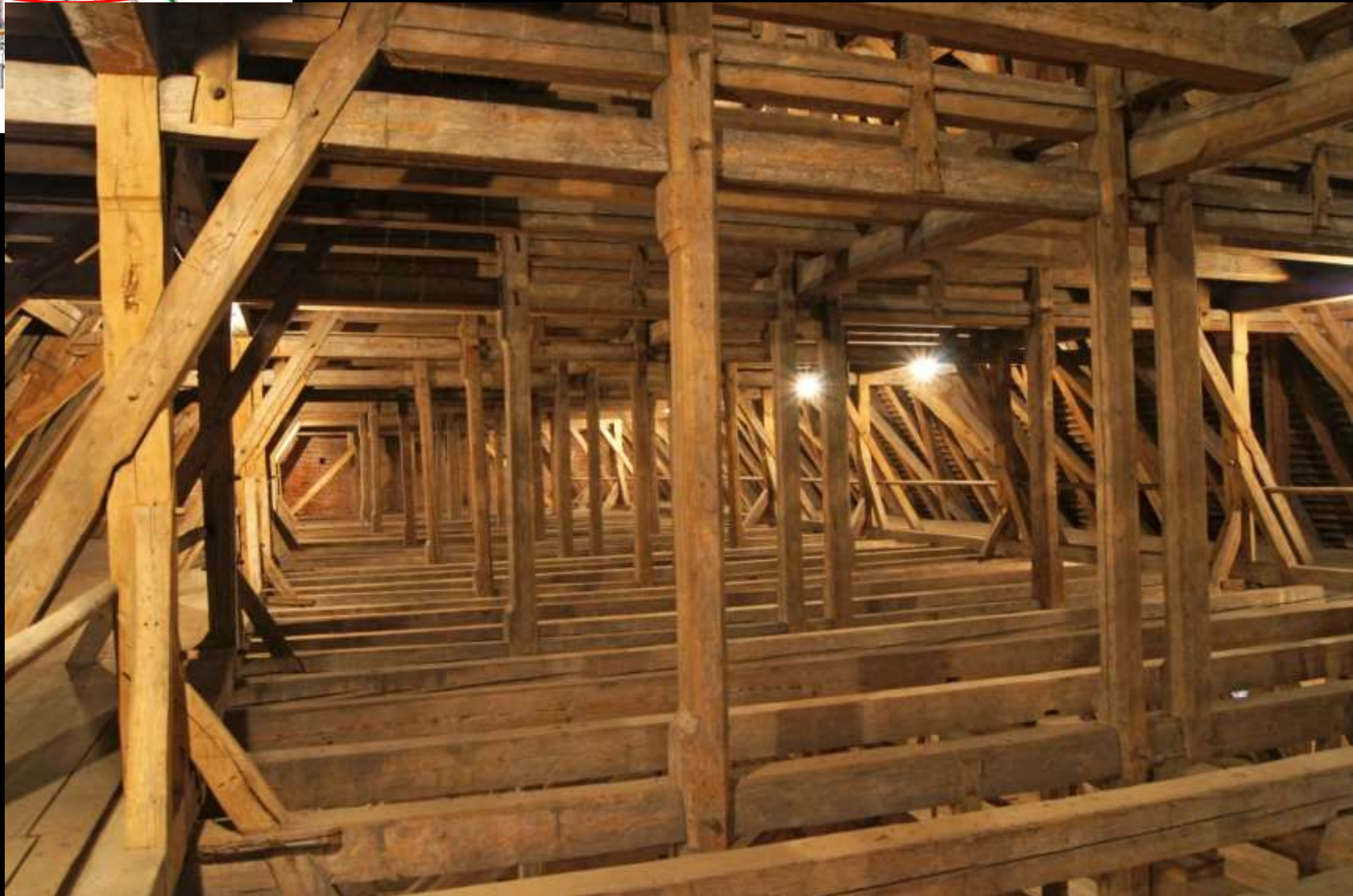
Ingolstadt, Liebfrauenkirche: oberes Stockwerk des Unterdaches, Hängesäulen und Stuhlsäulen
