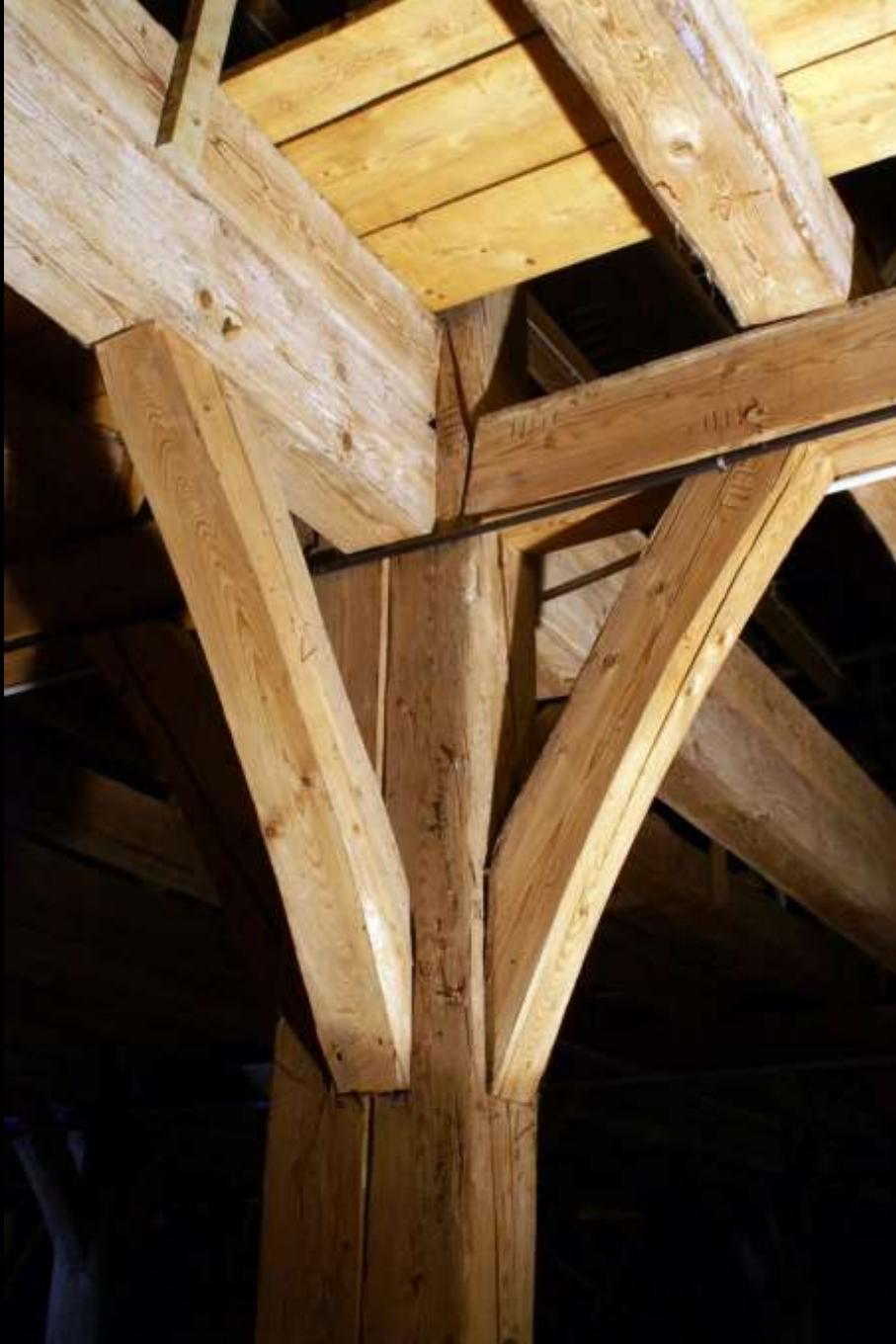
Fürstenfeld, Klosterkirche. Dachwerk. Zweiteilige Hängesäulen und Längsunterzug
