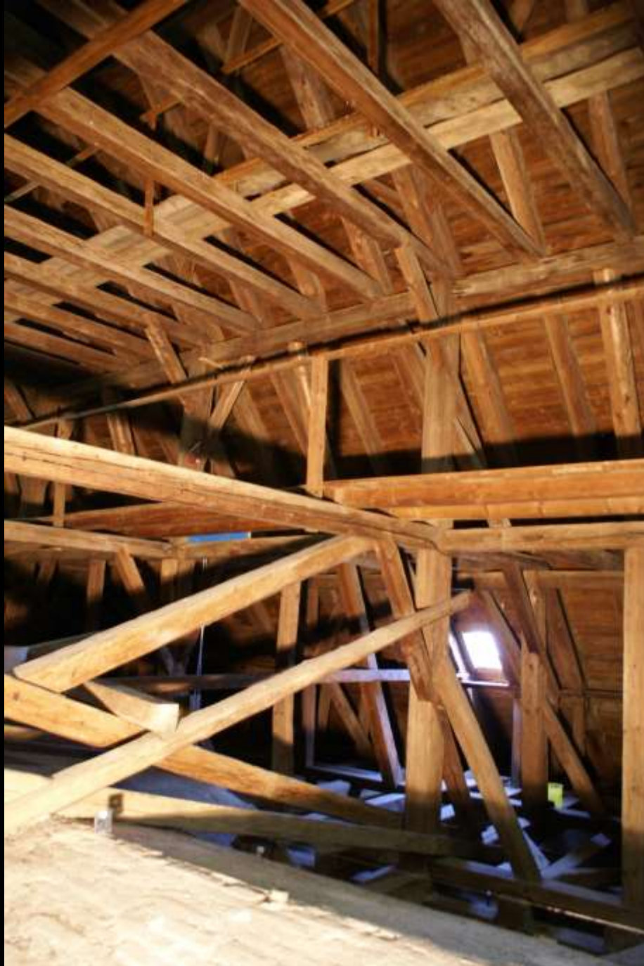
Tuntenhausen, Wallfahrtskirche (1627-29). Dachwerk. Hoher stehender Stuhl im unteren Stockwerk.
