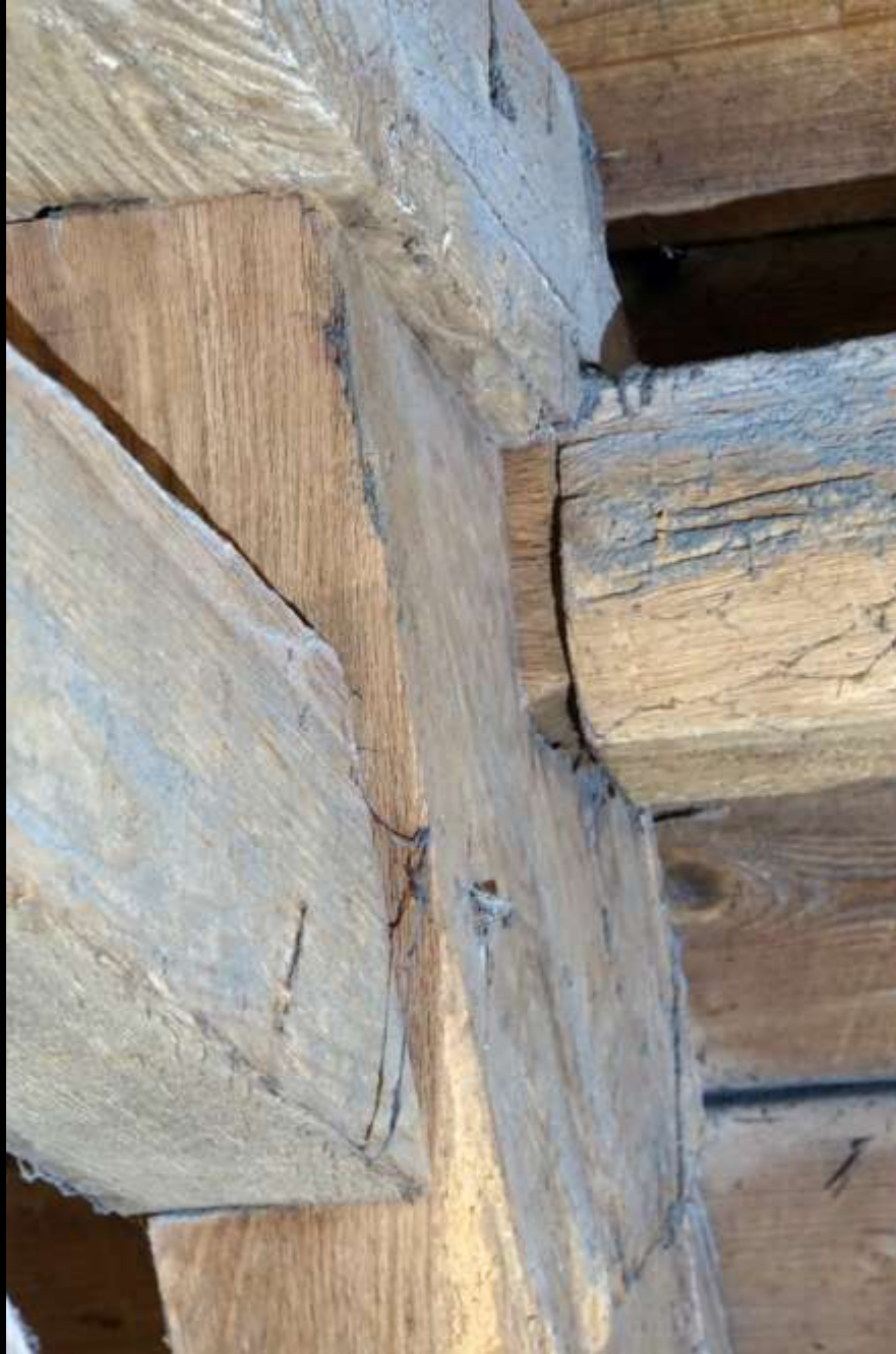
liegender Stuhl: Sonderformen – in die Stuhlsäule eingehälstes Rechteckkrähm (Limburg/Lahn, Dom, Ende 18. Jh.)
