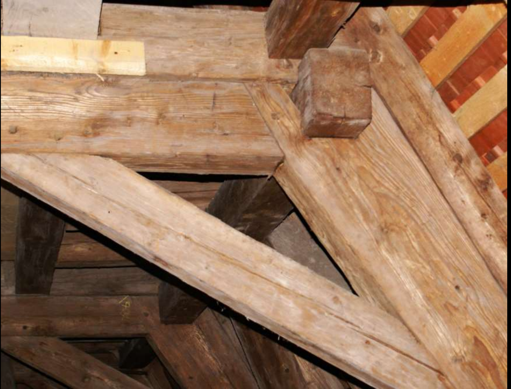
liegender Stuhl: Sonderformen – in die Stuhlsäule eingehälstes Rechteckkrähm (südwestdeutsch-schweizerische Variante, hier Salem, 18. Jh.)
