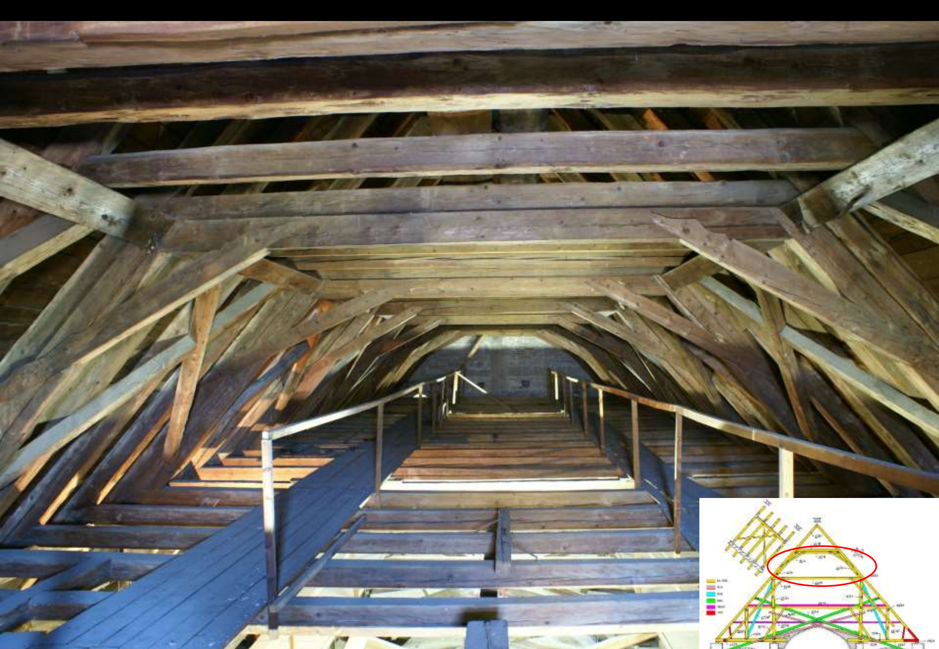
Tuntenhausen, Wallfahrtskirche (1627-29). Dachwerk. Liegender Stuhl im oberen Stockwerk.
