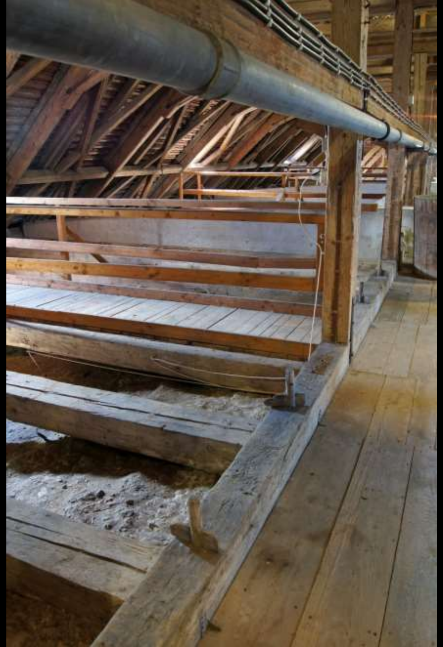
Hängesäule im Binder und Längsüberzug zur Aufhängung der Zerrbalken (Kempten, Stiftskirche St. Lorenz, um 1660)
