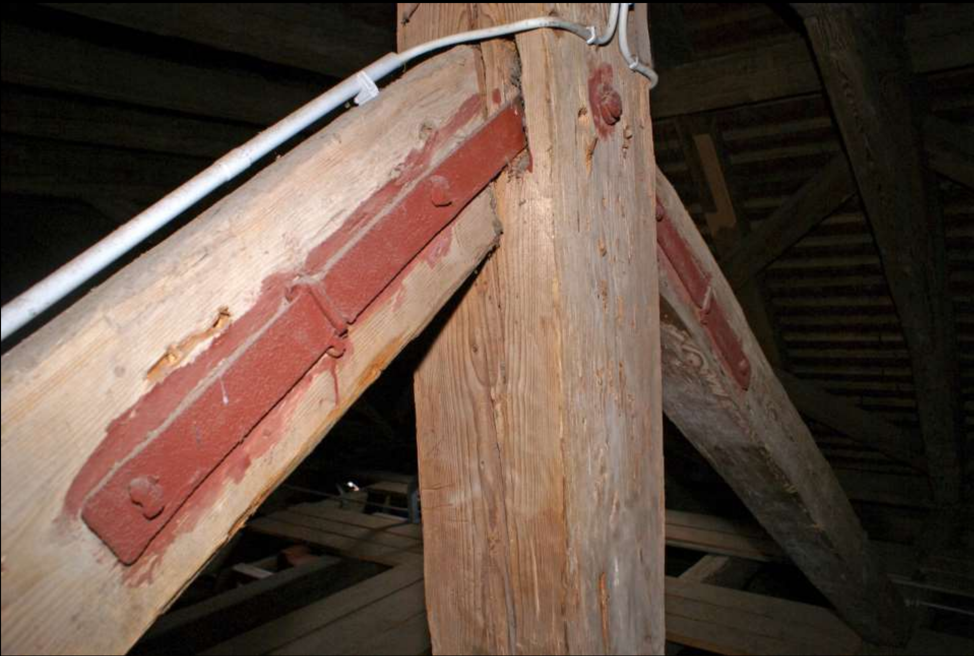
Perlach, St. Michael (1728). Hängesäule. Reparatur.
