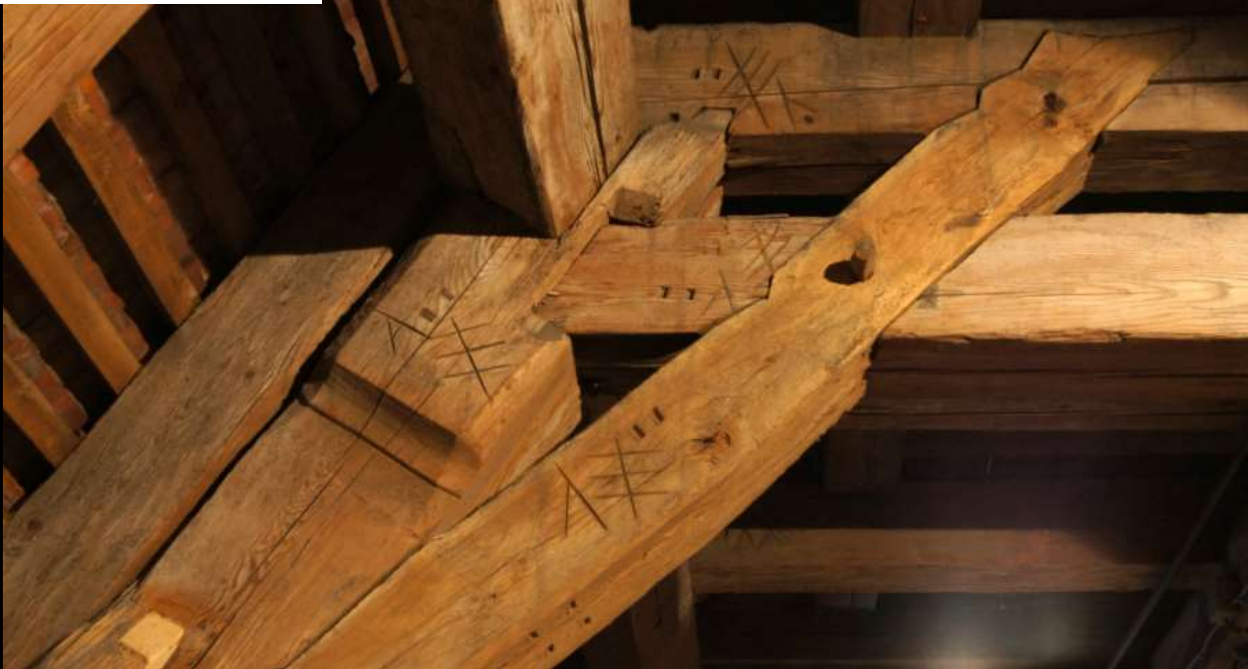
Ingolstadt, Liebfrauenkirche: oberes Stockwerk des Unterdaches, liegender Stuhl
