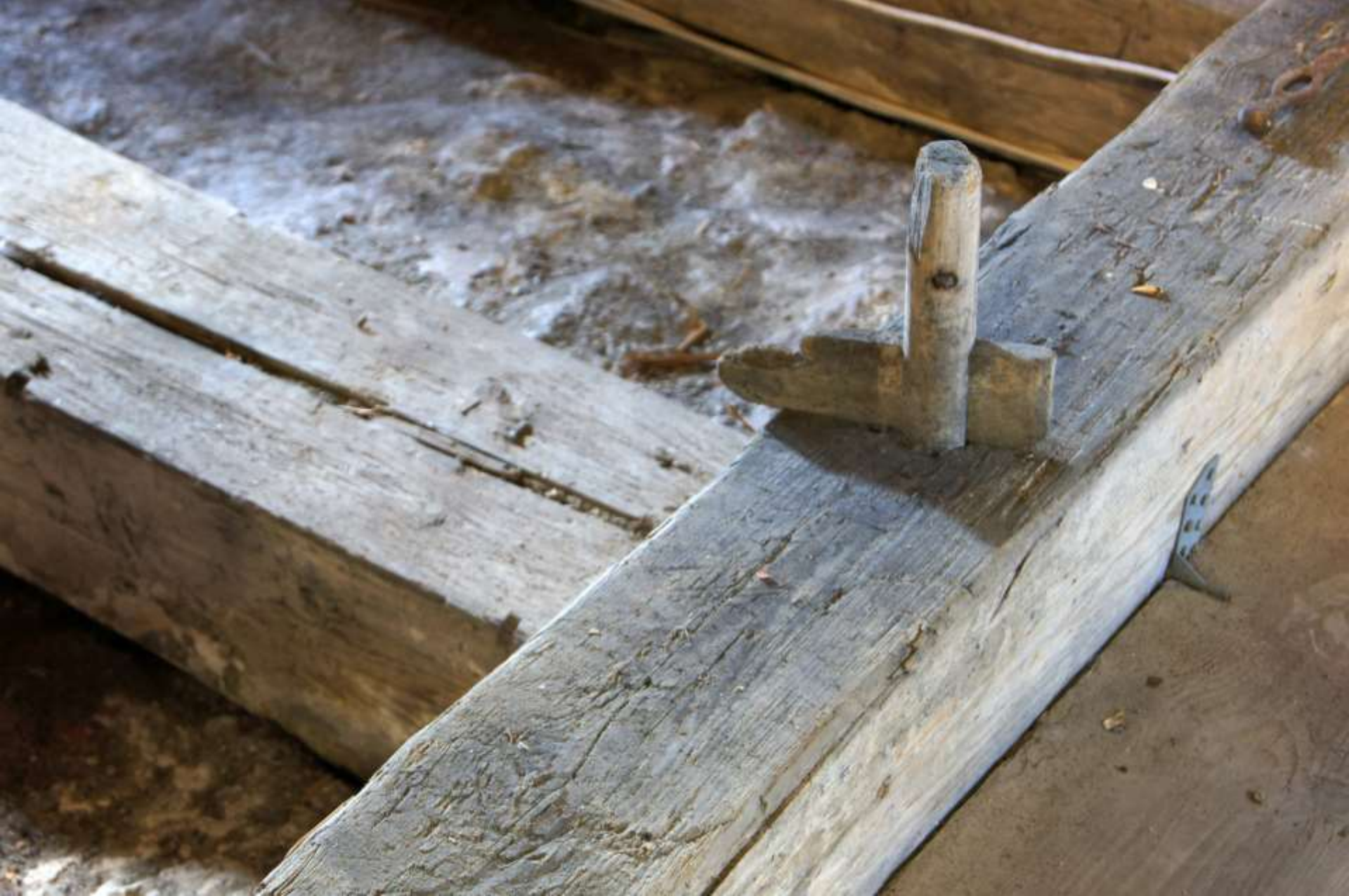
Hölzerner „Bolzen mit Splint“ zur Aufhängung der Zerrbalken im Leergespärre (Kempten, Stiftskirche St. Lorenz, um 1660)
