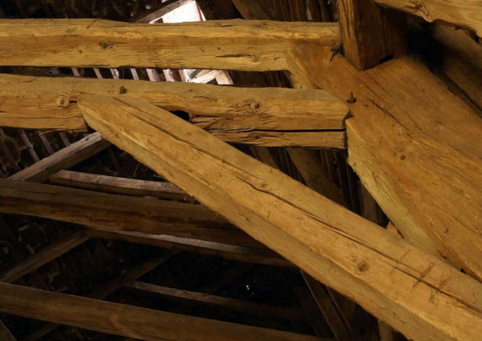
liegender Stuhl: Sonderformen – Spannriegel und Kehlbalken durch Zwischenraum getrennt (Corvey, 17. Jh.)
