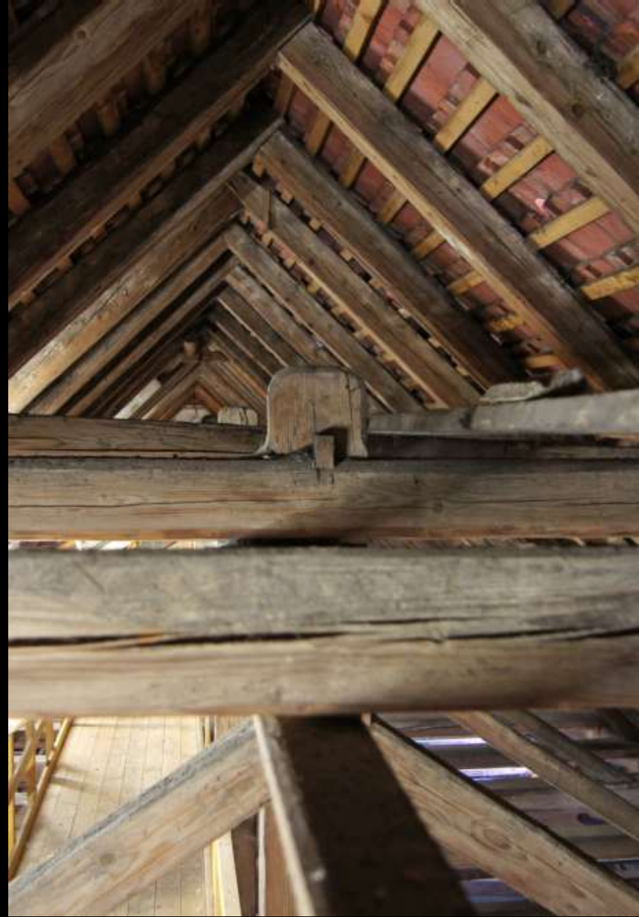
Oberes Ende der Hängesäule mit Zapfenschloss (Kempten, Stiftskirche St. Lorenz, um 1660)
