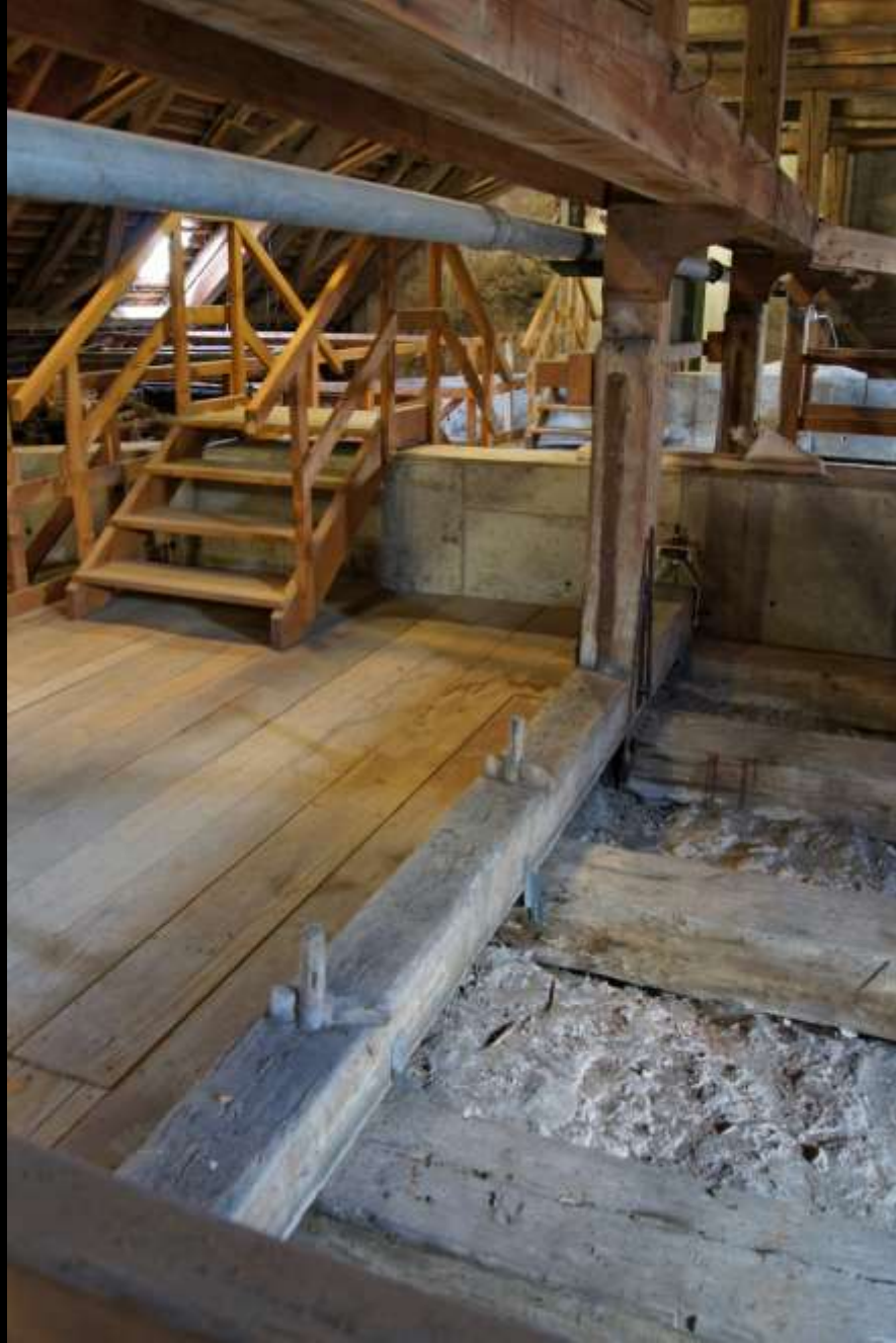
Hängesäule im Binder und Längsüberzug zur Aufhängung der Zerrbalken (Kempten, Stiftskirche St. Lorenz, um 1660)
