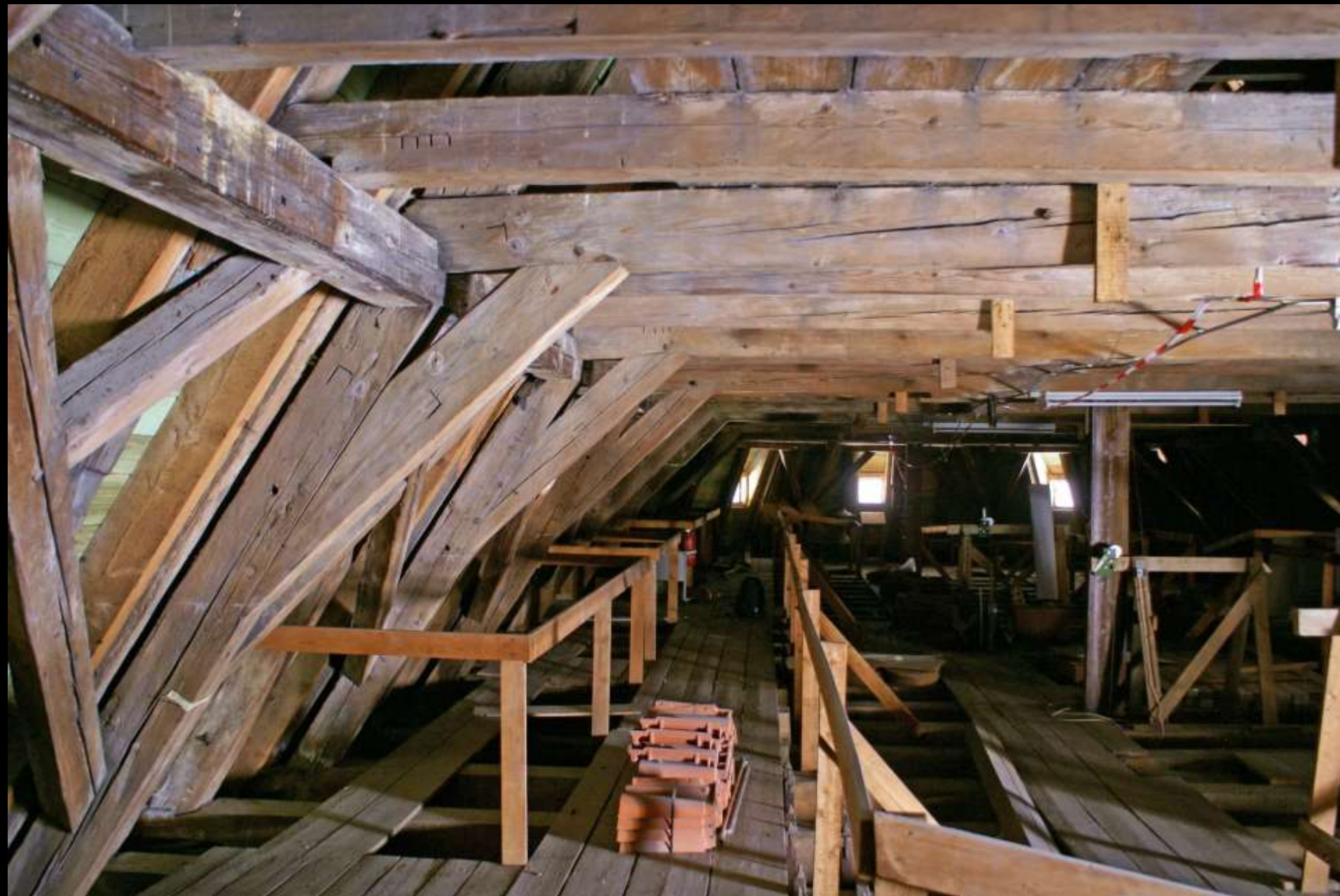
liegender Stuhl: Sonderformen – fehlender Spannriegel (Salvatorkirche München, Ende 15. Jh.)
