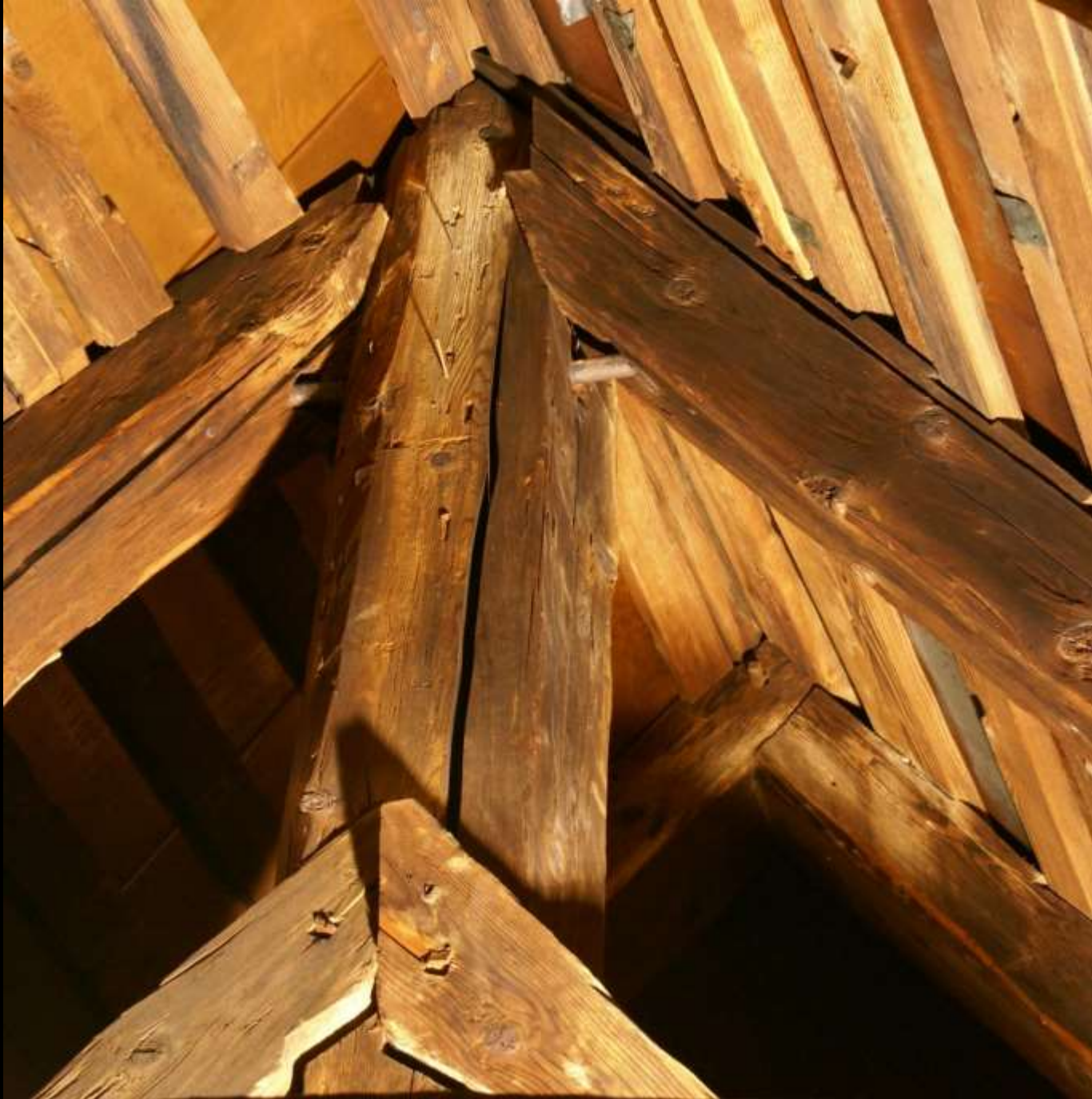
Versatz der Sparren in den Kopf der Hängesäule (Augsburg, ev. Hl. Kreuz, Mitte 17. Jh.)
