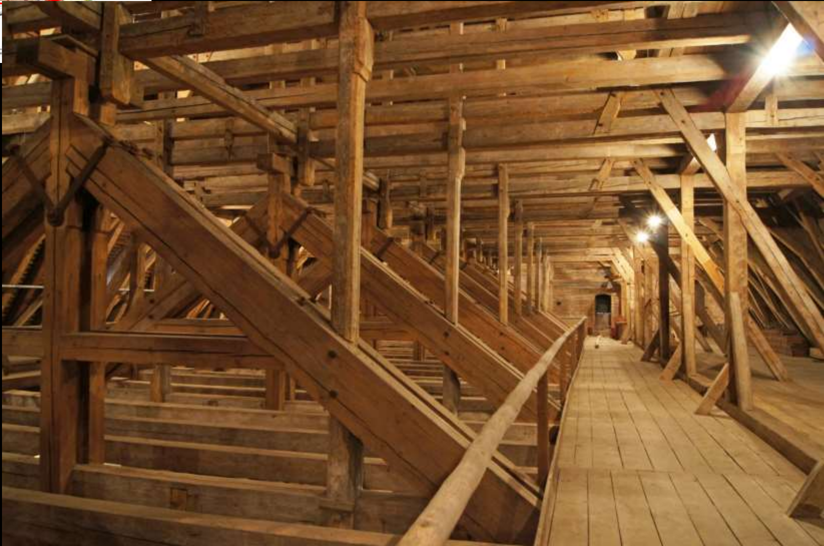
Ingolstadt, Liebfrauenkirche: Hauptkehlbalkenebene, Hängesäulen und stehende Stühle
