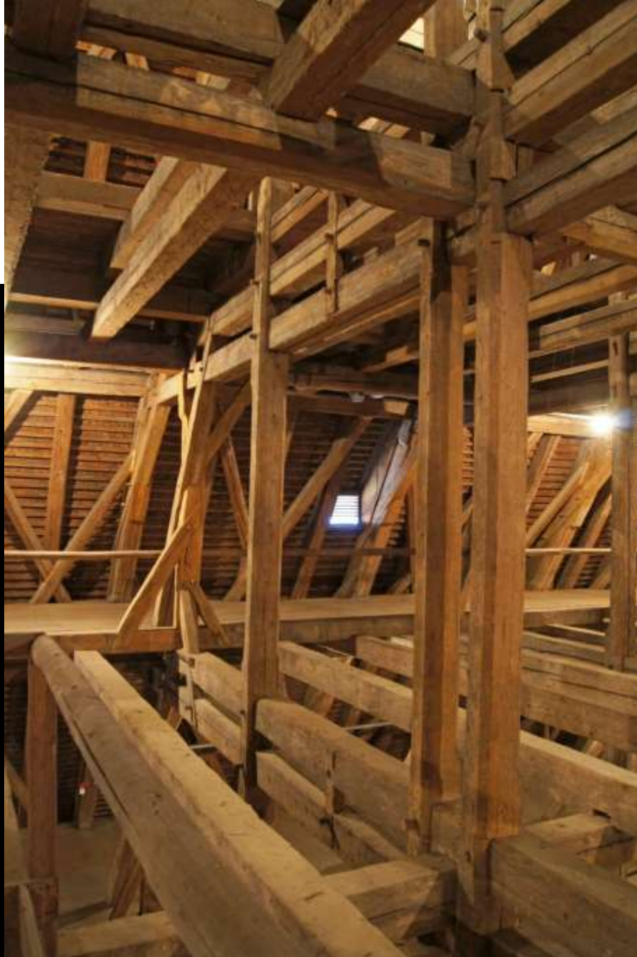
Ingolstadt, Liebfrauenkirche: oberes Stockwerk des Unterdaches und Übergang zum Oberdach
