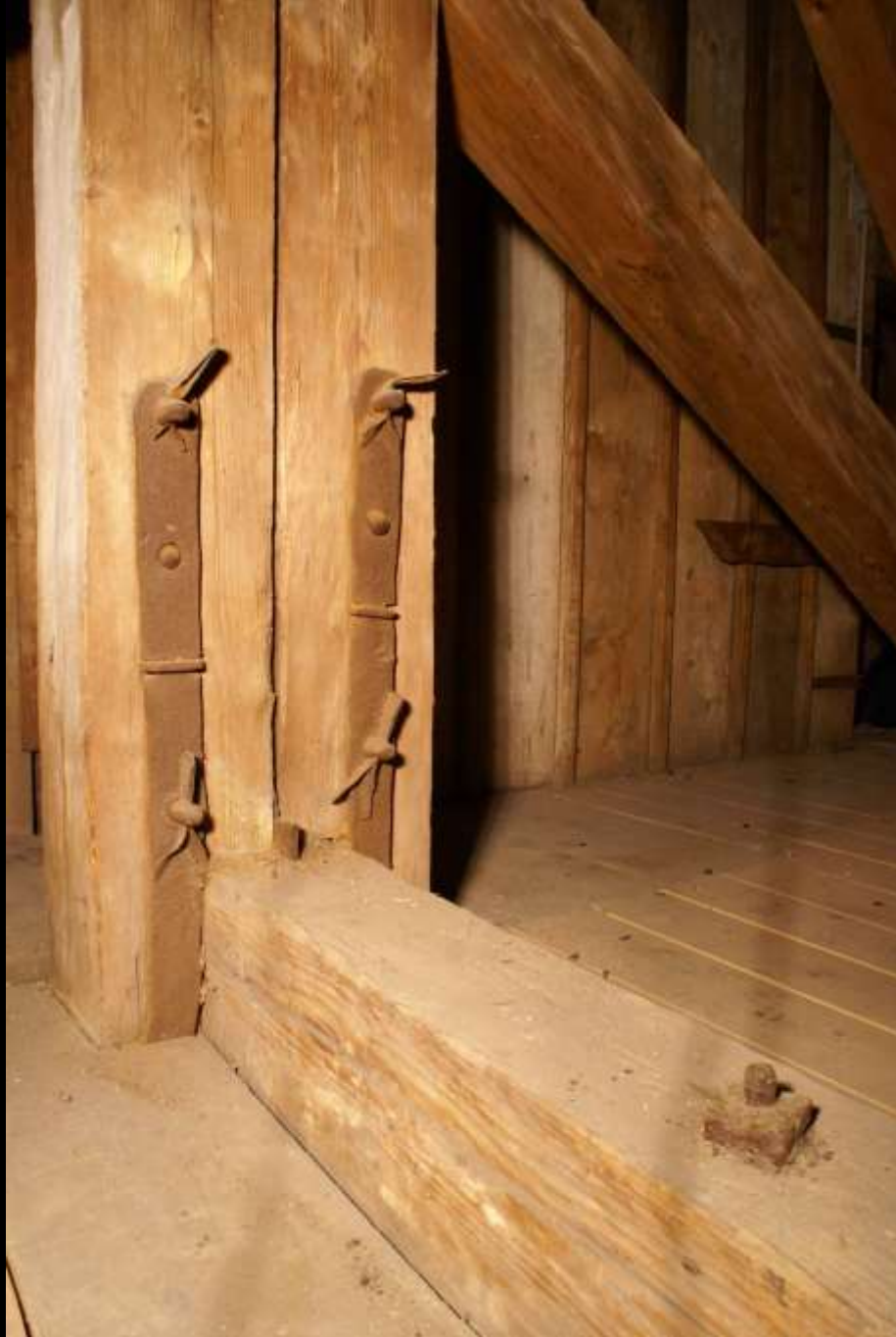
ev. St. Ulrich, Augsburg (1709-10). Dachwerk
