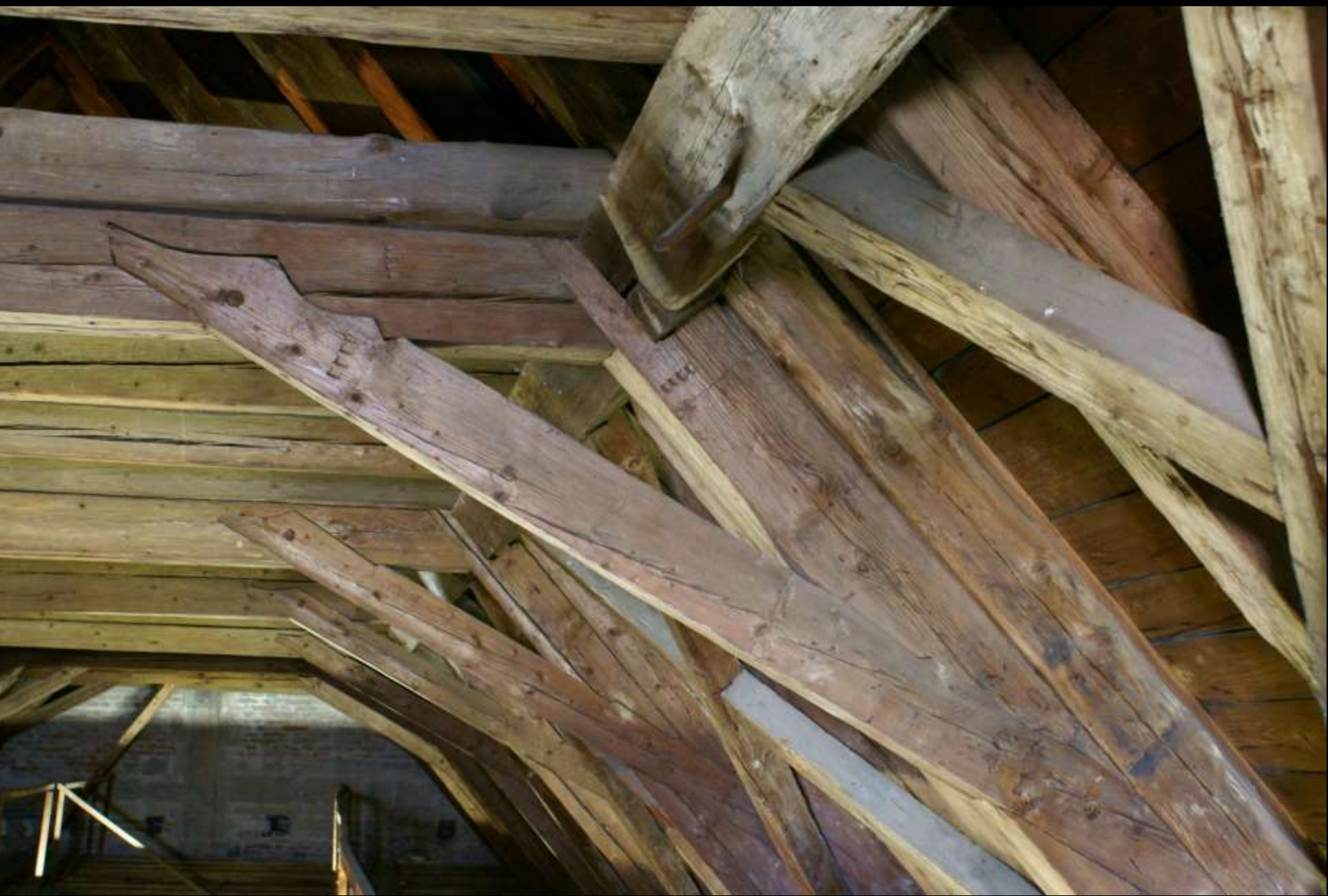
liegender Stuhl: Anschluss der Kopfbänder: Blattverbindung (Tuntenhausen, 17. Jh.)
