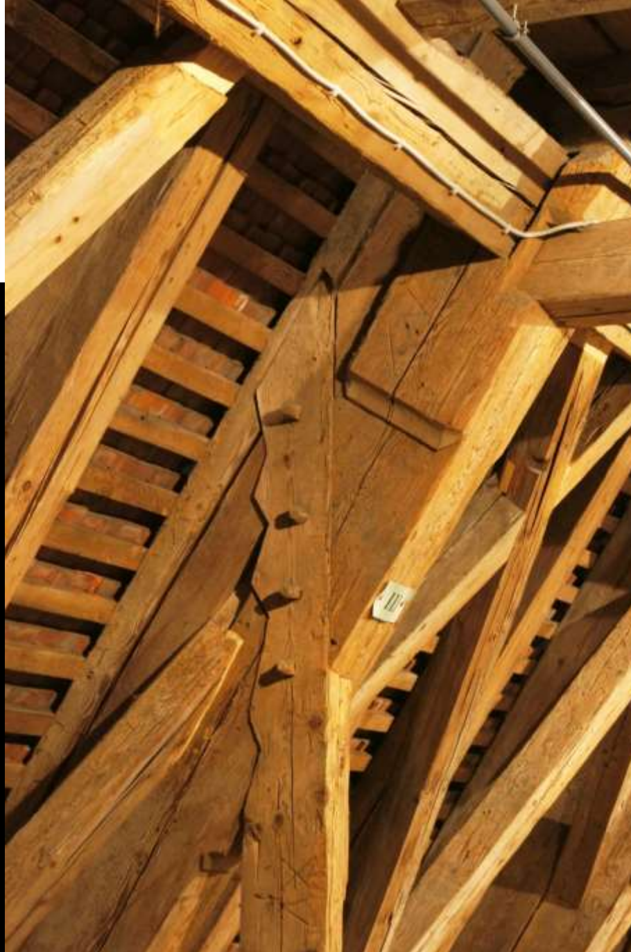
Ingolstadt, Liebfrauenkirche: Oberdach: Anschluss der seitlichen Hängesäulen
