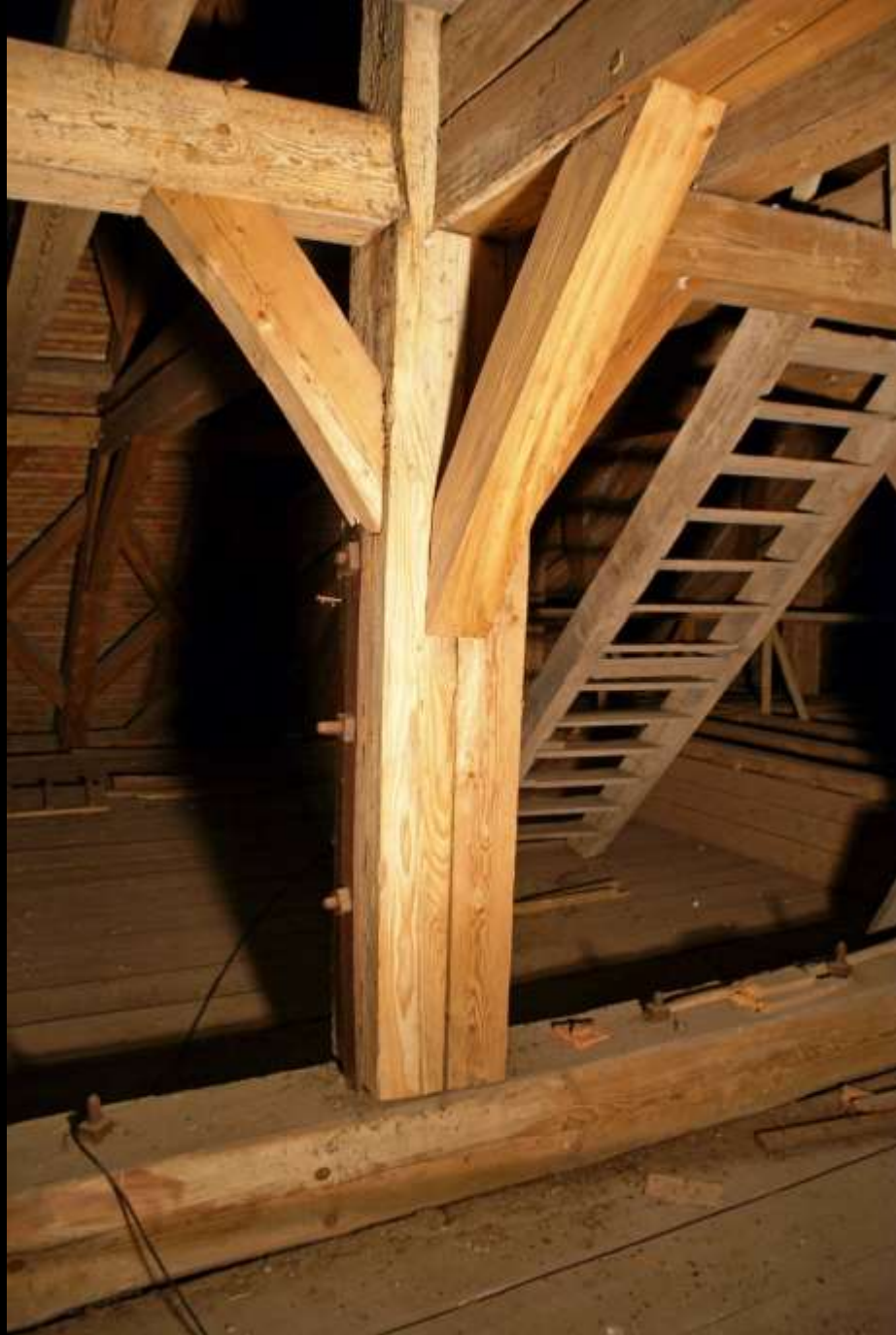
Fürstenfeld, Klosterkirche. Dachwerk. Überzug über der Zerrbalkenlage
