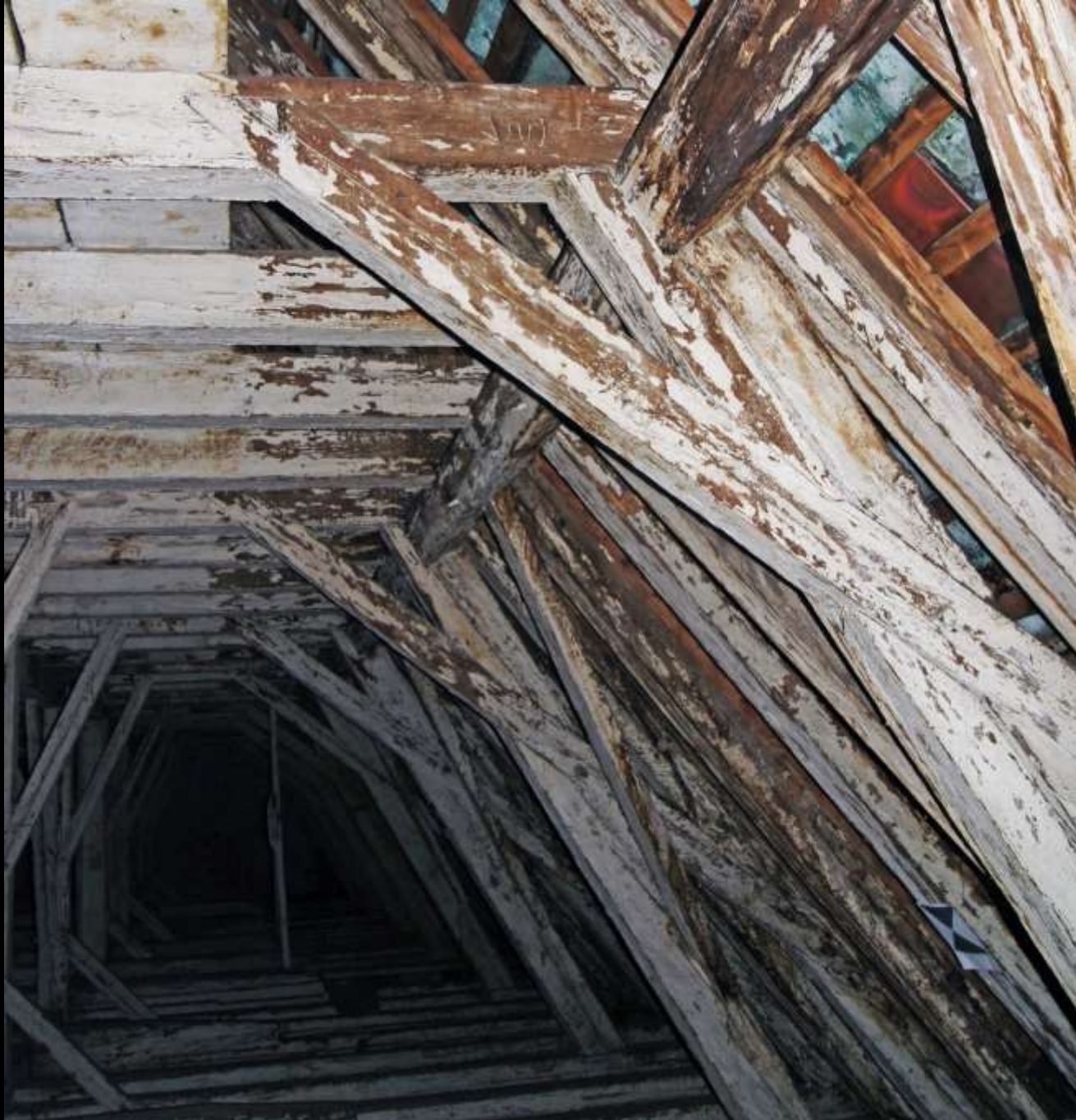
liegender Stuhl: Sonderformen – fehlender Spannriegel (Schwaz, 15. Jh.)
