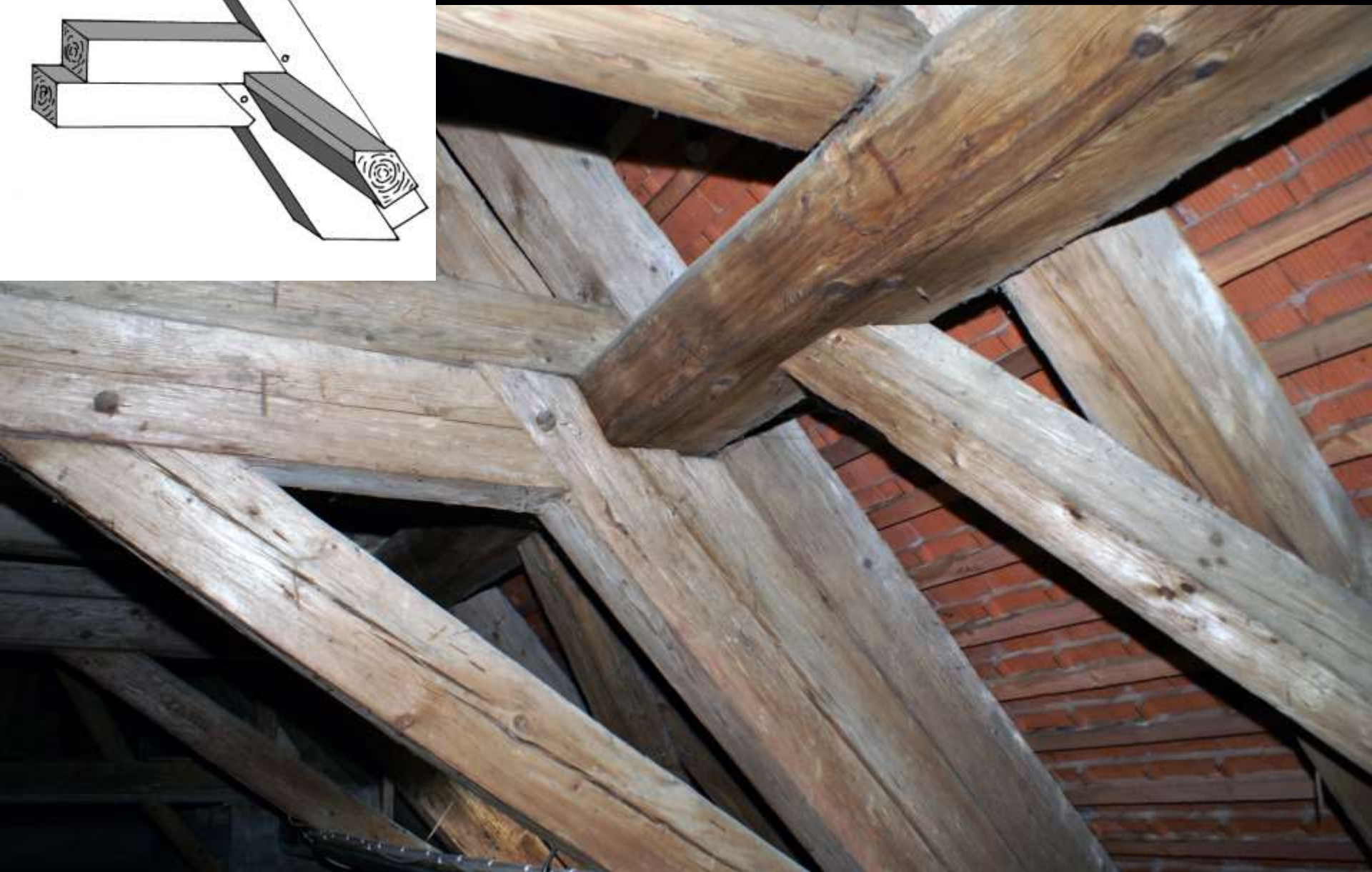
liegender Stuhl: Sonderformen – falsch geschnittenes Rähm (Glonn, 2. H. 18. Jh.)
