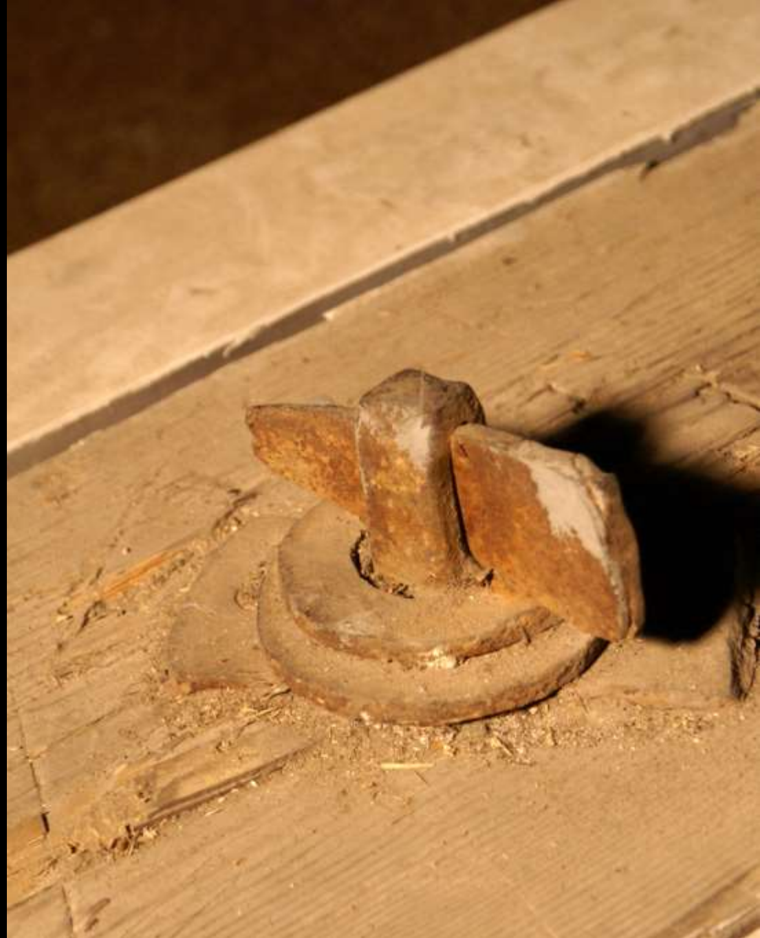
Aufhängung des Zerrbalkens mit Splintbolzen (Mittenwald)
