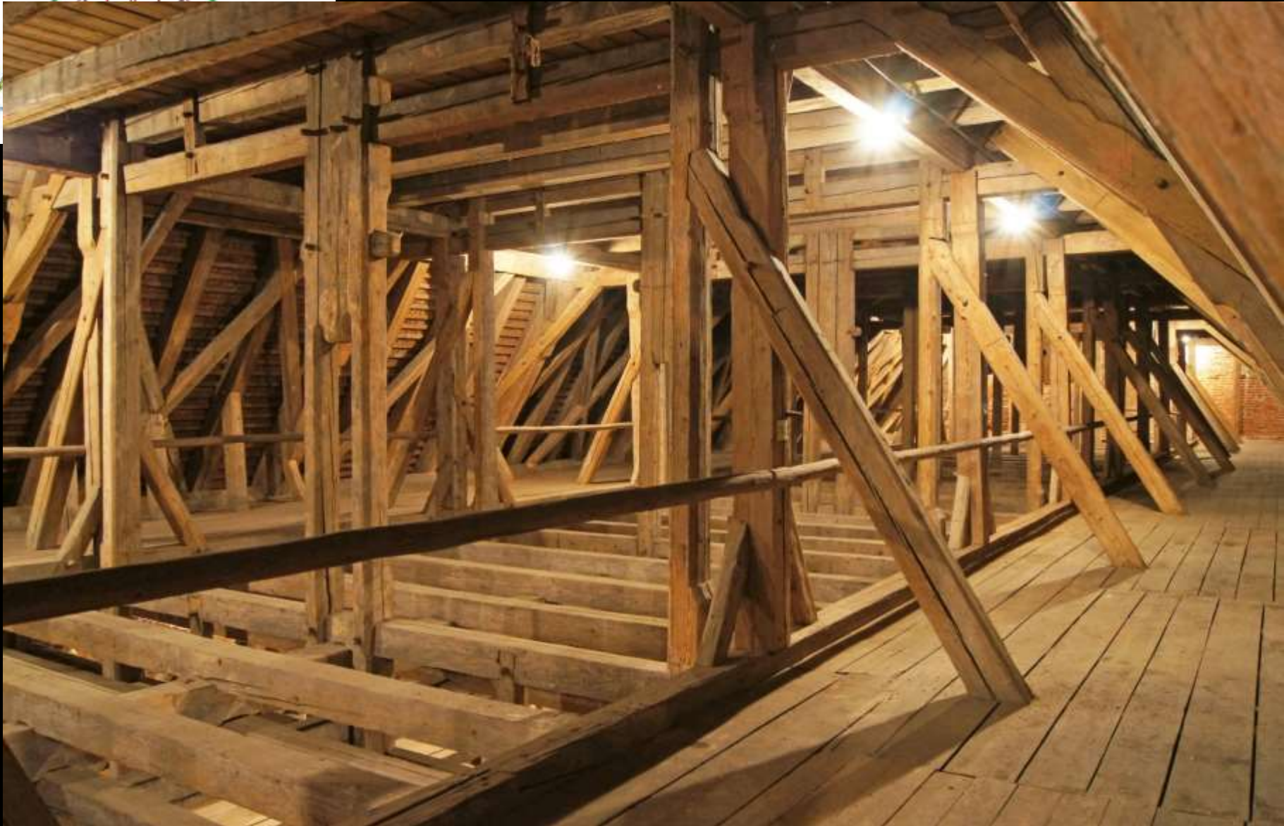
Ingolstadt, Liebfrauenkirche: Oberdach: Hängesäulen
