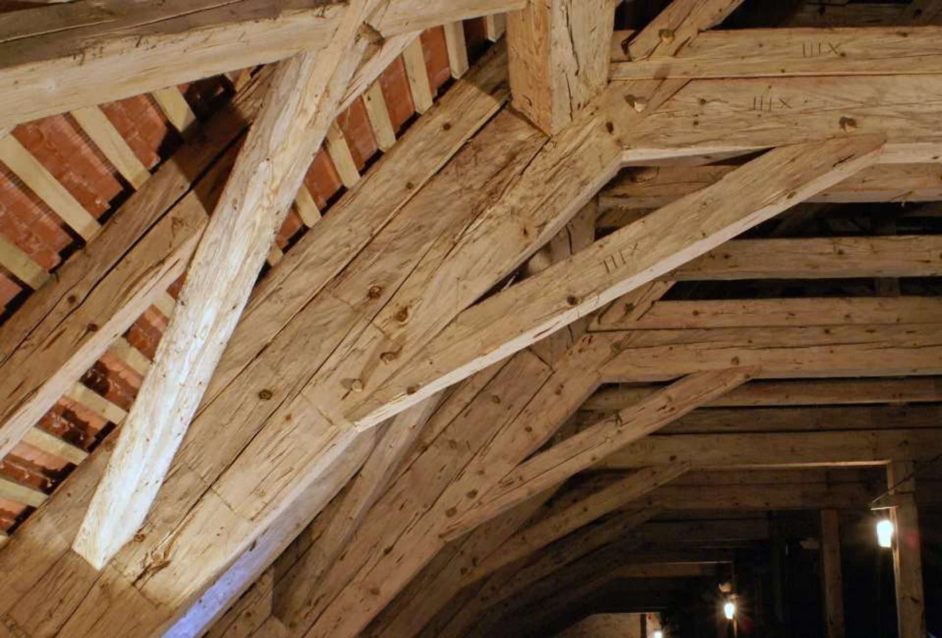
liegender Stuhl: Anschluss der Kopfbänder: Versatz mit Zapfen (Baumburg/Alz, 18. Jh.)
