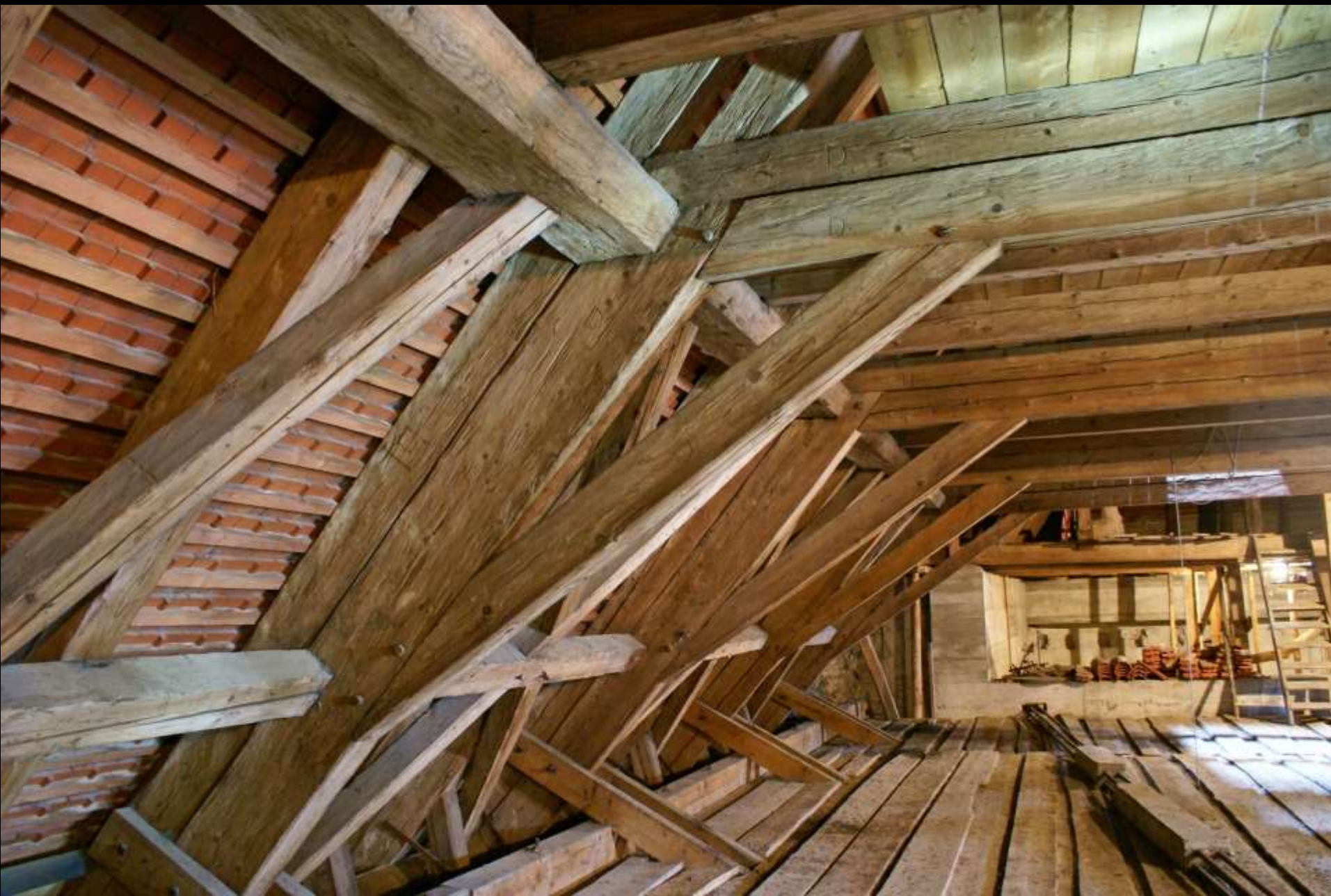
liegender Stuhl: Sonderformen – falsch geschnittenes Rähm (Glonn, 2. H. 18. Jh.)
