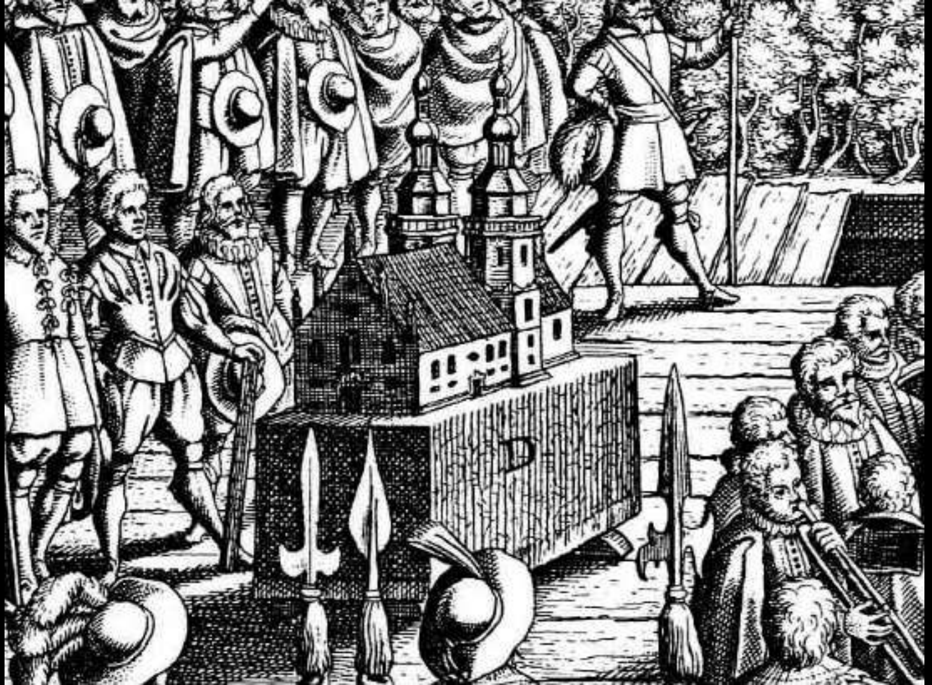
Regensburg, Dreieinigkeitskirche. Grundsteinlegung 1627 (M. Merian). Kirchenmodell.
