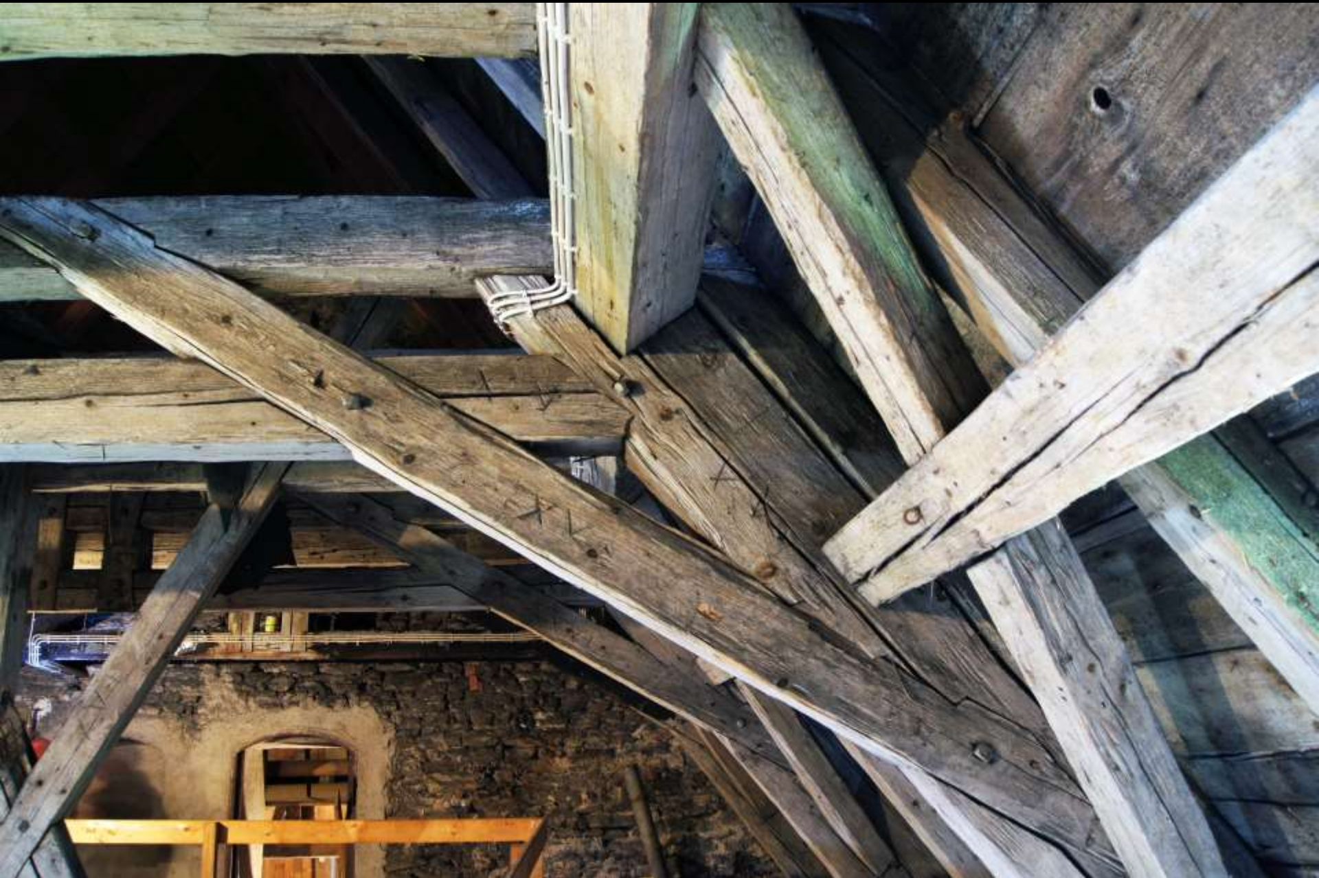
liegender Stuhl: Anschluss der Kopfbänder: Blattverbindung (Hof/Bayern, St. Lorenz, 15. Jh.)
