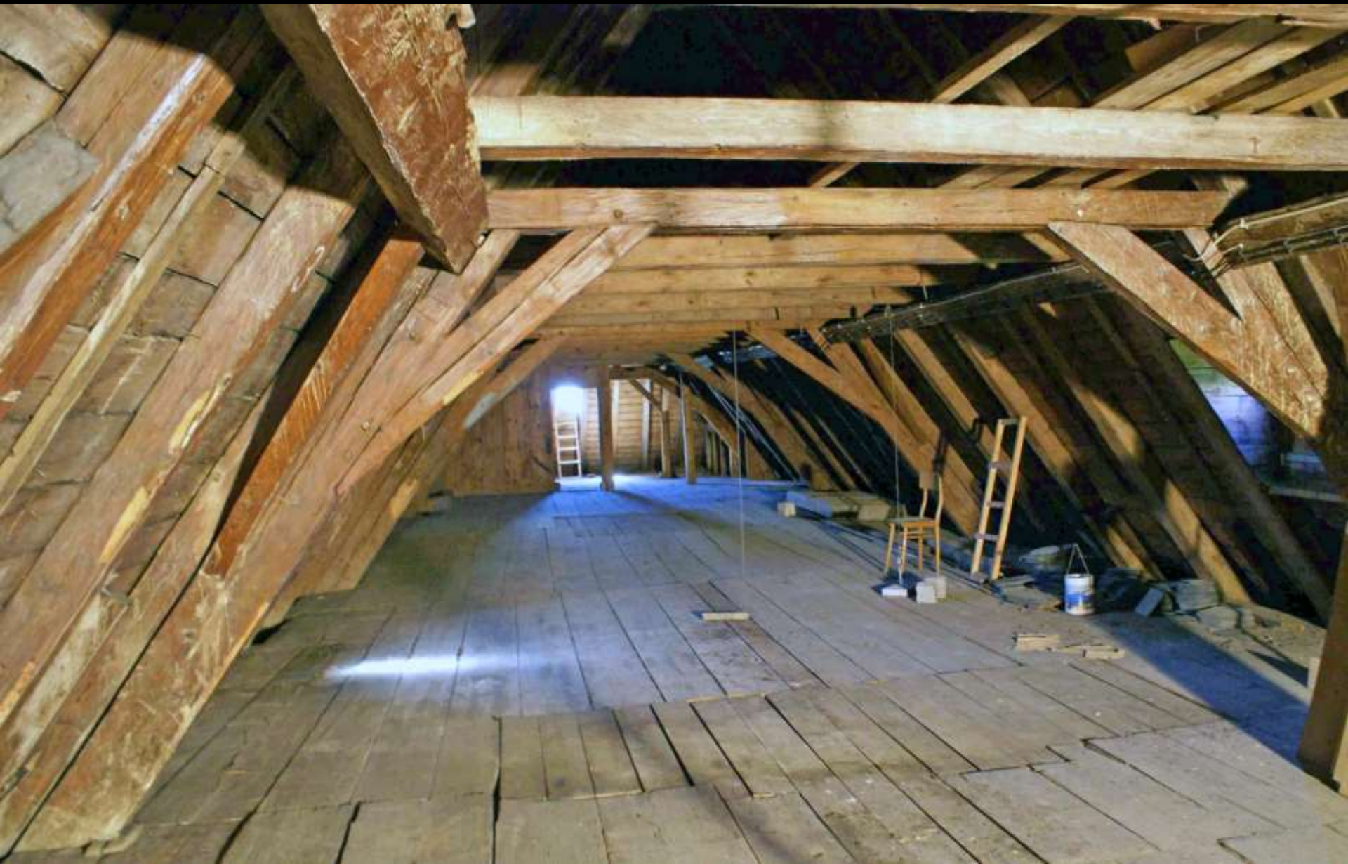
liegender Stuhl: Sonderformen – fehlender Spannriegel (Weihenlinden, Mitte 17. Jh.)
