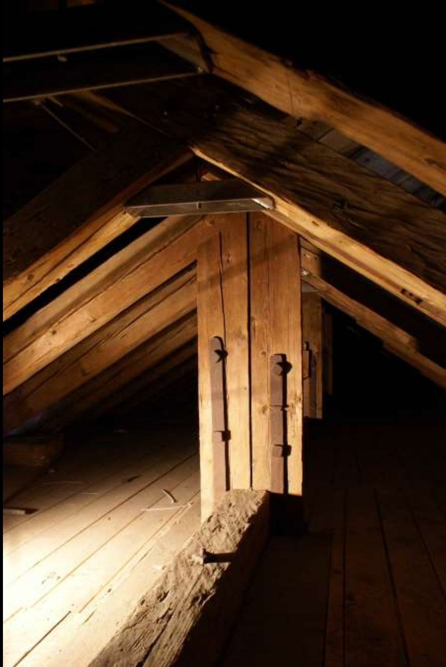
Doppelte, den Überzug umfassende Hängesäule (Augsburg, ev. St. Ulrich, 1710)
