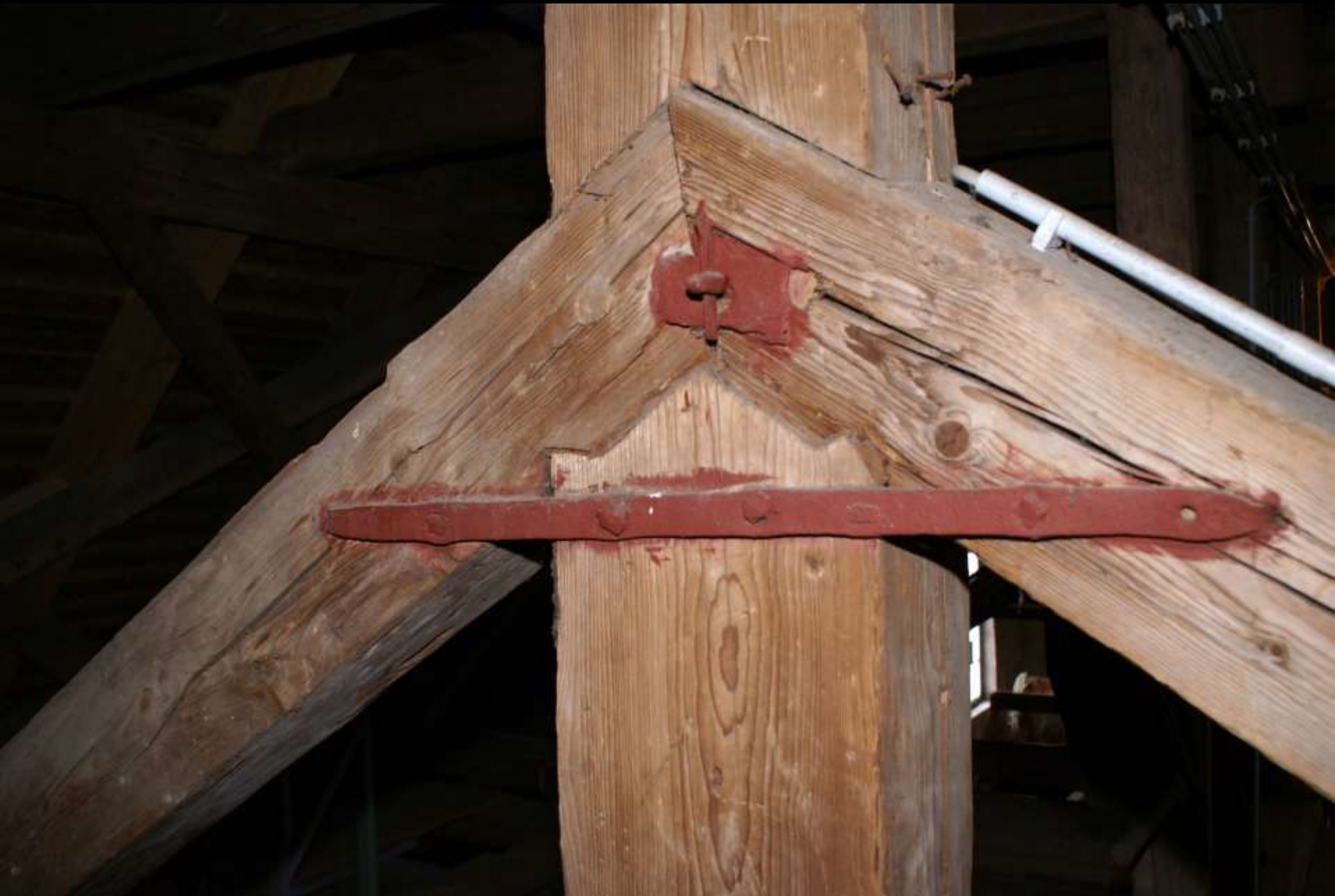
Perlach, St. Michael (1728). Hängesäule. Reparatur.
