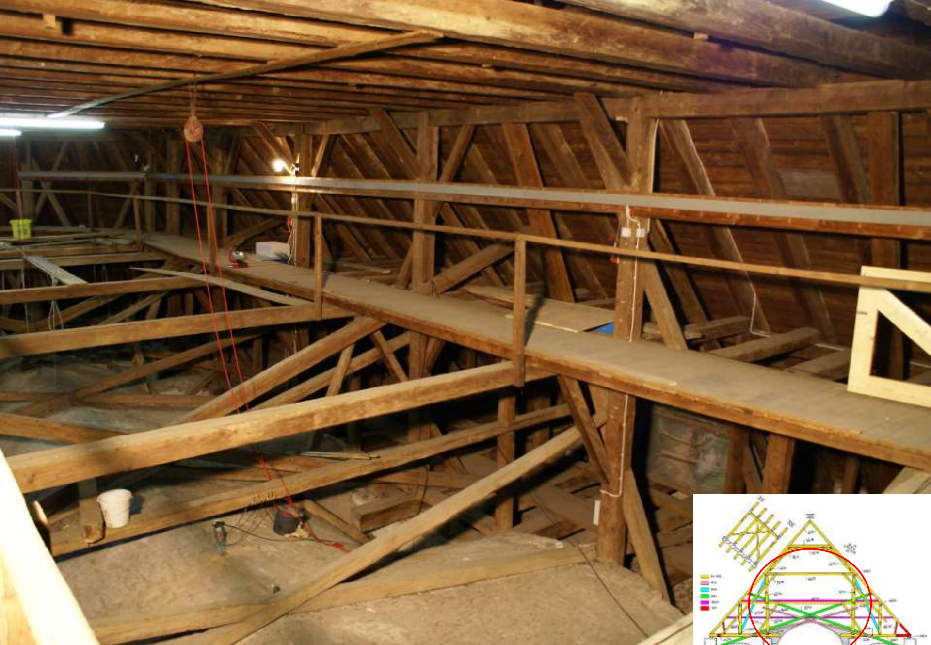
Tuntenhausen, Wallfahrtskirche (1627-29). Dachwerk. Hoher stehender Stuhl im unteren Stockwerk.
