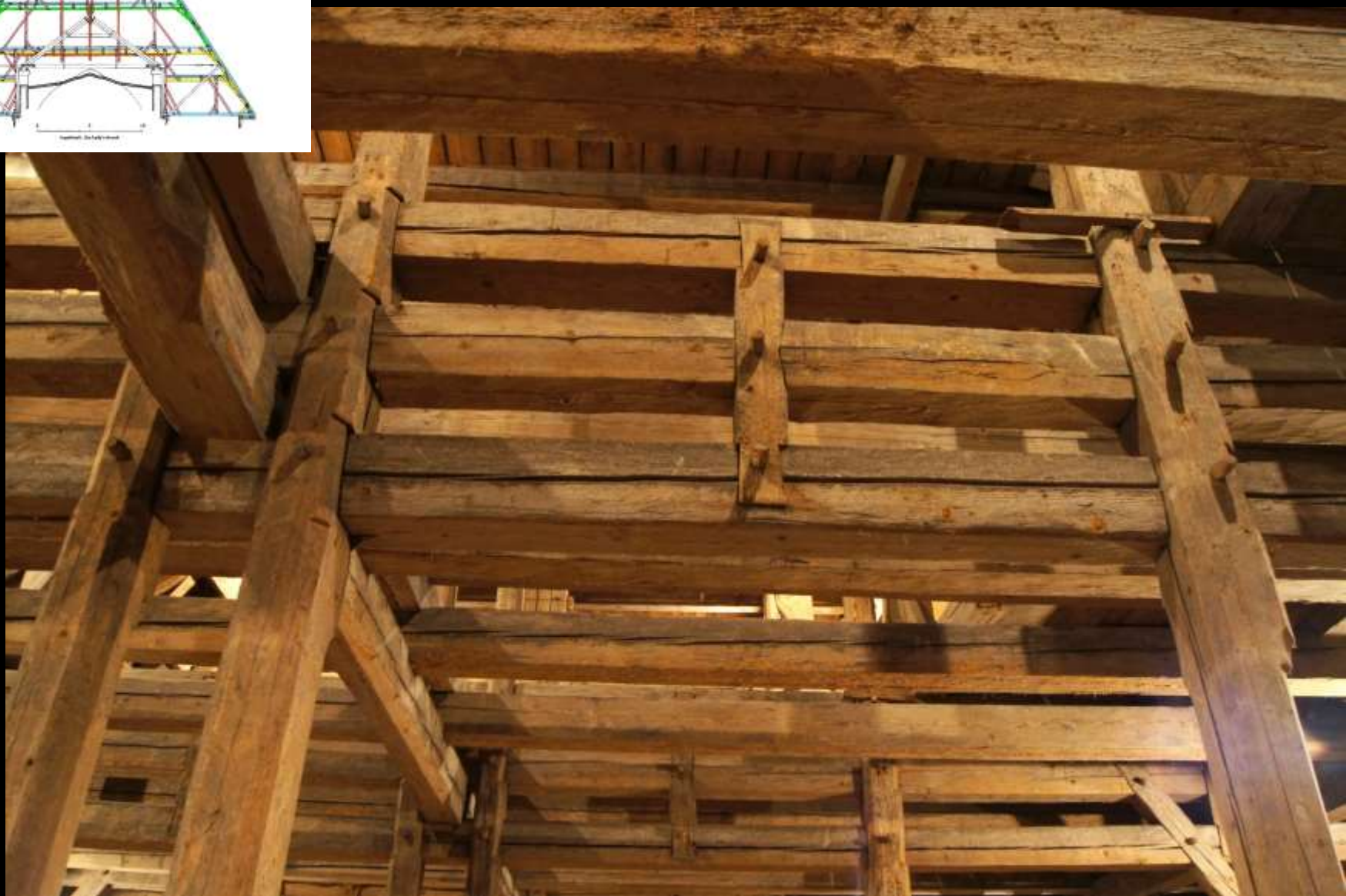
Ingolstadt, Liebfrauenkirche: Übergang Unterdach – Oberdach
