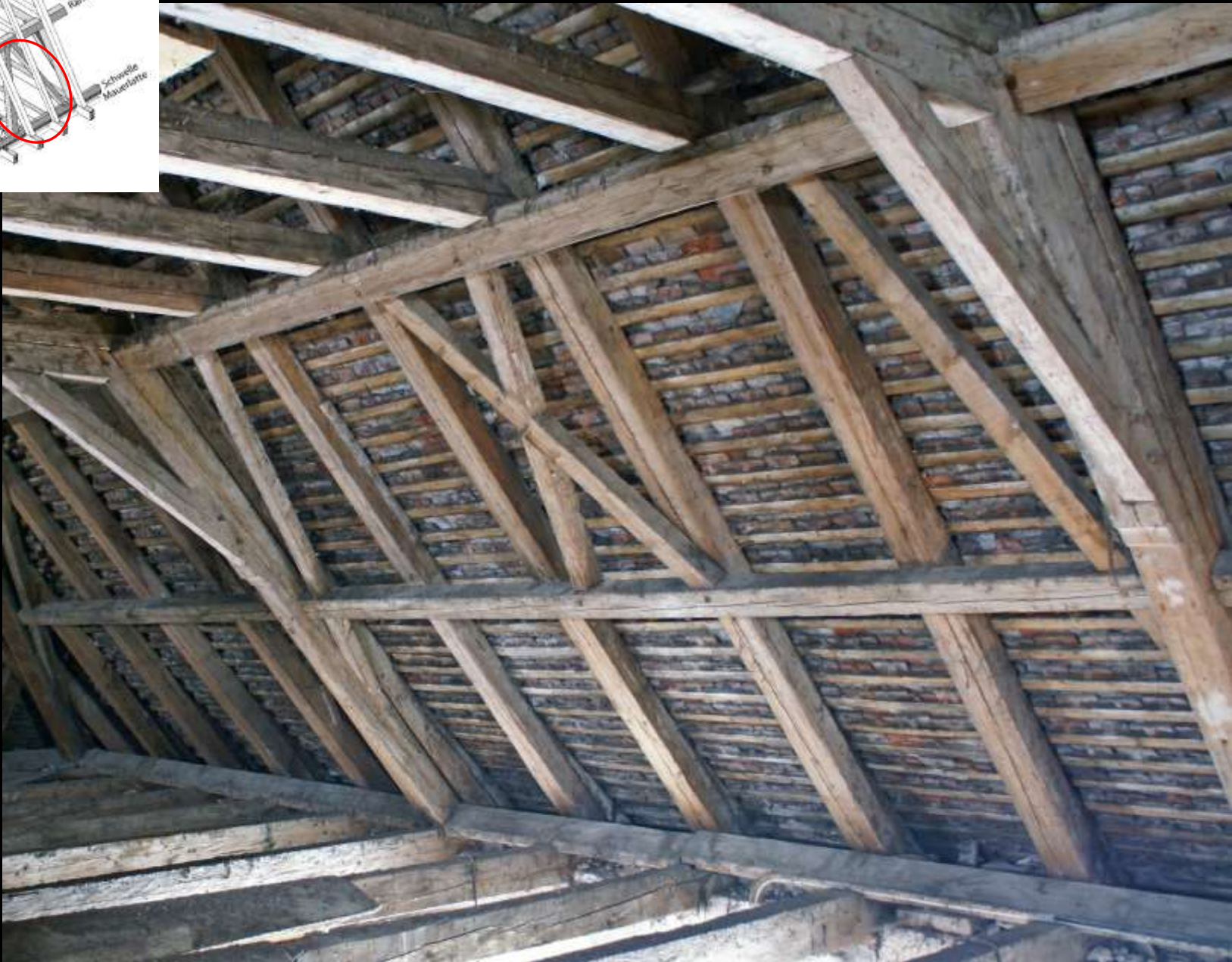
liegende Stuhl, kanonische Form: Windverband mit Brustriegel und Andreaskreuzen (Benediktbeuern, 18. Jh.)
