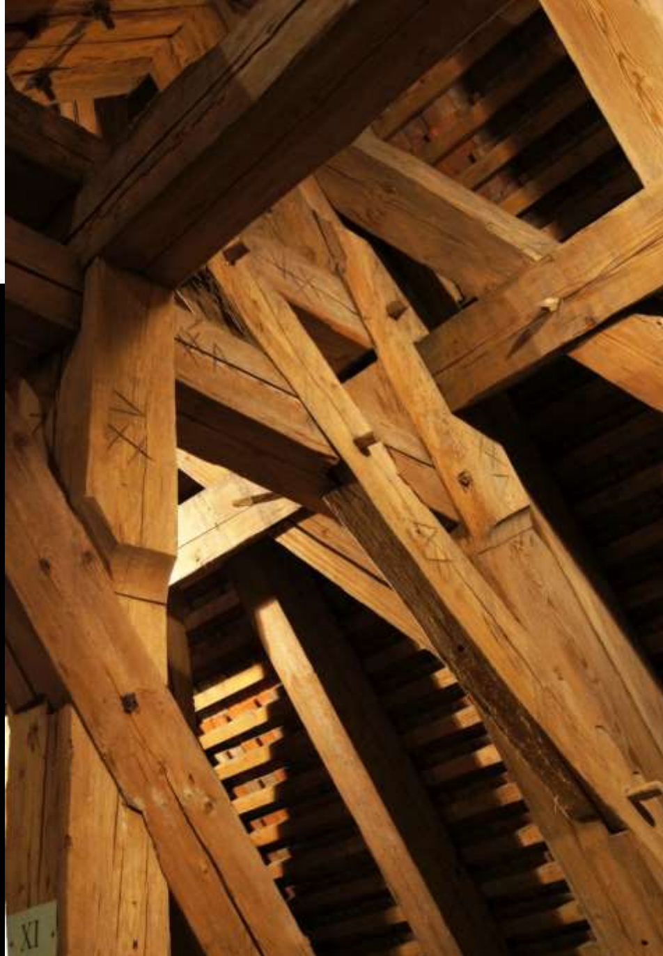
Ingolstadt, Liebfrauenkirche: Seitenschiffsdach, durchgehende liegende Stuhlsäule
