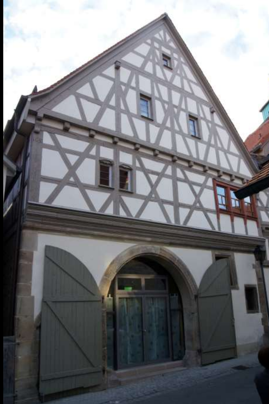
ablesbarer stehender Stuhl am Fachwerkgiebel (Markgröningen)
