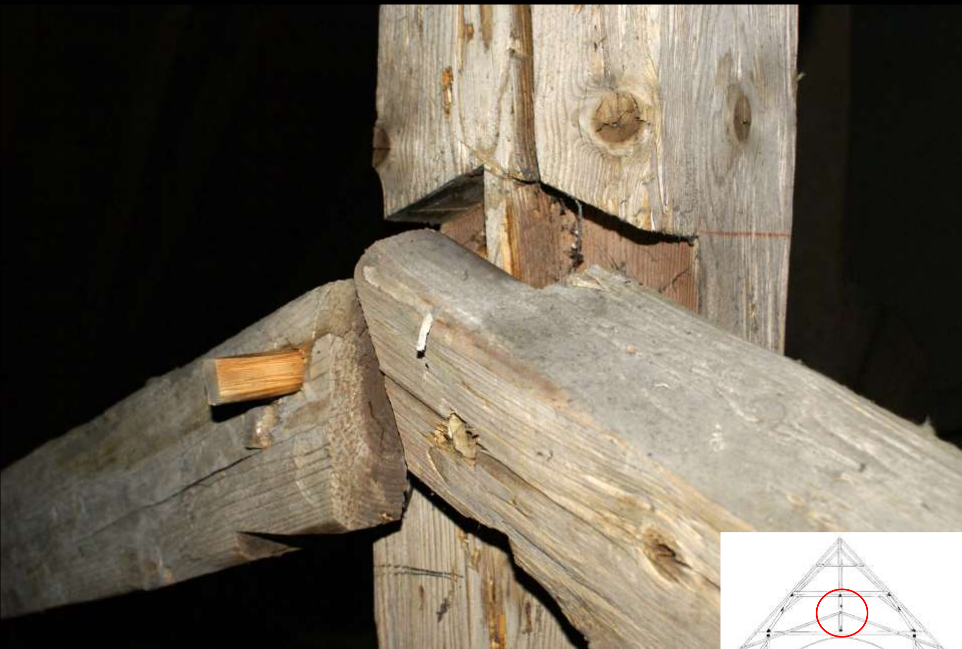
Weyarn, Augustinerstiftskirche (1693). Anschluss der Diagonalstreben an die Hängesäule
