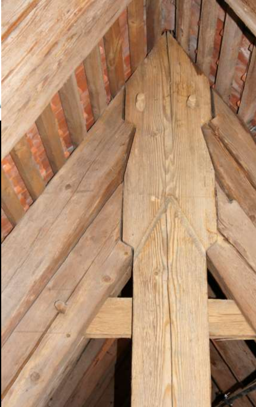
Ingolstadt, Liebfrauenkirche: Firstzone und Hängewerk, durchgehendes Schwert
