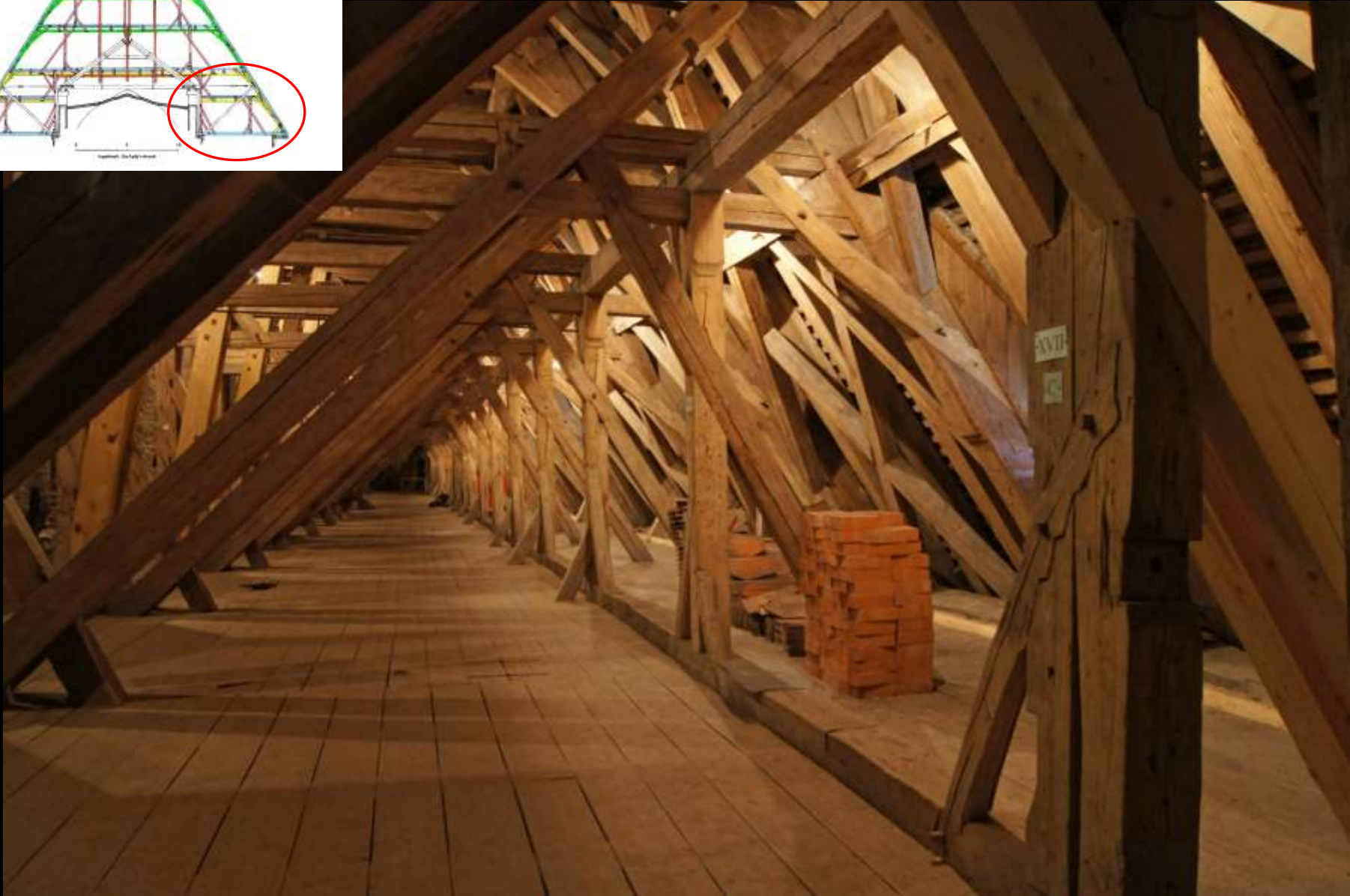
Ingolstadt, Liebfrauenkirche: Seitenschiffdach
