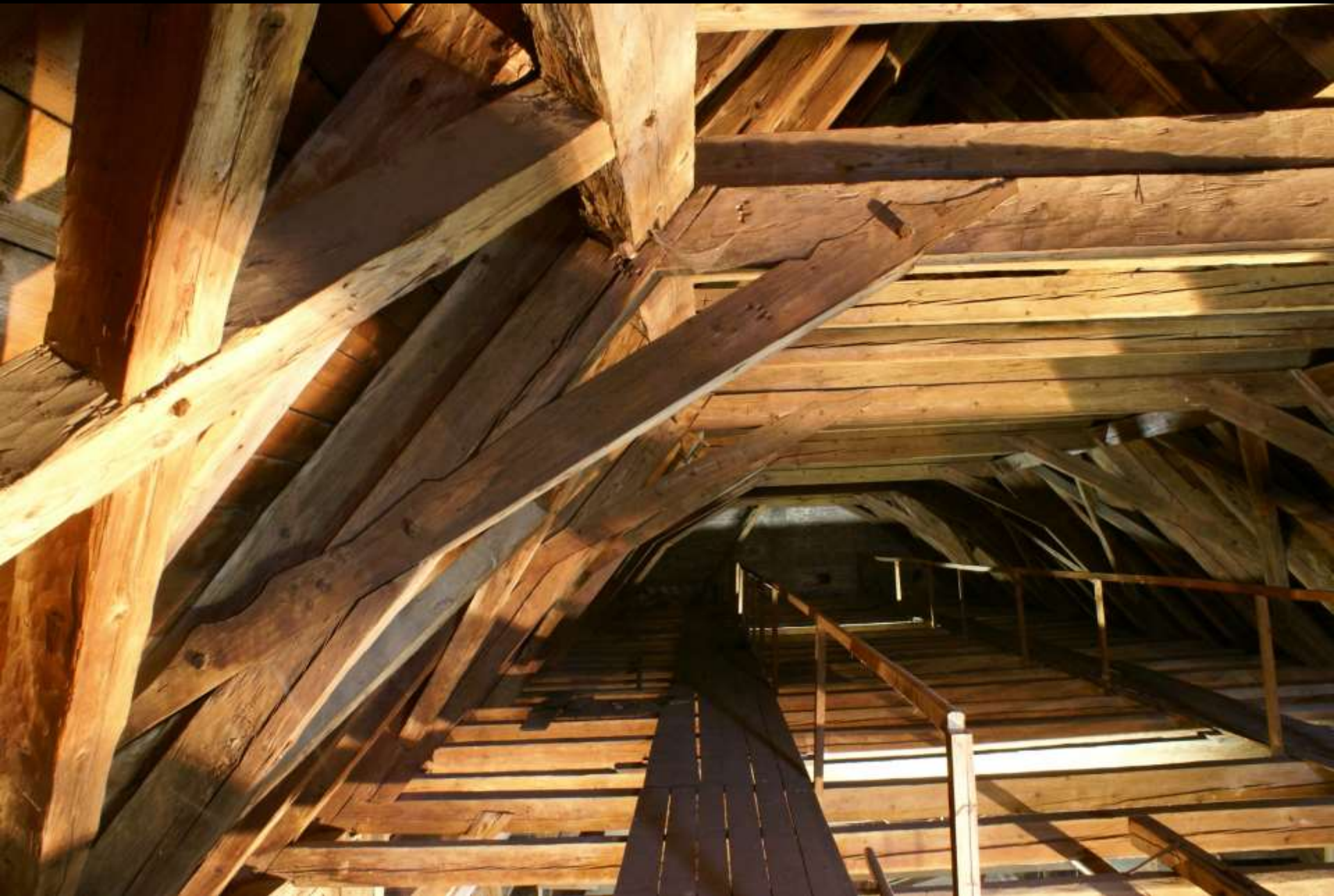
liegender Stuhl: Anschluss der Kopfbänder: ausgreifende Blattverbindung (Tuntenhausen, 17. Jh.)
