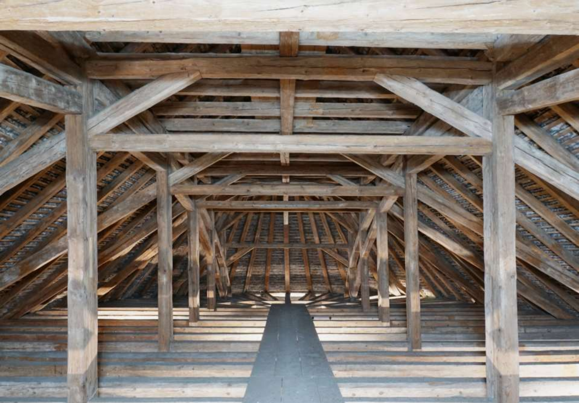
Stabpolygon-Brücke im Dach: Horgen ZH, Pfarrkirche (Johann Jakob und Hans Ulrich Haltiner, 1780–81) Foto: Jasmin Schäfer
