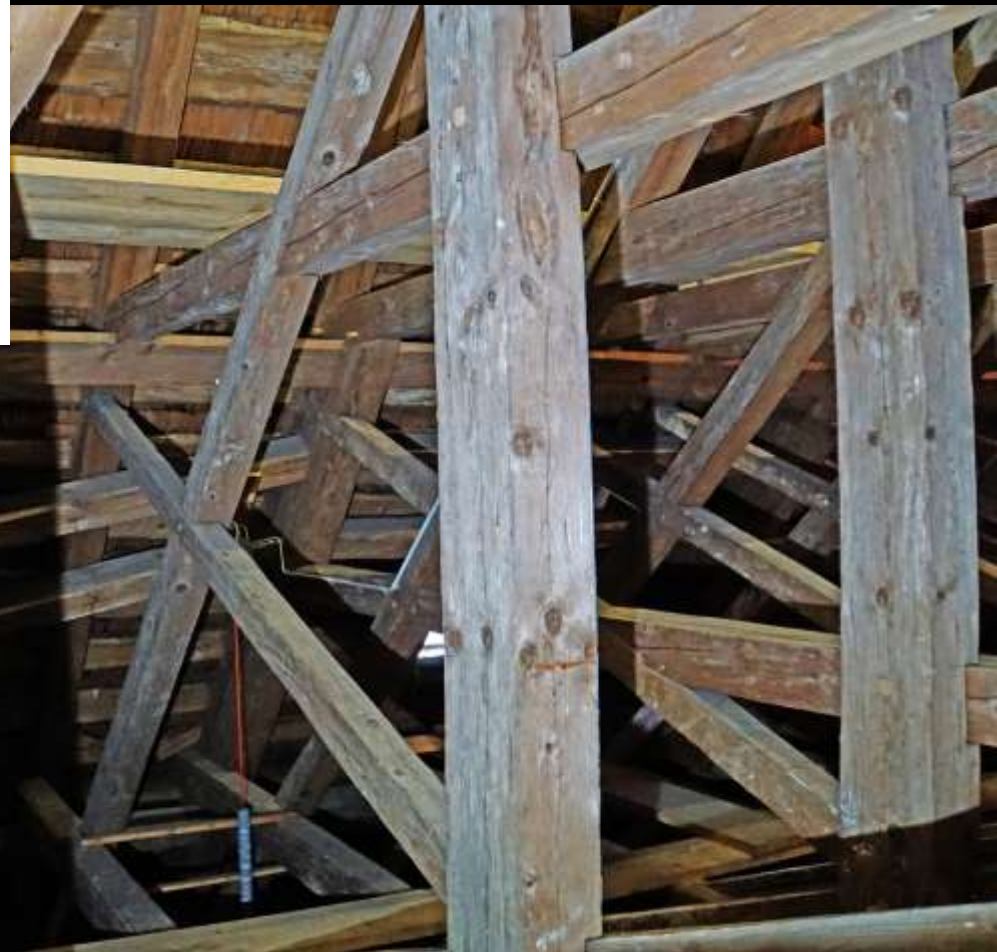
Stabpolygon als Längsaussteifung in der Sparrenebene: Ref. Kirche Ebnat-Kappel SG (Hans Ulrich Grubenmann, 1762; Foto: Jasmin Schäfer 2021)
