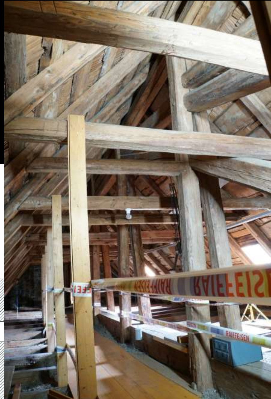
Stabpolygon als Längsverband zwischen den Hängesäulen: Ref. Kirche Brunnadern SG (Hans Ulrich Grubenmann, 1764; Foto: Jasmin Schäfer 2021)
