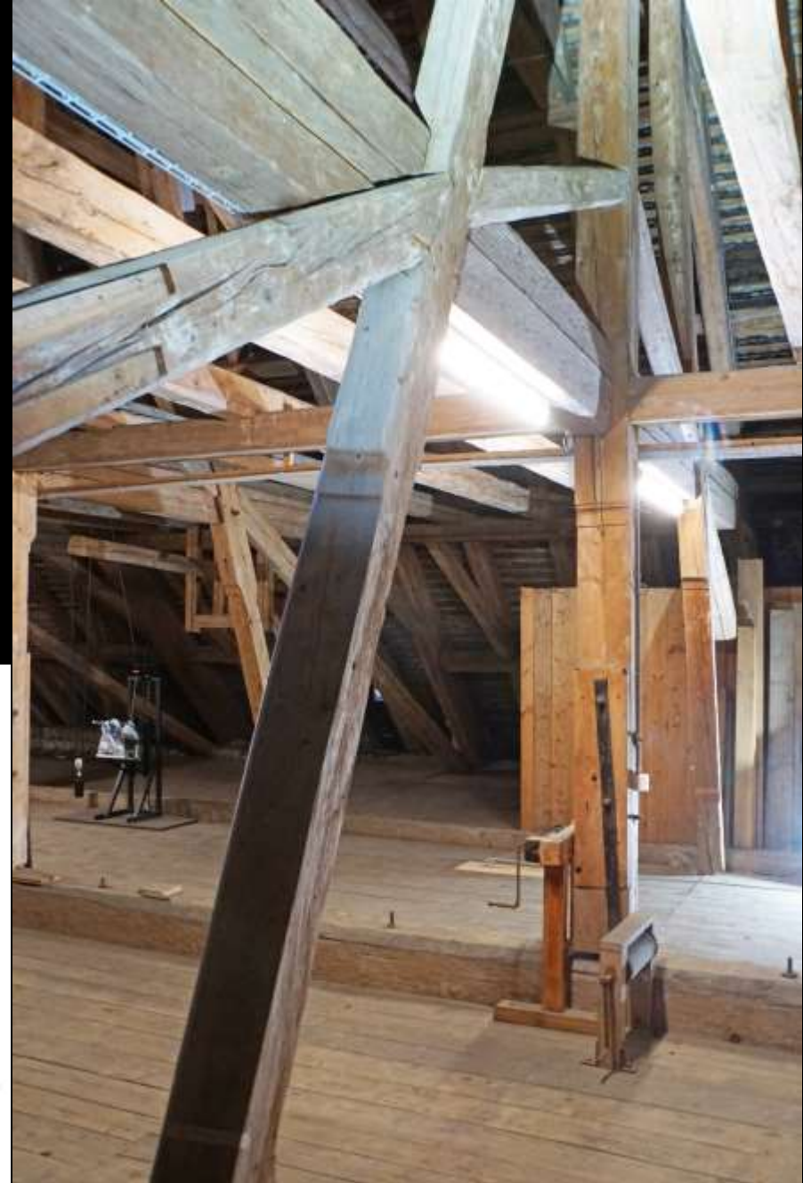
Hinwil ZH, reformierte Kirche (1787). Lichtweite des Saalraums 16.00 m. Dachwerk
