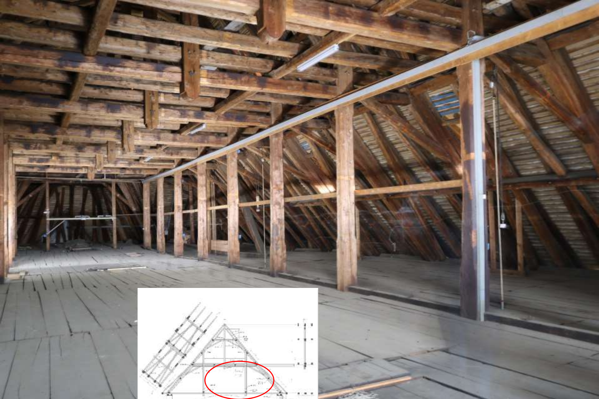
Cham ZG, katholische Pfarrkirche St. Jakob (1784). Lichtweite 17.19 m. Dachwerk über dem Langhaus
