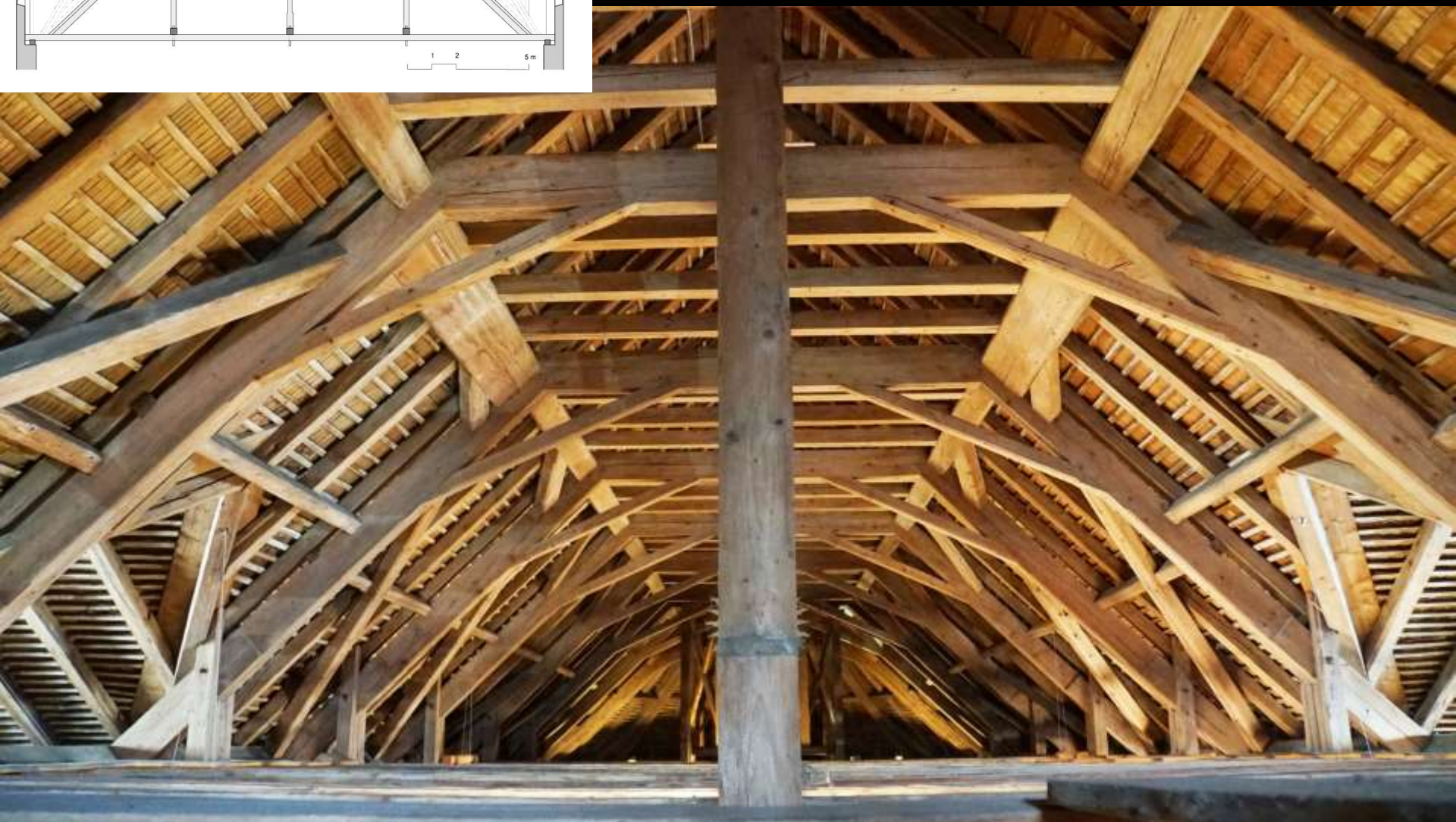
Altstätten SG, katholische Pfarrkirche (1798). Dachwerk (Foto: Jasmin Schäfer 2021).
