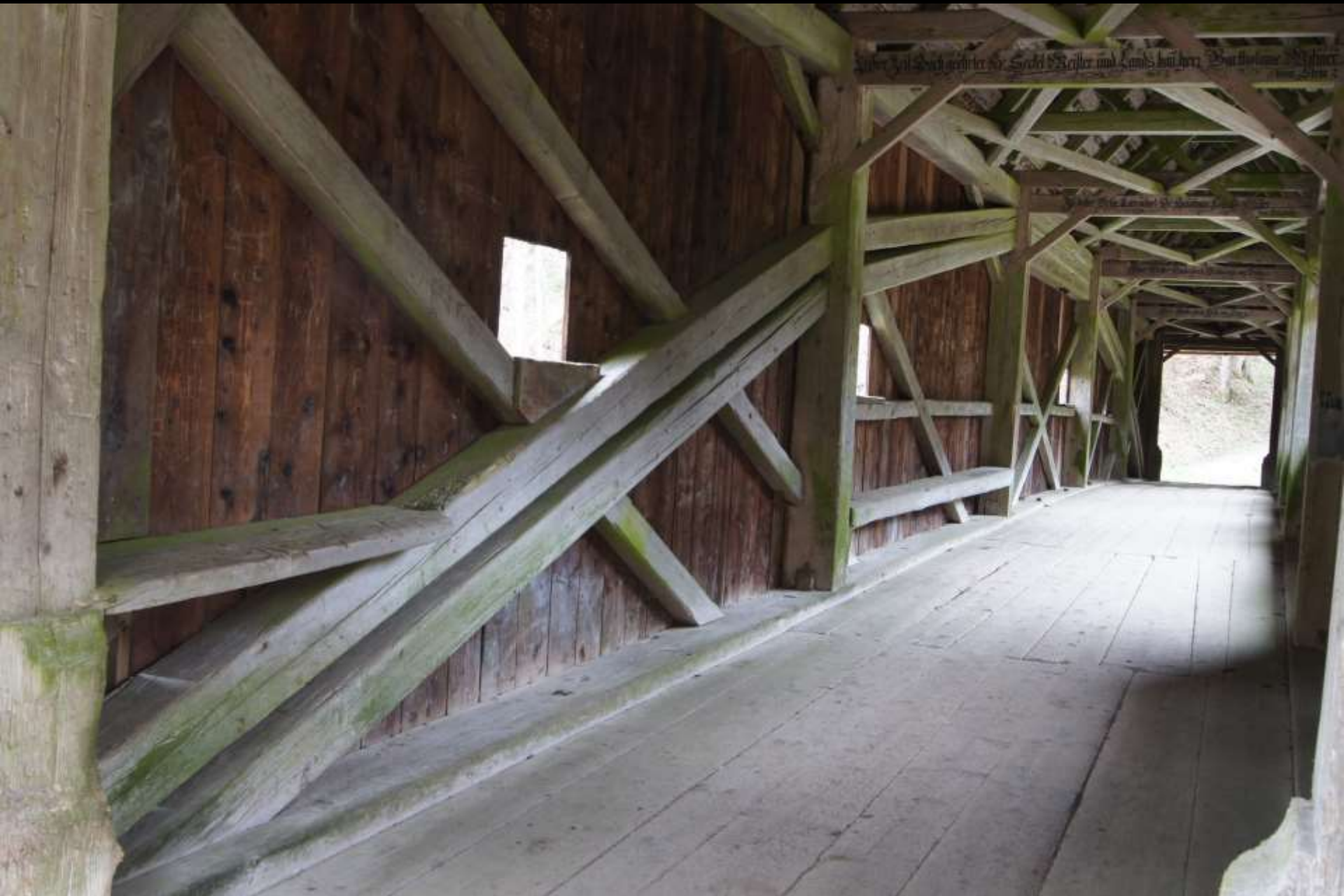
Brücke über die Urnäsch bei Hundwil (Hans Ulrich Grubenmann 1778)
