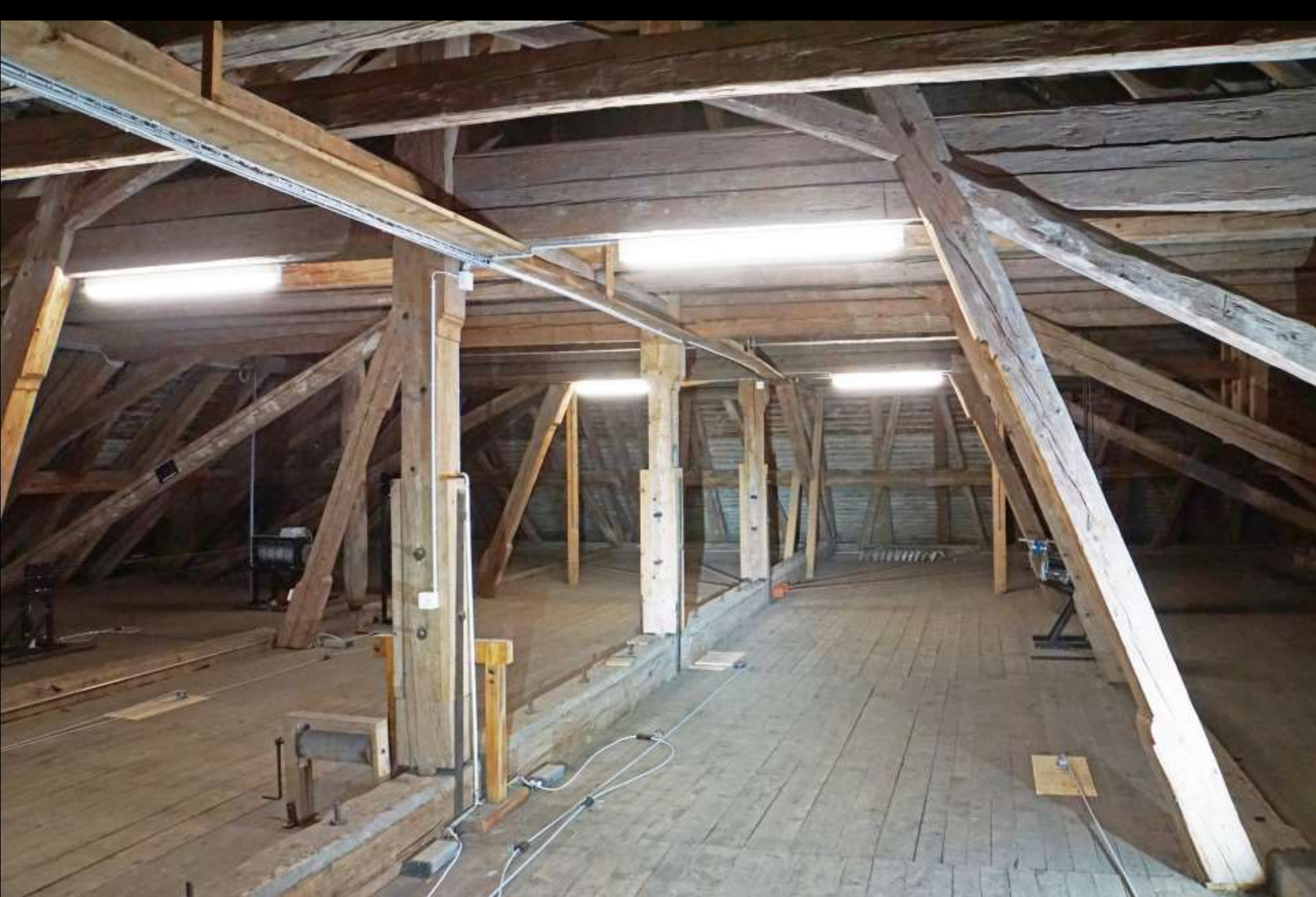
Hinwil ZH, reformierte Kirche (1787). Lichtweite des Saalraums 16.00 m. Dachwerk
