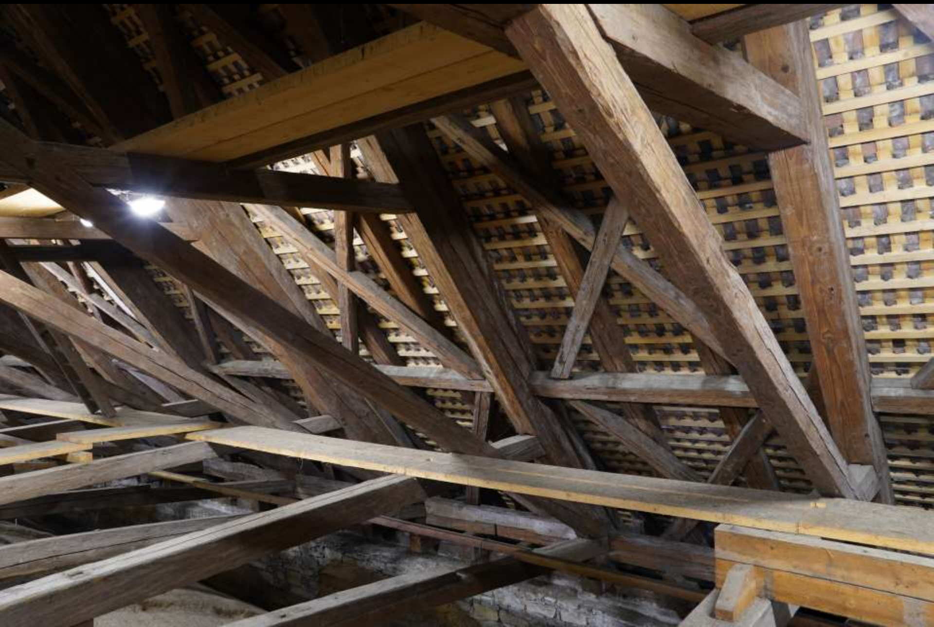
Luzern, Jesuitenkirche (1669). Dachwerk
