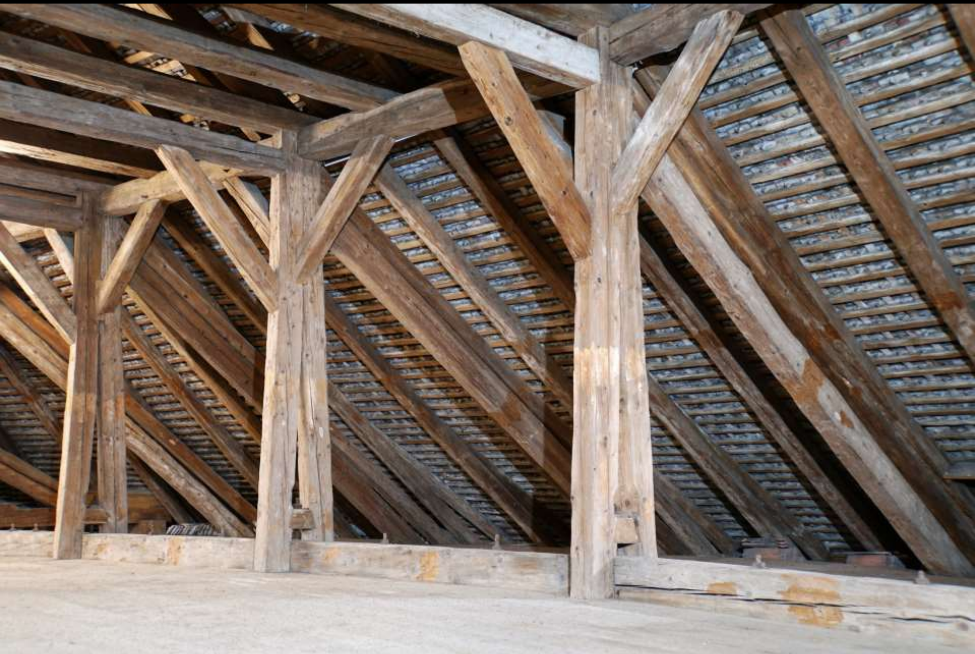
Stabpolygon-Brücke im Dach: Horgen ZH, Pfarrkirche (Johann Jakob und Hans Ulrich Haltiner, 1780–81) (Foto: Jasmin Schäfer 2021)
