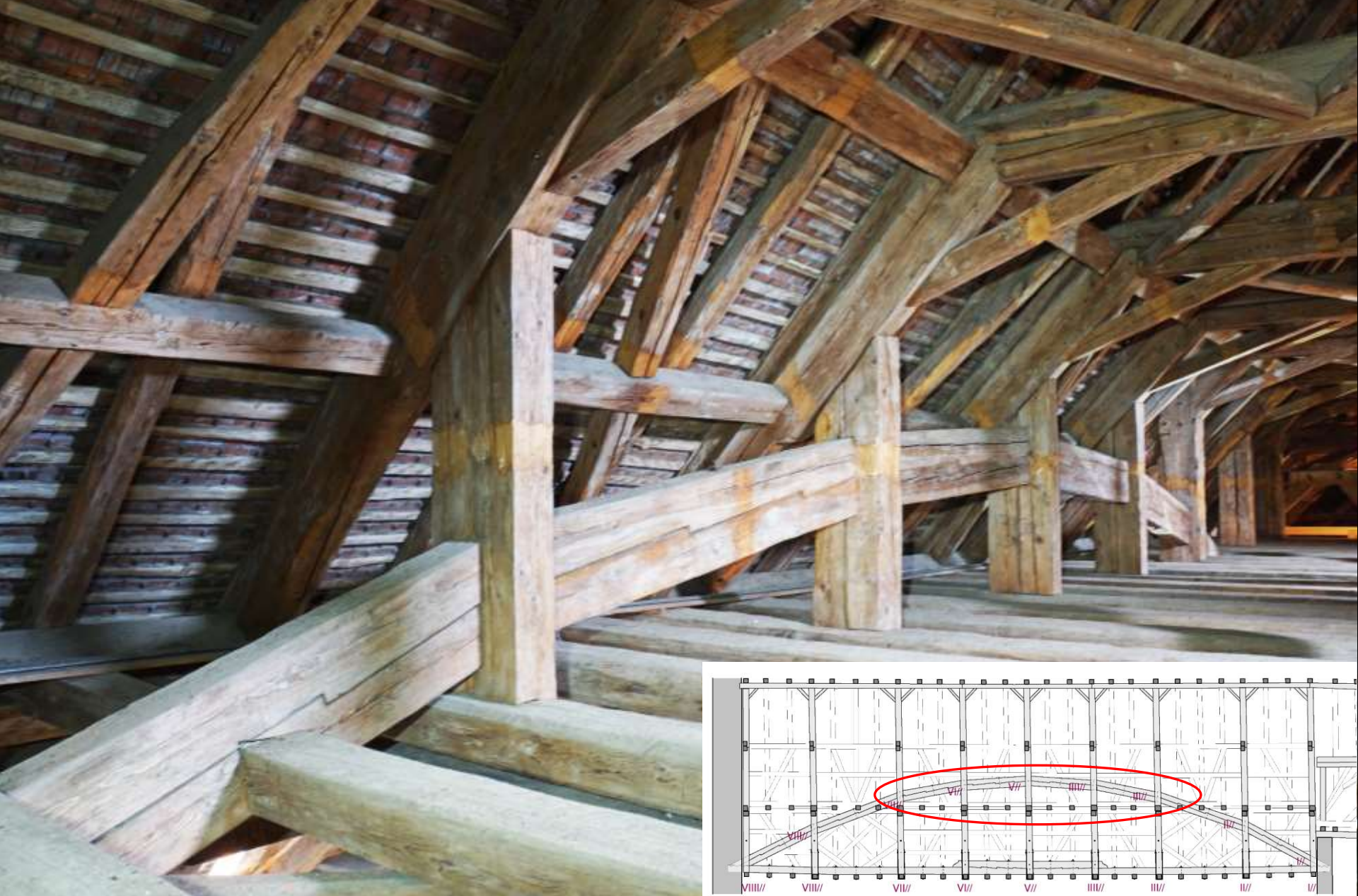
Unterstammheim ZH, reformierte Kirche (1780). Längstragwerk mit verzahntem Bogen (Foto: Jasmin Schäfer 2021)
