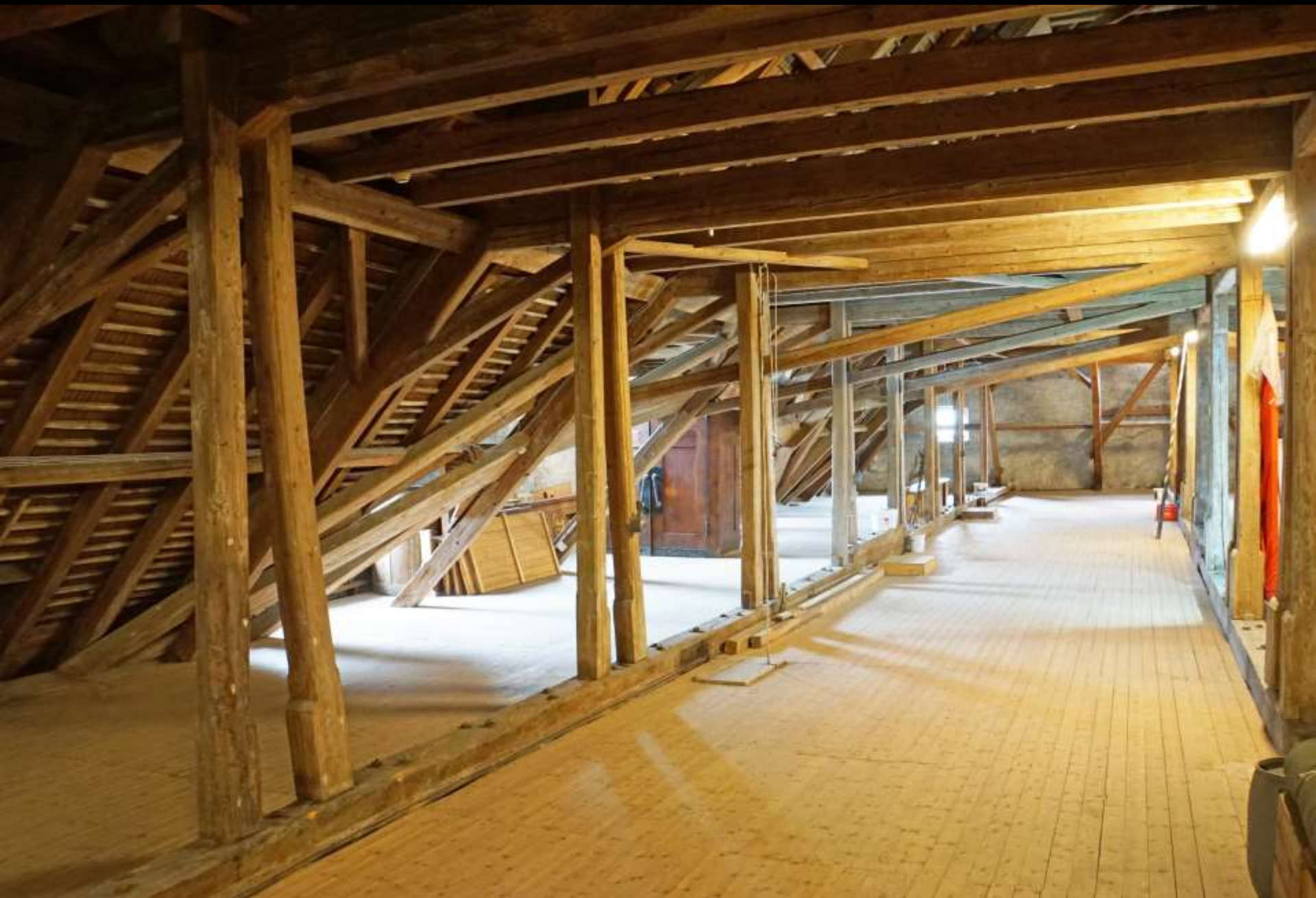
Altstätten SG, katholische Pfarrkirche (1798). Dachwerk.
