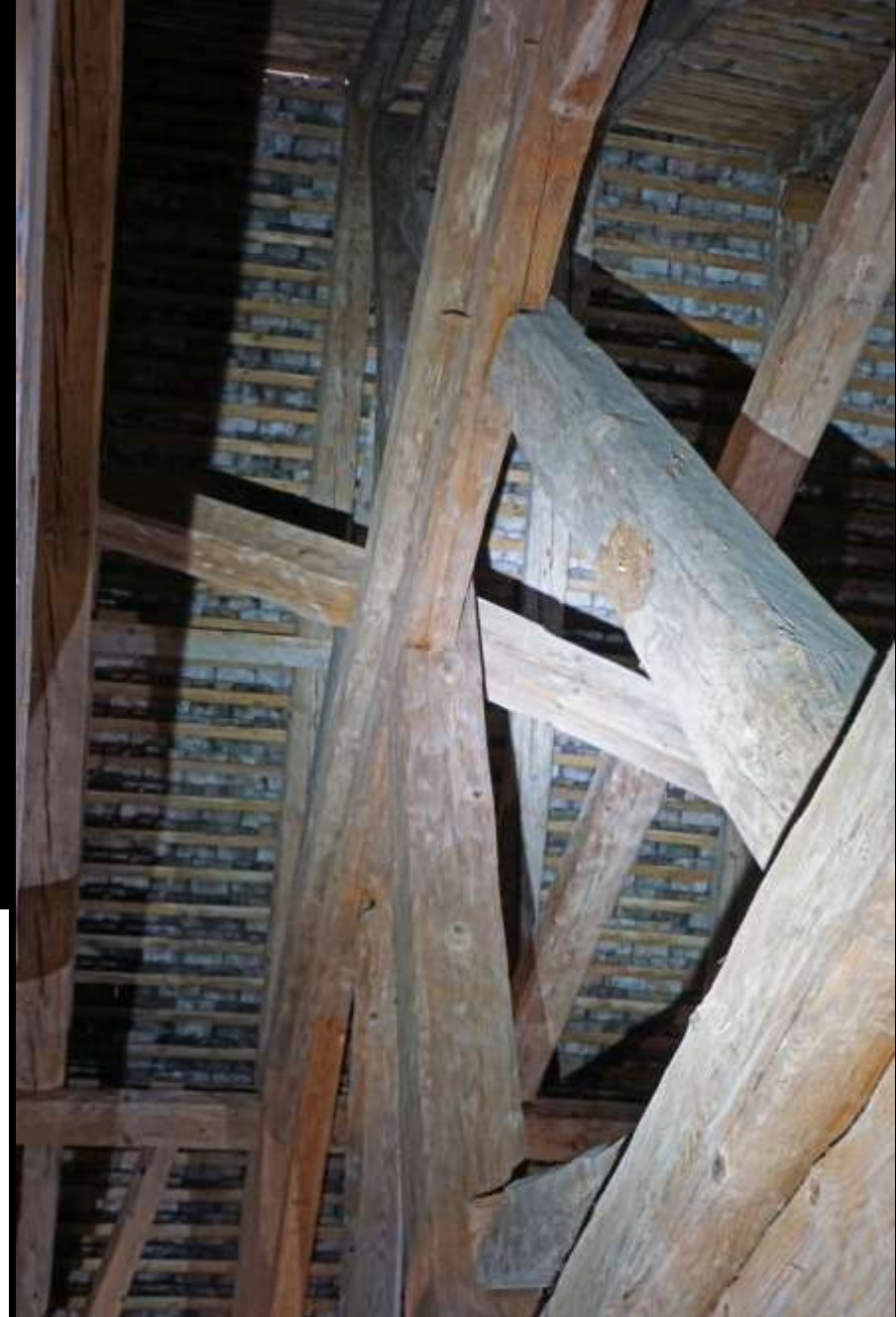
Hinwil ZH, reformierte Kirche (1787). Lichtweite des Saalraums 16.00 m. Längsschnitt des Dachwerks mit Stabbogen
