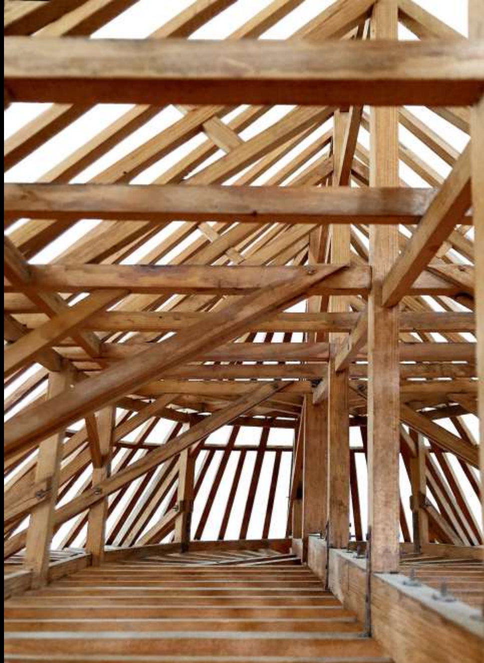
La-Chaux-de-Fonds, reformierte Kirche (1796). Bauzeitliches Entwurfsmodell (Jean-Michel Niedt, um 1794) Foto: Jasmin Schäfer 2023
