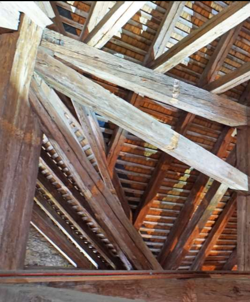
Stabpolygon als Längsverband zwischen den Hängesäulen: Ref. Kirche Kloten ZH (1786)
