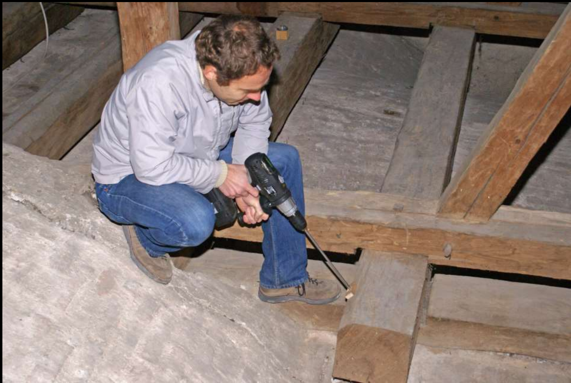
Entnahme einer Probe für die dendrochronologische Datierung mit dem Hohlbohrer an einer „Waldkante“
