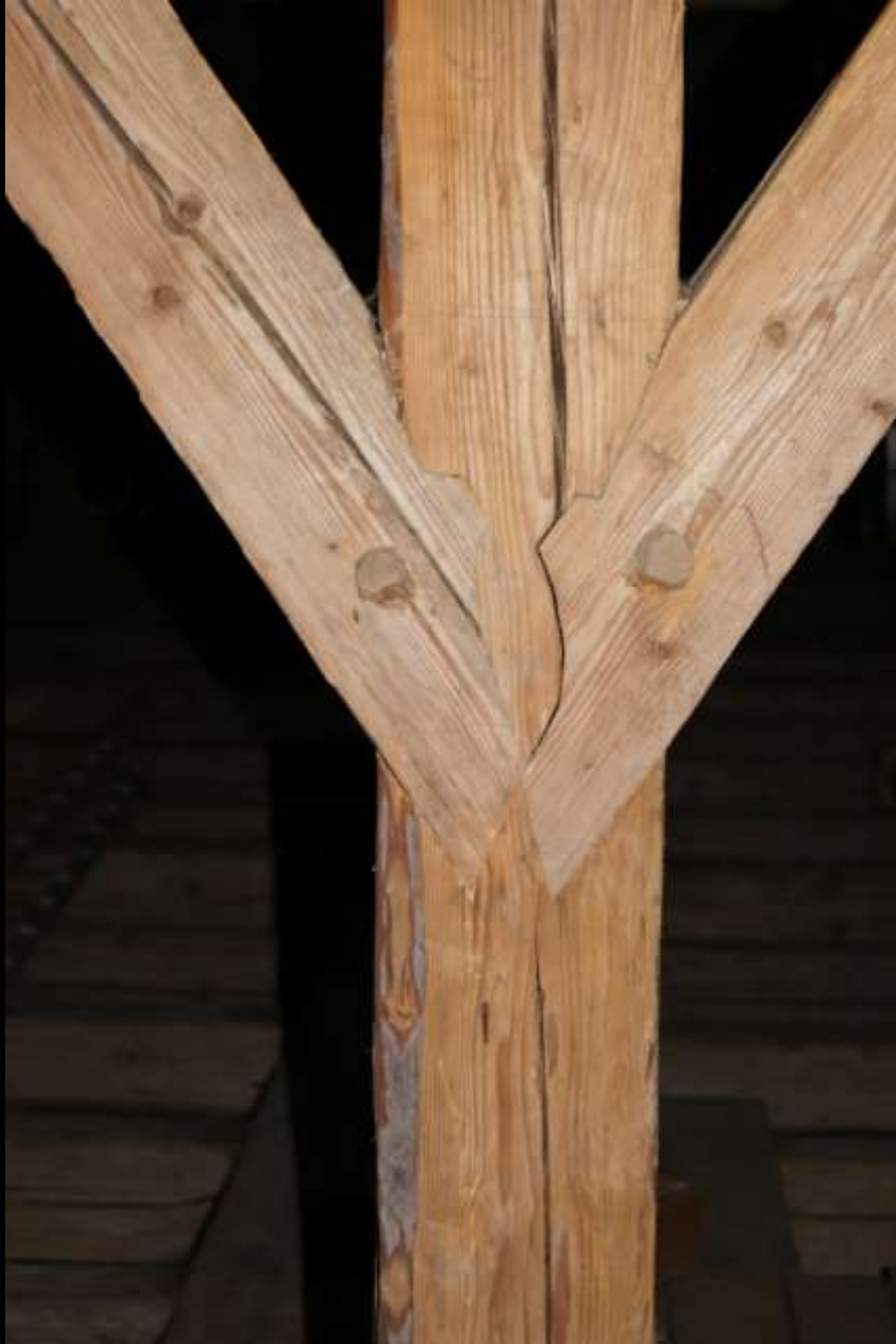
Das Bauwerk als Quelle: «Befunde» Dachwerk «stehender Stuhl» – konstruktive Details deuten eher auf spätgotische Konstruktion ... (Frauenkirche Oberwarngau/Bayern)
