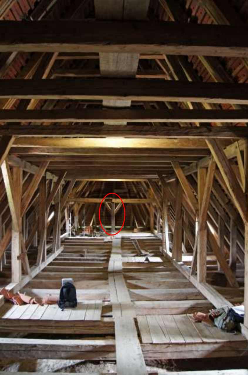
Das Bauwerk als Quelle: «Befunde» Datierung am Dachwerk « I 1777 G» - also alles klar? (Frauenkirche Osterwarngau/Bayern)
