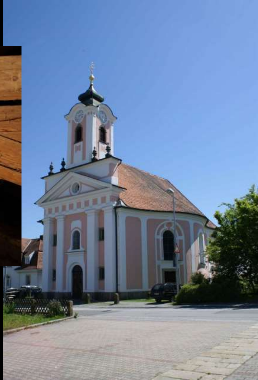
Das Bauwerk als Quelle: «Befunde» Offenkundig ein homogener Neubau von 1747 – einfacher Fall ... Inscriptliche Datierung (Kirche Dommelstadt bei Passau)
