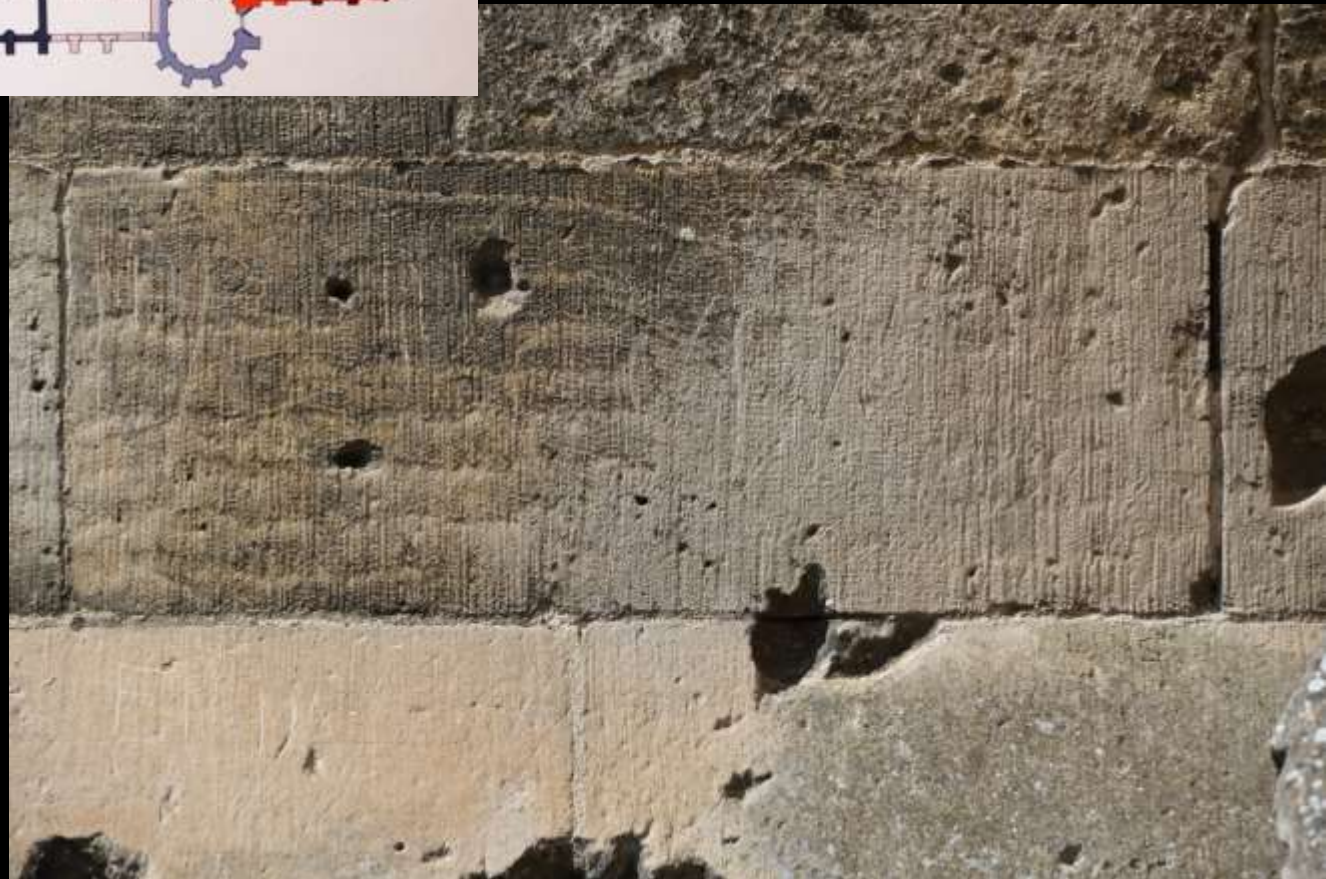
Noyon, Kathedrale (2. H. 12. Jh.). Chor von O. Detail des Kapellenkranzes. Steinbearbeitung um 1145/60?
