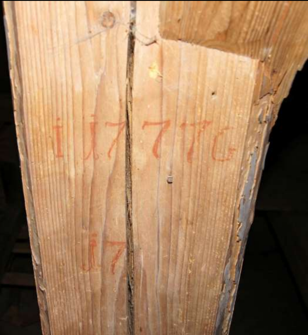
Das Bauwerk als Quelle: «Befunde» Datierung am Dachwerk « I 1777 G» - also alles klar? (Frauenkirche Osterwarngau/Bayern)
