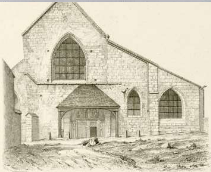
Facade ouest, avant la restauration.
