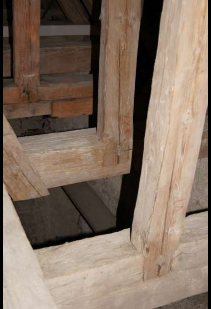
Das Bauwerk als Quelle: «Befunde» Dachwerk «stehender Stuhl» – konstruktive Details deuten eher auf spätgotische Konstruktion ... (Frauenkirche Oberwarngau/Bayern)
