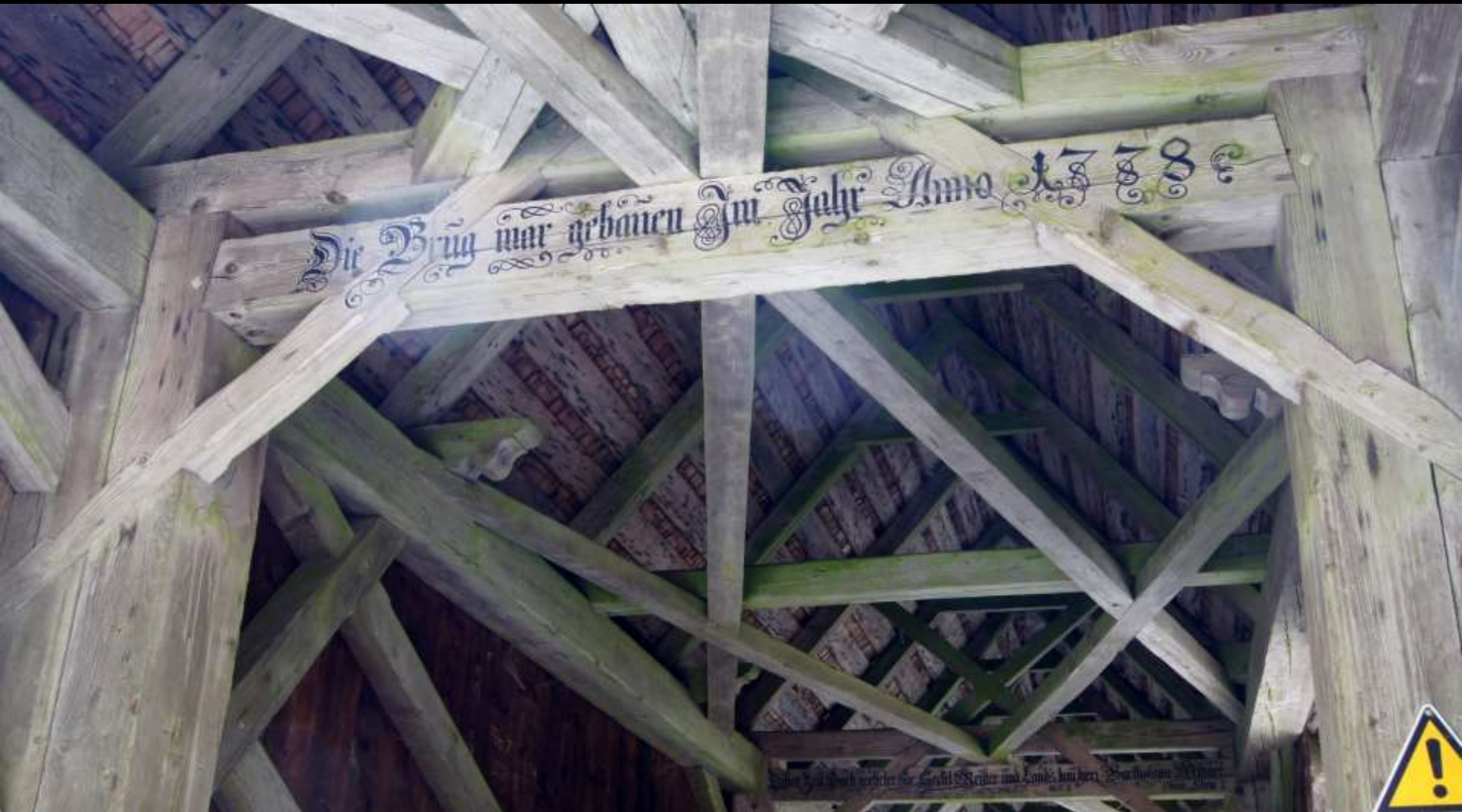
Das Bauwerk als Quelle: «Befunde» Inschriftliche Datierung (Brücke Hundwiler Tobel, 1778) ... lässt keine Zweifel offen
