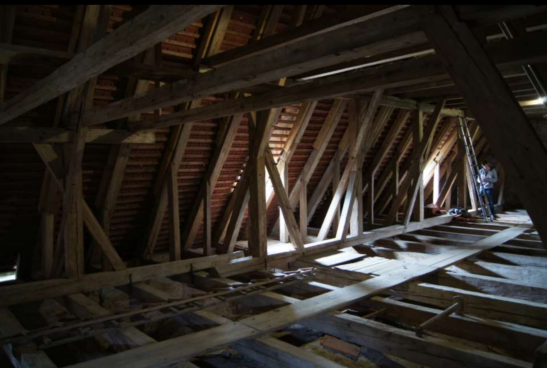
Das Bauwerk als Quelle: «Befunde» Dachwerk «stehender Stuhl» – barockzeitlich? (Frauenkirche Oberwarngau/Bayern)
