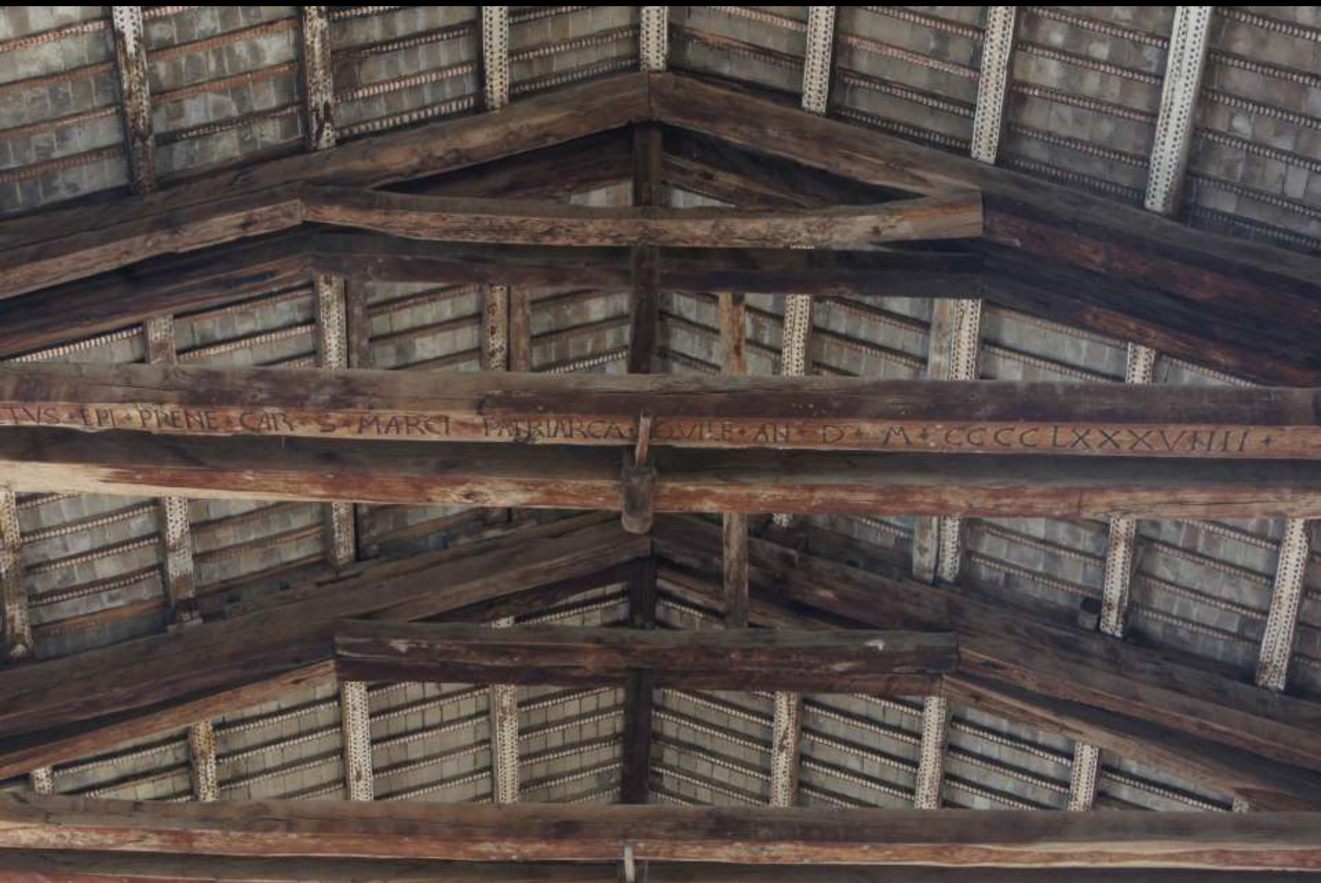
Das Bauwerk als Quelle: «Befunde» Inchriftliche Datierung (Dach von Santa Balbina, Rom, 1489)
