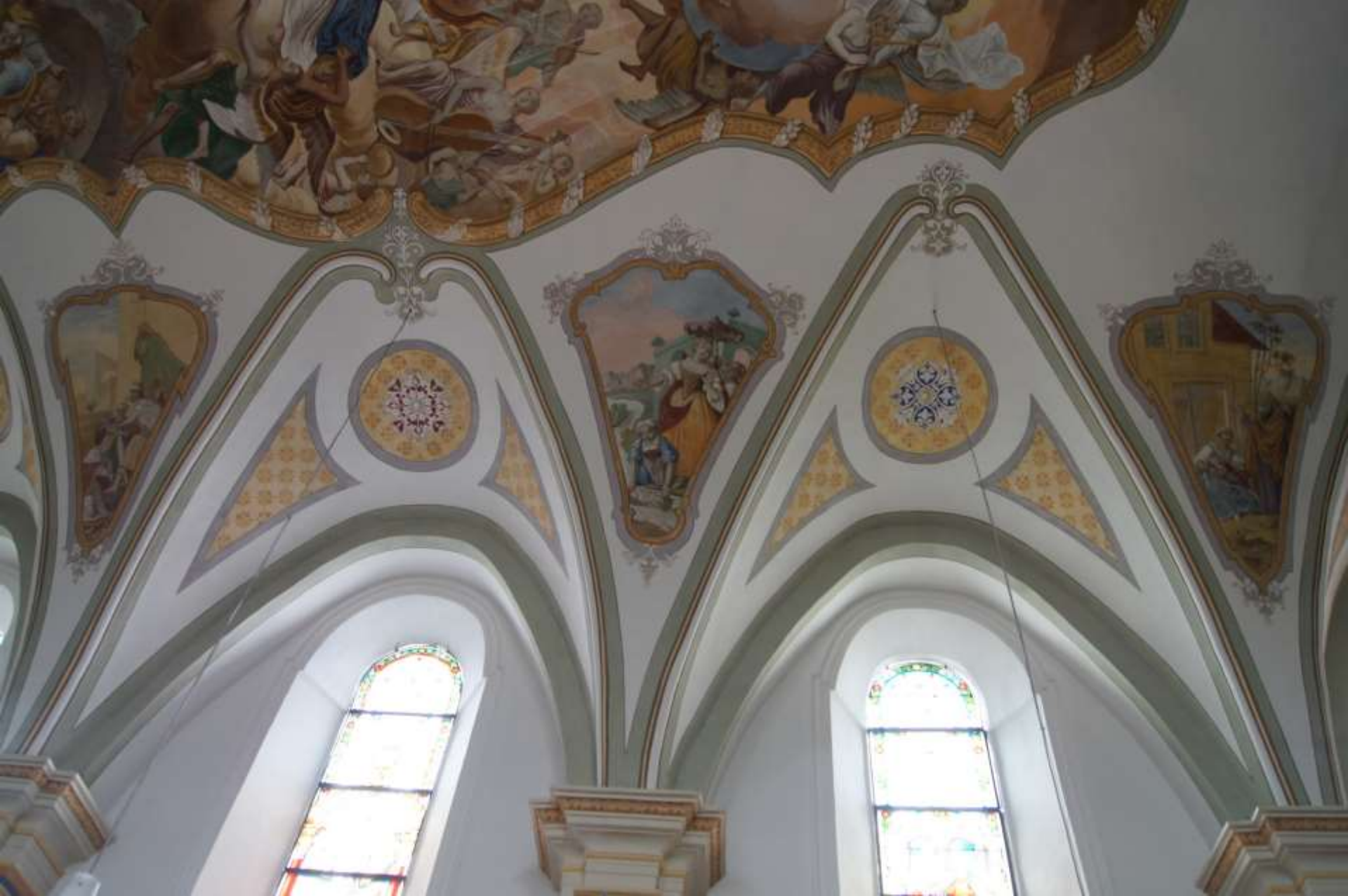
Das Bauwerk als Quelle: «Befunde» Gewölbe spitzbogig – substantiell noch vorhandenes spätgotisches Netzgewölbe? (Frauenkirche Osterwarngau/Bayern)
