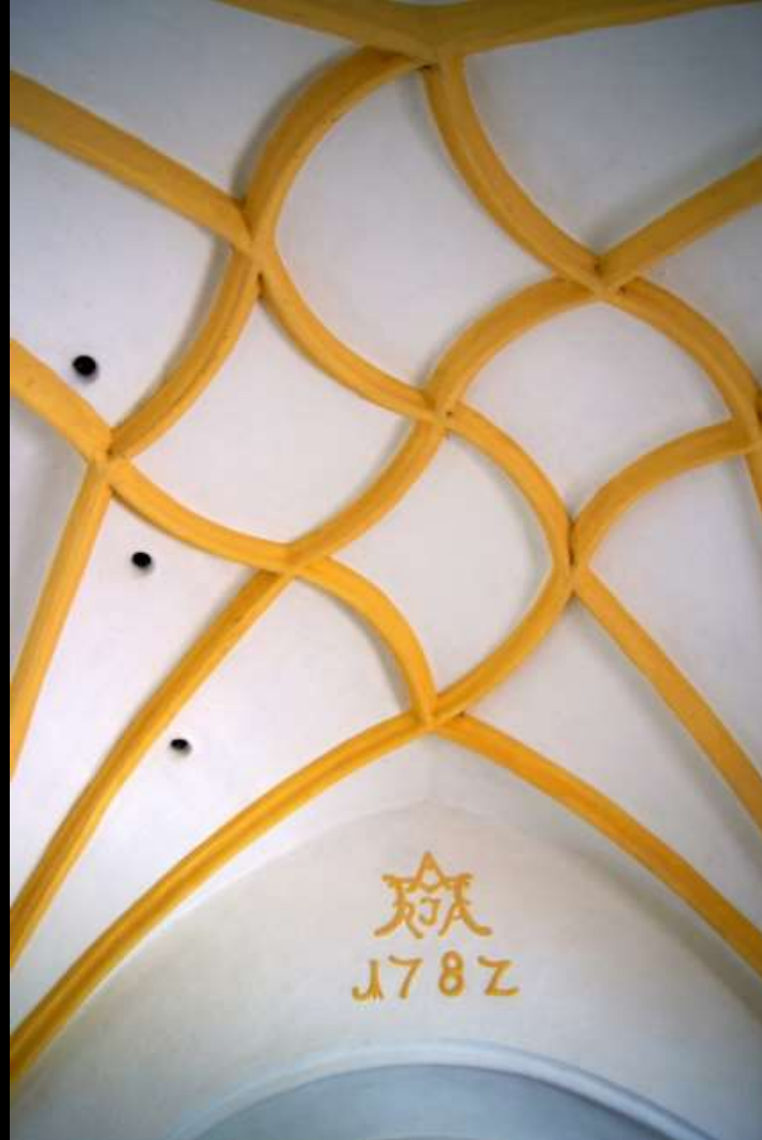
Das Bauwerk als Quelle: «Befunde» Datierung am Turmgewölbe «MARIA 1782» (Frauenkirche Osterwarngau/Bayern)
