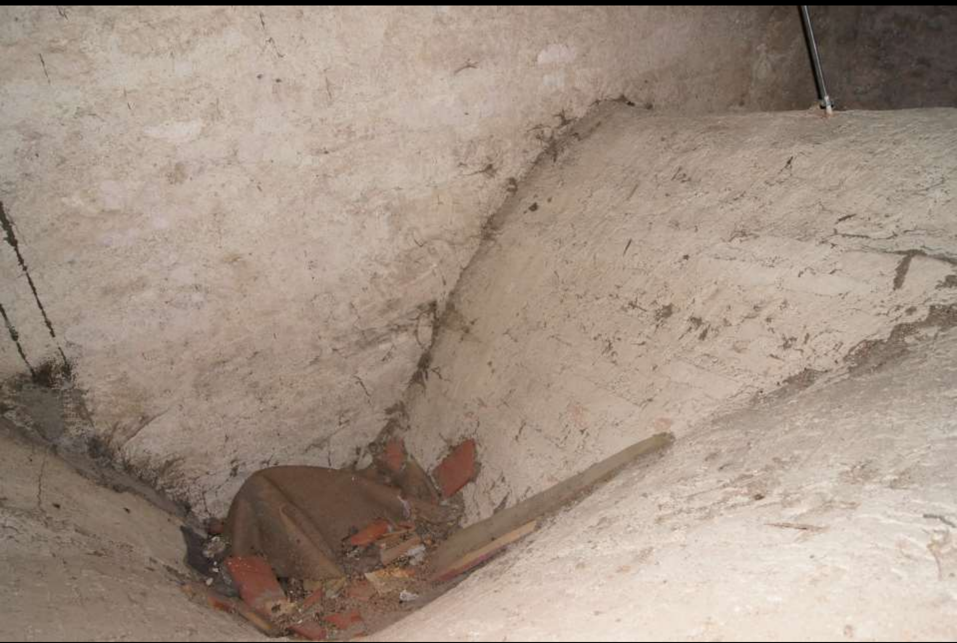
Das Bauwerk als Quelle: «Befunde» Gewölbe spitzbogig – substantiell noch vorhandenes spätgotisches Netzgewölbe? (Frauenkirche Osterwarngau/Bayern)
