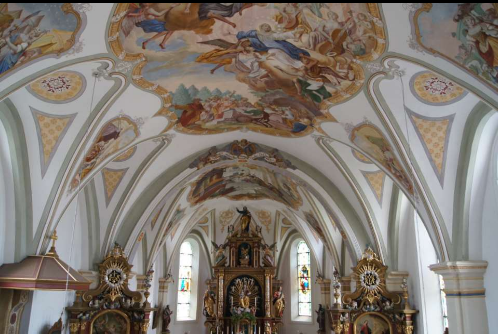
Das Bauwerk als Quelle: «Befunde» Gewölbe spitzbogig – abgeschlagene Rippen? (Frauenkirche Osterwarngau/Bayern)
