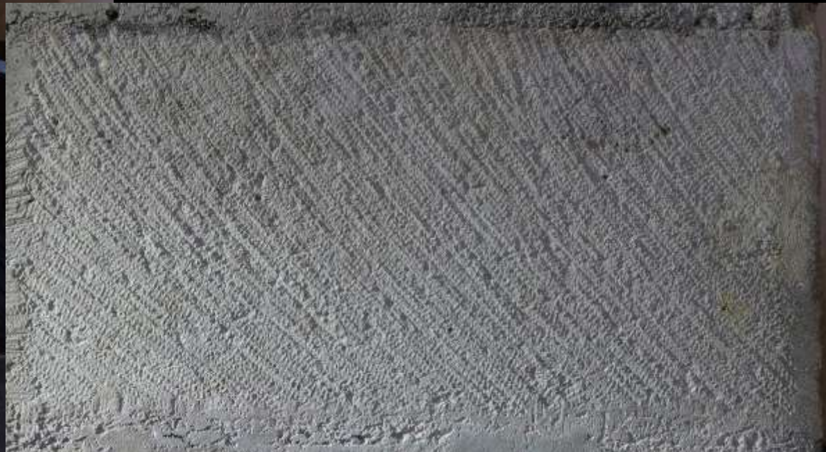
Vignory, Kirche. Eines der wichtigsten Baudenkmäler des 11. Jh. in Frankreich ... Steinbearbeitung an einem Langhauspfeiler
