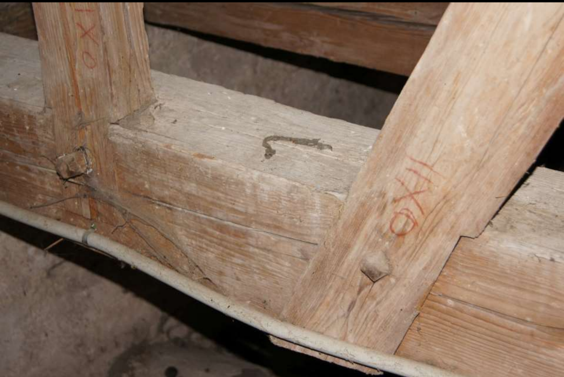
Das Bauwerk als Quelle: «Befunde» Dachwerk «stehender Stuhl» – dendrochronologische Datierung ergibt ca. 1492... (Frauenkirche Oberwarngau/Bayern)
