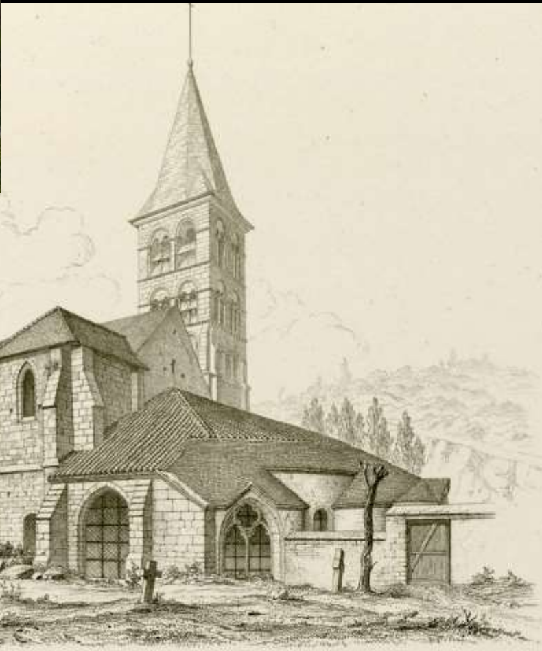
Vue de l'église, avant la restauration. — Côté du cimetière.
