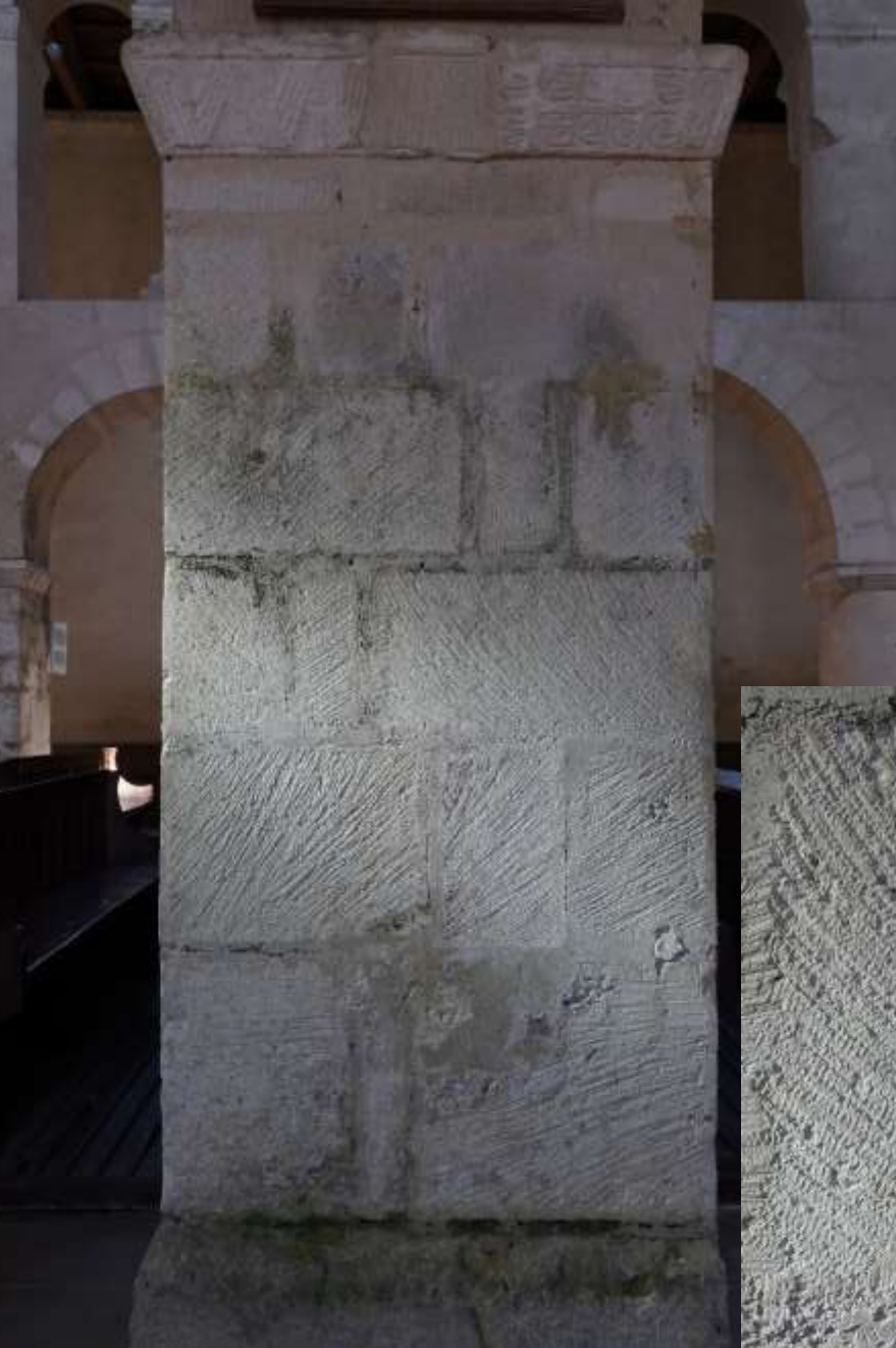
Vignory, Kirche. Eines der wichtigsten Baudenkmäler des 11. Jh. in Frankreich ... Steinbearbeitung an einem Langhauspfeiler
