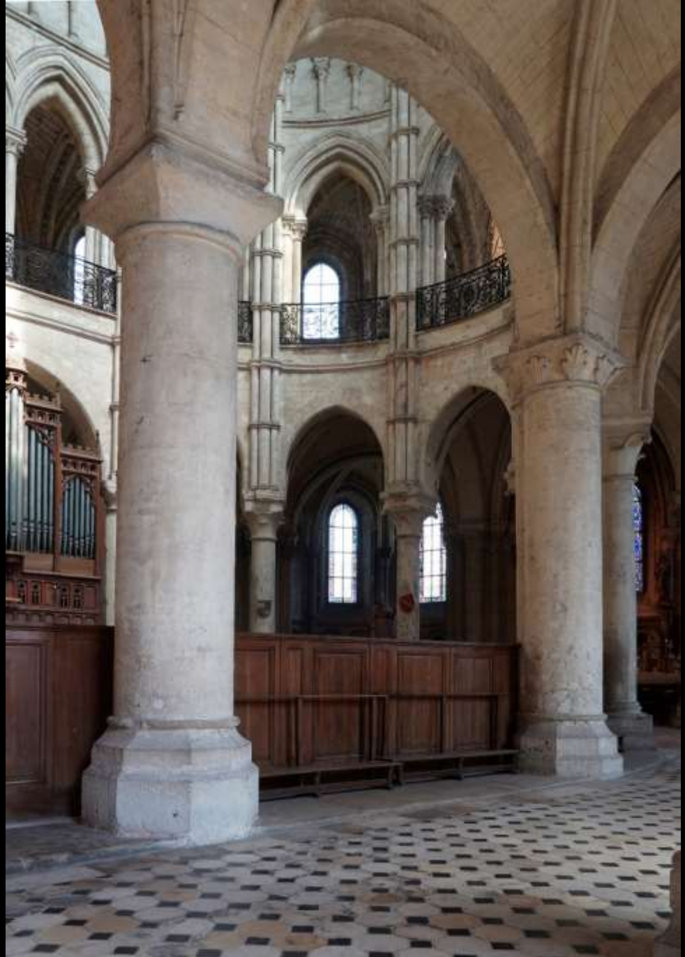
Noyon, Kathedrale (2. H. 12. Jh.). Chorumgang. Pfeiler links laut Baualtersplan um 1170, Säulen rechts 15. Jh.
