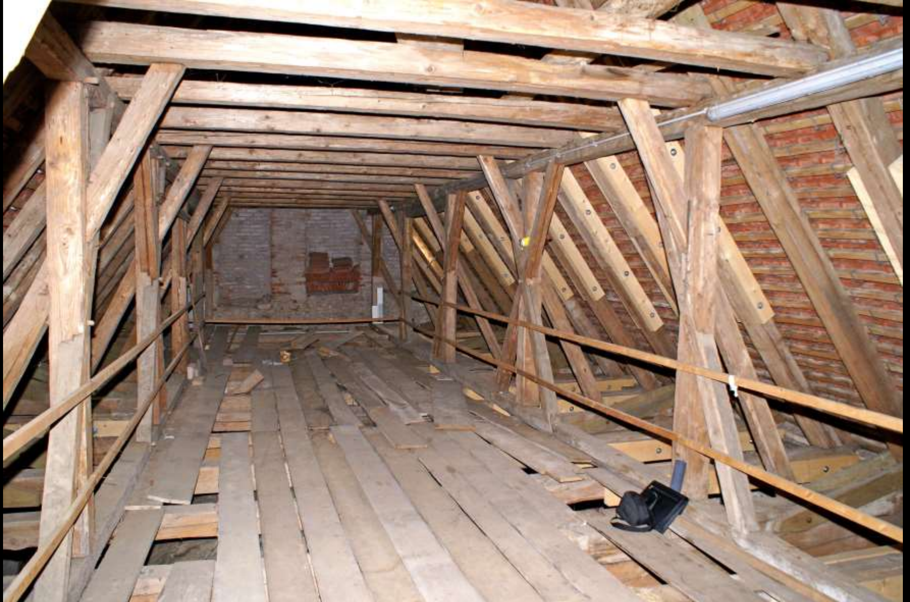
Dachwerk, Blick nach West. „Stehender Stuhl“ spätgotischer Prägung.
