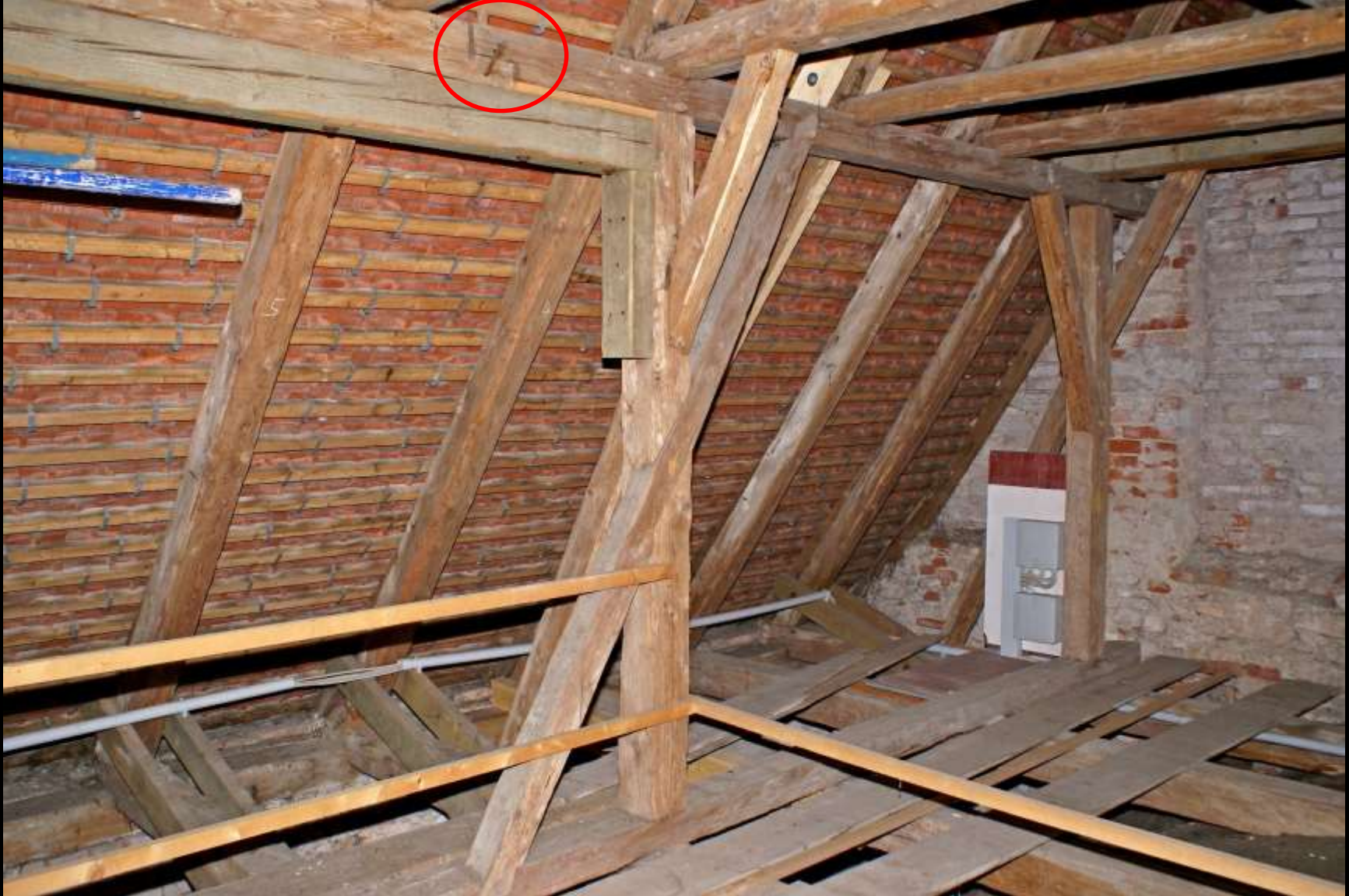
Dachwerk der westlichen Verlängerung. Sichtbare Zeichen der "Anstückelung", deuten erwartungsgemäss auf höheres Alter des restlichen Langhausdaches
