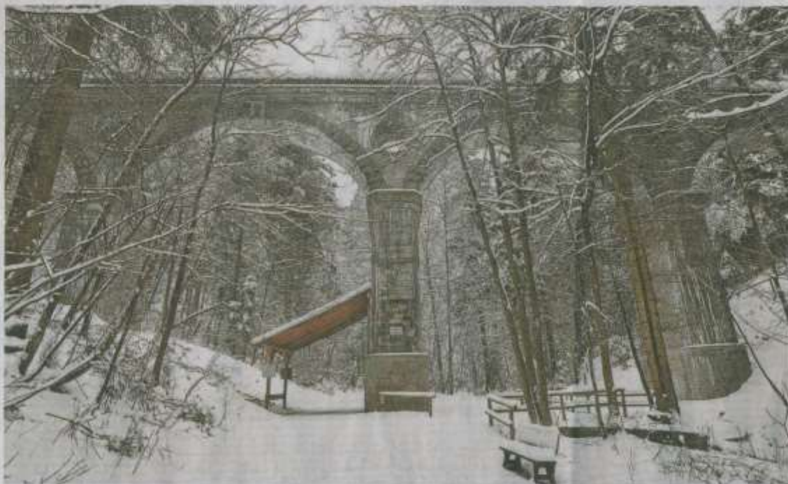
Seit 120 Jahren überspannt eine Wasserleitungs-Brücke den Teufelsgraben bei Grub. Da manchmal bereits Brocken herabfallen, wurde für Fußgänger eine Überdachung gebaut. Offiziell ist der Weg jetzt sogar gesperrt. FOTOS PLETTENBERG
