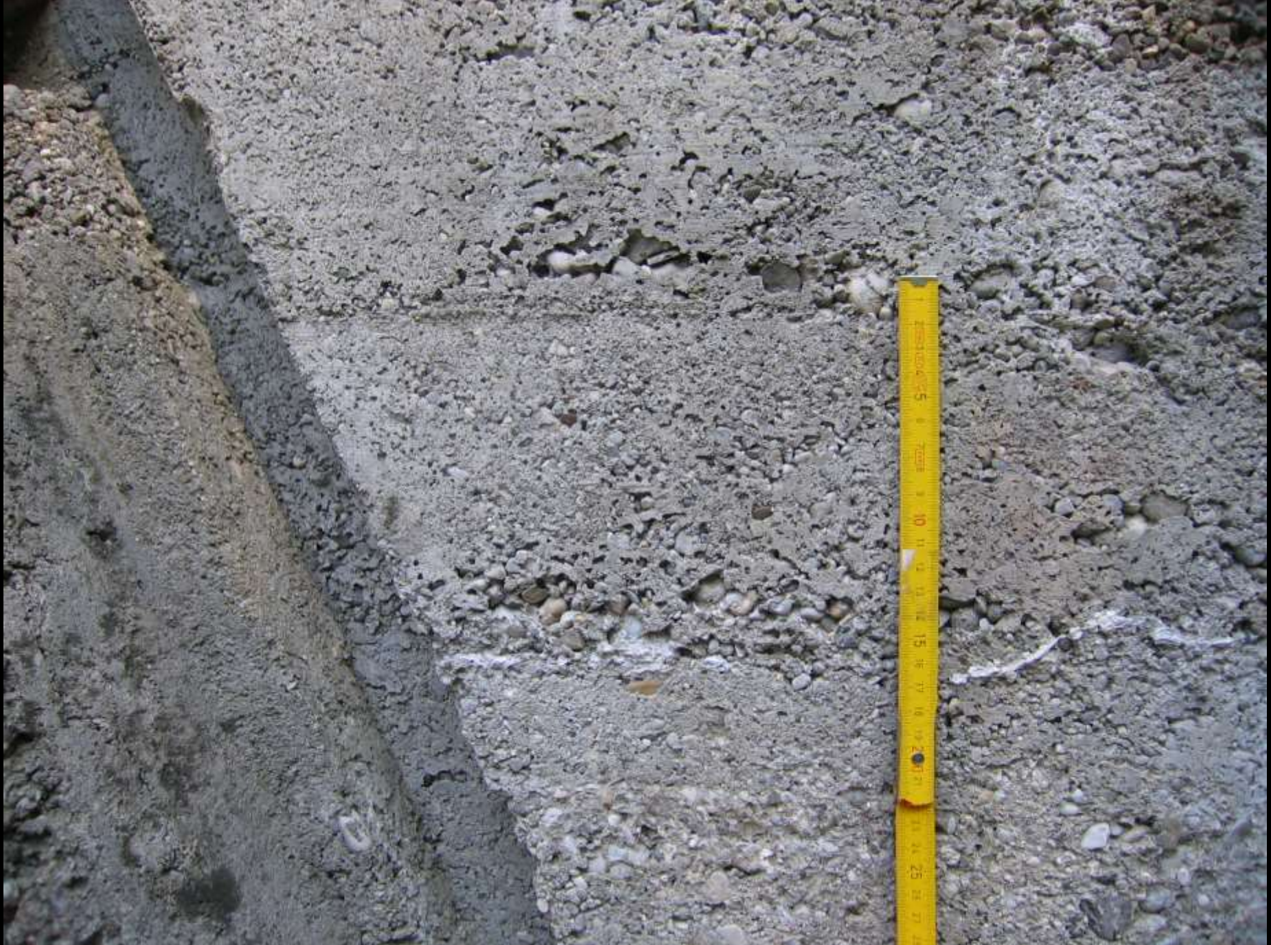
Spuren des schichtweisen Einbringens und Stampfens des Betons in horizontalen Lagen von 15 cm
