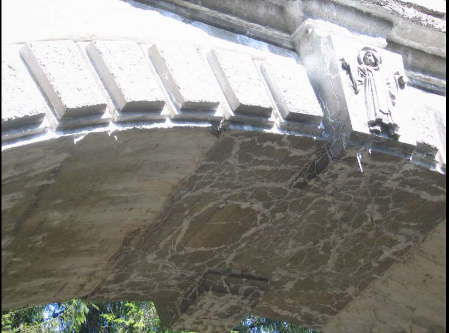
Besichtigungen vom 13. und 24. April 2010: Und die Schlusssteine? ->ebenfalls eingesetzte vofabrizierte Teile
