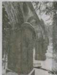
17 Meter hoch ist das Gruber Aquädukt.
