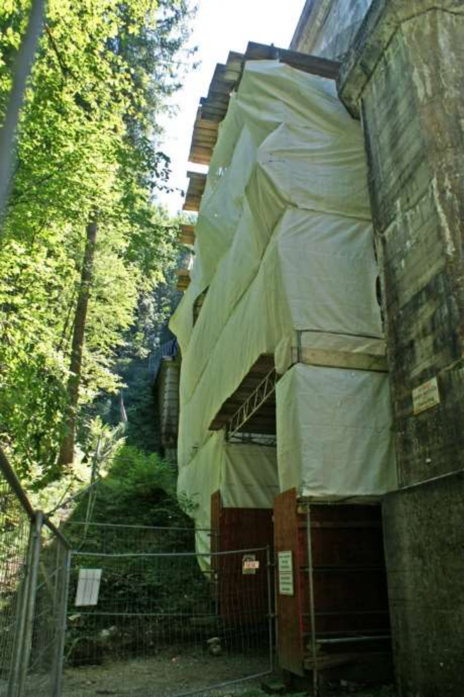
Ein Sicherungsgerüst ist installiert (29. August 2012)
