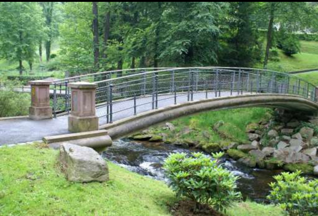
Enzbrücke im Kurpark (Lichtweite 16 m, verlorene Widerlager, Rheinhard 1885) Sichtflächen aus gefärbtem Beton, mit Eisen zusammengespannt
