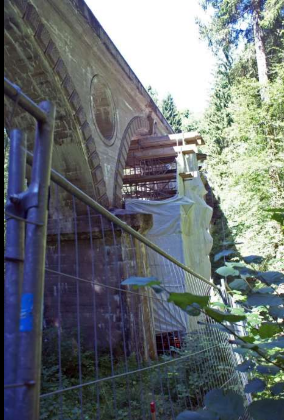
Ein Sicherungsgerüst ist installiert (29. August 2012)
