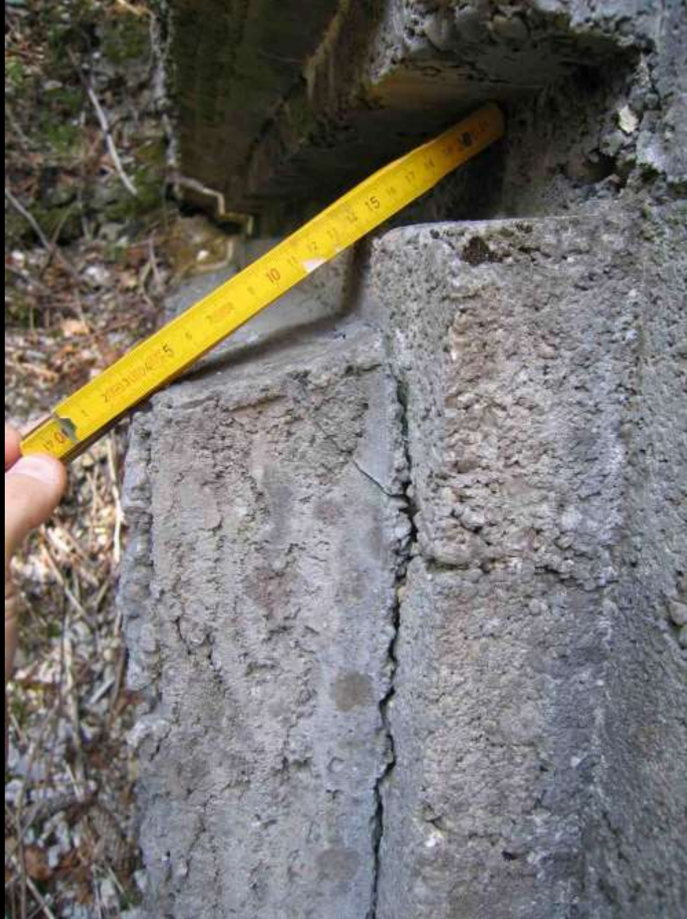
Besichtigungen vom 13. und 24. April 2010: Wie sind eigentlich die „Bossenquader“ gemacht? -> Eingesetzte, vofabrizierte Teile!
