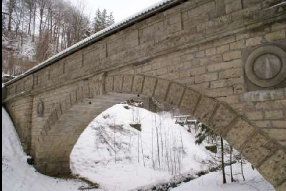
Höllgrabenaquädukt, 1886: Werksteinbau, flachgespannte Bogenbrücke, 15 m Spannweite
