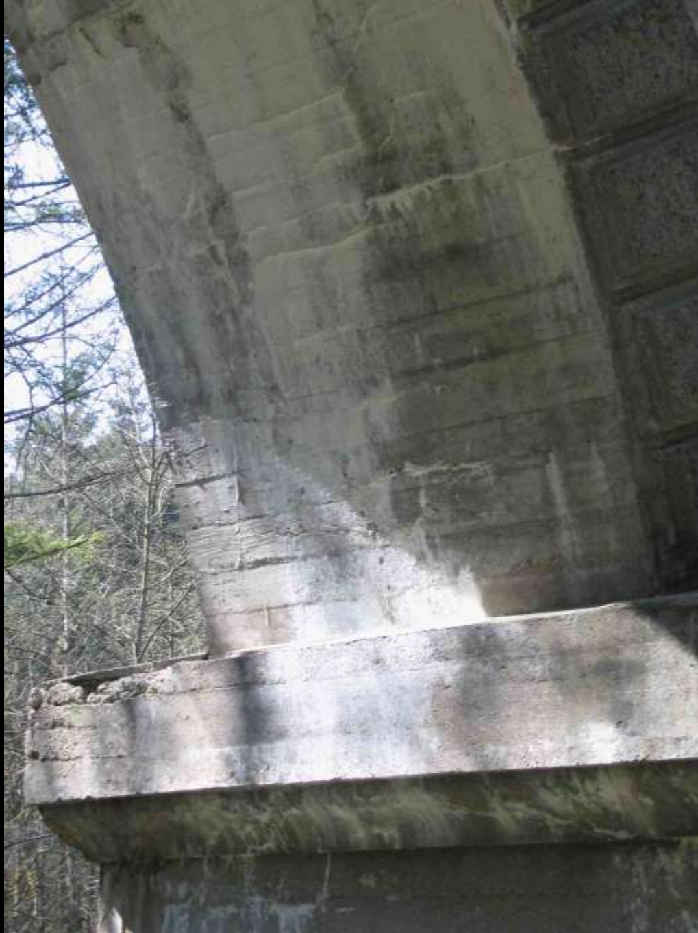
Im Streiflicht werden Schalbrettspuren sichtbar
