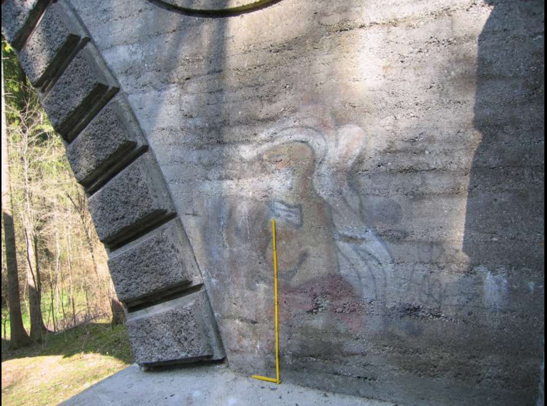
Spuren des schichtweisen Einbringens und Stampfens des Betons in horizontalen Lagen
