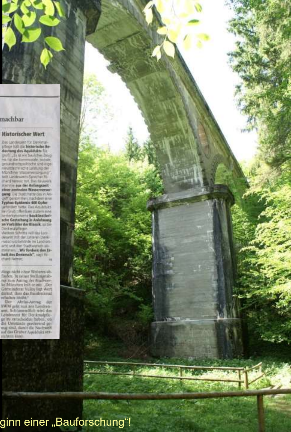
Seit 120 Jahren überspannt eine Wasserleitungsbrücke den Teufelsgraben bei Grub. Da manchmal bereits Brücken herabfallen, wurde für Fußgänger eine Überdachung gebaut. Offiziell ist der Weg jetzt sogar gesperrt.
