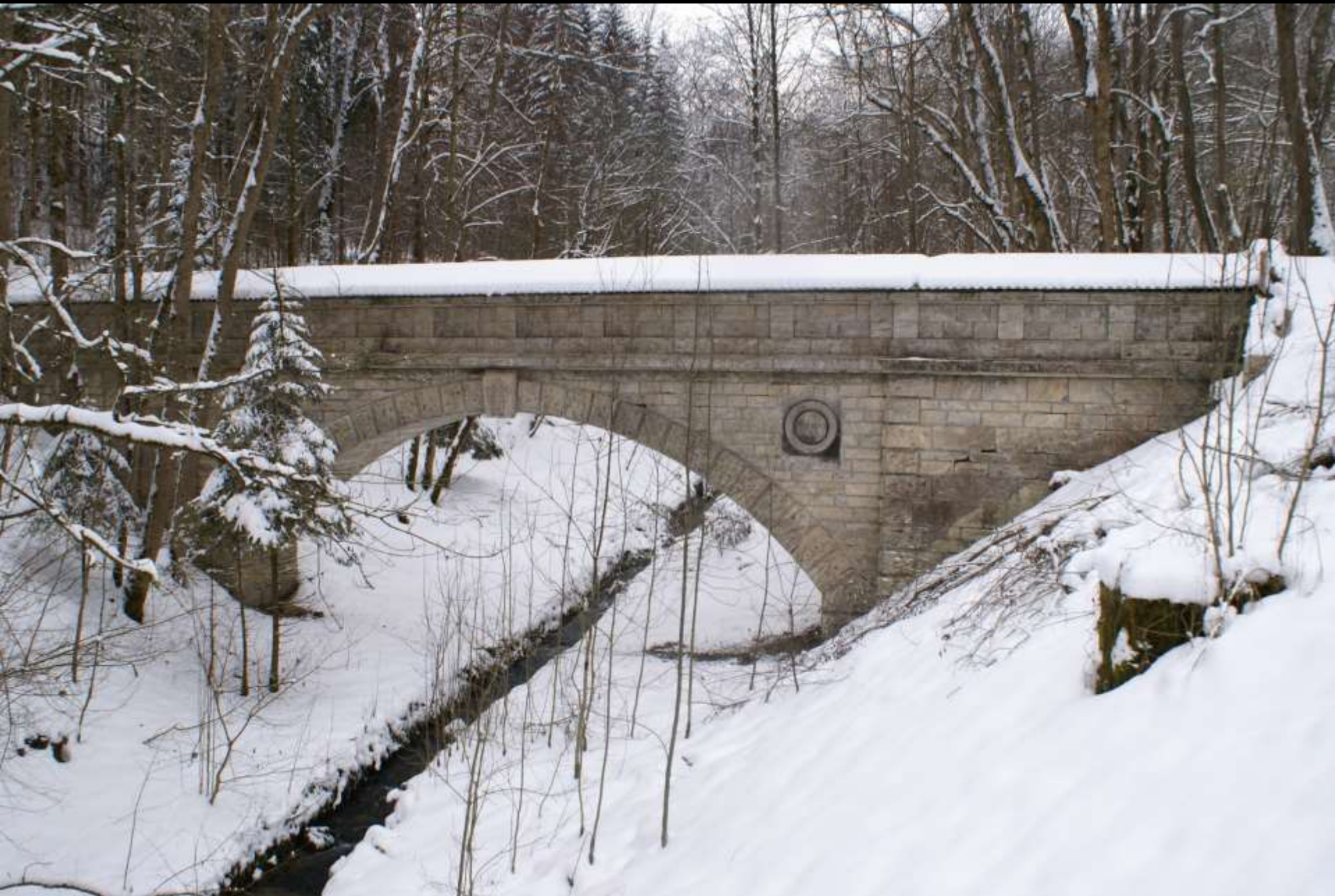
Ein erster Vor-Ort-Besichtigungstermin (13. Februar 2010): Kontext in der Umgebung
