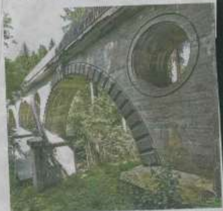
Römische Anwendungen: der Aquädukt von Grub.
