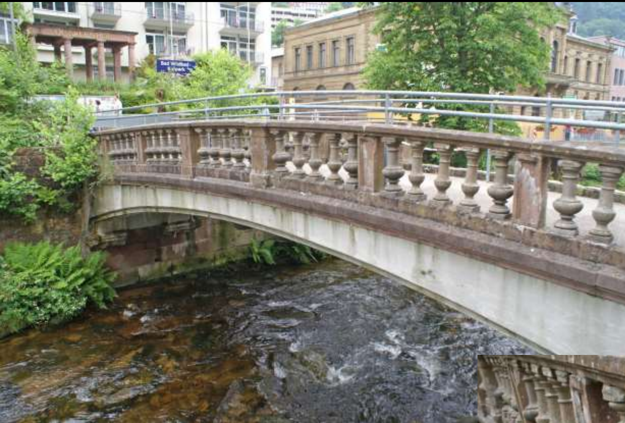
Enzbrücke beim Kurhaus Bad Wildbad 11.8 m Spannweite, 1882, unbewehrtes Betonbauwerk!
