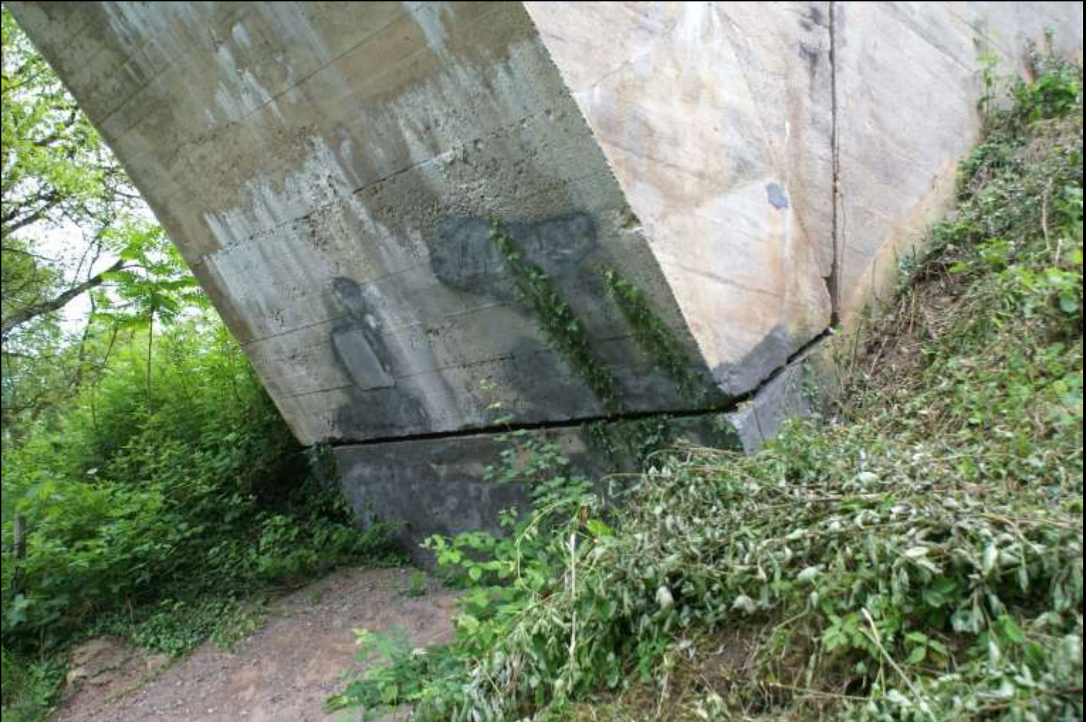
Igelsbachviadukt Klaffenbach: Eisenbeton-Dreigelenkbogen (Jori & Schächterle 1909)
