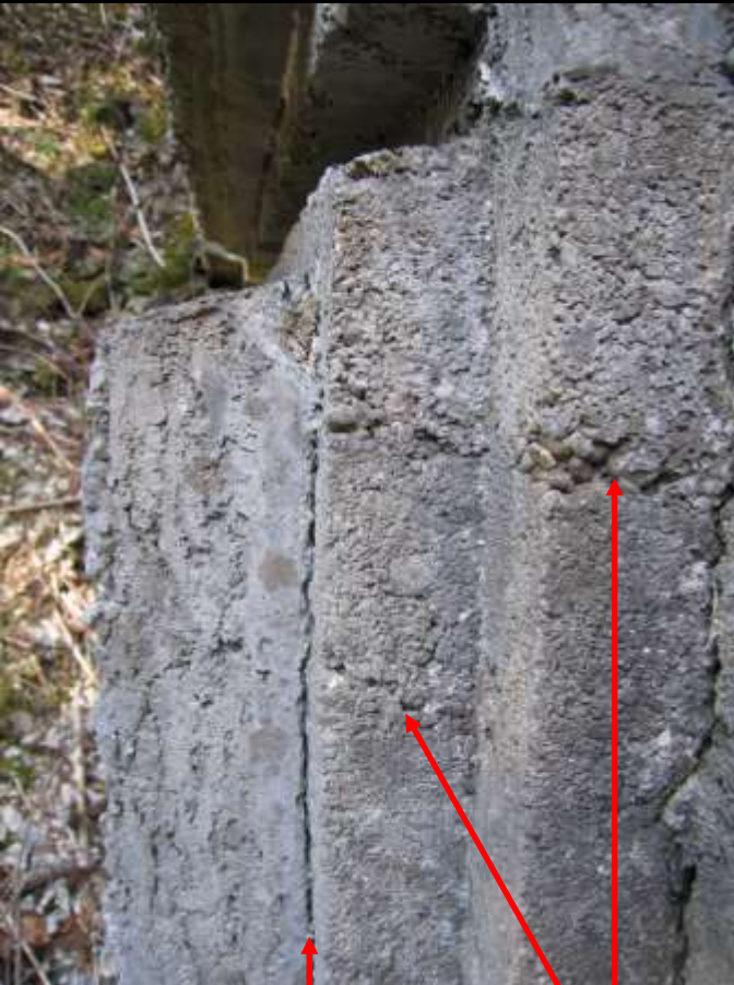
Fuge des Vorsatzelementes
