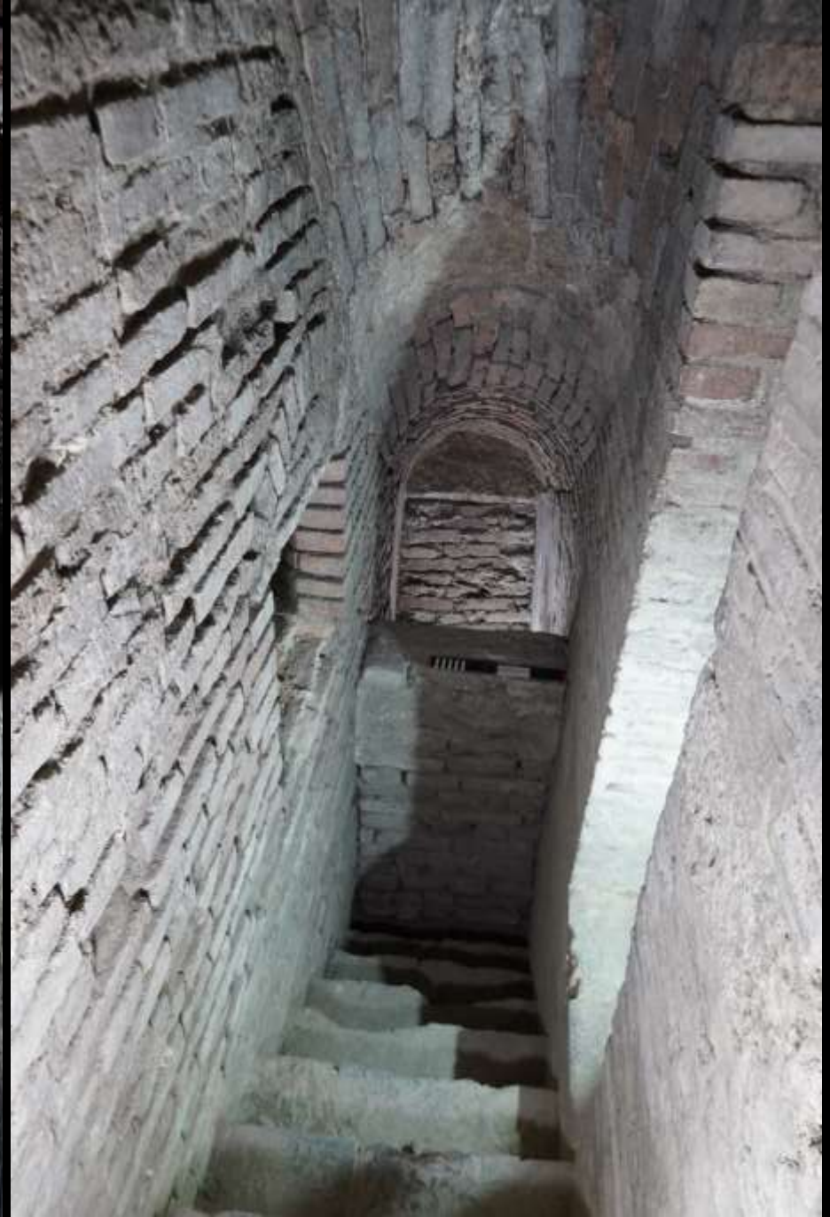
Padua – Basilica Sant'Antonio. System der Laufgänge und Treppen in der Mauerstärke
