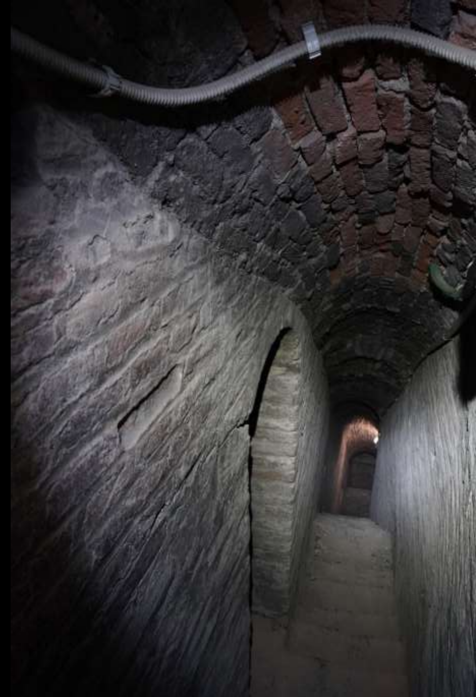
Padua – Basilica Sant'Antonio. System der Laufgänge und Treppen in der Mauerstärke
