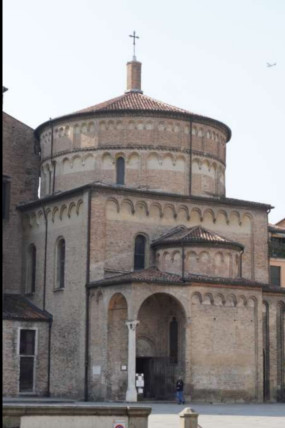
Vergleichsbeispiel: Padua, Baptisterium, gesichert erbaut 1260 – 1281.
