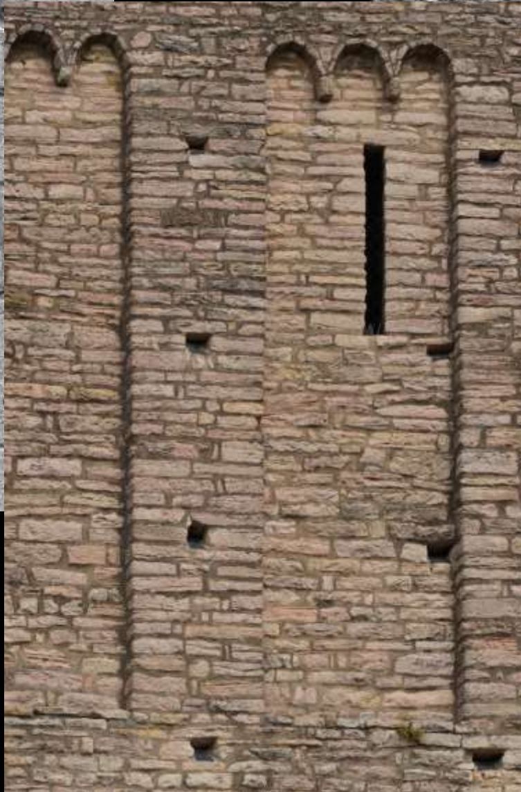
Rüstlöcher Spuren des Gerüstes
