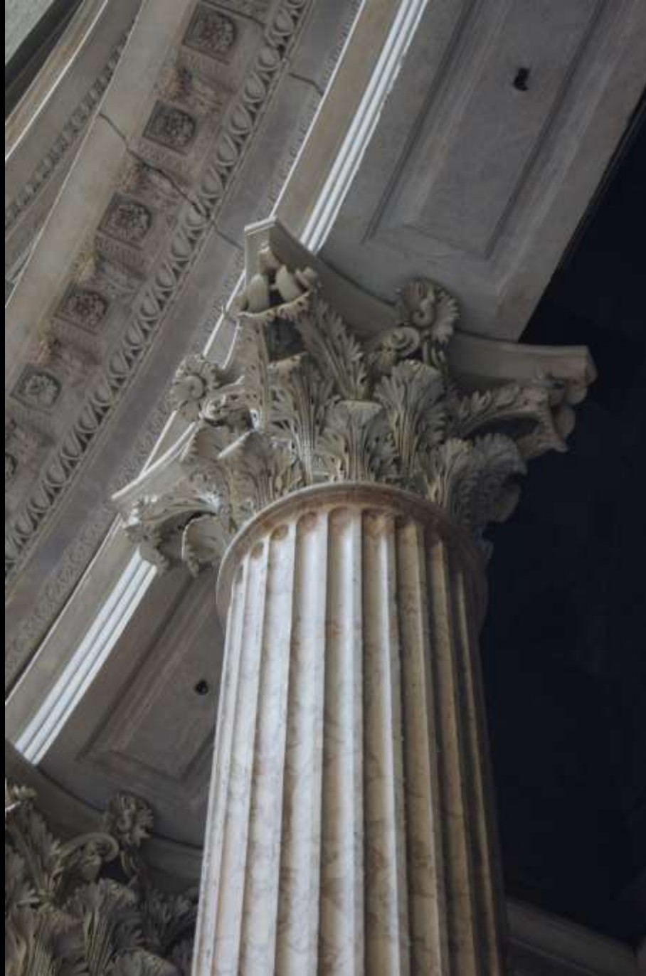
Kanneluren einer Säule korinthischer Ordnung (Pantheon, Rom, Innenraum)
