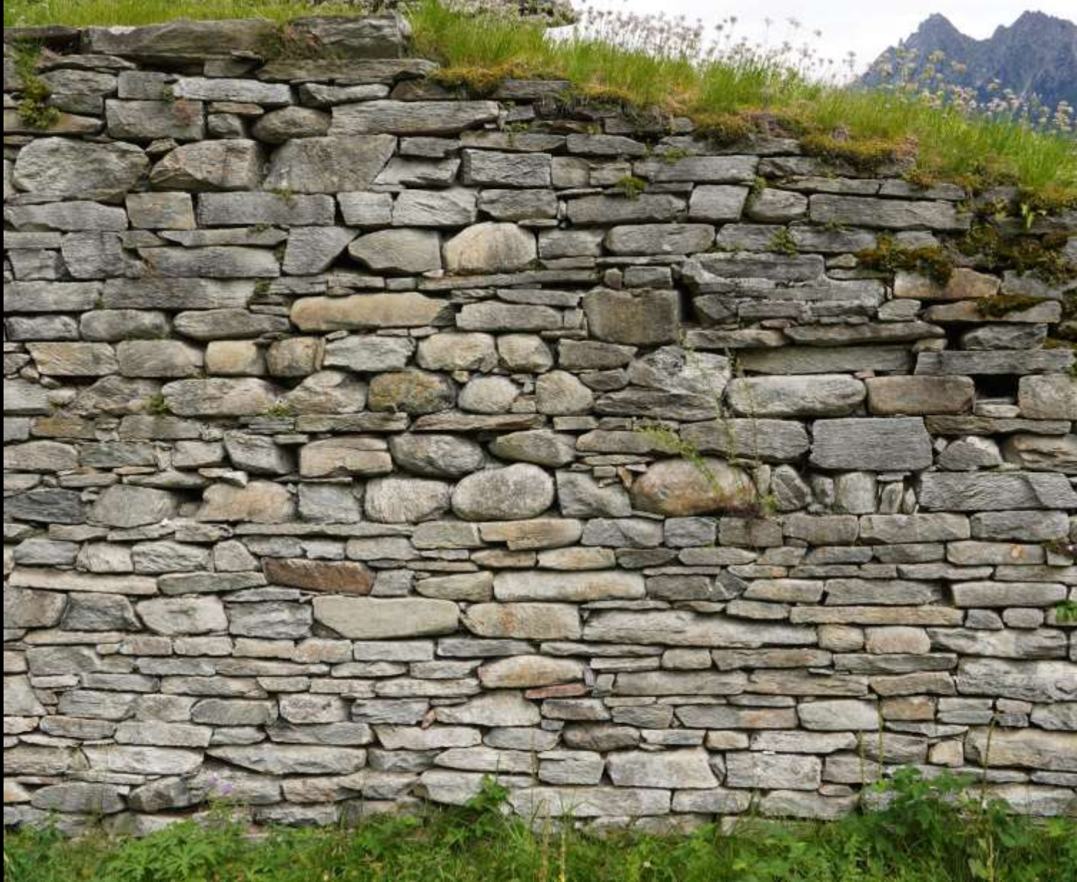
Trocken geschichtete Bruchsteinmauer
