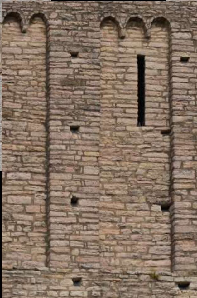
Ein historisches Bauwerk „lesen“ lernen! – Beispiel Löcher an einem Bauwerk
