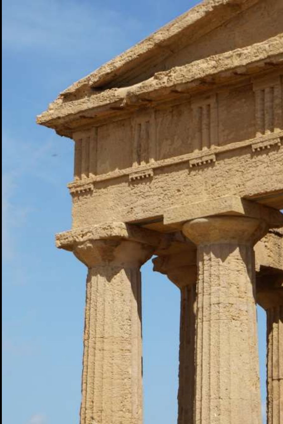
Sog. „Concordia-Tempel“, Agrigent. Detail der dorischen Ordnung
