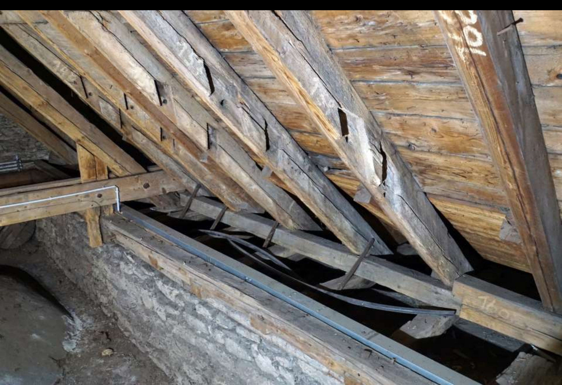
Handwerkliches Bauen ist nachhaltig Wiederverwendung ganzer Konstruktionen (Beispiel Dachwerk Dom Limburg/Lahn, Südquerhaus)
