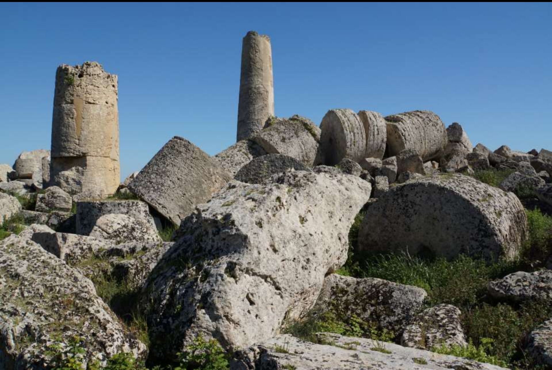
Säulen in Sturzlage nach Erdbeben (Tempel G, Selinunt)
