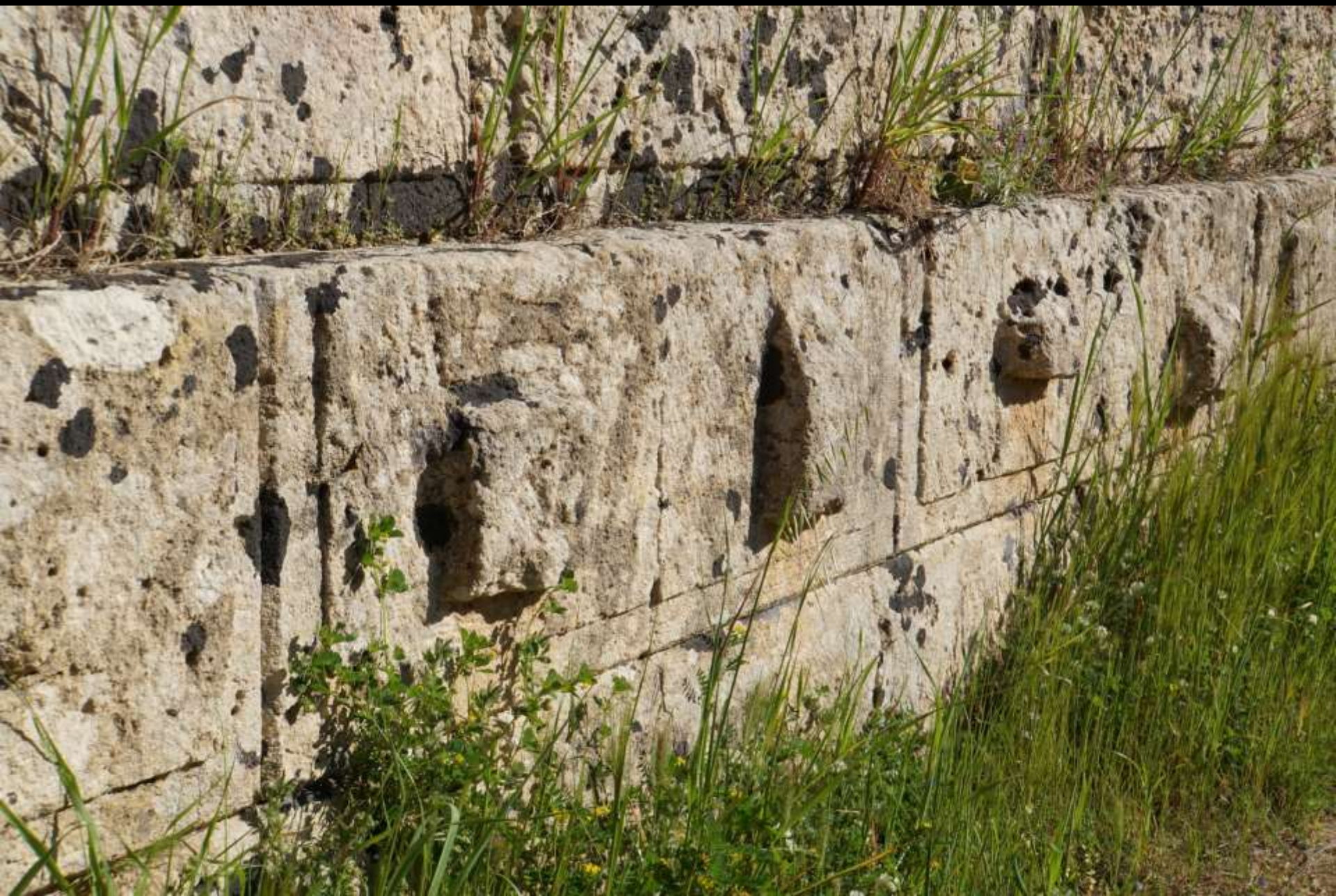
Selinunt, Temenosmauer von Tempel D, 5. Jh. v. Chr. Bossen, „Werkzoll“ und „Saumschlag“
