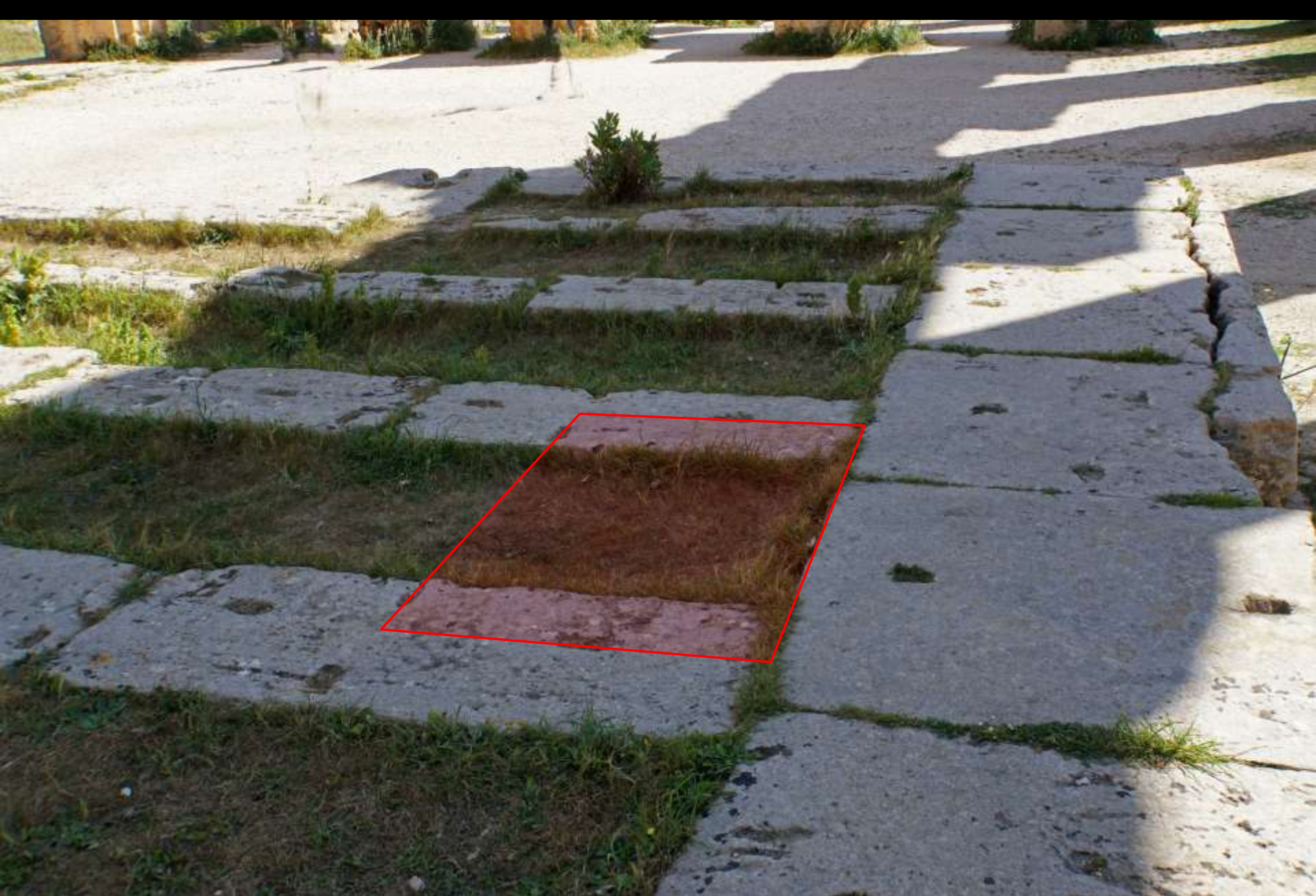
Das Fundament – Tempel E, Selinunt, 5. Jh. v. Chr.: Stemmlöcher auf dem rostartigen Fundament des Cellafussbodens
