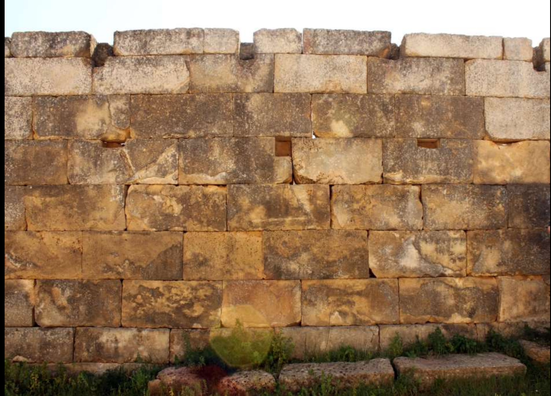
Dachspuren (Hera-Tempel, Contrada Gaggera, Selinunt, Anf. 6. Jh. v. Chr.)
