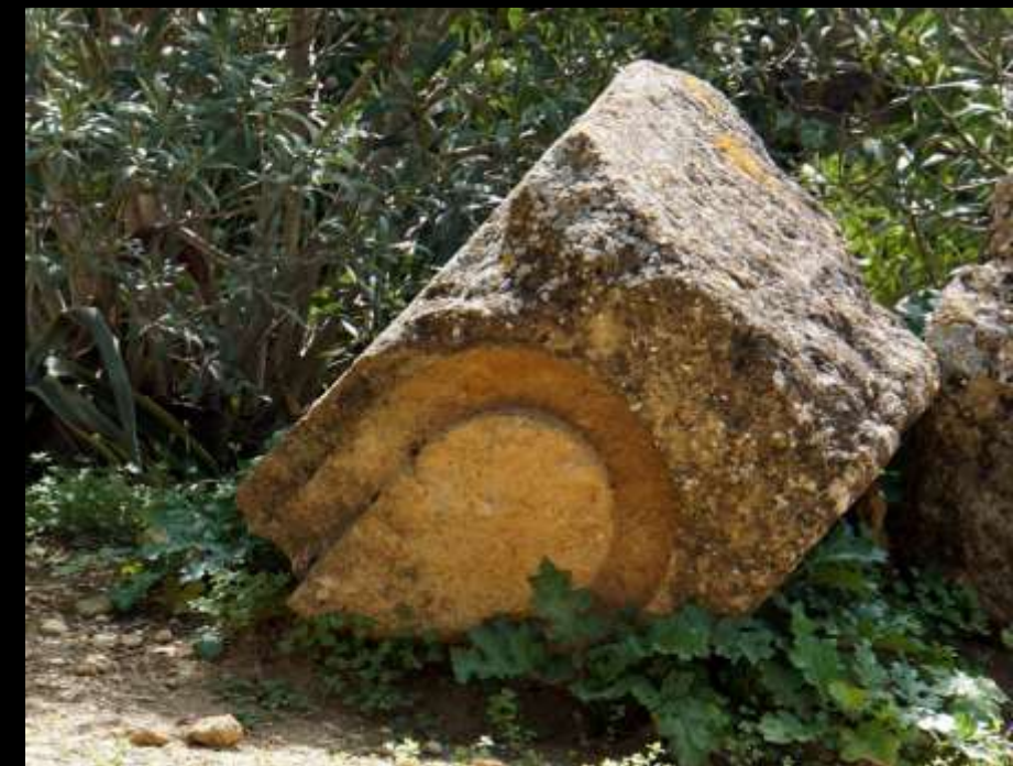
Seilrinnen an abgestürzten Blöcken (sog. Juno-Lacinia-Tempel, Agrigent, 5. Jh. v. Chr.) (Durm 1892 und Koldewey/Puchstein 1899)
