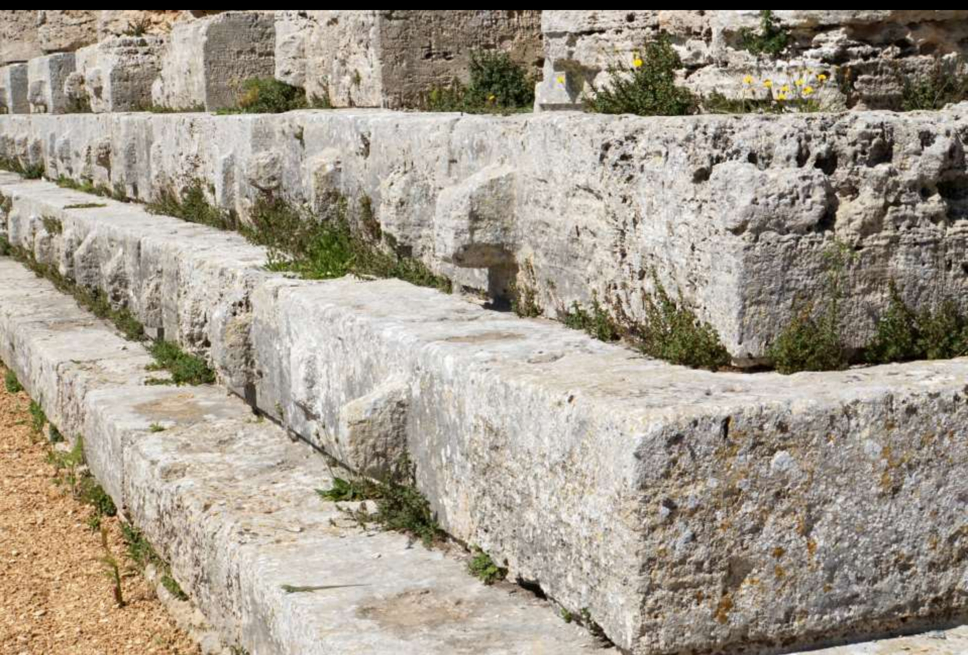
Segesta Stufenbau (Krepis) mit Bossen
