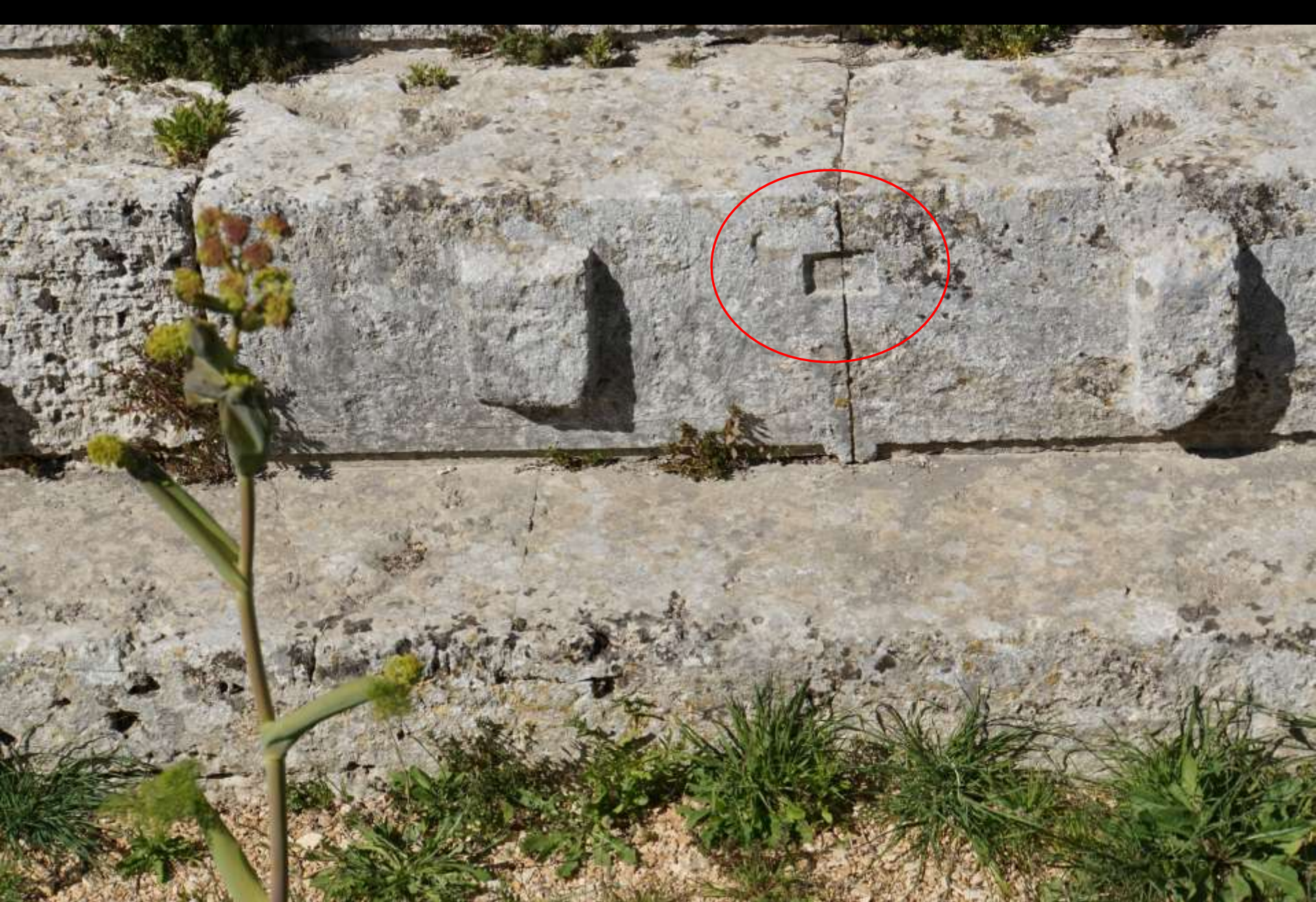
Segesta, Ende 5. Jh. v. Chr. Lehre zum endgültigen Zurückarbeiten des Quaderspiegels
