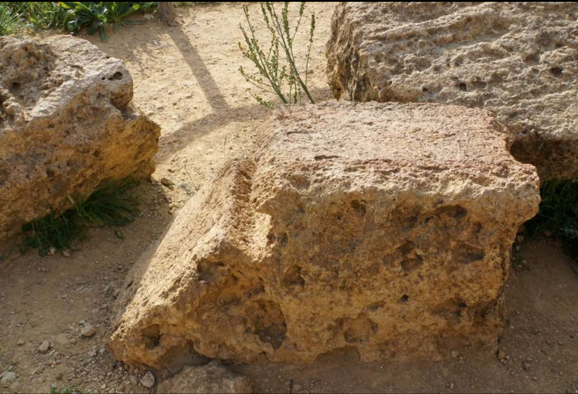
„Auf Gehrung“ geschnittene Ecke des inneren Architravblocks („Tempel der Juno Lacinia“, Agrigent)
