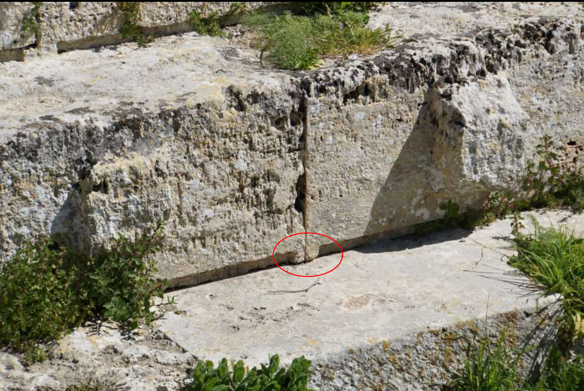
Segesta, Ende 5. Jh. v. Chr. Werkzoll, zurückgearbeitete „Lehre“ und Kantenschutzbosse
