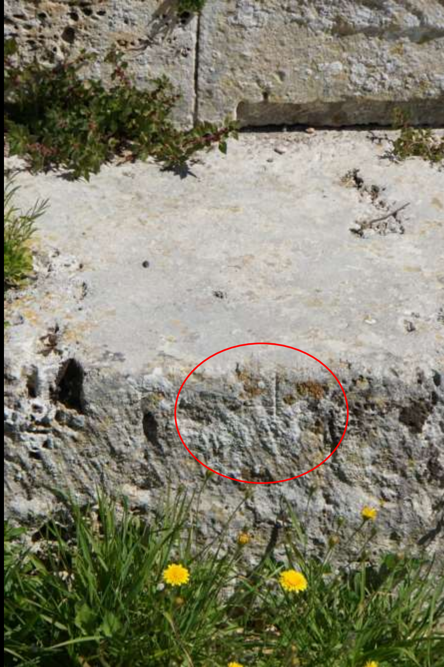
Segesta, Ende 5. Jh. v. Chr. Kurvatur des Stufenbaus – Markierung der Bezugslinie
