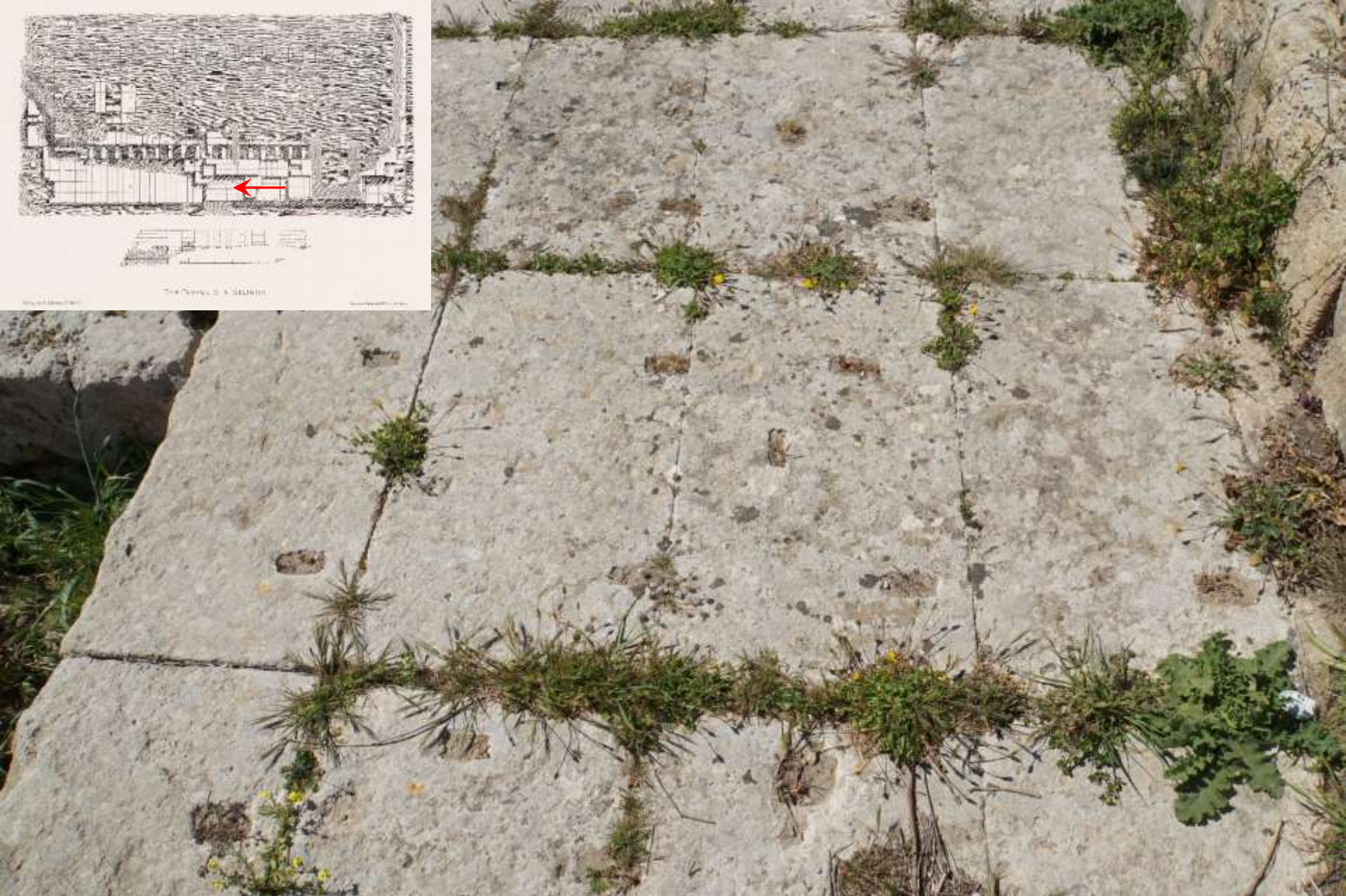
Das Fundament – Tempel O, Selinunt, 5. Jh. v. Chr.: Wechsel von Läufer- und Binderschichten Stemmlöcher
