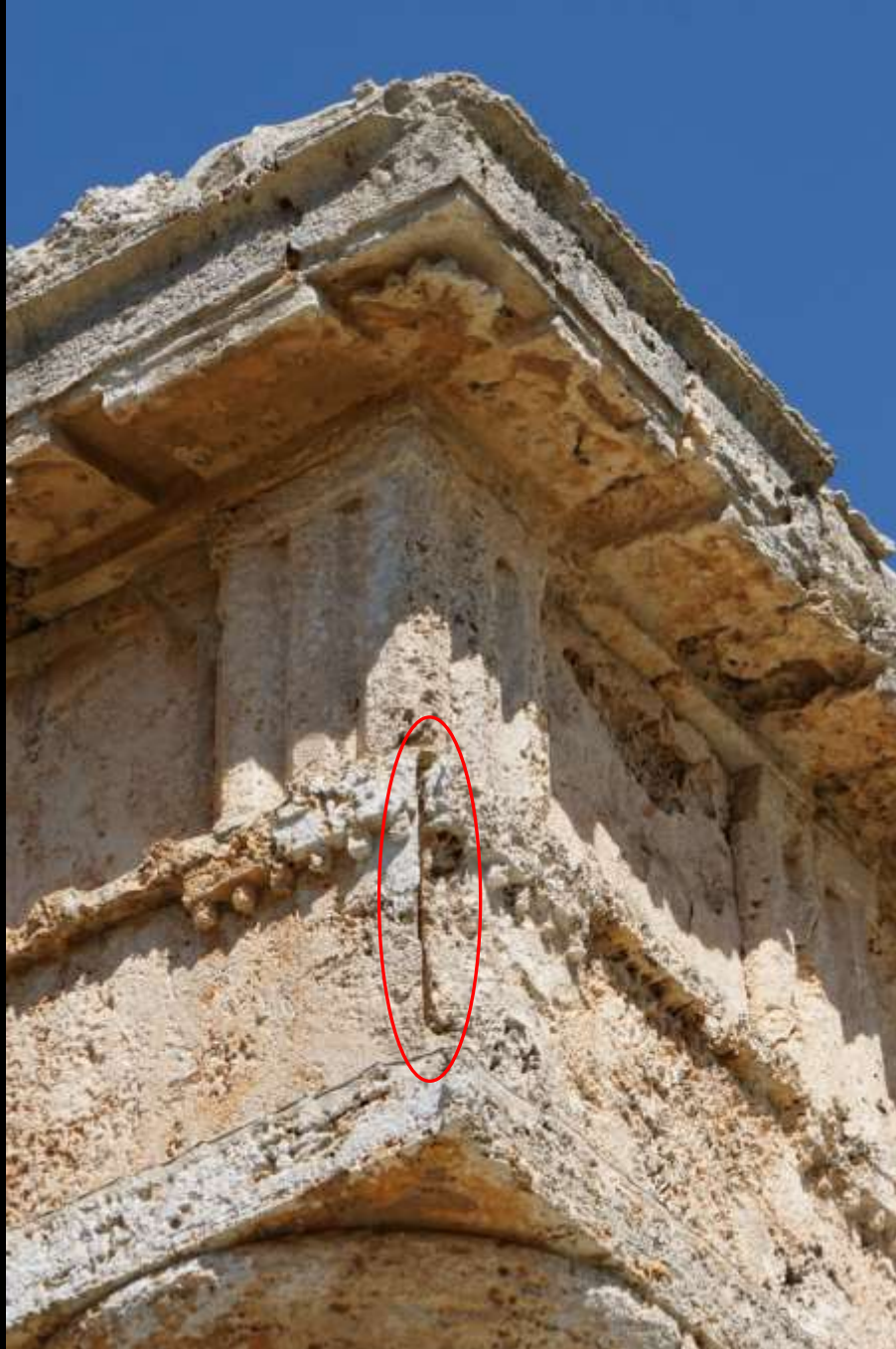
„Auf Gehrung“ geschnittene Ecke des Architravs (Segesta)
