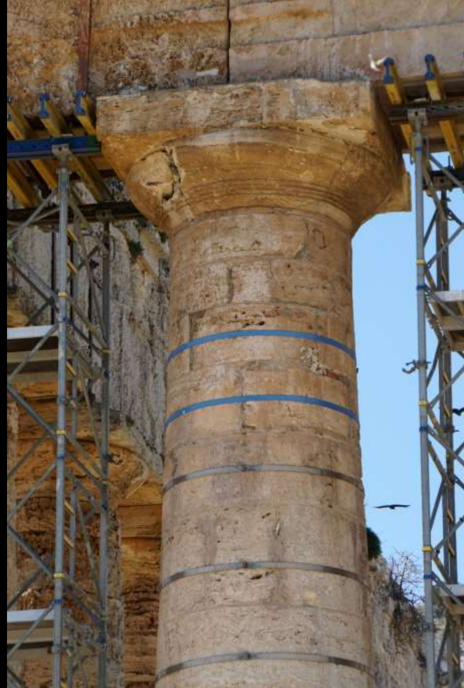
Frühe Vermessungs- und Erhaltungsbemühungen: reparierte Frontsäule, Segesta (1781 erneuert)
