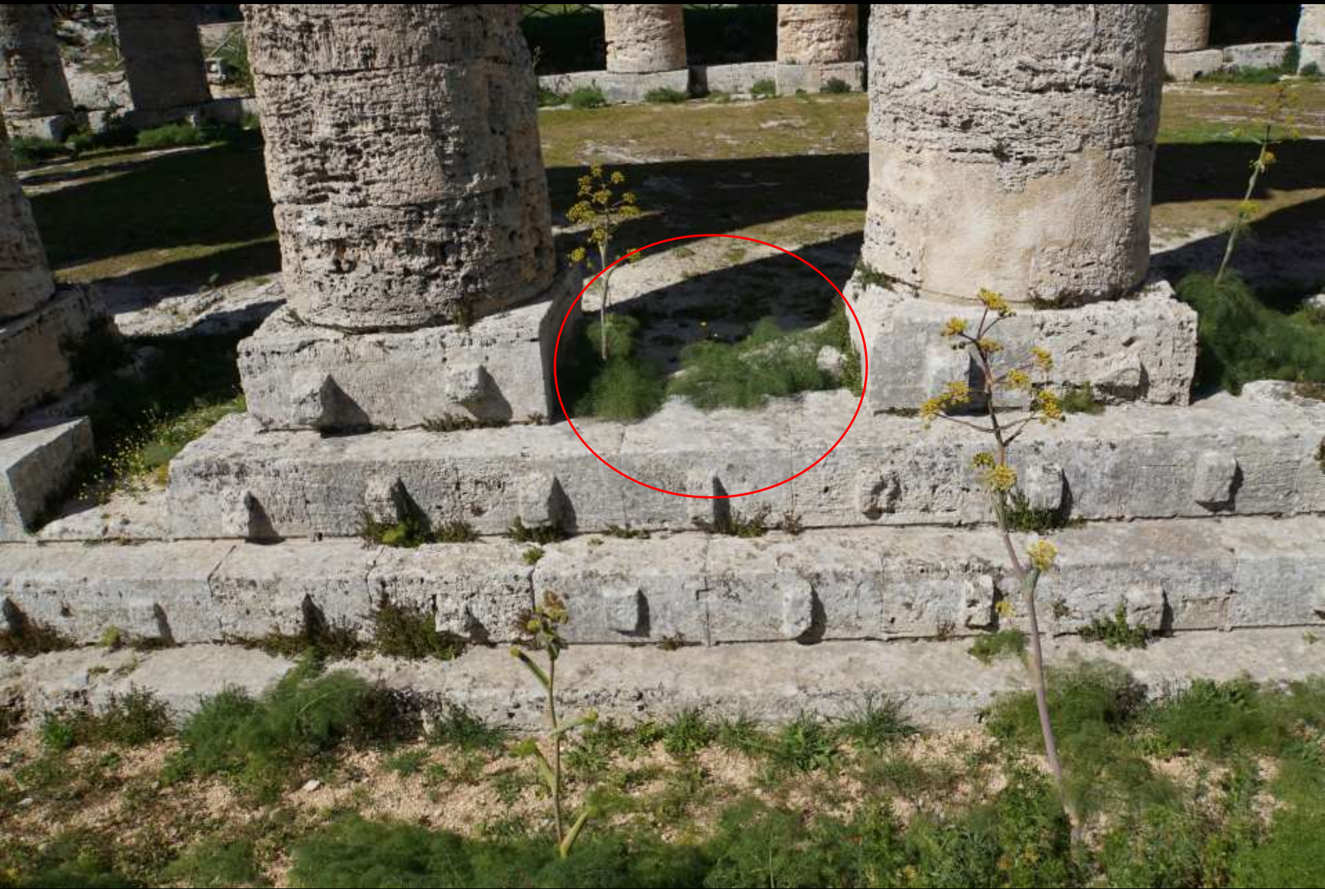
Segesta, Ende 5. Jh. v. Chr. Stufenbau (Krepis) mit geraubten Blöcken (hier 2)
