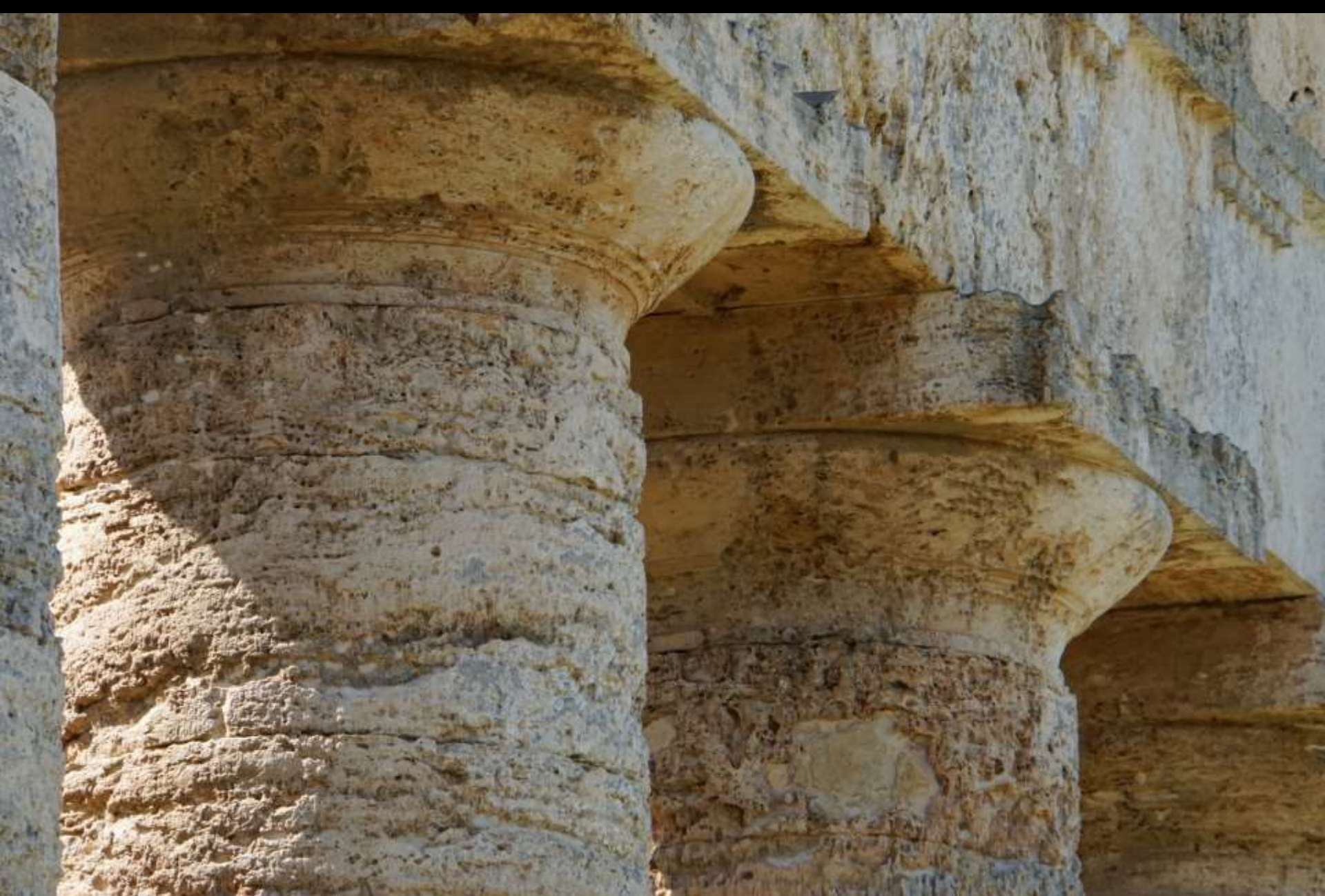
Fertig ausgearbeitet versetzte Kapitelle (Segesta)
