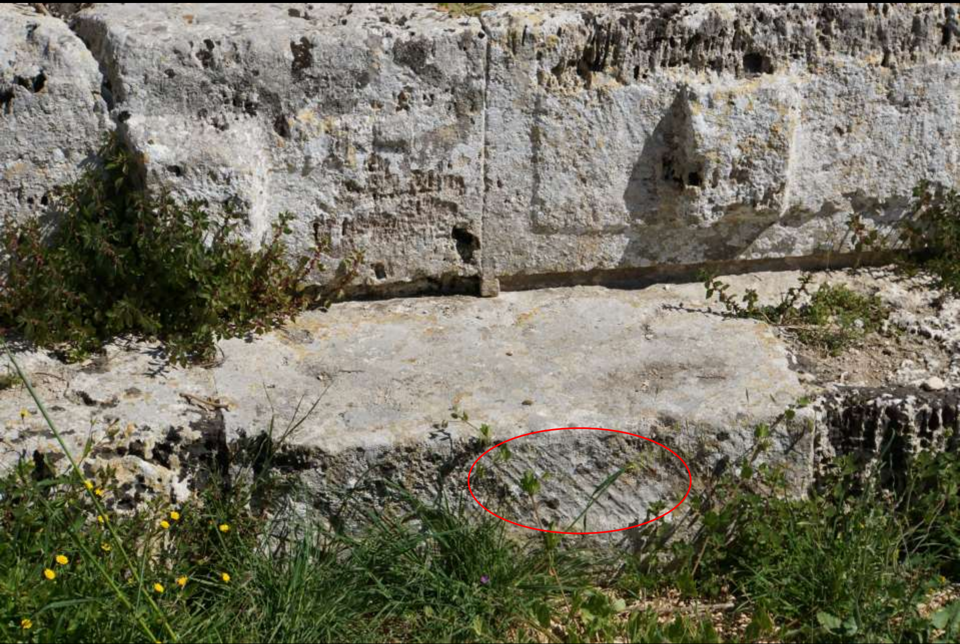
Segesta, Ende 5. Jh. v. Chr. Spuren des Abarbeitens der Bosse mit dem Dechsel an der Euthynterie
