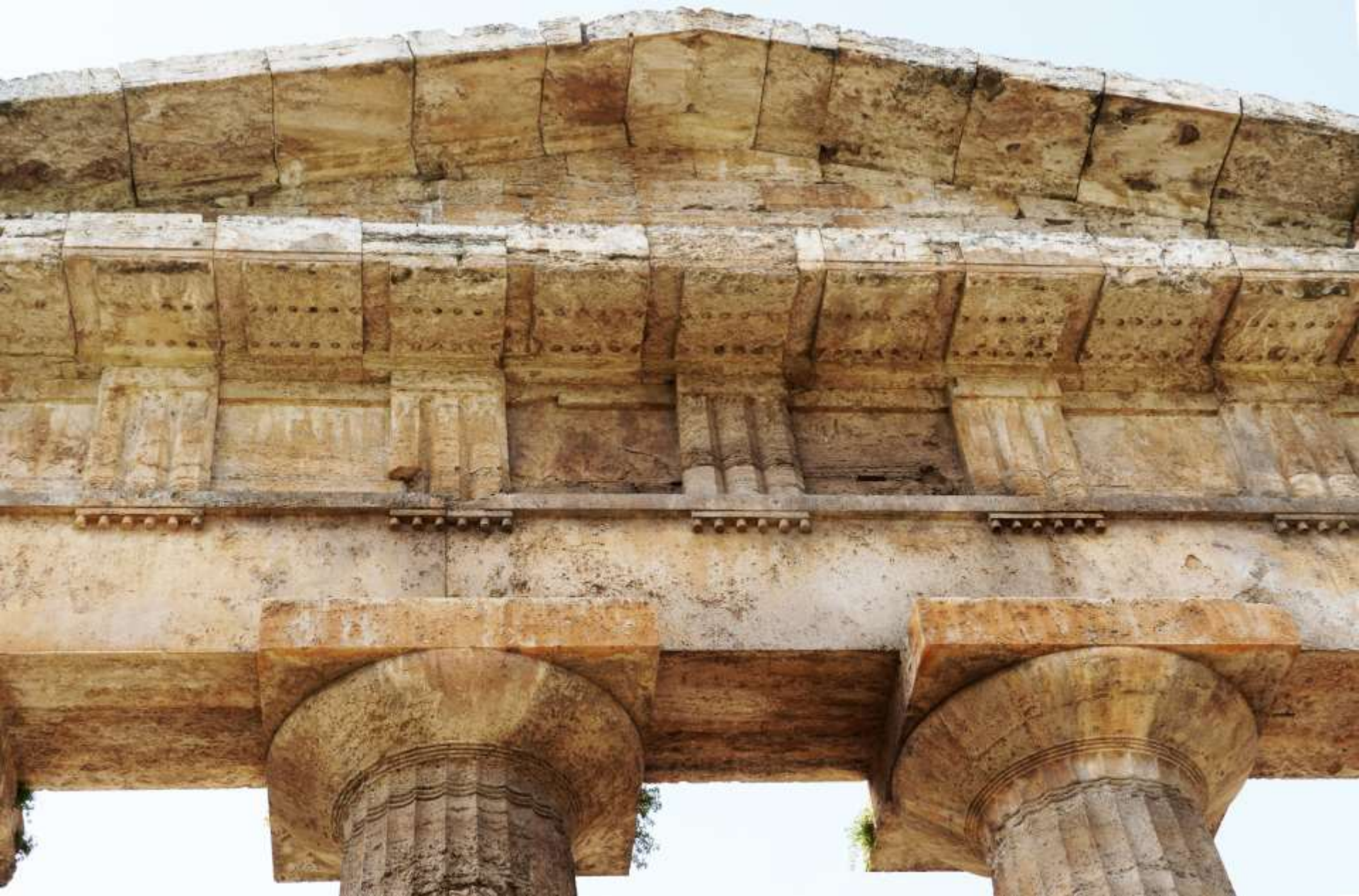
Fugenschnitt am Triglyphen-Metopen-Fries und am Geison (Paestum, Hera-Tempel II): schmale, aber lange, weit auskragende Steine
