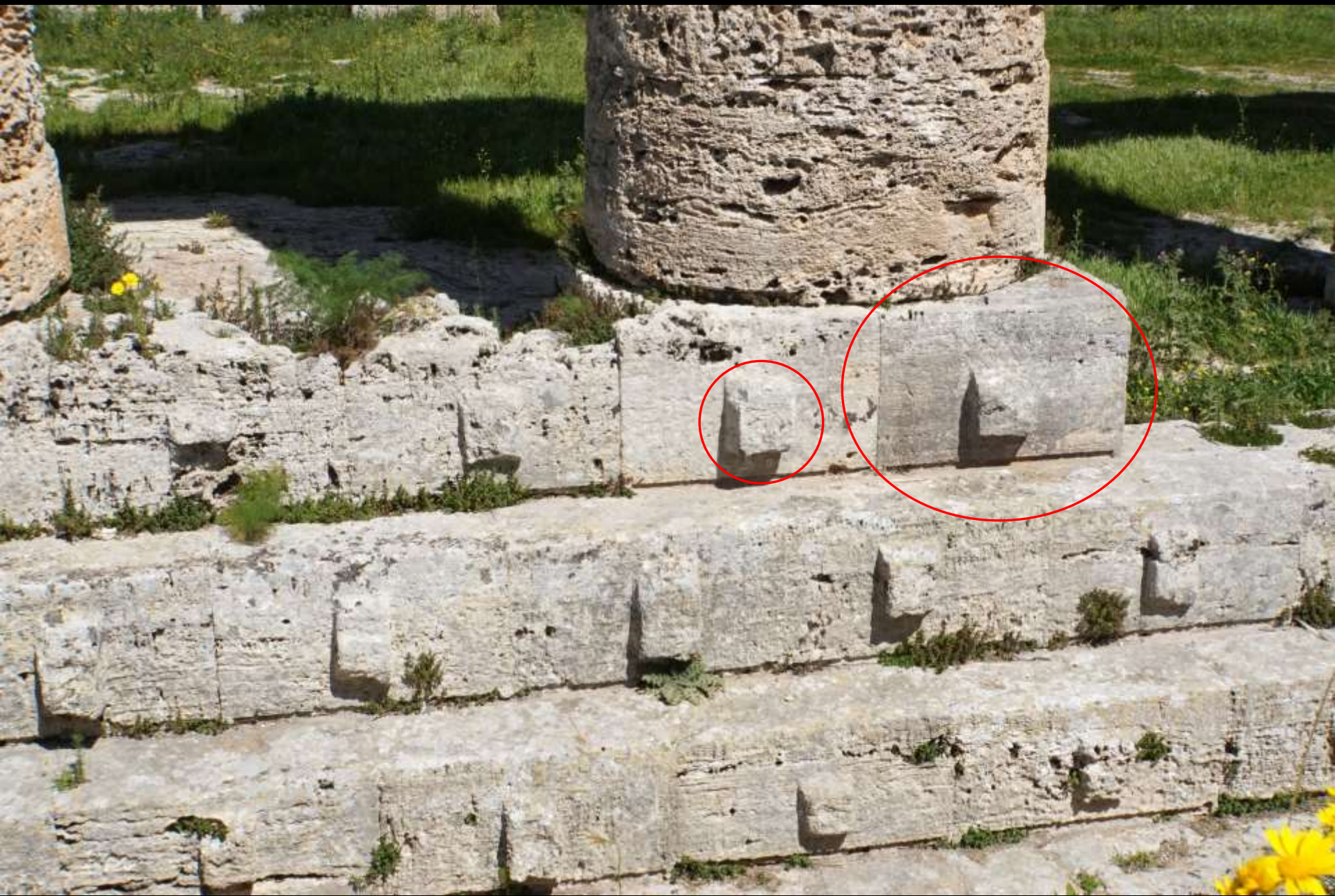
Segesta, Ende 5. Jh. v. Chr. Stufenbau (Krepis) mit Bossen (wohl zum Ansetzen hölzerner Hebel) und kleinteiligem Aufbau
