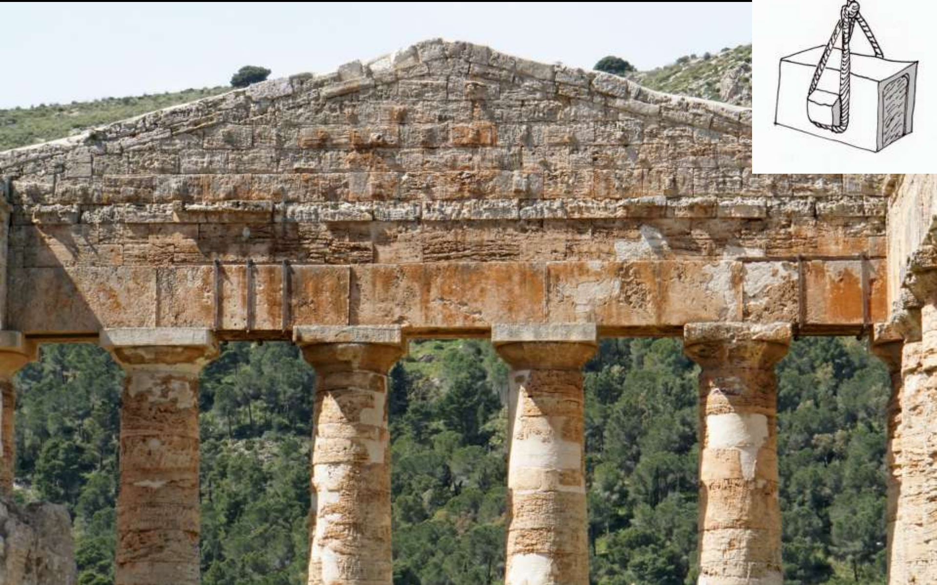
Bossen, wohl für Seile (Segesta, Giebelrückseite)
