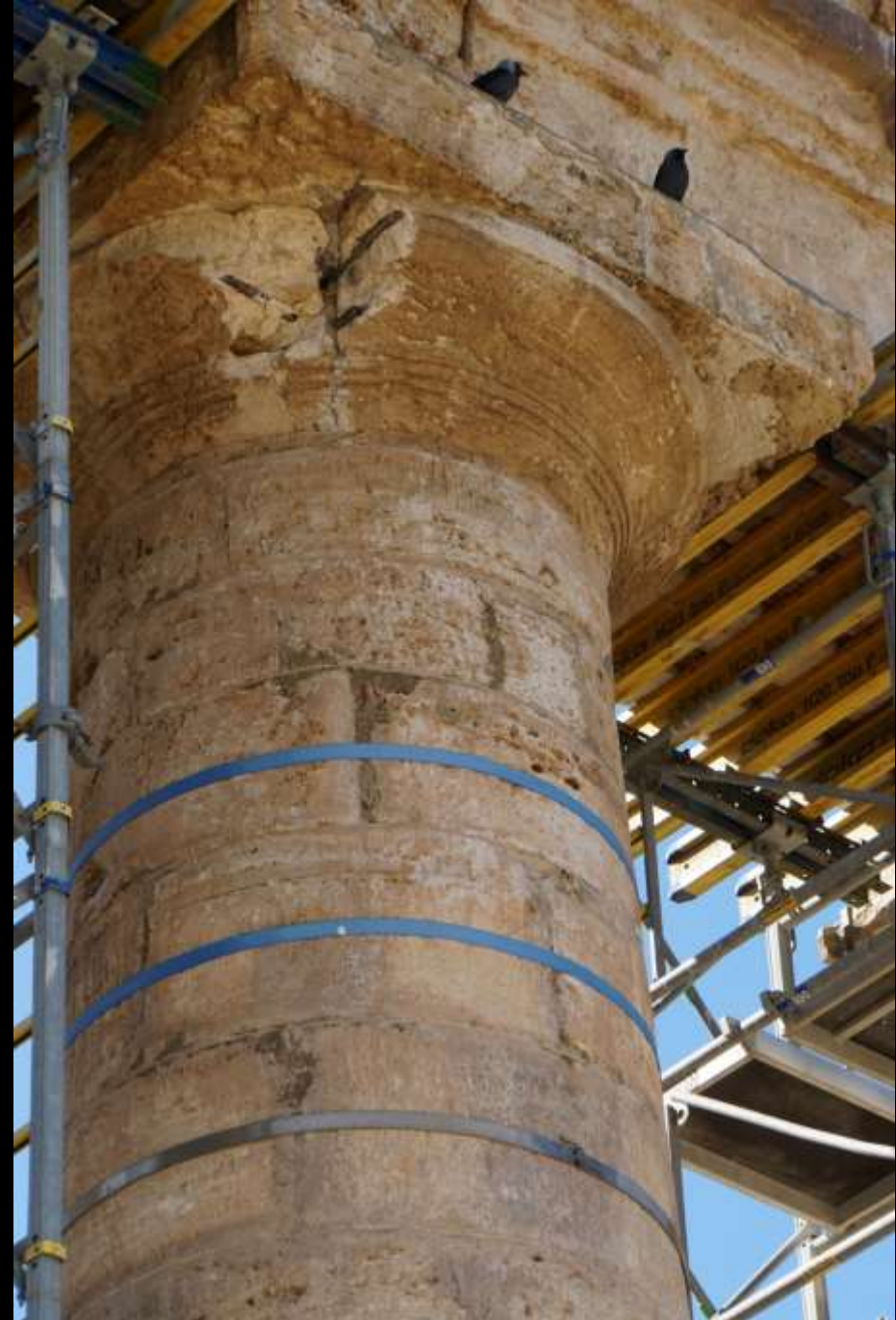
Frühe Vermessungs- und Erhaltungsbemühungen: reparierte Frontsäule, Segesta (1781 erneuert)
