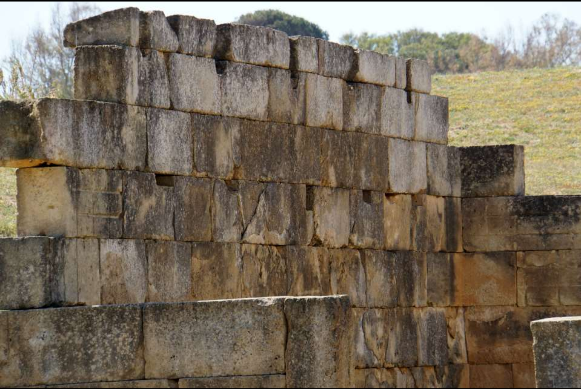
Dachspuren (Hera-Tempel, Contrada Gaggera, Selinunt, Anf. 6. Jh. v. Chr.)
