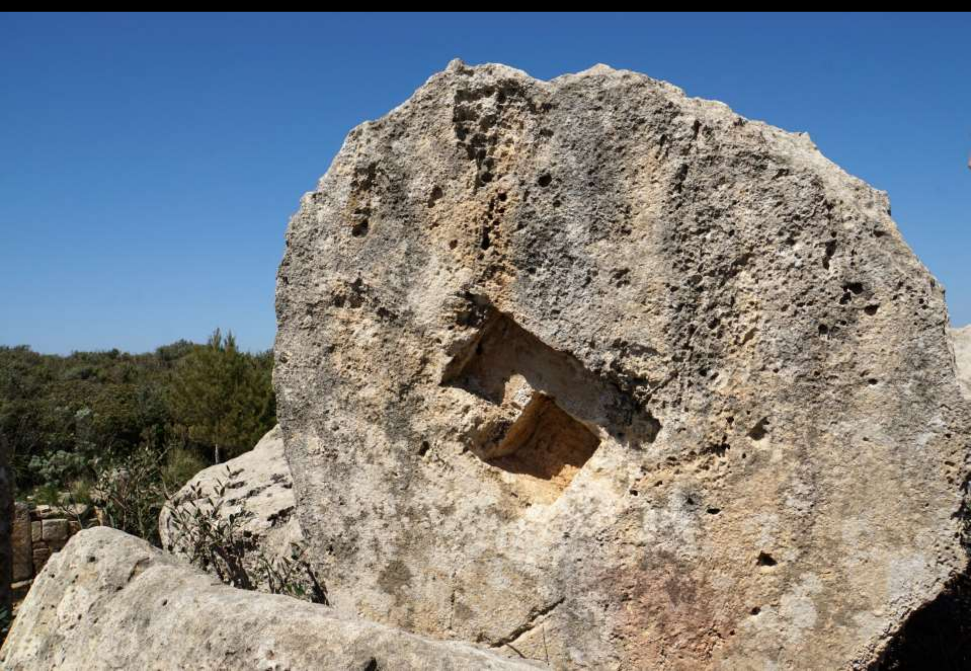
Sich gegenseitig überlagernde Einlassungen für Transporteinrichtungen und Empolia (Tempel D, Selinunt, Ende 6. Jh. v. Chr.)
