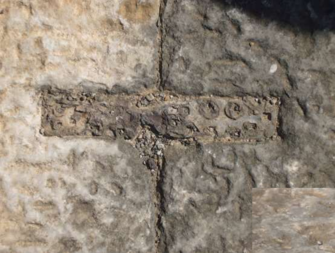
Priene/Kleinasien Athenatempel (2. H. 4. Jh. v. Chr.) Bleivergossene Klammer und bleivergossener Dübel (Fotos: Arnd Hennemeyer)
