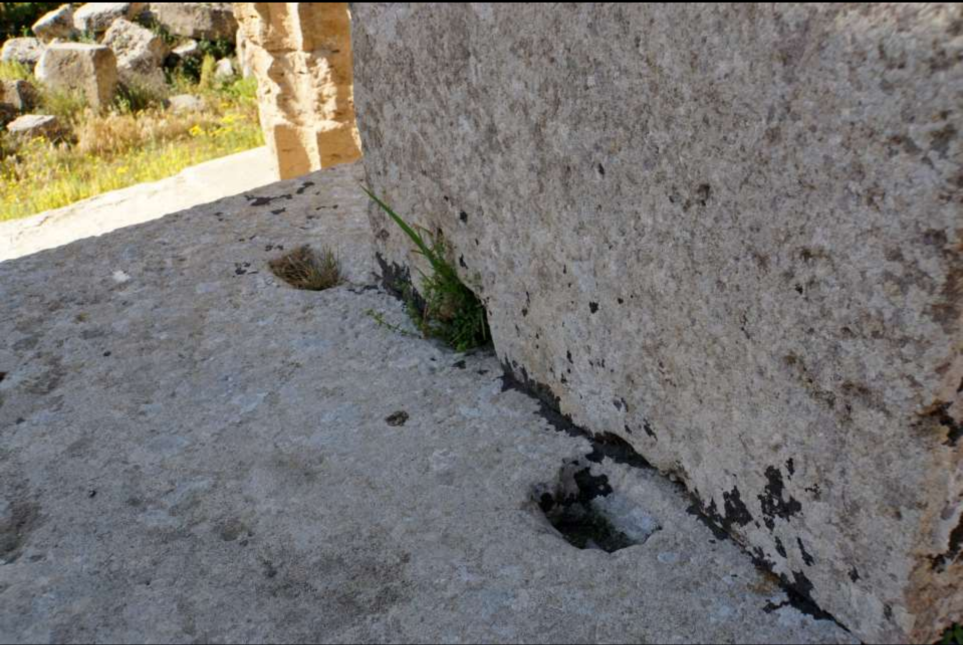
Das Fundament – Tempel E, Selinunt, 5. Jh. v. Chr.: Cellawand, Stemmlöcher und Wuchtekehle
