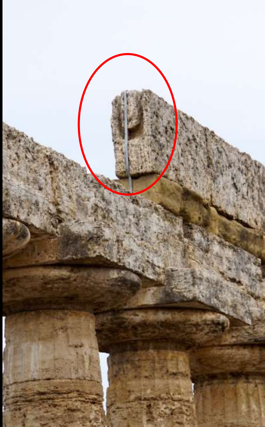
Seilrinne an einer Triglyphe (Paestum, sog. „Basilika“; 6. Jh. v. Chr.; Foto: Jasmin Schäfer)
