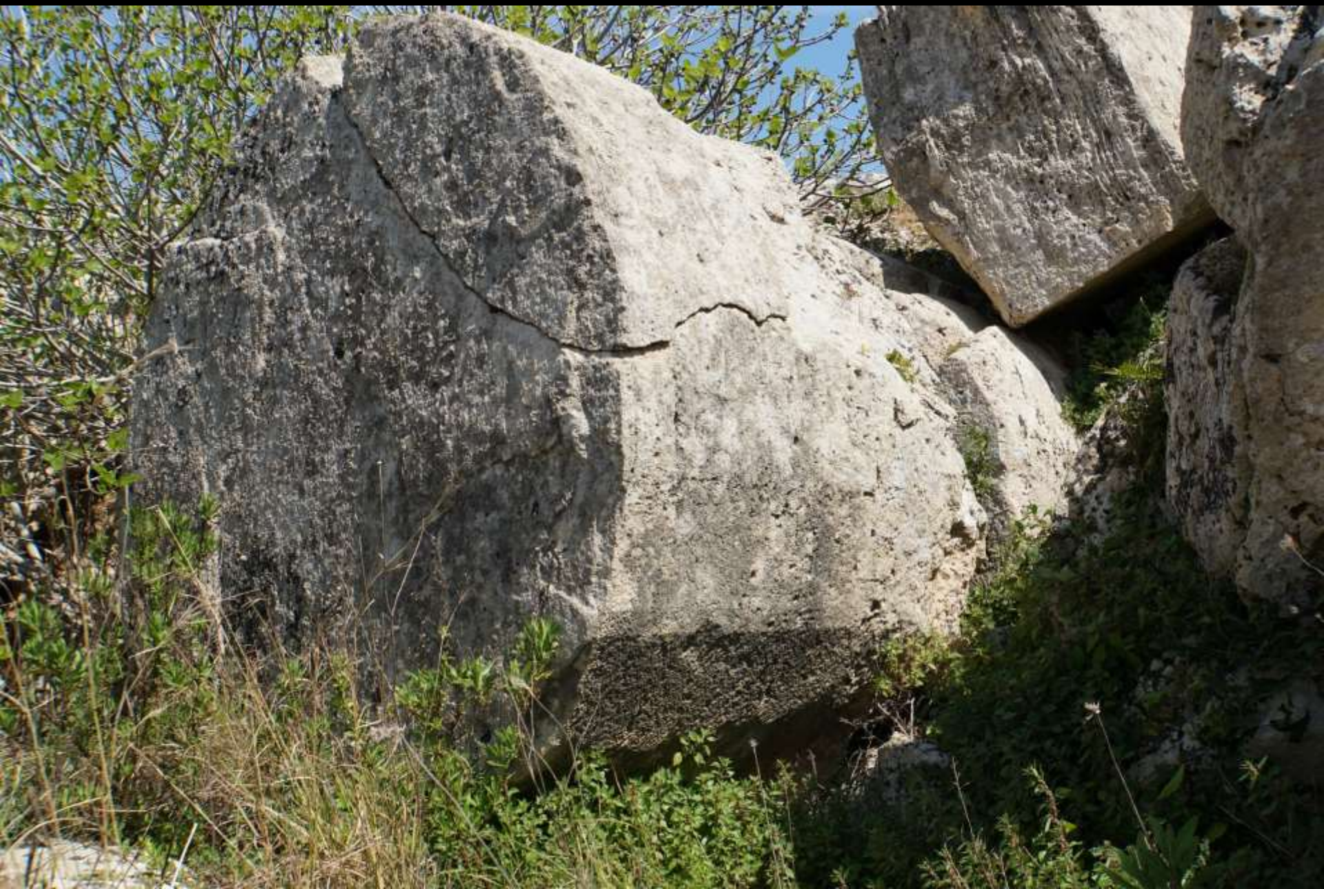
Zur Kannelierung vorbereitete (facettierte) Säulentrommel (Tempel G, Selinunt)
