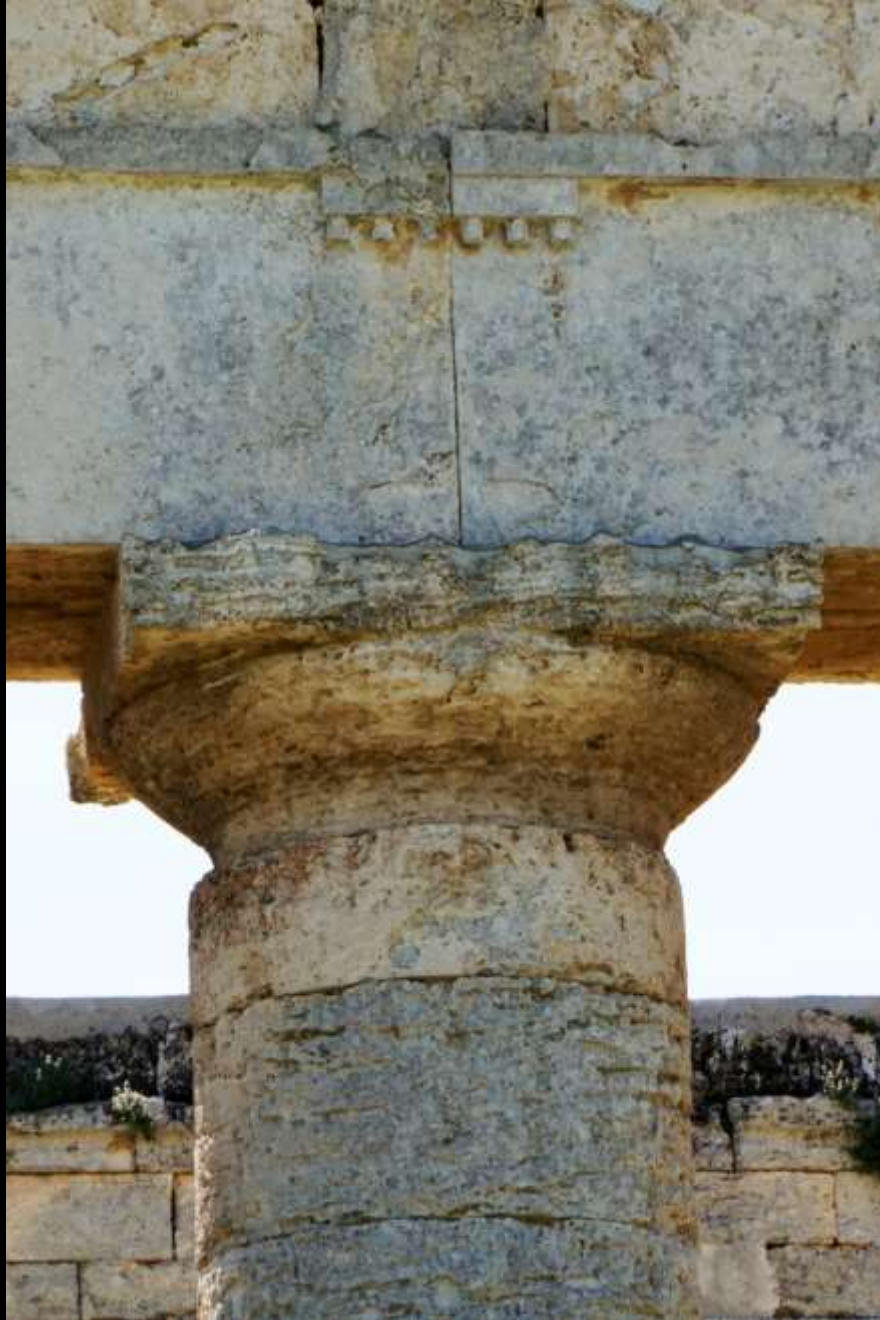
Säulentrommel im „Werkzoll“-Schutzmantel (Segesta)
