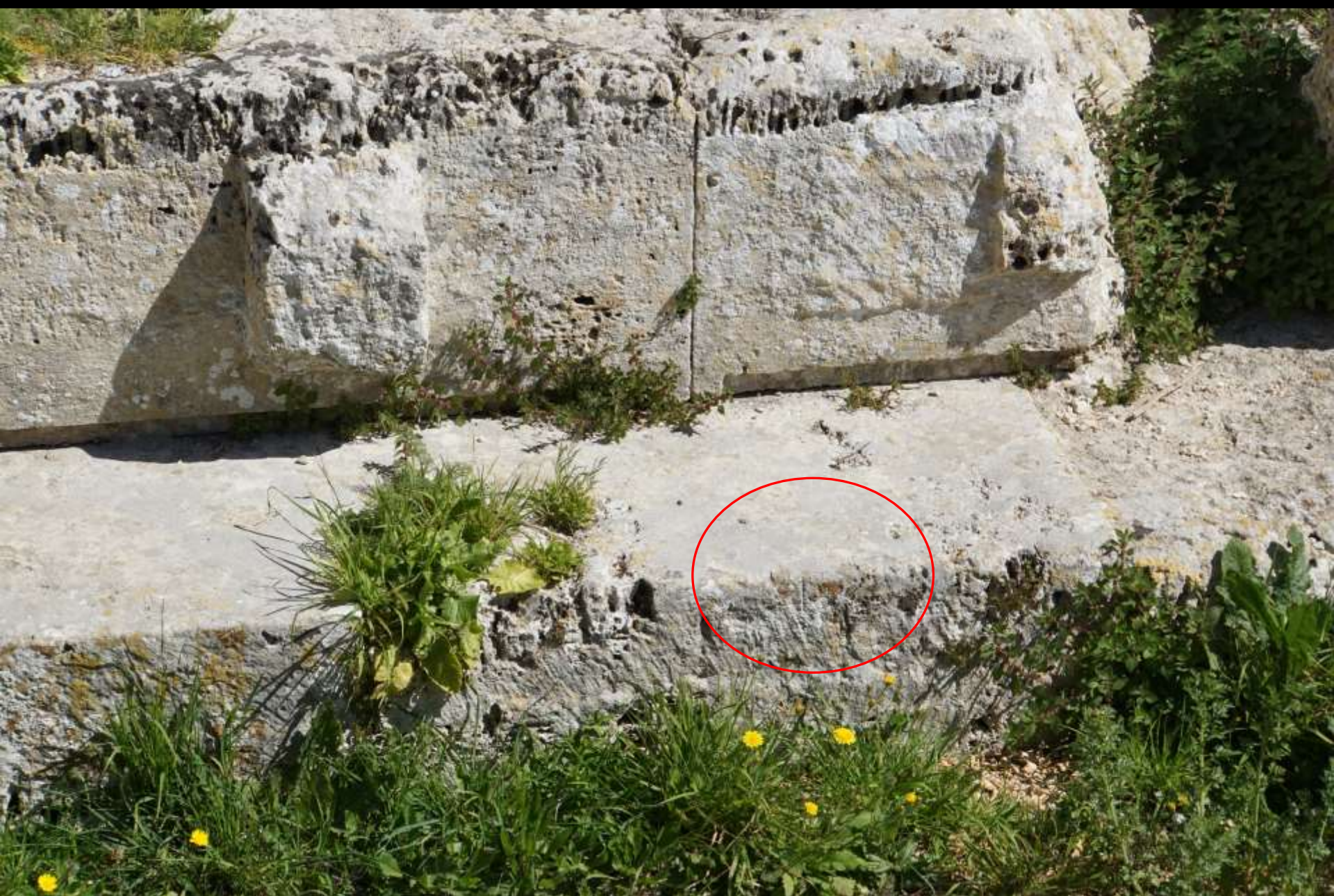
Segesta, Ende 5. Jh. v. Chr. Kurvatur des Stufenbaus – Markierung der Bezugslinie
