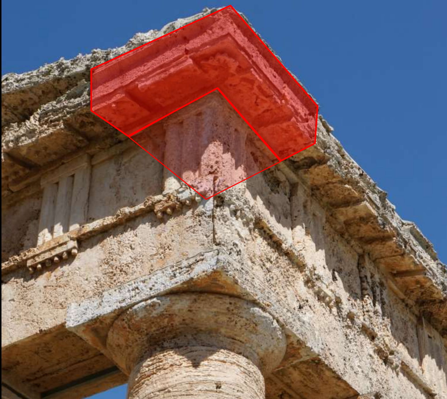
Grosser Eckblock des Geisons (Segesta). Der Block reicht weit nach hinten (Gegengewicht!)
