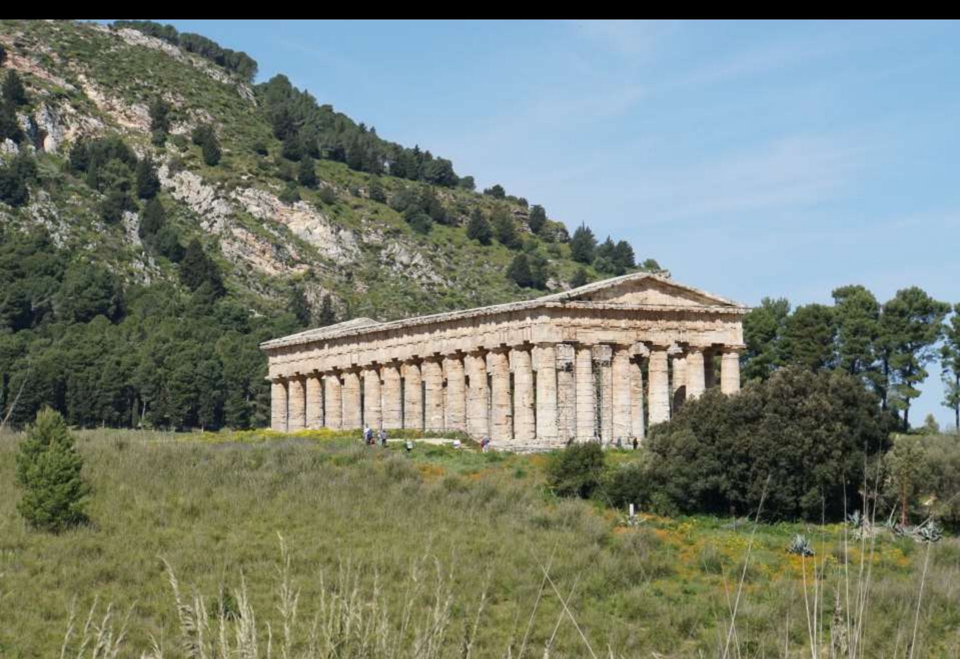
Segesta, Ende 5. Jh. v. Chr. Der als Baustelle erhaltene Tempel
