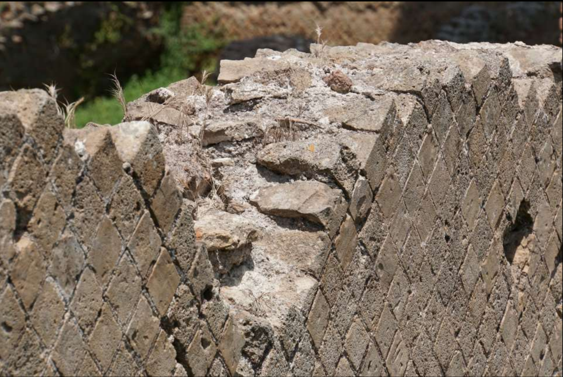
Wand aus Opus caementicium mit Aussenschale aus Opus reticulatum (Ostia, 2. Jh. n. Chr., Foto: W. Potgeter)
