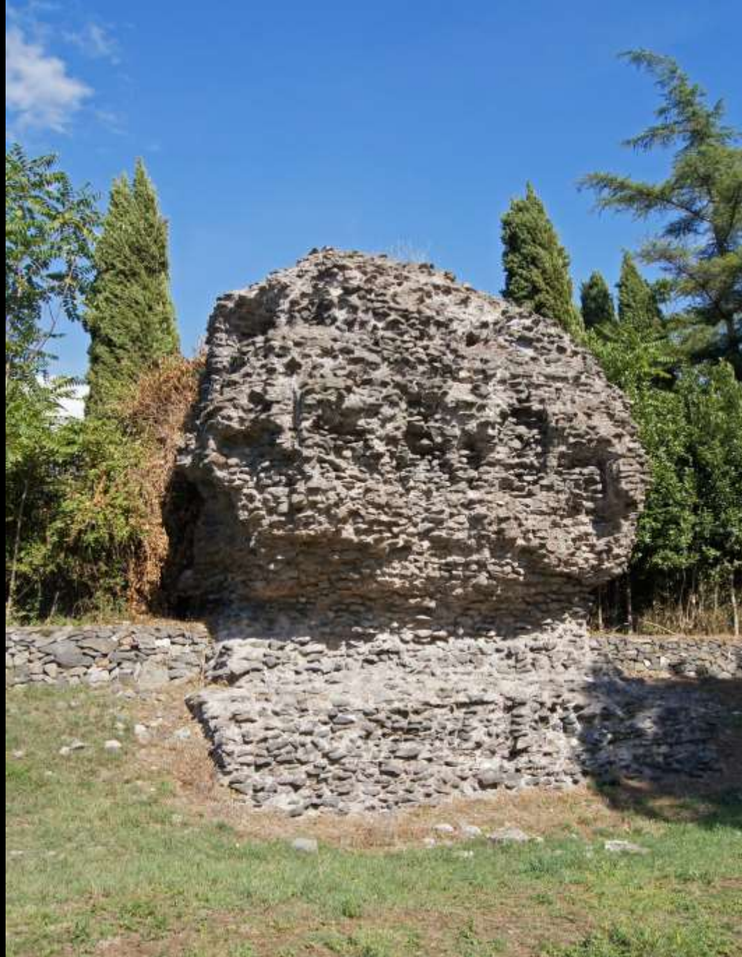
Allein erhaltener massiver Kern eines Grabmals an der Via Appia in Rom aus opus caementicium
