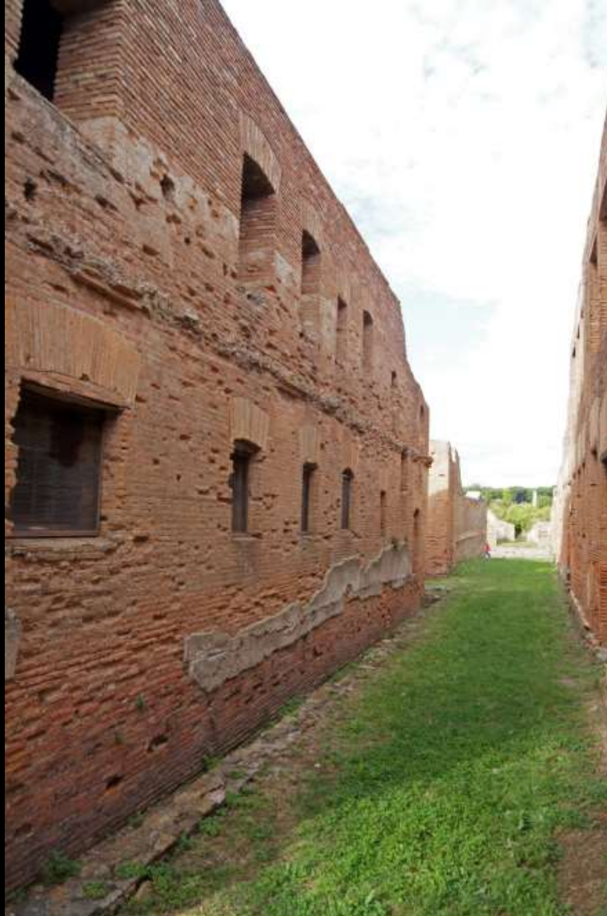
Wohnblöcke gehobenerer Kategorie in Ostia, in abgeschlossener Gartenanlage. Verputzreste! (Insula del Giardino, Ostia)
