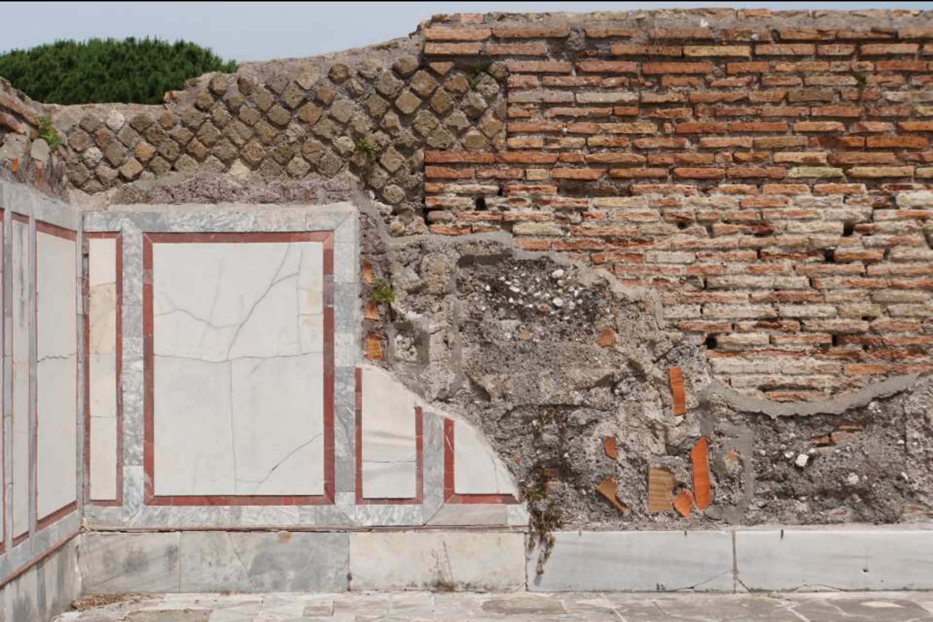
Buntmarmor-Intarsien ( opus sectile ) (gehobenes Wohnhaus in Ostia; Foto: W. Potgeter)
