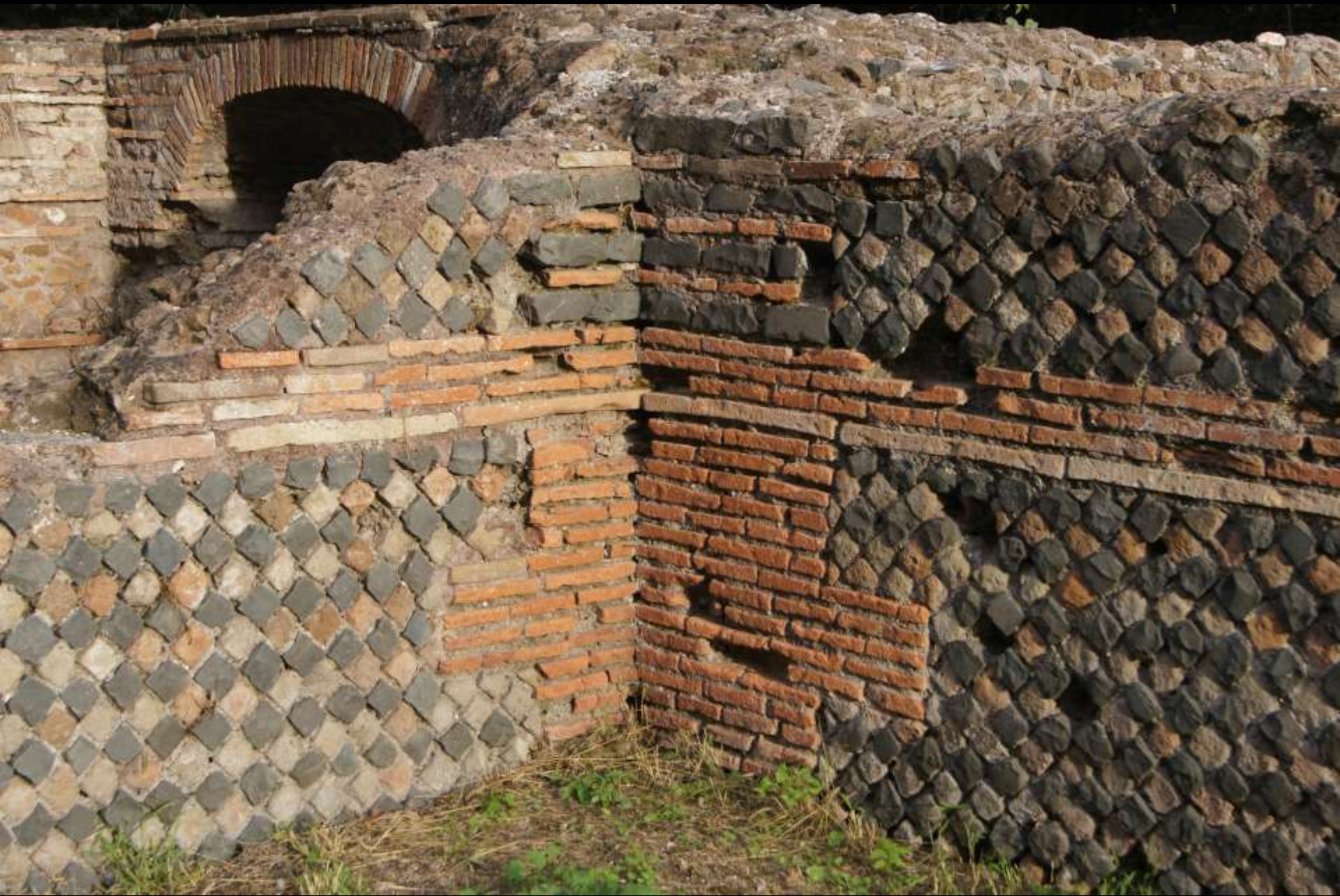
opus reticulatum mit Ziegeldurchschuss als Verkleidung von opus caementicium (Ostia)
