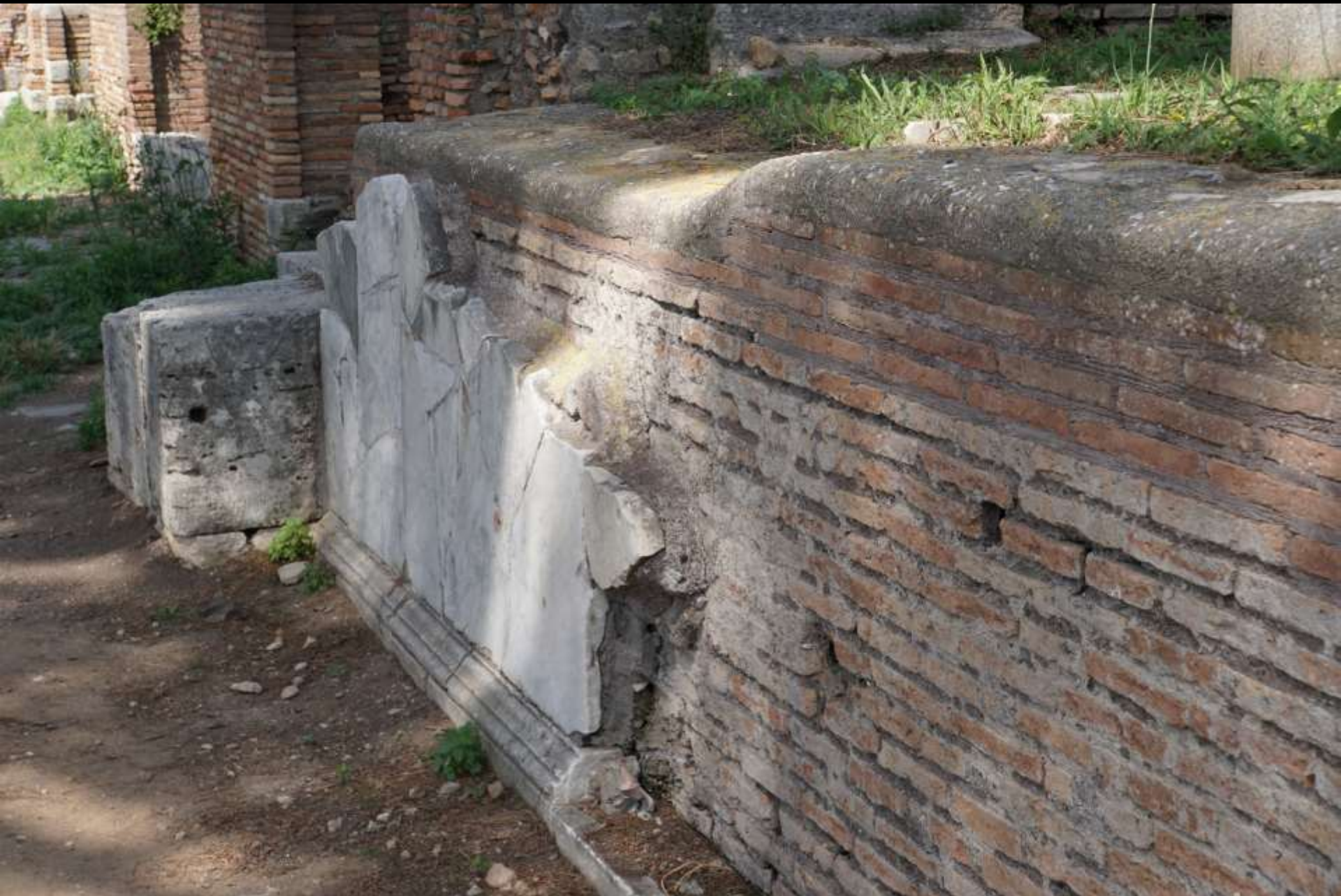
Verkleidung einer opus testaceum-Wand mit Marmorplatten (Forum, Ostia; Foto: W. Potgeter)
