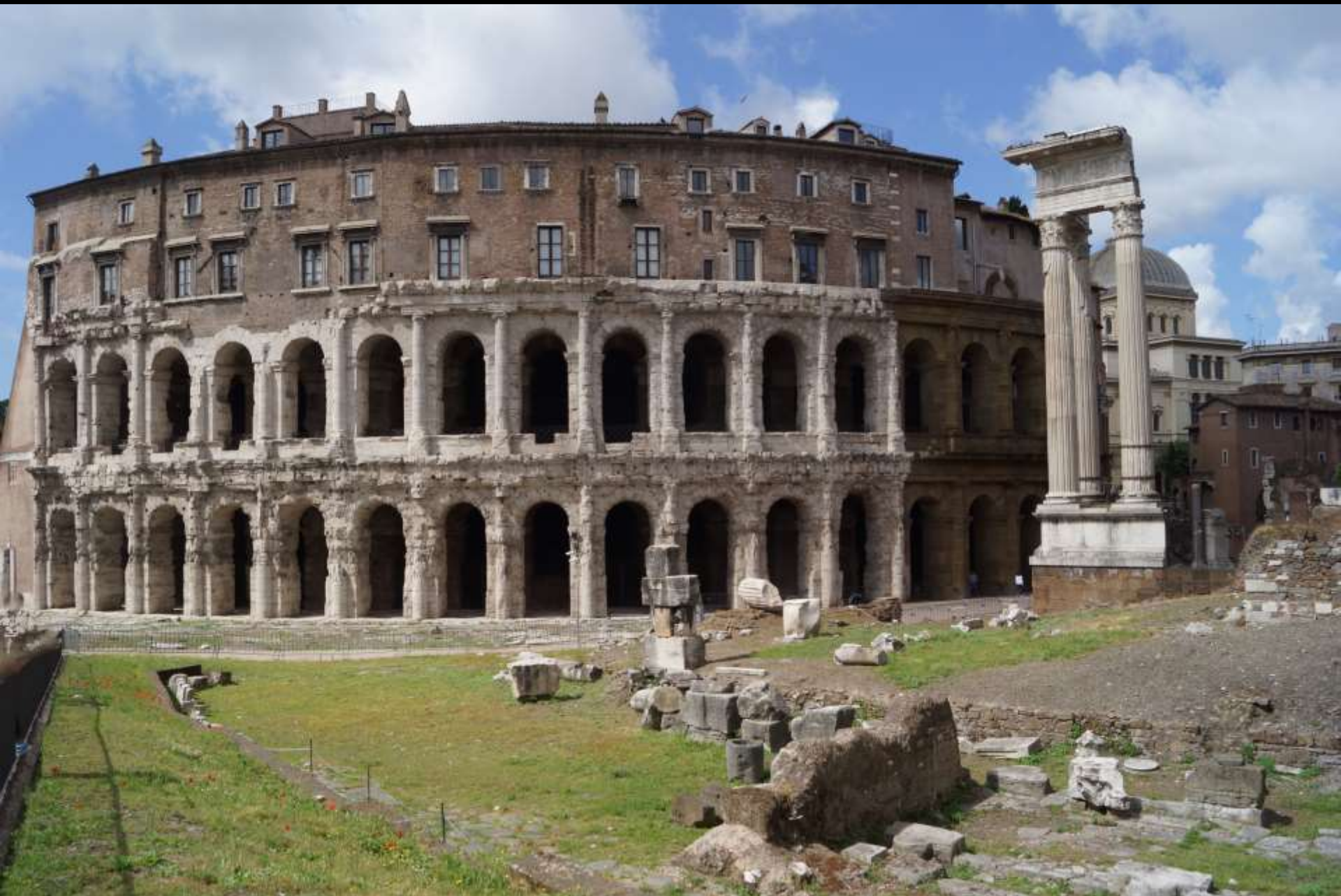
Theater: Rom, Marcellustheater (1. Jh. n. Chr.): gewölbte Substruktionen unter den Zuschauerrängen
