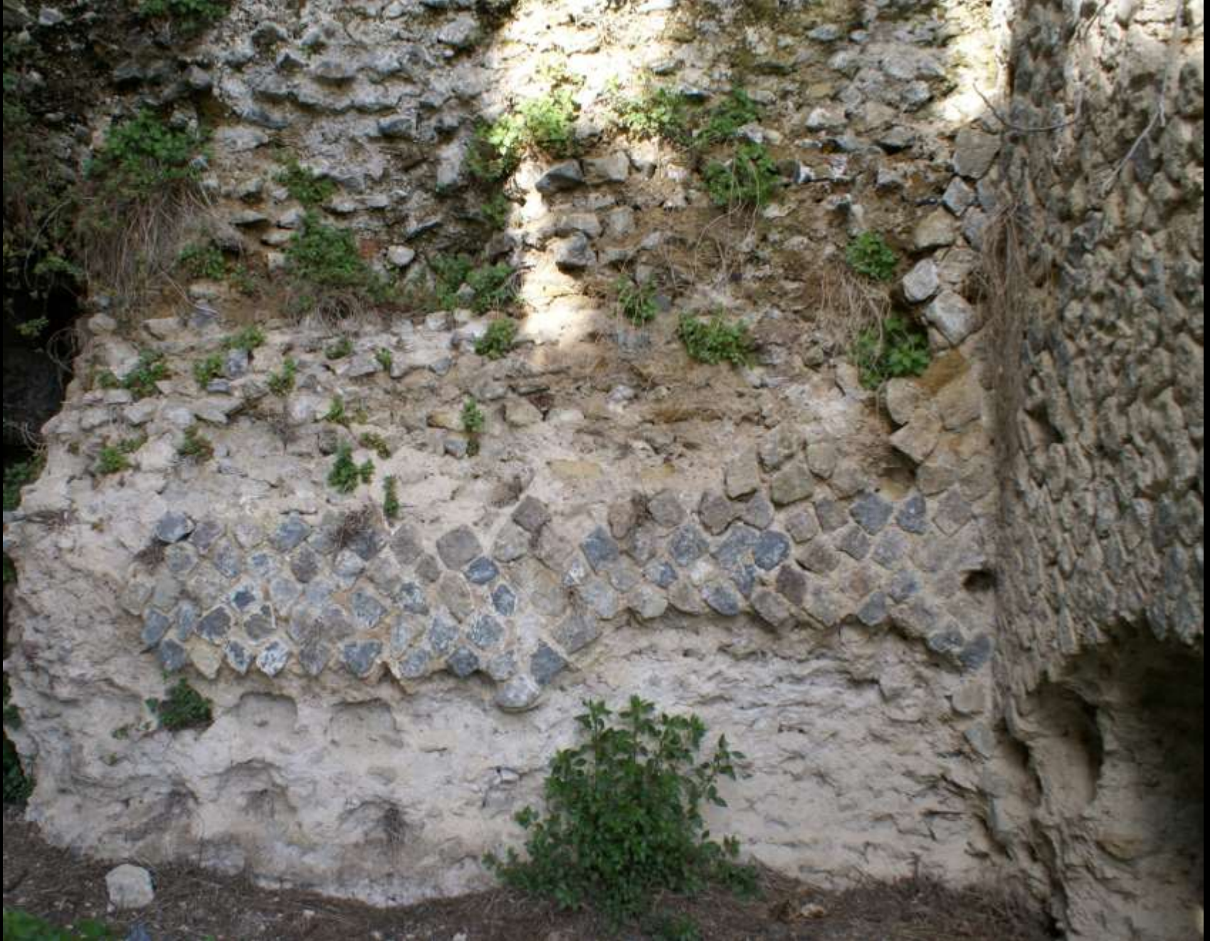
Opus incertum als Verkleidung von opus caementicium (Volsinii, Latium, 1. Jh. v. Chr.)
