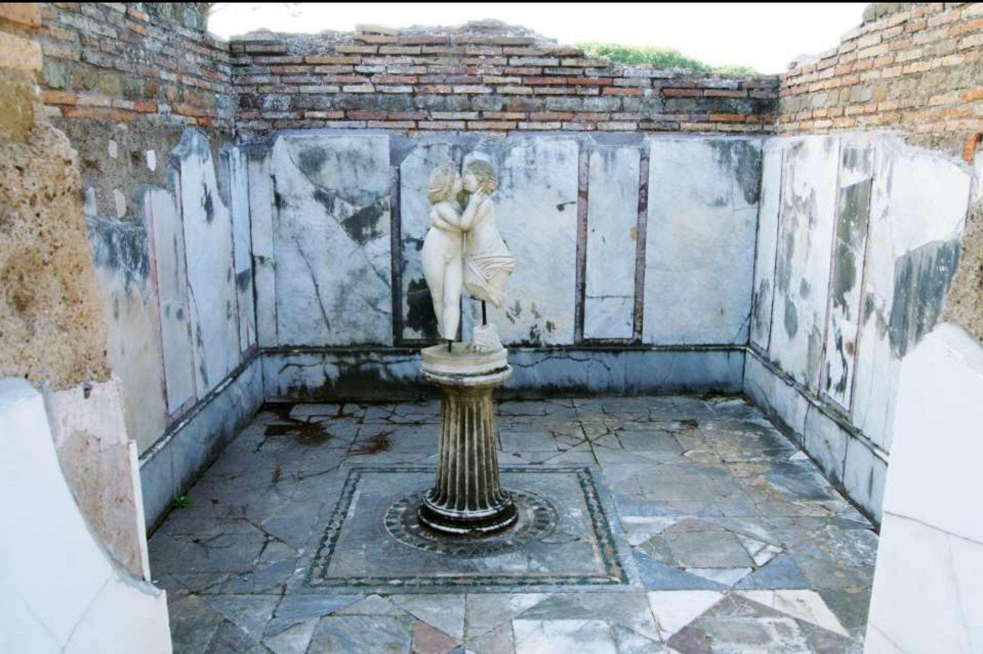
Wand- und Bodeninkrustation ( opus sectile ) (Casa di Psiche, Ostia)
