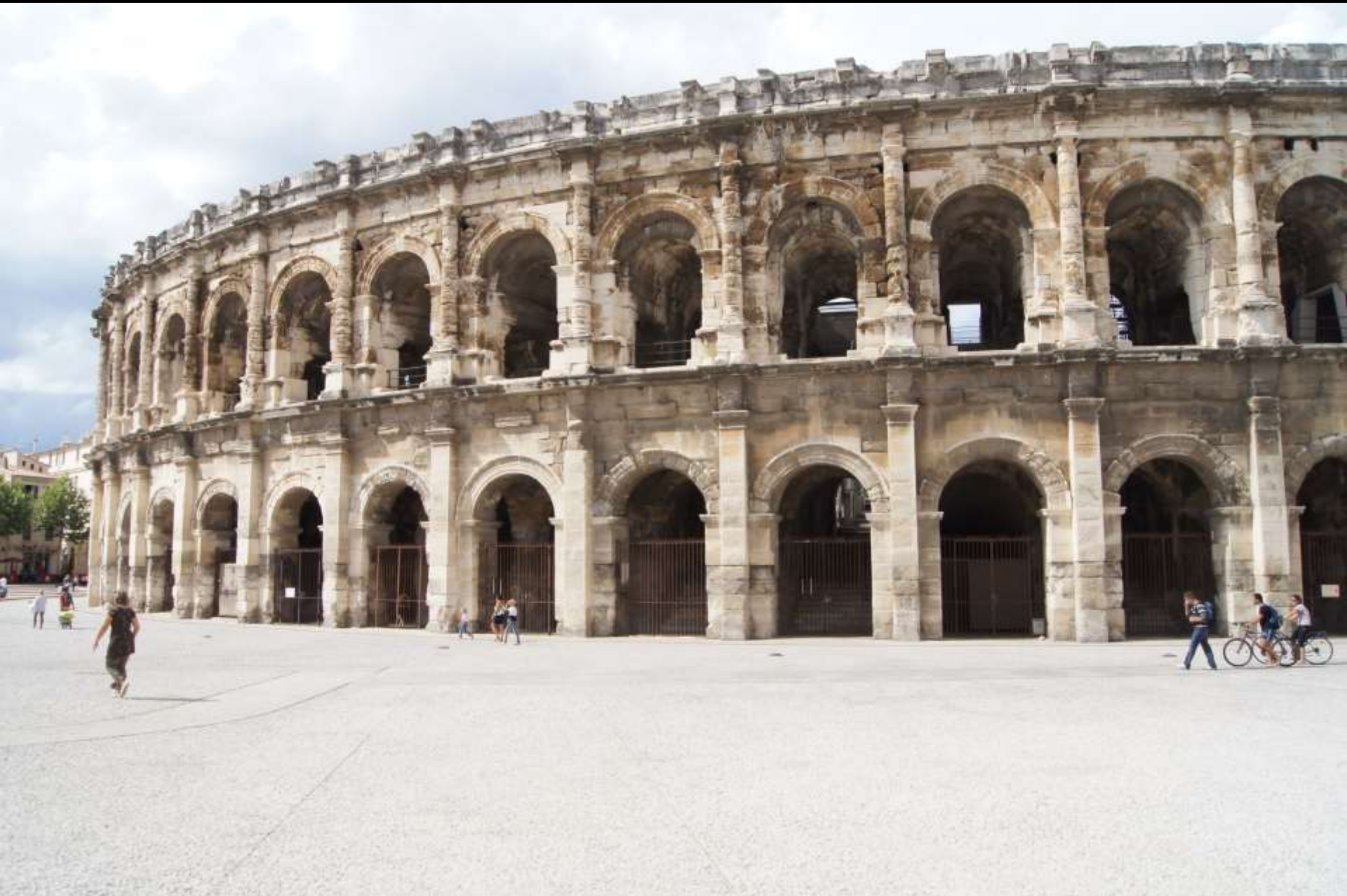
Amphitheater: Nîmes (1. Jh. n. Chr.). Gewölbte Substruktionen unter der cavea
