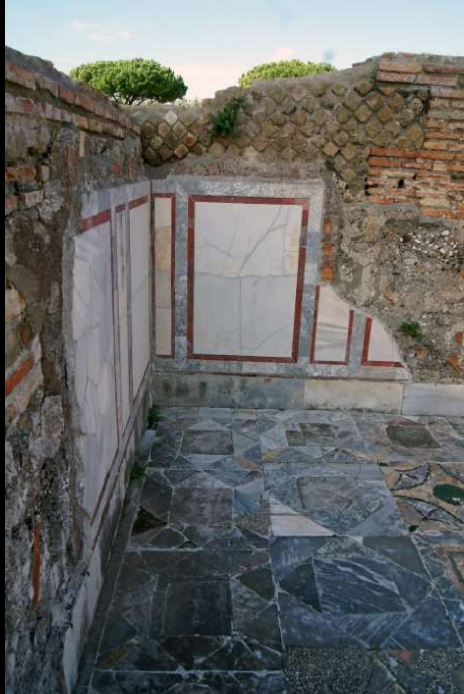
Wand- und Bodeninkrustation mit dünner Schicht aus Buntmarmor-Intarsien ( opus sectile ) (Casa di Psiche, Ostia)
