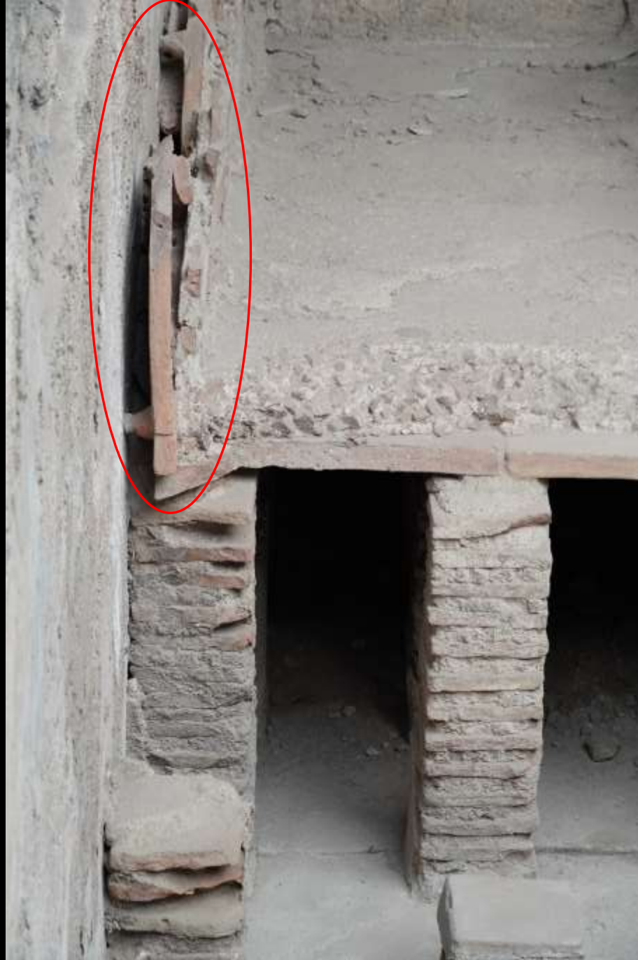
Wandverkleidung mit dünnen Tonplatten (tegulae mammatae) zur Wandheizung (Pompeii, Stabianer Thermen)
