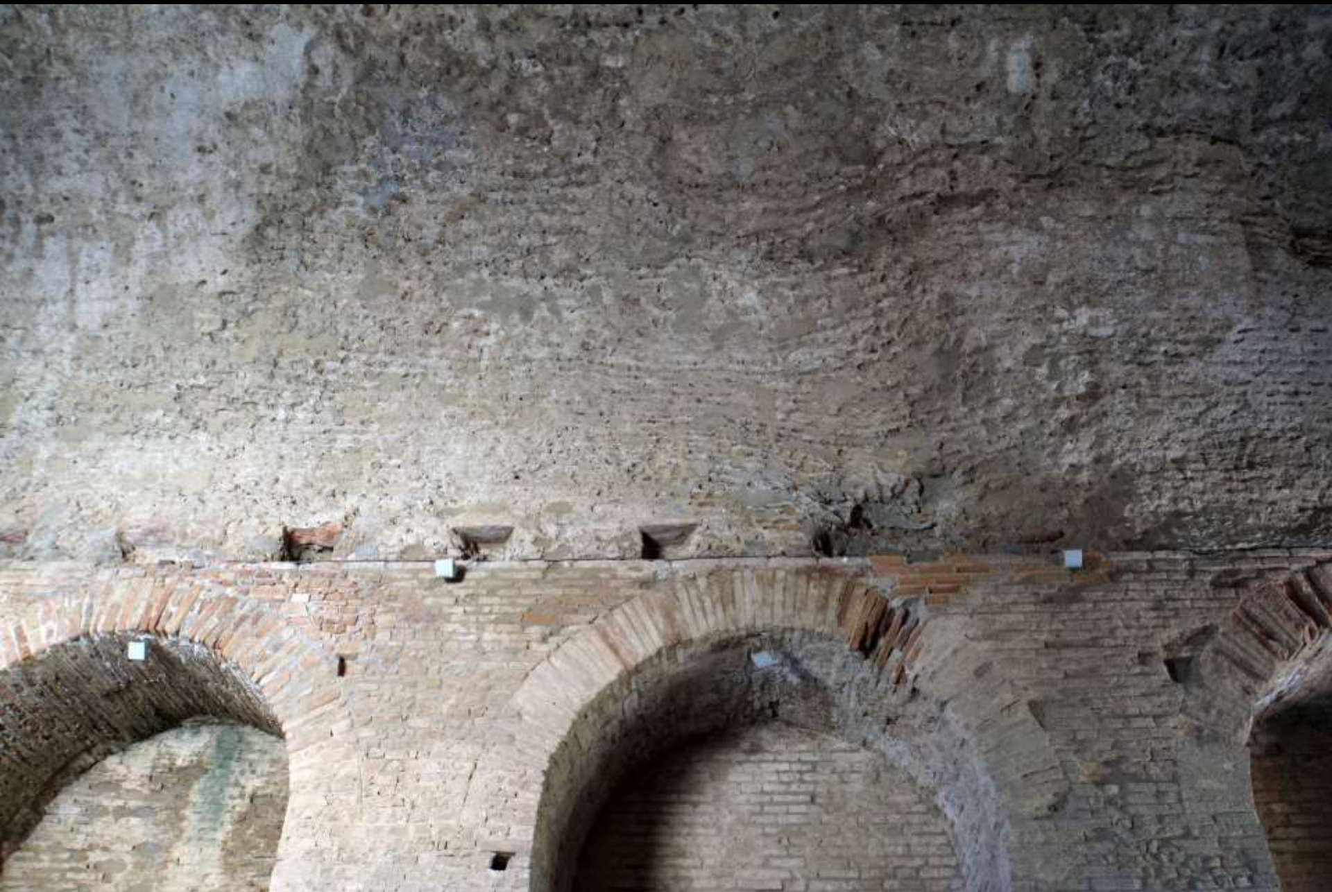
Unregelmässiger Verlauf der horizontalen Schichten (Taormina, röm. Theater)
