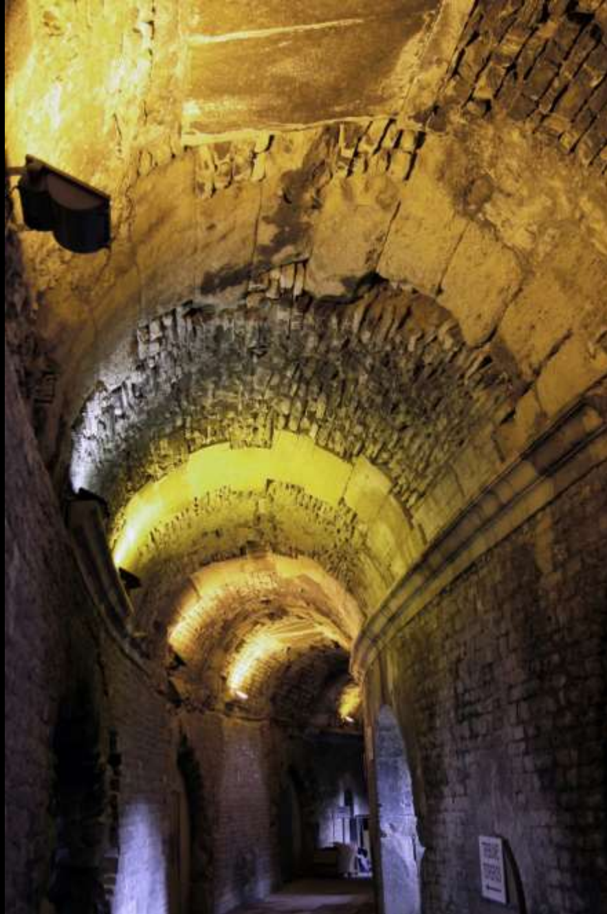
Gewölbe aus Bruchstein mit Werksteingurten (Nîmes, Amphitheater, 1. Jh. n. Chr.)
