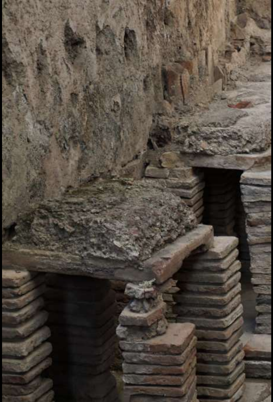
suspensurae der Hypokaustenheizung (Pompeii, Stabianer Thermen; Foto: J. Schäfer)
