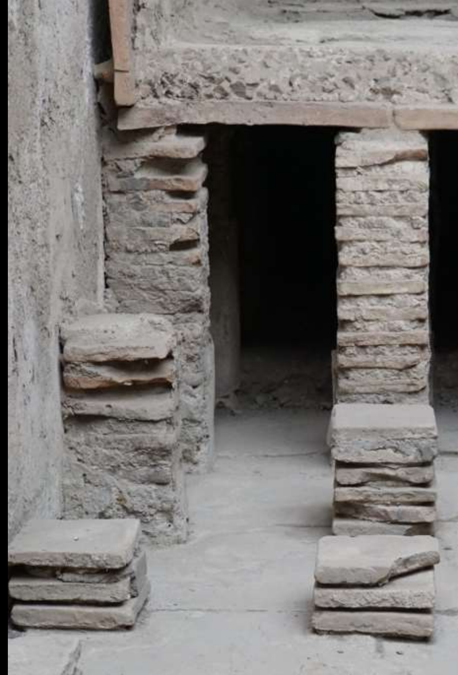
suspensurae der Hypokaustenheizung (Pompeii, Stabianer Thermen; Foto: J. Schäfer)
