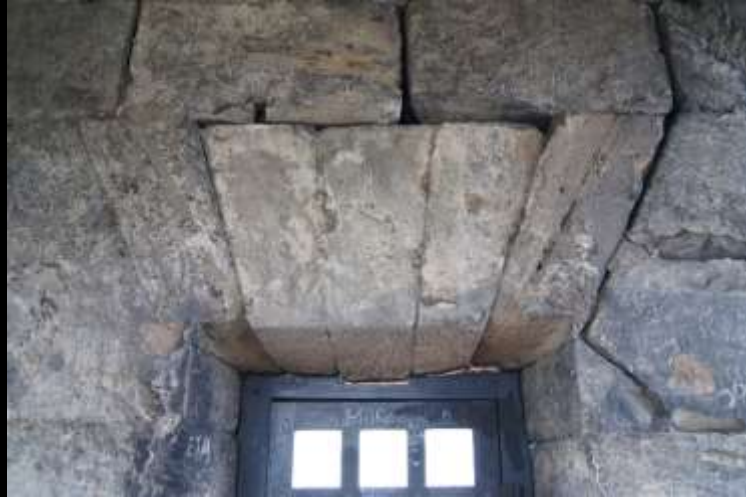
Keilsteine Spezialfall „scheitrechter Bogen“ („Platebande“)
