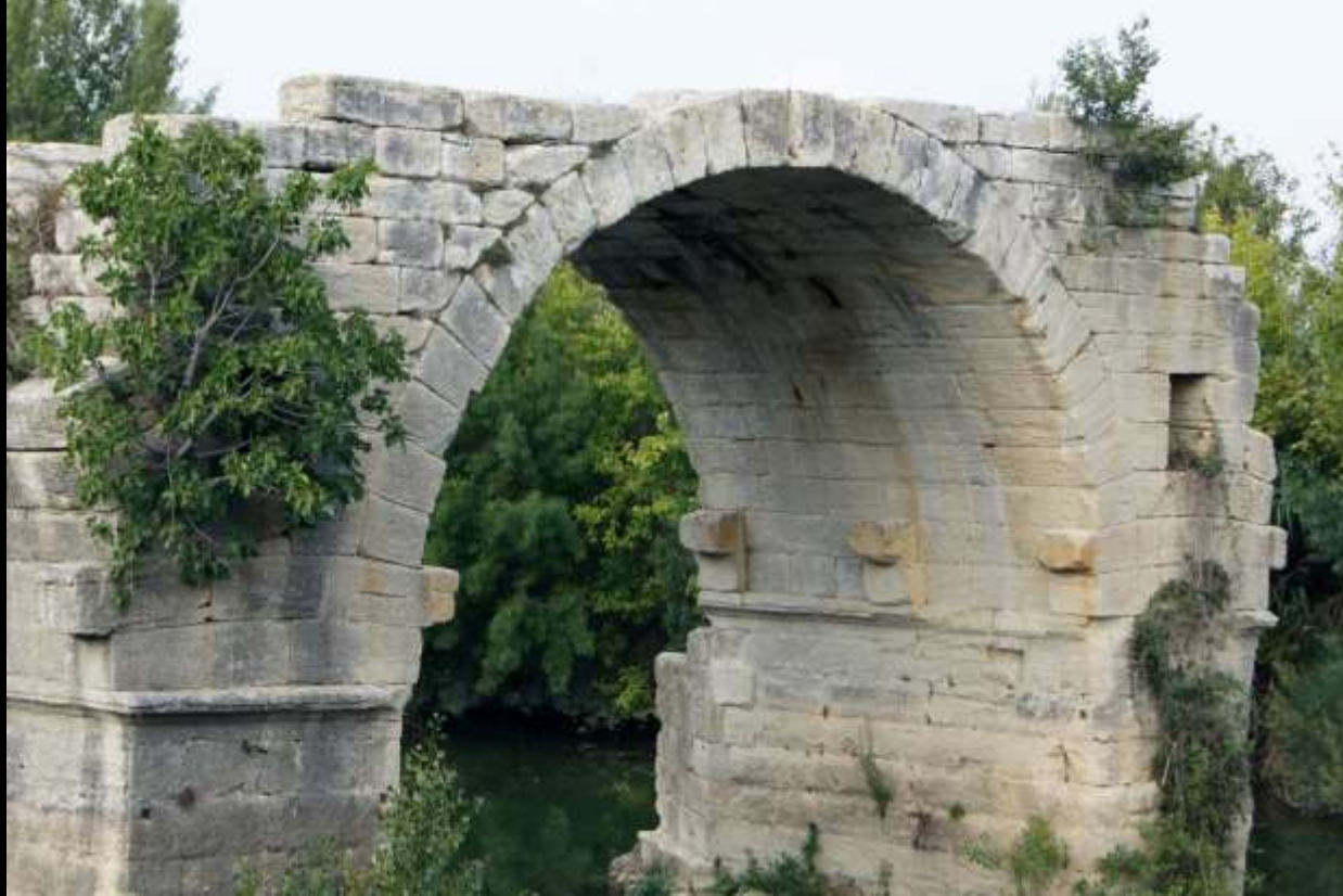
Wölben mit Werkstein Spuren der Herstellung
