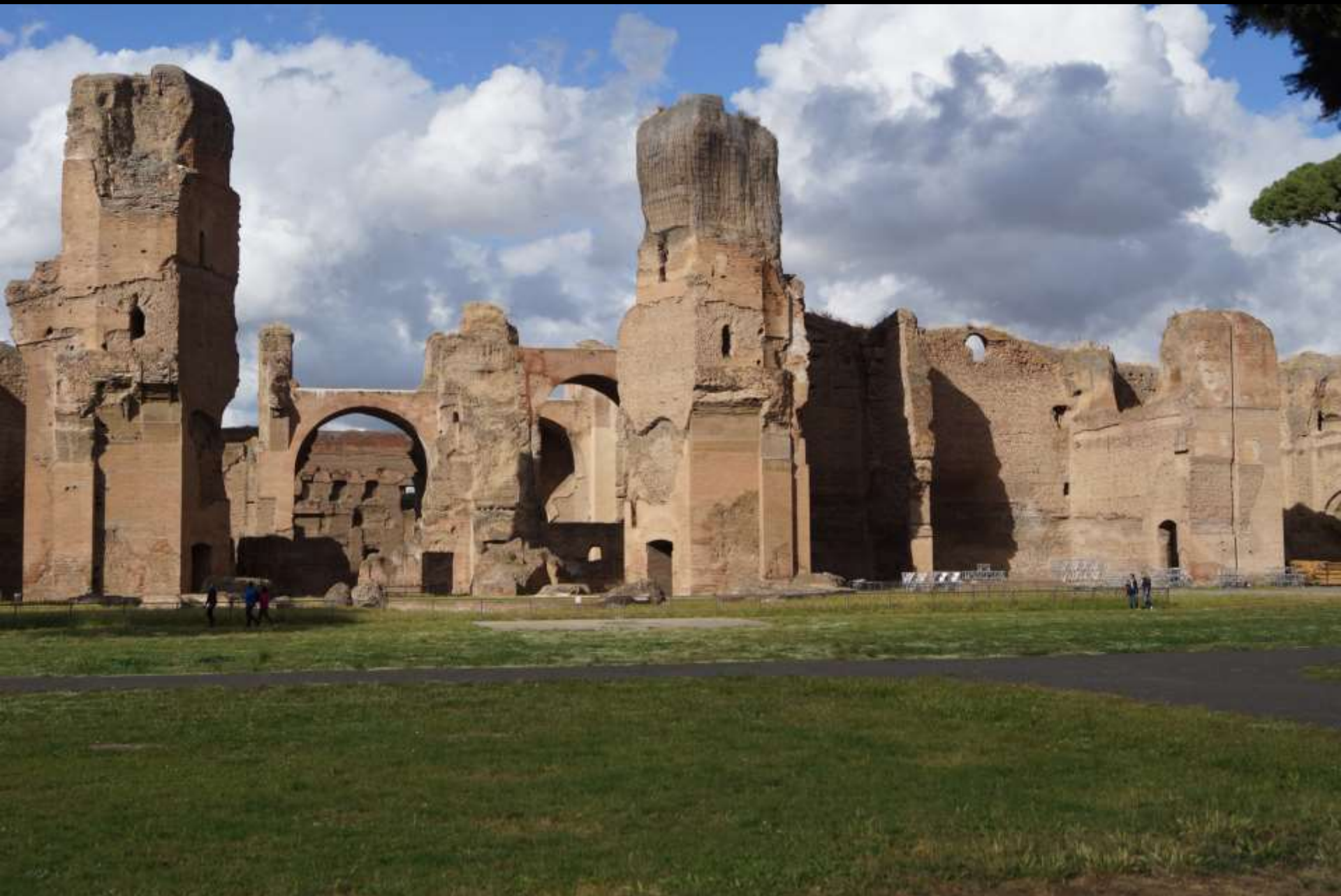
Caracallathermen in Rom, um 200 n. Chr.; Südfront (in der Mitte Ruine des Caldariums)
