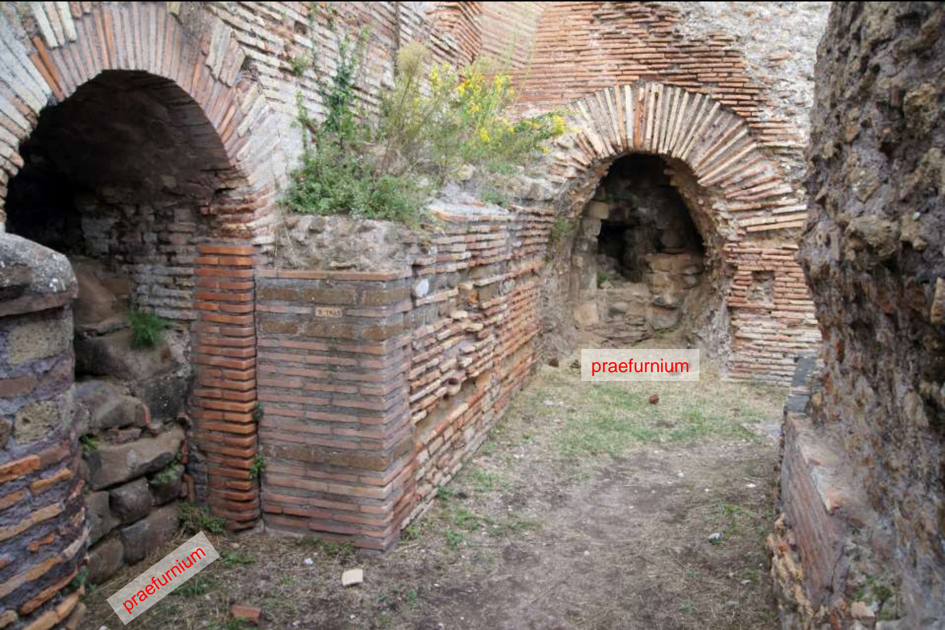
Forumsthermen in Ostia Antica. Heizgänge im Keller und praefurnia (Einschuböffnungen für Brennmaterial)
