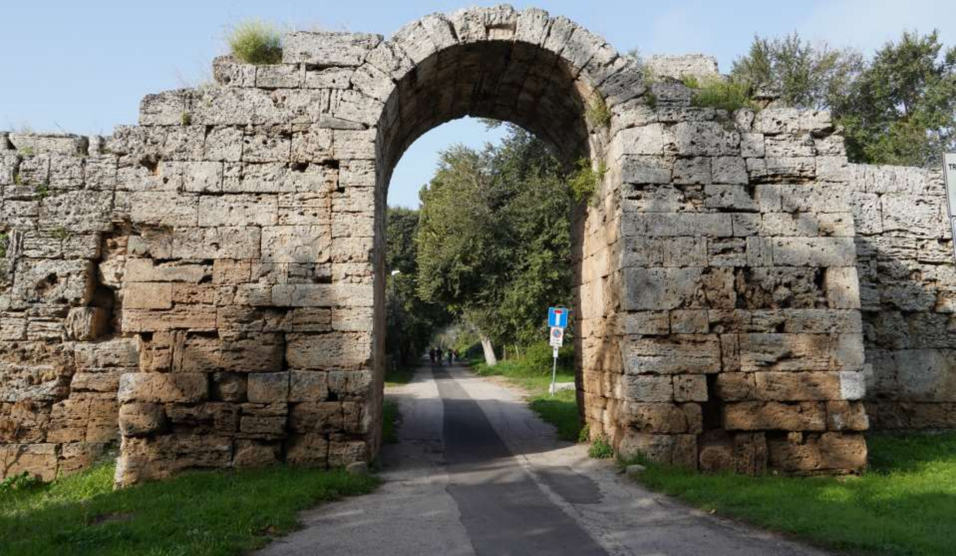
vorrömischer Keilsteinbogen (Paestum, Stadttor, 1. Viertel 3. Jh. v. Chr., Feldseite; Stadt seit 273 v. Chr. römisch, Mauern ab dann unnötig)
