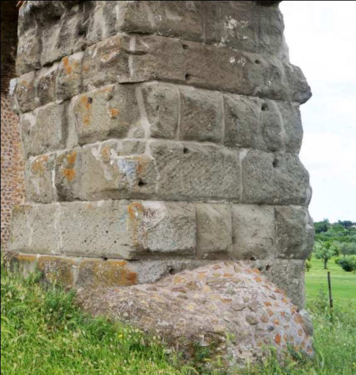
Aquädukt Rom, Aqua Claudia (1. Jh. n. Chr.), Zangenlöcher in den Quadern
