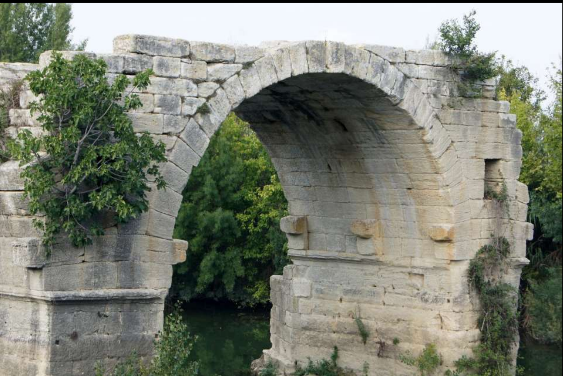
Kragsteine als Auflager für Lehrgerüst (Pont Ambroix, 1. Jh. n. Chr.)
