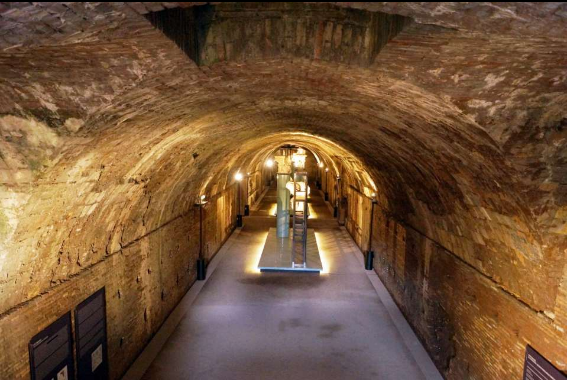
Caracallathermen in Rom, um 200 n. Chr.; Heizanlage vor der Caldariumsfront
