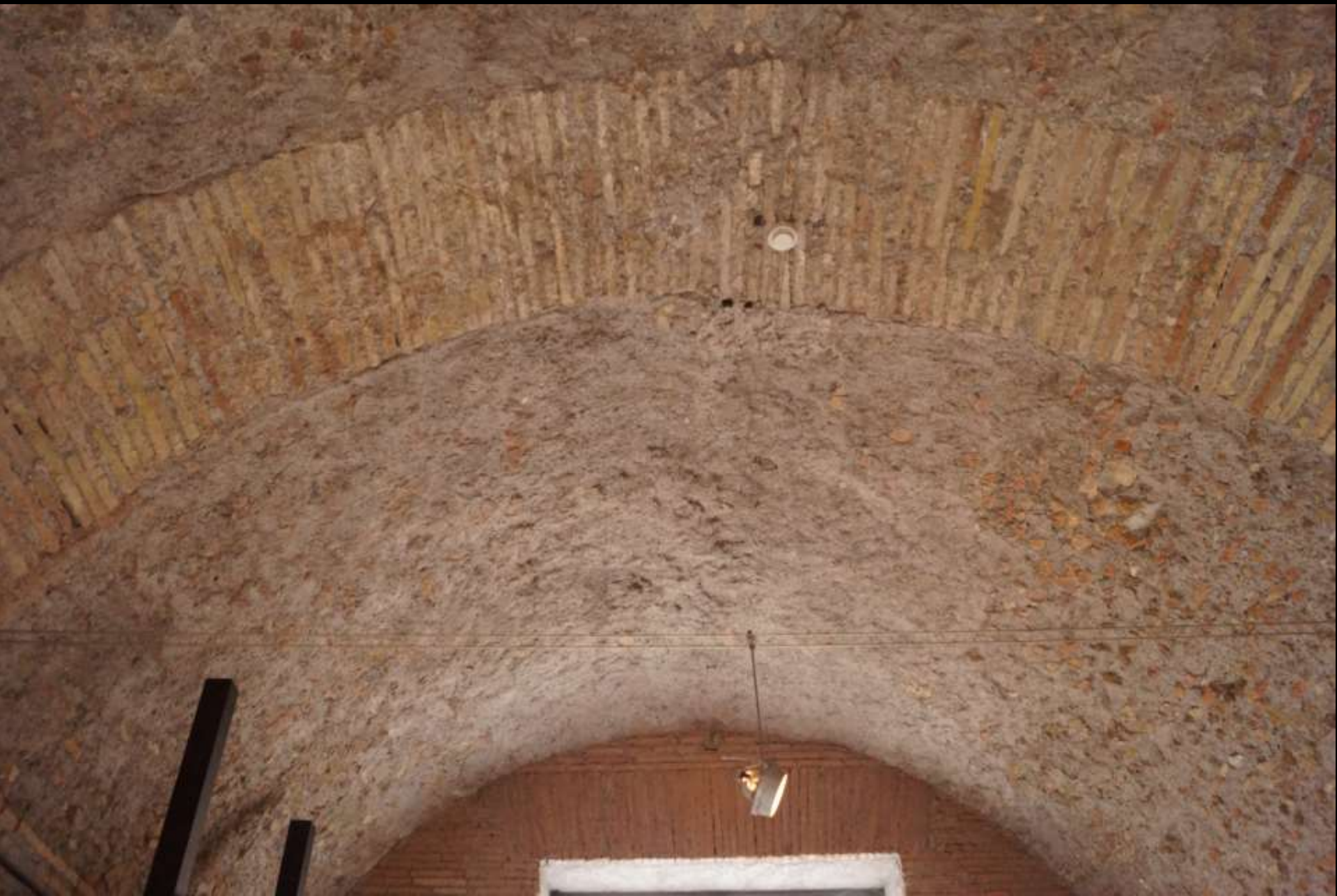
Opus caementicium mit Verstärkungsrippe aus Bipedales (Rom, Trajansmarkt, Anf. 2. Jh. n. Chr.)
