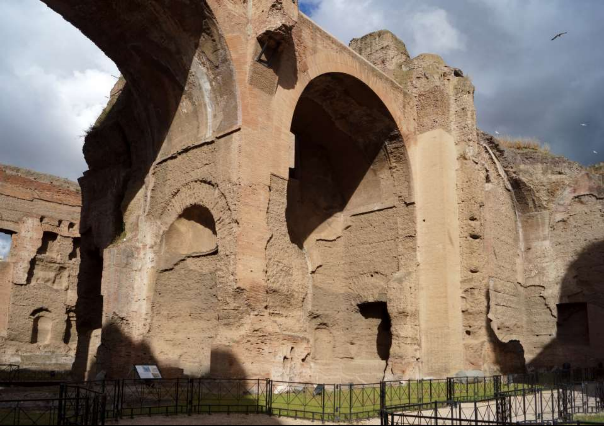
Rom, Caracallathermen, Ruine des Frigidariums. Tonnengewölbte Abseiten.
