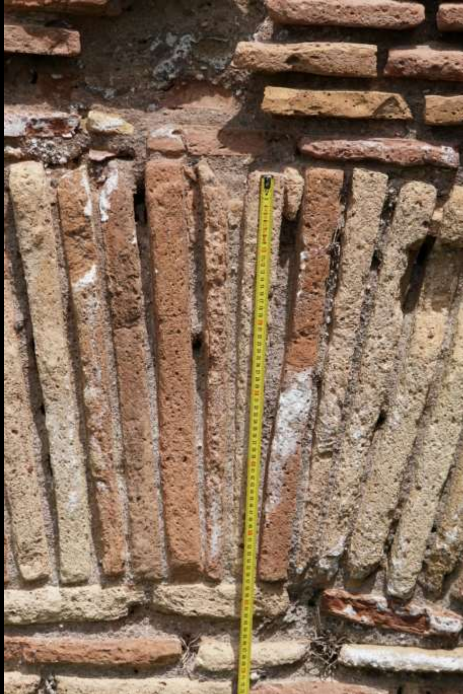
Ostia, gewölbte Fenster- und Türstürze aus bipedalis-Backsteinplatten mit keilförmiger Mörtelfuge (2. Jh. n. Chr.)
