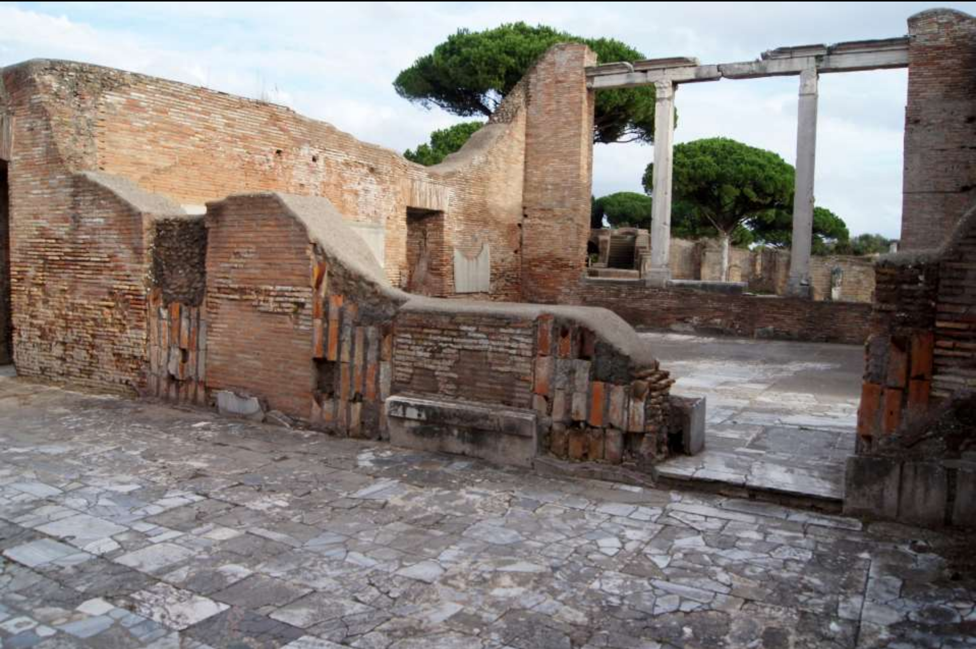
Forumsthermen in Ostia Antica. Wandheizung mit tubuli
