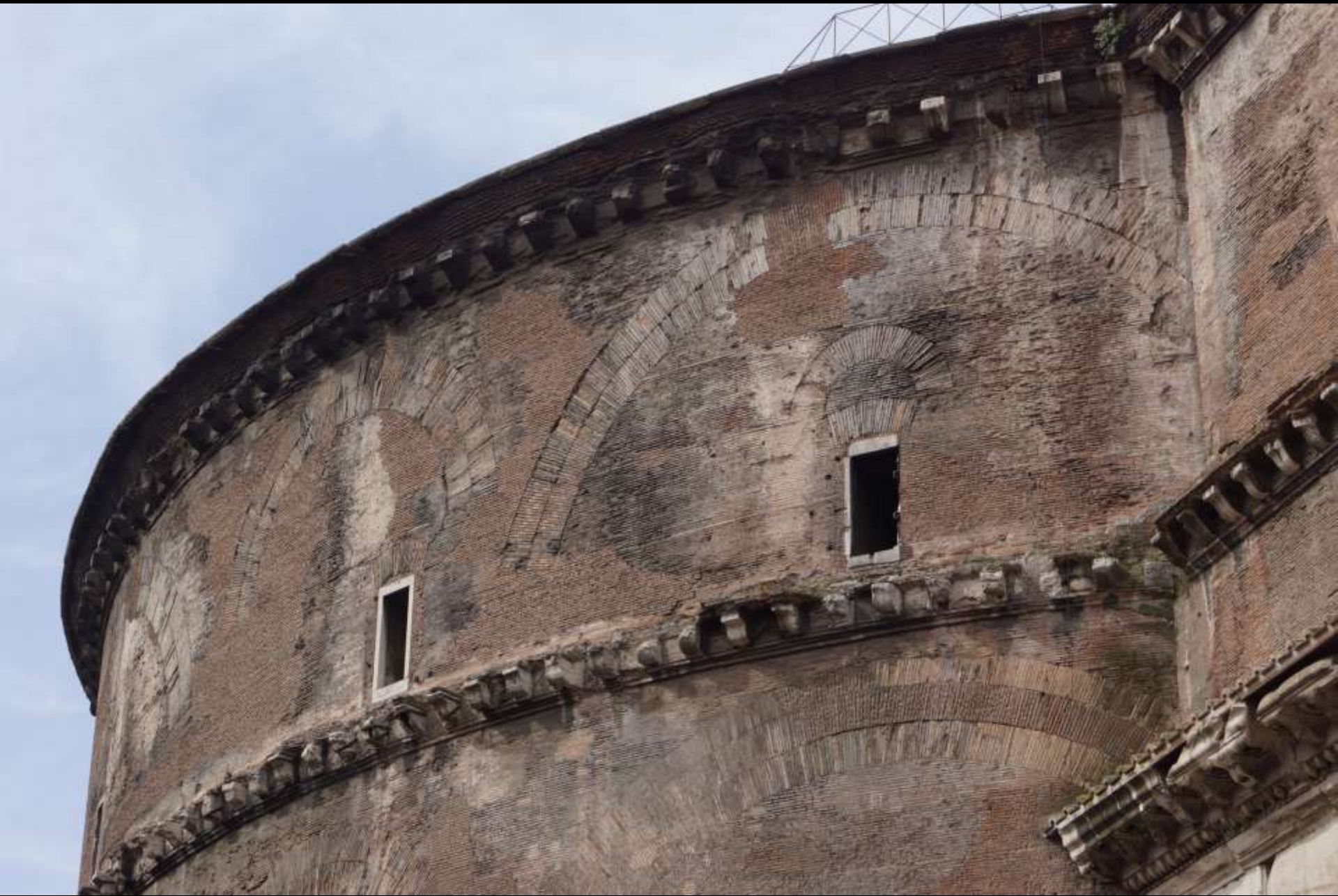
Rom, Pantheon. Aussenbau der Rotunde mit Entlastungsbögen
