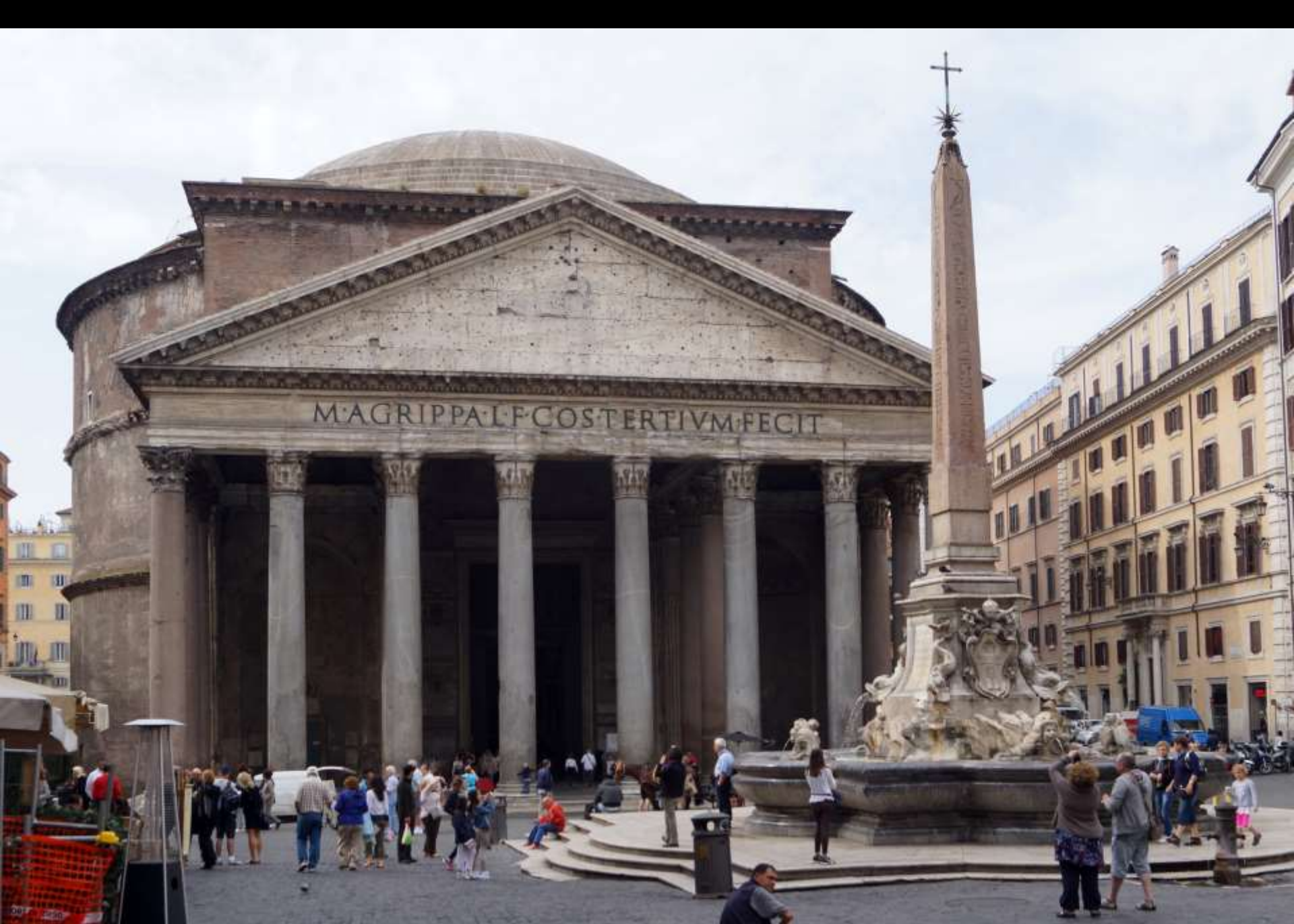
Rom, Pantheon. Fassade mit Portikus. Höhe der Säulenschäfte 40 Fuss.
