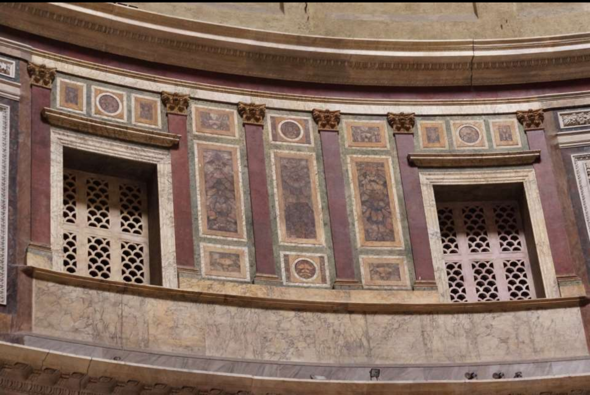
Rom, Pantheon. Rekonstruierte Marmorverkleidung der Attikazone
