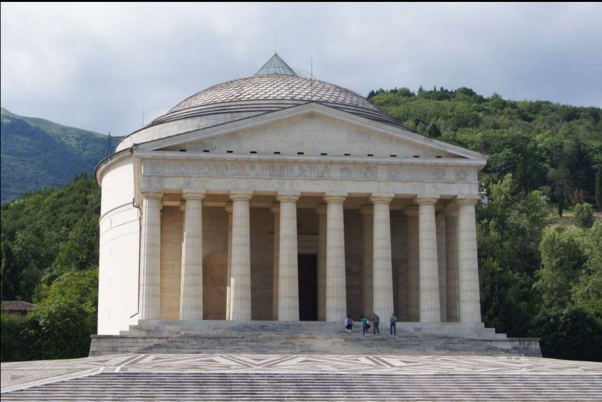
Rezeption des Pantheons in späterer Architektur Possagno, Tempio Canoviano (1818–30). Kombination von Parthenon-Fassade und Pantheon-Rotunde
