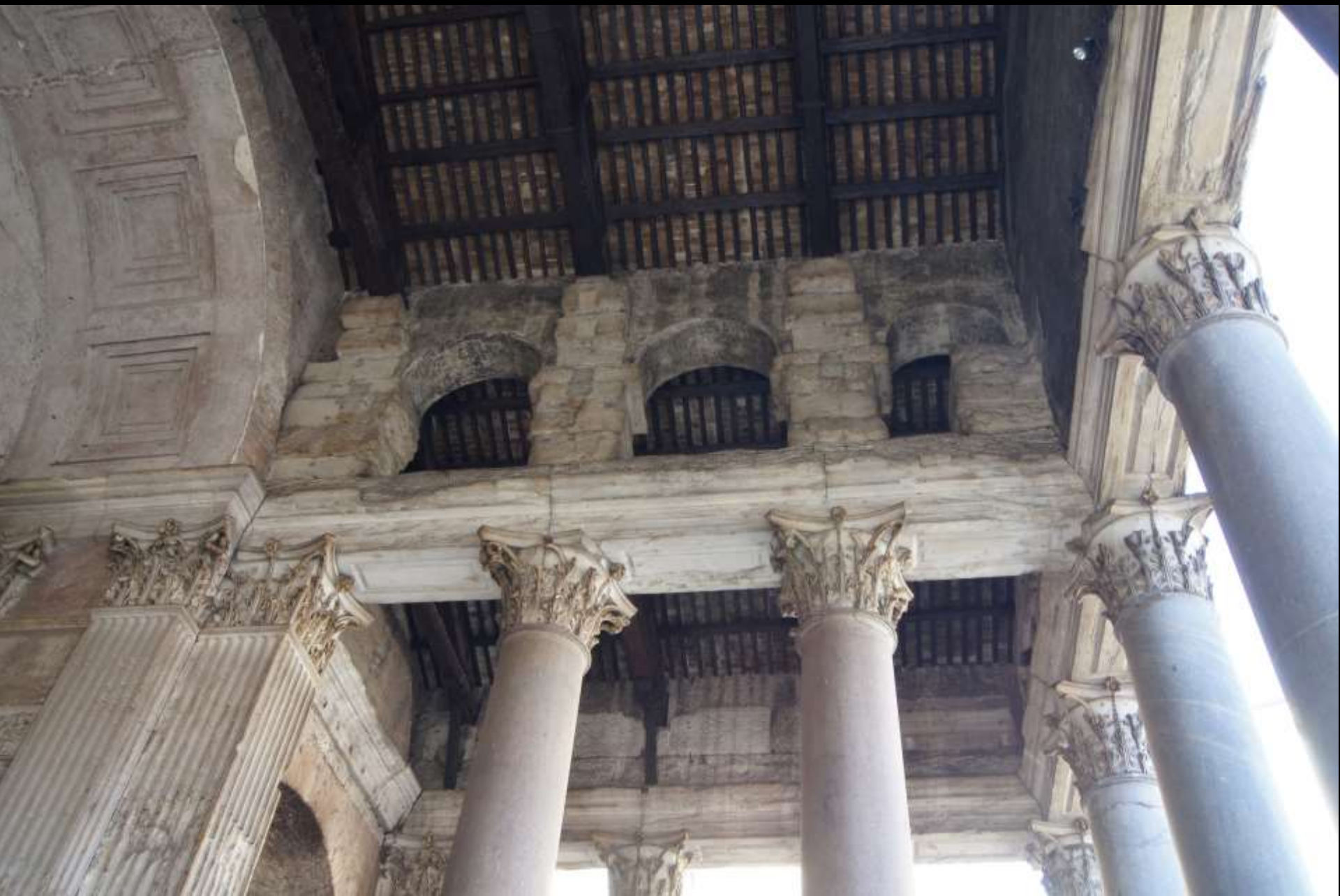
Rom, Pantheon. Portikus. Reste des antiken Dachaufbaus
