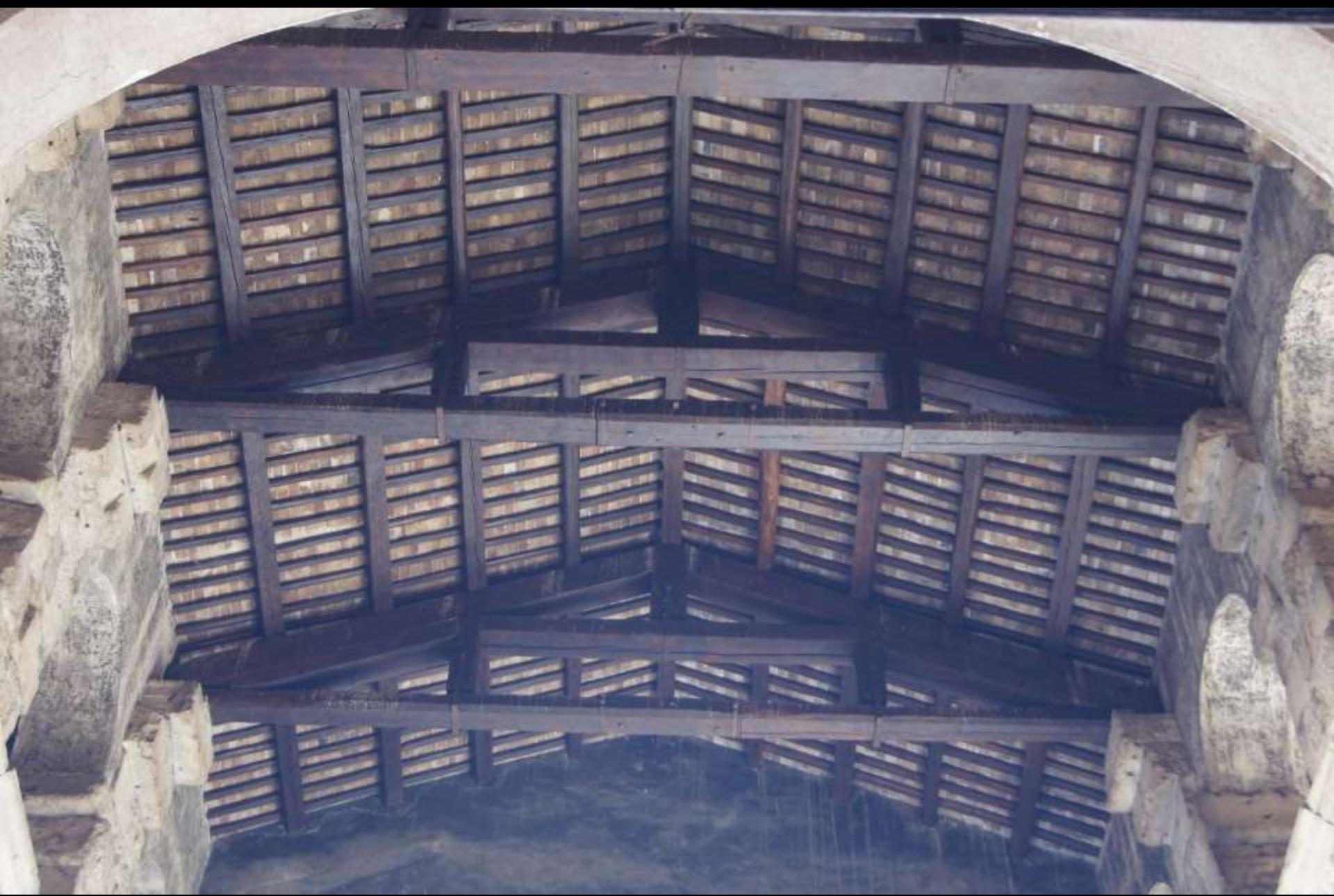
Rom, Pantheon. Portikus. Blick ins heutige Dachwerk (17. Jh.) „... quod non fecerunt Barbari, fecerunt Barberini ...“
