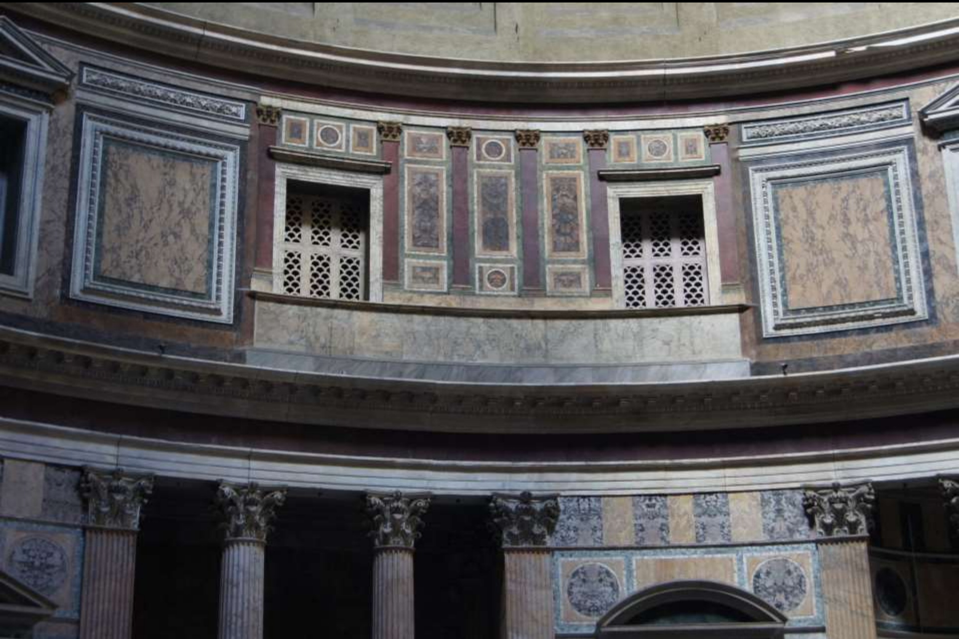
Rom, Pantheon. Rekonstruierte Marmorverkleidung der Attikazone
