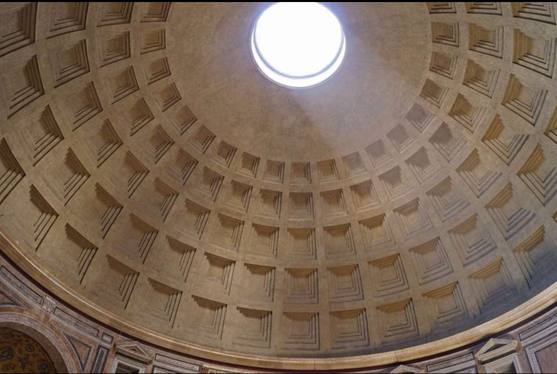
Rom, Pantheon. Kuppel mit Kassetten
