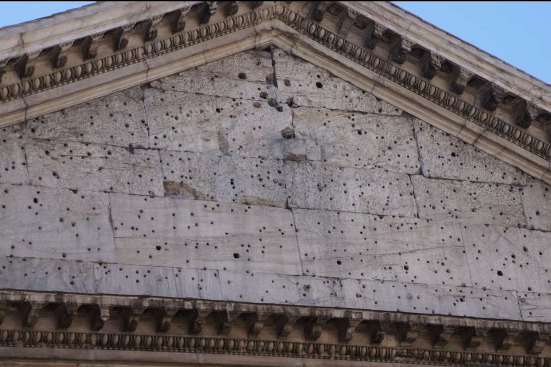
Rom, Pantheon. Giebelfeld mit Dübellöchern der ehemaligen Dekoration.
