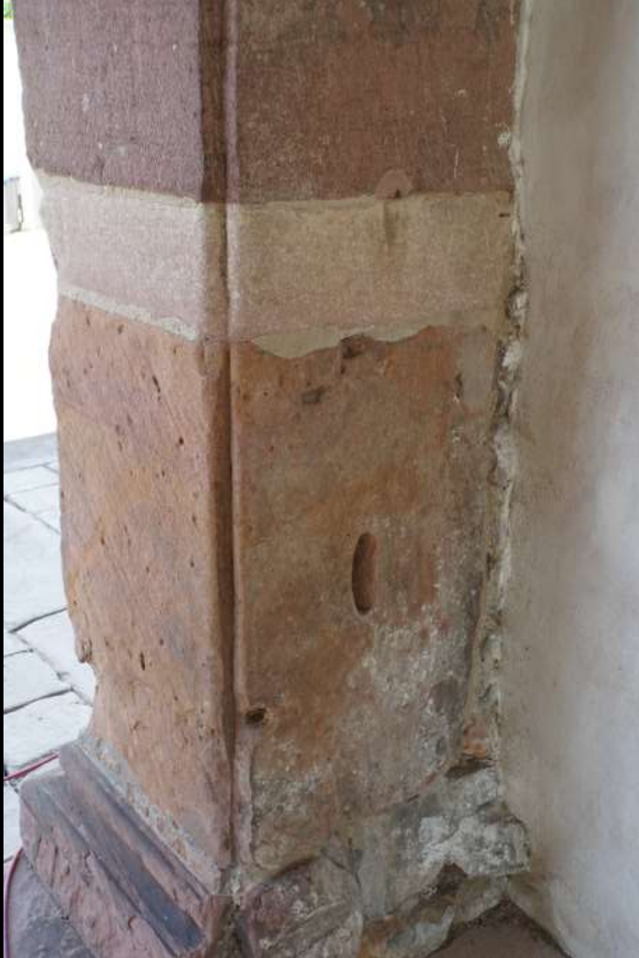
Lorsch, Torhalle (9. Jh.). Wiederverwendeter römischer Quader mit Wolfsloch.
