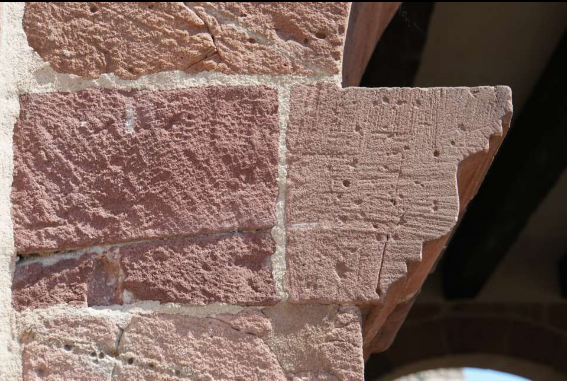
Lorsch, Torhalle (9. Jh.). Spuren glatter und gezahnter Steinbearbeitungswerkzeuge in antiker Tradition.
