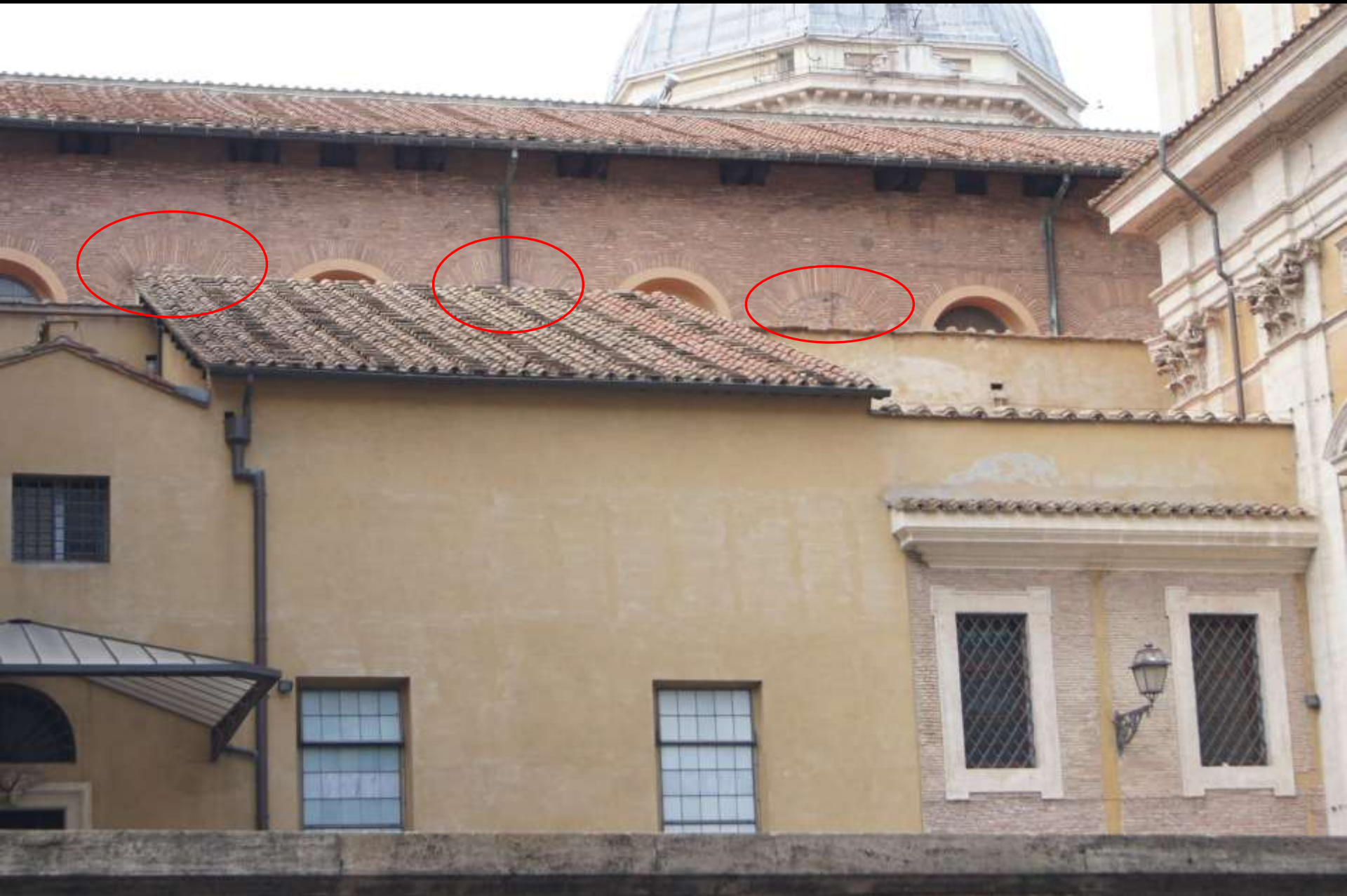
Rom, Santa Maria Maggiore. Ansicht des Obergadens mit dichter Fensterfolge
