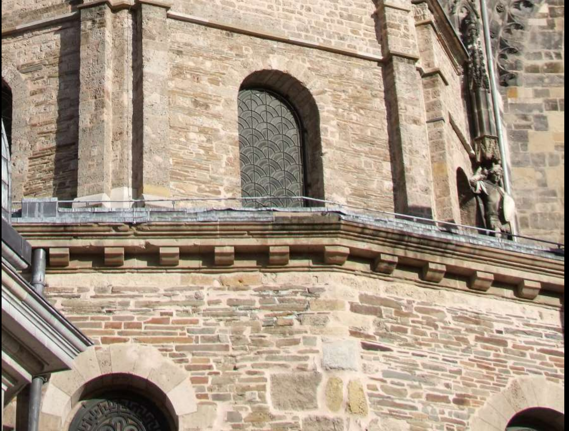
Aachen, Pfalzkapelle. Detailansicht des Mauerwerks aussen.
