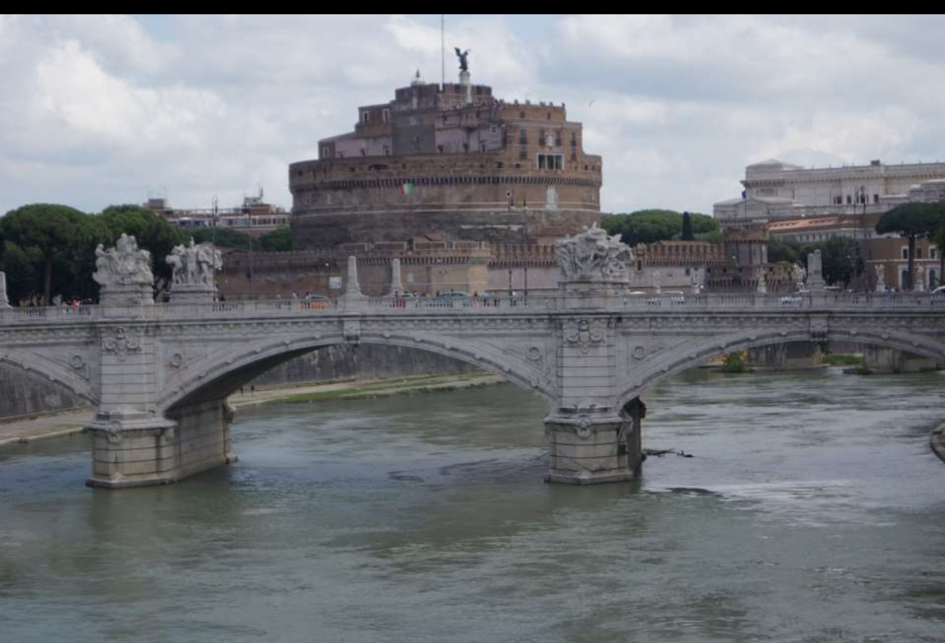
Rom. Grabmal des Hadrian (1. H. 2. Jh. n. Chr.) (später umgebaut zur „Engelsburg“)
