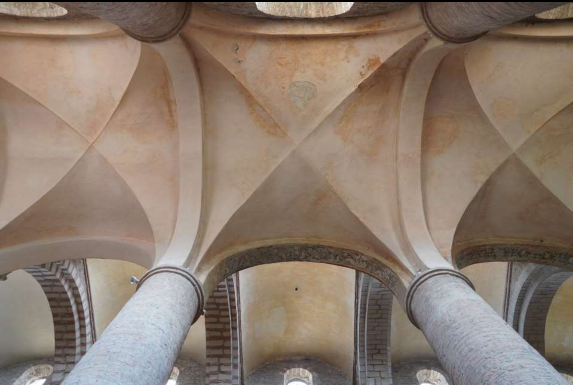
Tournus, Saint-Philibert. Langhaus, Seitenschiff, Kreuzgratgewölbe.
