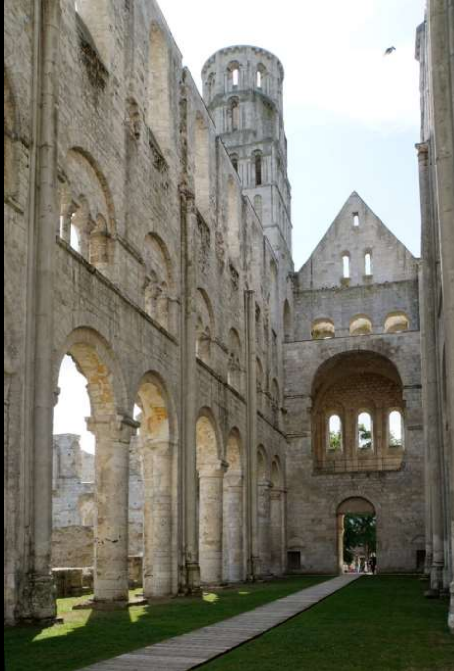
Jumièges (Normandie), Inneres. Einer der frühesten ganz in sichtbarem Werkstein ausgeführten Bauten
