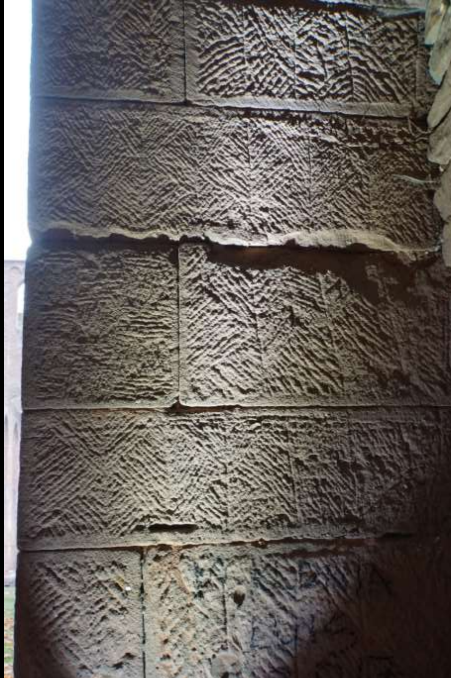
Limburg an der Haardt, Klosterkirche, Steinbearbeitung an den Werksteinelementen.
