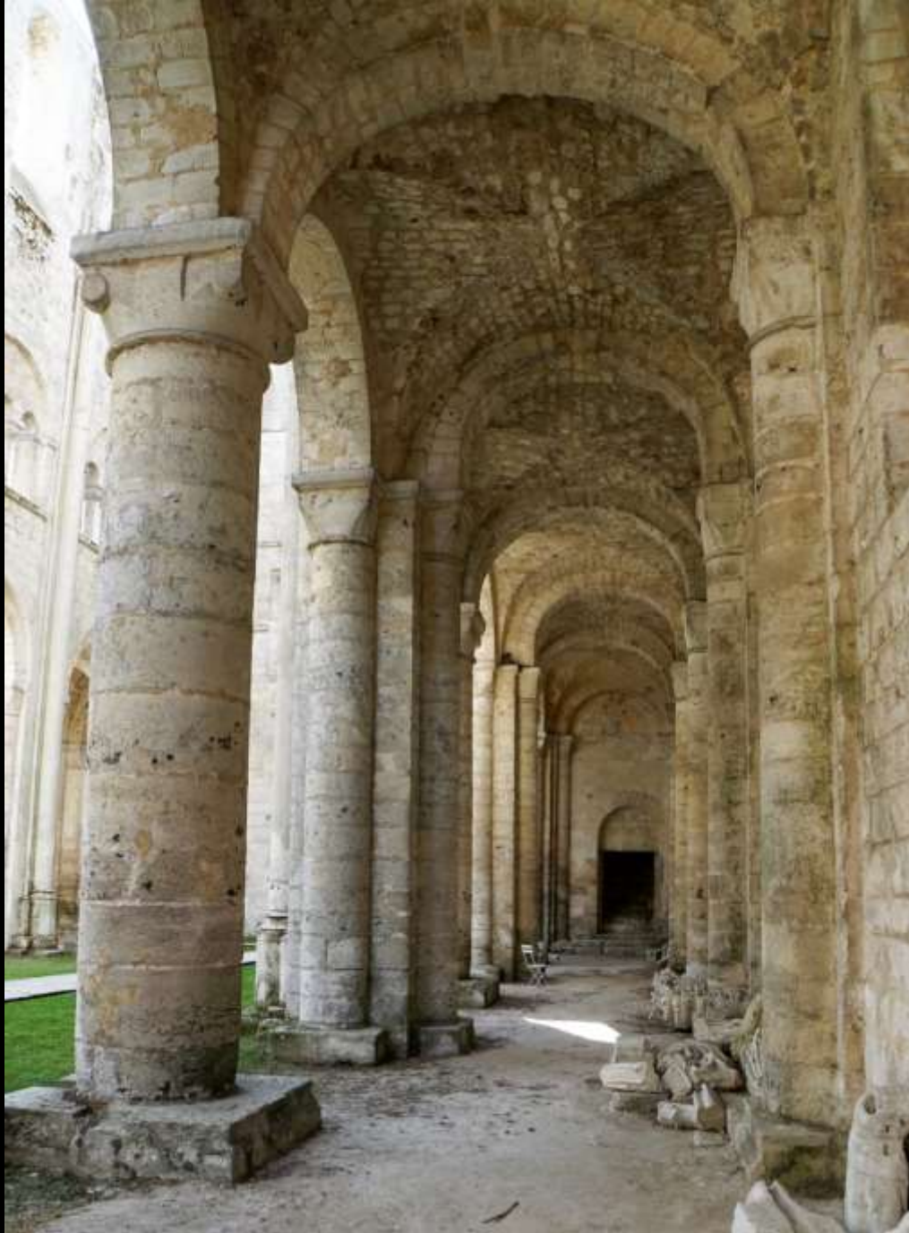
Jumièges (Normandie), Seitenschiffe mit Kreuzgratgewölben.
