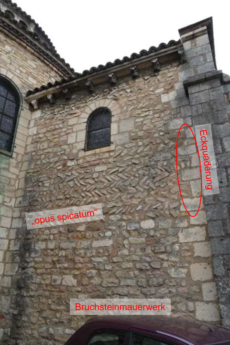
Tournus, Saint-Philibert. Bruchsteinmauerwerk (um 1008) an einer Radialkapelle des Chorumgangs
