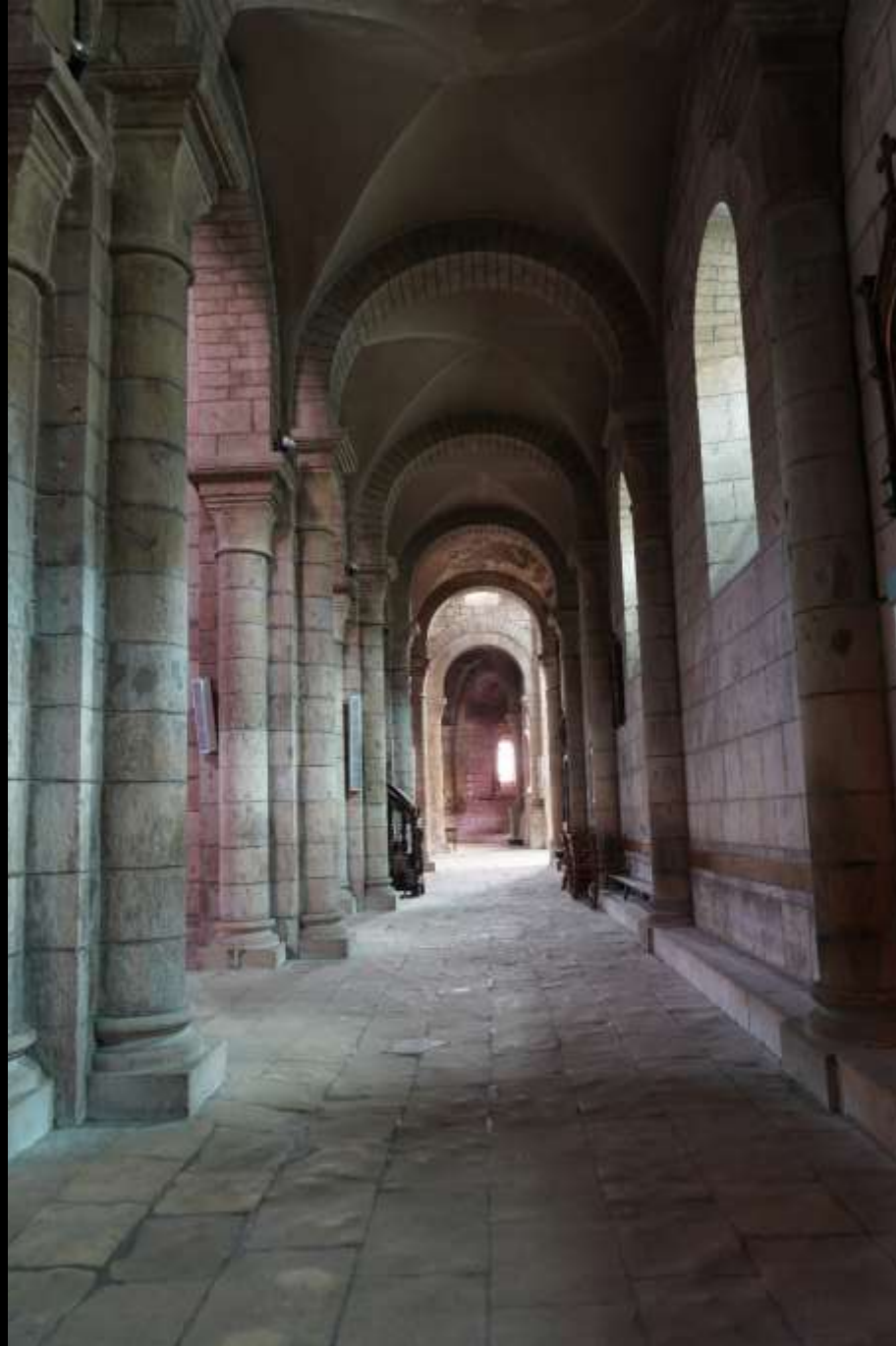
Nevers, Abteikirche Saint-Étienne, Seitenschiff, Gewölbe
