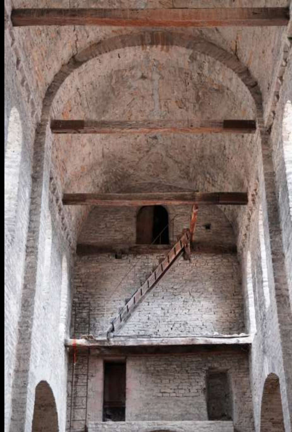
Tournus, Saint-Philibert. Vorkirche, Obergeschoss. Viertelkreistonnen im Seitenschiff und Zuganker im Mittelschiff.
