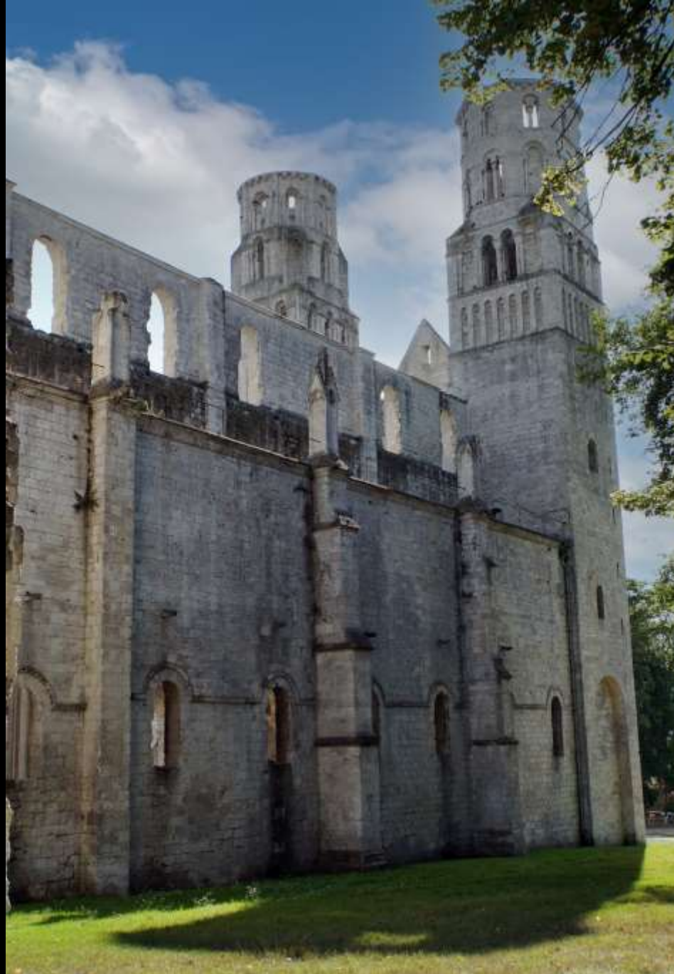
Jumièges (Normandie), Inneres. Einer der frühesten ganz in sichtbarem Werkstein ausgeführten Bauten
