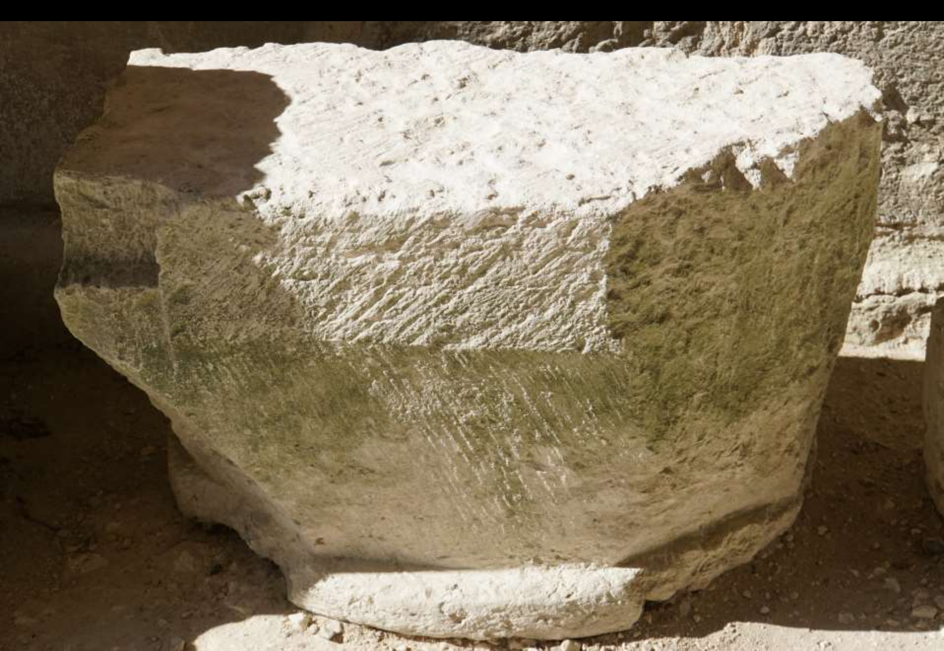
Jumièges (Normandie), Steinbearbeitung mit dem Beil („Glatfläche“) an einem Kapitell der Seitenschiffe
