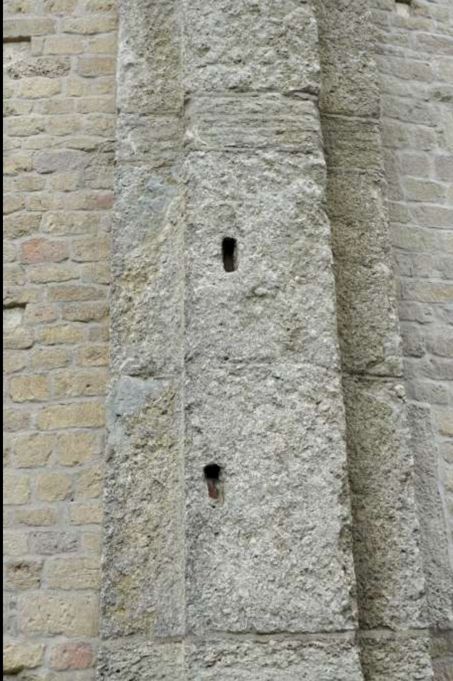
Abteikirche Payerne VD, wiederverwendete römische Quader aus Aventicum (Avenches)
