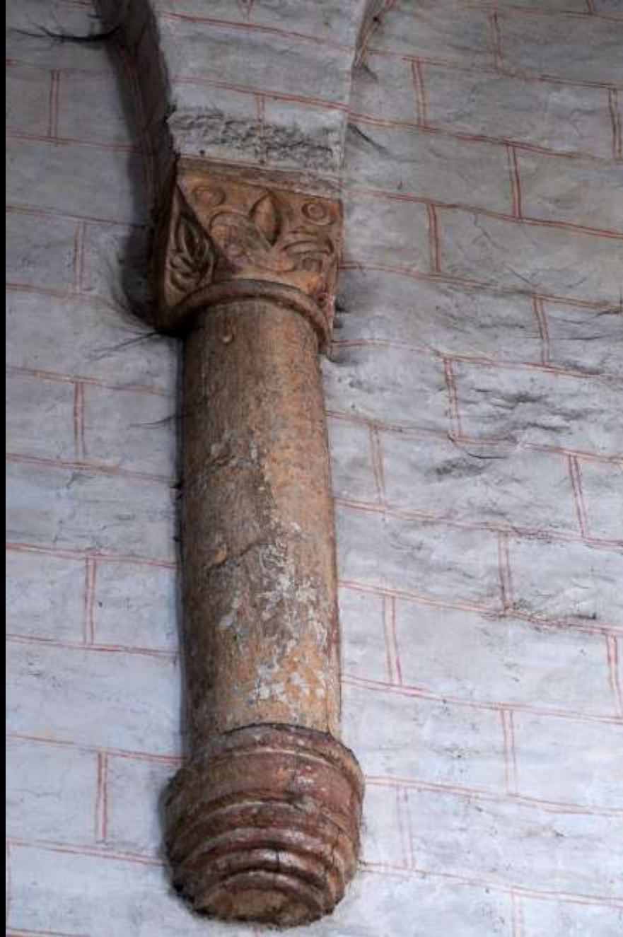
Romainmôtier, Abteikirche. Säulchen zur Aufnahme des Gewölbeanfängers Putz teils noch original mit Quadermalerei
