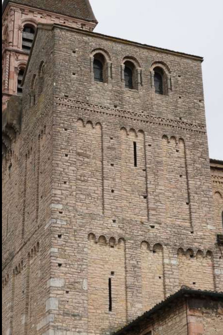
Tournus, Saint-Philibert. Bruchsteinmauerwerk, Lisenen und Frieze am Westwerk (um 1030).
