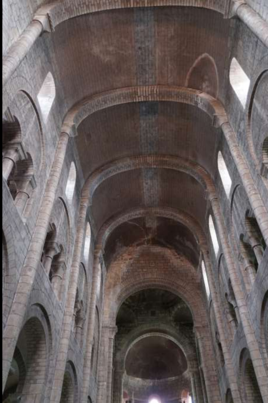
Nevers, Abteikirche Saint-Étienne, Mittelschiff, Gewölbe (Gewölbeputz und Quadermalerei 19. Jh.)
