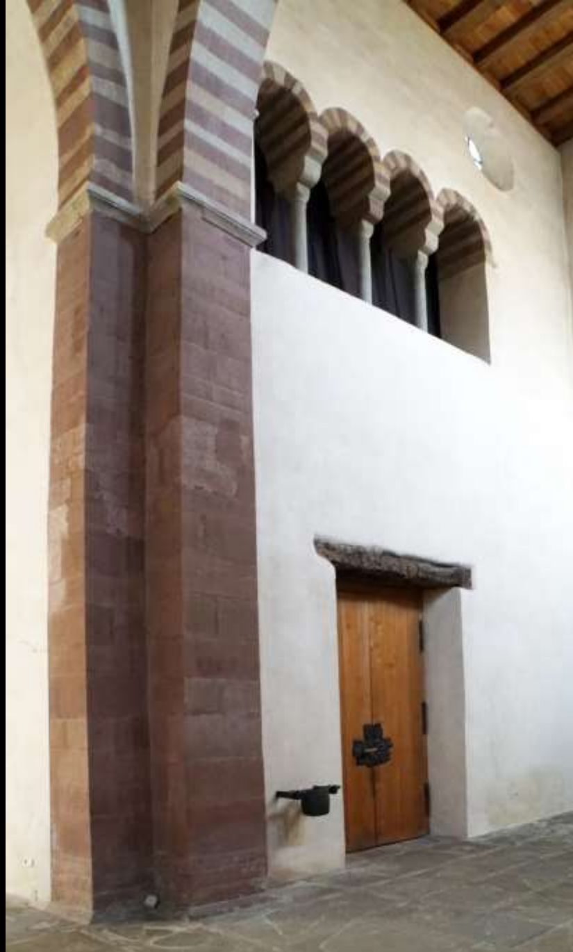
Insel Reichenau, Münster Mittelzell, verputztes Bruchsteinmauerwerk und unverputzte Werksteingliederung
