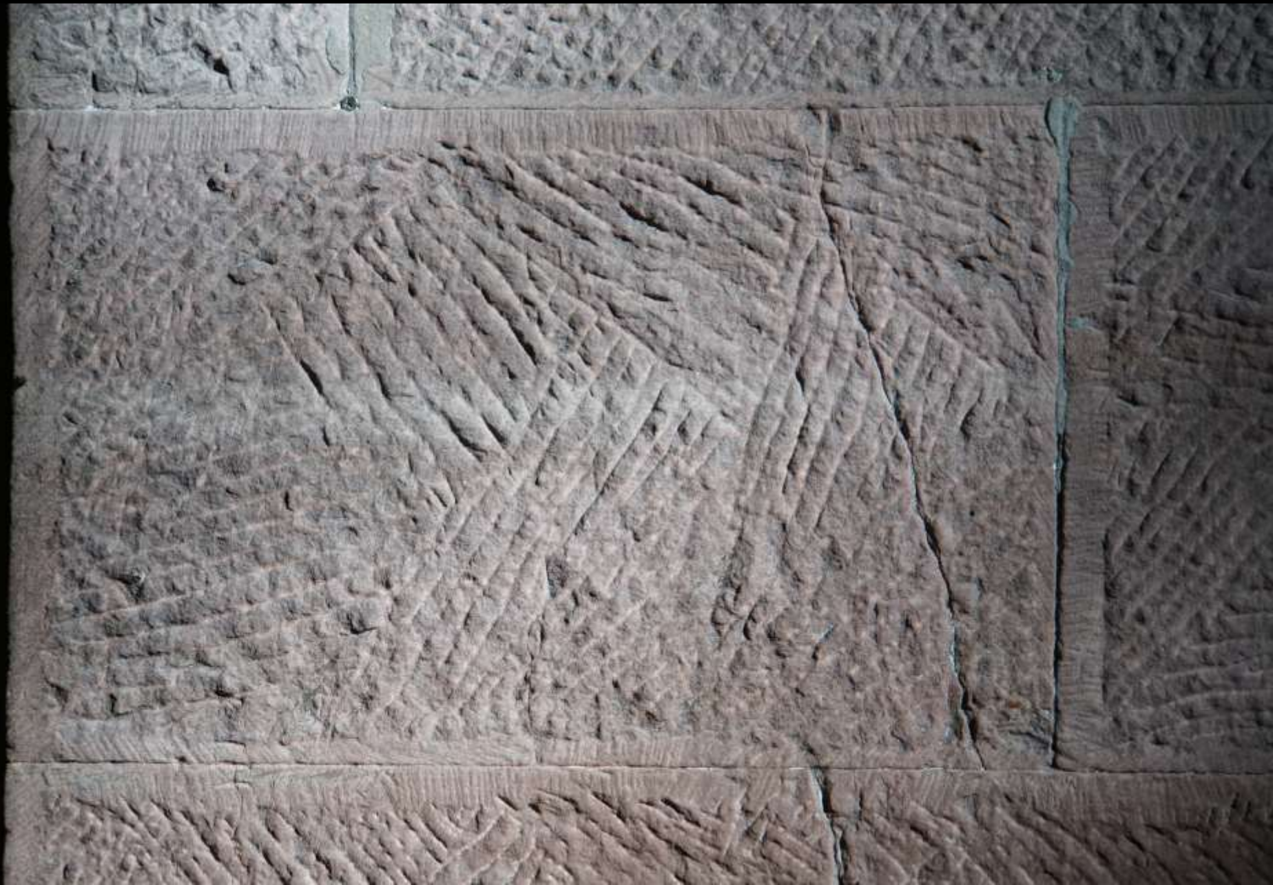
Insel Reichenau, Münster Mittelzell, Steinbearbeitung(1. H. 11. Jh.)
