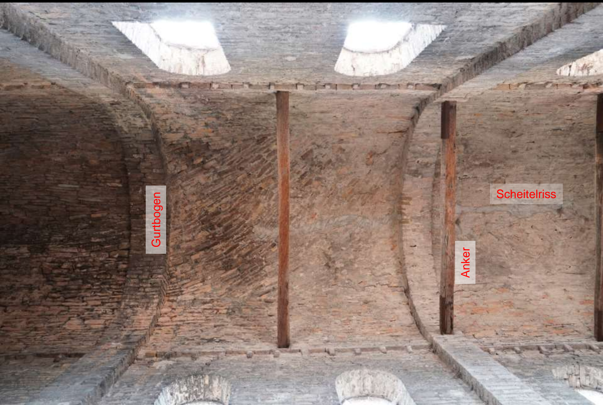
Tournus, Saint-Philibert. Vorkirche, Obergeschoss. Tonnengewölbe und Zuganker im Mittelschiff.
