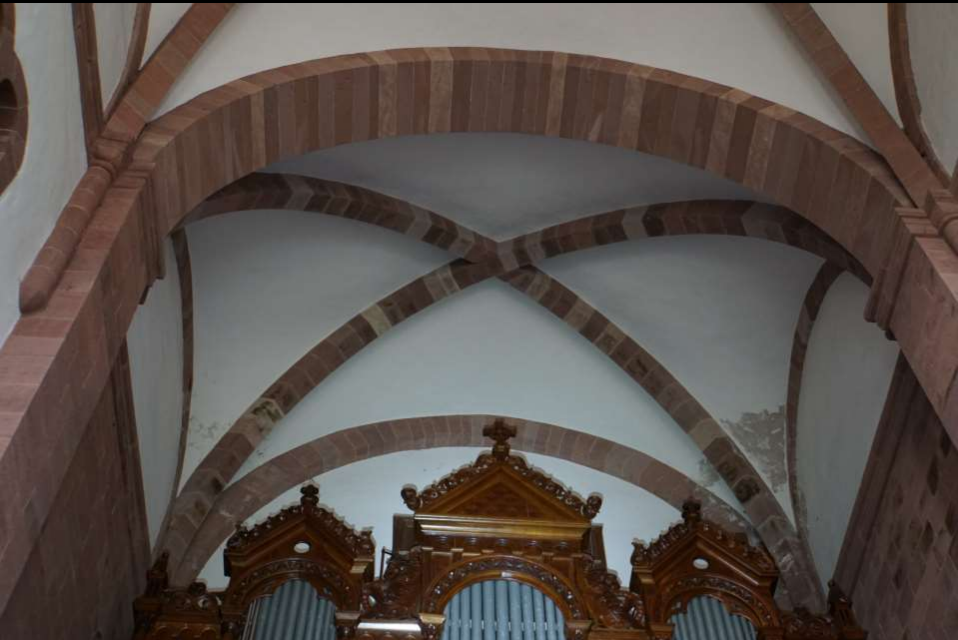
Murbach (Elsass), Ostfassade (1. H. 12. Jh.). Bandrippengewölbe.
