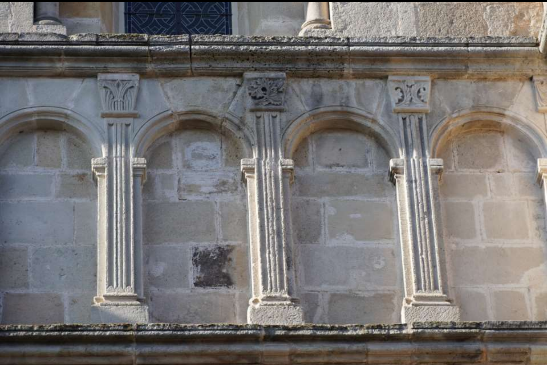
Autun, Kathedrale Saint-Lazare (12. Jh.). Steinschnitt an der Querhausfassade
