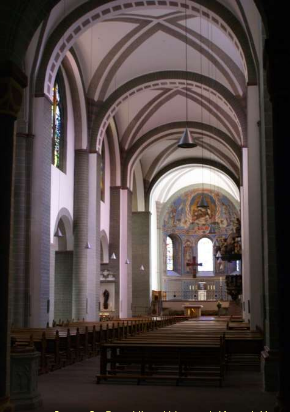
Soest, St. Patrokli und Lippstadt-Kappel, Kreuzgratgewölbe im „gebundenen System“ (12. Jh.). Gewölbebemalung 20. Jh.
