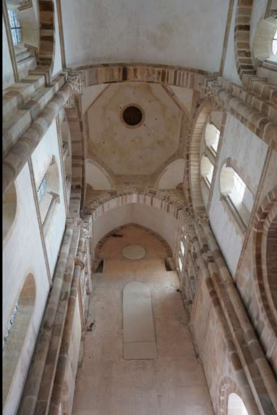
Cluny III, erhaltener Rest des rechten Querschiffs. Wölbung mit „Spitztonne“
