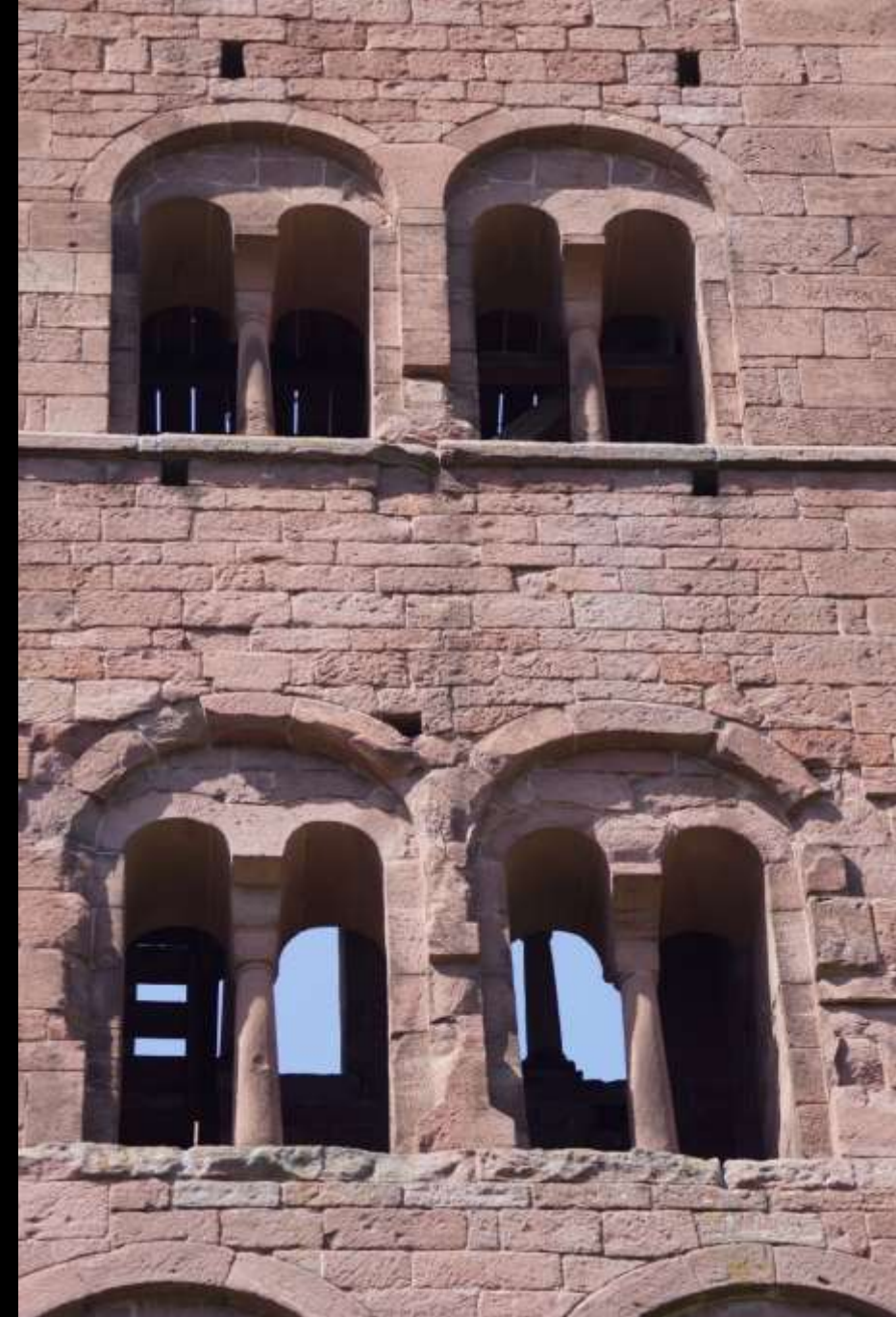
Biforienfenster und Bauplastik. Hirsau, „Eulenturm“, um 1100.
