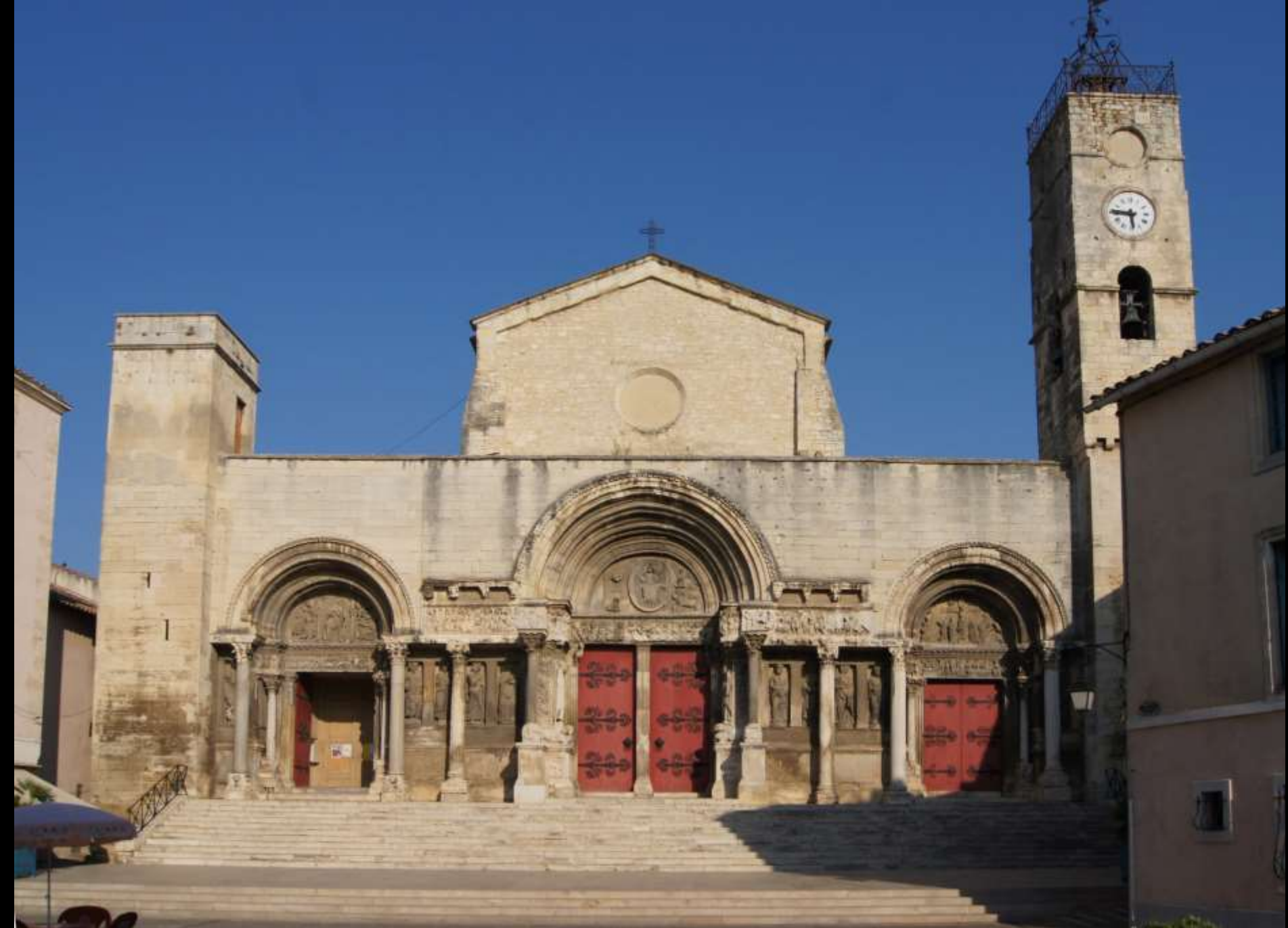
Saint-Gilles (Gard), Abteikirche, Fassade (Ende 12. Jh.)
