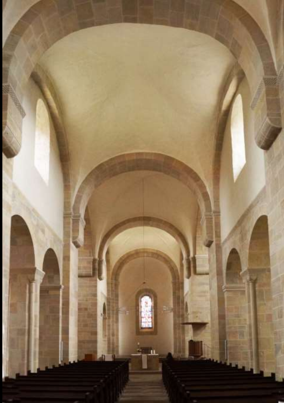
Lippoldsberg, Klosterkirche (12. Jh.). Kreuzgratgewölbe.
