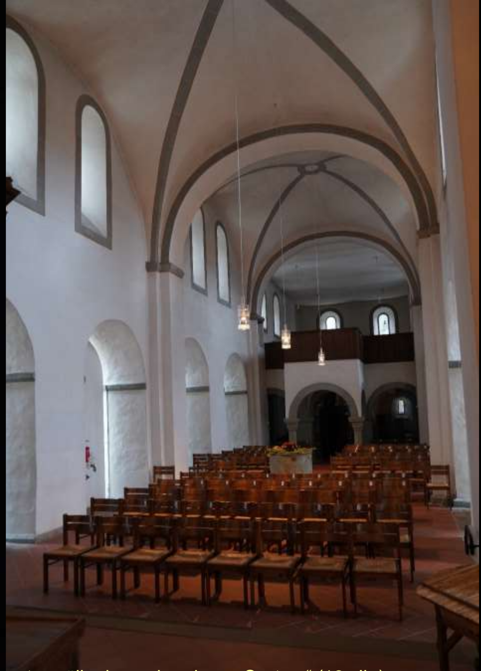
Soest, St. Patrokli und Lippstadt-Kappel, Kreuzgratgewölbe im „gebundenen System“ (12. Jh.). Gewölbebemalung 20. Jh.
