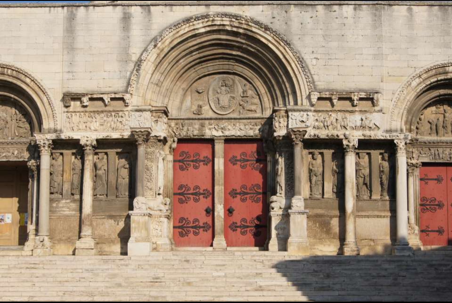
Saint-Gilles (Gard), Abteikirche, Fassade (Ende 12. Jh.)
