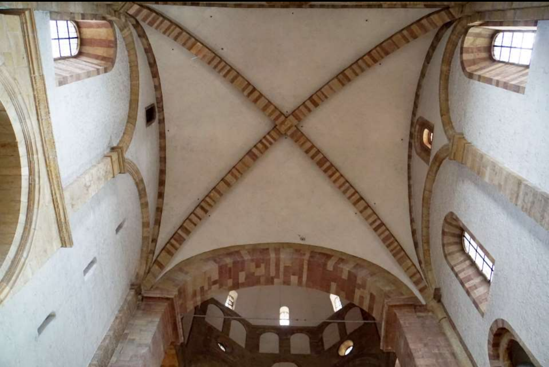
Speyer, Dom, Querhaus. Bandrippengewölbe wohl um 1100.
