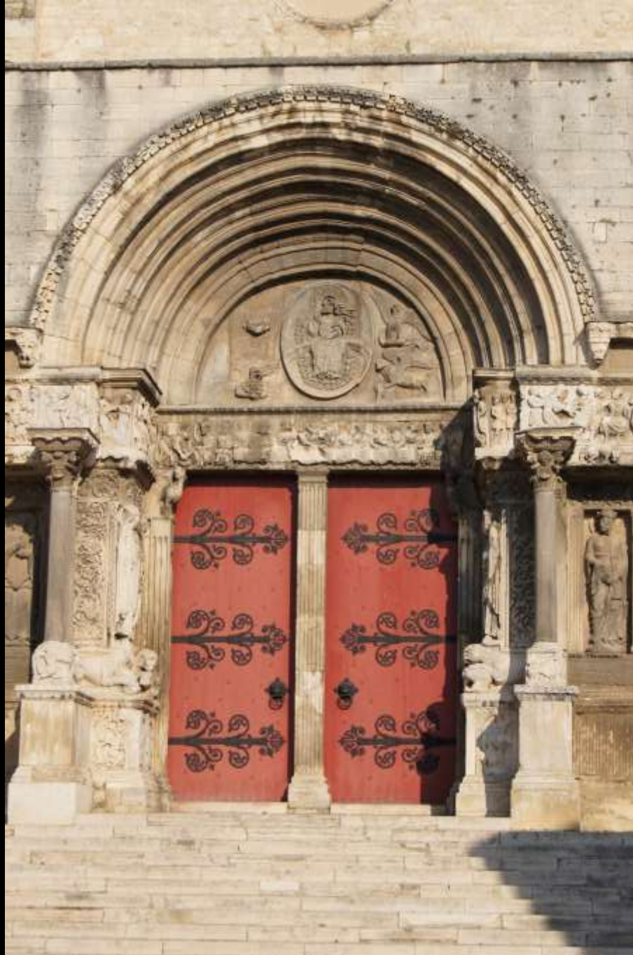
Saint-Gilles (Gard), Abteikirche, Fassade (Ende 12. Jh.)
