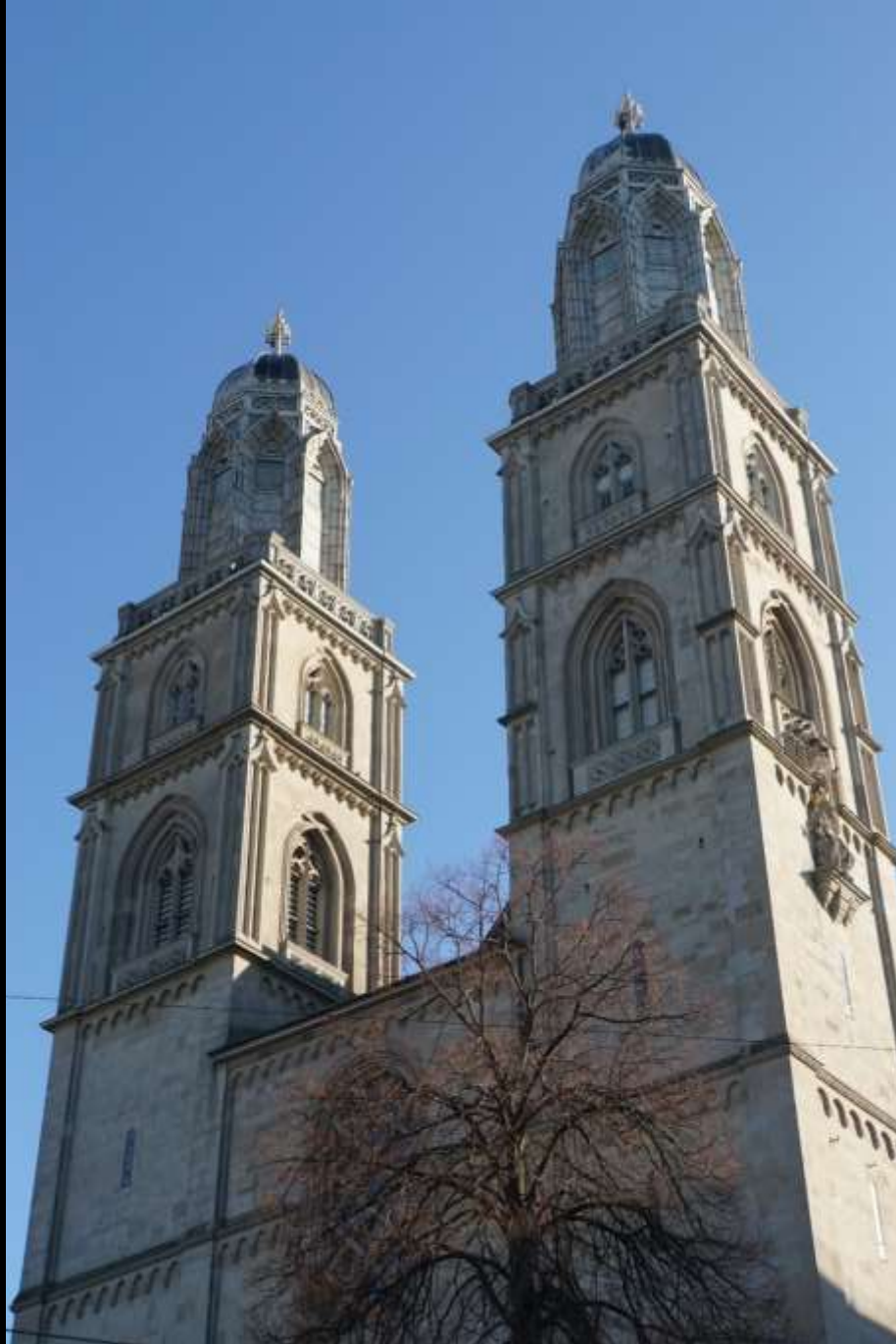
Zürich, Grossmünster, Zweiturfassade (Turmaufsätze sehr viel später)
