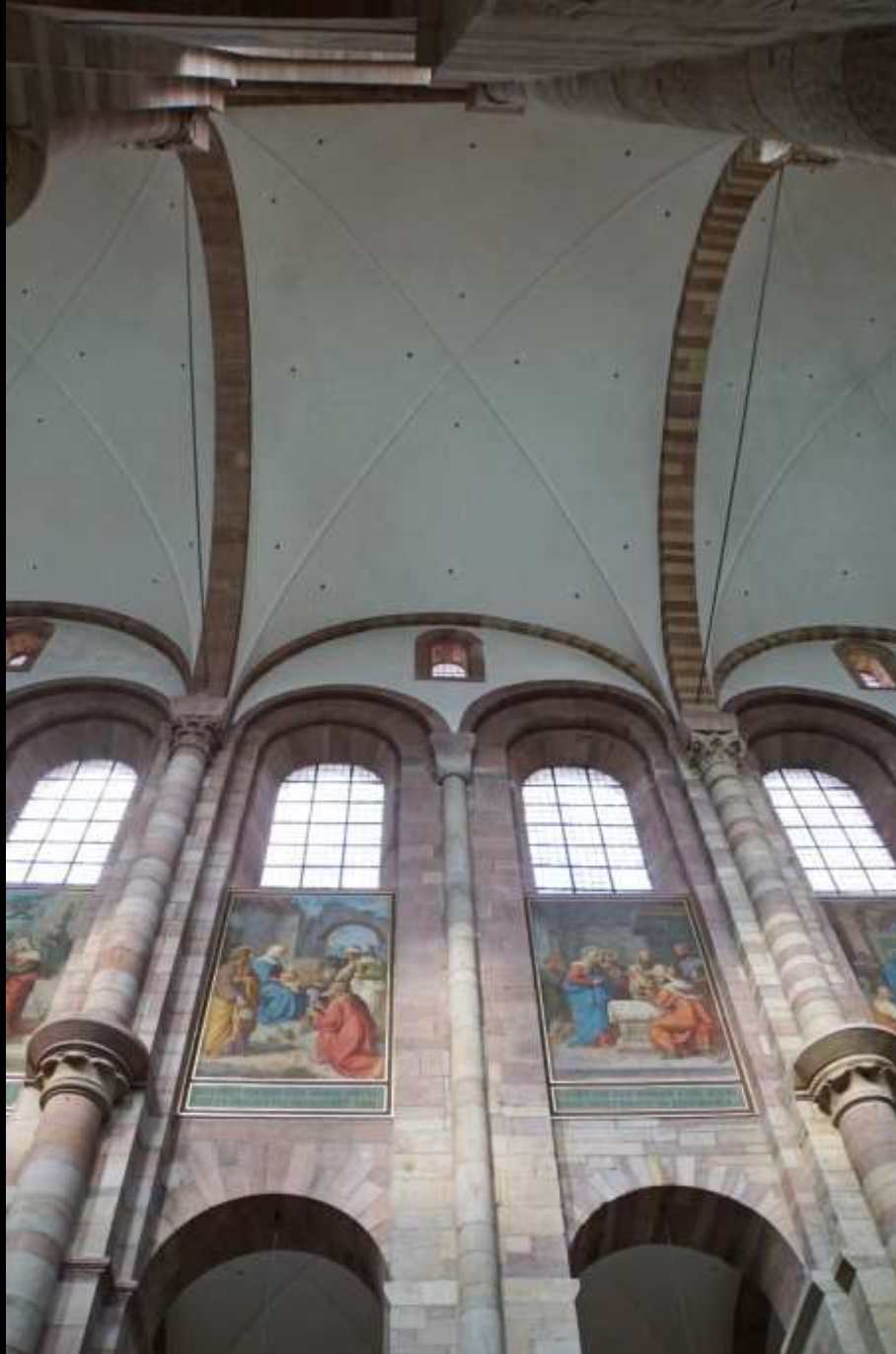
Speyer, Dom, Bau II. Ende 11. Jh. „Gebundenes System“.
