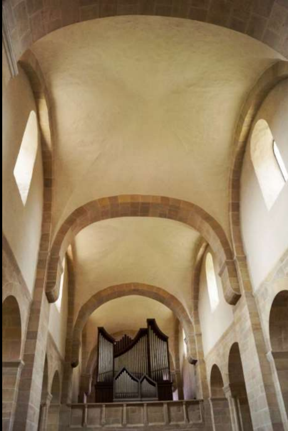
Lippoldsberg, Klosterkirche (12. Jh.). Kreuzgratgewölbe.
