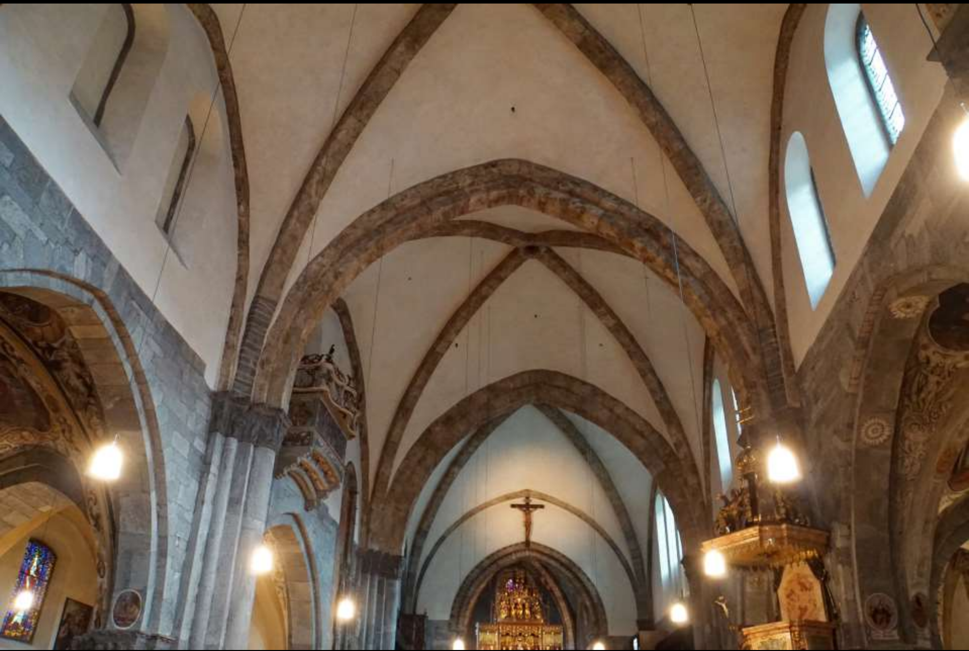
Chur, Kathedrale (1151–1272). Gewölbe
