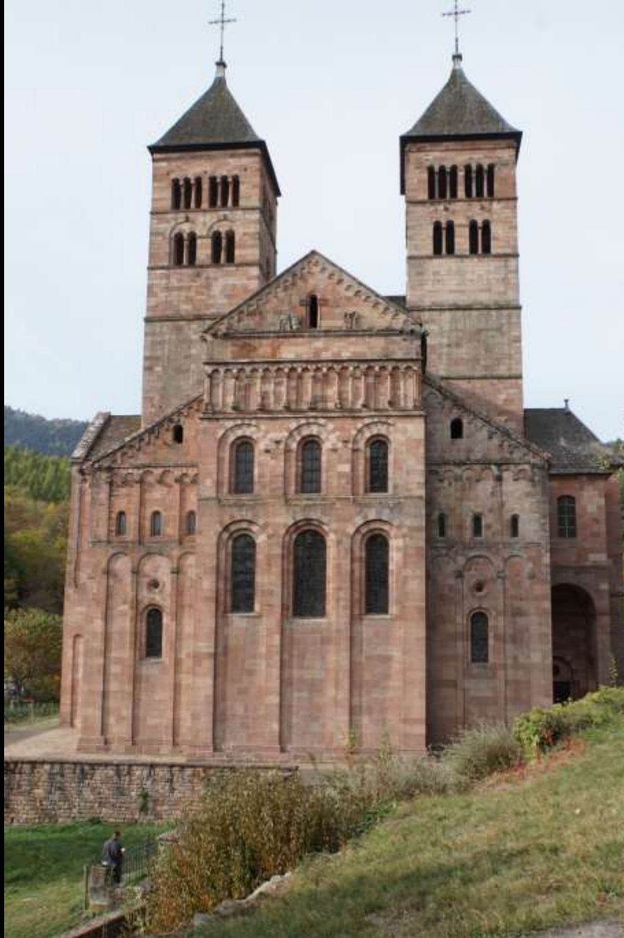
Murbach (Elsass), Ostfassade (1. H. 12. Jh.)
