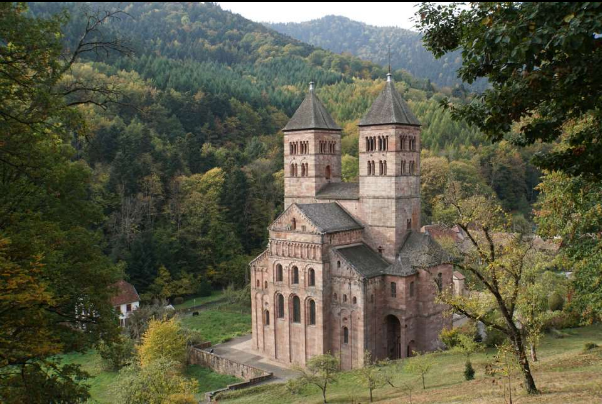
Murbach (Elsass), Ostfassade (1. H. 12. Jh.)
