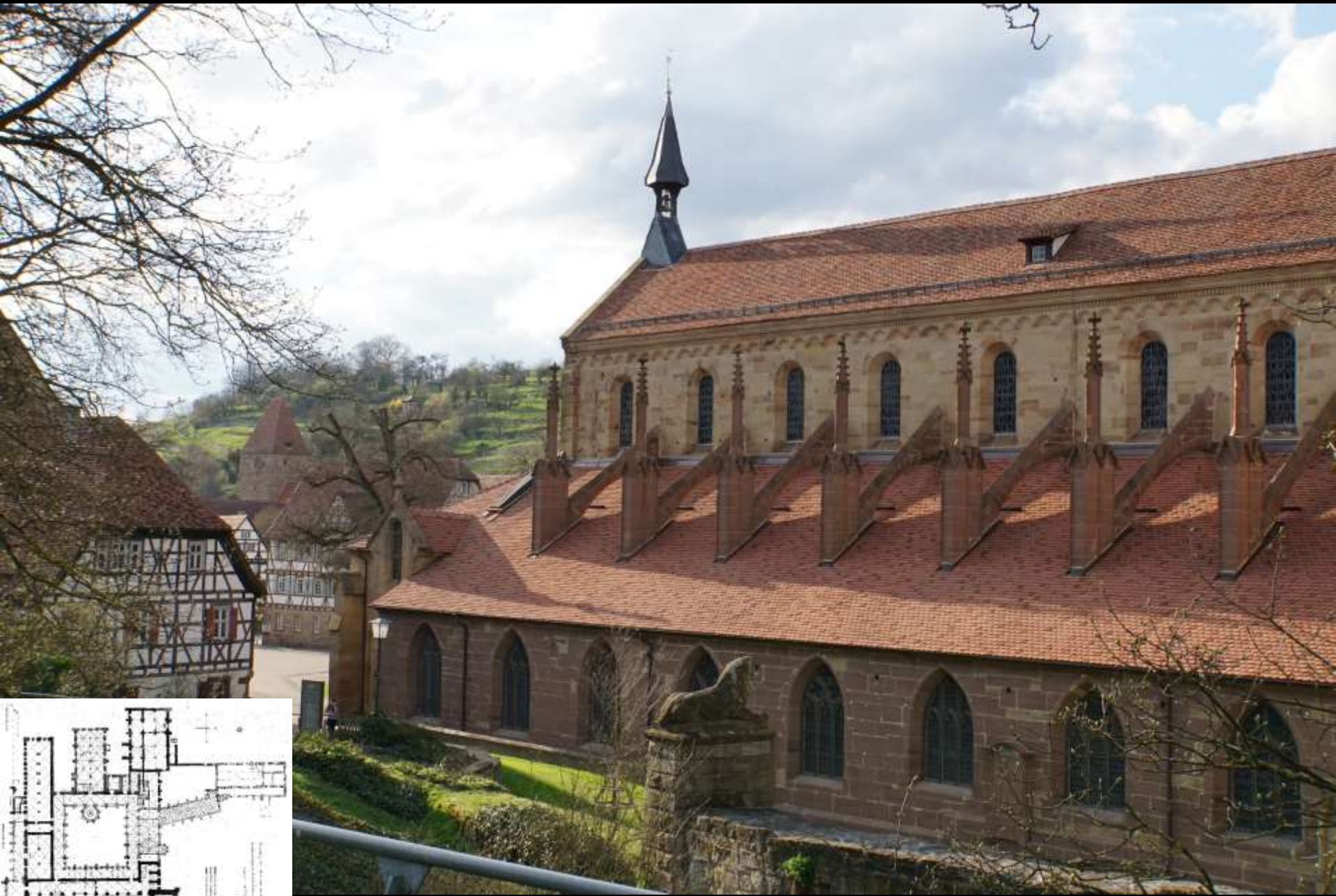
Maulbronn, Kirche von Süden. Strebewerk später hinzugefügt.
