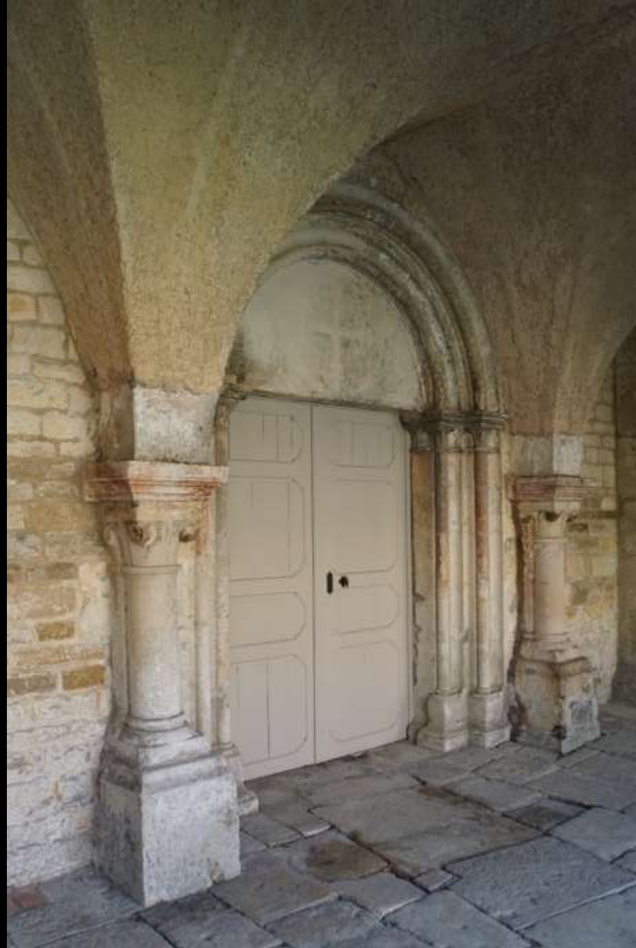
Kloster Fontenay, Burgund – Portal zum Refektorium
