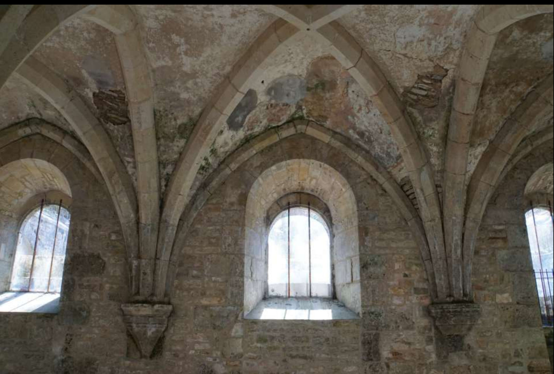
Kloster Fontenay, Burgund – Rippengewölbe in der Schmiede
