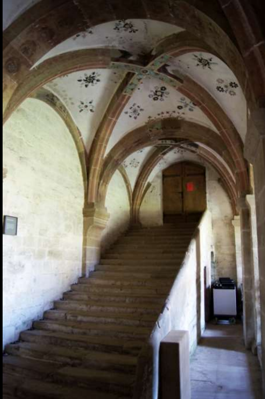
Maulbronn. Dormitoriumstreppe im nördlichen Querhaus
