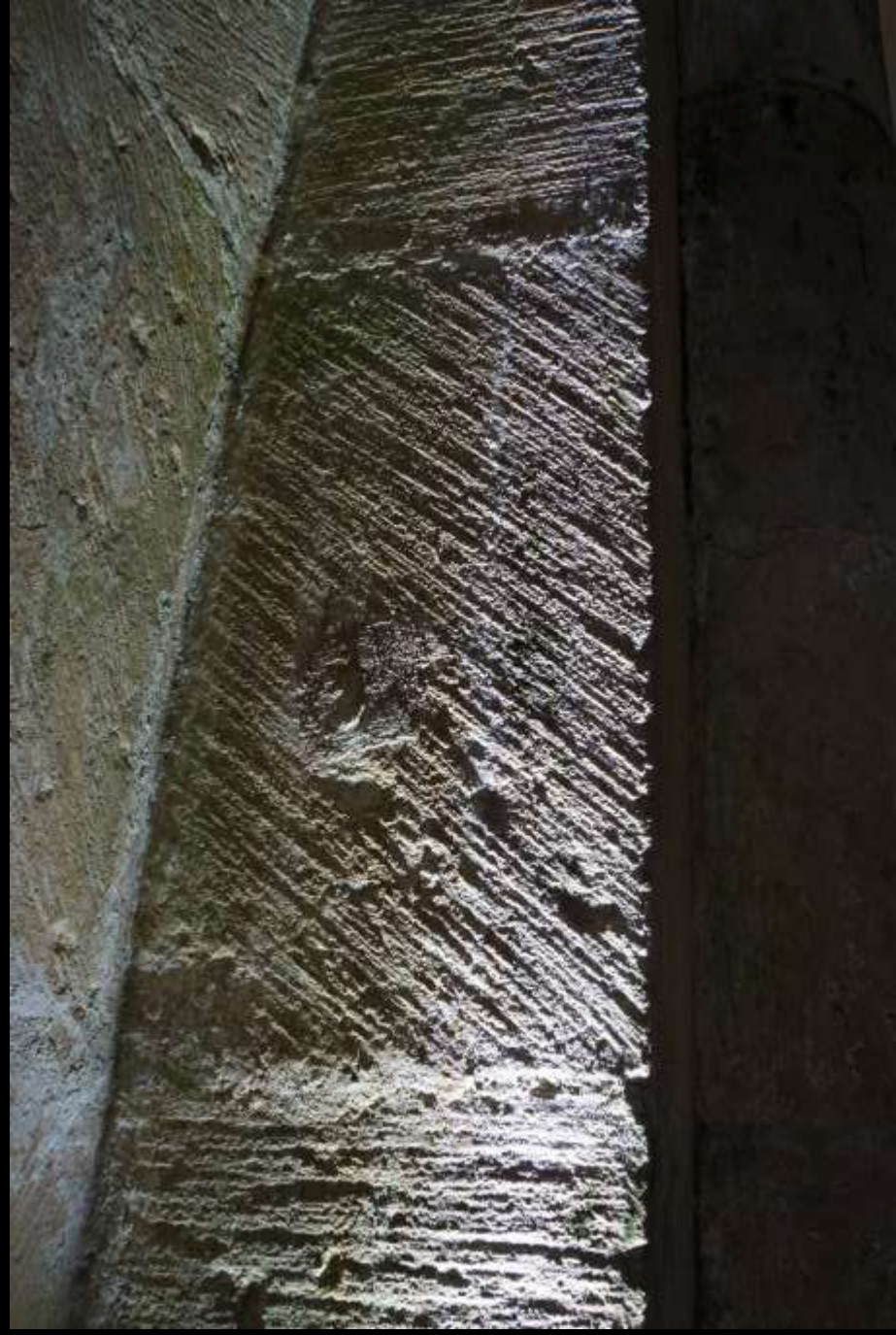
Kloster Fontenay, Burgund – Steinbearbeitung mit „Glatfläche“
