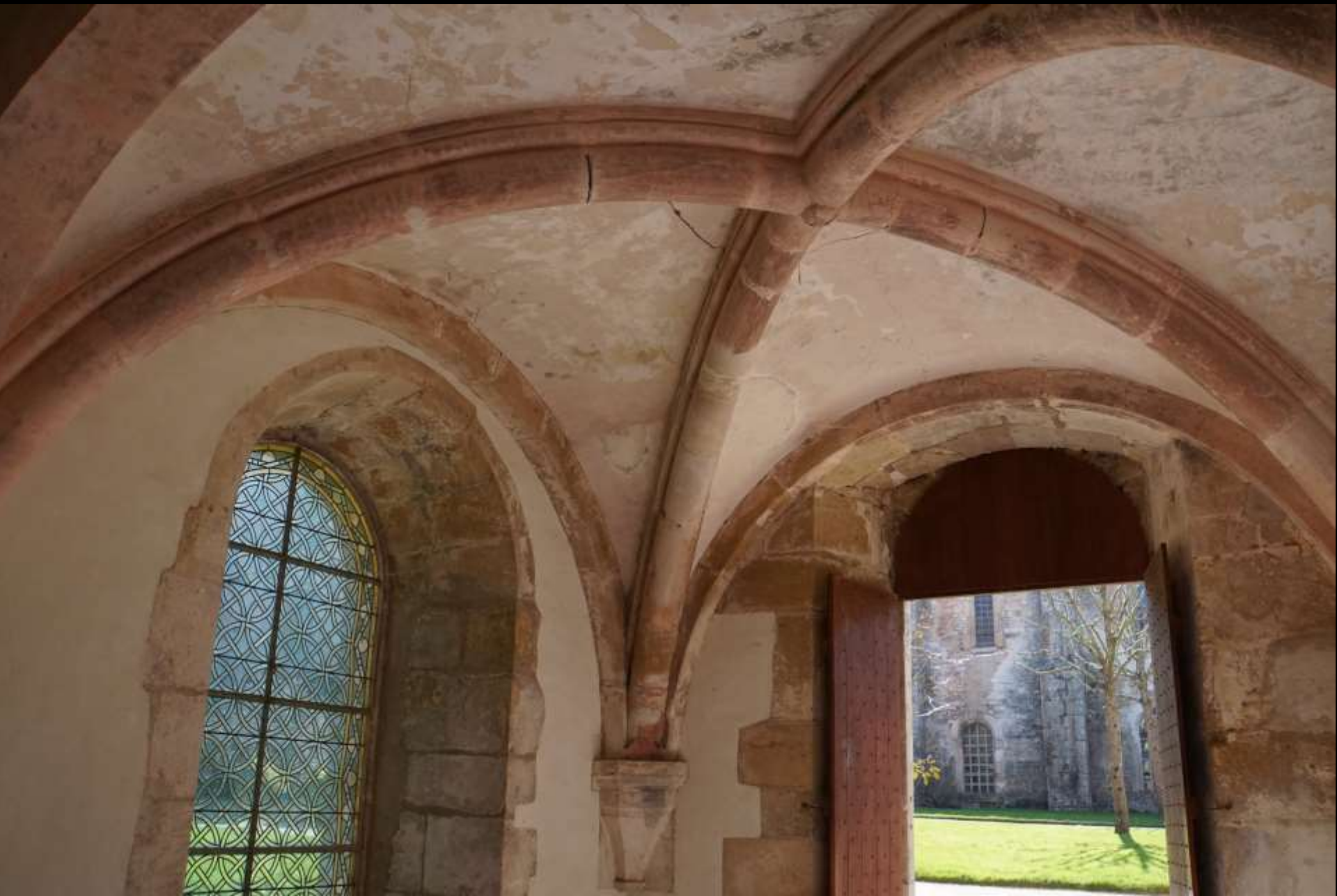
Kloster Fontenay, Burgund – Rippengewölbe im Mönchssaal
