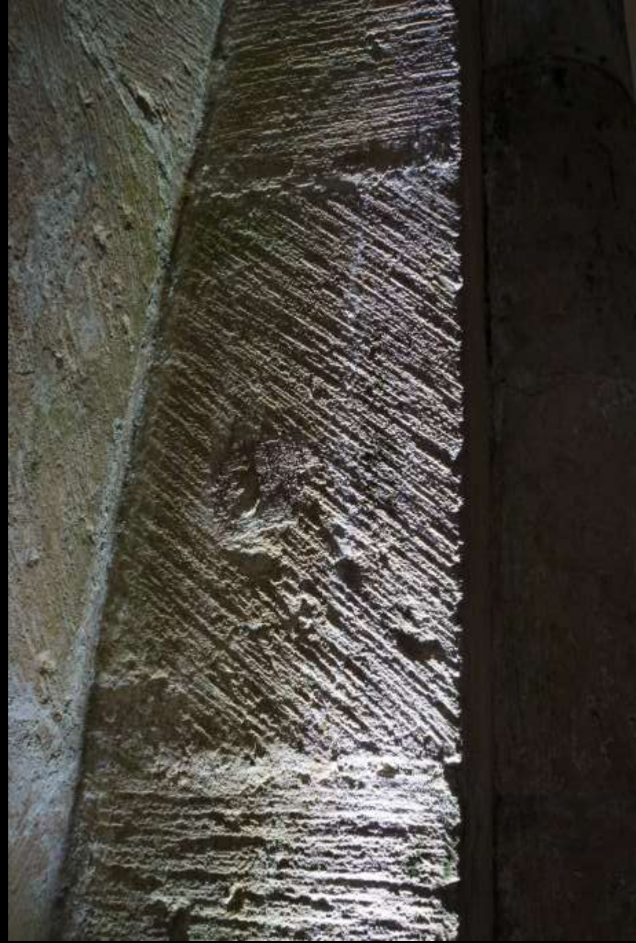
Kloster Fontenay, Burgund – Steinbearbeitung in der Kirche im Normal- und Streiflicht
