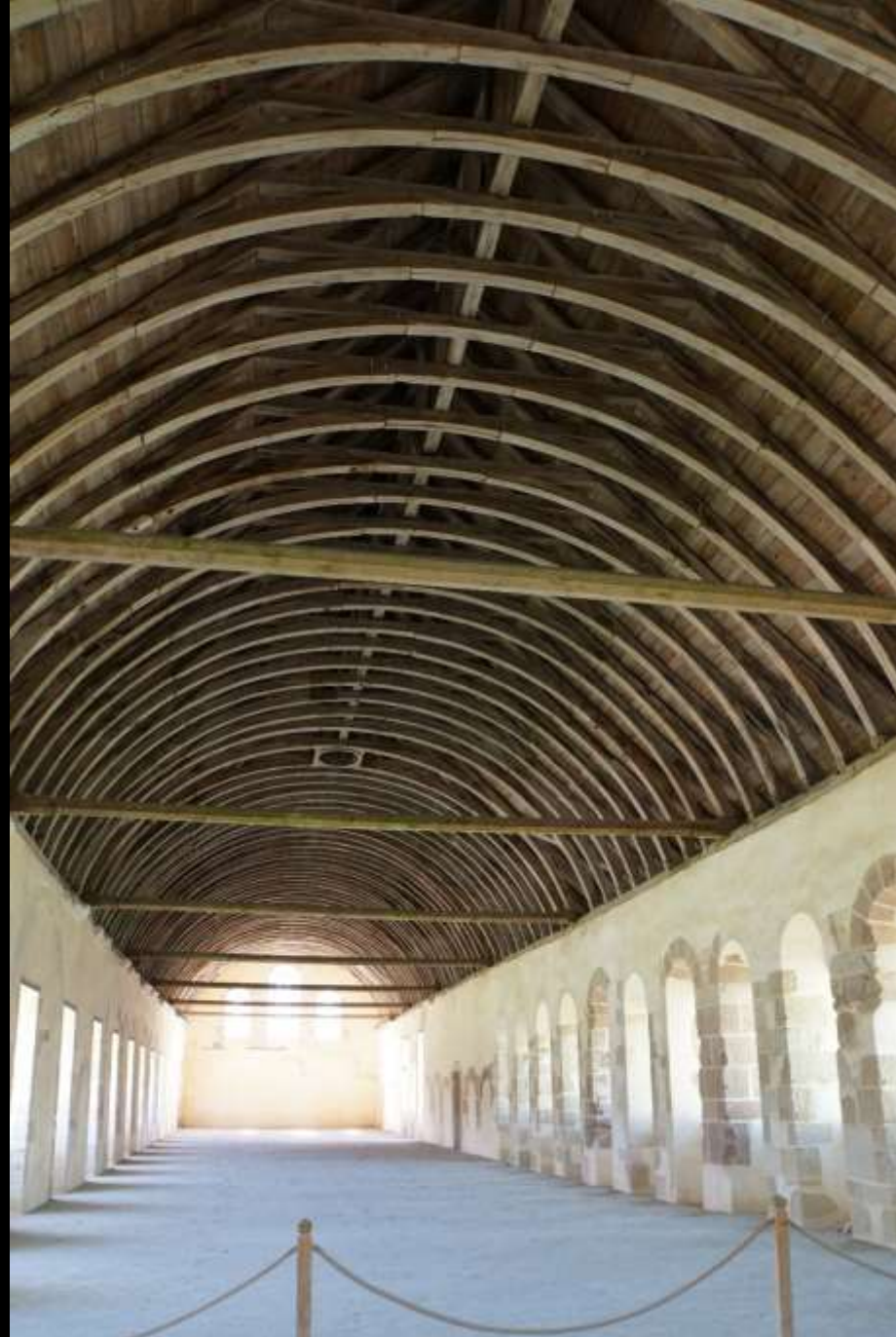
Kloster Fontenay, Burgund – Dormitorium im Obergeschoss (rekonstruiert im 15. Jh.)
