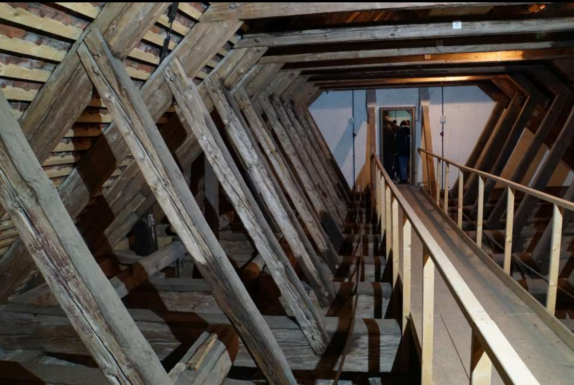
Maulbronn, Kirche. Dachwerk (1169–71)
