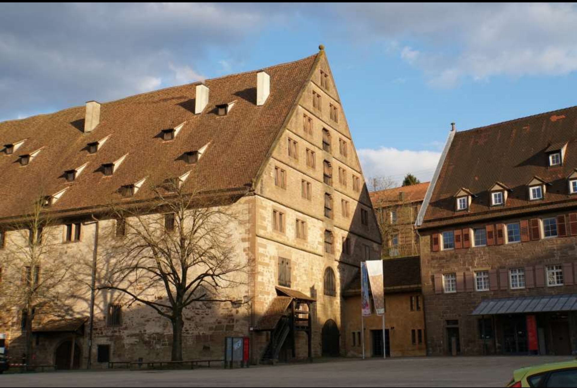
Maulbronn. Wirtschaftshof. Speicher, 16. Jh.
