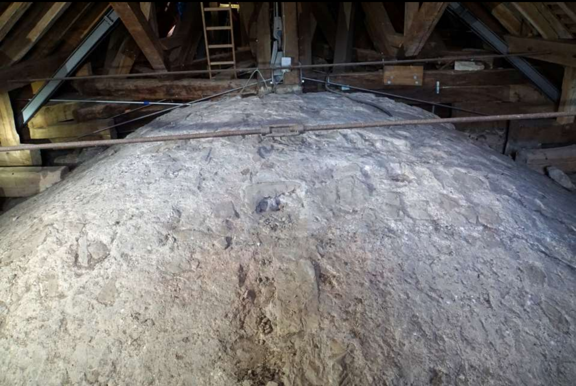
Maulbronn, Kirche. Kreuzrippengewölbe des Chores von oben
