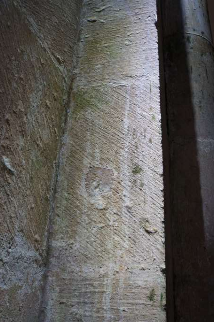
Kloster Fontenay, Burgund – Steinbearbeitung in der Kirche im Normal- und Streiflicht
